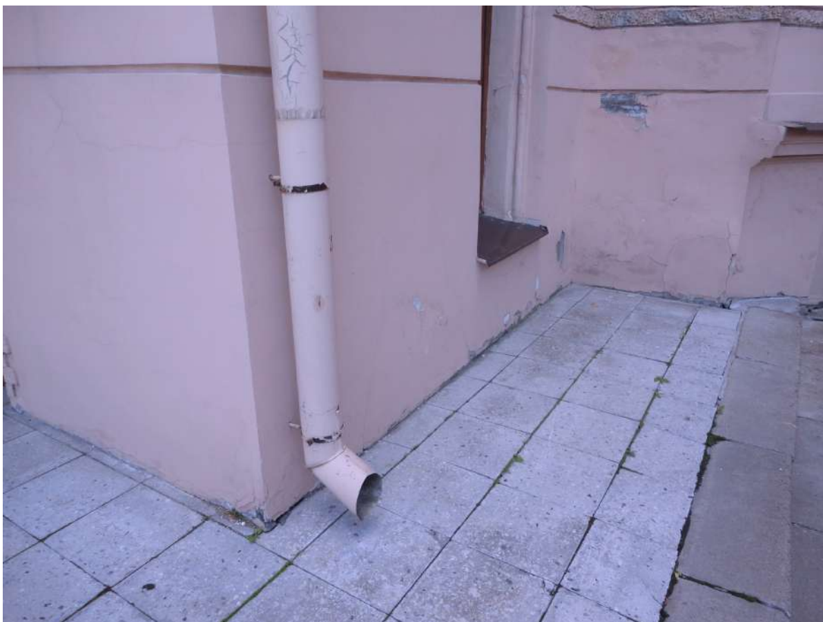
11. Участок по адресу: Санкт-Петербург, Арсенальная наб., 3; Комсомола ул., 4. Здание школы. Вид на крыльцо. Главный вход. 27.09.2021 г.
