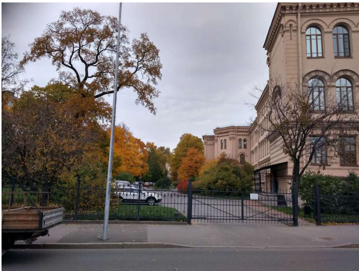
15. Участок по адресу: Санкт-Петербург, Арсенальная наб., 3; Комсомола ул., 4. Южная часть участка с проездом в центре. Вид с юга. 27.09.2021 г.
