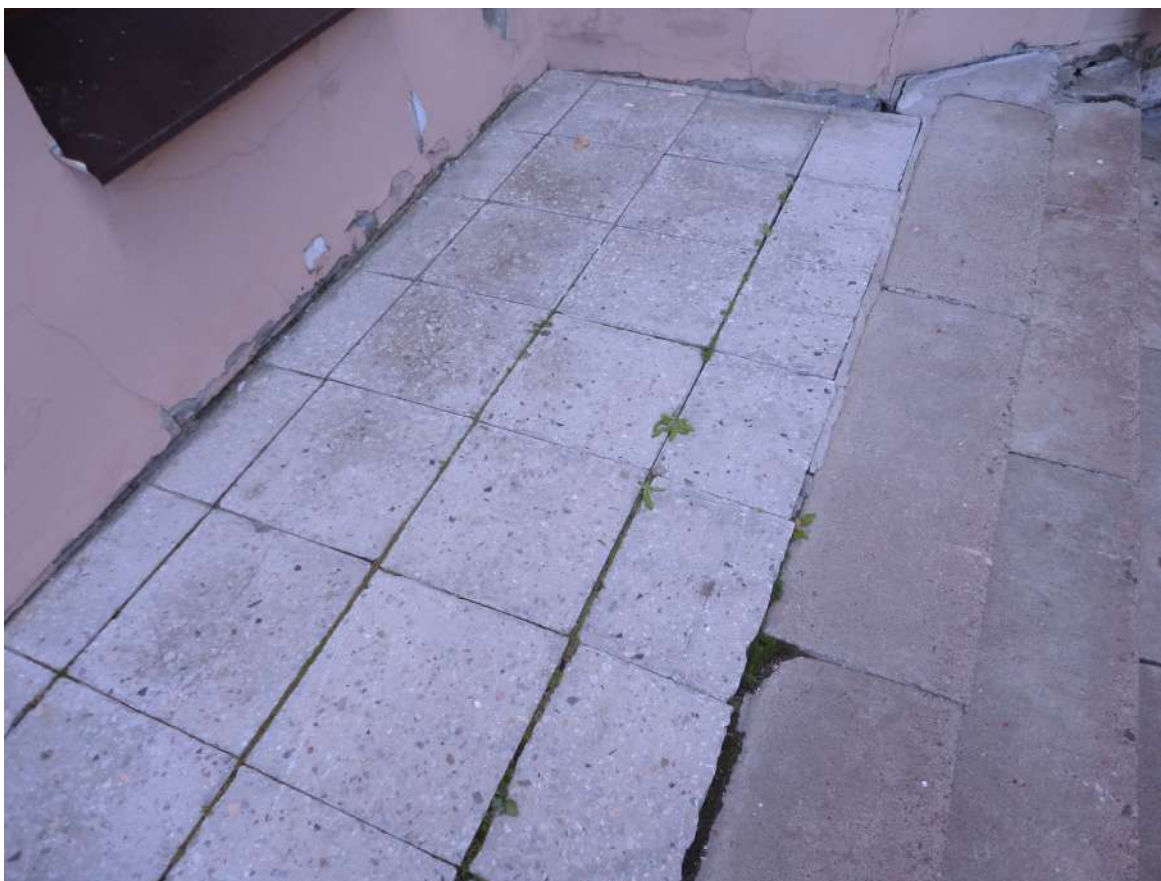
12. Участок по адресу: Санкт-Петербург, Арсенальная наб., 3; Комсомола ул., 4. Здание школы. Вид на крыльцо. Главный вход. 27.09.2021 г.
