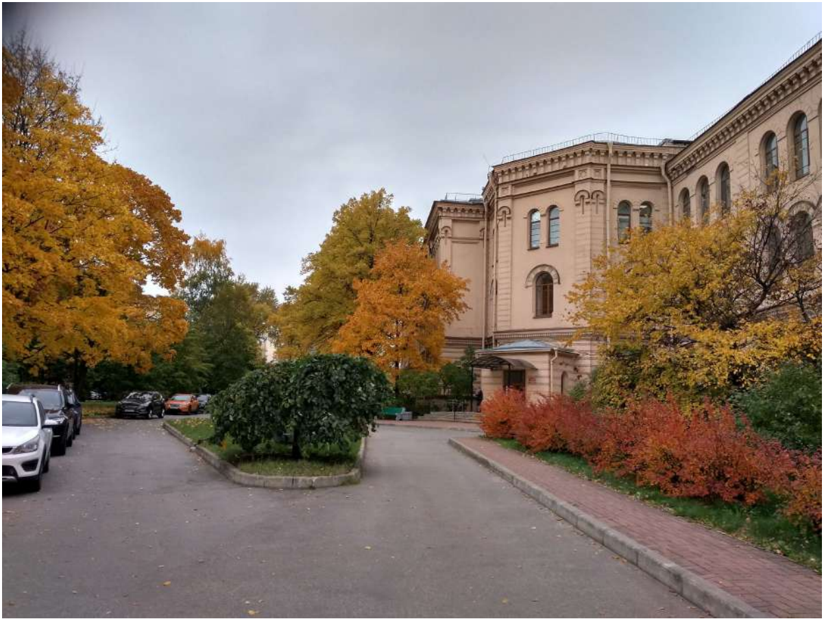
6. Участок по адресу: Санкт-Петербург, Арсенальная наб., 3; Комсомола ул., 4. Центральная часть участка. Вид с юга. 27.09.2021 г.
