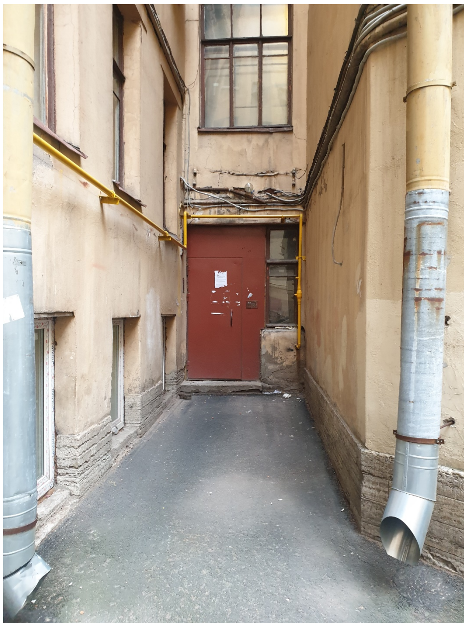
Фото 8 – Дворовой фасад. Вход в подъезд.
