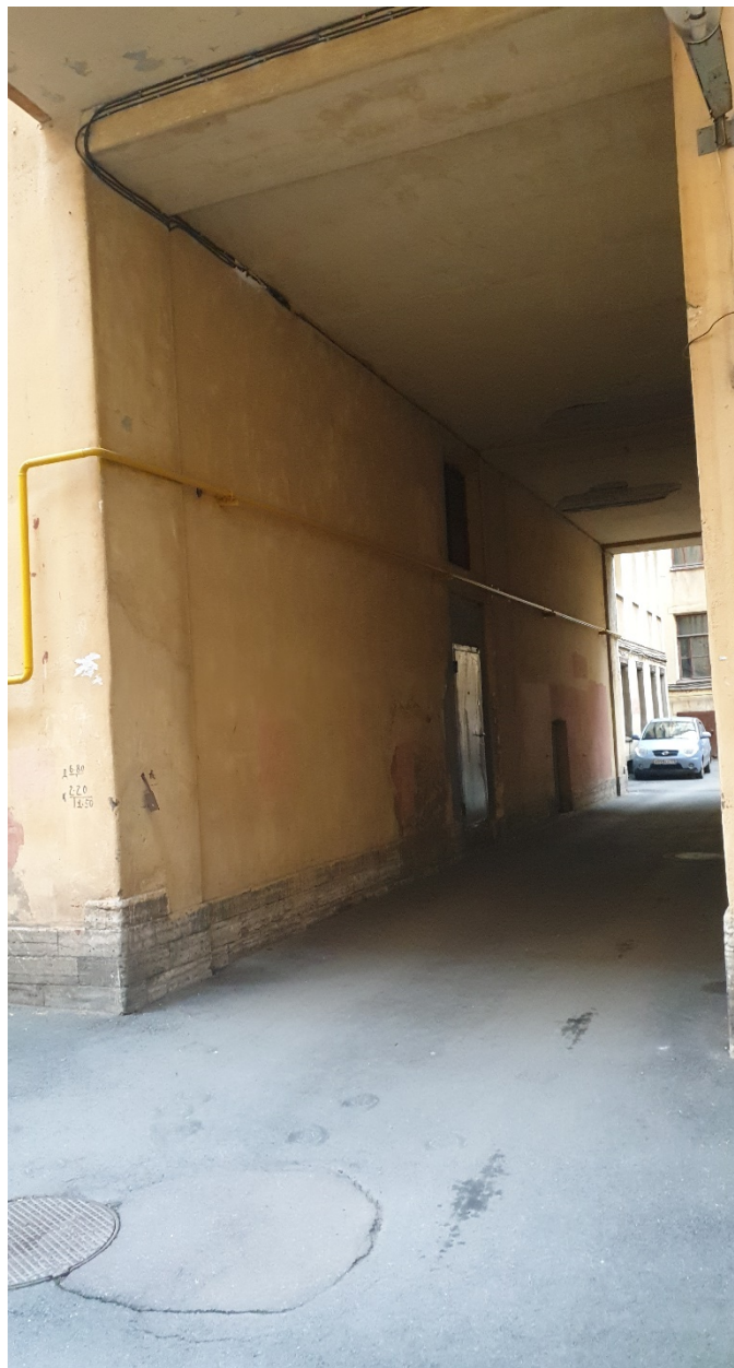
Фото 7 – Дворовой фасад. Арка. Устроенная наружная дверь в квартиру.
