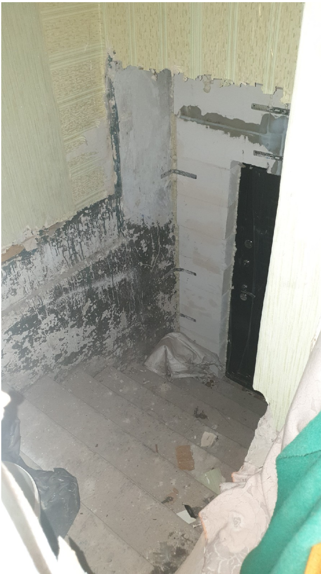
Фото 20 – Устроенный вход со стороны арки
