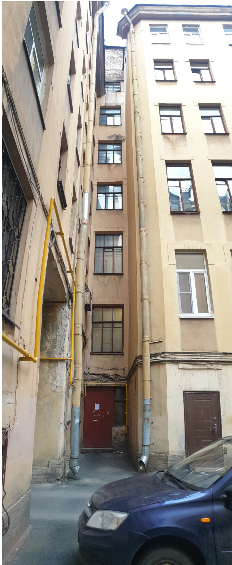
Фото 4 – Дворовой фасад. Вход в подъезд, слева арка.
