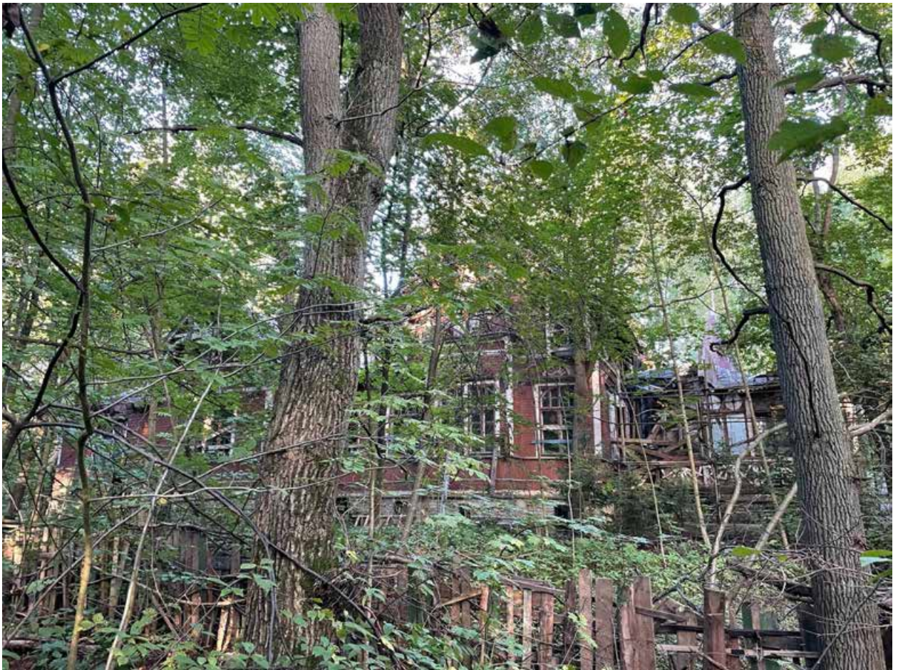
Фото 4. Здание по адресу: Санкт-Петербург, г. Зеленогорск, Театральная ул., д. 9. Западный фасад.
