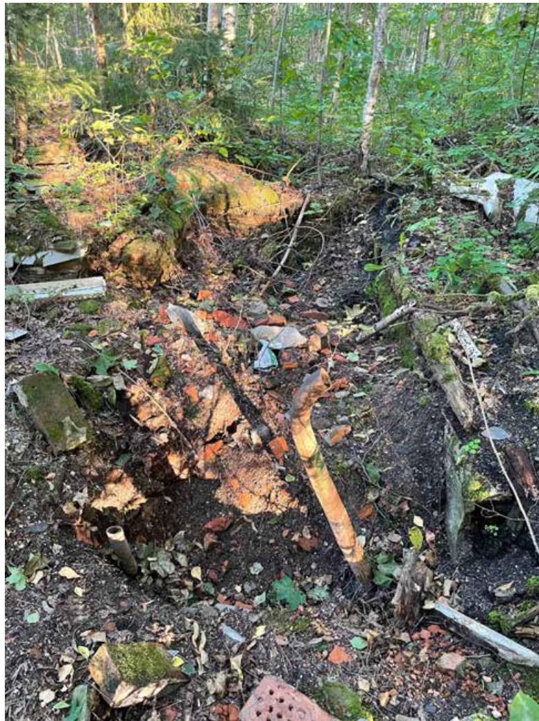
Фото 8. Строительный мусор на месте здания по адресу: Санкт-Петербург, г. Зеленогорск, Театральная ул., д. 7.
