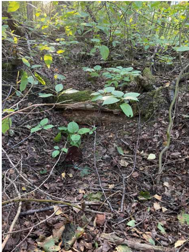
Фото 13. Остатки строительных конструкций здания по адресу: Санкт-Петербург, г. Зеленогорск, Театральная ул., д. 7.
