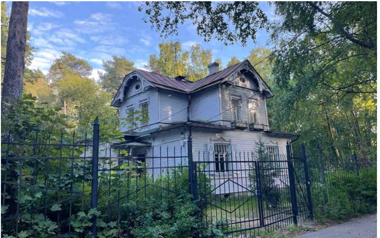
Фото 1. Здание по адресу: Санкт-Петербург, г. Зеленогорск, Театральная ул., д. 8. Вид с Театральной улицы. Северный и западный фасады.
