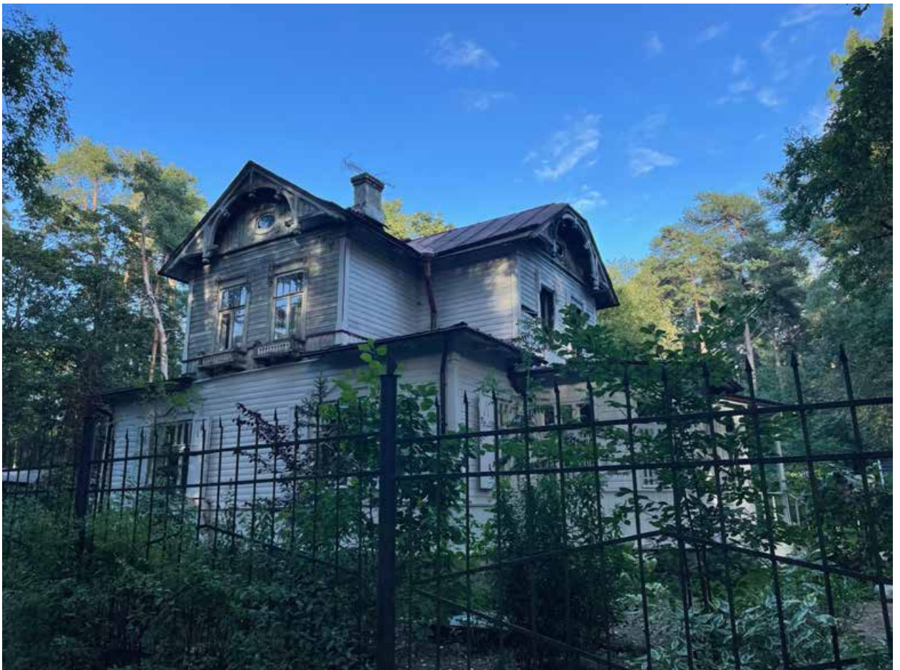
Фото 2. Здание по адресу: Санкт-Петербург, г. Зеленогорск, Театральная ул., д. 8. Вид с Театральной улицы. Южный и западный фасады.
