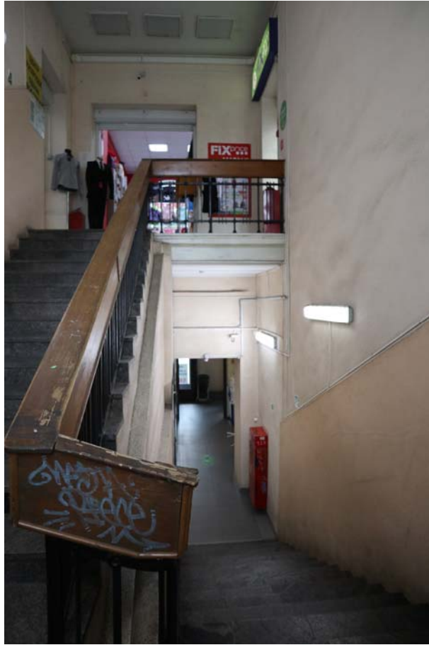
Фото 1.7. 1 этаж, лестница, помещение 7Н (1).
