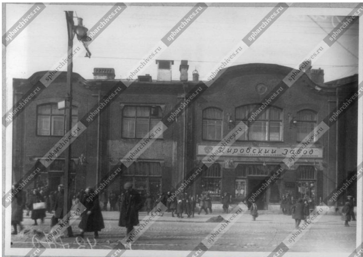
Илл. 11. Вид части фасада дома №53 на улице Стачек. 1938 г. ЦГАКФФД СПб. Фотодокумент Вр 43770.
