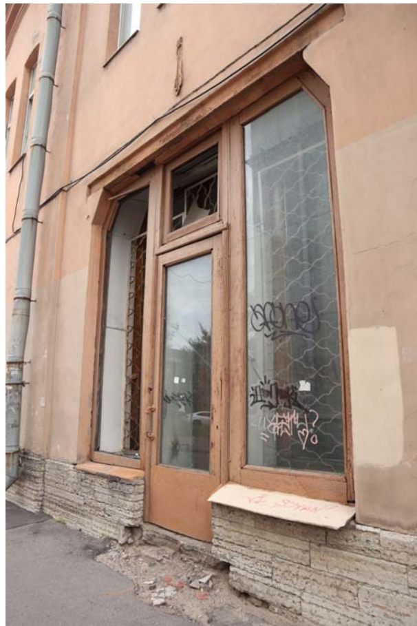
Фото 5. Фрагмент бокового фасада со стороны Новоовсянниковской улицы.
