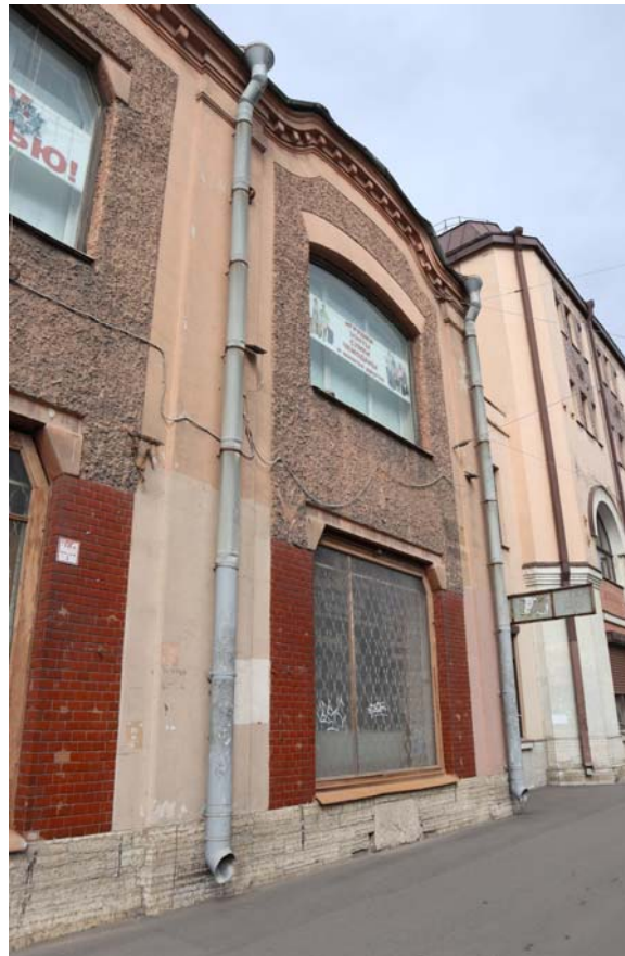
Фото 7. Фрагмент лицевого фасада со стороны пр. Стачек.
