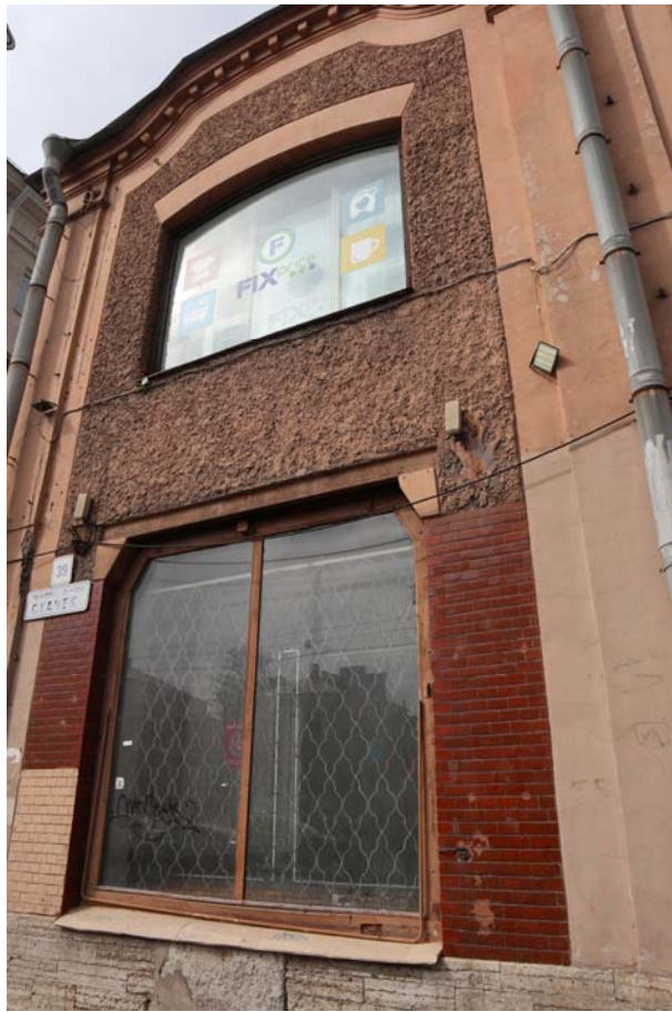
Фото 8. Фрагмент лицевого фасада со стороны пр. Стачек.
