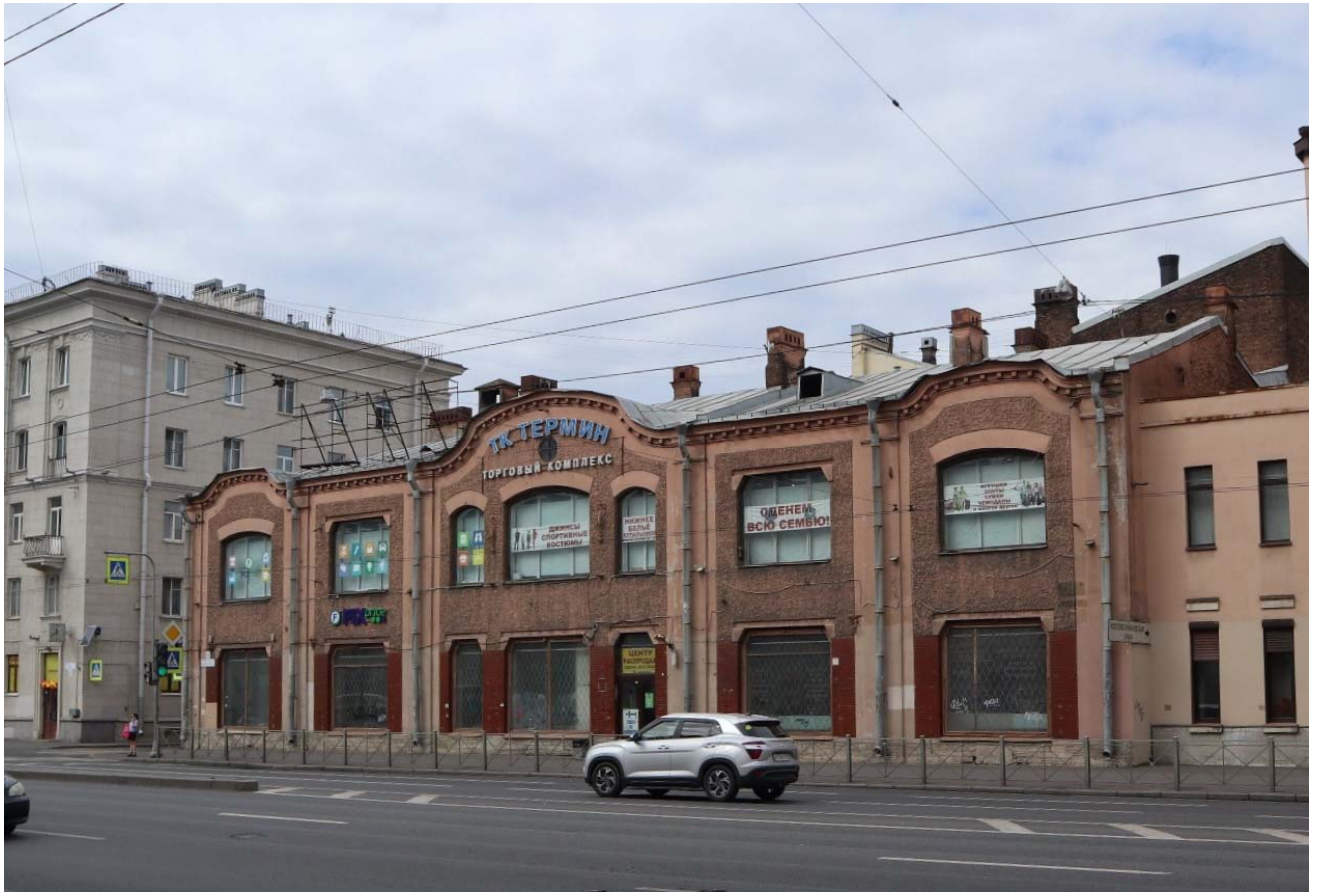
Фото 1. Лицевой фасад со стороны пр. Стачек.
