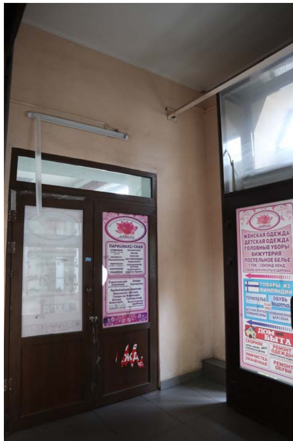
Фото 1.2. 1 этаж, помещение 1 ЛК (1).
