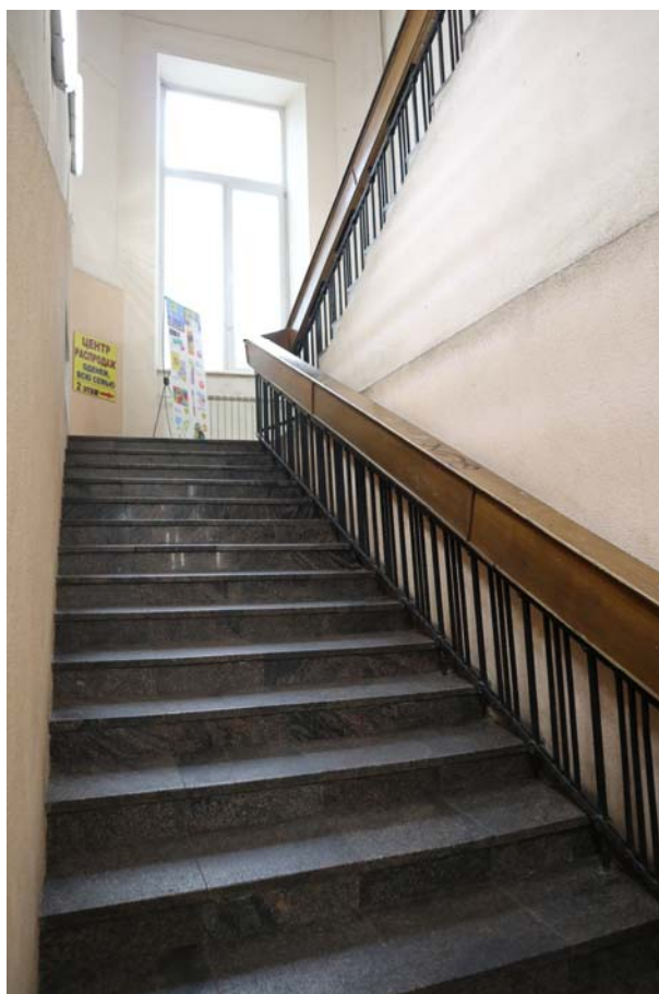
Фото 1.6. 1 этаж, лестница, помещение 7Н (1).
