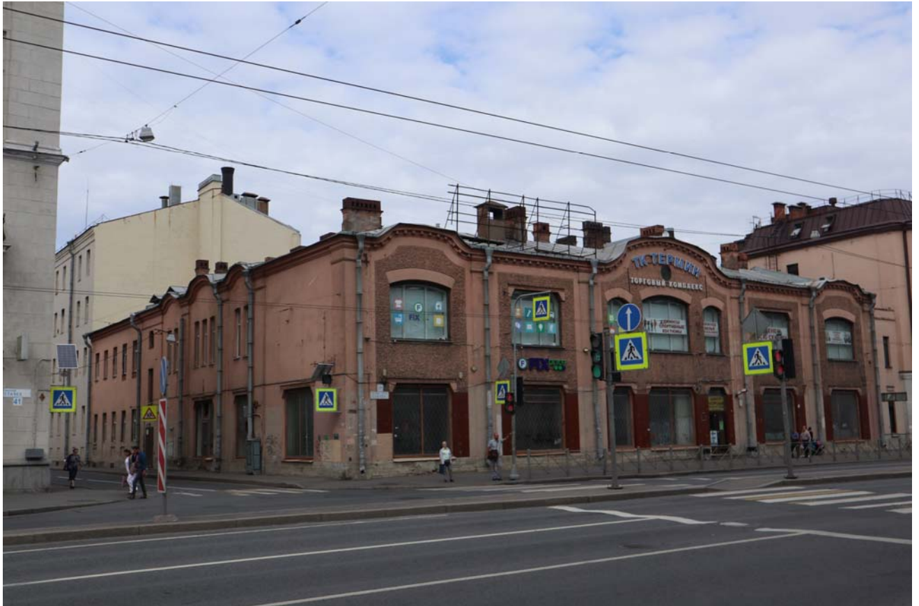
Фото 2. Лицевой фасад со стороны пр. Стачек.
