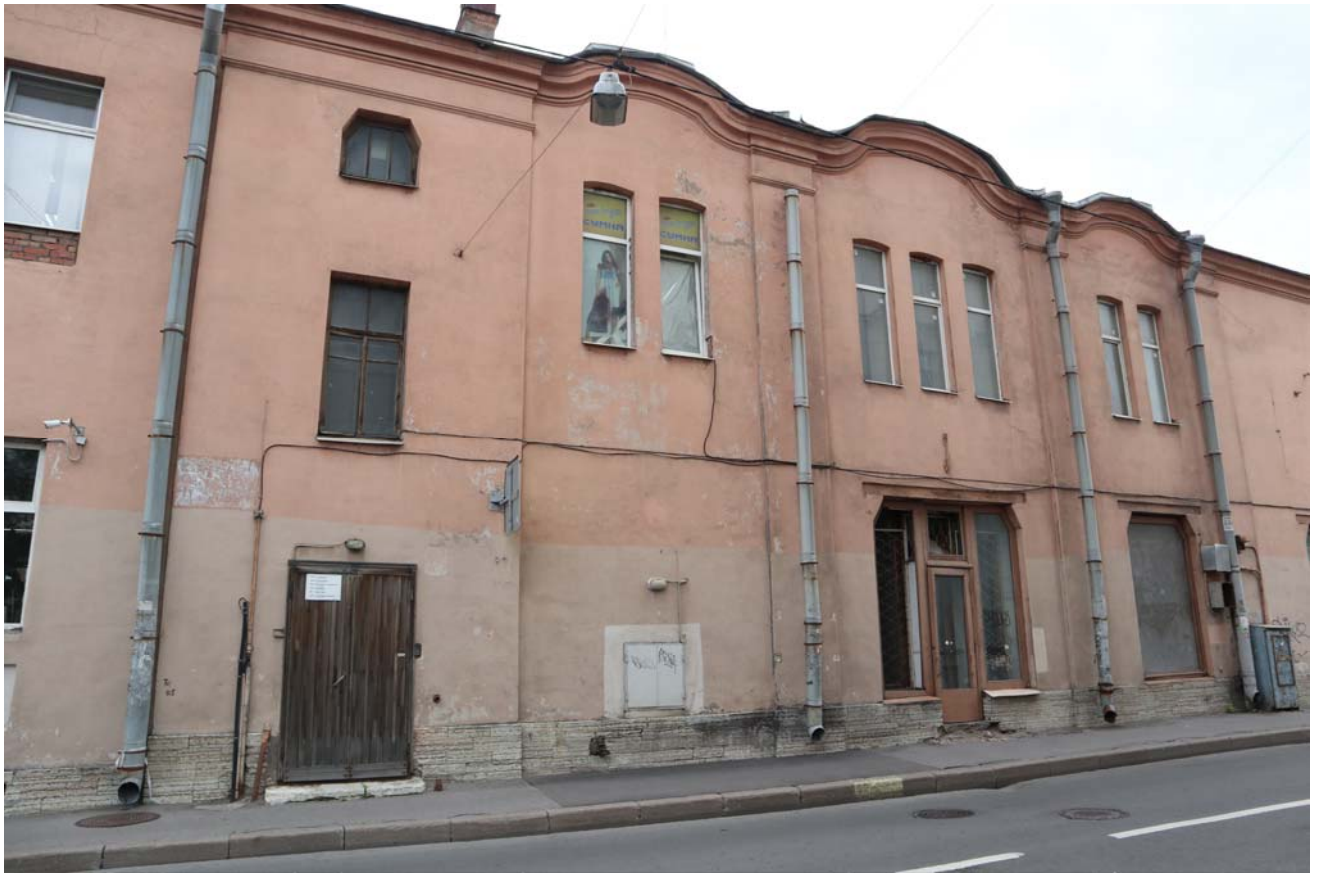
Фото 4. Фрагмент бокового фасада со стороны Новоовсянниковской улицы.
