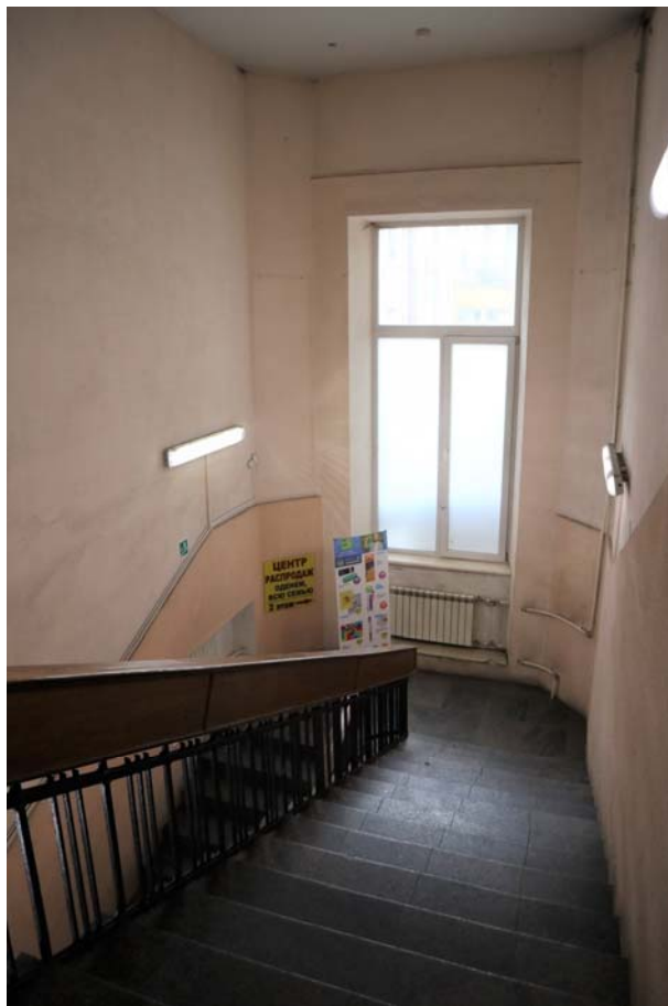
Фото 2.1. 2 этаж, лестница, помещение 7Н (2).
