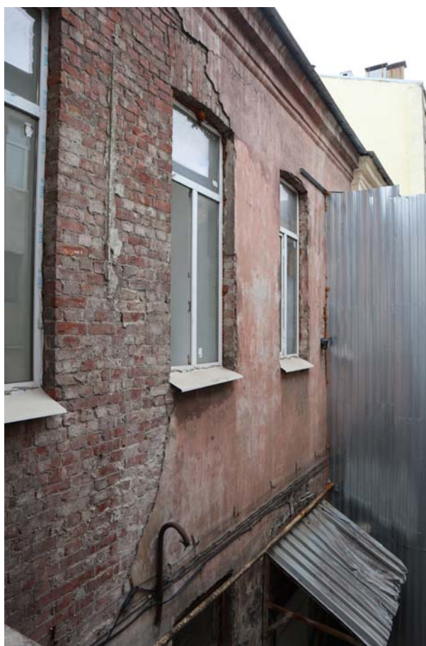
Фото 11. Фрагмент дворового фасада, оконные проемы второго этажа.
