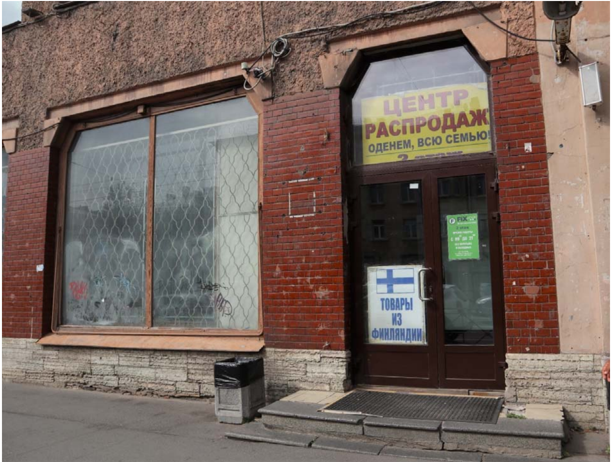
Фото 6. Фрагмент лицевого фасада со стороны пр. Стачек.
