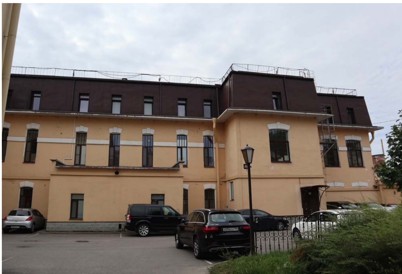
Фото 4. Фрагмент бокового фасада, вид с севера.
