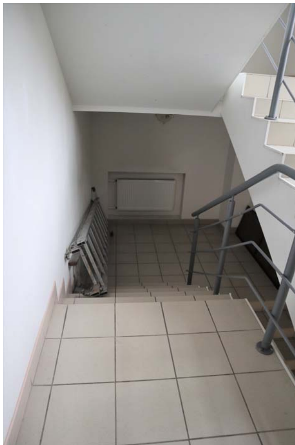
Фото 2.2. 2 этаж, лестница, помещение 1Н (65).
