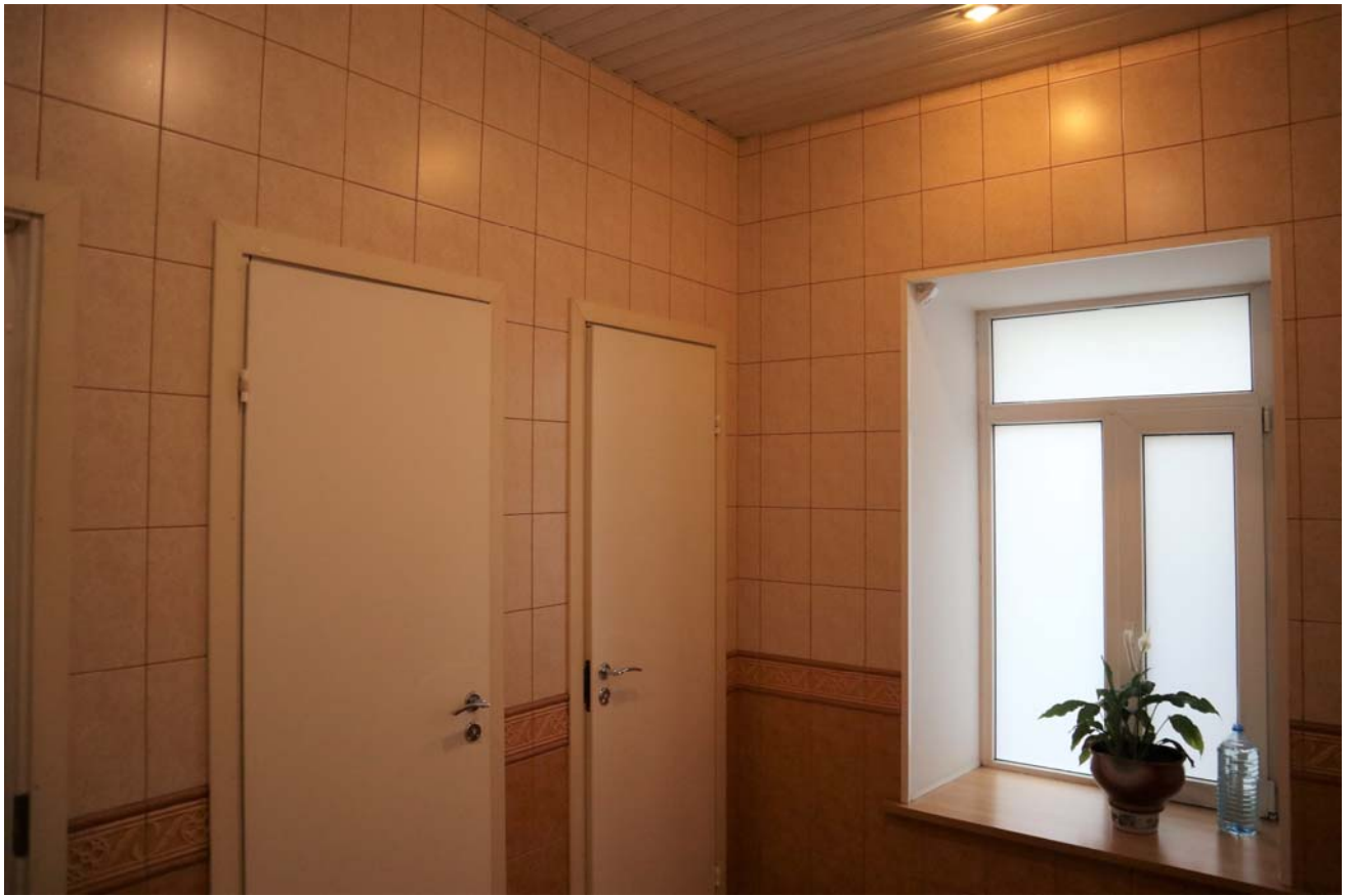
Фото 1.17. 1 этаж, помещение 1Н (39).
