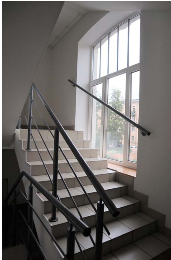
Фото 2.1. 2 этаж, лестница, помещение 1Н (65).
