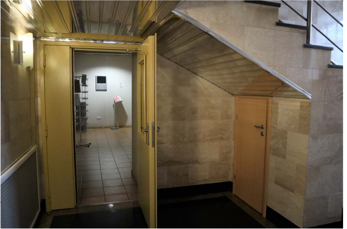
Фото 1.7. 1 этаж, помещение 1Н (2).
