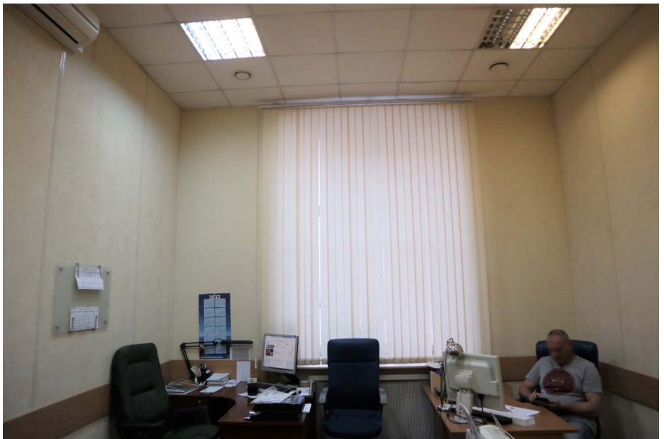
Фото 2.14. 2 этаж, помещение 1Н (55).
