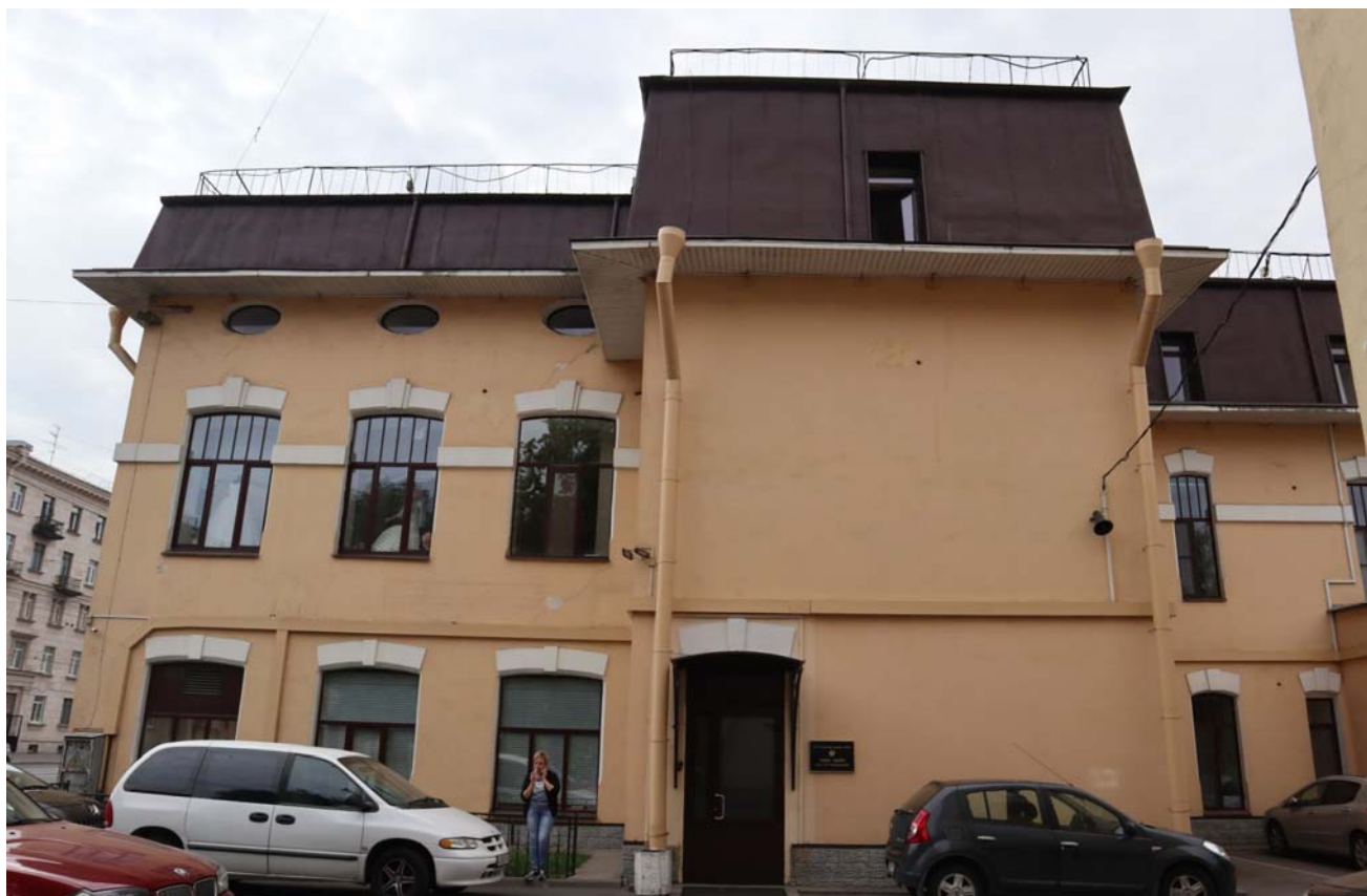
Фото 5. Фрагмент бокового фасада, вид с севера.
