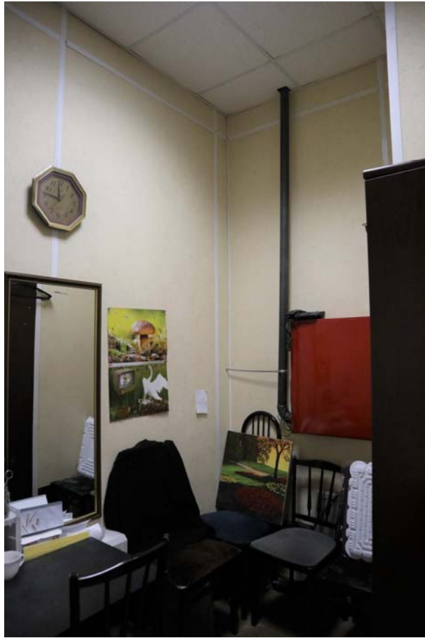
Фото 3.19. 3 этаж, помещение 1Н (117).
