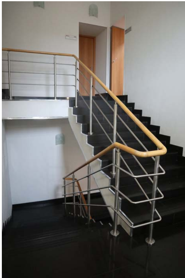
Фото 3.22. 3 этаж, лестница, помещение 1Н (79).
