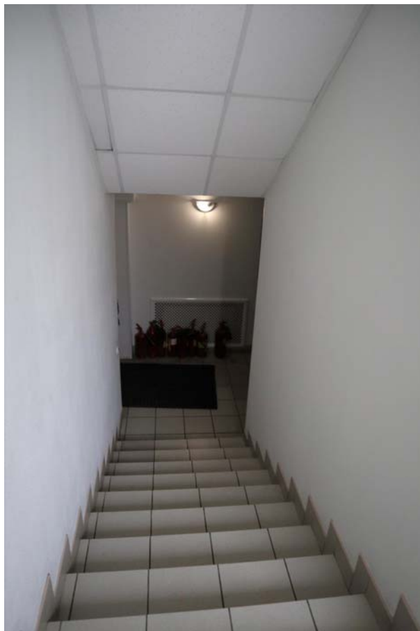
Фото 1.36. 1 этаж, лестница, помещение 1Н (26).
