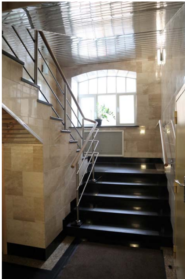
Фото 1.8. 1 этаж, лестница , помещение 1Н (2).
