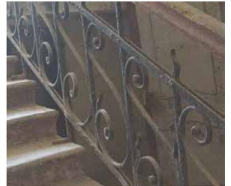
историческая черная лестница – местоположение, габариты, тип (двухмаршевая), конструкция (лестничные марши на металлических косоурах), материал (известняк), профиль ступеней;
