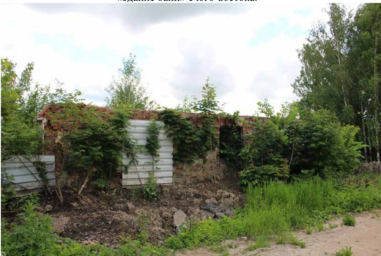
Фото 35. Вид на западный фасад объекта культурного наследия регионального значения «Здание бани».
