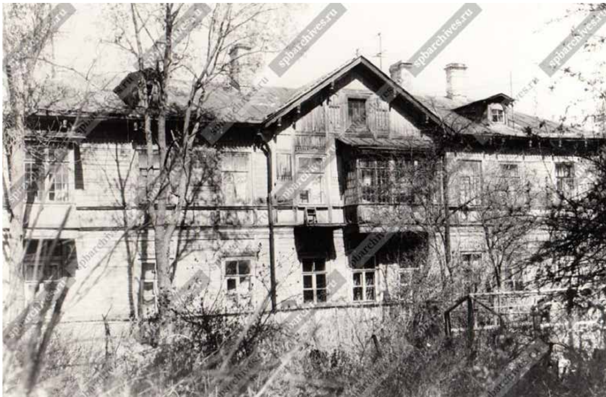
Илл. 54. Вид жилого 2-х этажного деревянного дома № 7 на территории Фабричном поселке в Красном Селе. 30.04.2000 г. (источник: ЦГАКФФД СПб. Фотодокумент Ар 230495).
