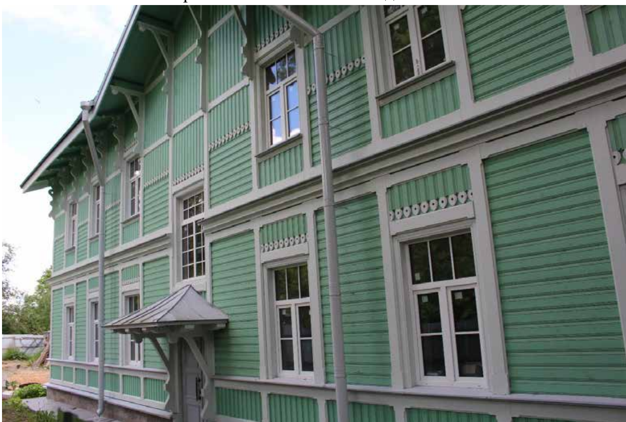
Фото 41. Вид на западный фасад объекта культурного наследия регионального значения «д. № 4».
