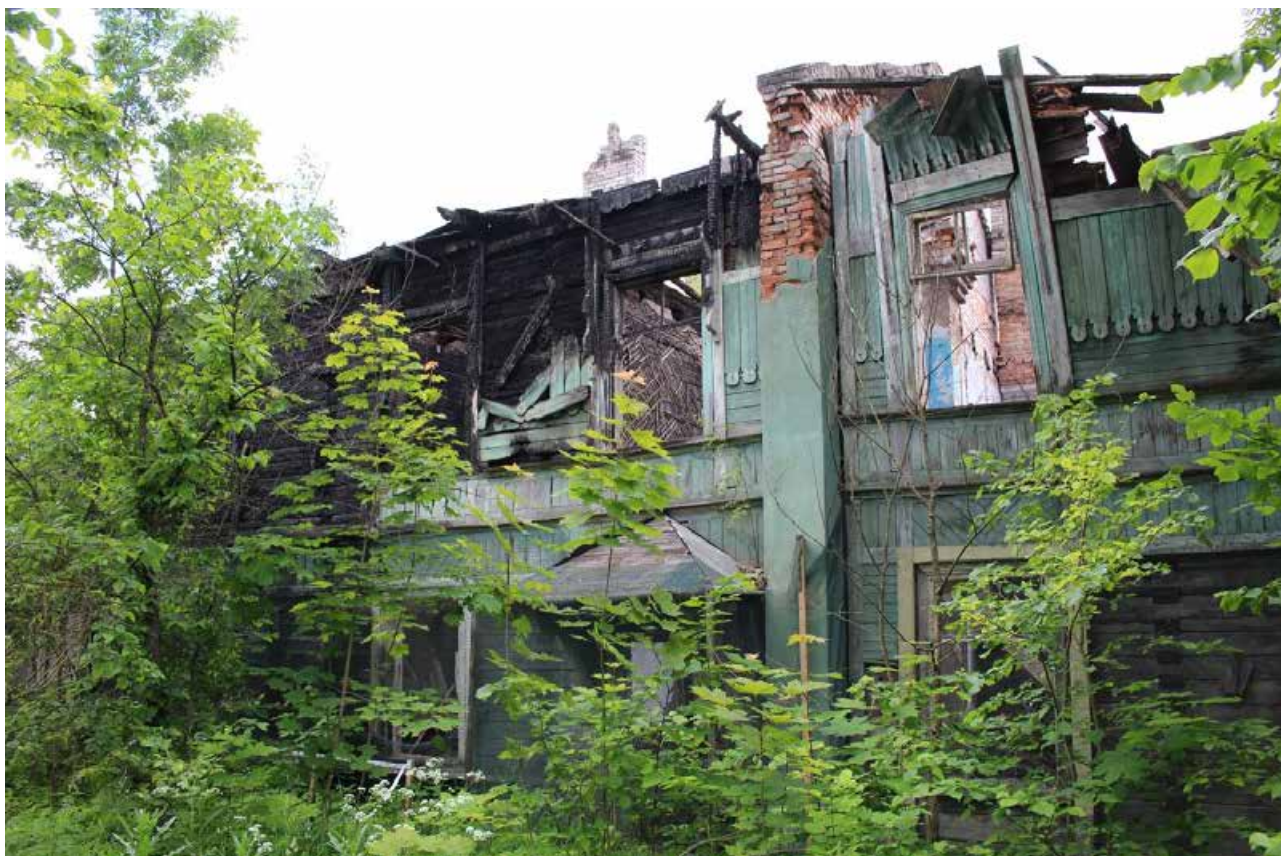
Фото 27. Вид на фрагмент (северный) западного фасада объекта культурного наследия регионального значения «д. № 2».
