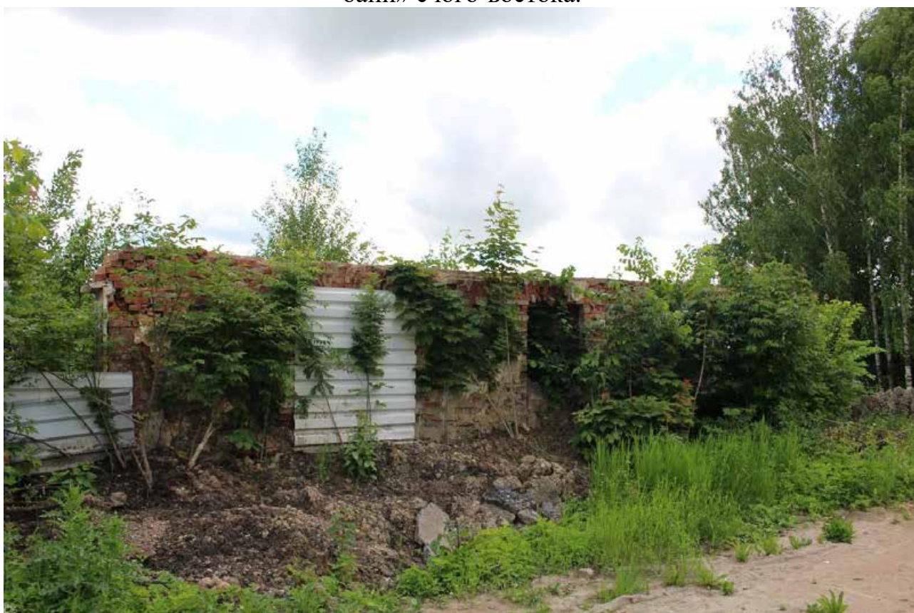
Фото 20. Вид на западный фасад объекта культурного наследия регионального значения «Здание бани».
