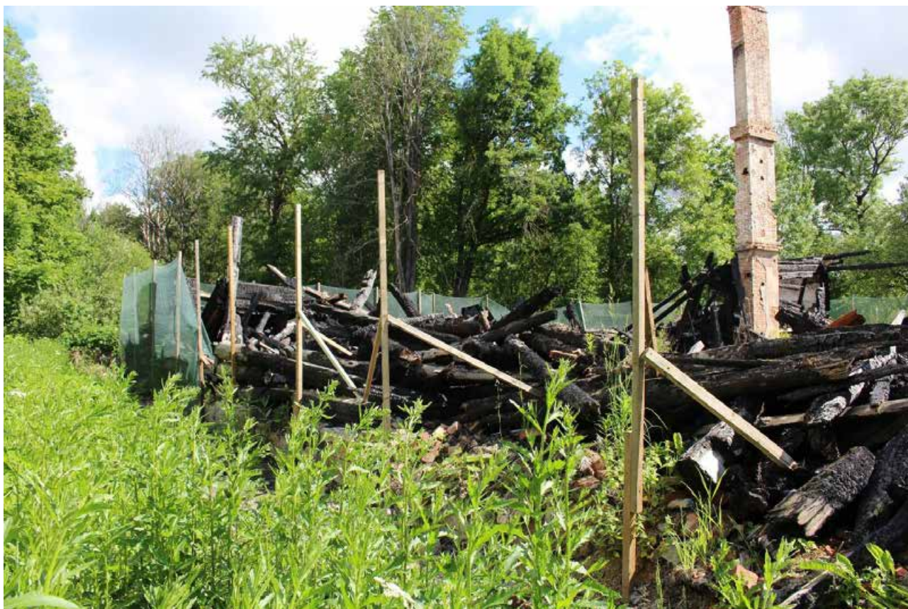
Фото 23. Вид на западный фасад объекта культурного наследия регионального значения «д. № 5» с юго-запада.
