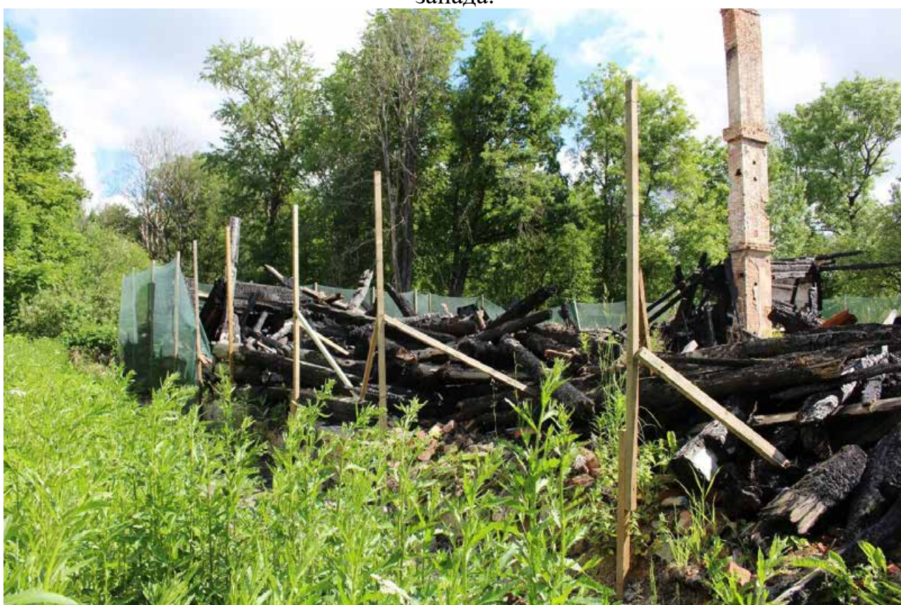
Фото 8. Вид на западный фасад объекта культурного наследия регионального значения «д. № 5» с юго-запада.
