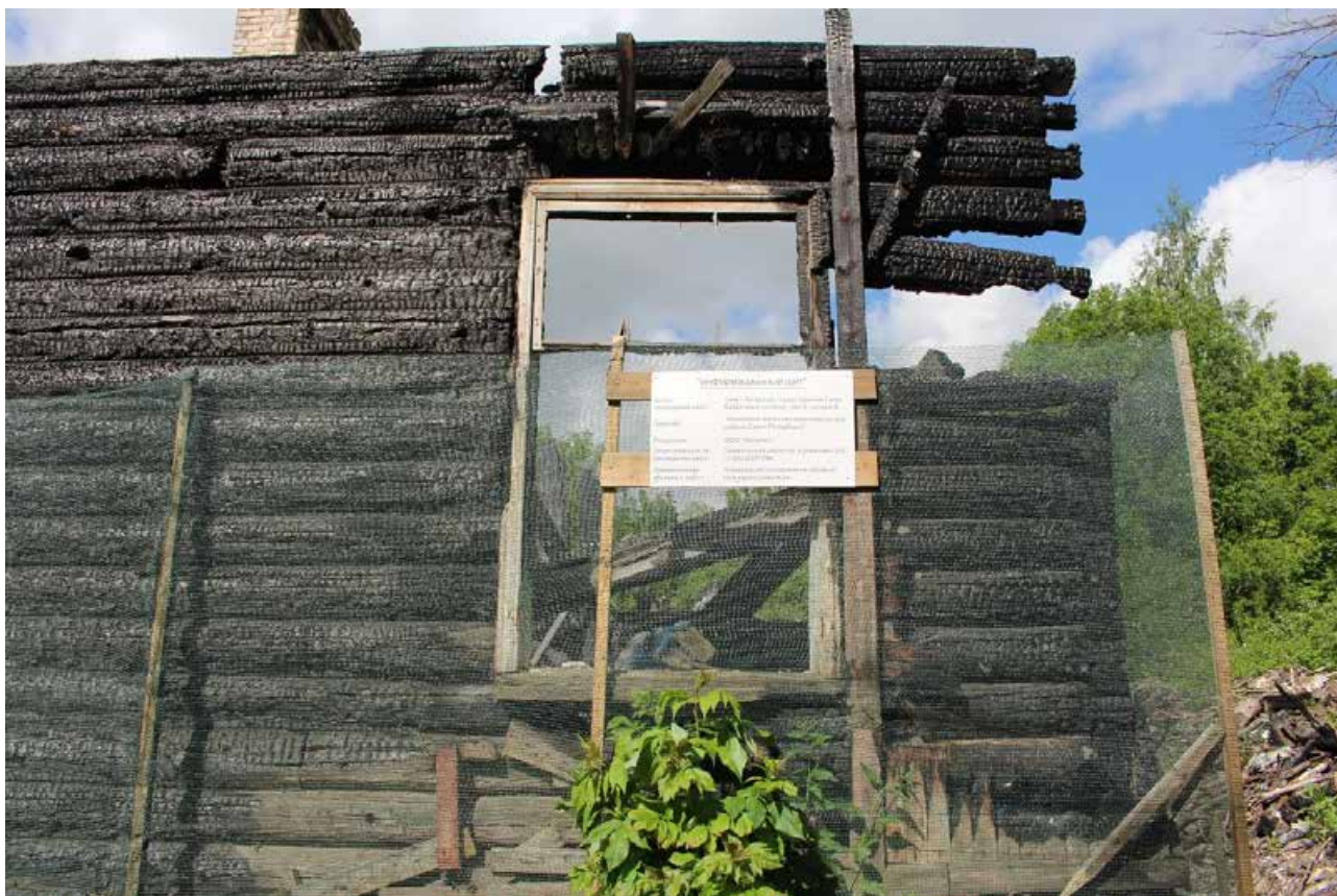
Фото 11. Вид на информационный щит, установленный на сохранившемся фрагменте фасада в северо-восточной части объекта культурного наследия регионального значения «д. № 5».
