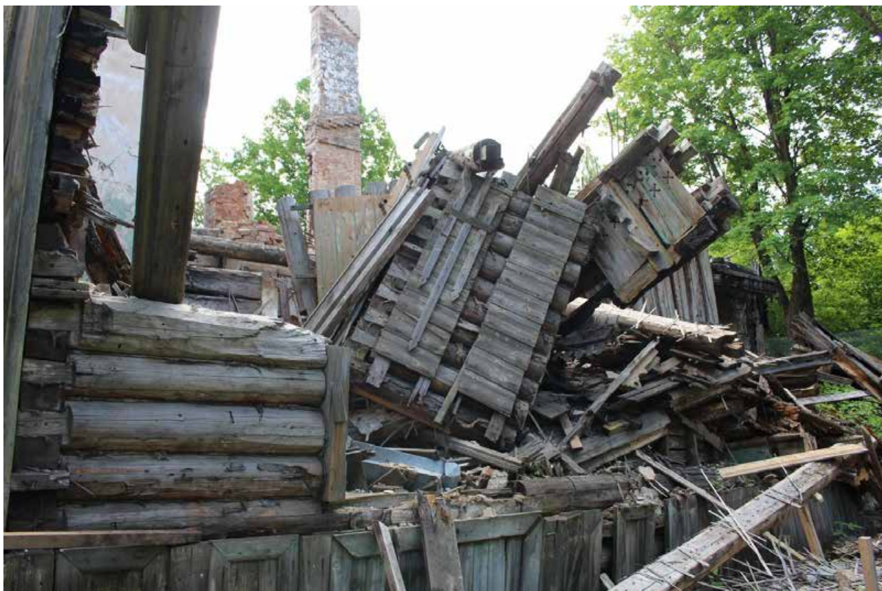
Фото 3. Вид на западный фасад объекта культурного наследия регионального значения «д. № 7».
