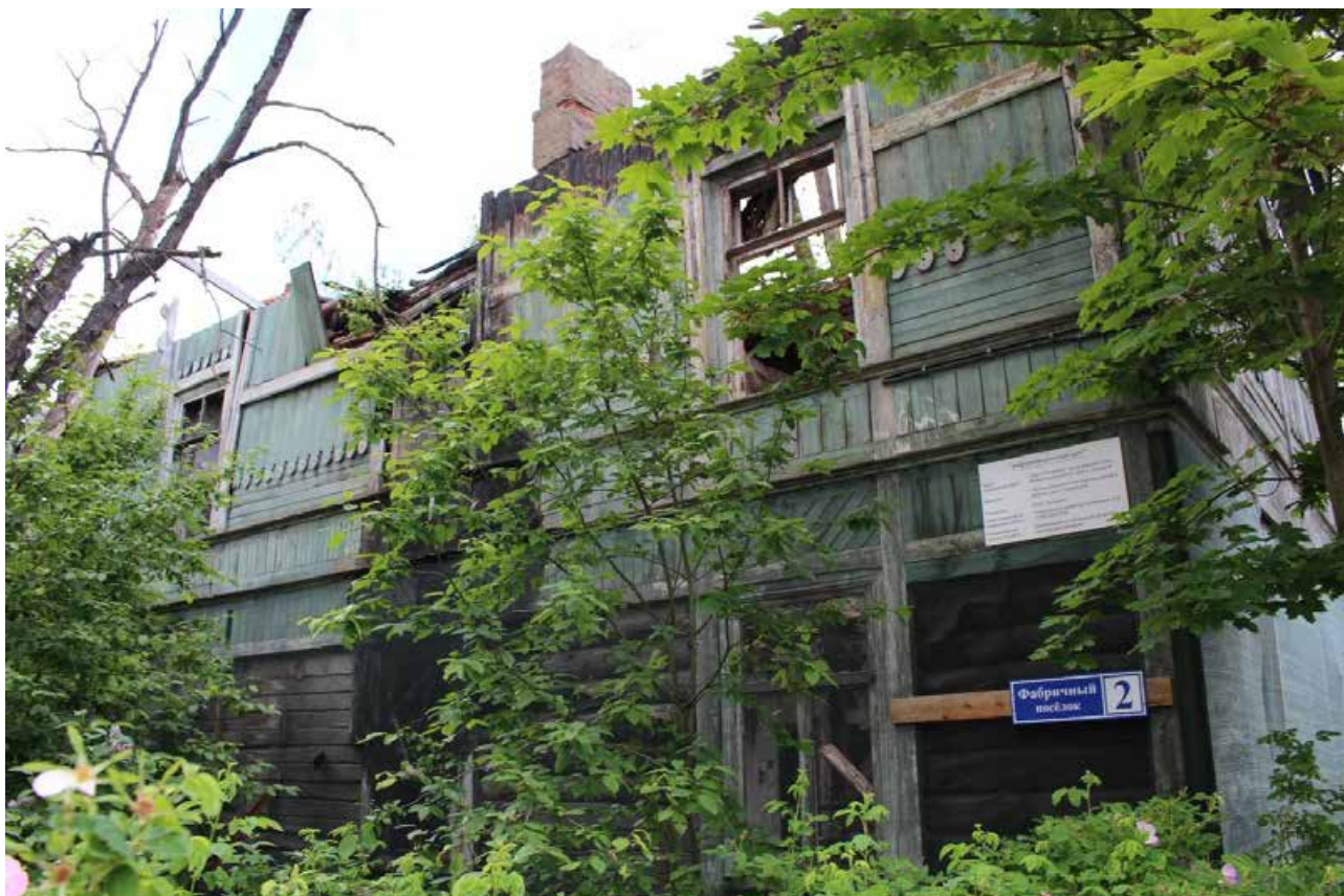
Фото 29. Вид на фрагмент (южный) западного фасада объекта культурного наследия регионального значения «д. № 2».
