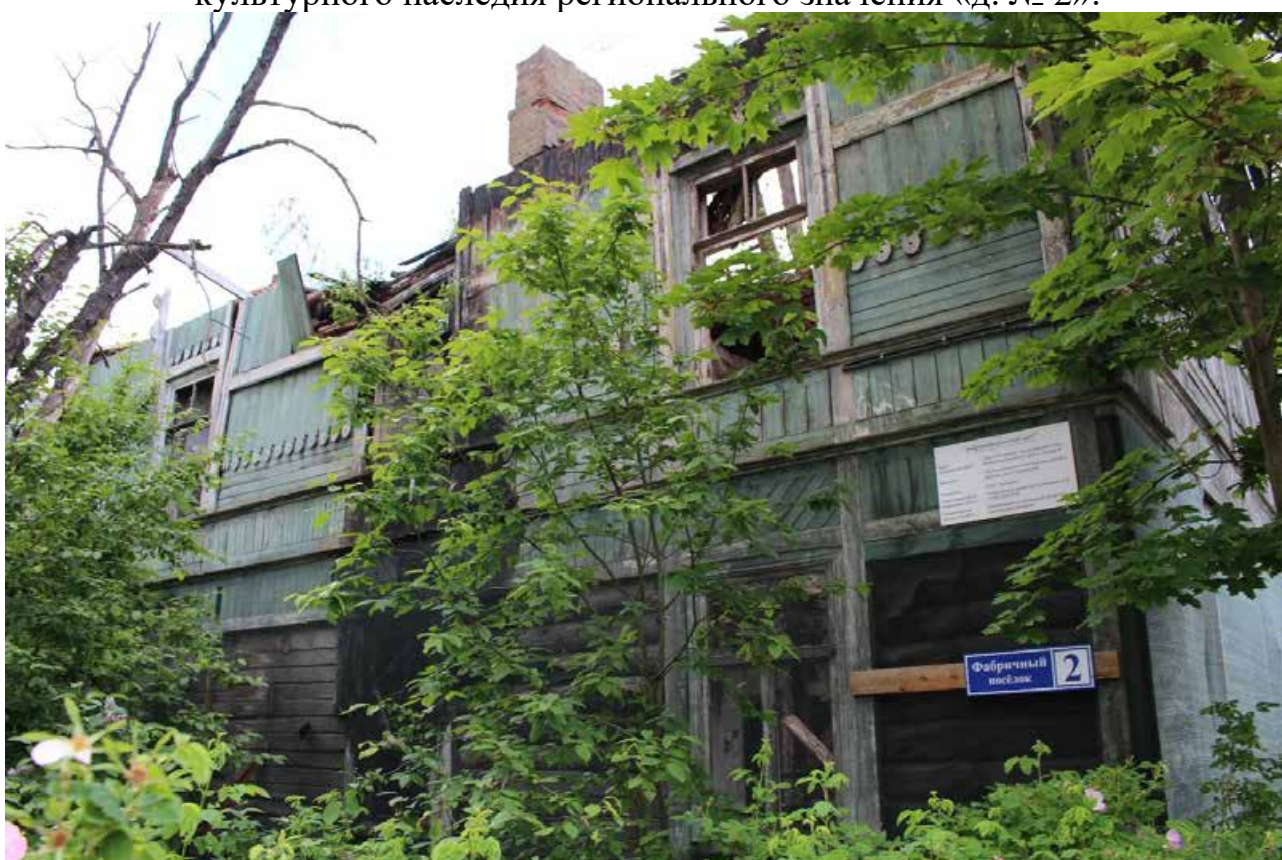
Фото 14. Вид на фрагмент (южный) западного фасада объекта культурного наследия регионального значения «д. № 2».
