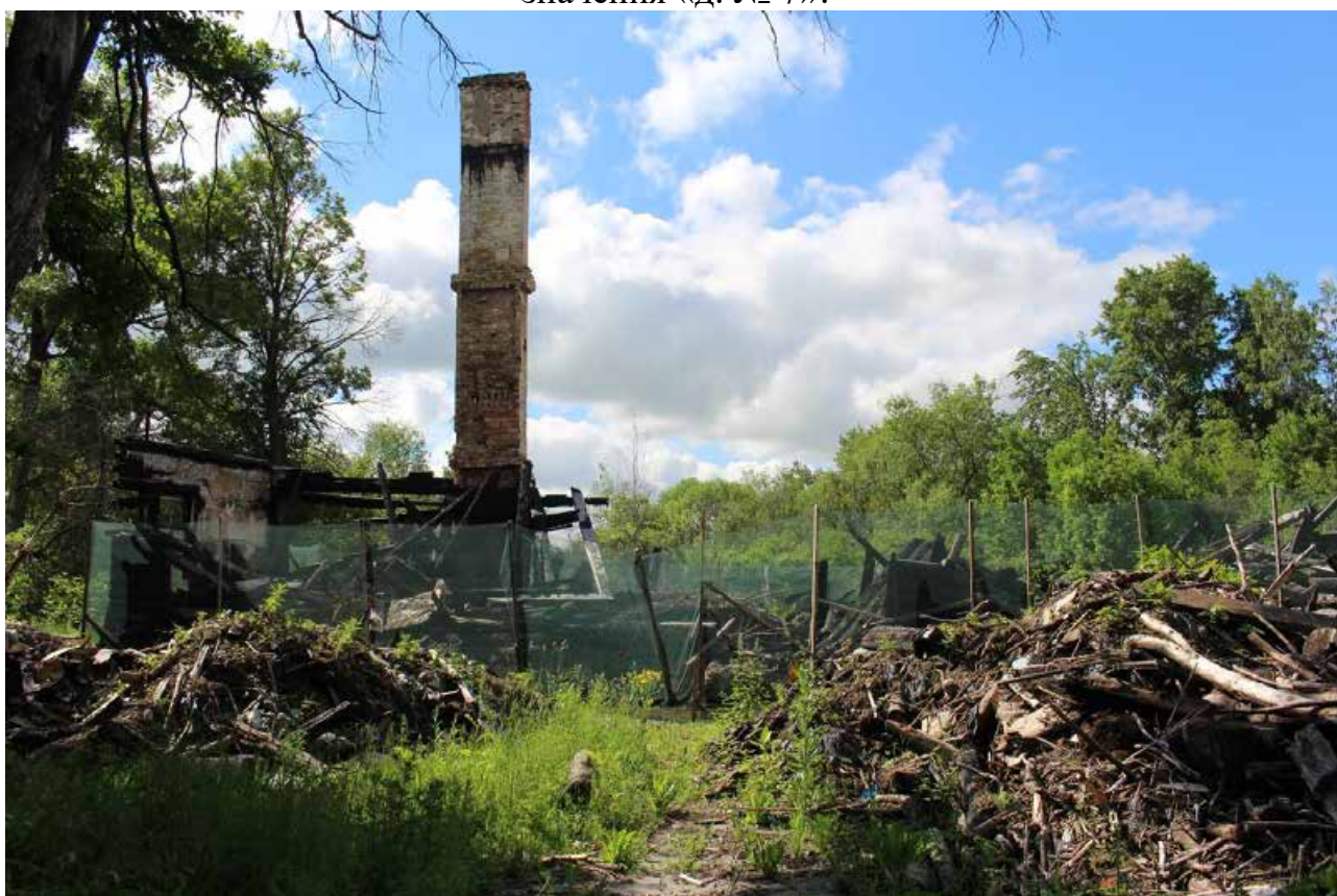
Фото 6. Вид на северный фасад объекта культурного наследия регионального значения «д. № 5».
