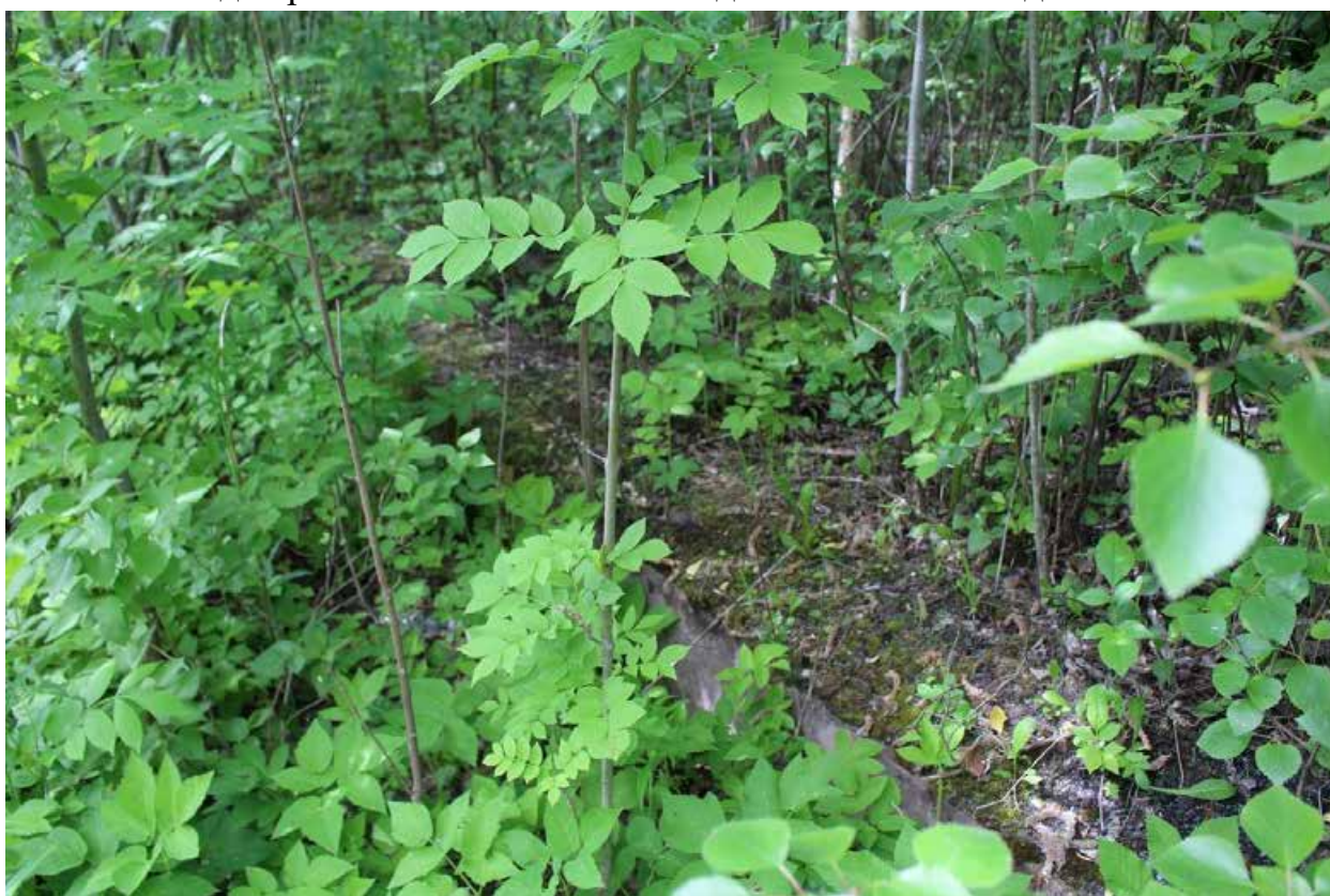
Фото 8. Вид на фрагменты фундамента утраченного объекта культурного наследия регионального значения «д. № 8» в южной части.
