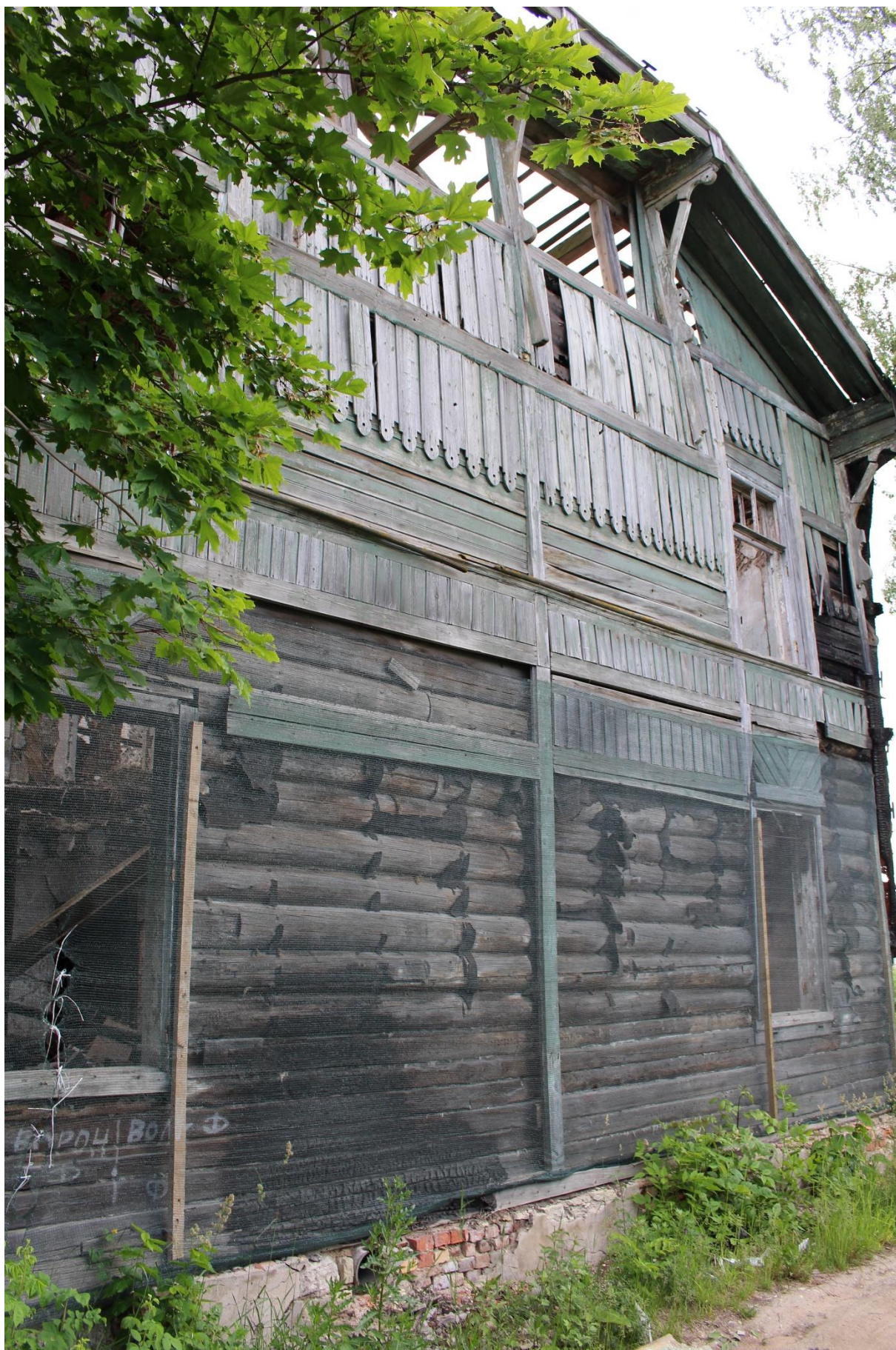
Фото 30. Вид на южный фасад объекта культурного наследия регионального значения «д. № 2».
