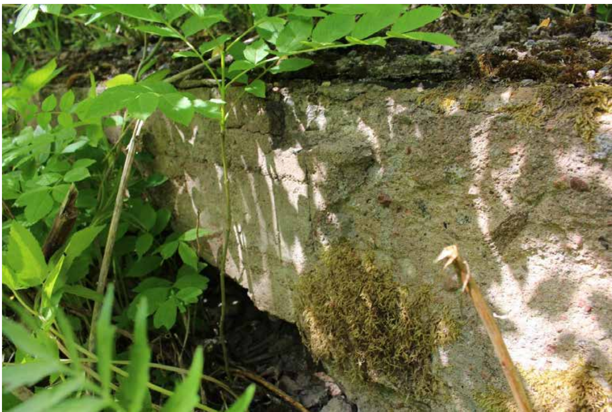
Фото 9. Вид на фрагменты фундамента утраченного объекта культурного наследия регионального значения «д. № 8» в юго-восточной части.
