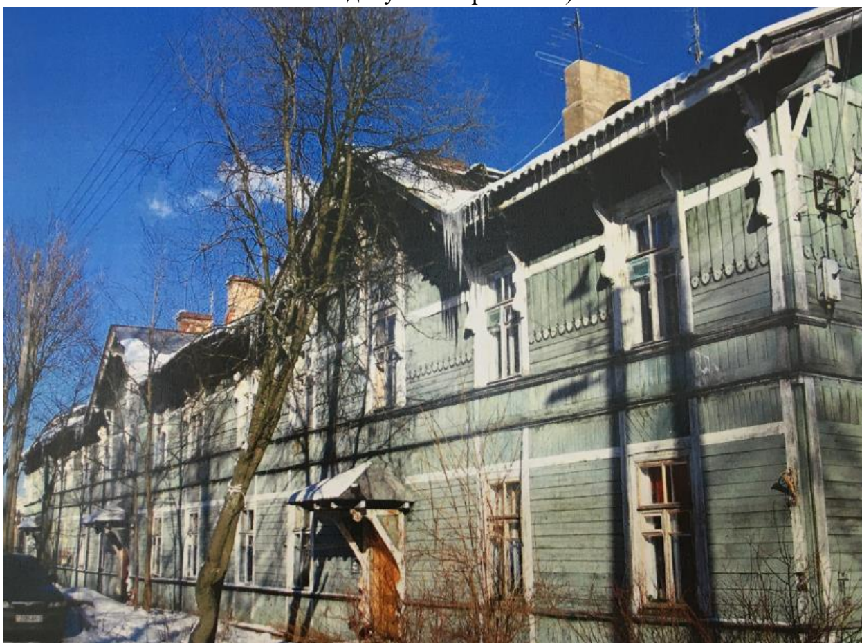
Илл. 55. Жилой дом по адресу: Фабричный поселок, дом № 2. Лицевой (западный) фасад. 2006 г. (источник: архив КГИОП п.623-15).
