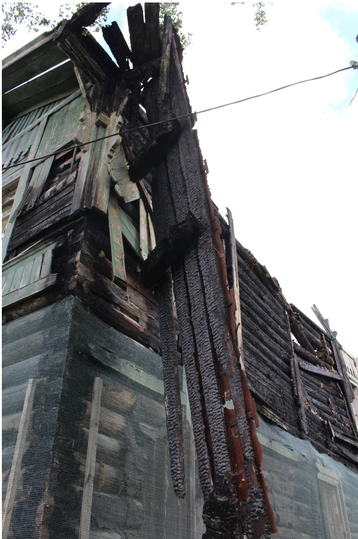
Фото 16. Вид на фрагмент (южный) восточного фасада объекта культурного наследия регионального значения «д. № 2».
