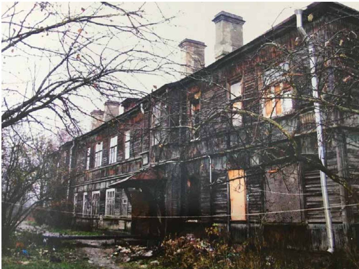
Илл. 68. Жилой дом по адресу: Фабричный поселок, дом № 8. Западный фасад. 2006 г. (источник: архив КГИОП п.623-15).
