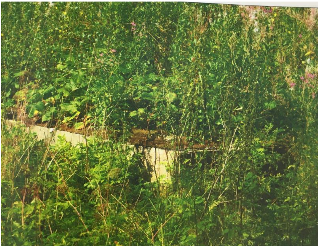
Илл. 70. Фабричный поселок, дом № 8. Фрагмент фундамента. 2013 г. (источник: архив КГИОП п.623-15).
