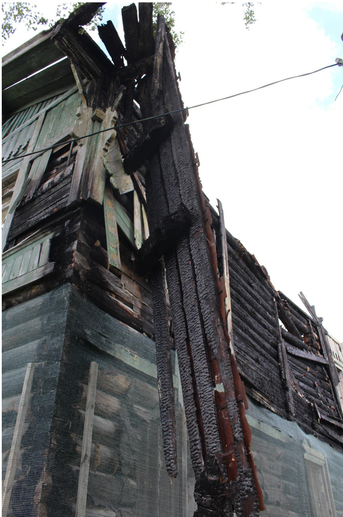
Фото 31. Вид на фрагмент (южный) восточного фасада объекта культурного наследия регионального значения «д. № 2».
