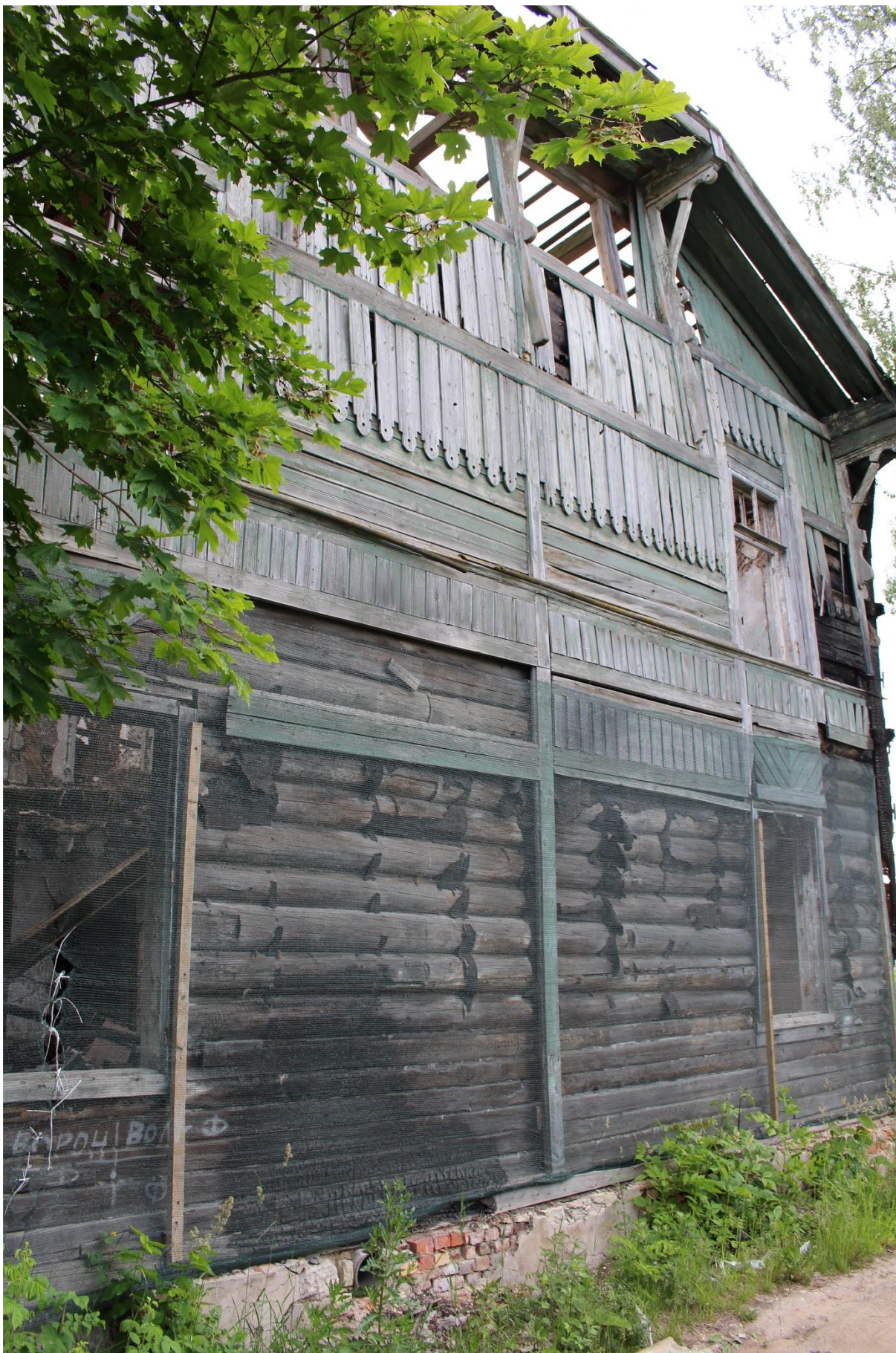
Фото 15. Вид на южный фасад объекта культурного наследия регионального значения «д. № 2».
