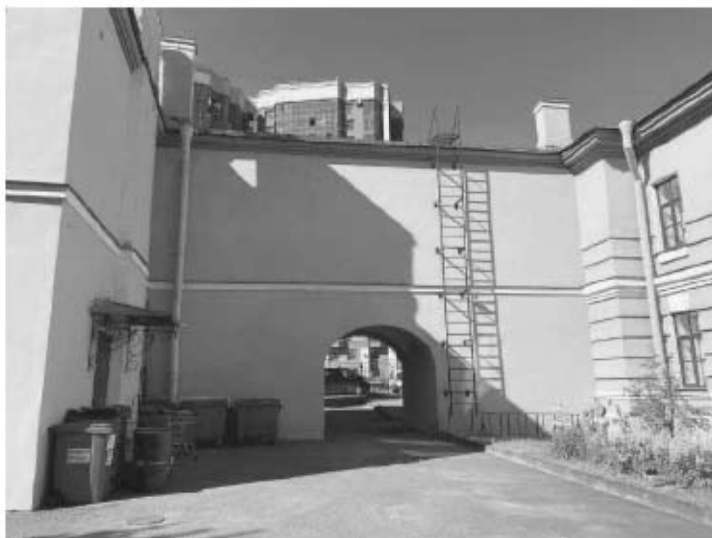
Фото №20. Юго-восточный двор здания, фрагмент южного фасада в осях 6-7, арка во двор.
