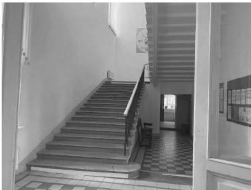
Фото №28. Главная лестница, вид от парадного вестибюля.
