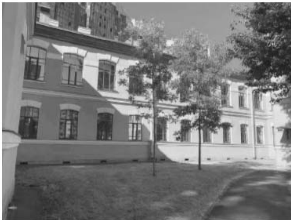
Фото №11. Юго-западный двор здания. Южный фасад в осях 2-4.
