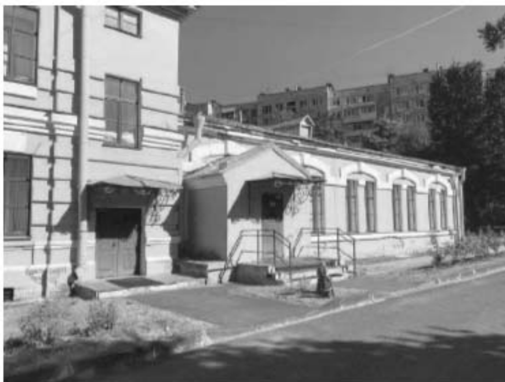
Фото №21. Юго-восточный двор здания, фрагмент восточного фасада в осях Б-В, поздний тамбур входа.
