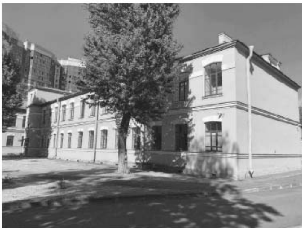
Фото №14. Юго-западный двор здания, западный фасад здания в осях А-Д, вид с южной стороны.
