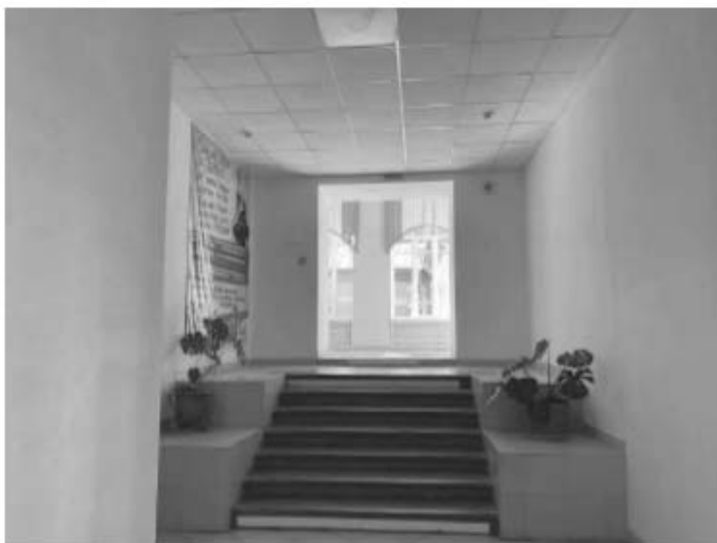
Фото №39. Переход между центральным и восточным корпусами в осях 4-6, историческая лестница.
