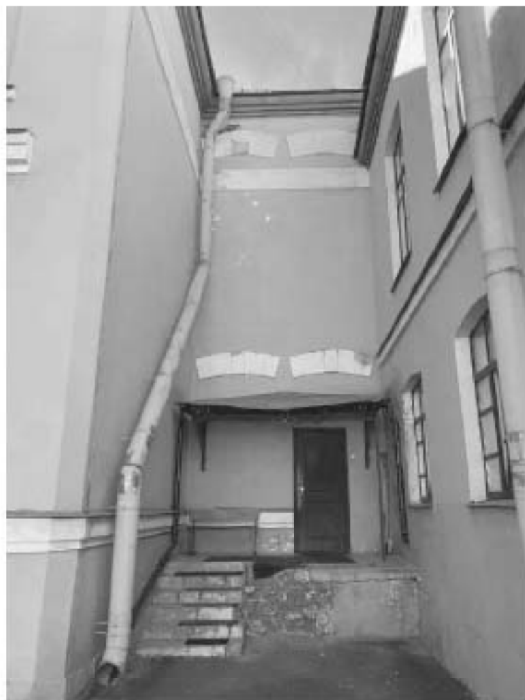
Фото №19. Юго-восточный двор здания, фрагмент восточного фасада в осях А-Д.
