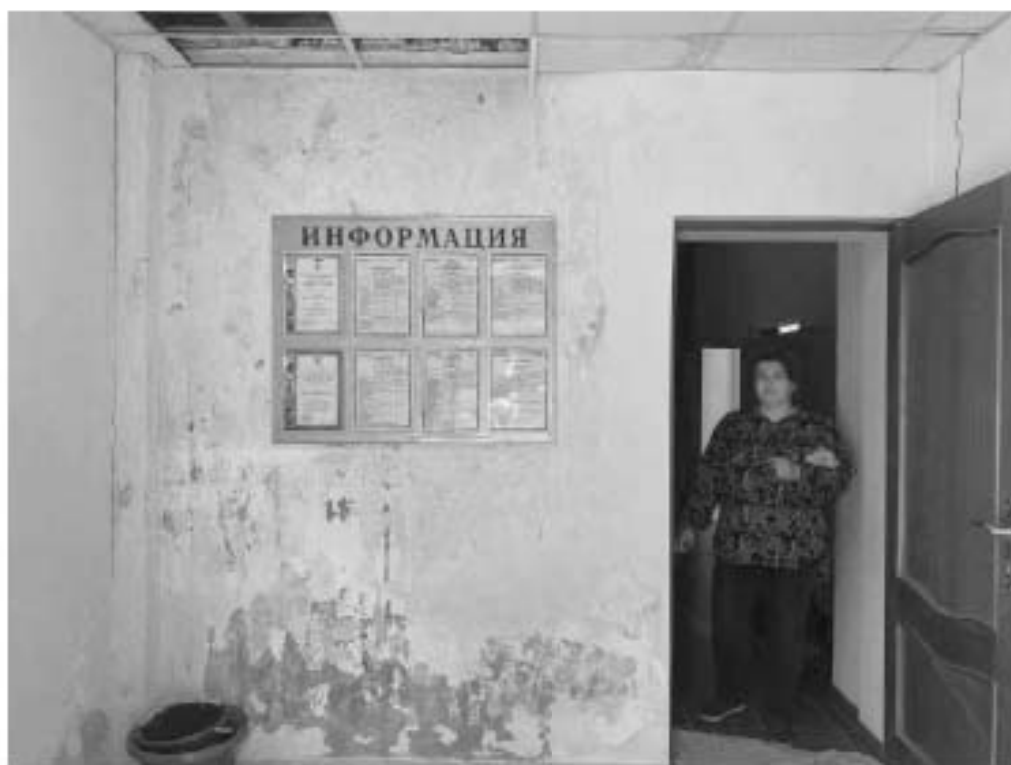
Фото №48. Тамбур одноэтажной пристройки.
