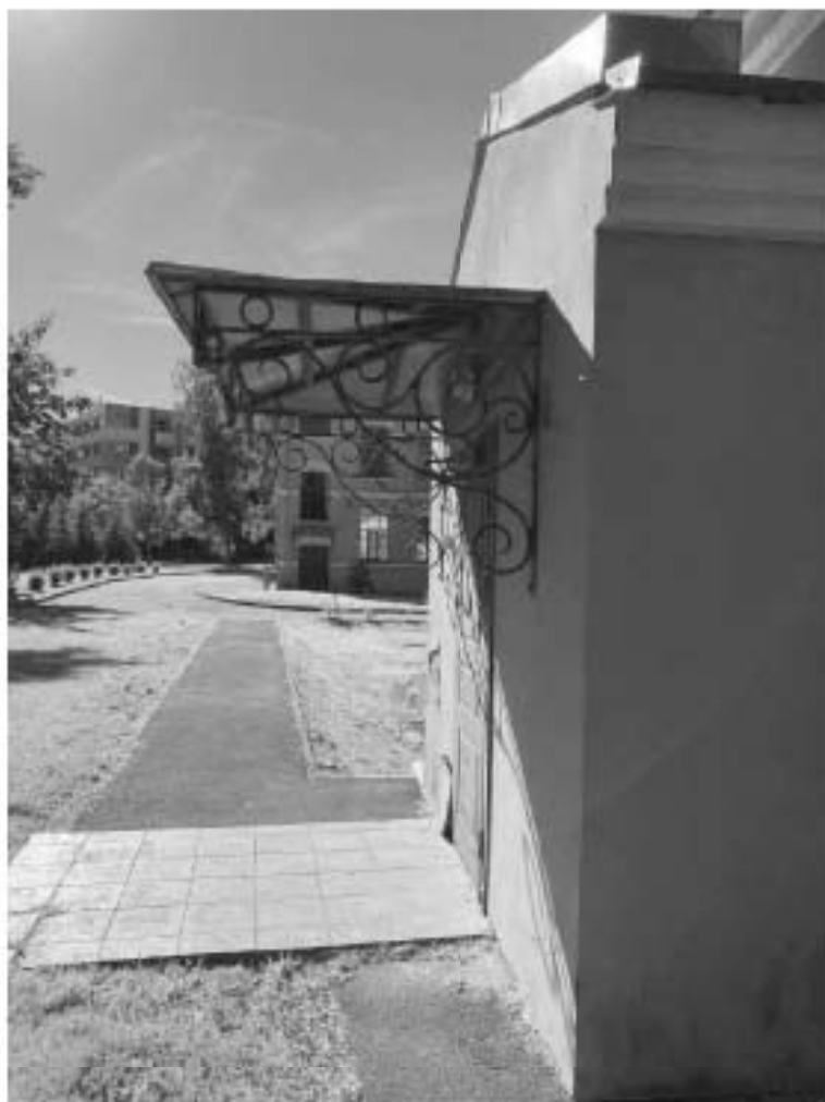
Фото №3. Вход в одноэтажную пристройку с южной стороны в осях 7-8.
