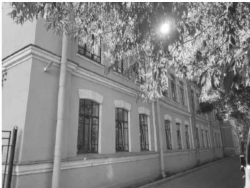
Фото №7. Северный фасад здания в осях 1-5.
