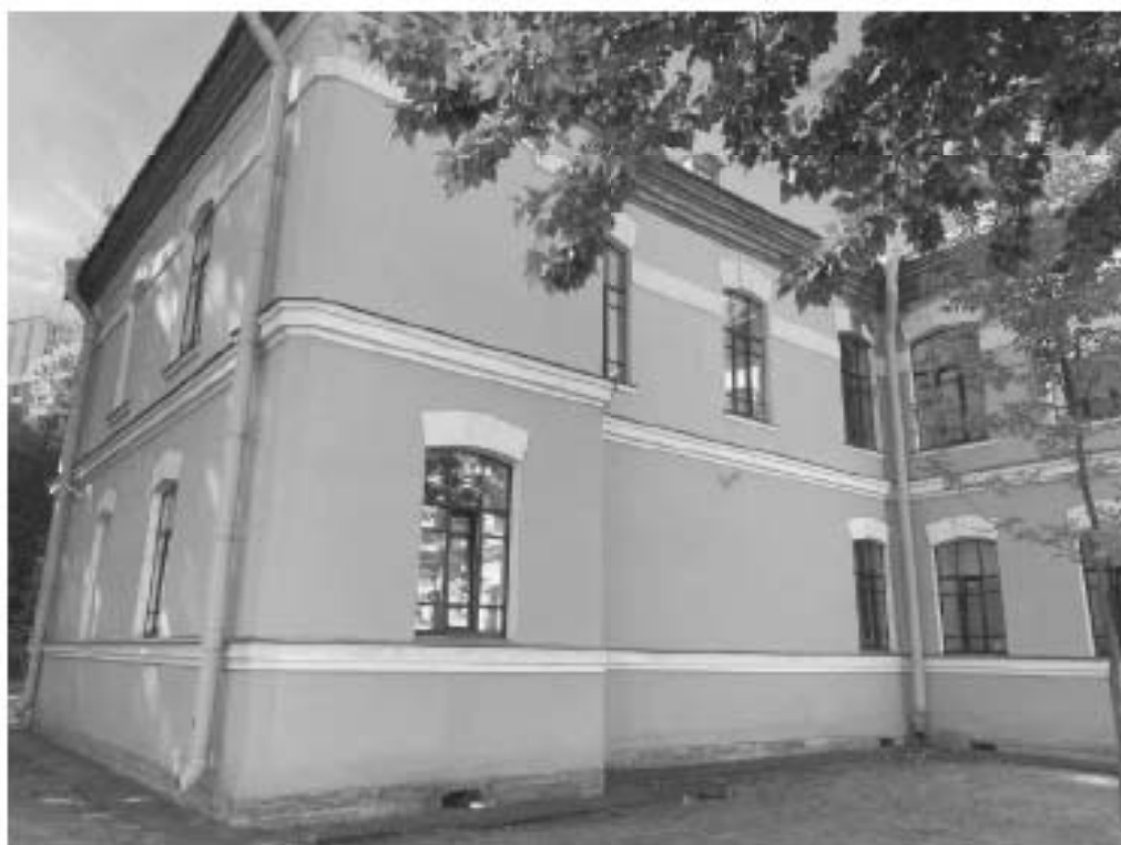
Фото №12. Юго-западный двор здания. Восточный фасад здания в осях Г-Е.
