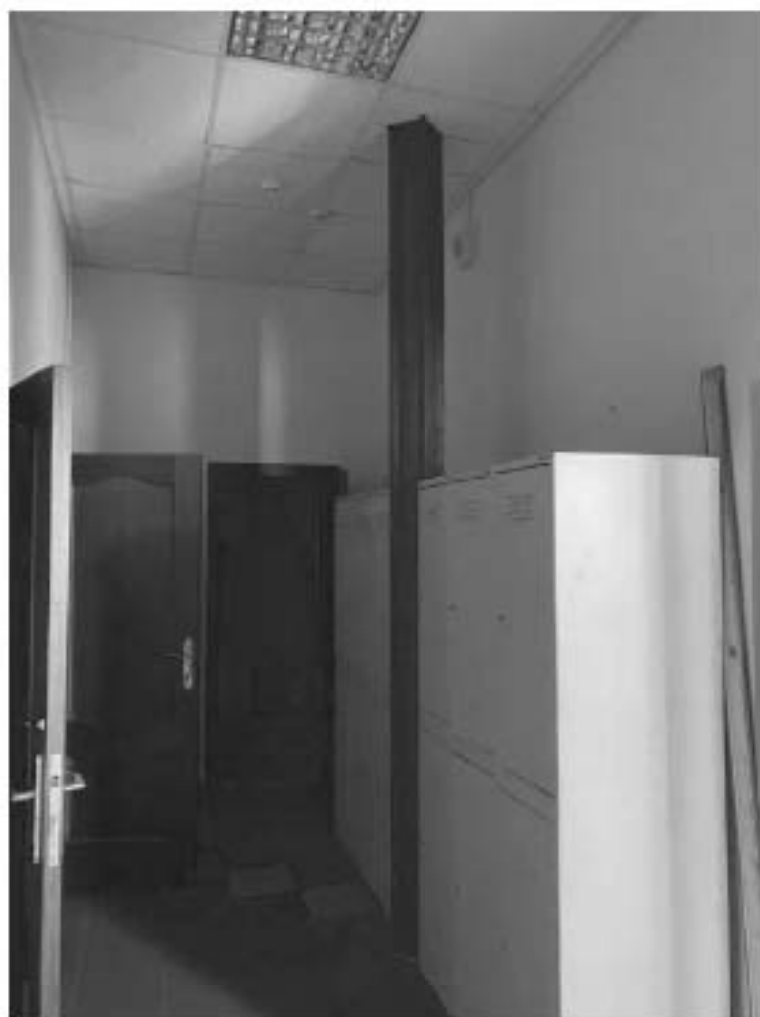
Фото №49. Историческая металлическая несущая конструкция в одноэтажной пристройке.
