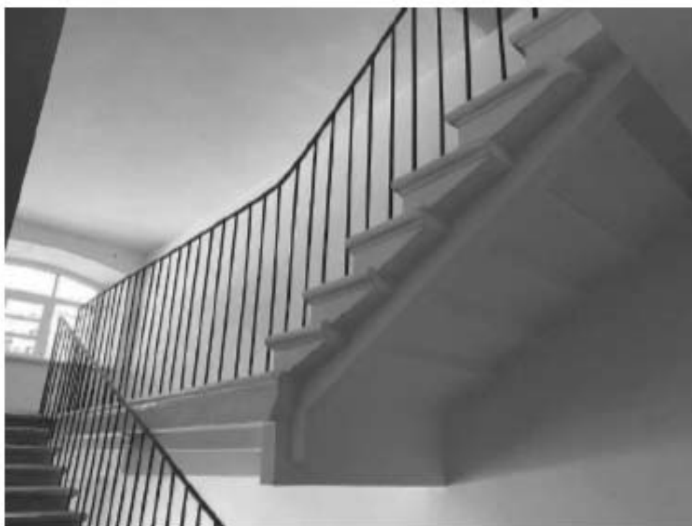
Фото №45. Запасная лестница центрального корпуса в осях 3-5, вид с площадки 2 этажа, лестница на чердак.
