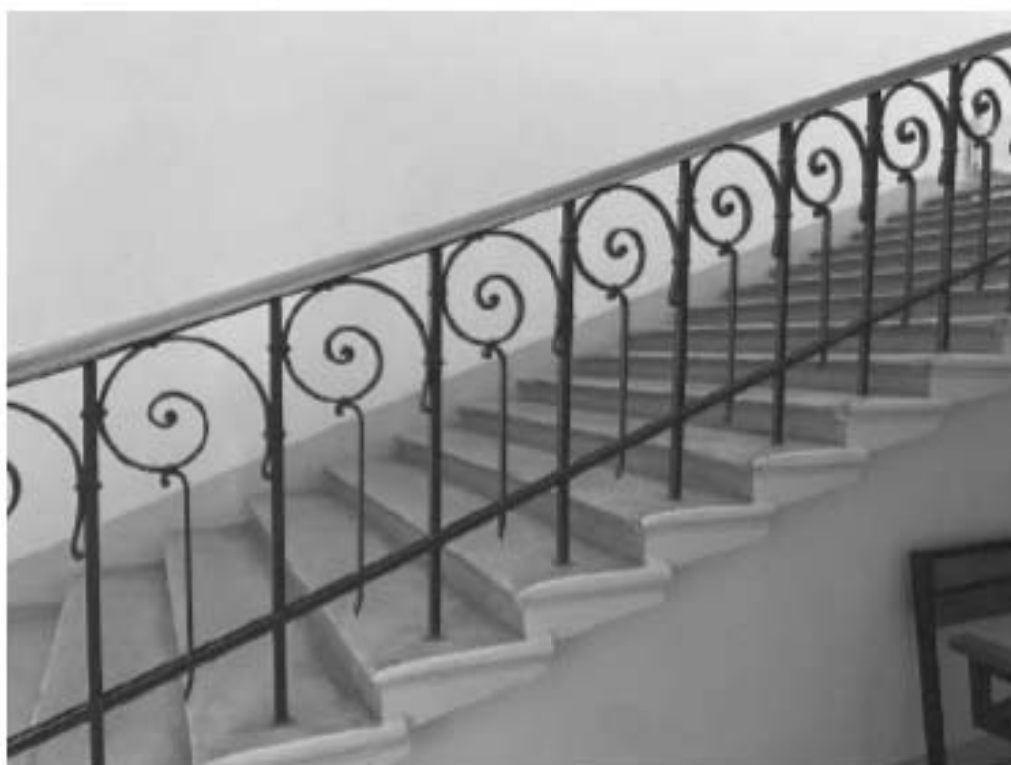
Фото №29. Ограждение главной лестницы, отреставрированы.
