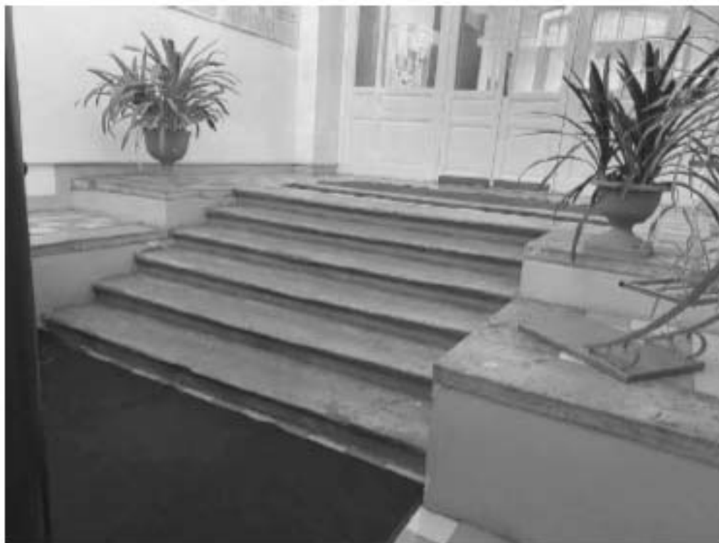
Фото №23. Лестница в парадном вестибюле.
