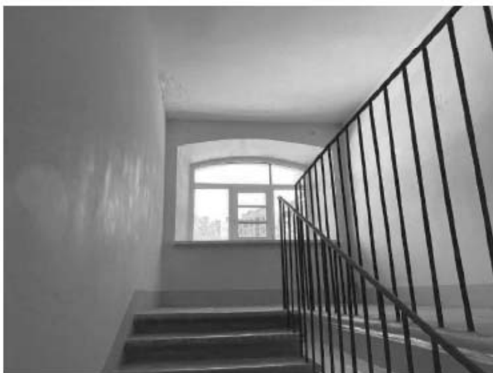
Фото №44. Запасная лестница центрального корпуса в осях 3-5, вид с площадки 2 этажа.
