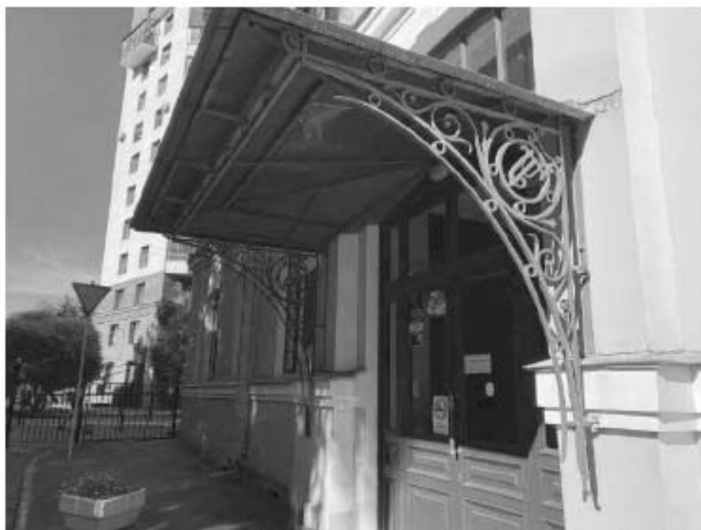
Фото №10. Исторический металлодекор козырек парадного входа.
