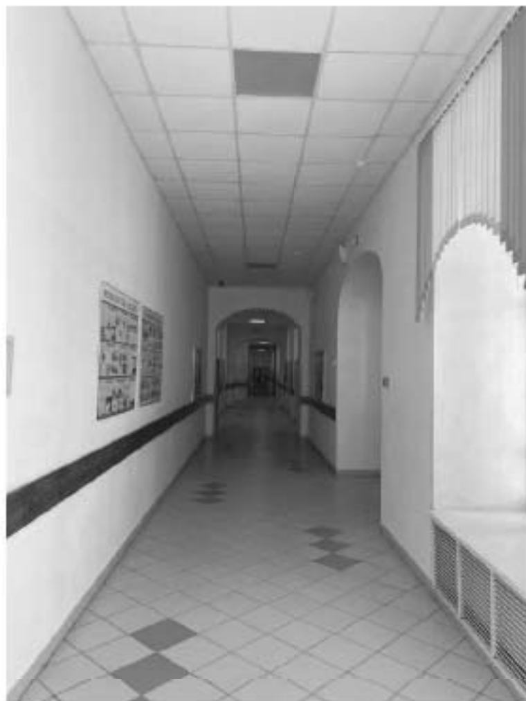
Фото №35. Вестибюль второго этажа корпуса в осях А-Е.
