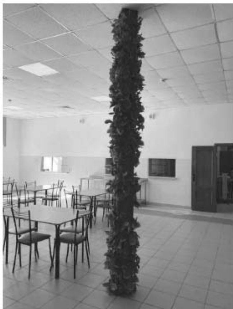
Фото №47. Историческая металлическая несущая конструкция в столовой первого этажа.
