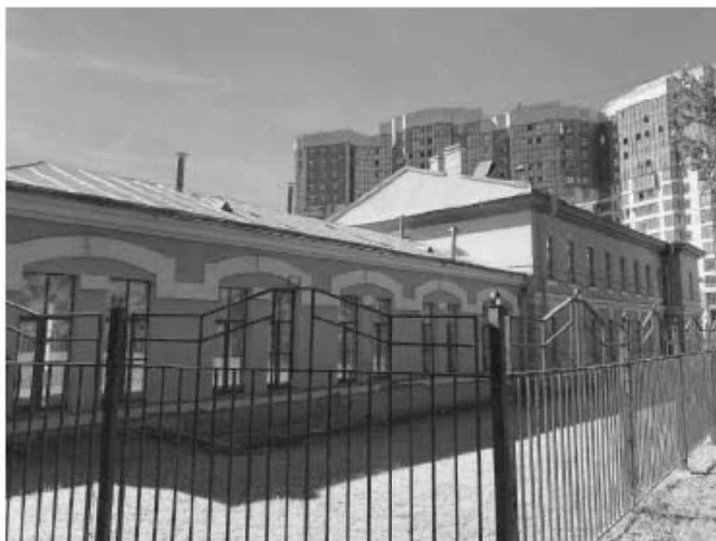
Фото №2. Восточный фасад здания в осях Б-Е.
