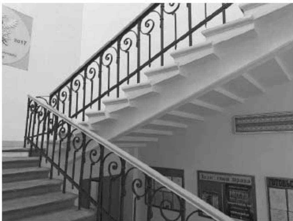
Фото №30. Главная лестница, ограждение.
