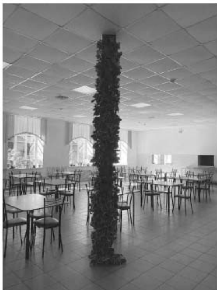
Фото №46. Историческая металлическая несущая конструкция в столовой первого этажа.
