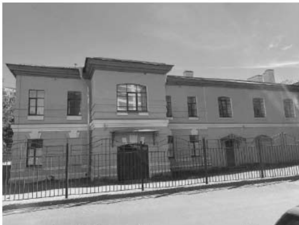
Фото №4. Северный фасад здания в осях 6-8.
