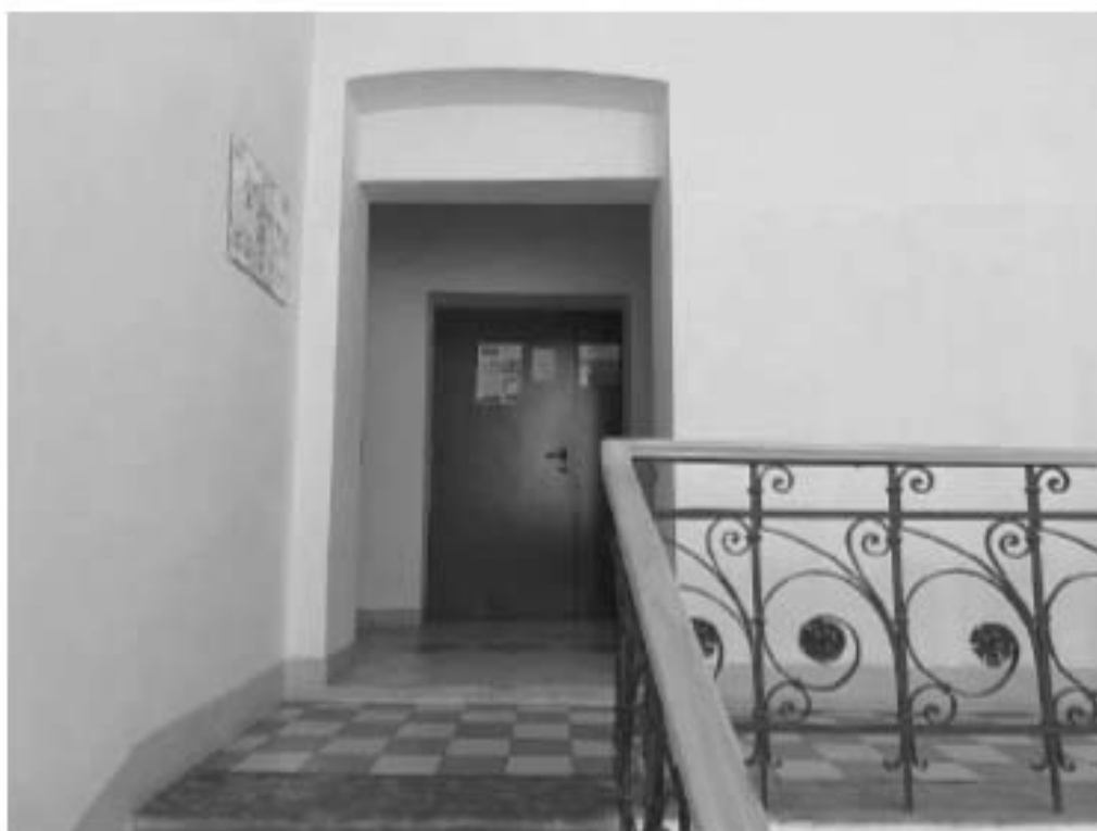
Фото №37. Лестница восточного корпуса в осях 7-8, площадка второго этажа, исторический проем.
