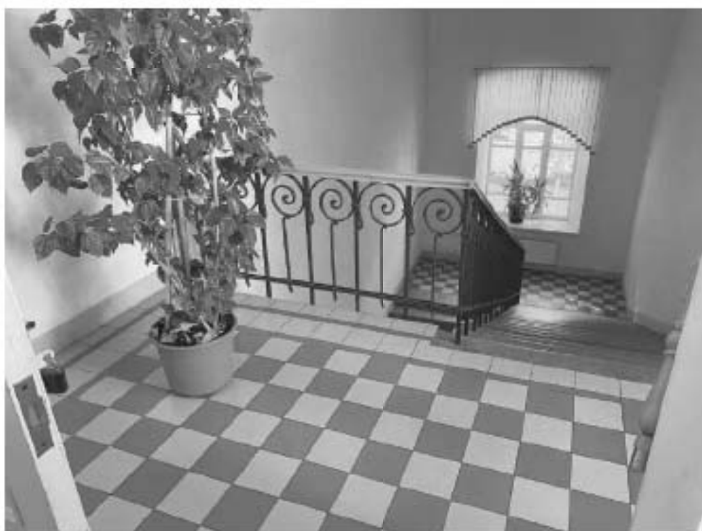
Фото №40. Главная лестница центрального корпуса в осях 3-4, площадка второго этажа.
