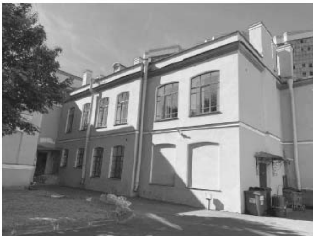
Фото №18. Юго-восточный двор здания, закладка окон южного фасада в осях 4-6.
