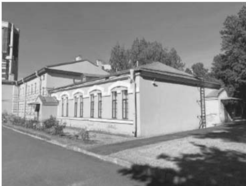
Фото №17. Юго-восточный двор здания, западный фасад здания в осях Б-Д, одноэтажная пристройка.
