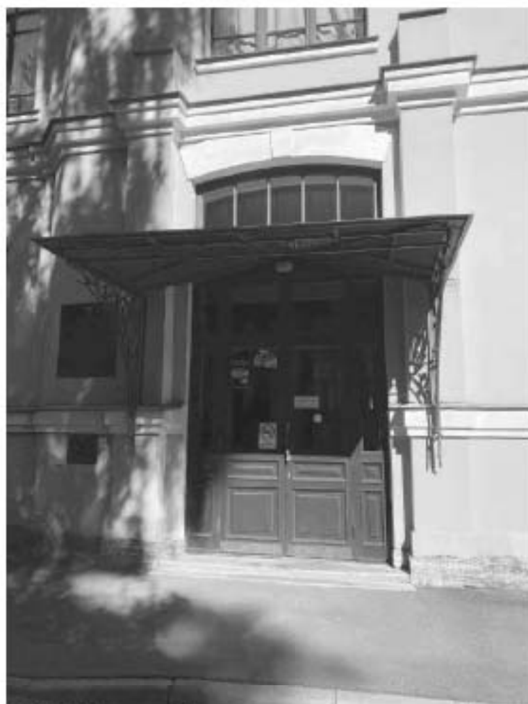
Фото №9. Парадный вход в здание с западной стороны.
