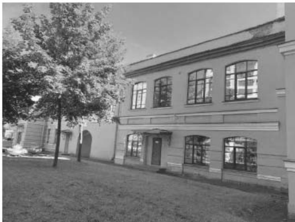
Фото №6. Северный фасад здания в осях 5-8.
