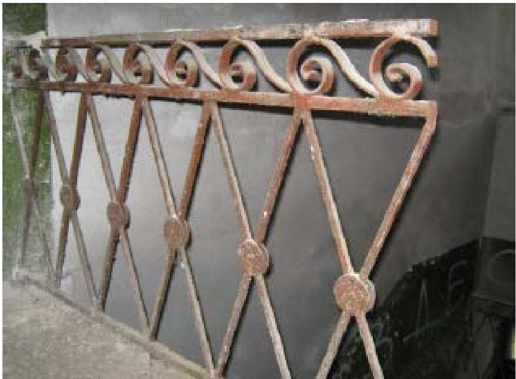
13. Ограждение лестничных маршей в помещении 7-Н. 03.06.2022
