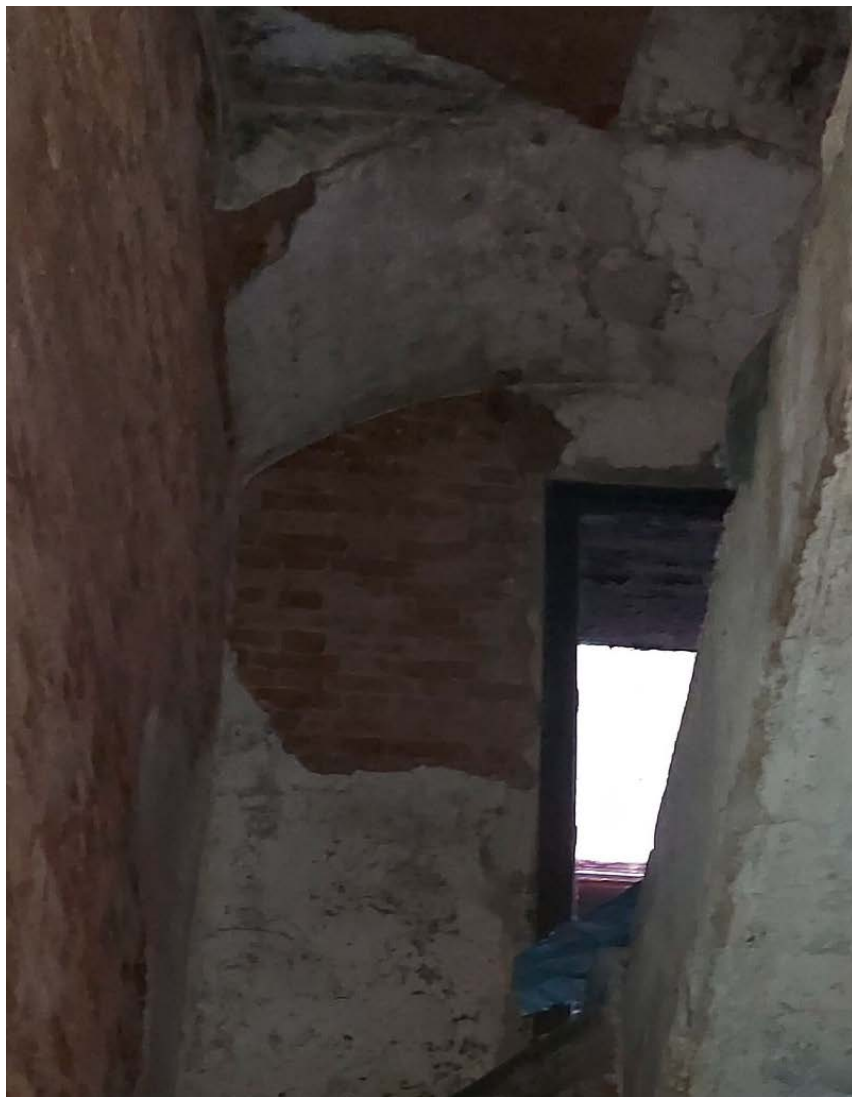
11. Своды над межэтажной лестничной площадкой лестницы ЛК-1. 03.06.2022
