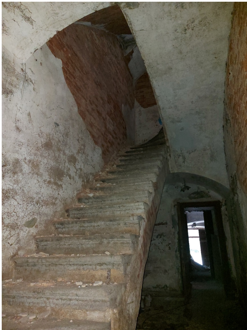
10. Лестница ЛК-1 в южной части здания. 03.06.2022
