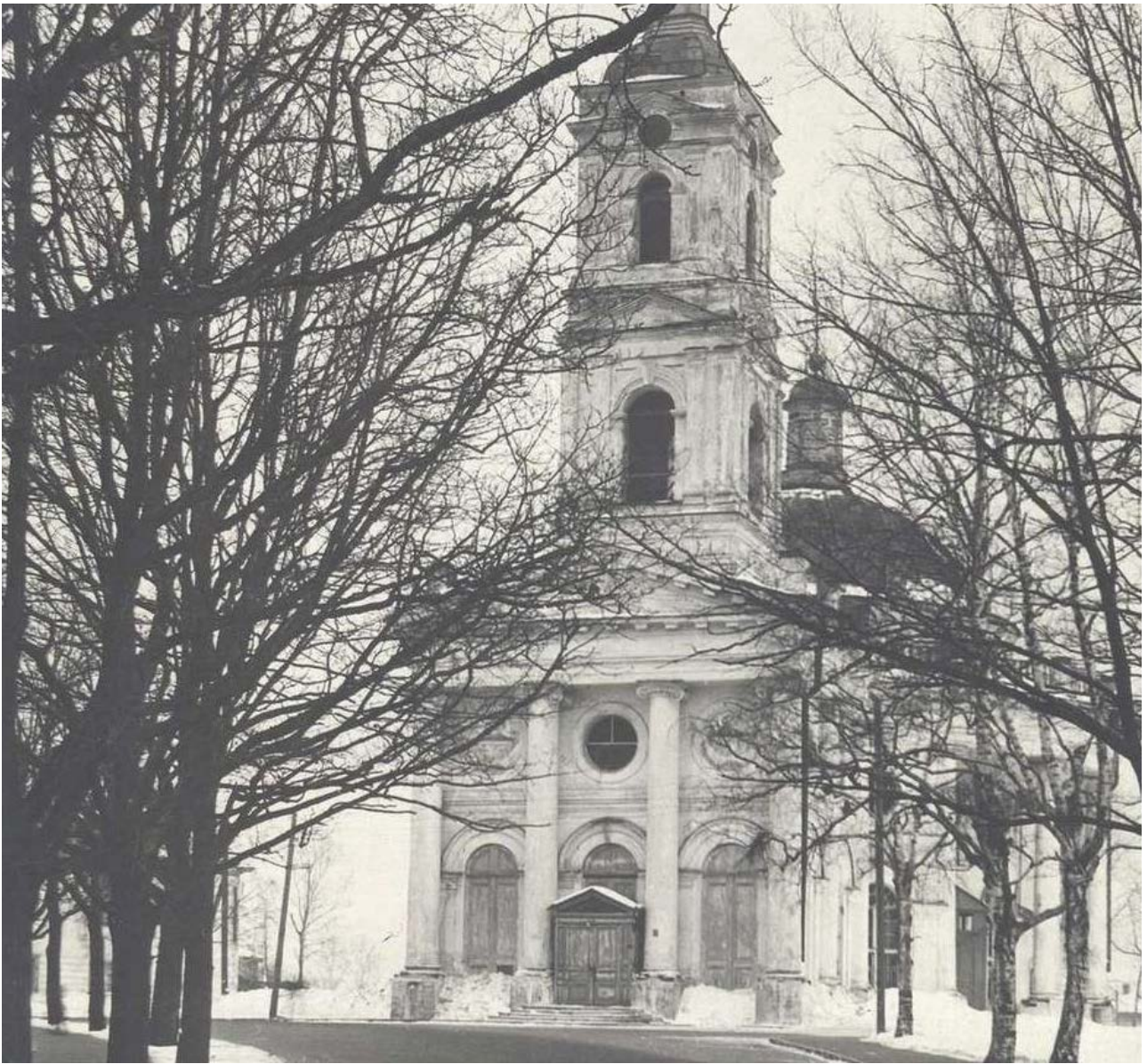
15. Церковь Пророка Илии на Пороховых. Колокольня. Март 1941 г. Фрагмент фото. Проект «Наследие окраин». Красногвардейский район // https://kgiop.gov.spb.ru/deyatelnost/populyarizaciya/iz-arhivnogo-sobraniya-kgiop/proekt-nasledie-okrain-krasnogvardejskij-rajon/
