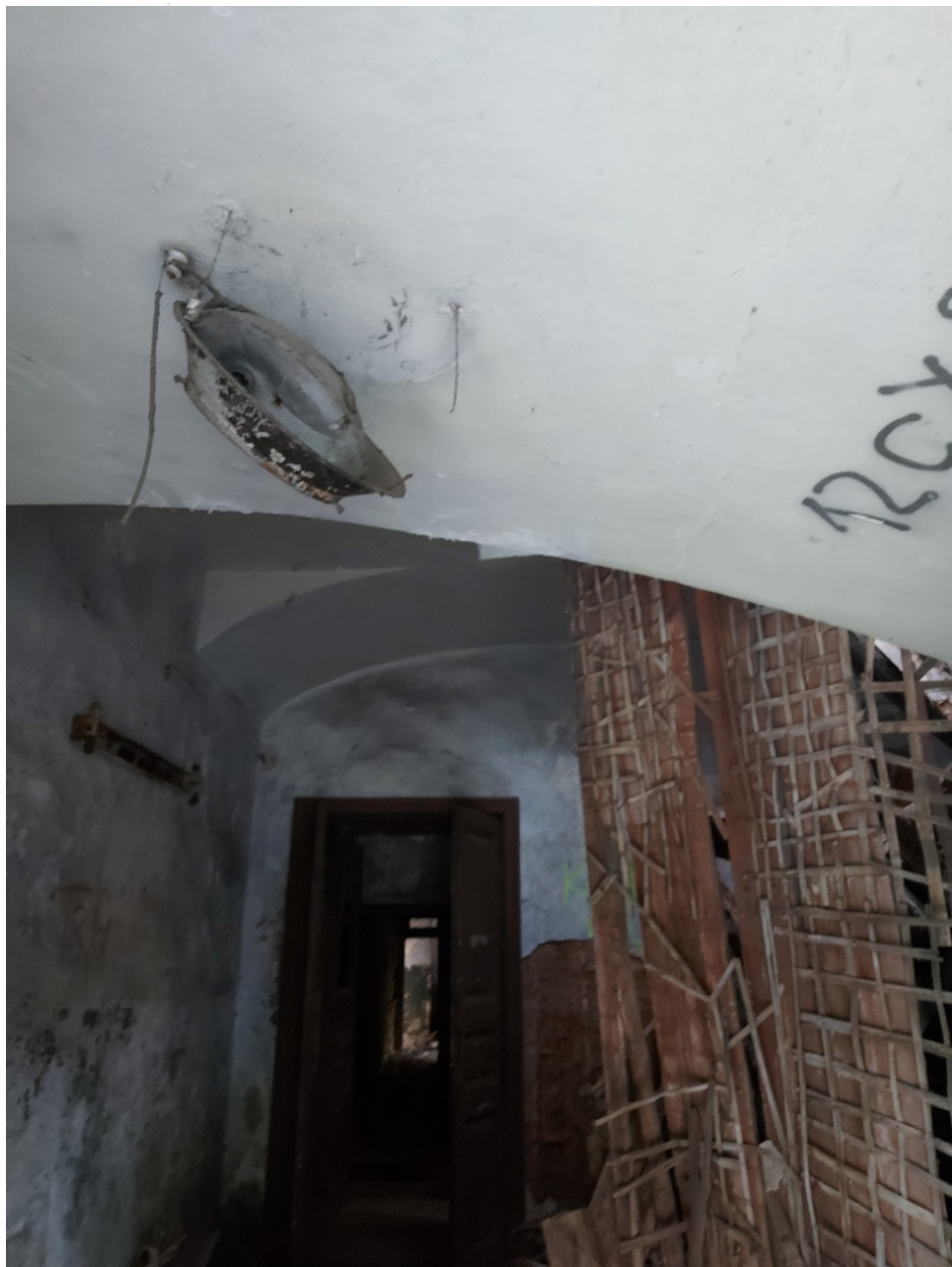
12. Лестничные марши в помещении 7-Н. 03.06.2022
