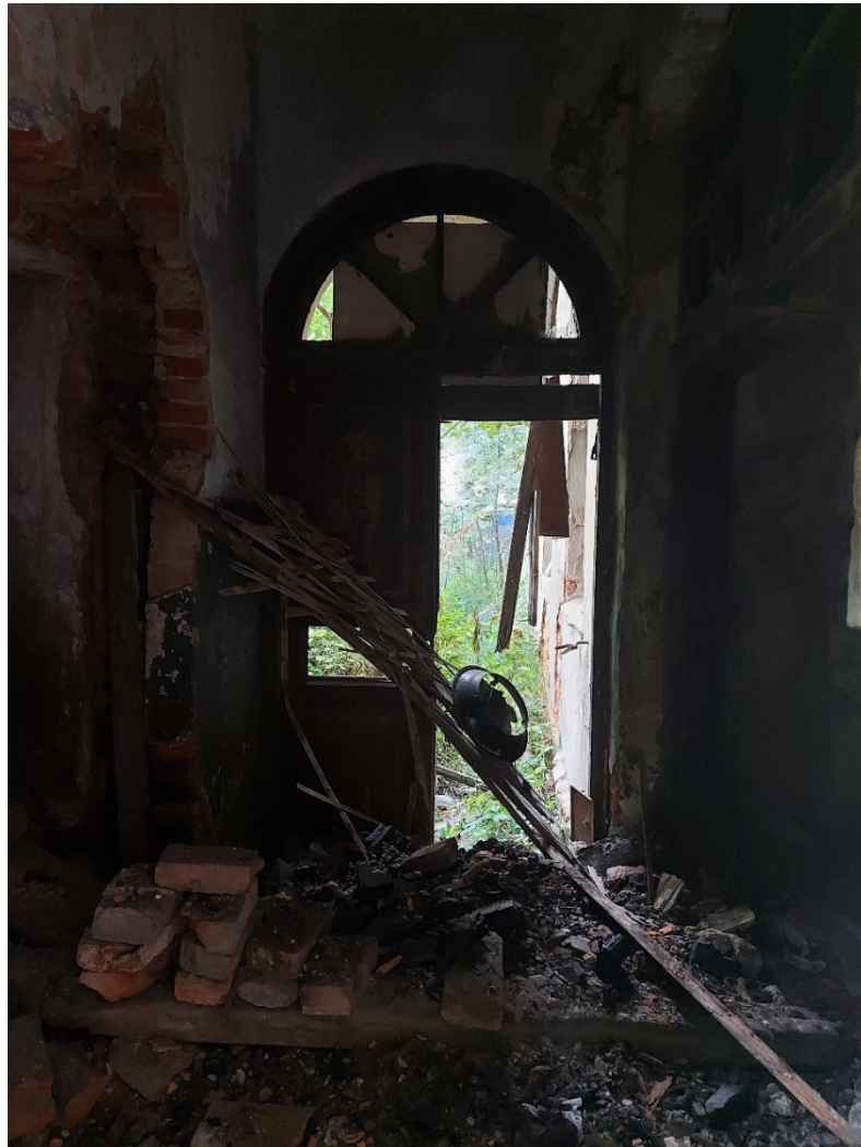
9. Помещение ЛК-1 (I) в уровне 1-го этажа ризалита южного (дворового) фасада. 03.06.2022
