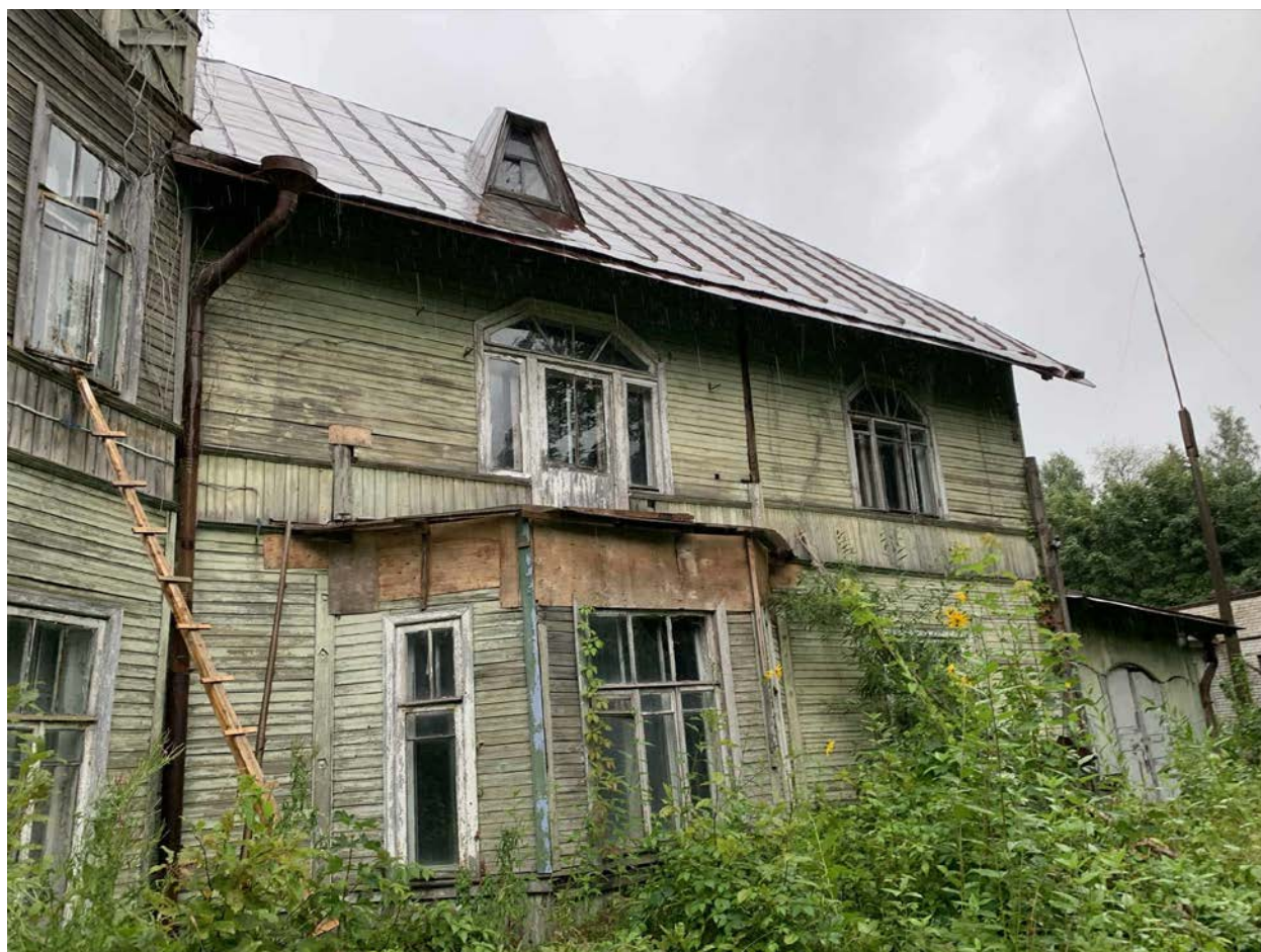
8. Вид западного фасада. 03.06.2022
