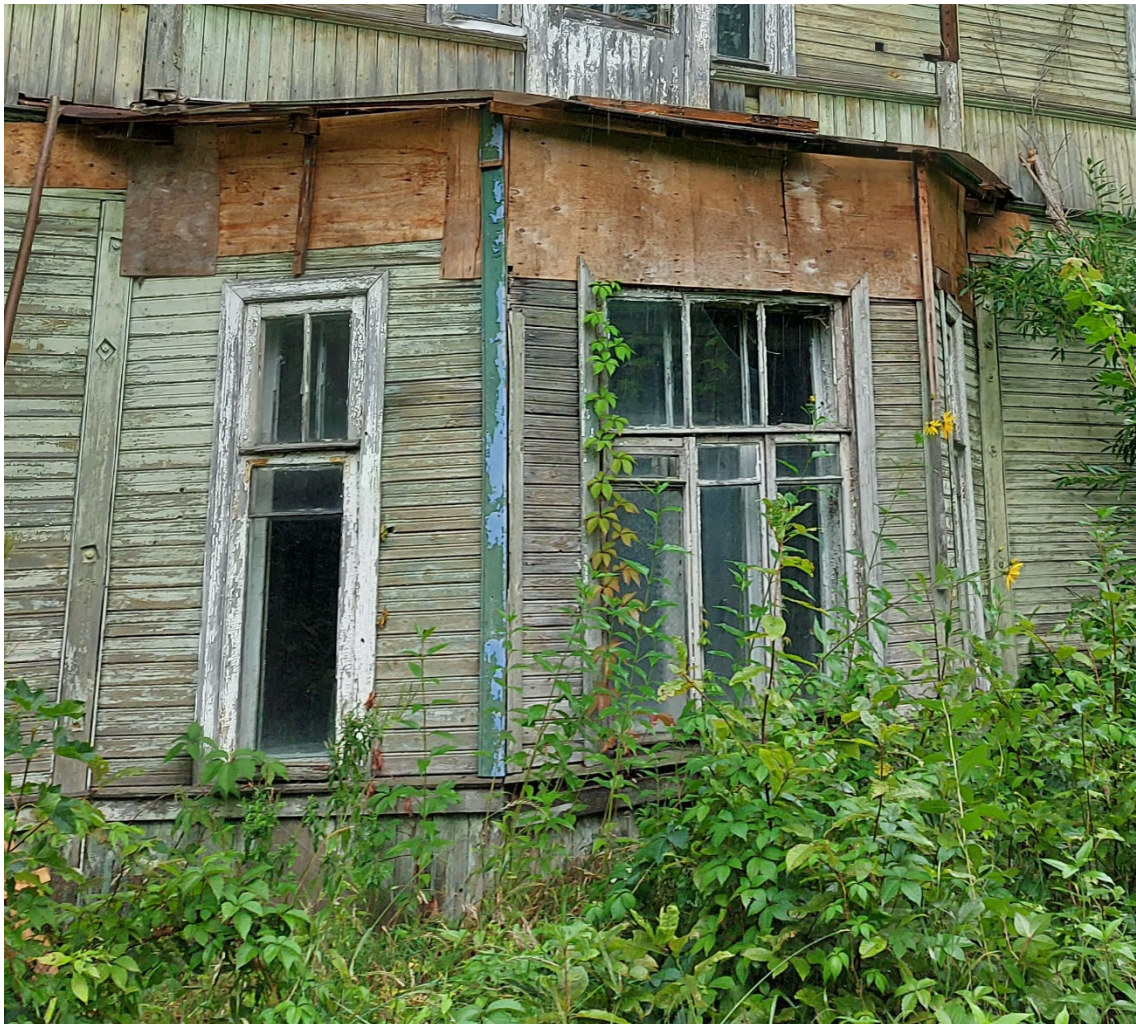
9. Вид на одноэтажный эркер западного фасада. 03.06.2022
