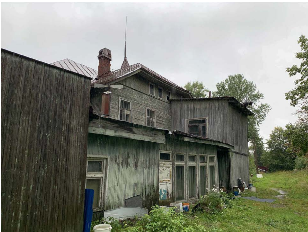
1. Вид на восточный фасад выявленного объекта культурного наследия «Дача Ф.Ю. Кана», расположенного по адресу: г. г. Санкт-Петербург, Сестрорецк, Малая Горская, ул., д. 32, литера А. 03.06.2022
