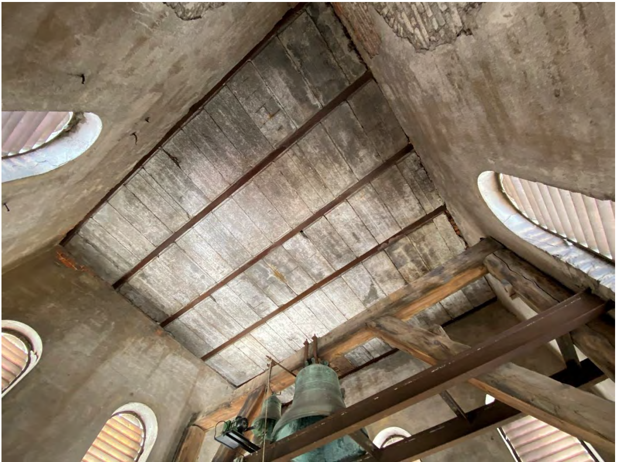
Фото 10. Помещение 2ЛК(7) в восточной башне храма.
