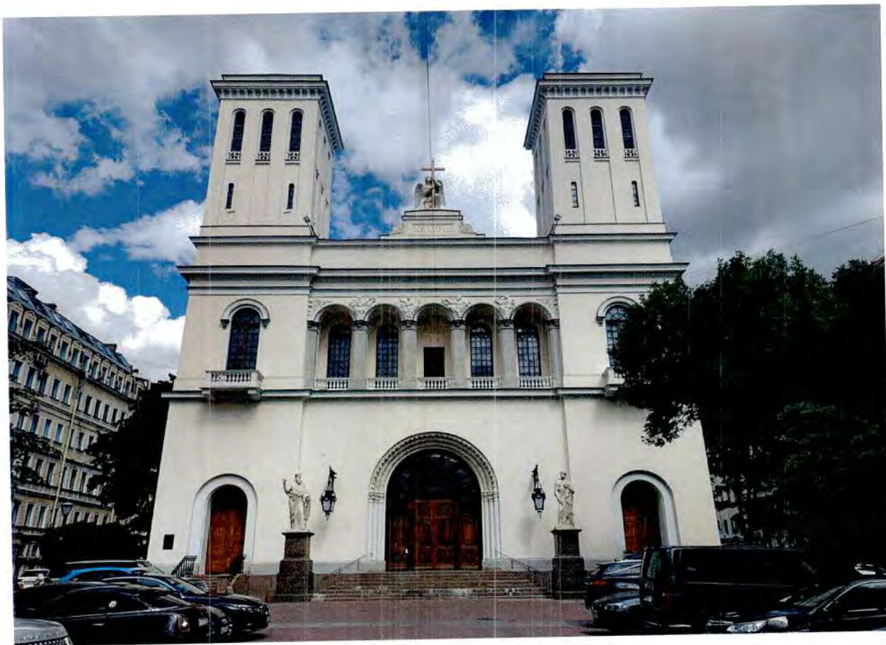
1. Вид на южный фасад.
