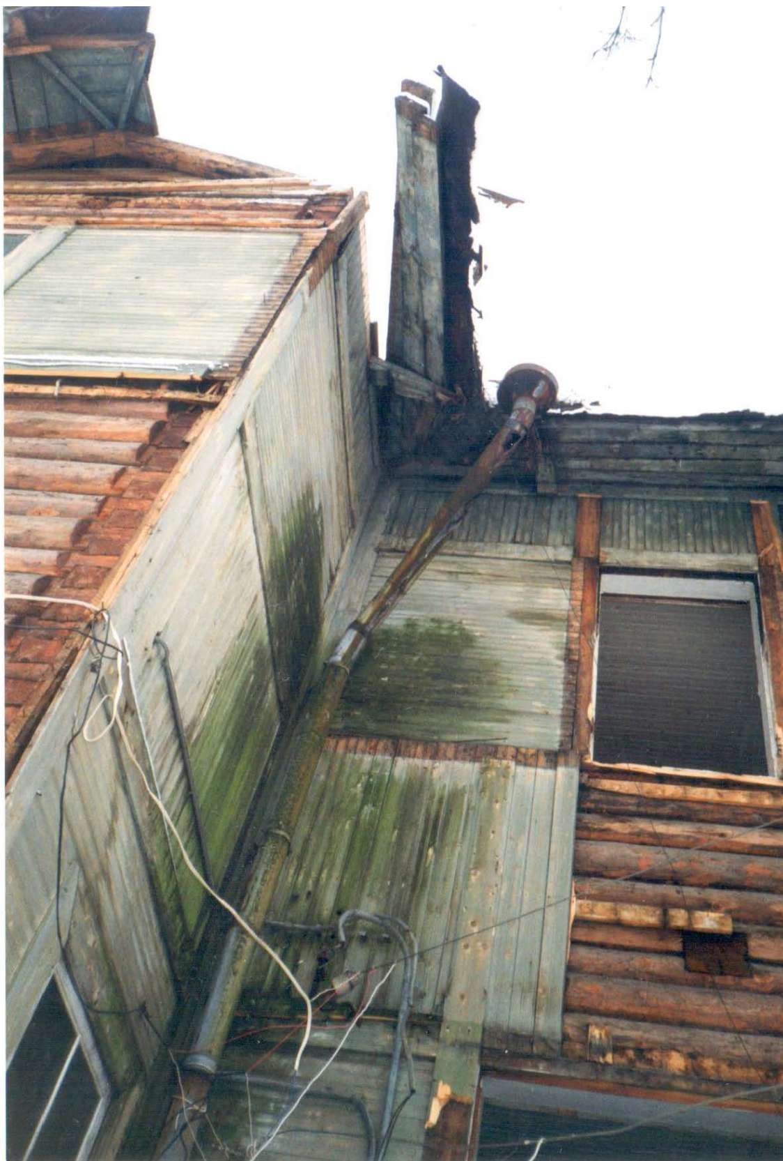
46. Натурные исследования дачи Н.В. Граве по ул. Софийской, 11 в Санкт-Петербурге. СПб., 1999. (архив КГИОП).
