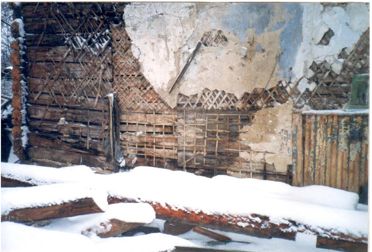
53. Натурные исследования дачи Н.В. Граве по ул. Софийской, 11 в Санкт-Петербурге. СПб., 1999. (архив КГИОП).
