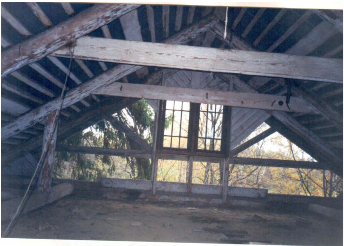
42. Натурные исследования дачи Н.В. Граве по ул. Софийской, 11 в Санкт-Петербурге. СПб., 1999. (архив КГИОП).
