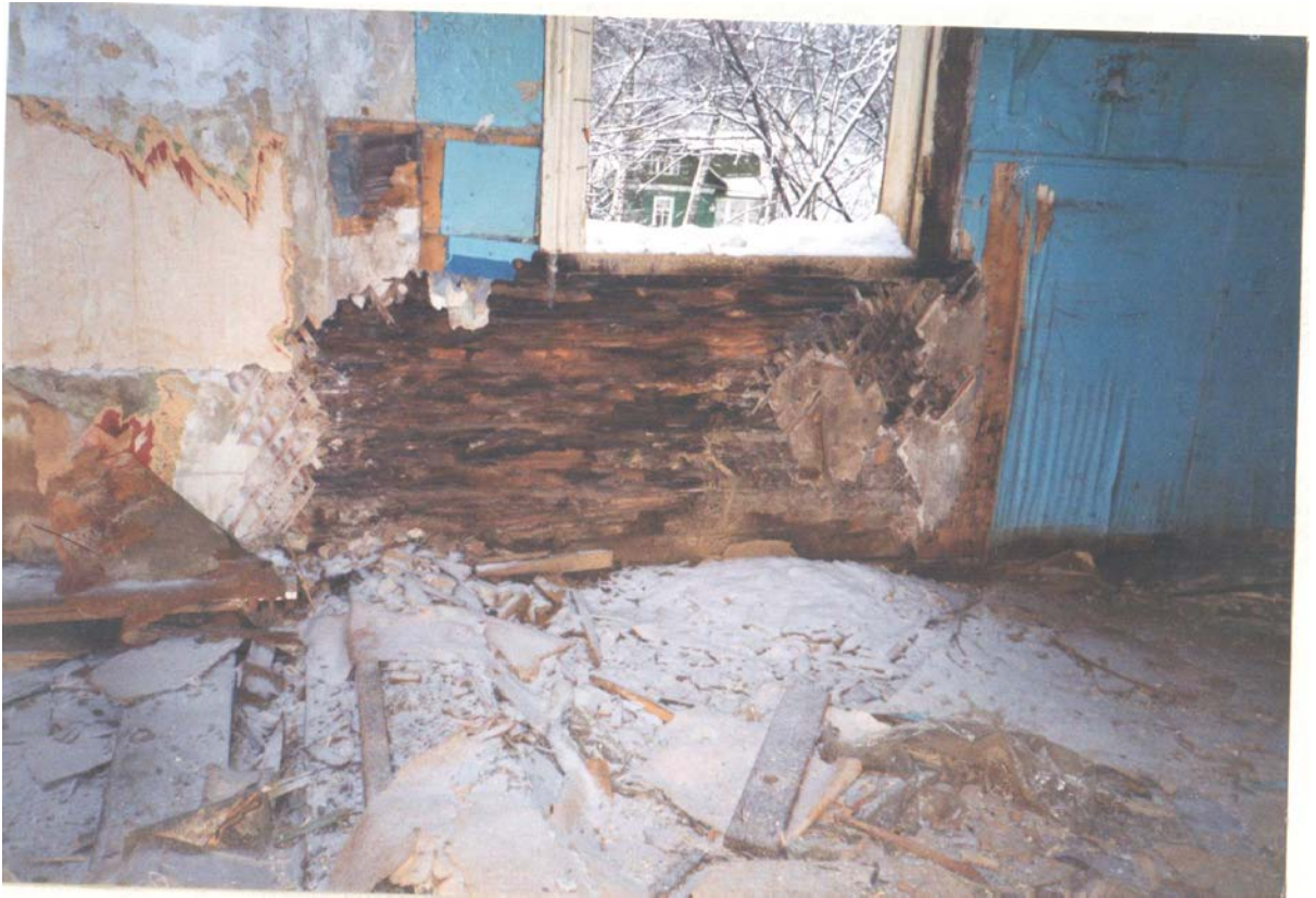
57. Натурные исследования дачи Н.В. Граве по ул. Софийской, 11 в Санкт-Петербурге. СПб., 1999. (архив КГИОП).
