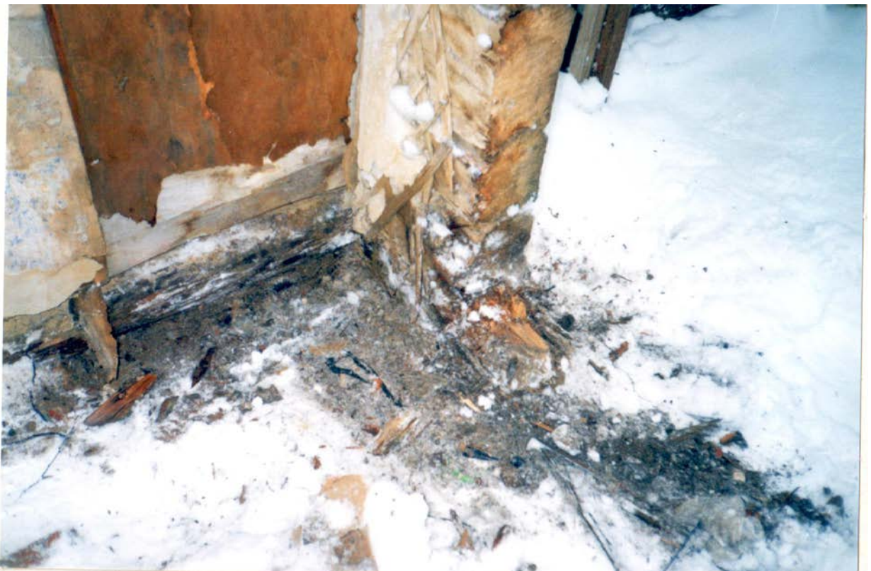
51. Натурные исследования дачи Н.В. Граве по ул. Софийской, 11 в Санкт-Петербурге. СПб., 1999. (архив КГИОП).
