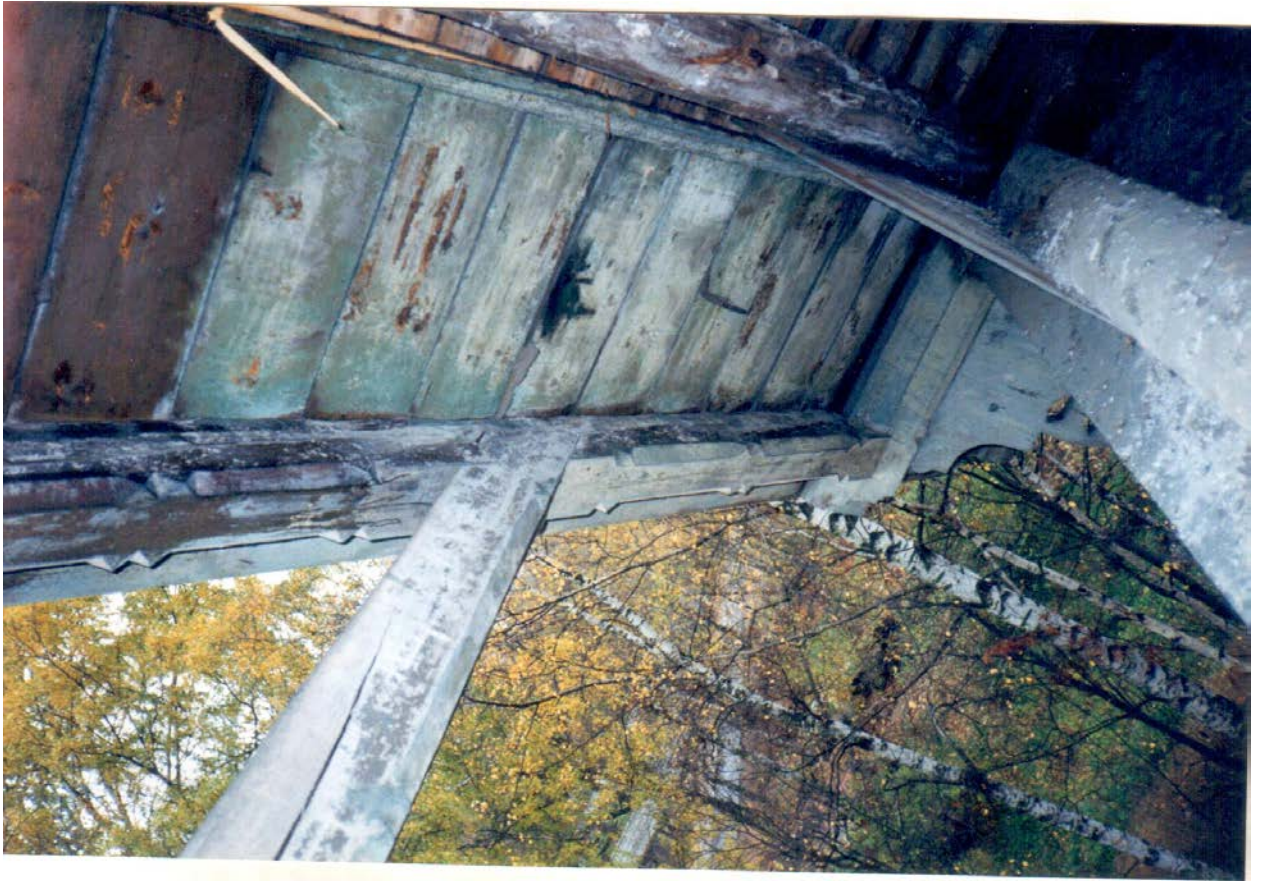
44. Натурные исследования дачи Н.В. Граве по ул. Софийской, 11 в Санкт-Петербурге. СПб., 1999. (архив КГИОП).
