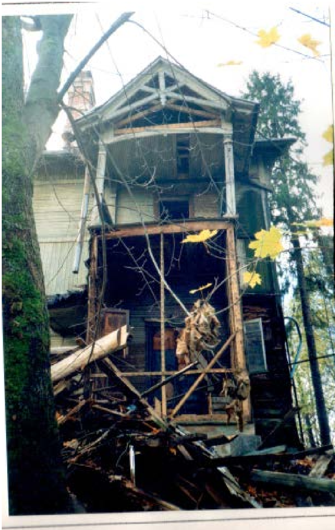
28. Натурные исследования дачи Н.В. Граве по ул. Софийской, 11 в Санкт-Петербурге. СПб., 1999. (архив КГИОП).
