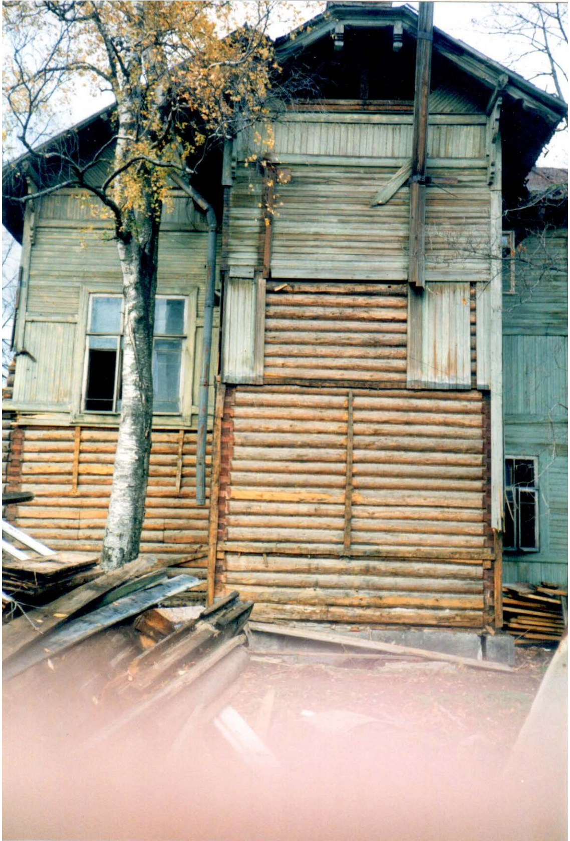
36. Натурные исследования дачи Н.В. Граве по ул. Софийской, 11 в Санкт-Петербурге. СПб., 1999. (архив КГИОП).
