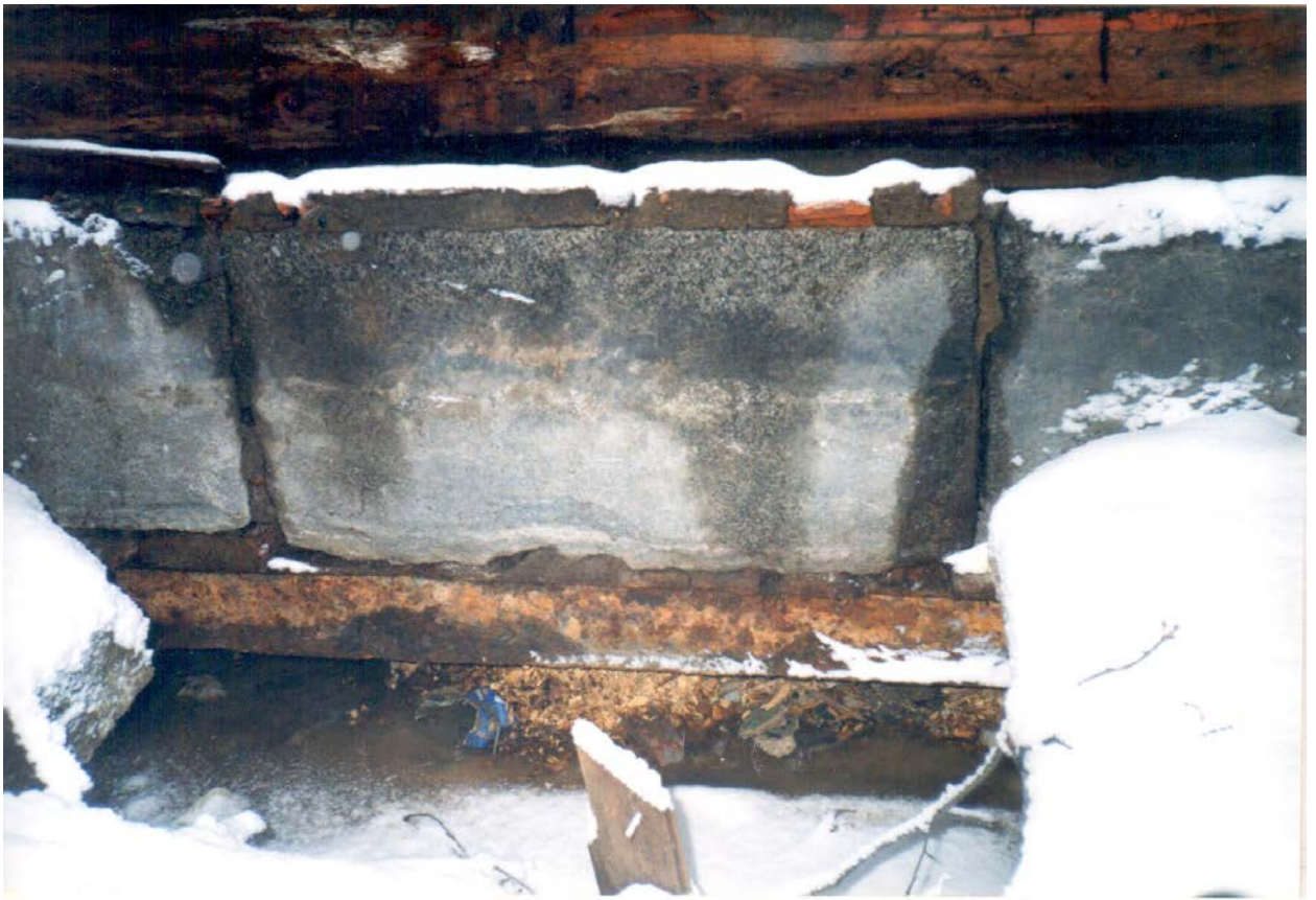
50. Натурные исследования дачи Н.В. Граве по ул. Софийской, 11 в Санкт-Петербурге. СПб., 1999. (архив КГИОП).
