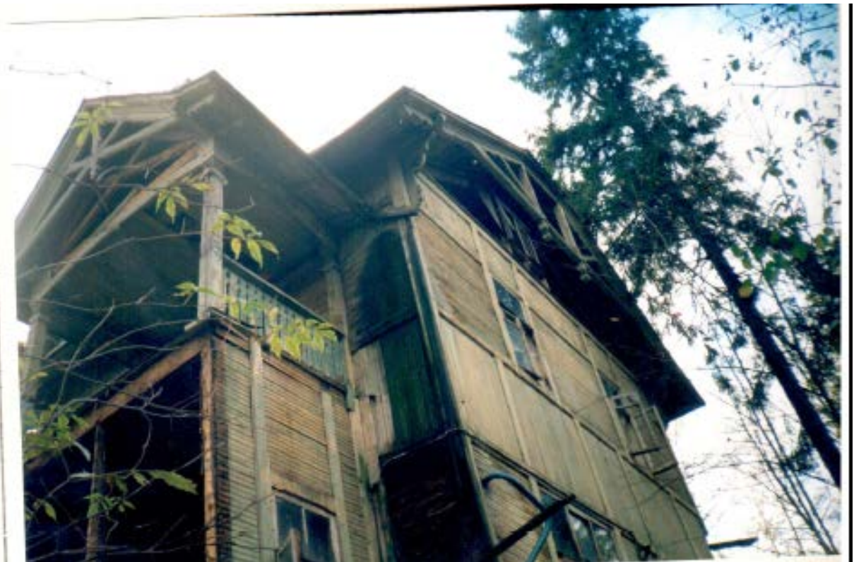
26. Натурные исследования дачи Н.В. Граве по ул. Софийской, 11 в Санкт-Петербурге. СПб., 1999. (архив КГИОП).
