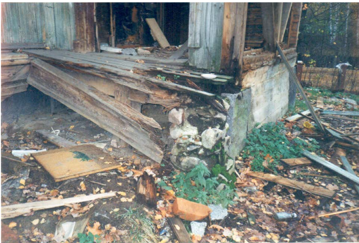
30. Натурные исследования дачи Н.В. Граве по ул. Софийской, 11 в Санкт-Петербурге. СПб., 1999. (архив КГИОП).
