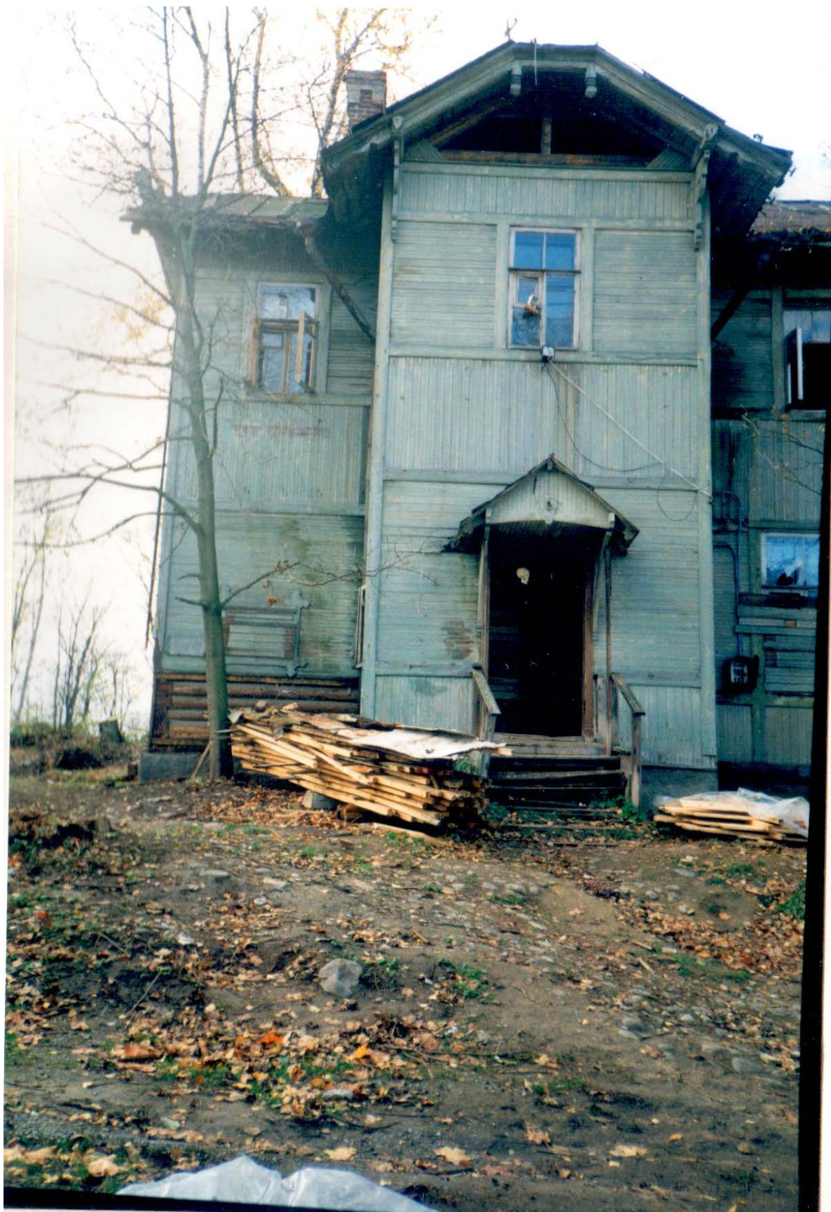
32. Натурные исследования дачи Н.В. Граве по ул. Софийской, 11 в Санкт-Петербурге. СПб., 1999. (архив КГИОП).
