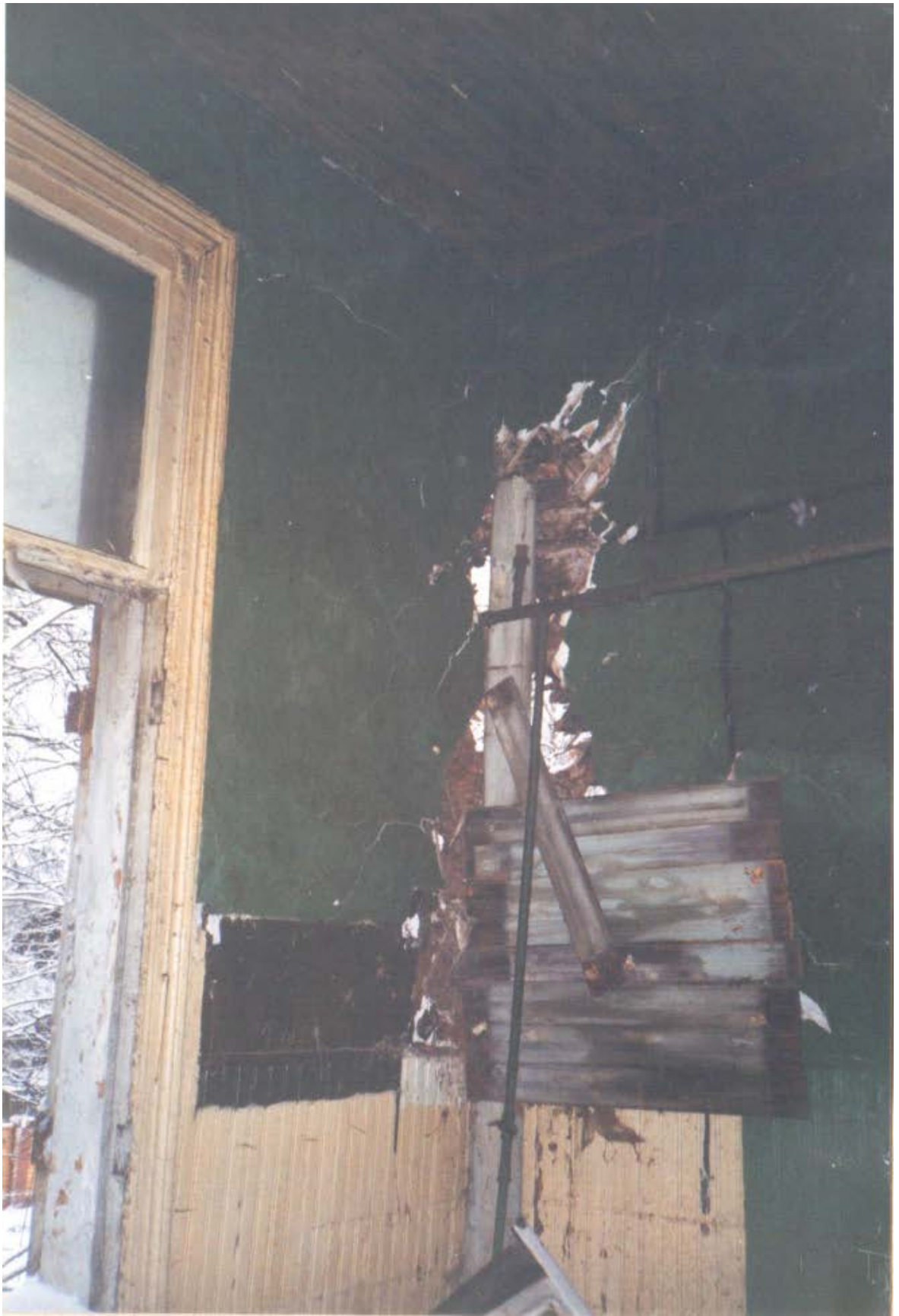
55. Натурные исследования дачи Н.В. Граве по ул. Софийской, 11 в Санкт-Петербурге. СПб., 1999. (архив КГИОП).
