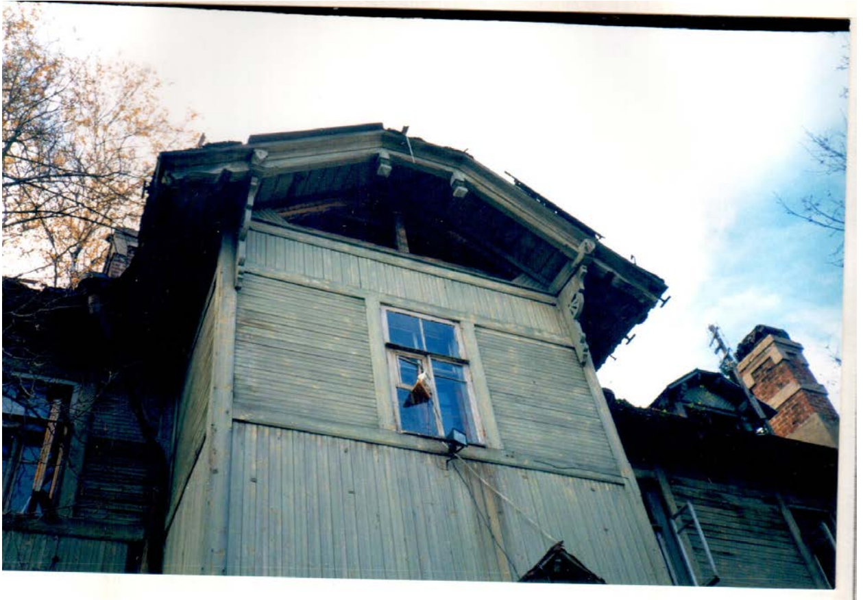
33. Натурные исследования дачи Н.В. Граве по ул. Софийской, 11 в Санкт-Петербурге. СПб., 1999. (архив КГИОП).
