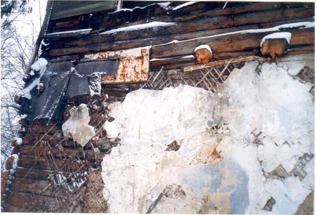
52. Натурные исследования дачи Н.В. Граве по ул. Софийской, 11 в Санкт-Петербурге. СПб., 1999. (архив КГИОП).
