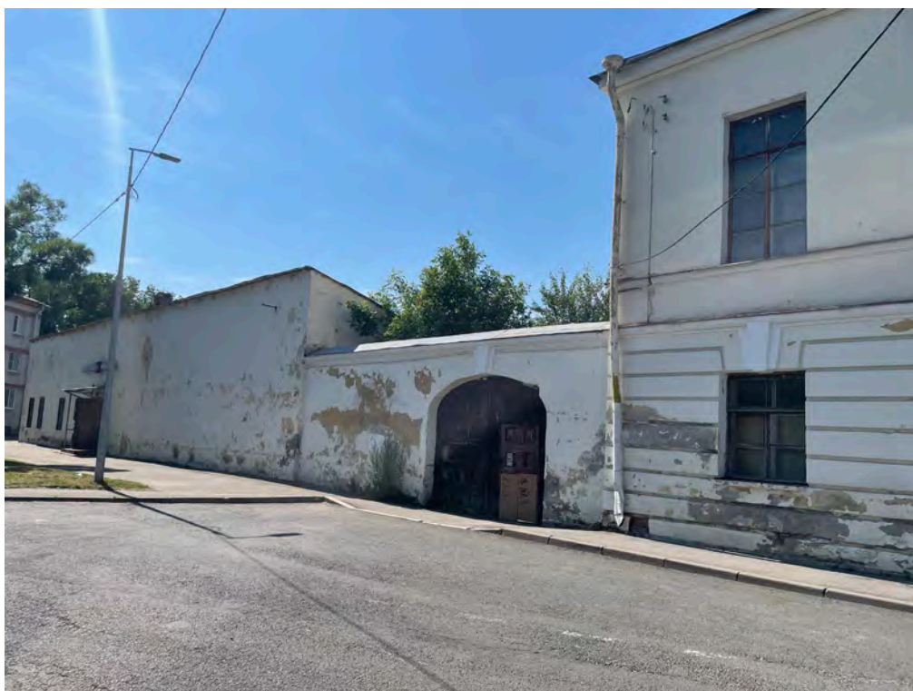
Фото №12. Здание почты вдоль западной границы территории объекта.
