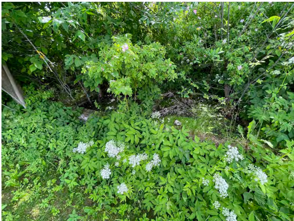
Фото №5. Бетонные конструкции (фундаменты?) вдоль северной границы территории, в направлении с севера на юг.
