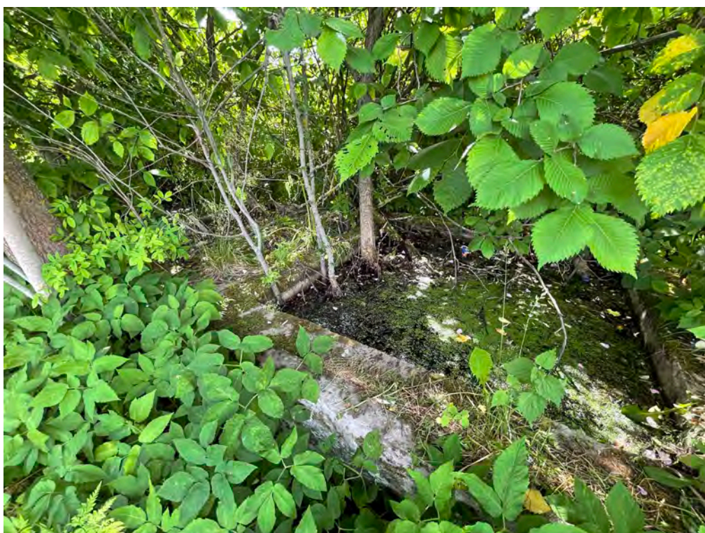
Фото №6. Бетонные конструкции (фундаменты?) вдоль северной границы территории, вид с севера на юг.
