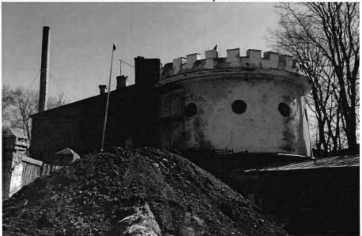
Фото 10. Часть западного фасада. Западная башенная пристройка.
