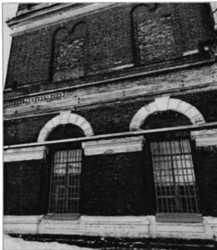
9. Фрагмент западного фасада. Вид с территории объекта.
