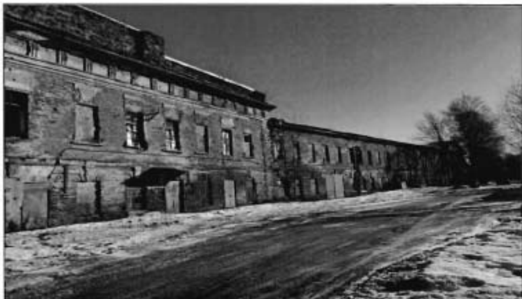
2. Фасад по улице Восстания.
