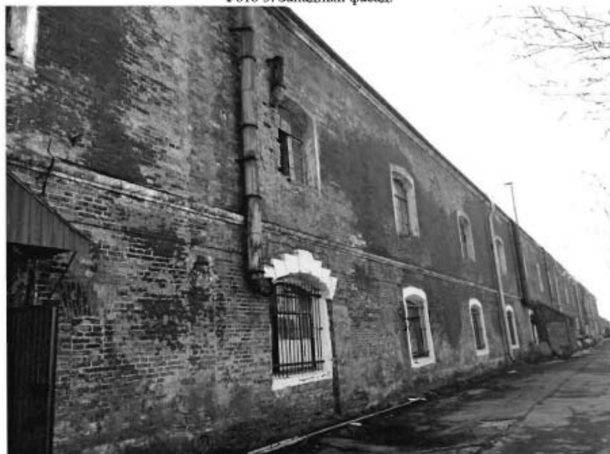
Фото 4. Часть северного фасада.
