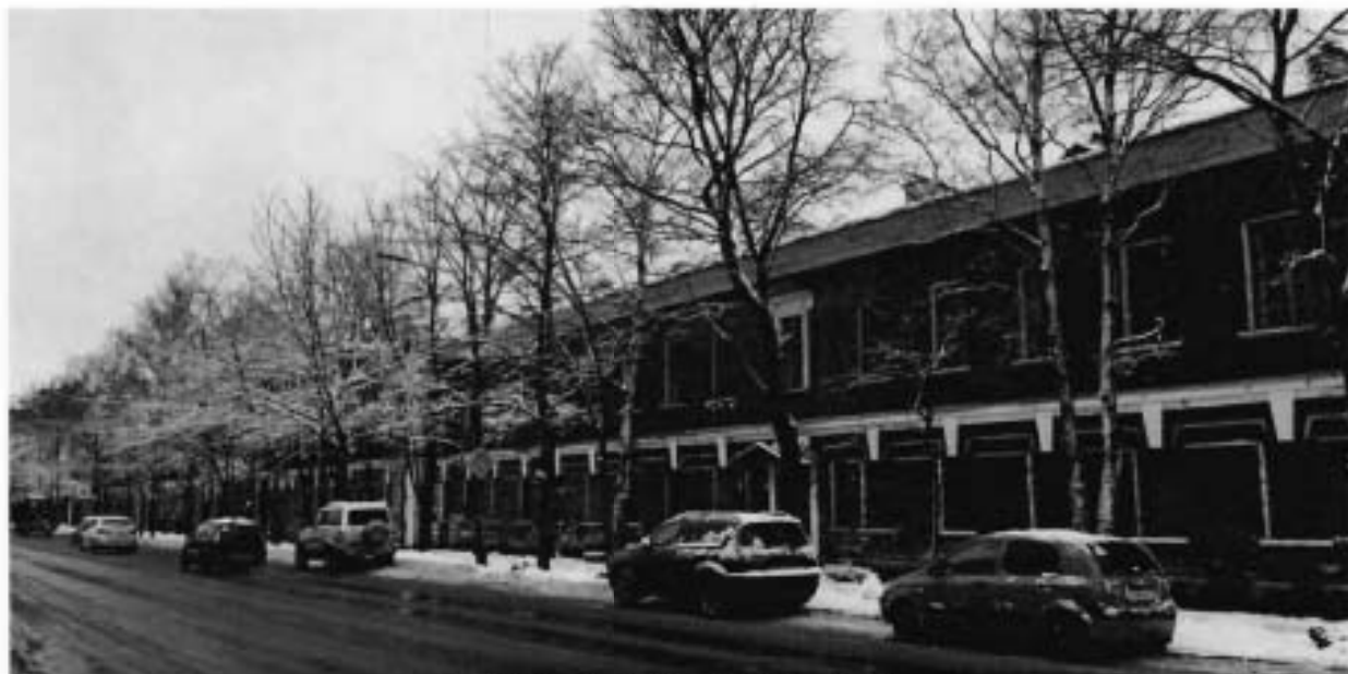
Фото 6. Часть южного фасада.
