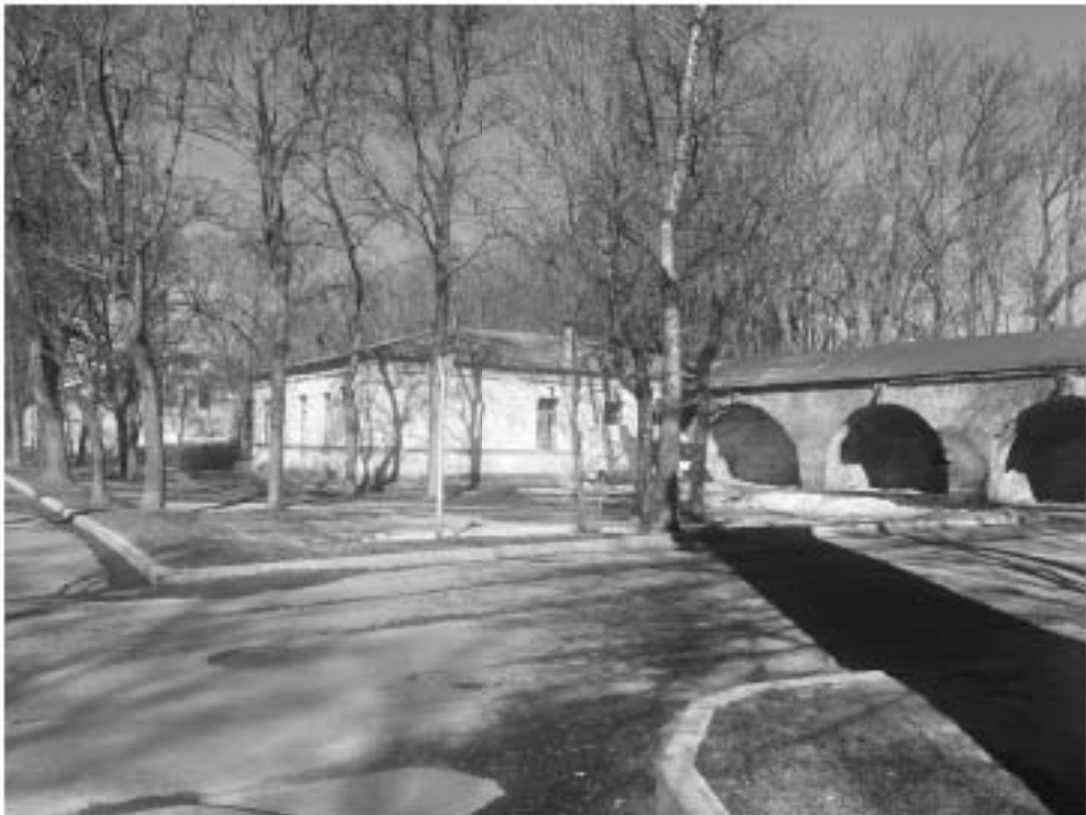
10. Вид объекта культурного наследия «Стена оборонительная», улица Восстания. Направление съемки север.
