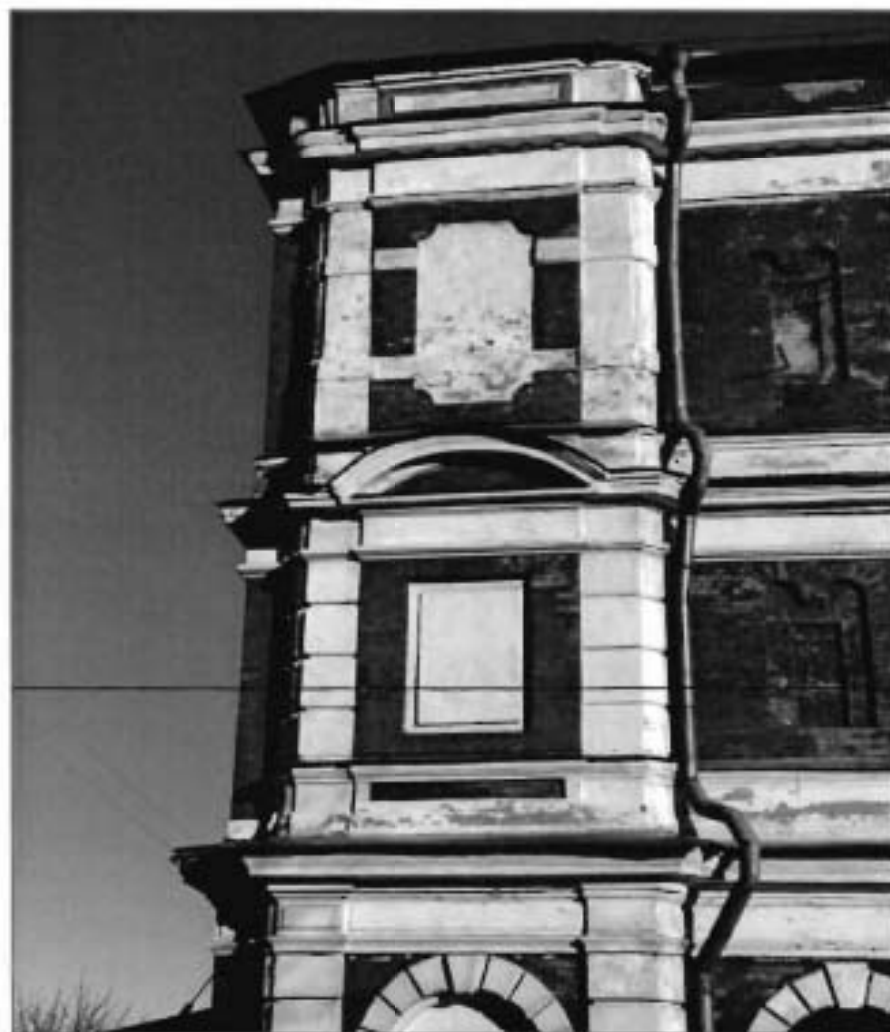
8. Южный фасад по улице Восстания. Фрагмент.
