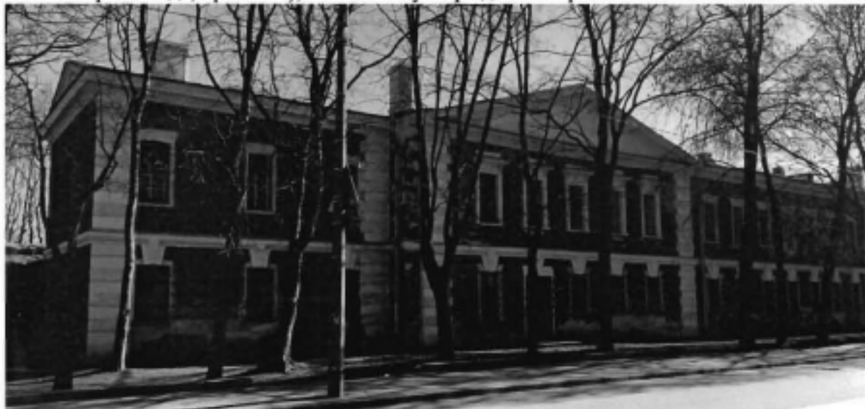
Фото 1. Часть южного фасада.
