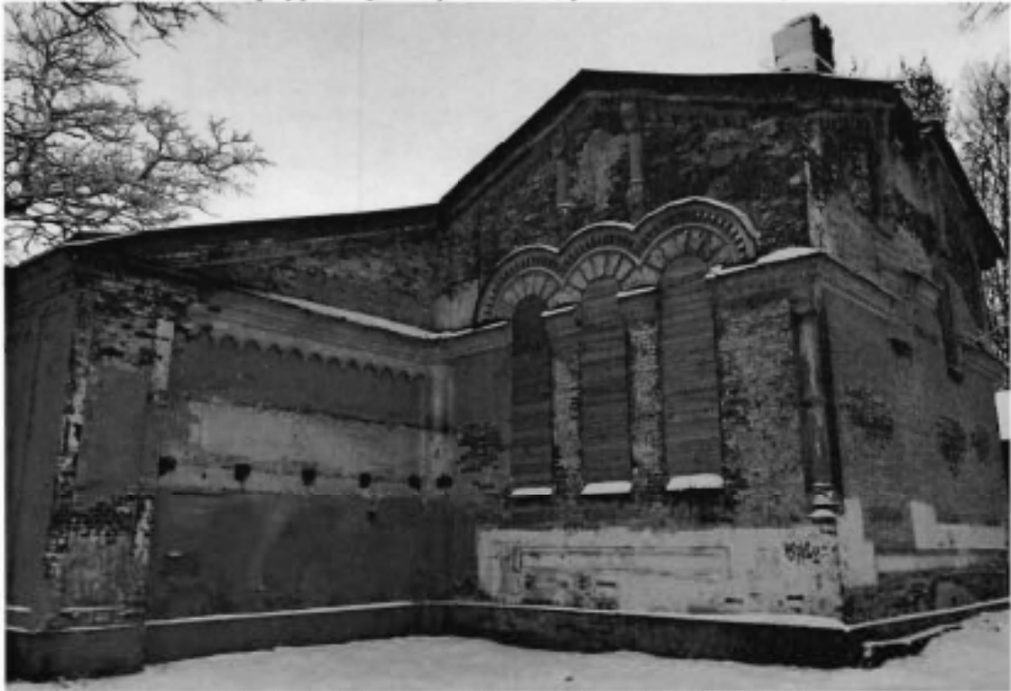
фото 1. Восточный фасад и часть южного фасада.
