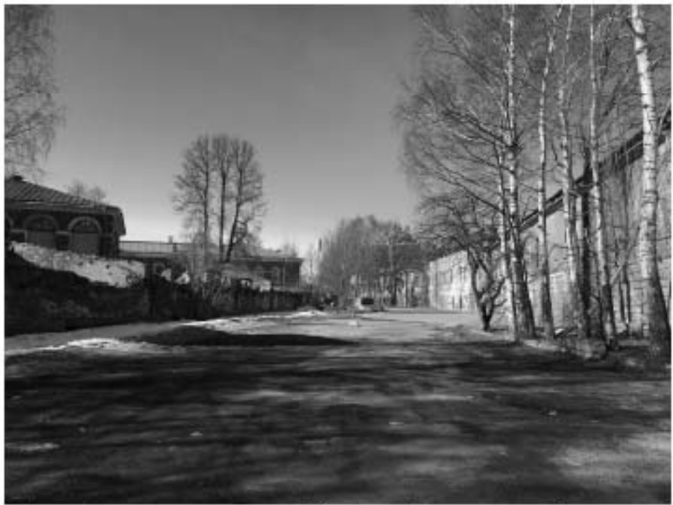
40. Вид объекта культурного наследия «Казарма оборонительная 4-я северная», улица Восстания, дом 1, литера А. Направление съемки северо-запад.
