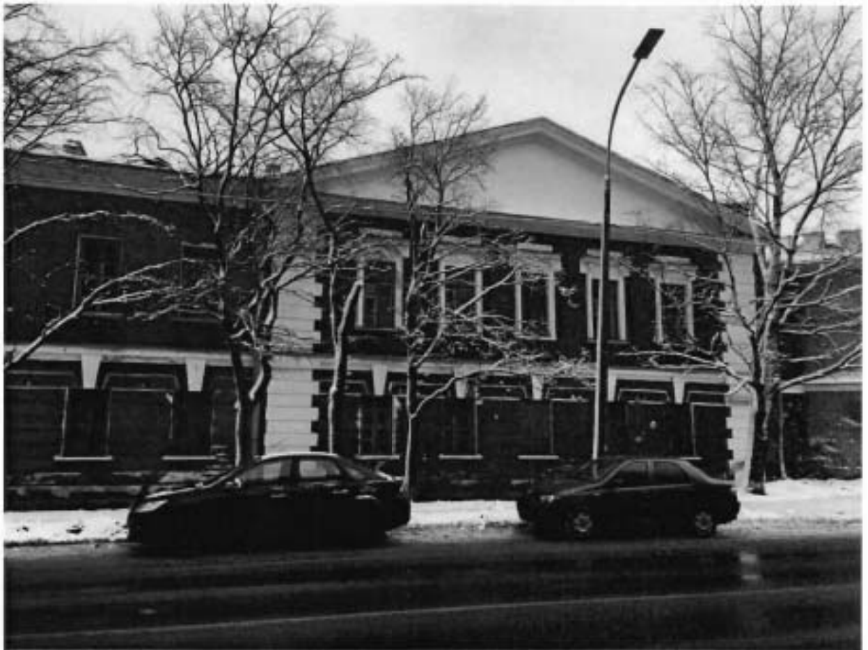
Фото 9. Часть южного фасада.
