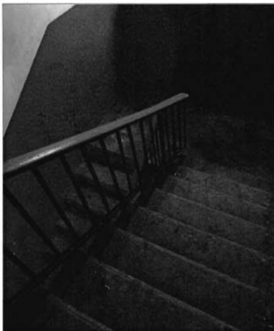
11. Западная лестница на металлических косоурах.
