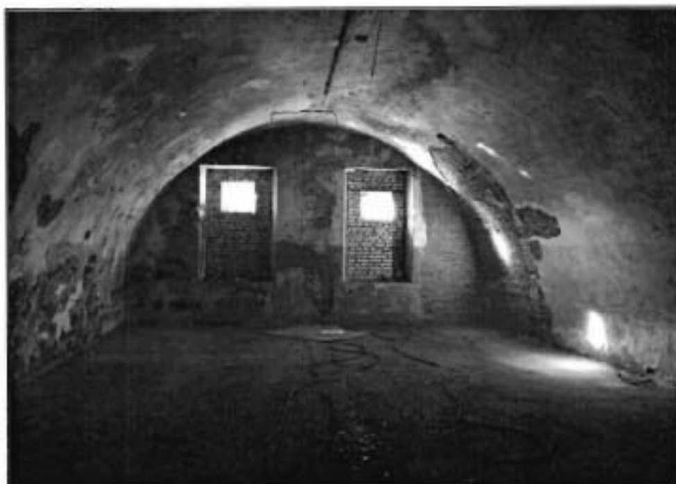
5. Своды основного объема здания.
