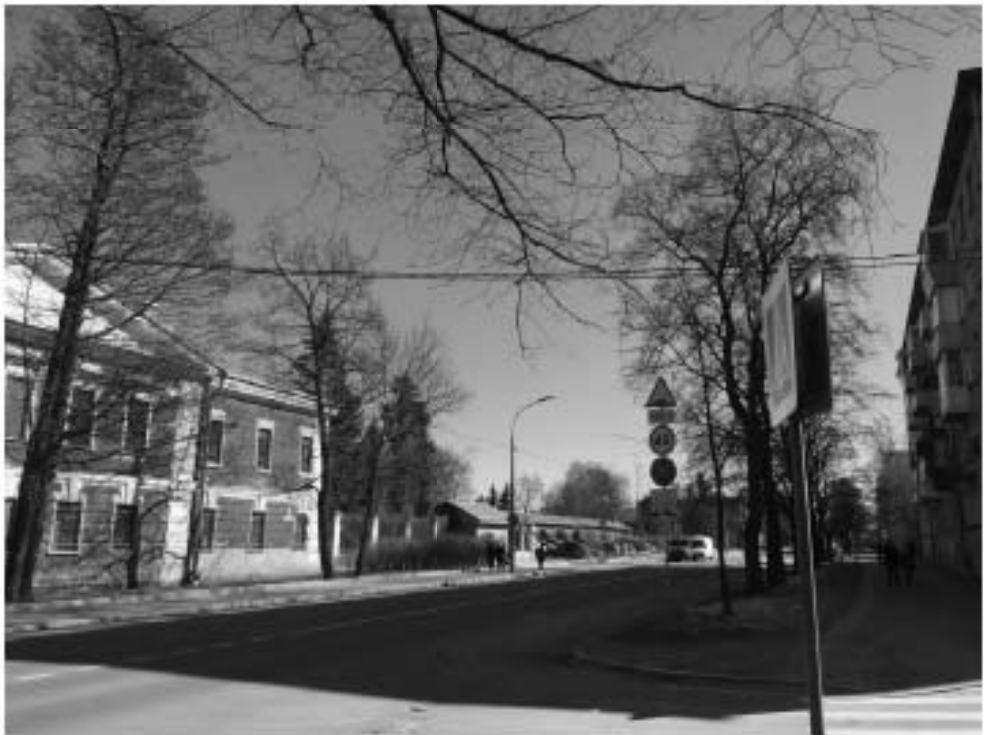
18. Вид объекта культурного наследия «Казарма оборонительная 2-я северная» улица Восстания, дом 9, литера А. Направление съемки юго-восток.
