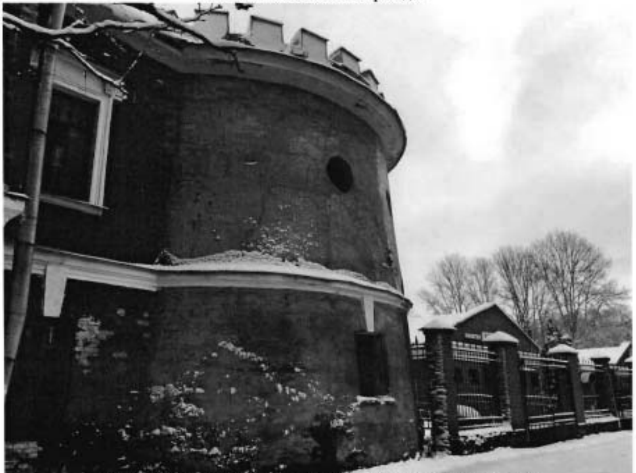
Фото 8. Часть южного фасада. Восточная башенная пристройка.
