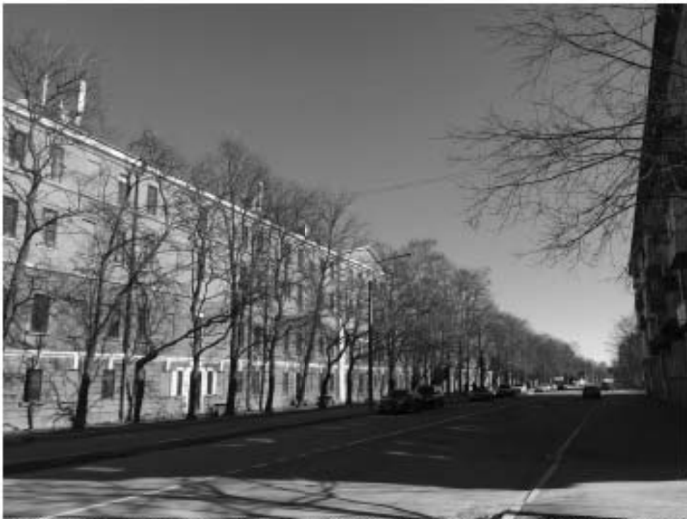
28. Вид на объект культурного наследия «Казарма оборонительная 3-я северная», улица Восстания, дом 5, литера А. Направление съемки юго-восток.
