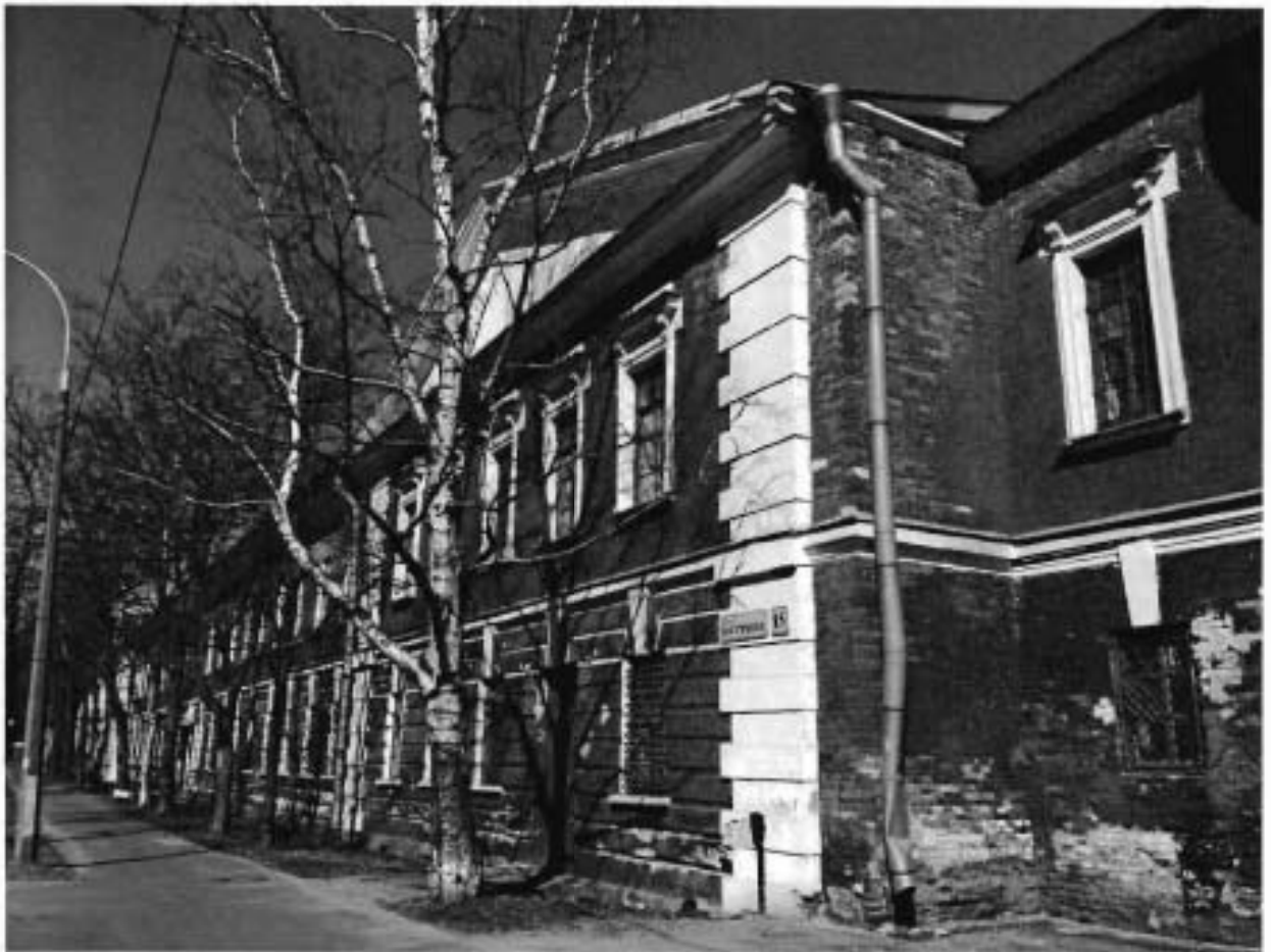
Фото 7. Часть южного фасада.
