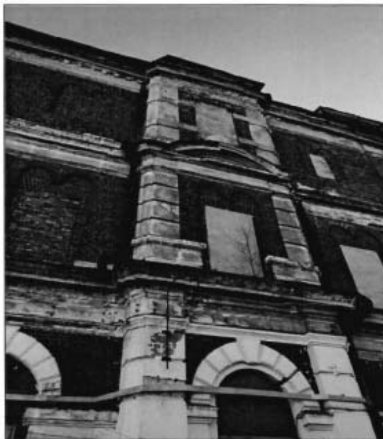
10. Фрагмент западного фасада. Вид с территории объекта.
