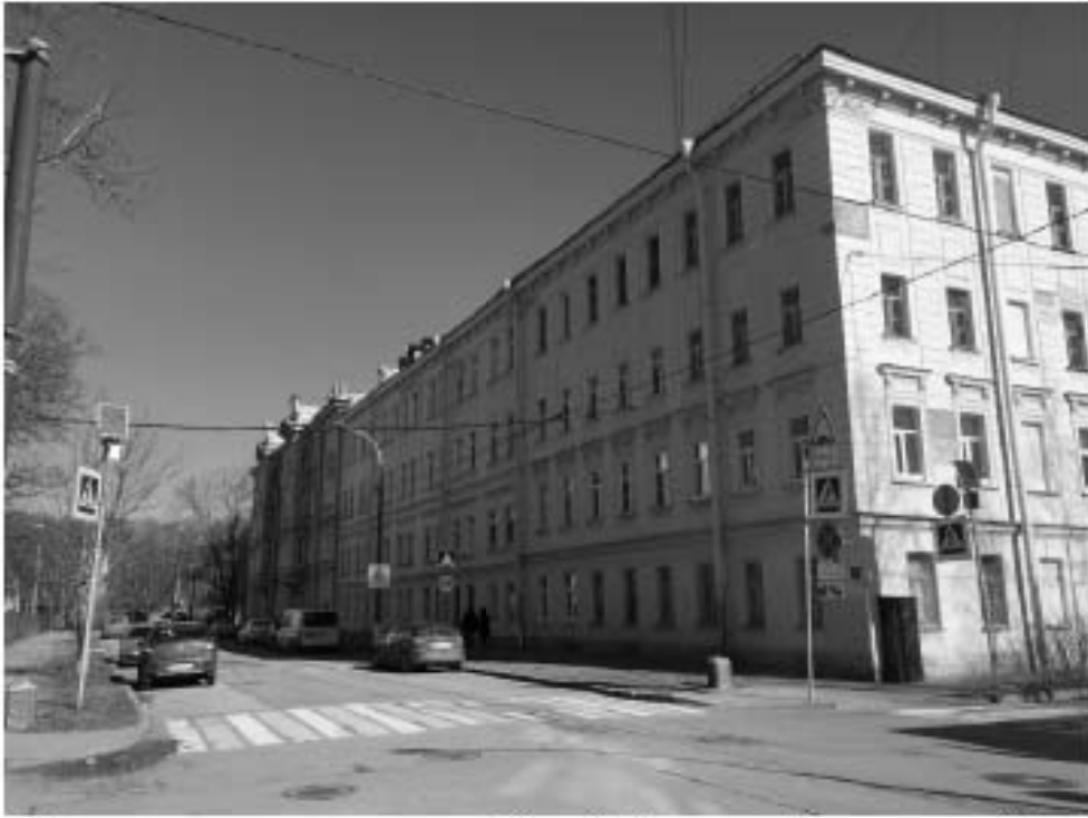
15. Вид на объект культурного наследия «Дома С. Каралин» «Дом по улице Карла Маркса» и «Угловой дом» ул. К. Маркса, дом 4/11, литера А. Направление съемки северо-восток.
