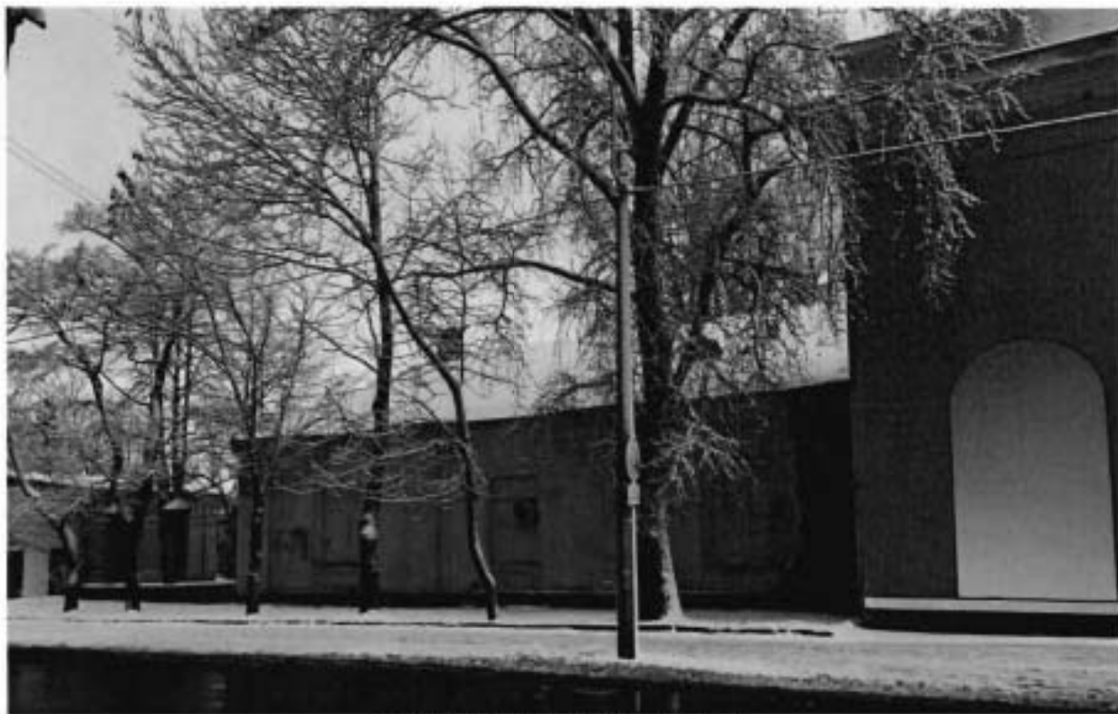
Фото 3. Часть южного фасада.
