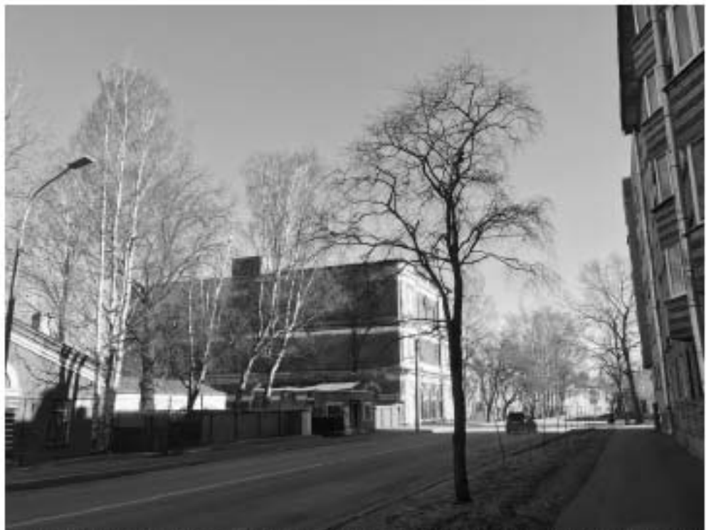
34. Вид объекта культурного наследия «Казарма оборонительная 4-я северная», улица Восстания, дом 1, литера А. Направление съемки юго-восток.
