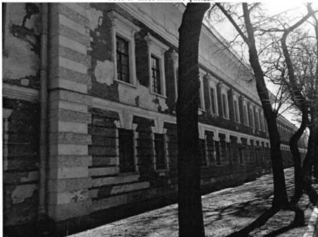
Фото 2. Часть южного фасада.
