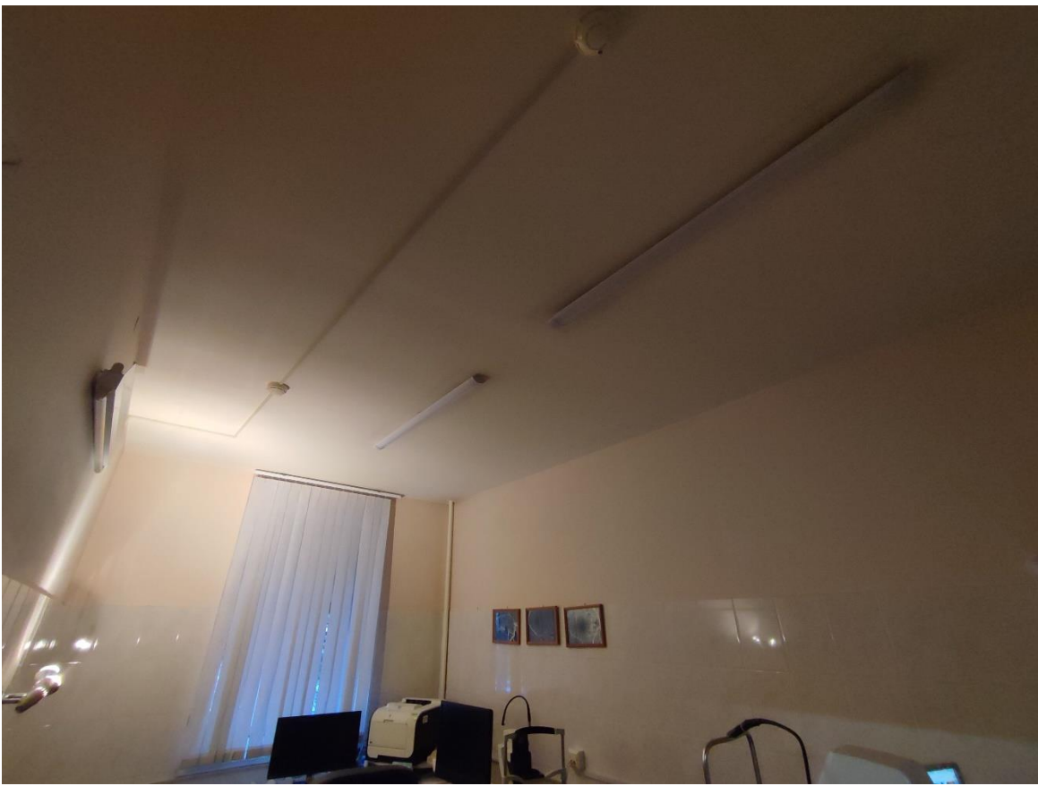
56. Общий вид пом. 16-Н (2) в уровне 1-го этажа.
