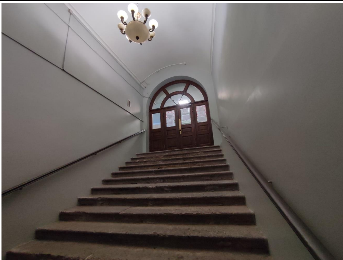
24. Общий вид пом. 1-Н (48) в уровне цокольного этажа.
