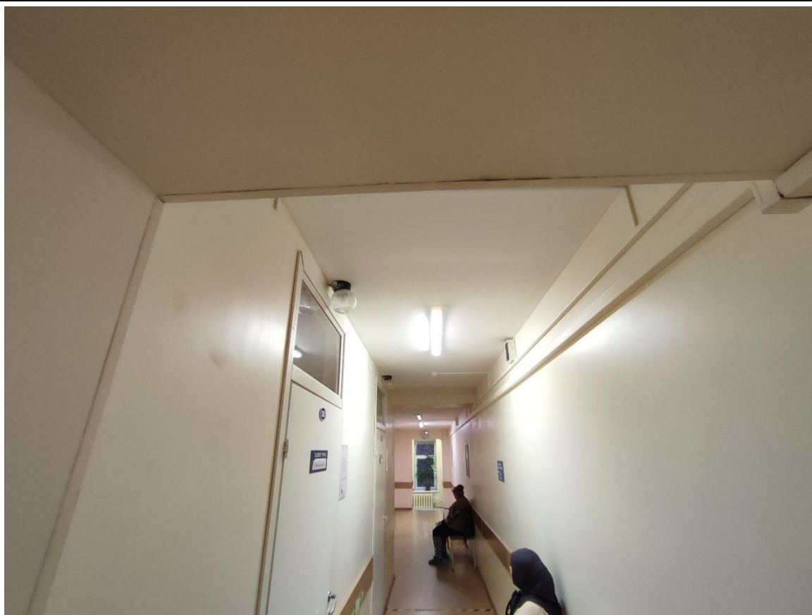
64. Общий вид пом. 22-Н (6) в уровне 2-го этажа.
