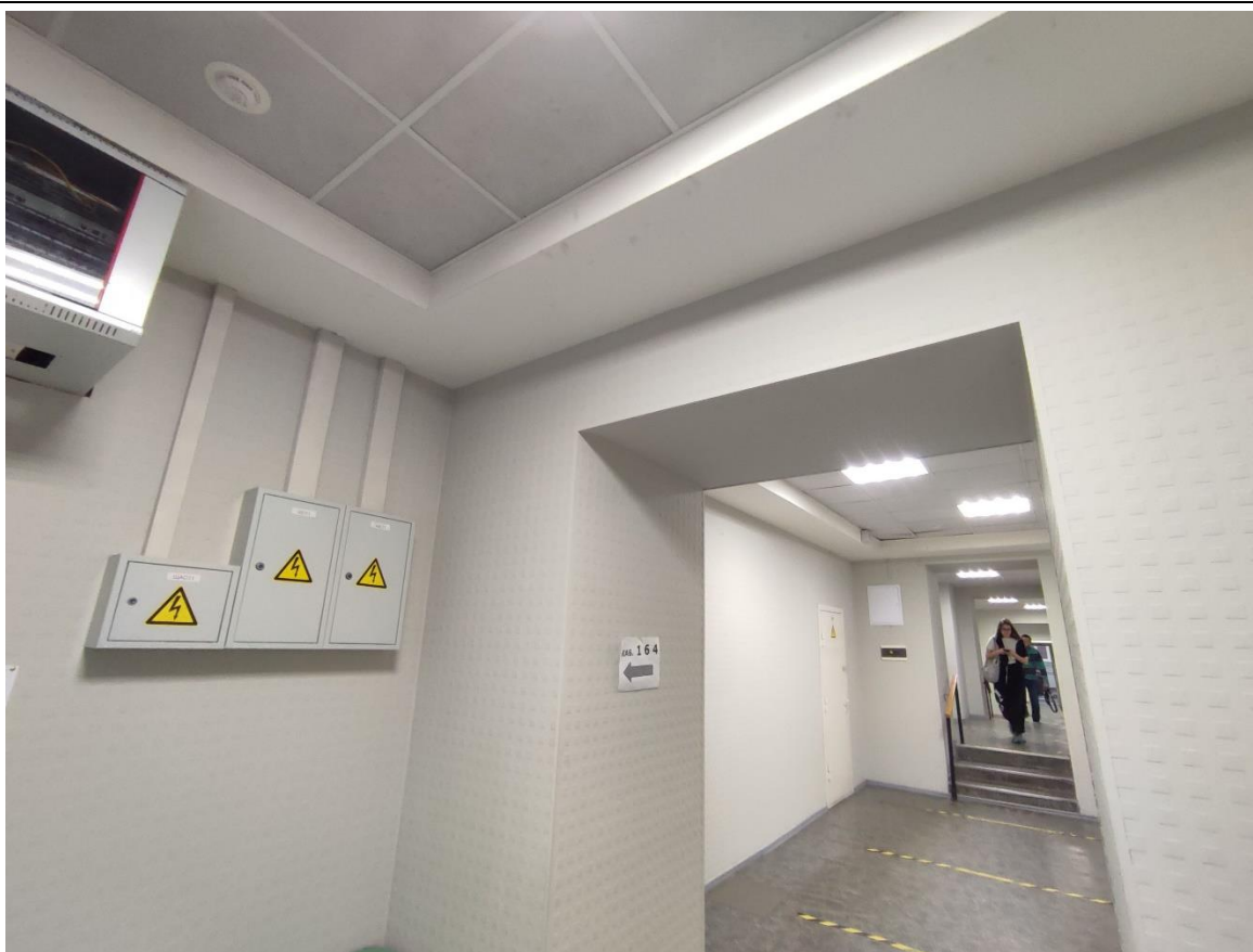
36. Фрагмент пом. 1-Н (12) в уровне 2-го этажа.
