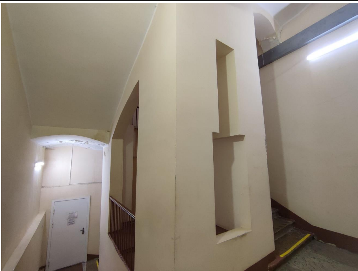
26. Общий вид площадки трехмаршевой лестницы Л-1 в уровне 2-го этажа.
