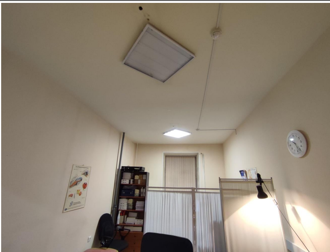
44. Общий вид пом. 14-Н (3) в уровне 1-го этажа.
