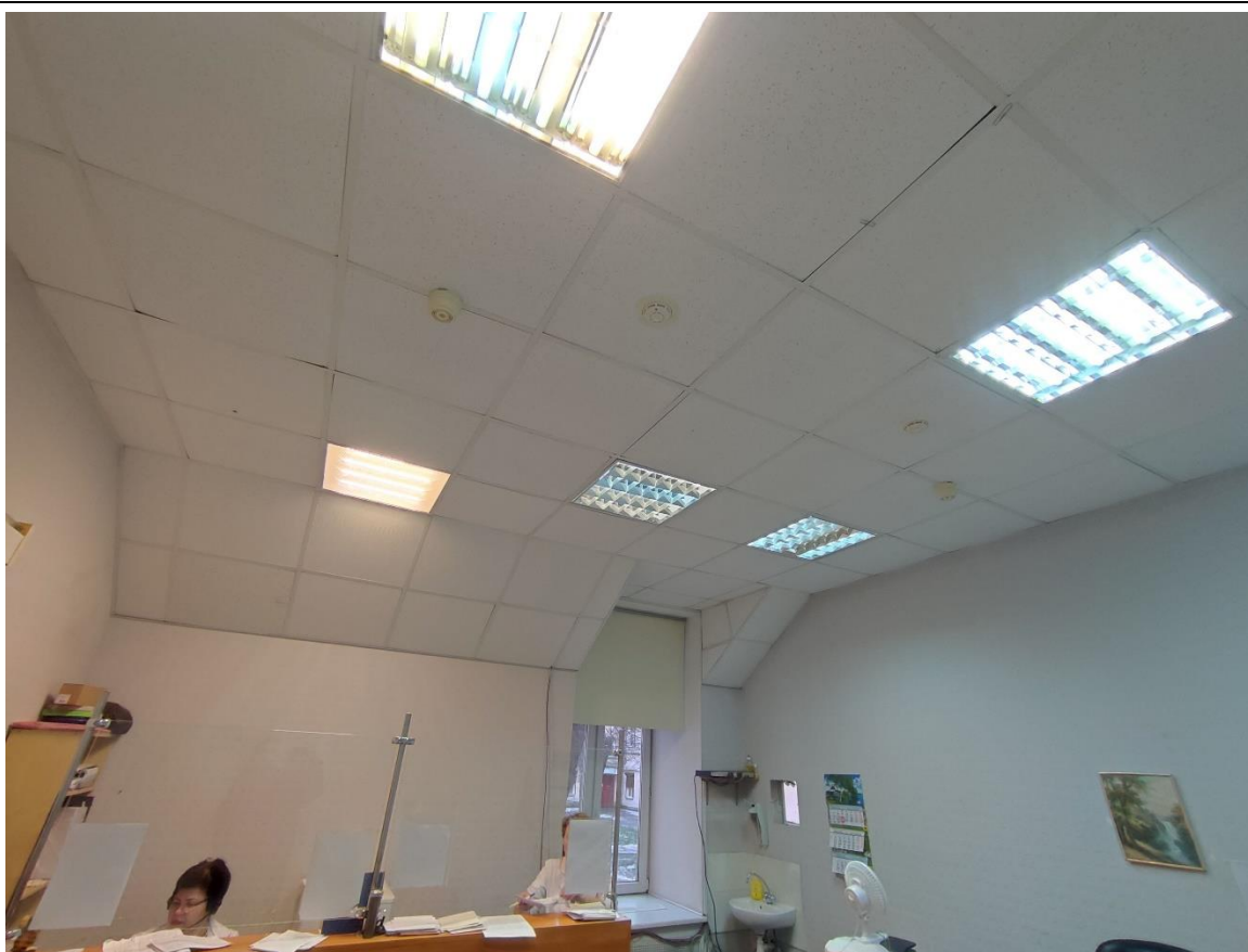
34. Общий вид пом. 1-Н (15) в уровне 2-го этажа.
