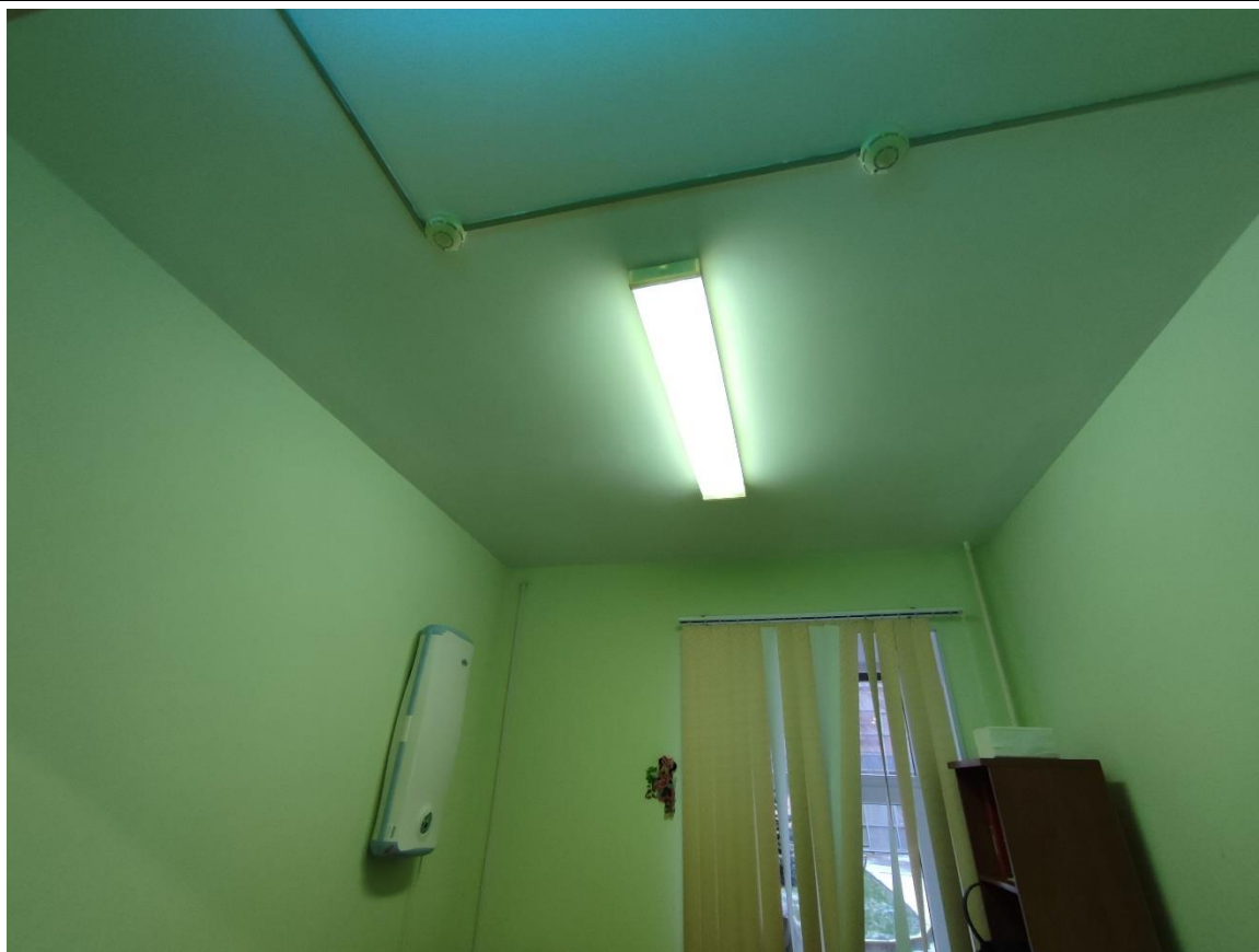
51. Фрагмент пом. 15-Н (5) в уровне 1-го этажа.
