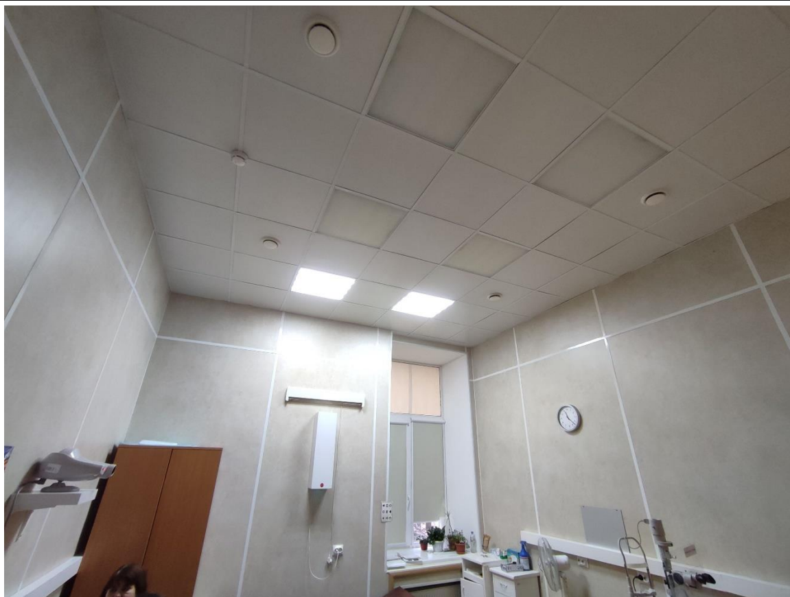
85. Общий вид пом. 17-Н (16) в уровне 3-го этажа.
