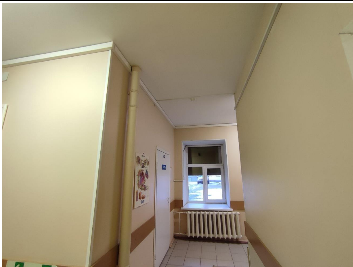
52. Фрагмент пом. 15-Н (7) в уровне 1-го этажа.
