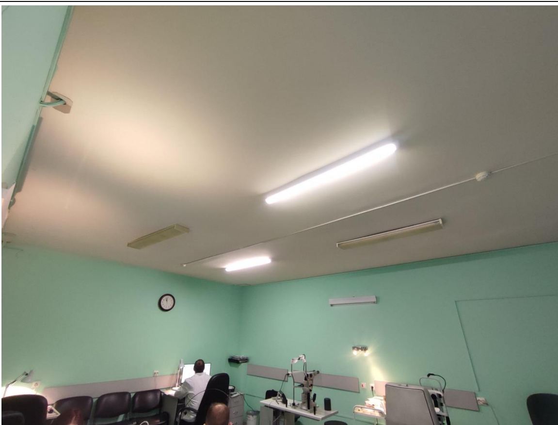
58. Общий вид пом. 16-Н (8) в уровне 1-го этажа.
