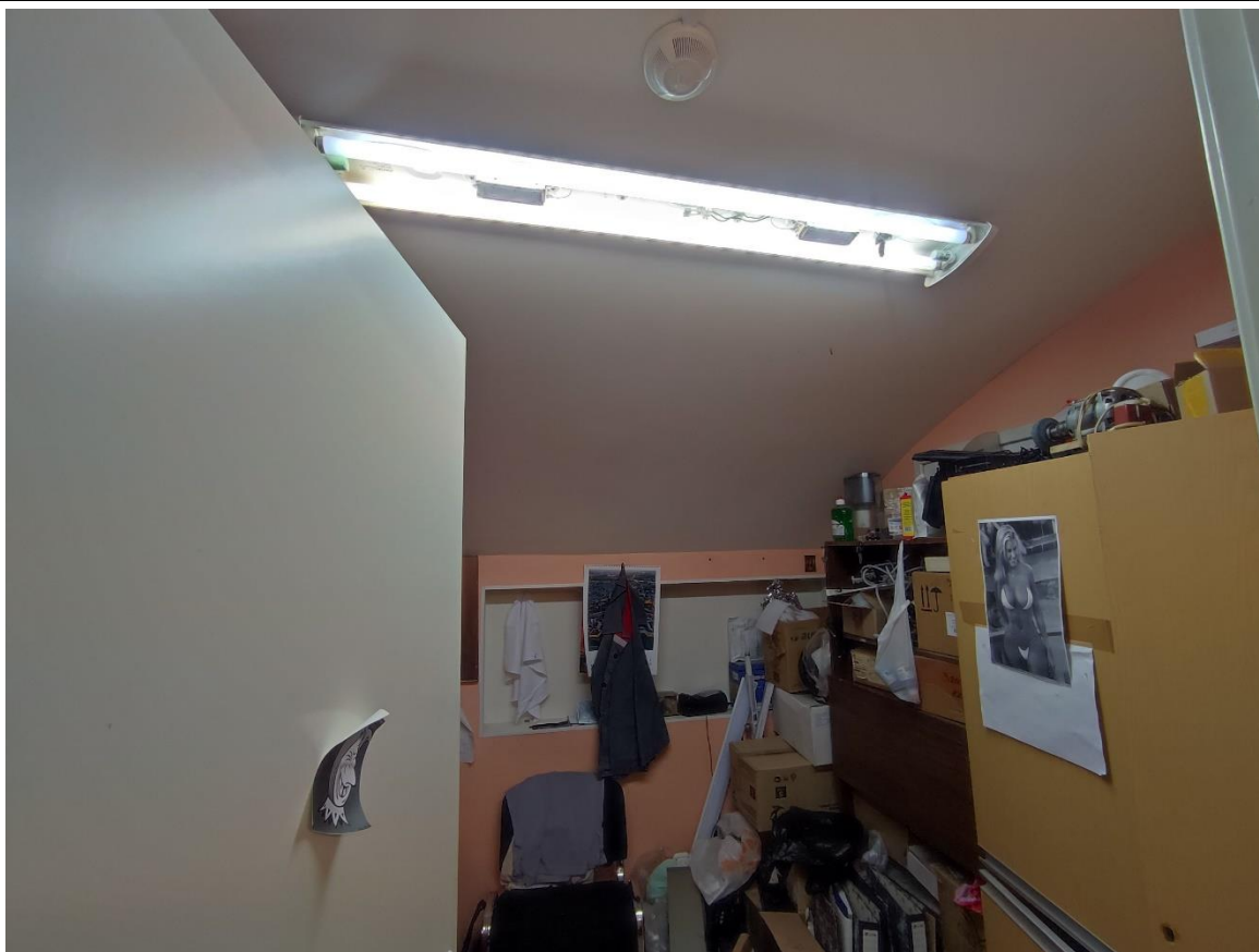
10. Фрагмент пом. 8-Н (3) в уровне цокольного этажа.
