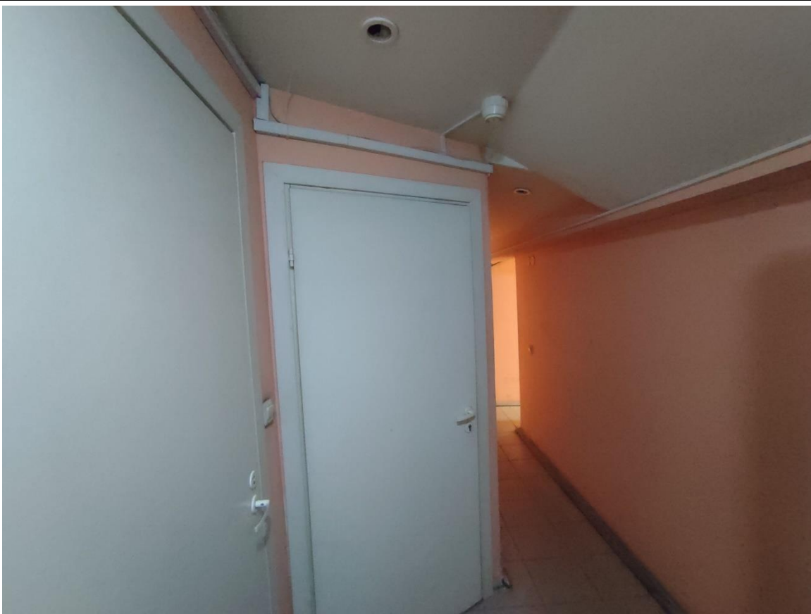
6. Общий вид пом. 8-Н (1) в уровне цокольного этажа.
