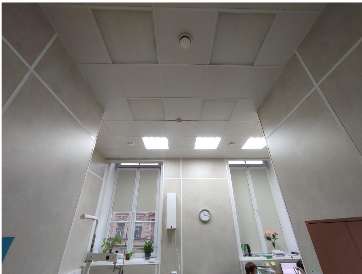
75. Общий вид пом. 17-Н (3) в уровне 3-го этажа.
