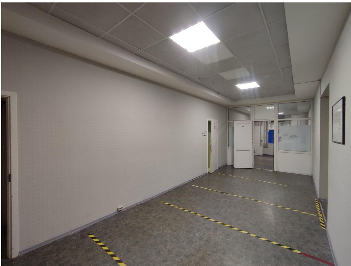
25. Общий вид пом. 1-Н (5) в уровне 2-го этажа.
