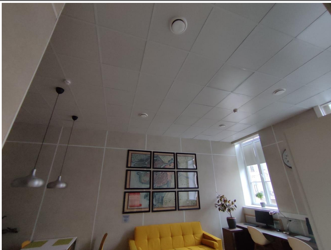
86. Фрагмент пом. 17-Н (8) в уровне 3-го этажа.
