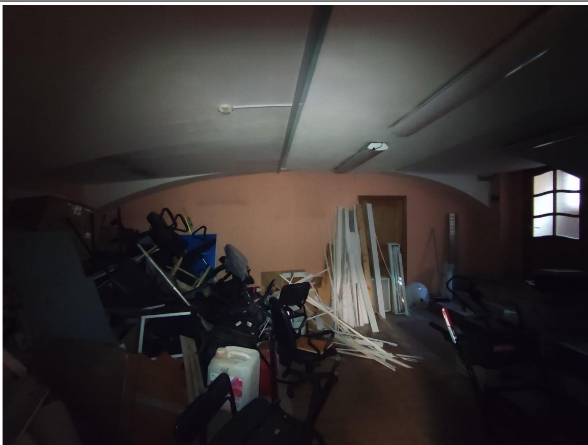
9. Фрагмент пом. 1-Н (49) в уровне цокольного этажа.
