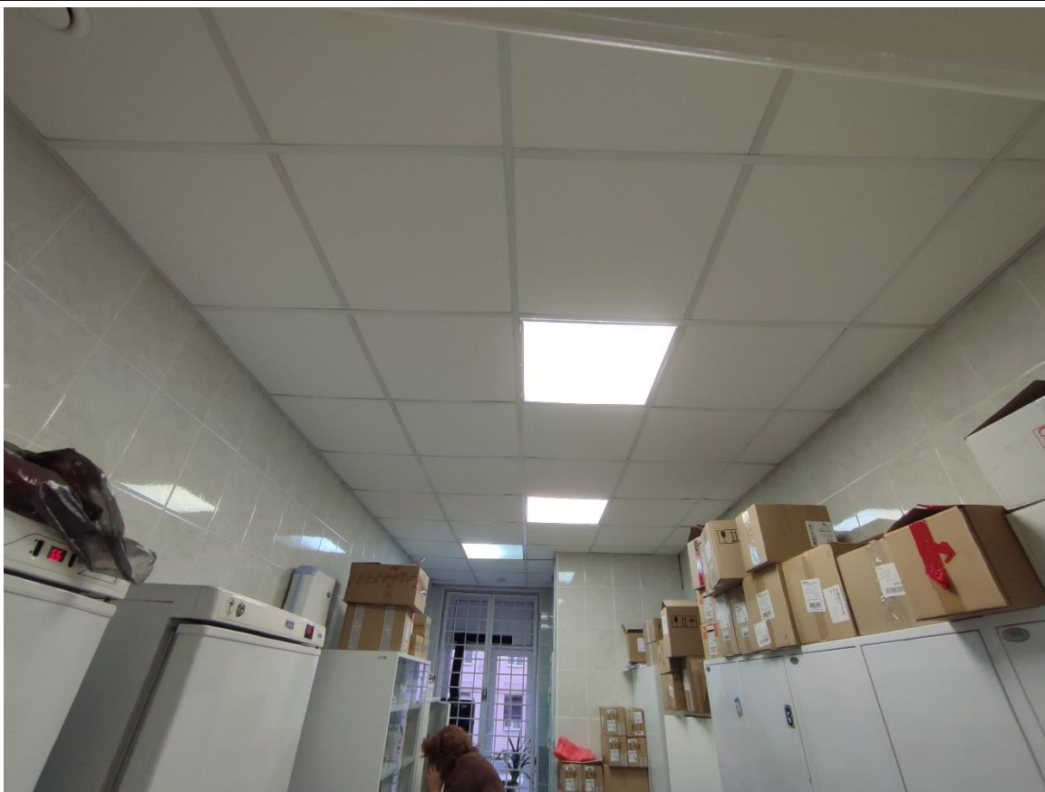
29. Общий вид пом. 13-Н (8) в уровне 2-го этажа.
