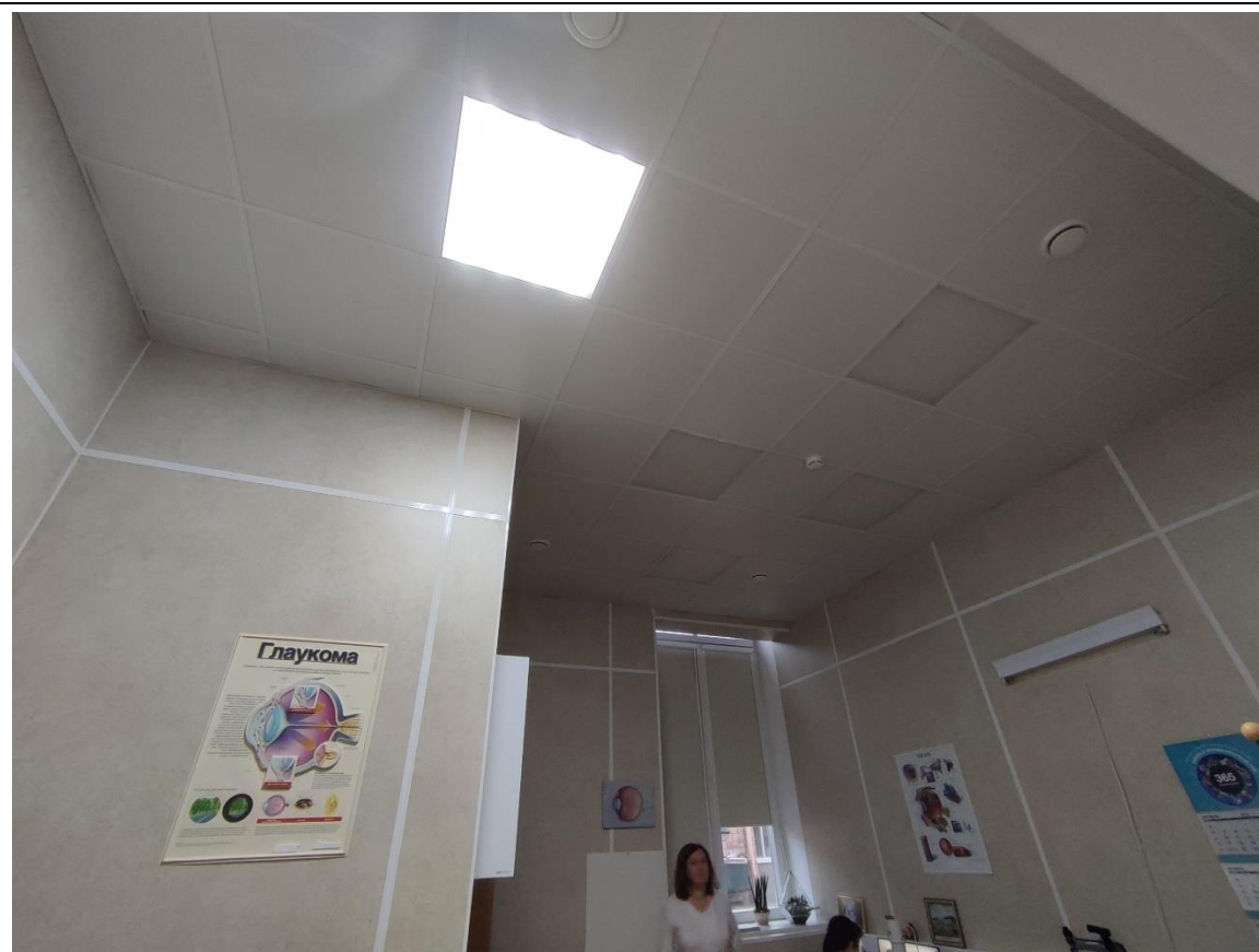
76. Общий вид пом. 17-Н (4) в уровне 3-го этажа.
