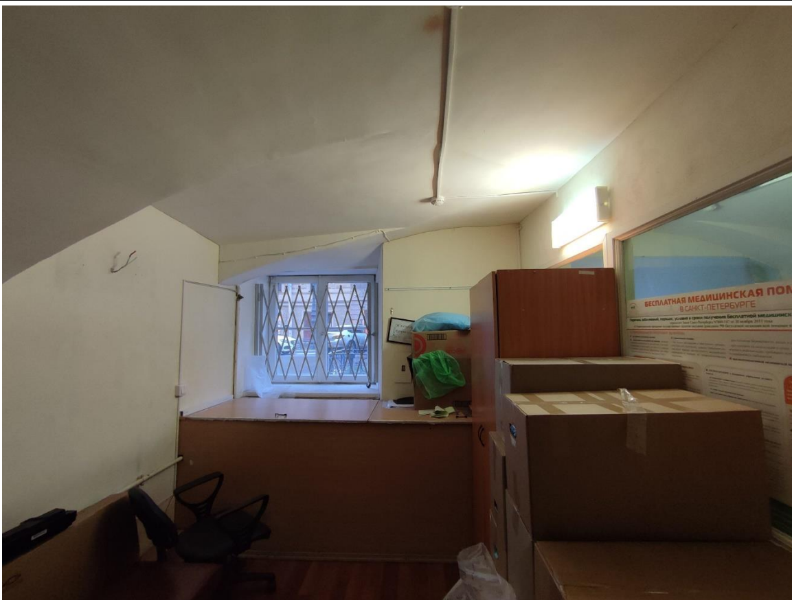
12. Фрагмент пом. 2-Н (1) в уровне цокольного этажа.
