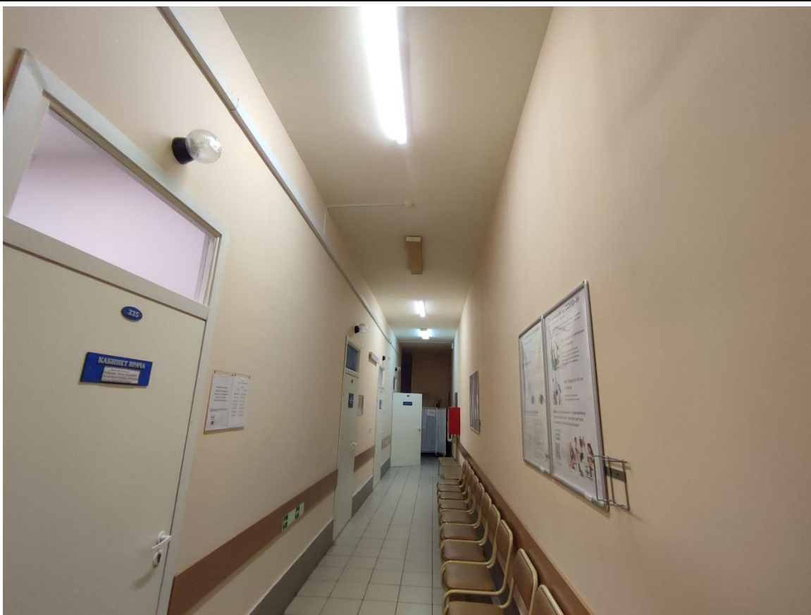
111. Общий вид пом. 30-Н (1) в уровне 3-го этажа.
