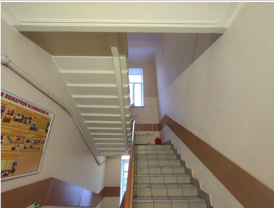
69. Общий вид площадки двухмаршевой лестницы ЗЛК (2) в уровне 2-го этажа.
