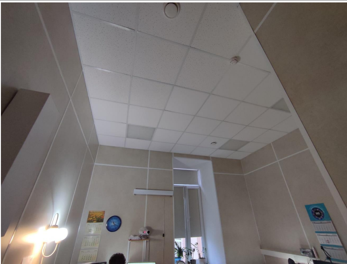
78. Общий вид пом. 17-Н (22) в уровне 3-го этажа.
