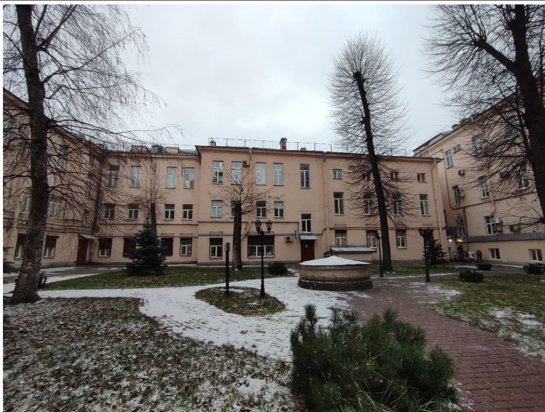
4. Общий вид южного дворового фасада выявленного объекта культурного наследия «Здание глазной лечебницы В.В. Лерхе».
