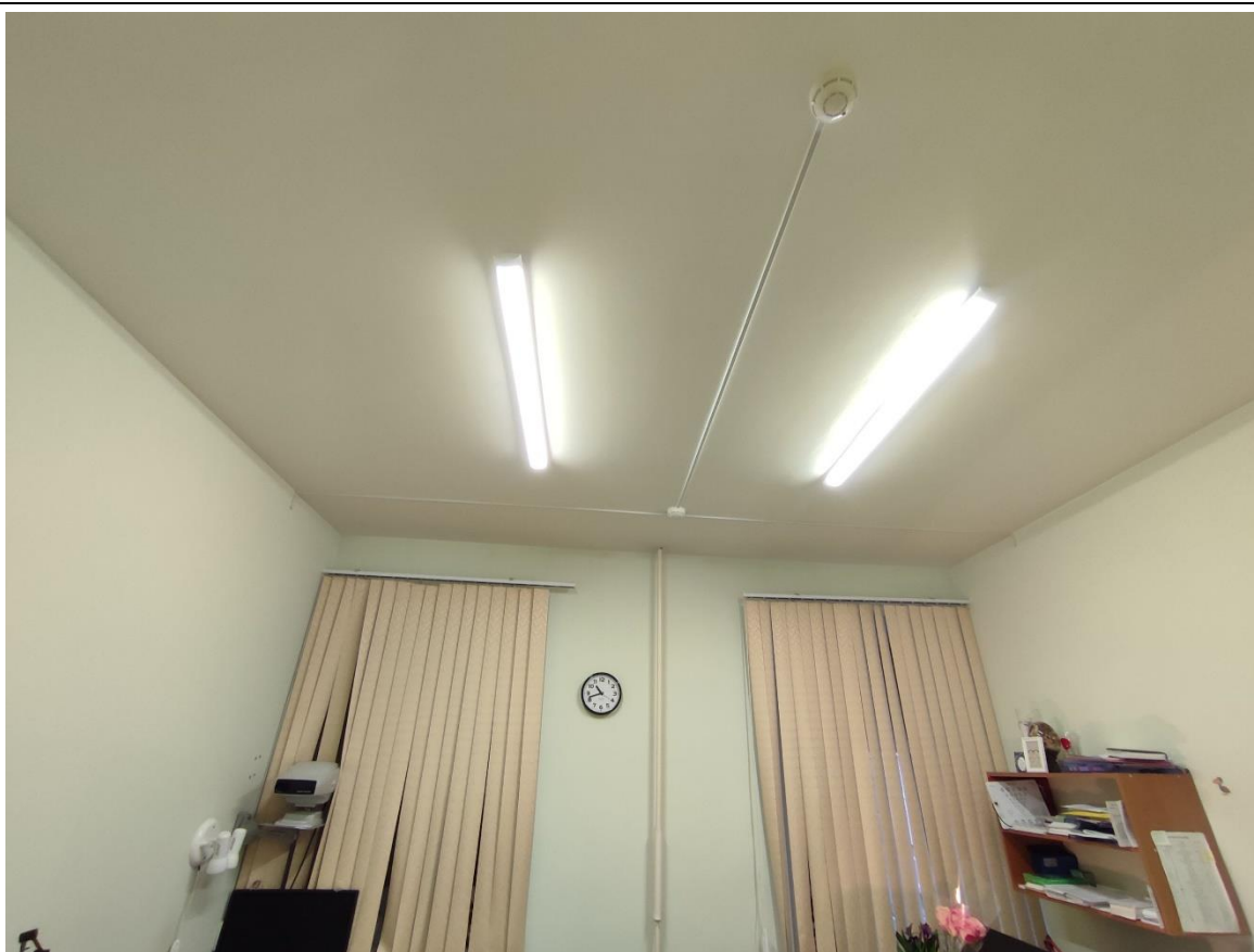
68. Общий вид пом. 22-Н (3) в уровне 2-го этажа.
