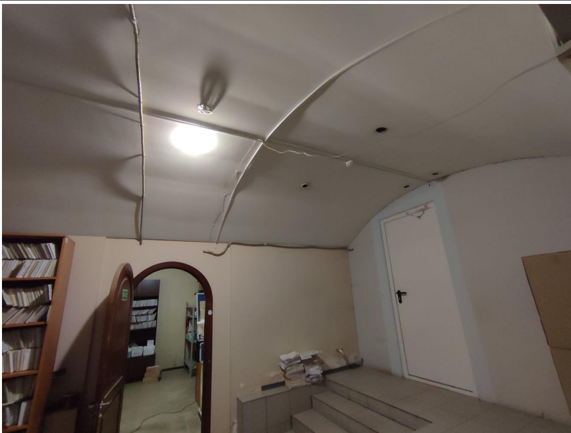
18. Общий вид пом. 3-Н (4, 5, 6) в уровне цокольного этажа.
