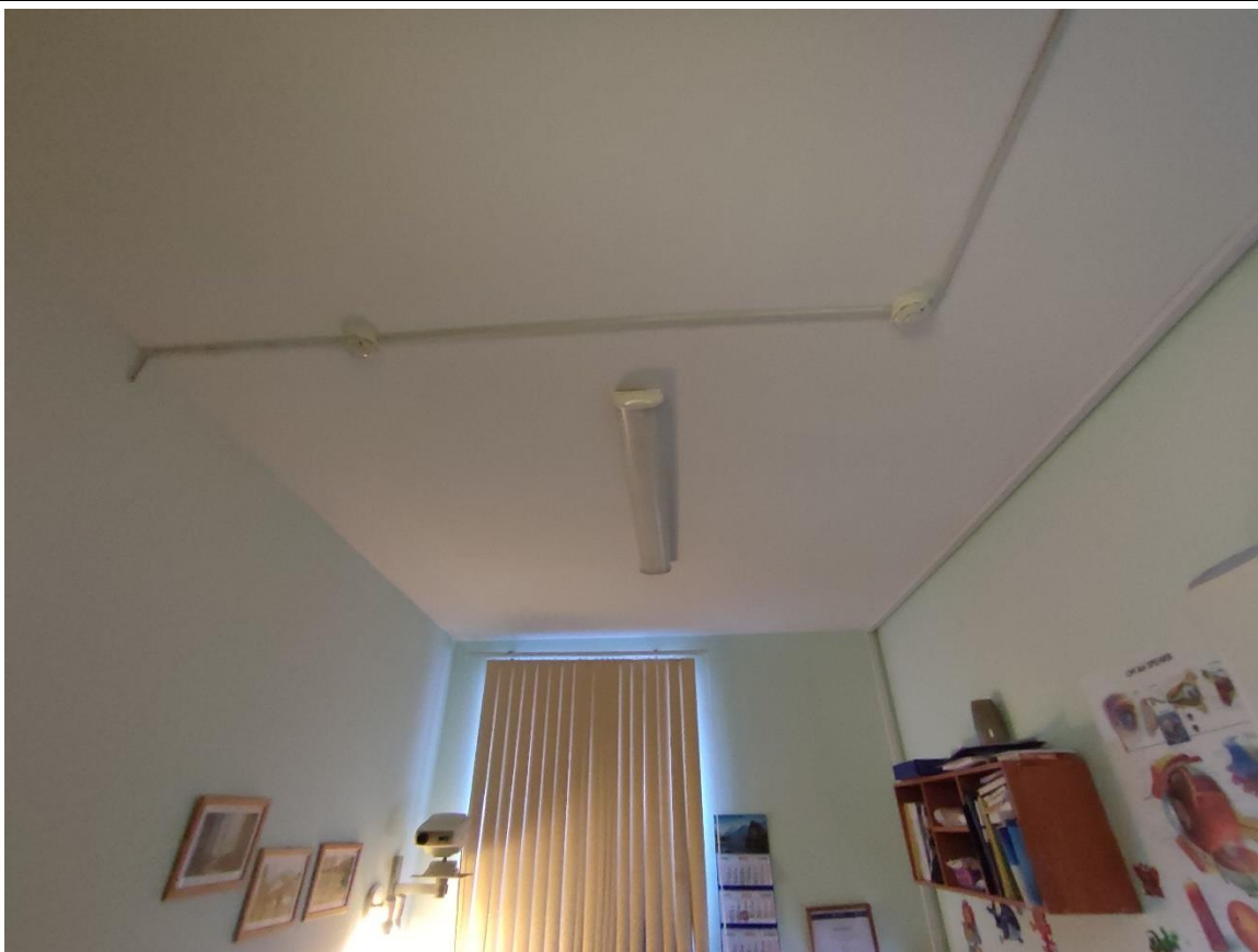
65. Общий вид пом. 22-Н (8) в уровне 2-го этажа.
