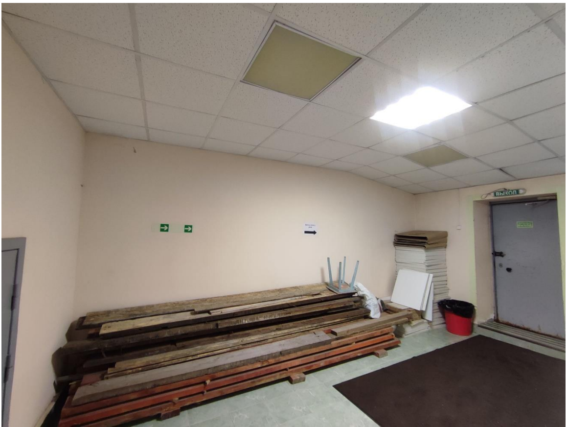
22. Общий вид пом. Л-1 (1) в уровне подвала.
