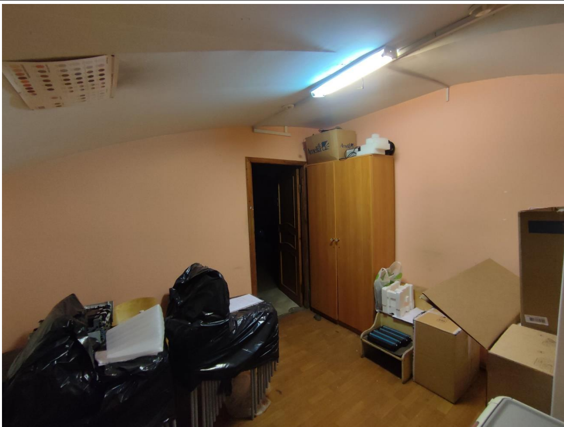
8. Фрагмент пом. 1-Н (49) в уровне цокольного этажа.
