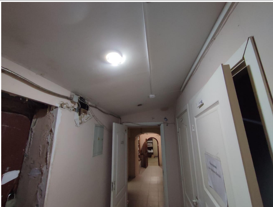
15. Общий вид пом. 3-Н (11) в уровне цокольного этажа.
