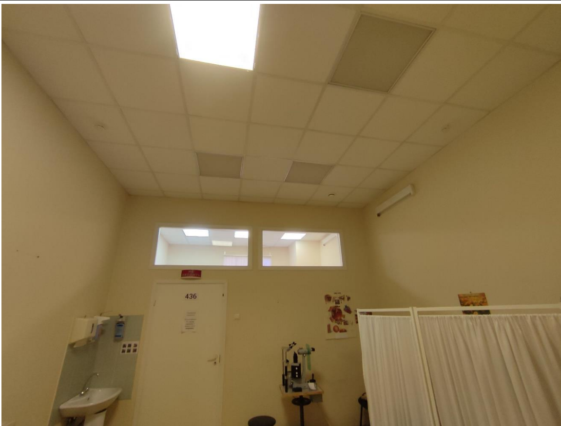
97. Общий вид пом. 24-Н (45) в уровне 4-го этажа.
