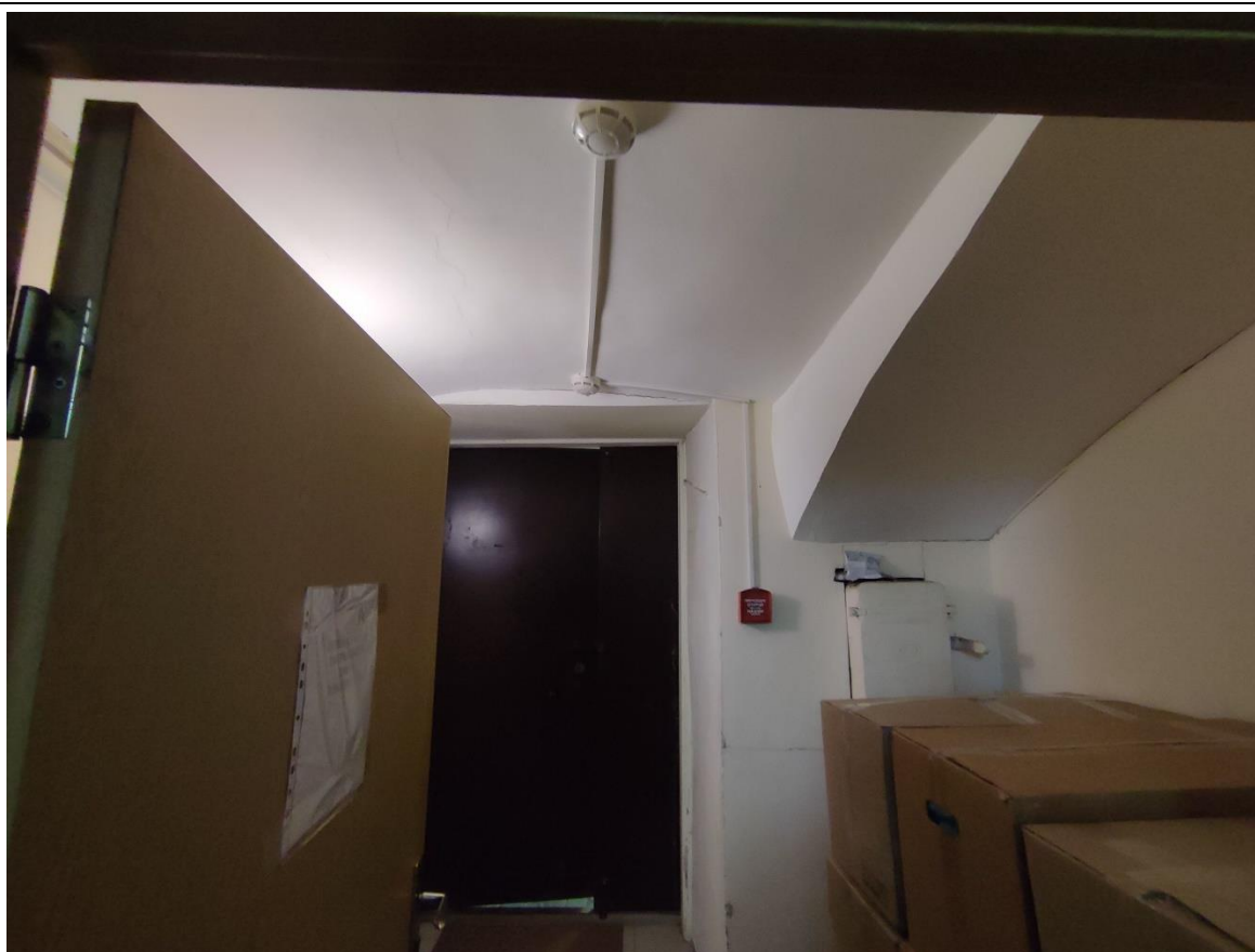
11. Фрагмент пом. 2-Н (1) в уровне цокольного этажа.
