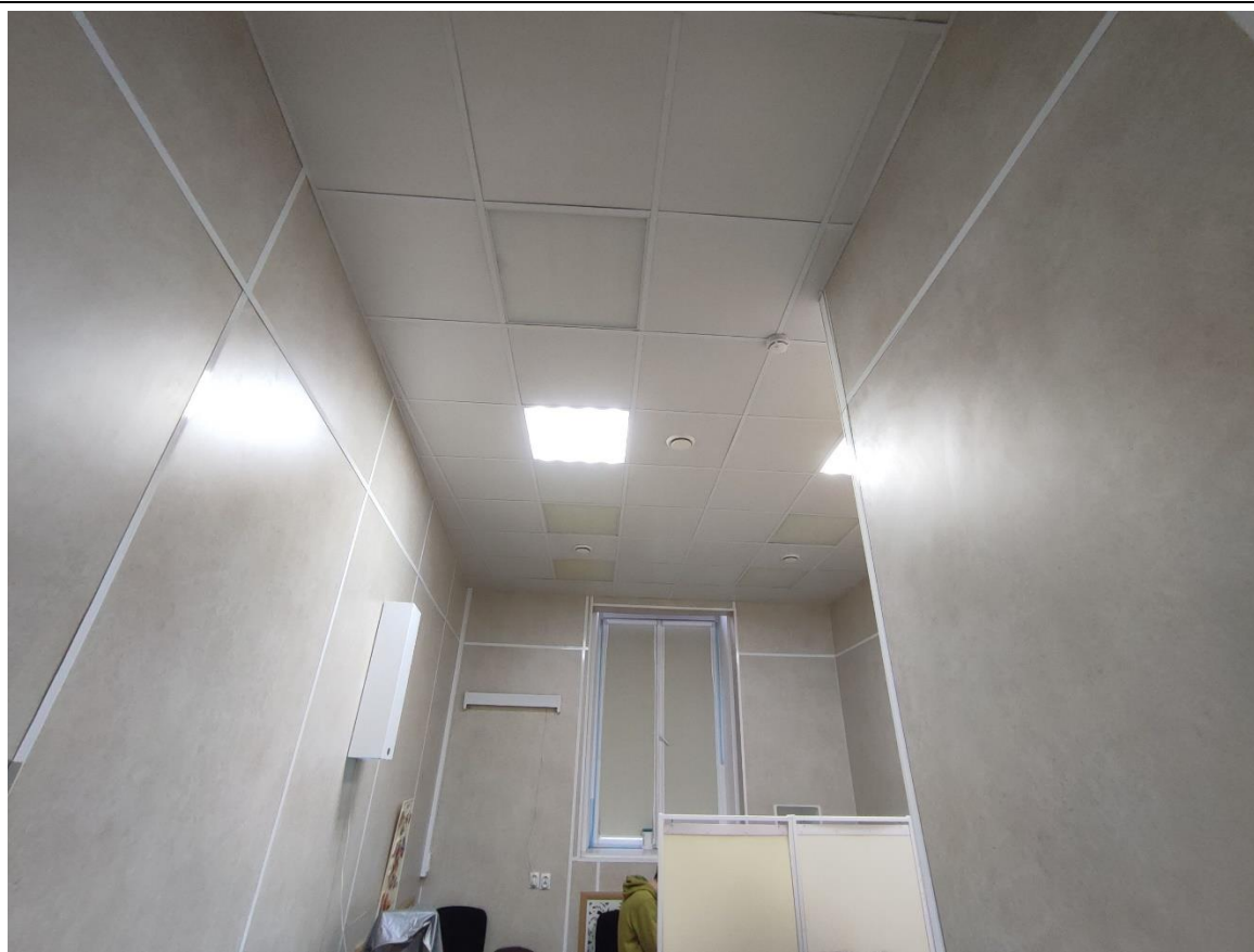
74. Общий вид пом. 20-Н (2) в уровне 3-го этажа.
