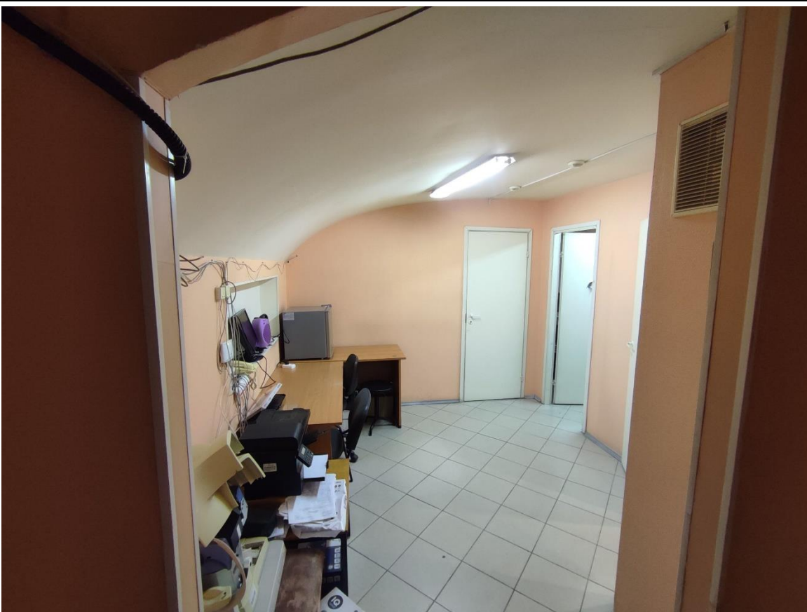
7. Фрагмент пом. 8-Н (3) в уровне цокольного этажа.
