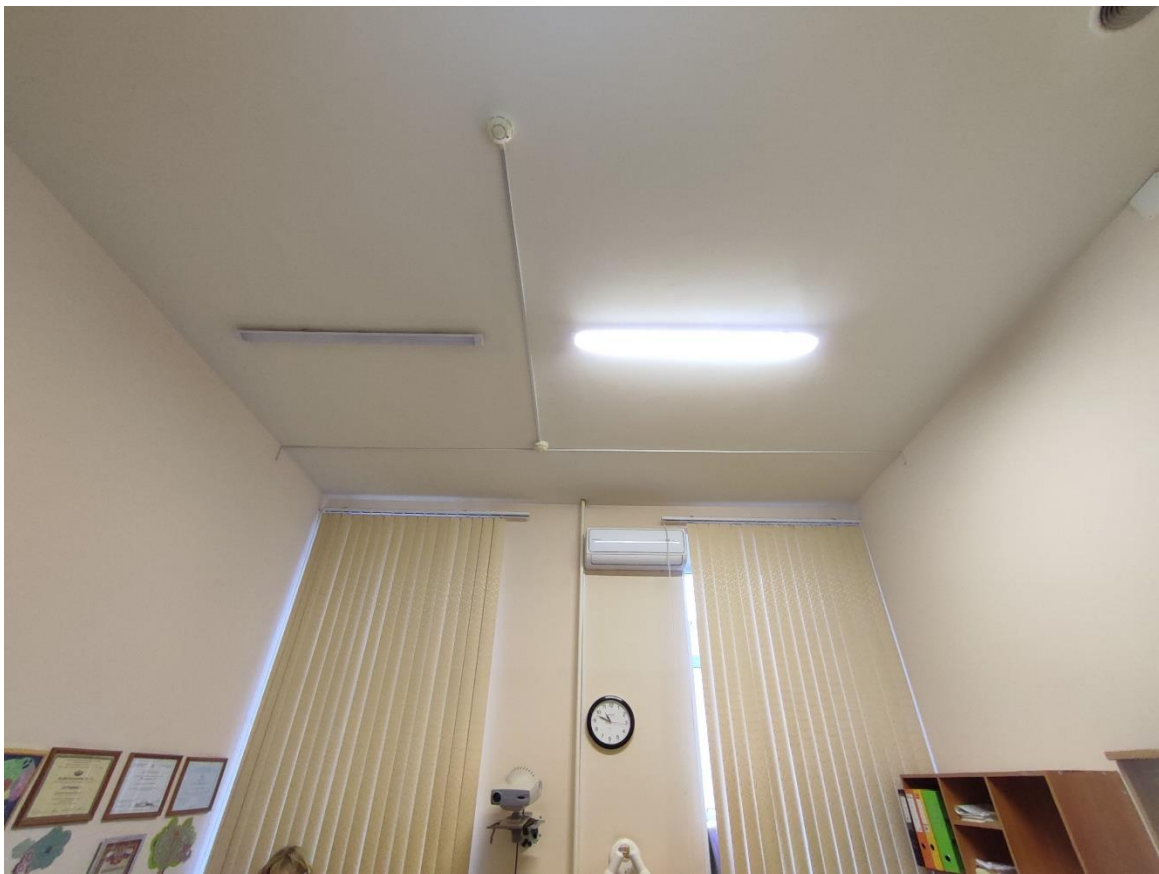
104. Общий вид пом. 29-Н (3) в уровне 3-го этажа.
