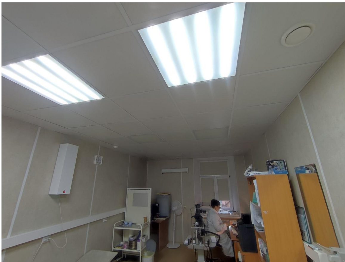
84. Общий вид пом. 17-Н (14, 15) в уровне 3-го этажа.
