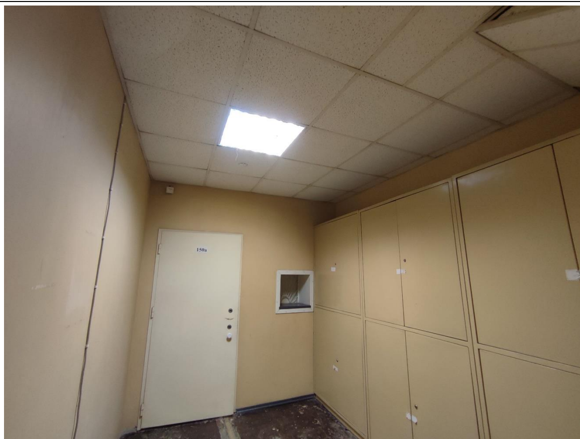
42. Общий вид пом. 1-Н (28) в уровне 2-го этажа.
