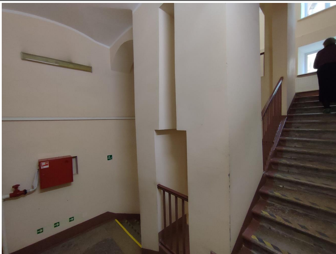
87. Общий вид площадки трехмаршевой лестницы Л-1 в уровне 3-го этажа.
