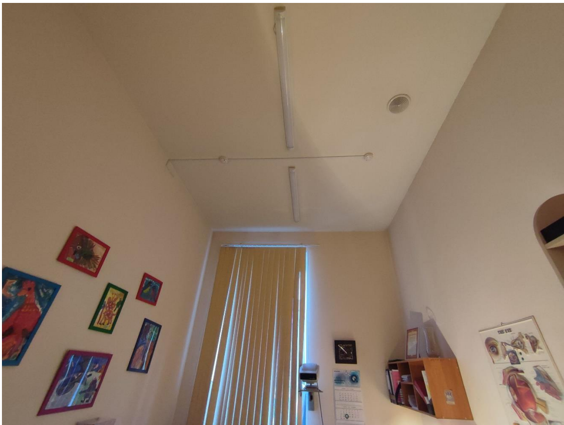
106. Общий вид пом. 29-Н (6) в уровне 3-го этажа.
