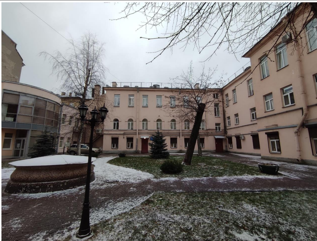
3. Общий вид западного дворового фасада выявленного объекта культурного наследия «Здание глазной лечебницы В.В. Лерхе».
