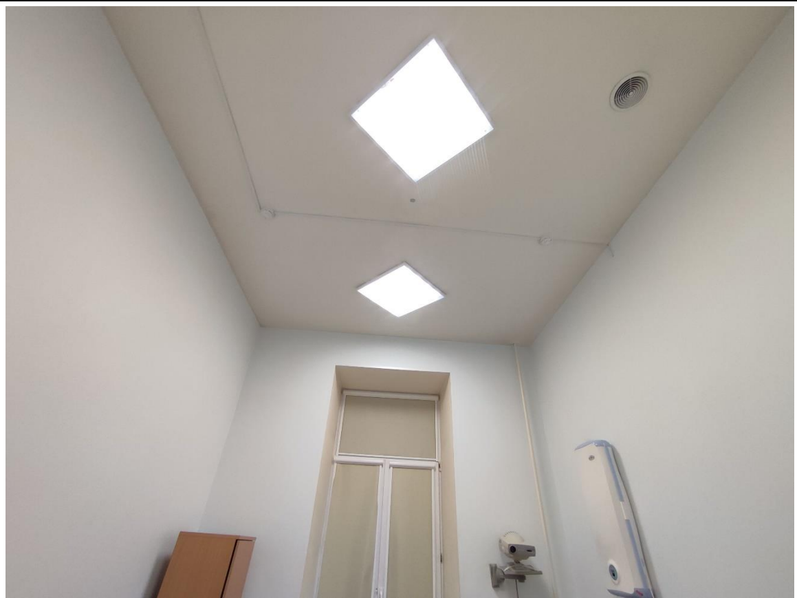
107. Общий вид пом. 29-Н (8) в уровне 3-го этажа.
