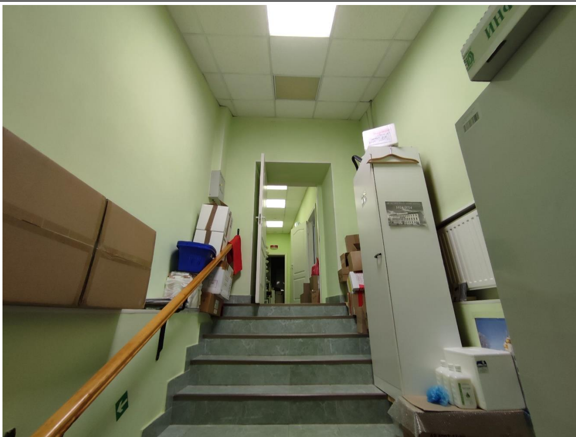
27. Общий вид пом. 13-Н (1) в уровне 2-го этажа.
