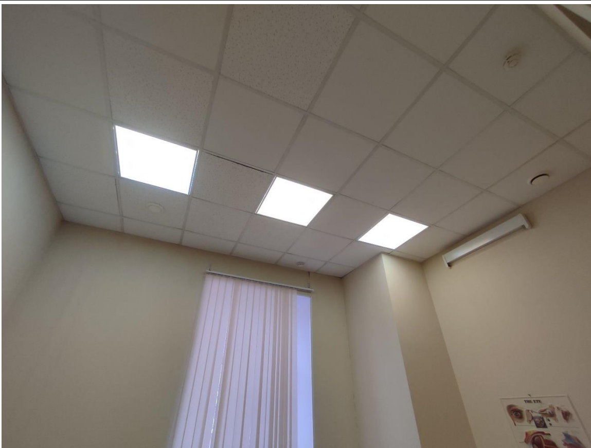
98. Фрагмент пом. 24-Н (46) в уровне 4-го этажа.
