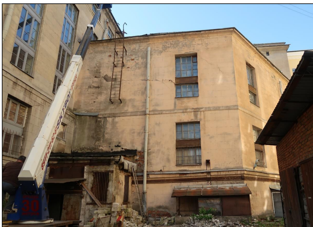
11. Выявленный объект культурного наследия «Здание Библиотеки Академии наук», расположенный по адресу: г. Санкт-Петербург, Василеостровский район, Биржевая линия, д. 1, Тифлисская ул., д. 1, литера А. Пристройка, восточный фасад, общий вид.
