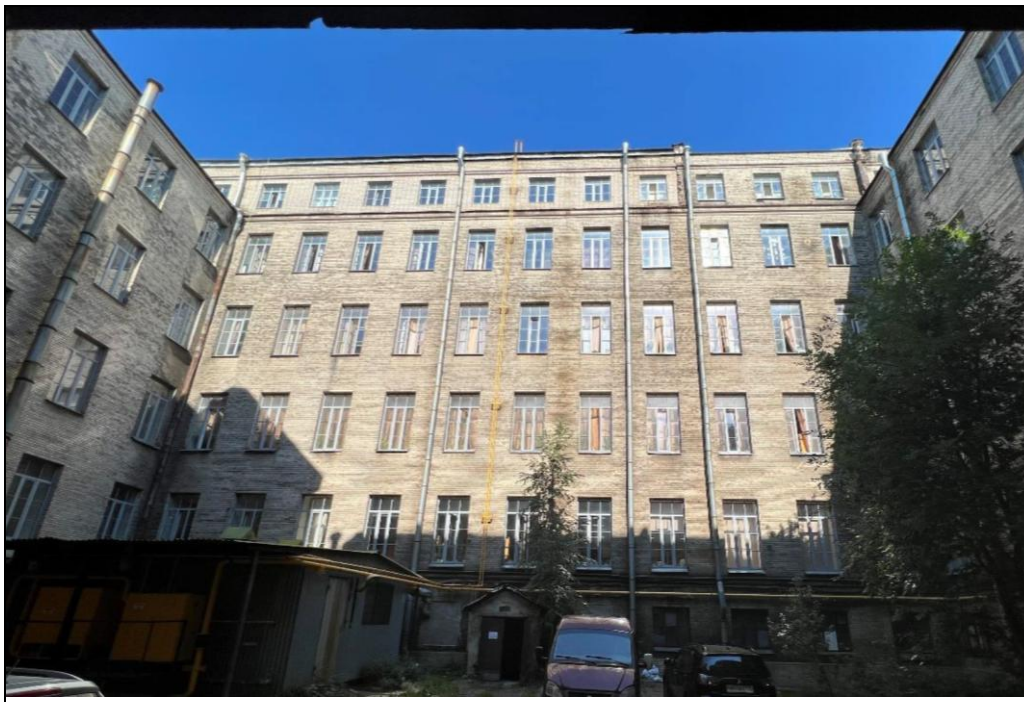
14. Выявленный объект культурного наследия «Здание Библиотеки Академии наук», расположенный по адресу: г. Санкт-Петербург, Василеостровский район, Биржевая линия, д. 1, Тифлисская ул., д. 1, литера А. Двор-колодец. Дворовые фасады Общий вид.
