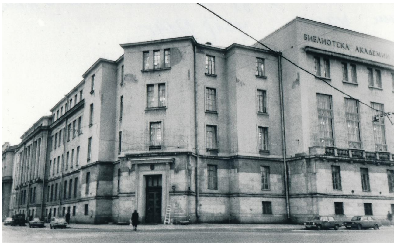
13. Здание Библиотеки Академии наук. Вид на главный вход в здание с современной площади Академика Сахарова. Фотография. 1995 г.
