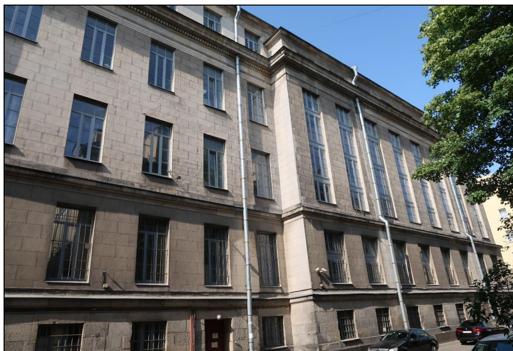
9. Выявленный объект культурного наследия «Здание Библиотеки Академии наук», расположенный по адресу: г. Санкт-Петербург, Василеостровский район, Биржевая линия, д. 1, Тифлисская ул., д. 1, литера А. Фасад по Биржевой линии Васильевского острова (западный фасад). Фрагмент.
