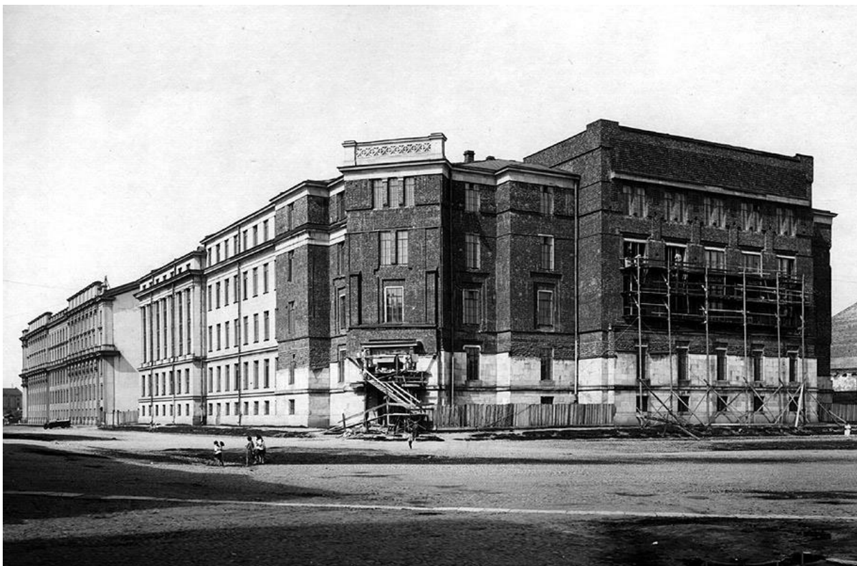
7. Здание Библиотеки Академии наук. Общий вид во время производства строительных и отделочных работ. Фотография. 1925 г.
