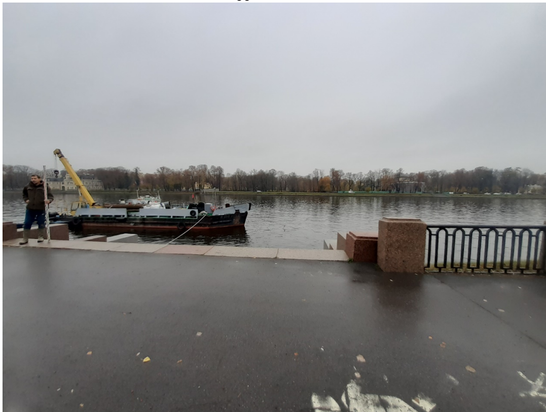
Рис. 26. Санкт-Петербург, земельный участок по объекту: «Дюкерный переход газопровода среднего давления с подводными газопроводами с Аптекарского острова на Каменный остров». Общий вид трассы. Точка съемки 5. Вид на северо-запад.
