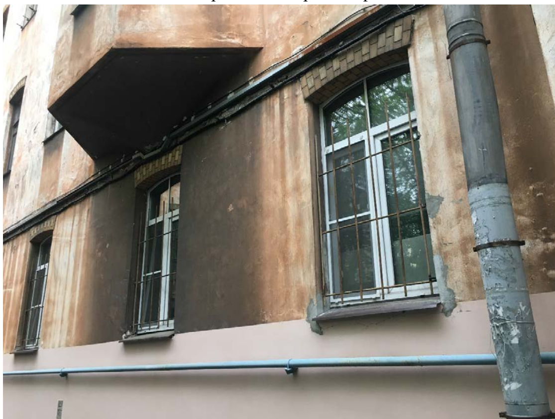
20. Фрагмент дворового фасада
