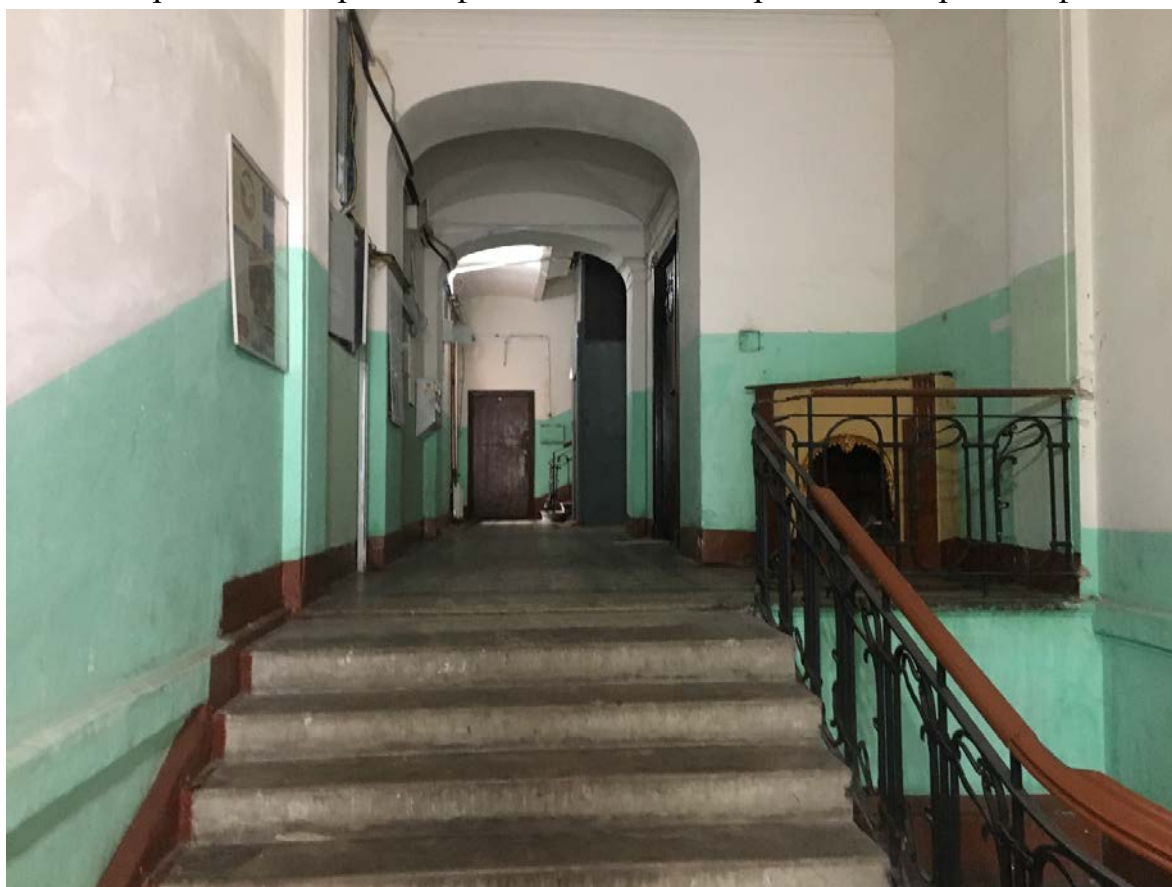
29. Вестибюль лестницы 1ЛК
