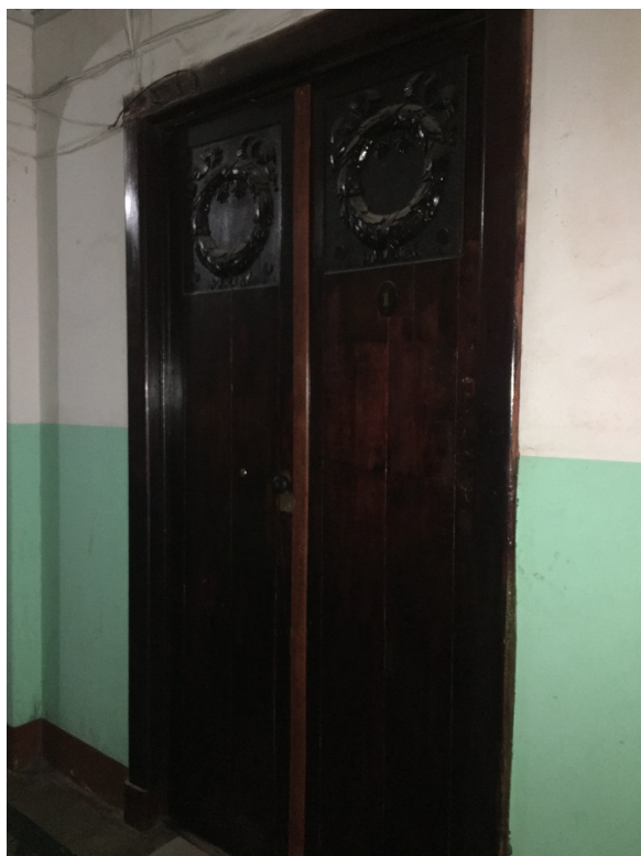
34. Дверь в квартиру №1
