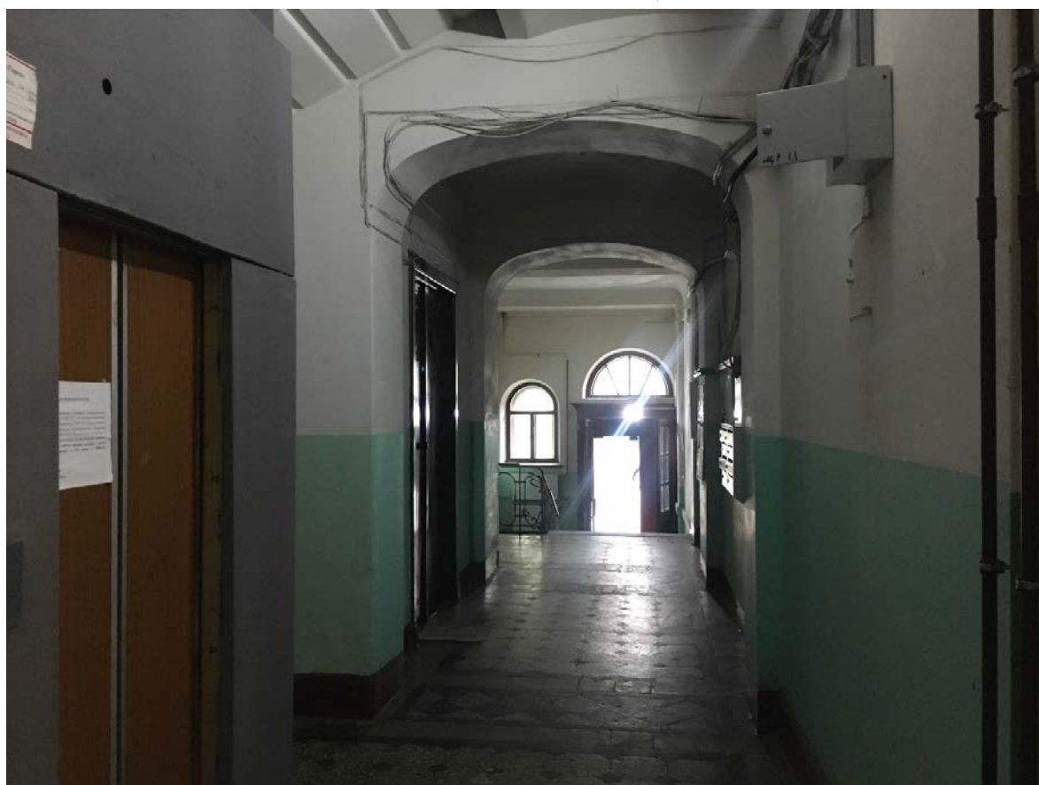
37. Вестибюль лестницы 1ЛК
