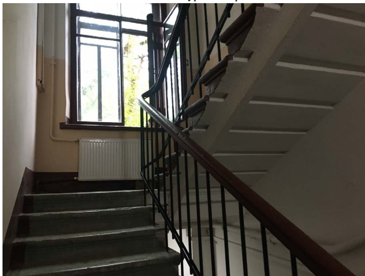
63. Лестница 2ЛК в уровне первого этажа
