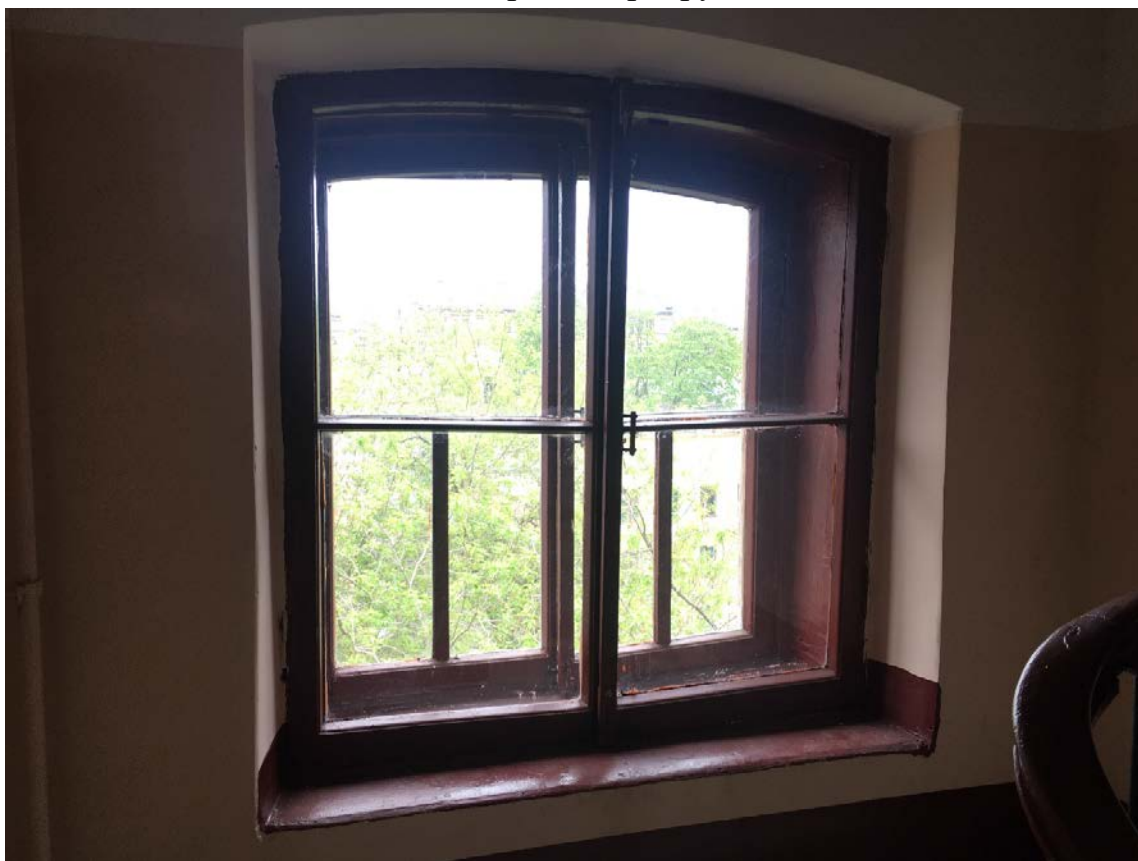
69. Оконный проем на лестнице 2ЛК в уровне четвертого этажа
