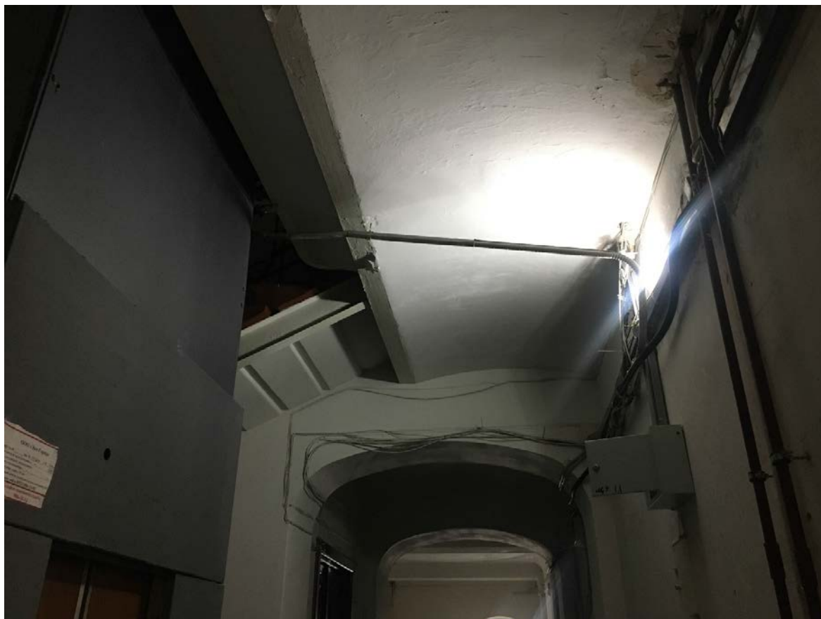
38. Вестибюль лестницы 1ЛК
