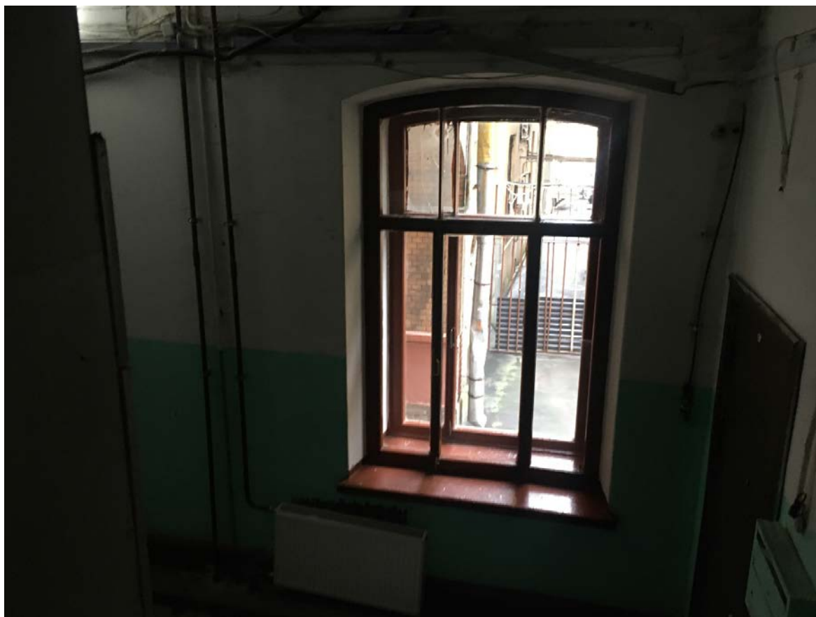
39. Вестибюль лестницы 1ЛК
