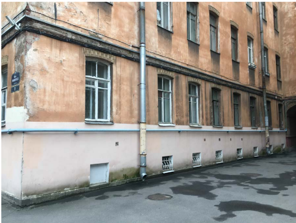
15. Фрагмент дворового фасада
