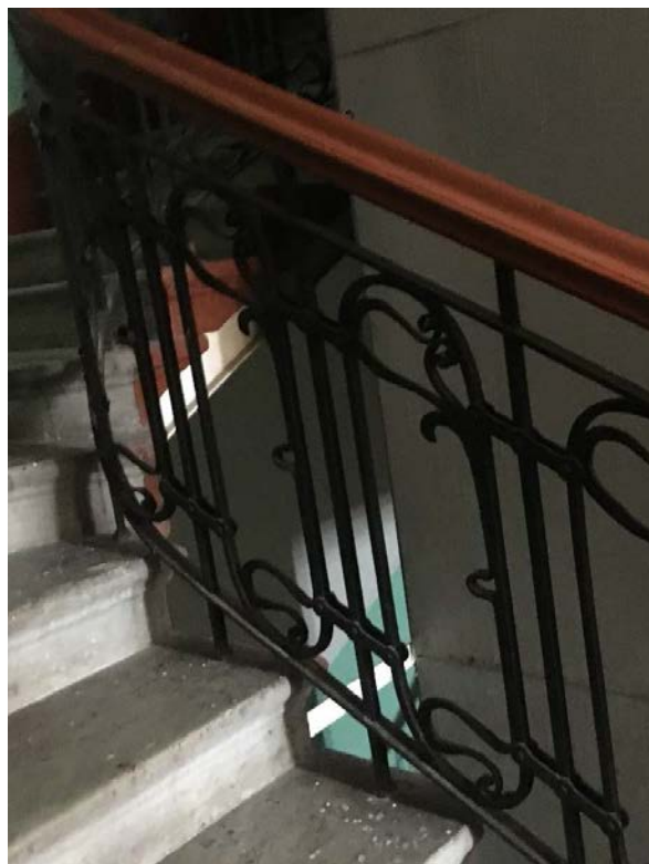
43. Ограждение лестницы 1ЛК
