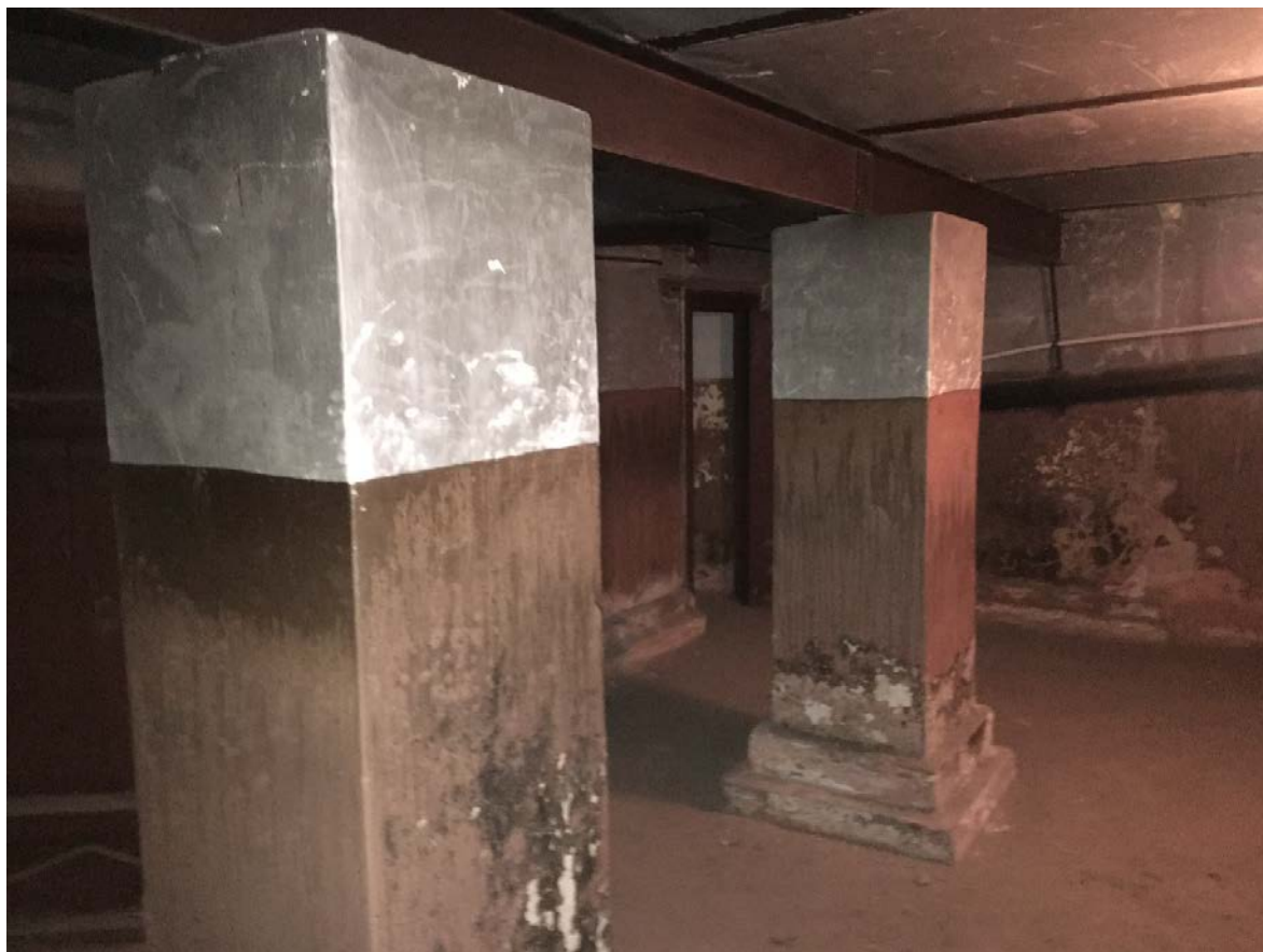
56. Интерьер помещения 1-Н на цокольном этаже
