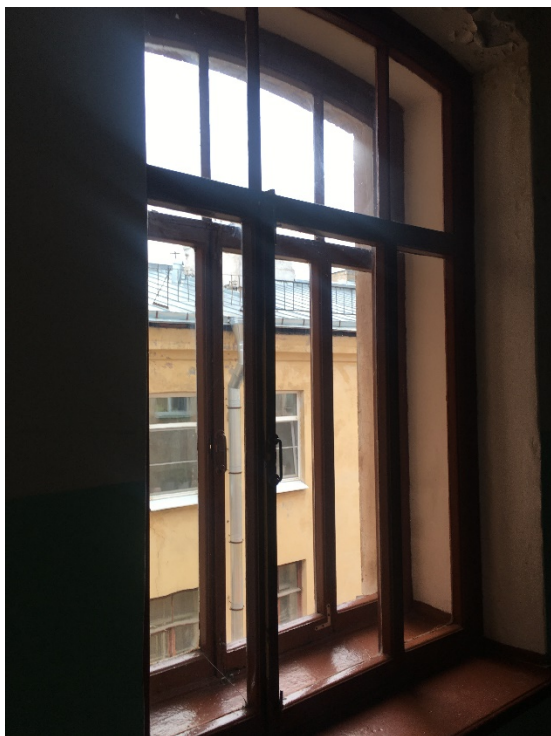
51. Оконный проем на лестнице 1ЛК в уровне четвертого этажа
