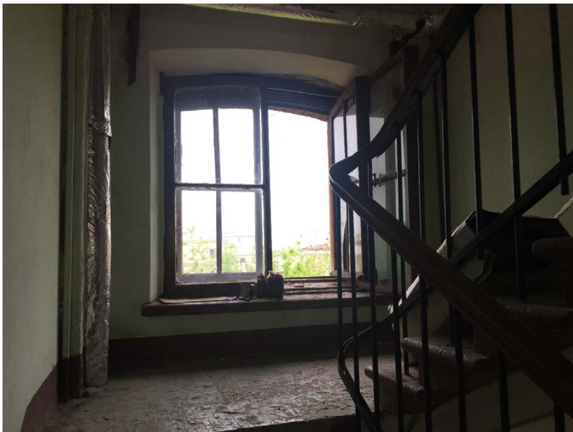
78. Лестница ЗЛК в уровне четвертого этажа
