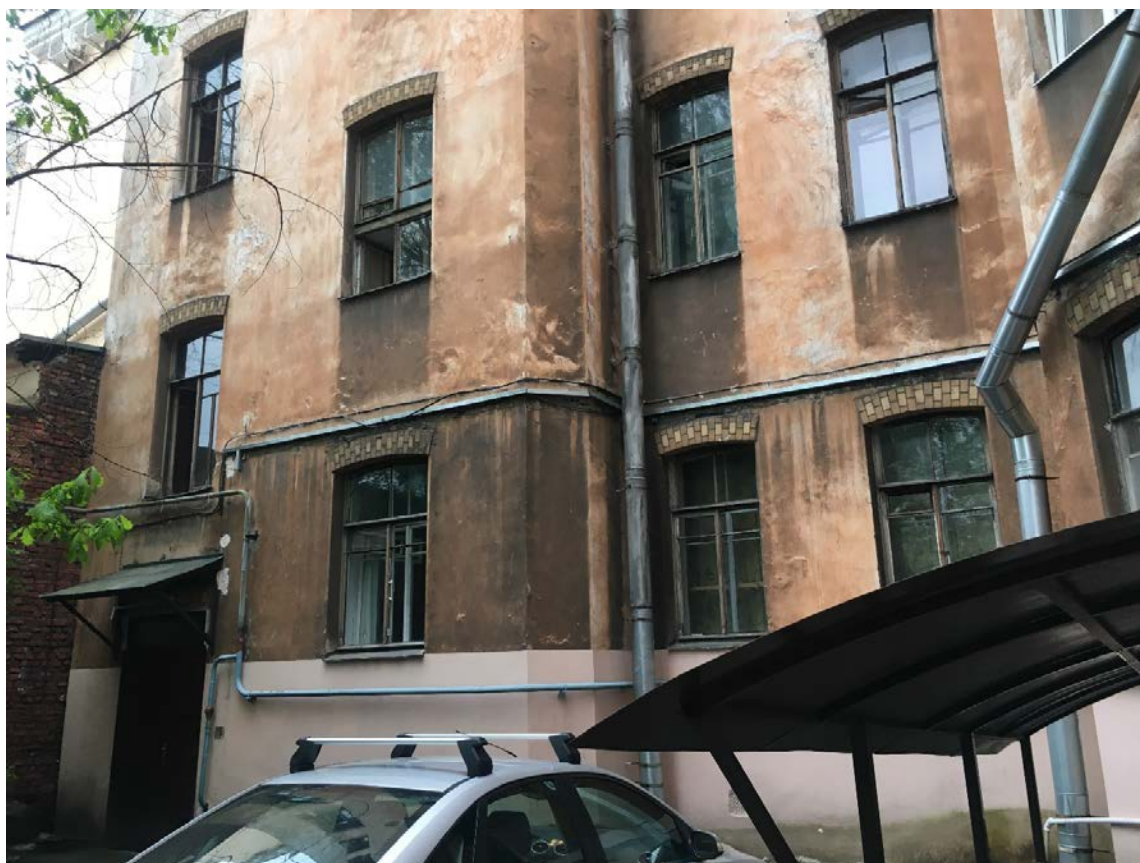
25. Фрагмент дворового фасада
