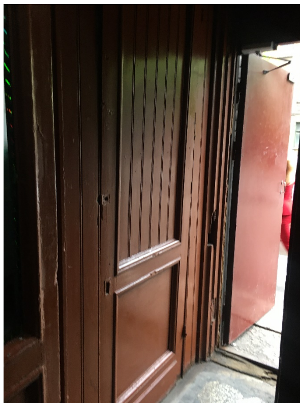
31. Тамбур лестницы 1ЛК
