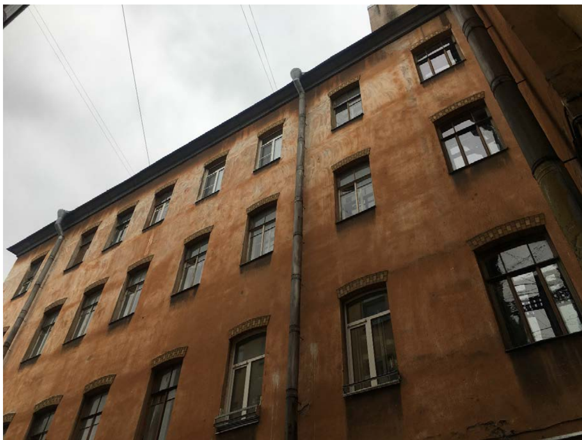
13. Фрагмент дворового фасада
