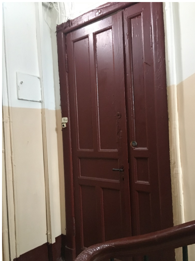
68. Дверь в квартиру №16
