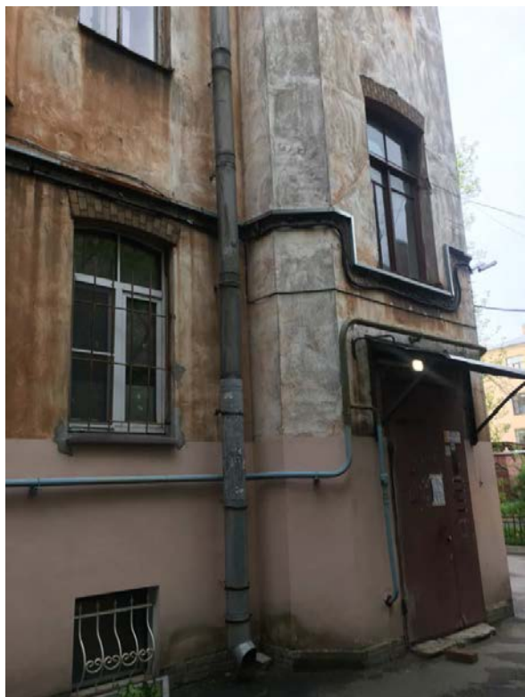
27. Фрагмент дворового фасада
