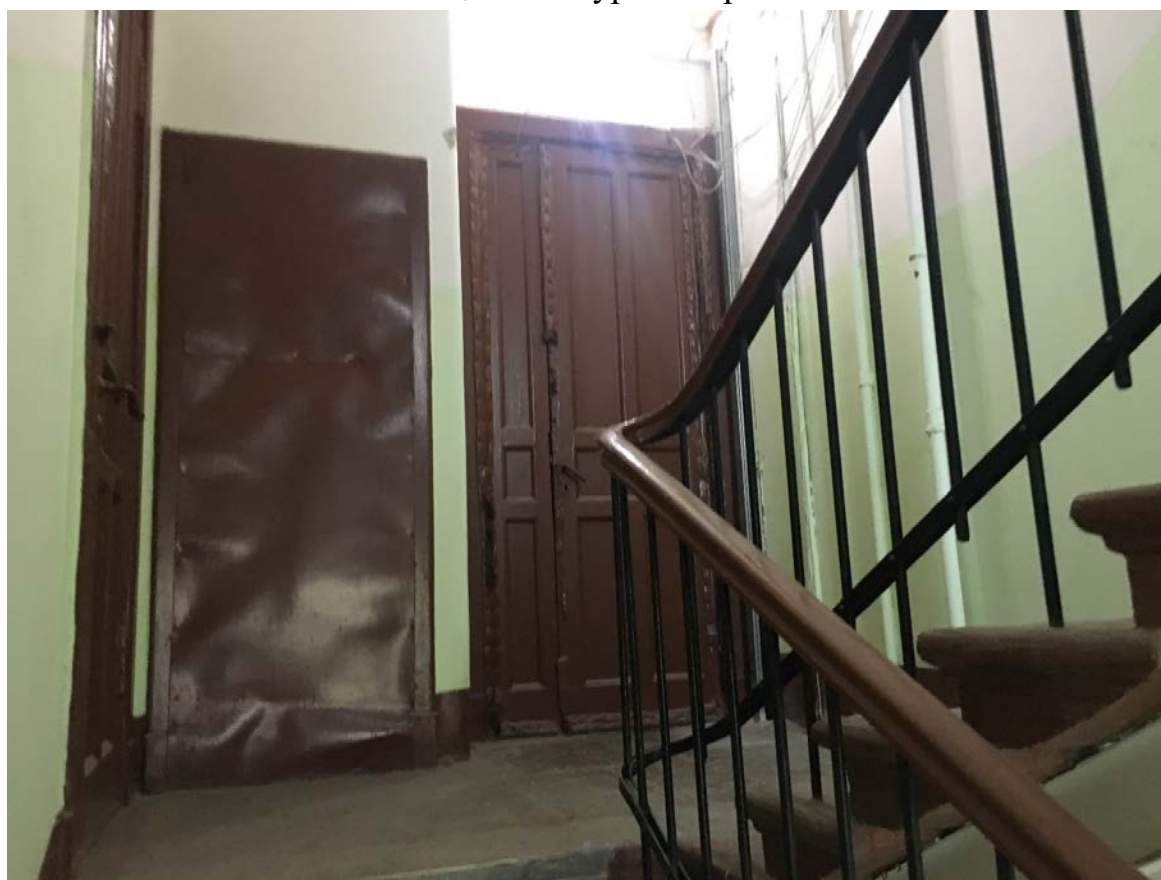
77. Лестница ЗЛК в уровне четвертого этажа
