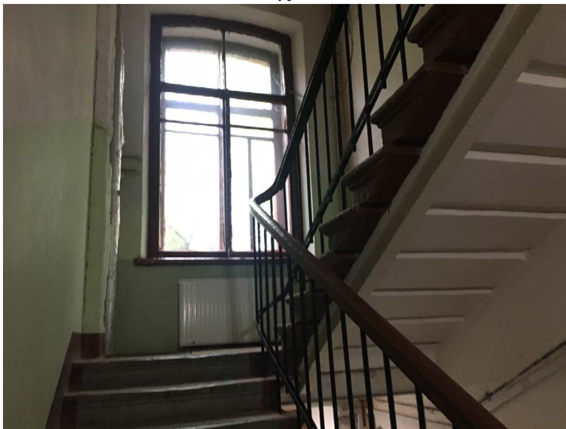
73. Лестница ЗЛК в уровне первого этажа
