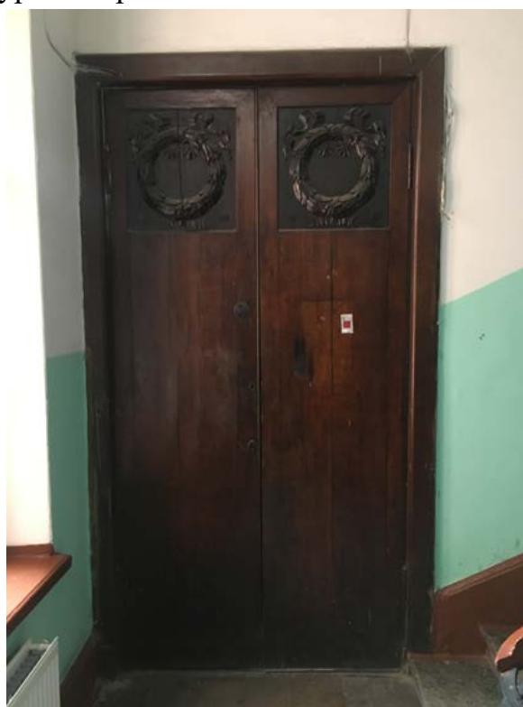
47. Дверь в квартиру №4
