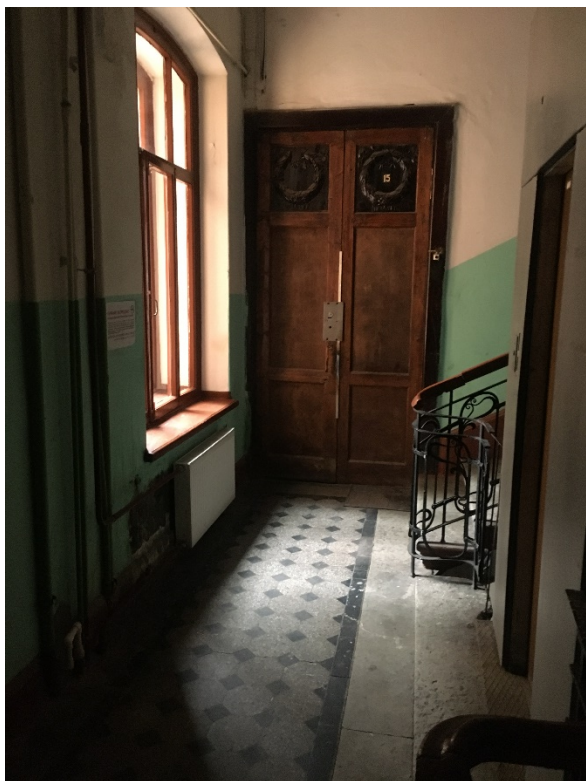
42. Лестница 1ЛК в уровне второго этажа
