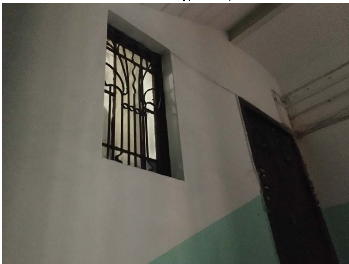
41. Лестница 1ЛК в уровне второго этажа
