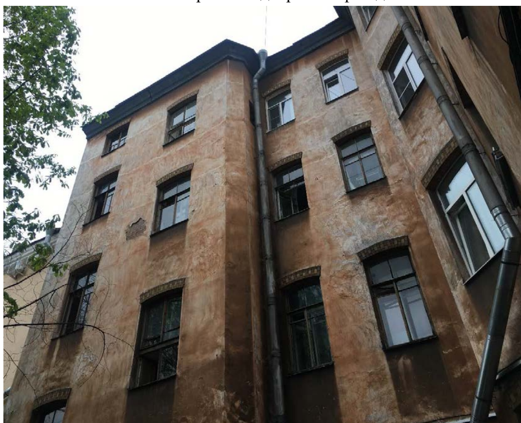
26. Фрагмент дворового фасада
