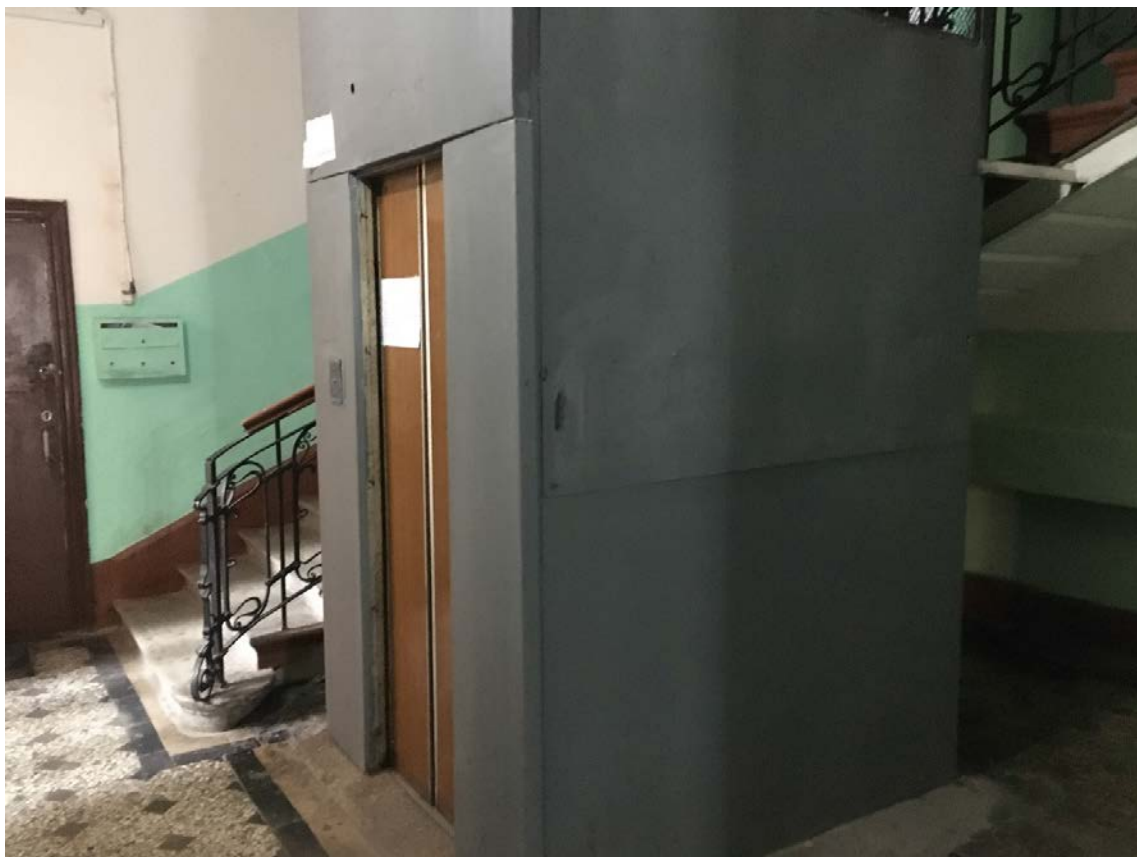
36. Вестибюль лестницы 1ЛК
