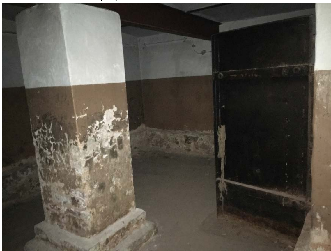
57. Интерьер помещения 1-Н на цокольном этаже
