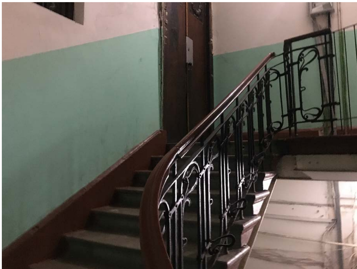
45. Лестница 1ЛК в уровне третьего этажа
