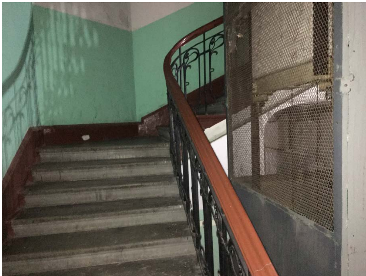
40. Лестница 1ЛК в уровне первого этажа
