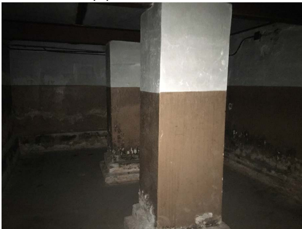
59. Интерьер помещения 1-Н на цокольном этаже
