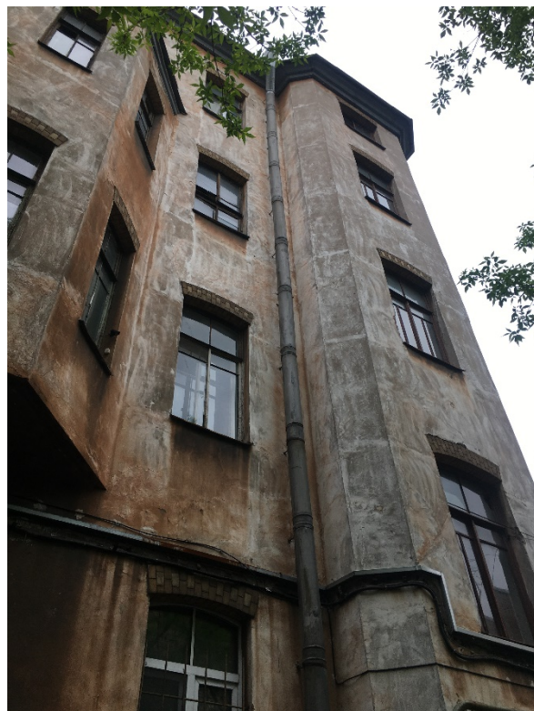
28. Фрагмент дворового фасада
