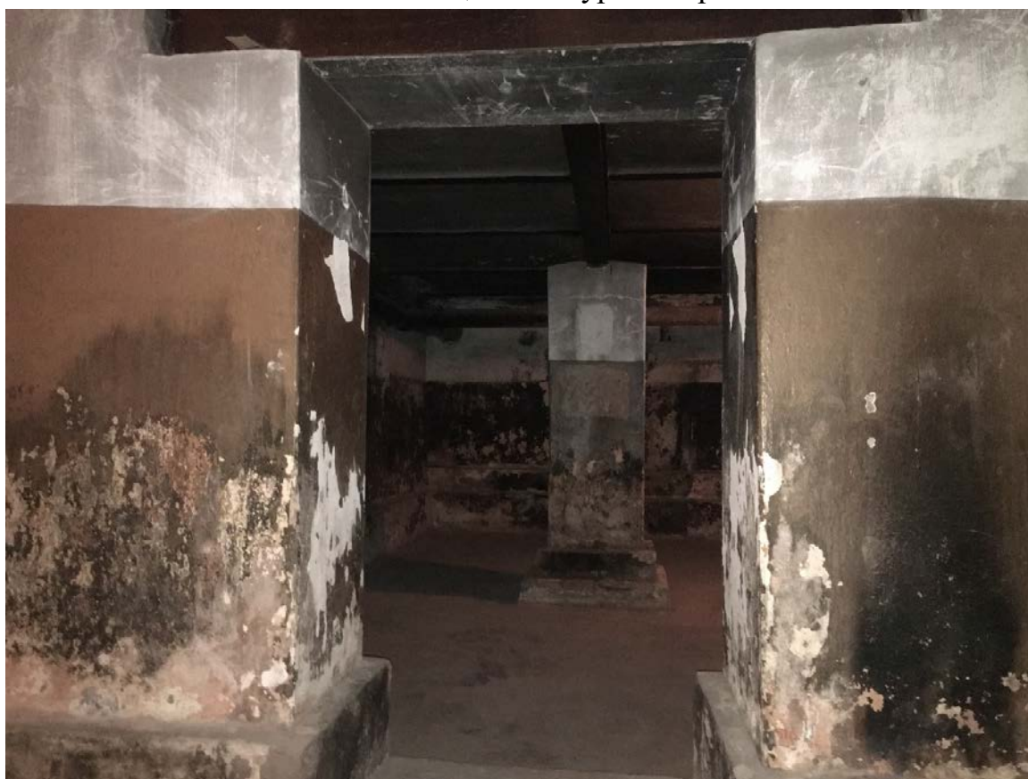
55. Интерьер помещения 1-Н на цокольном этаже
