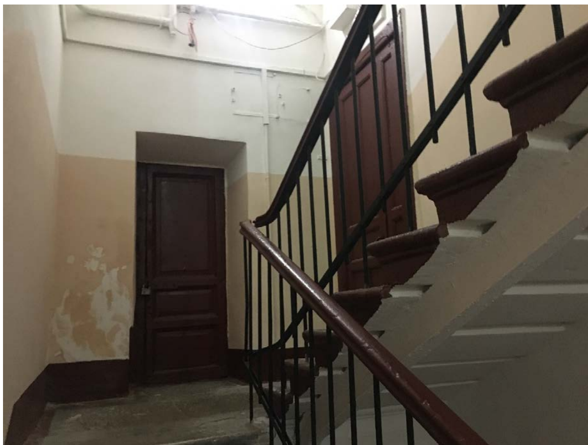
62. Лестница 2ЛК в уровне первого этажа
