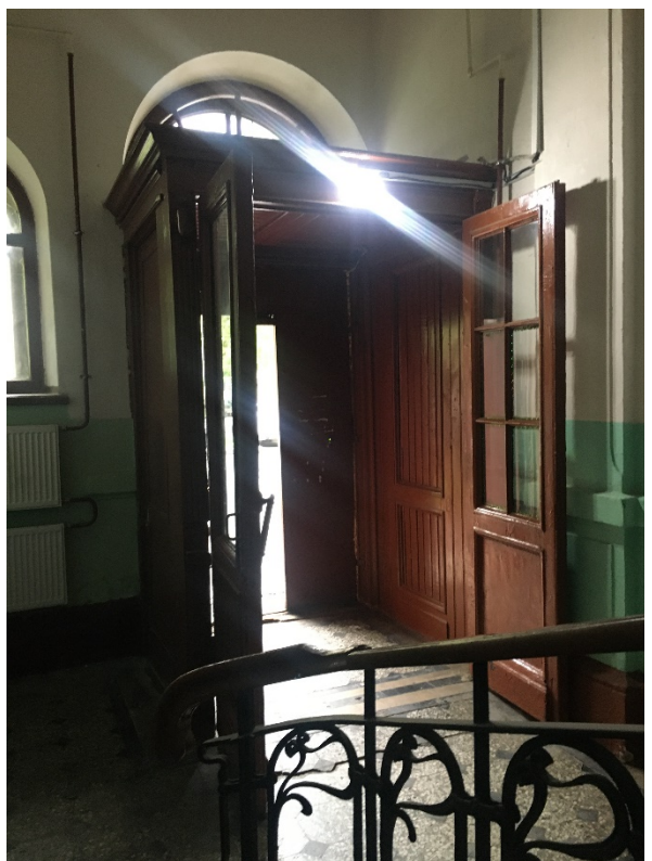
30. Тамбур лестницы 1ЛК
