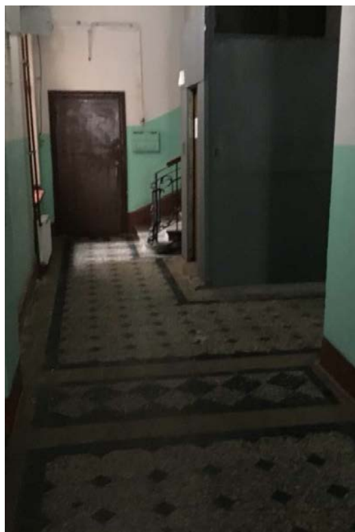
35. Вестибюль лестницы 1ЛК
