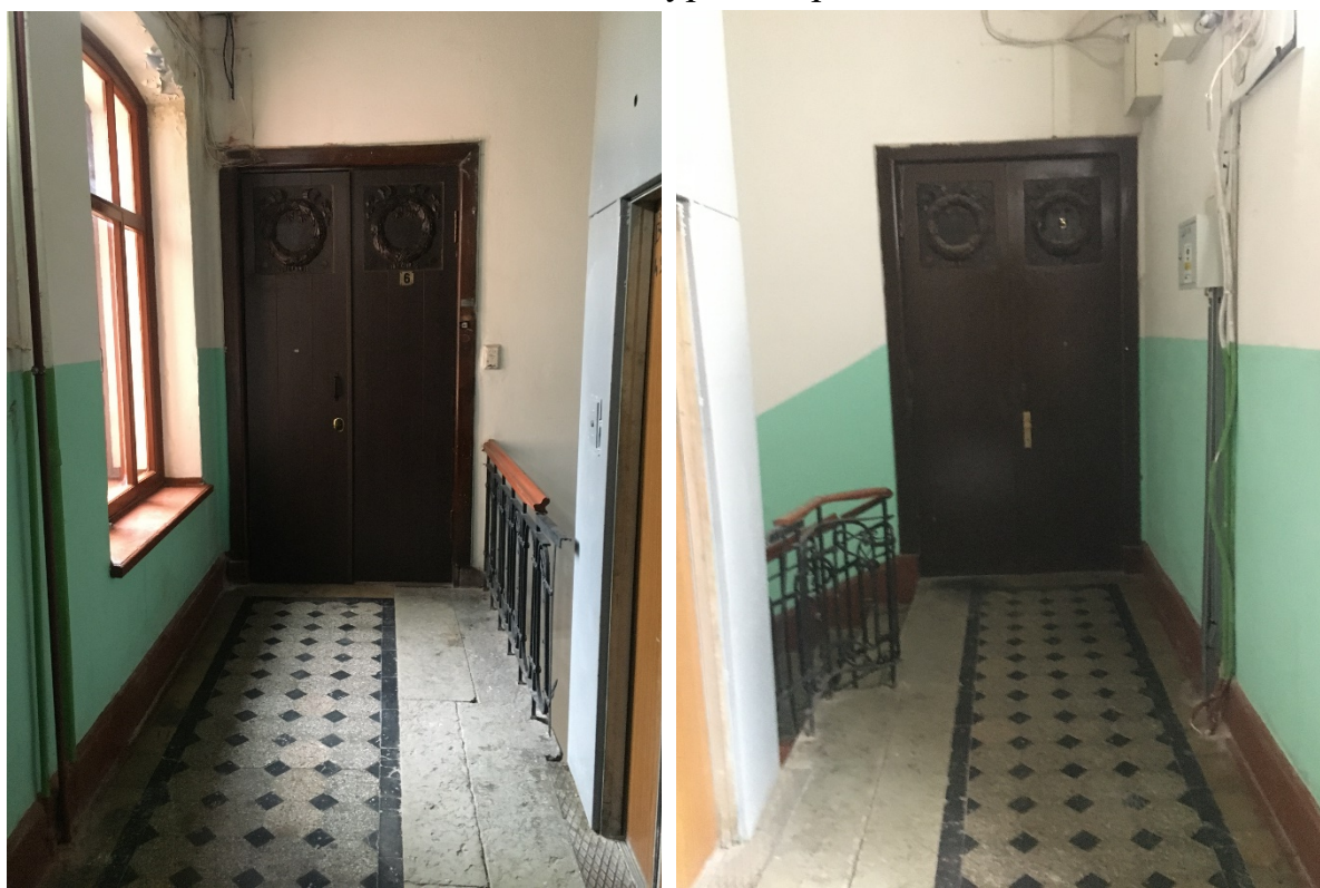
49. Лестница 1ЛК в уровне четвертого этажа
