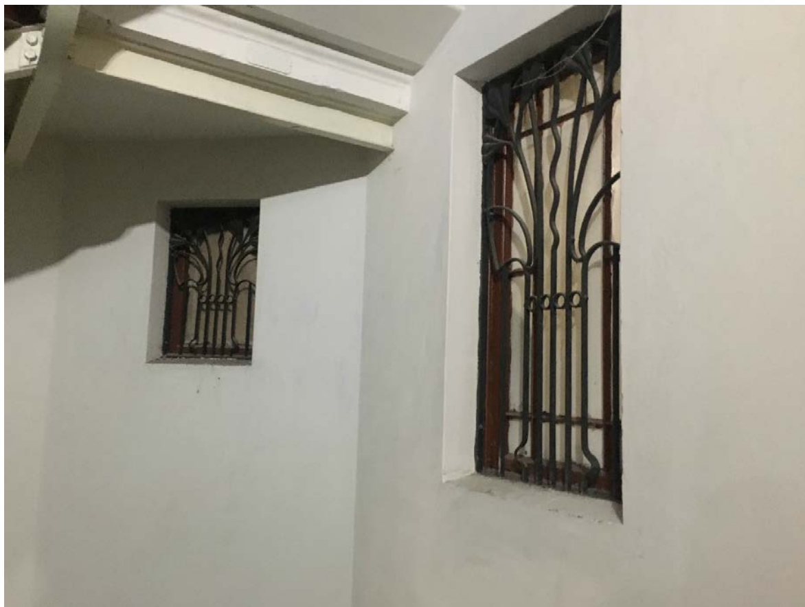
54. Окна на лестнице 1ЛК в уровне третьего этажа
