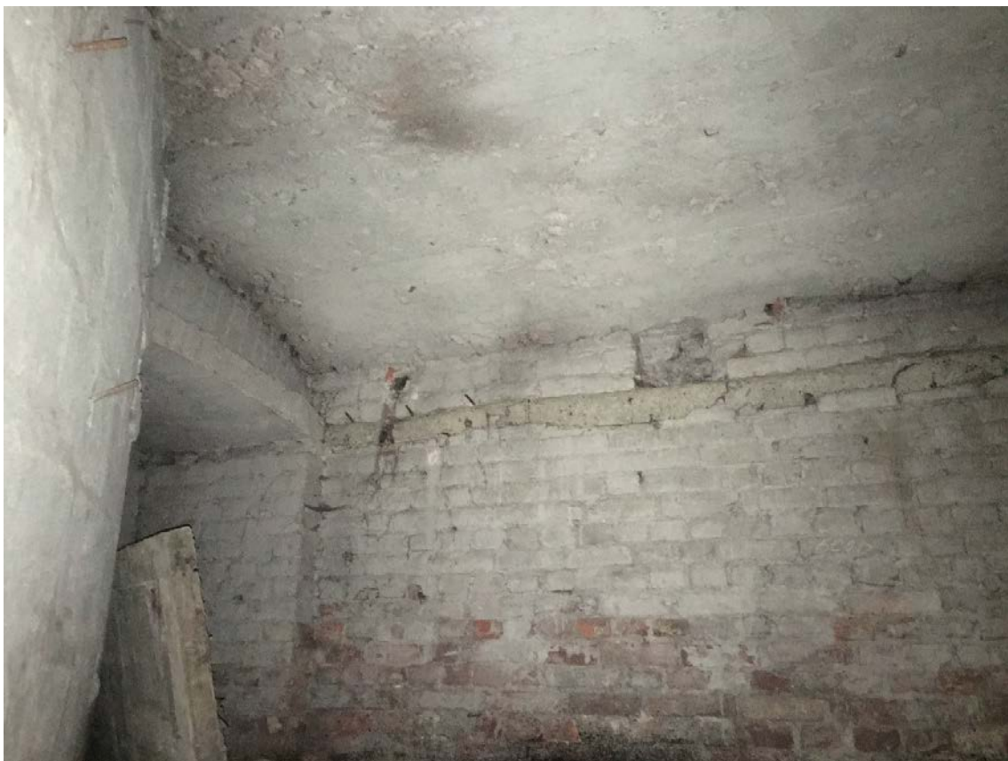
58. Интерьер помещения 1-Н на цокольном этаже
