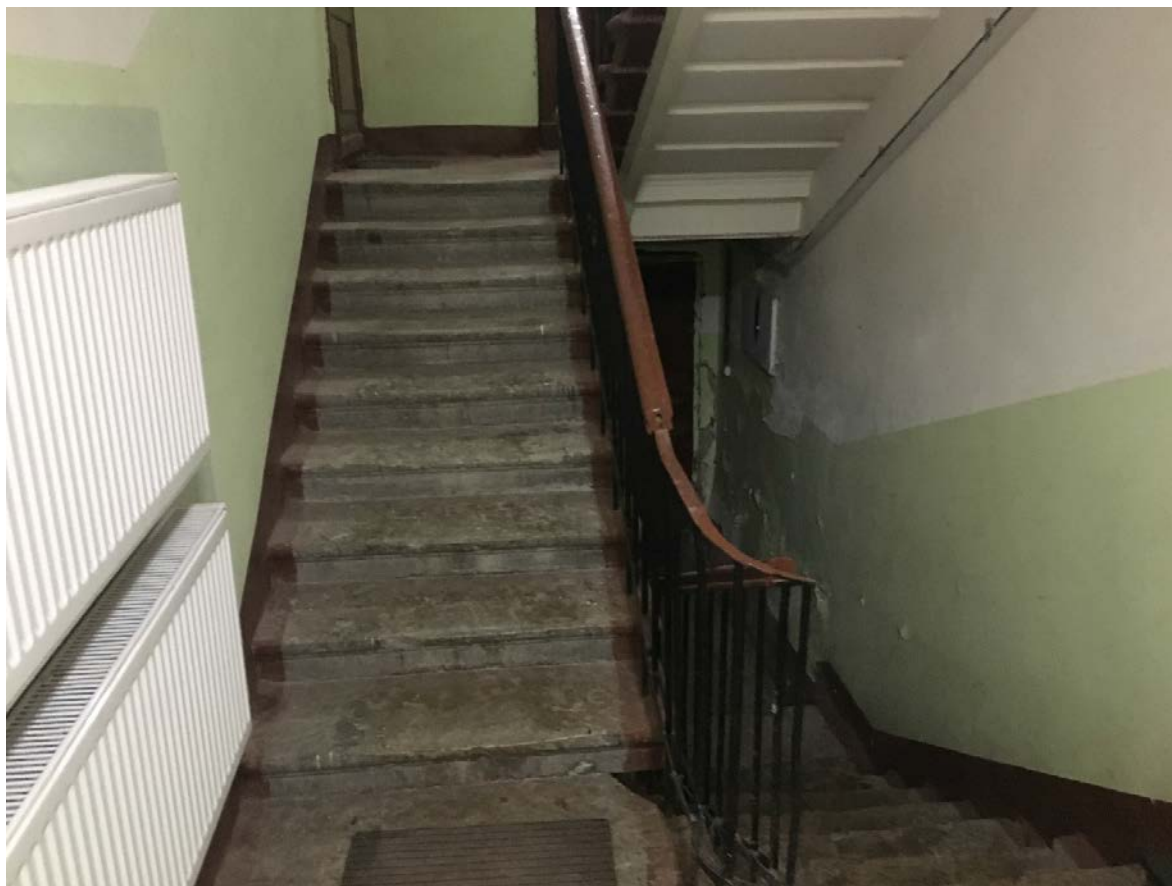
72. Лестница ЗЛК в уровне цокольного этажа
