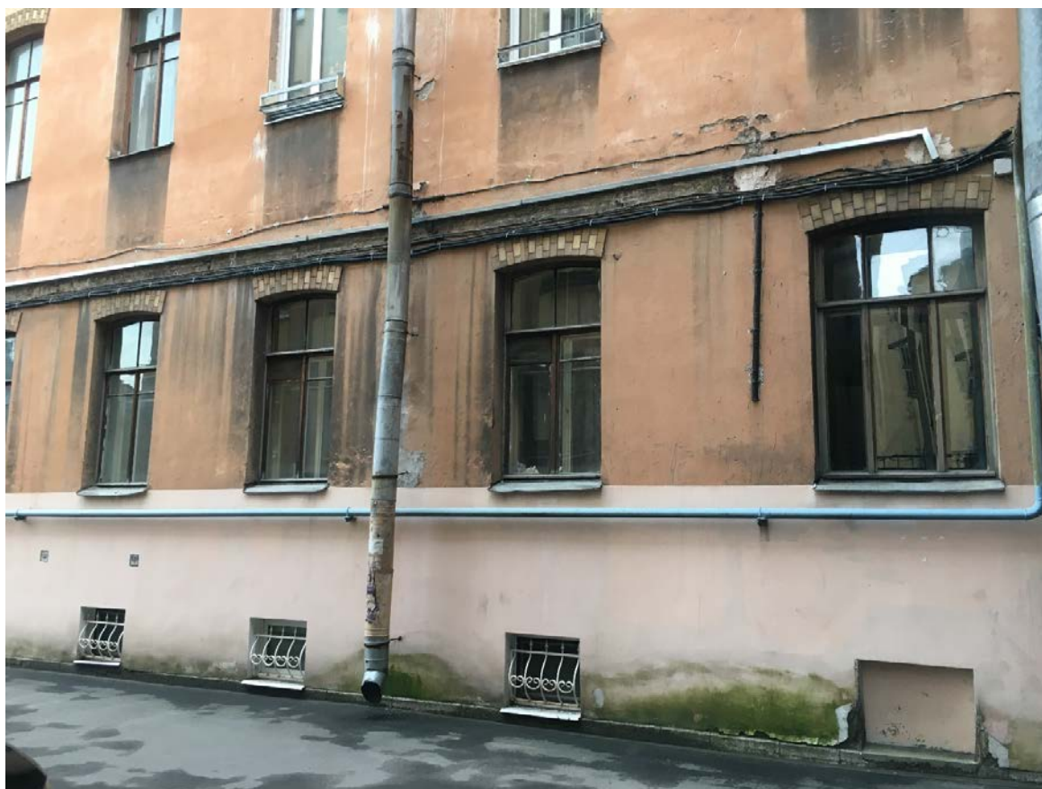
11. Фрагмент дворового фасада
