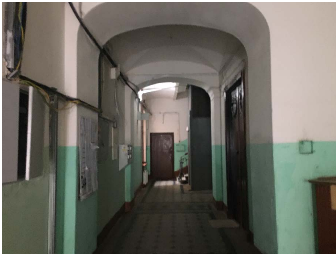
33. Вестибюль лестницы 1ЛК
