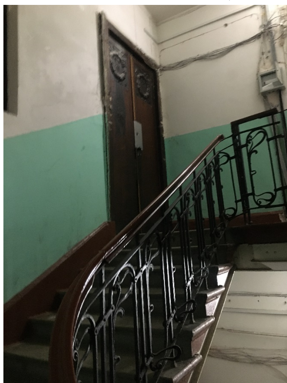
46. Лестница 1ЛК в уровне третьего этажа
