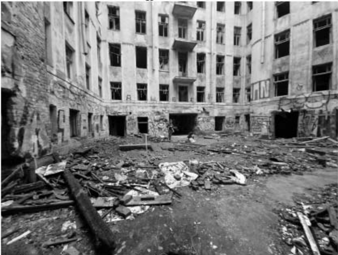
Рис. 24. СПб-2022. Петроградский район, Большая Пушкарская ул., д. 7. Общий вид участка обследования. Шурф 1. Общий вид до начала работ. Вид с севера
