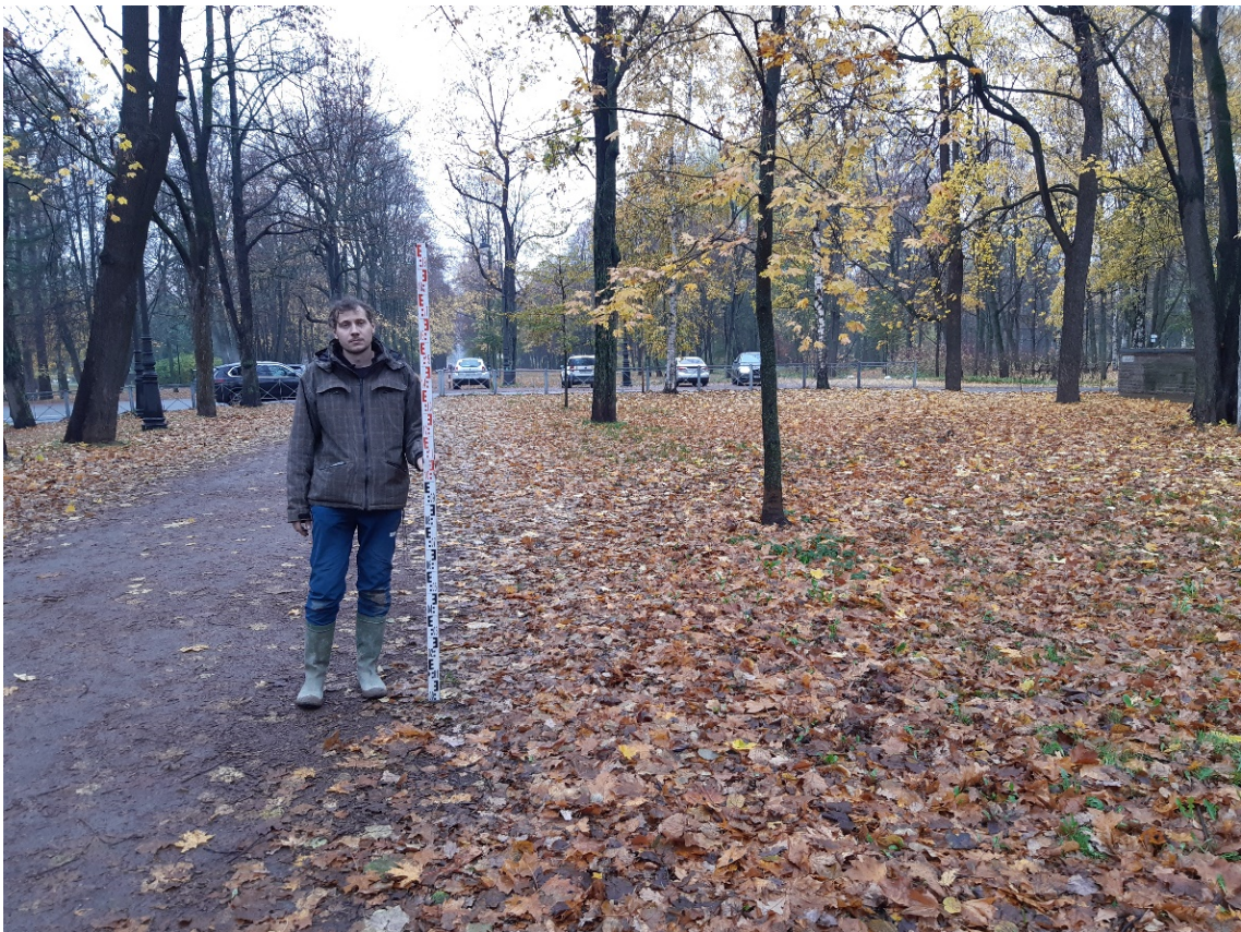
Рис. 21. Санкт-Петербург, Реконструкция газопровода среднего давления между Аптекарским и Каменным островами. Общий вид трассы. Точка съемки 4. Вид на северо-запад.
