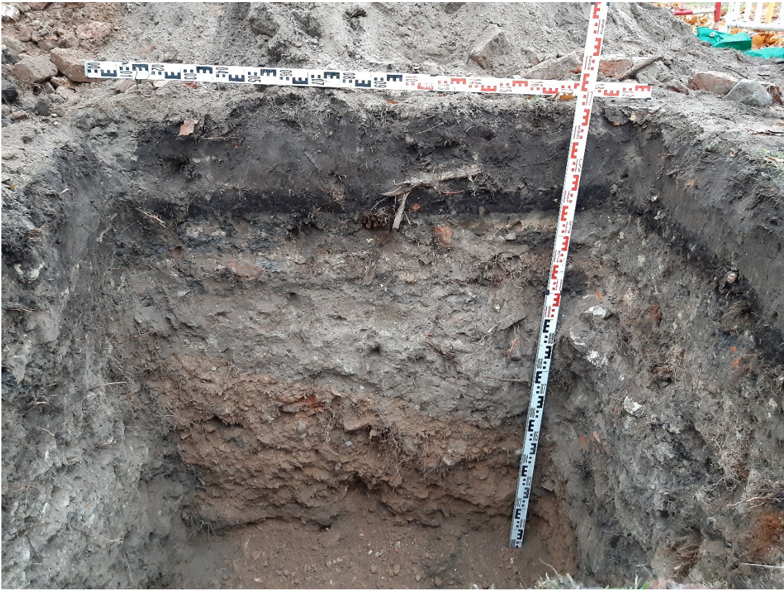
Рис. 30. Санкт-Петербург, Реконструкция газопровода среднего давления между Аптекарским и Каменным островами. Шурф 1. Фотофиксация стратиграфии южной стенки.
