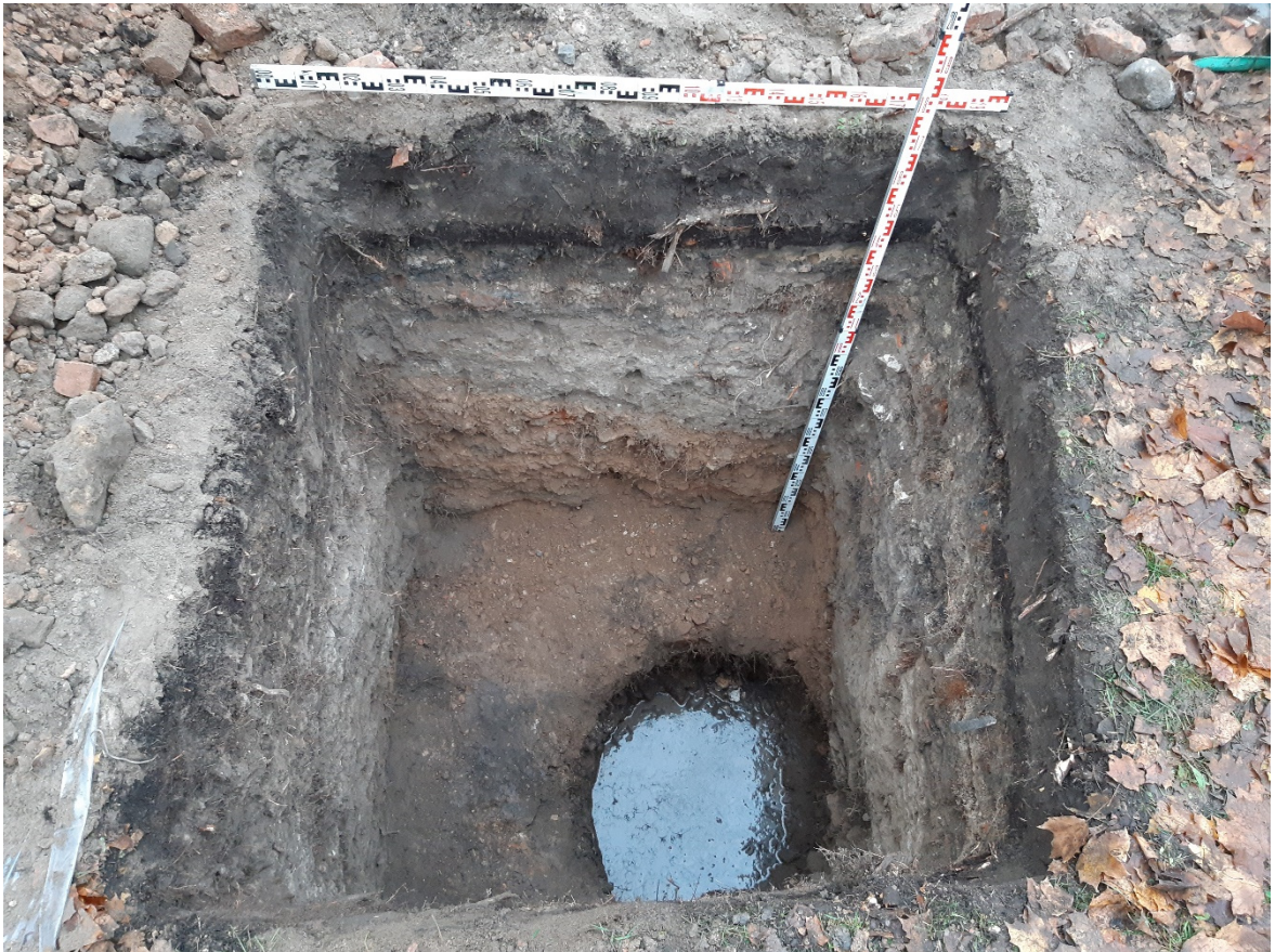
Рис. 26. Санкт-Петербург, Реконструкция газопровода среднего давления между Аптекарским и Каменным островами. Шурф 1. Фотофиксация по уровню строительного мусора и грунтовым водам. Уровень остановки работ. Вид на юг.
