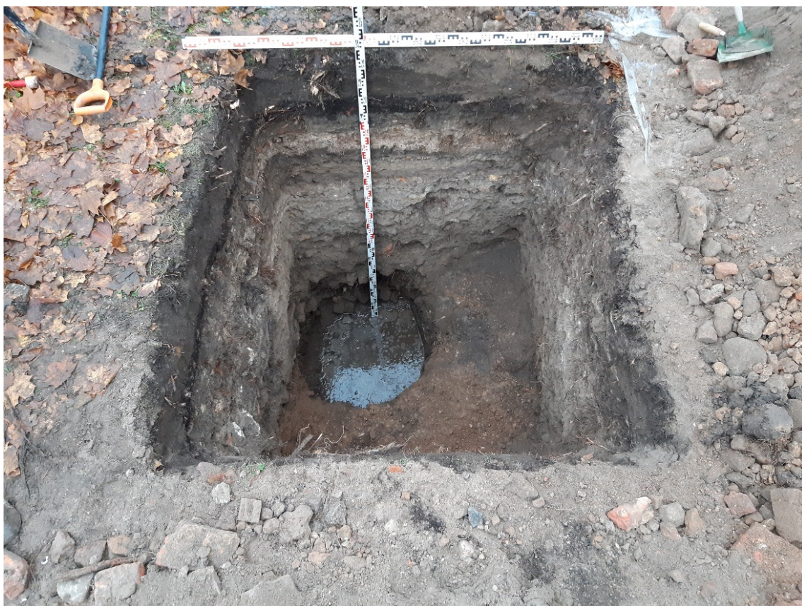
Рис. 25. Санкт-Петербург, Реконструкция газопровода среднего давления между Аптекарским и Каменным островами. Шурф 1. Фотофиксация по уровню строительного мусора и грунтовыми водами. Уровень остановки работ. Вид на север.
