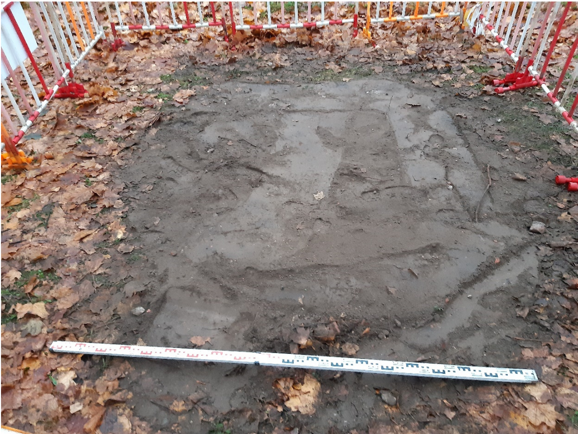
Рис. 33. Санкт-Петербург, Реконструкция газопровода среднего давления между Аптекарским и Каменным островами. Шурф 1 Фотофиксация после рекультивации. Вид на север.
