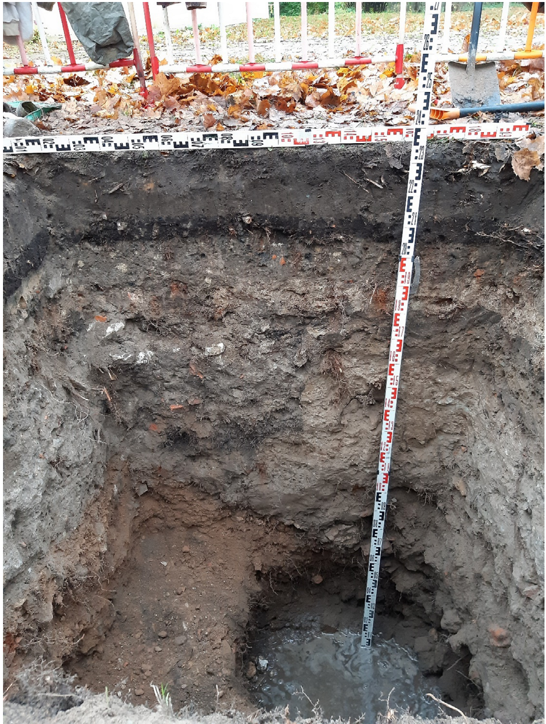
Рис. 29. Санкт-Петербург, Реконструкция газопровода среднего давления между Аптекарским и Каменным островами. Шурф 1. Фотофиксация стратиграфии западной стенки.
