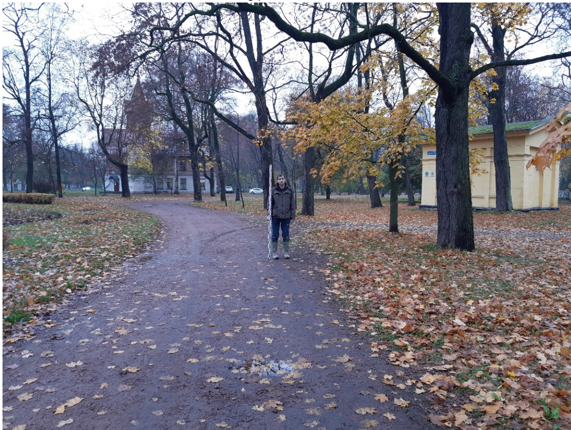
Рис. 18. Санкт-Петербург, Реконструкция газопровода среднего давления между Аптекарским и Каменным островами. Общий вид трассы. Точка съемки 1. Вид на запад.
