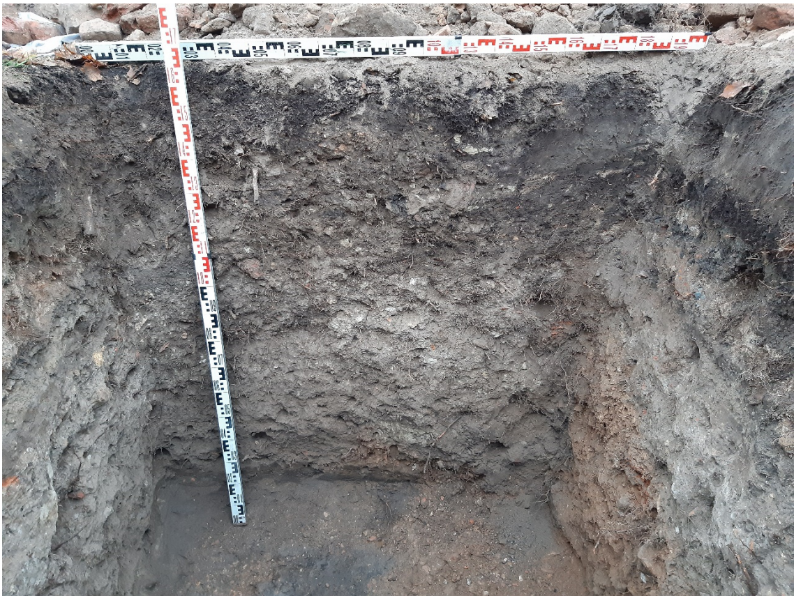
Рис. 31. Санкт-Петербург, Реконструкция газопровода среднего давления между Аптекарским и Каменным островами. Шурф 1. Фотофиксация стратиграфии восточной стенки.
