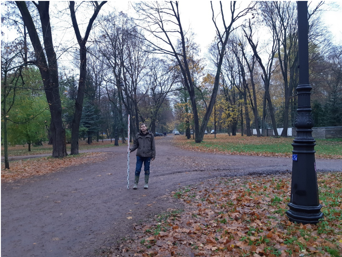
Рис. 20. Санкт-Петербург, Реконструкция газопровода среднего давления между Аптекарским и Каменным островами. Общий вид трассы. Точка съемки 3. Вид на северо-запад.
