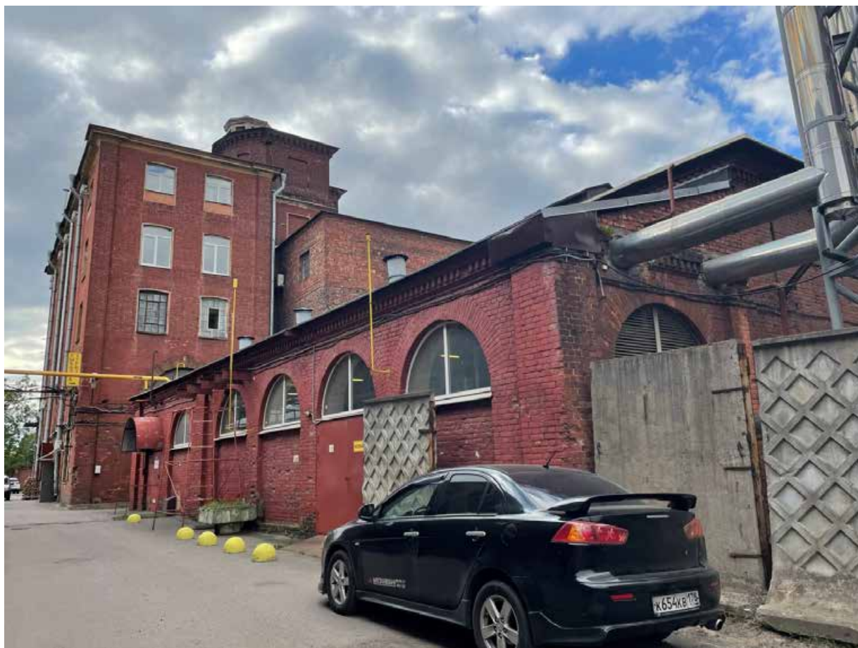
29. Фрагмент южного фасада прядильного корпуса
