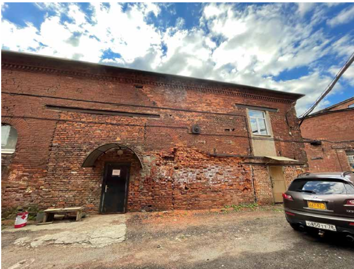
31. Фрагмент восточного фасада
