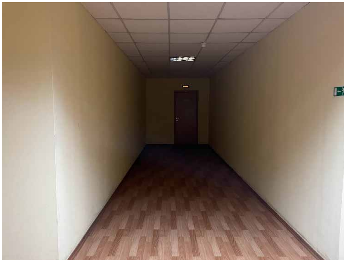
160. Фрагмент интерьера пятого этажа
