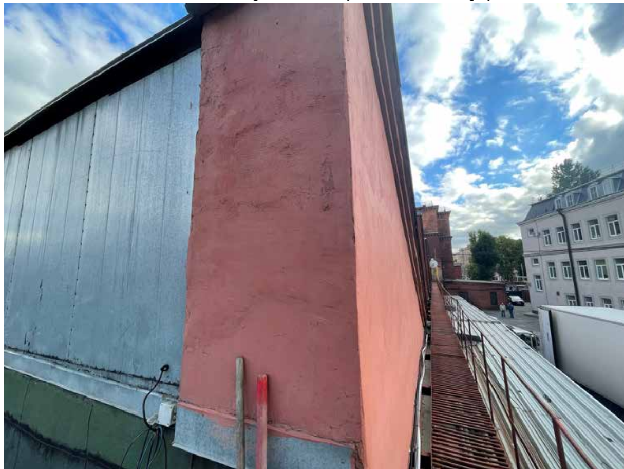
16. Вид вдоль крыши шедового корпуса
