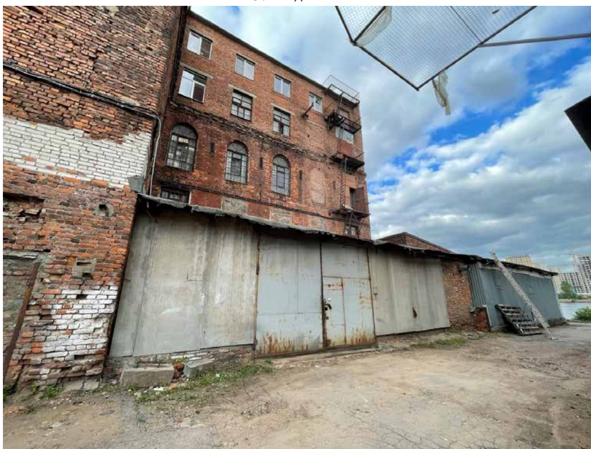
38. Фрагмент южного фасада ткацкого корпуса
