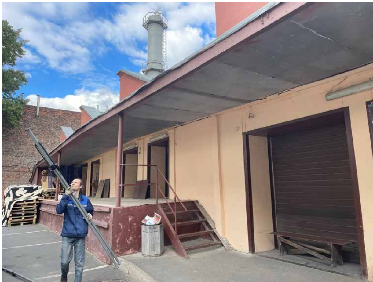
5. Фрагмент западного фасада шедового корпуса
