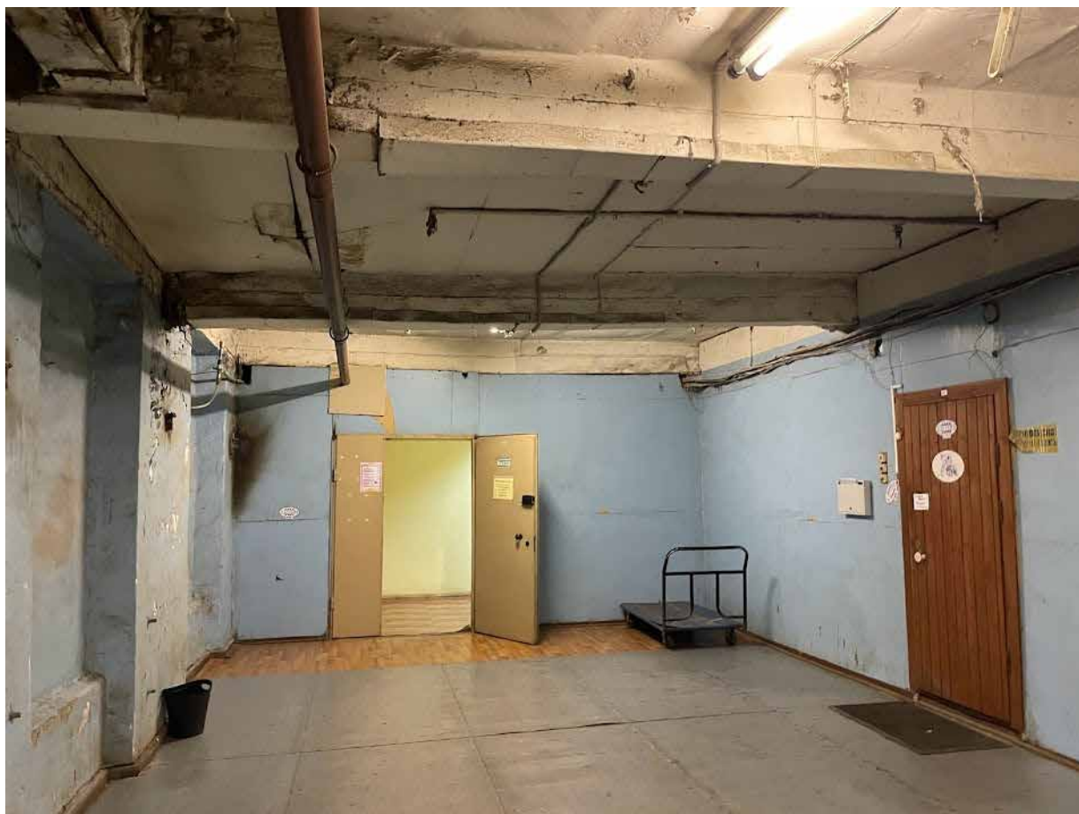
166. Фрагмент интерьера пятого этажа
