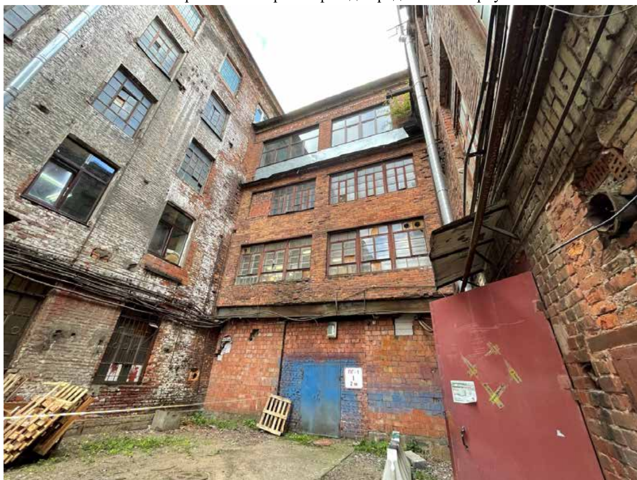
42. Вид на переход между корпусами
