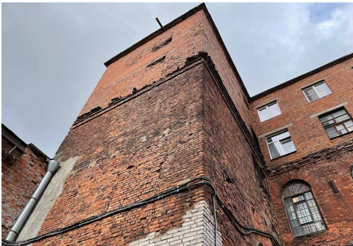
39. Фрагмент южного фасада ткацкого корпуса
