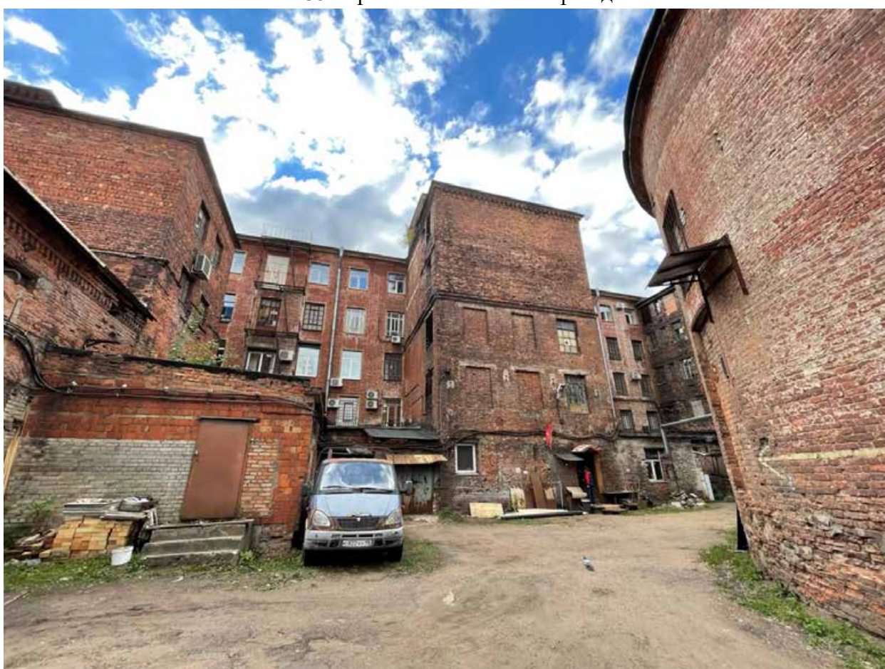
36. Фрагмент восточного фасада
