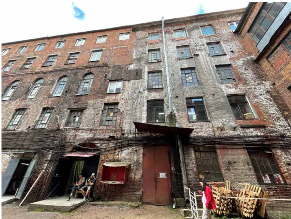
41. Фрагмент северного фасада прядильного корпуса
