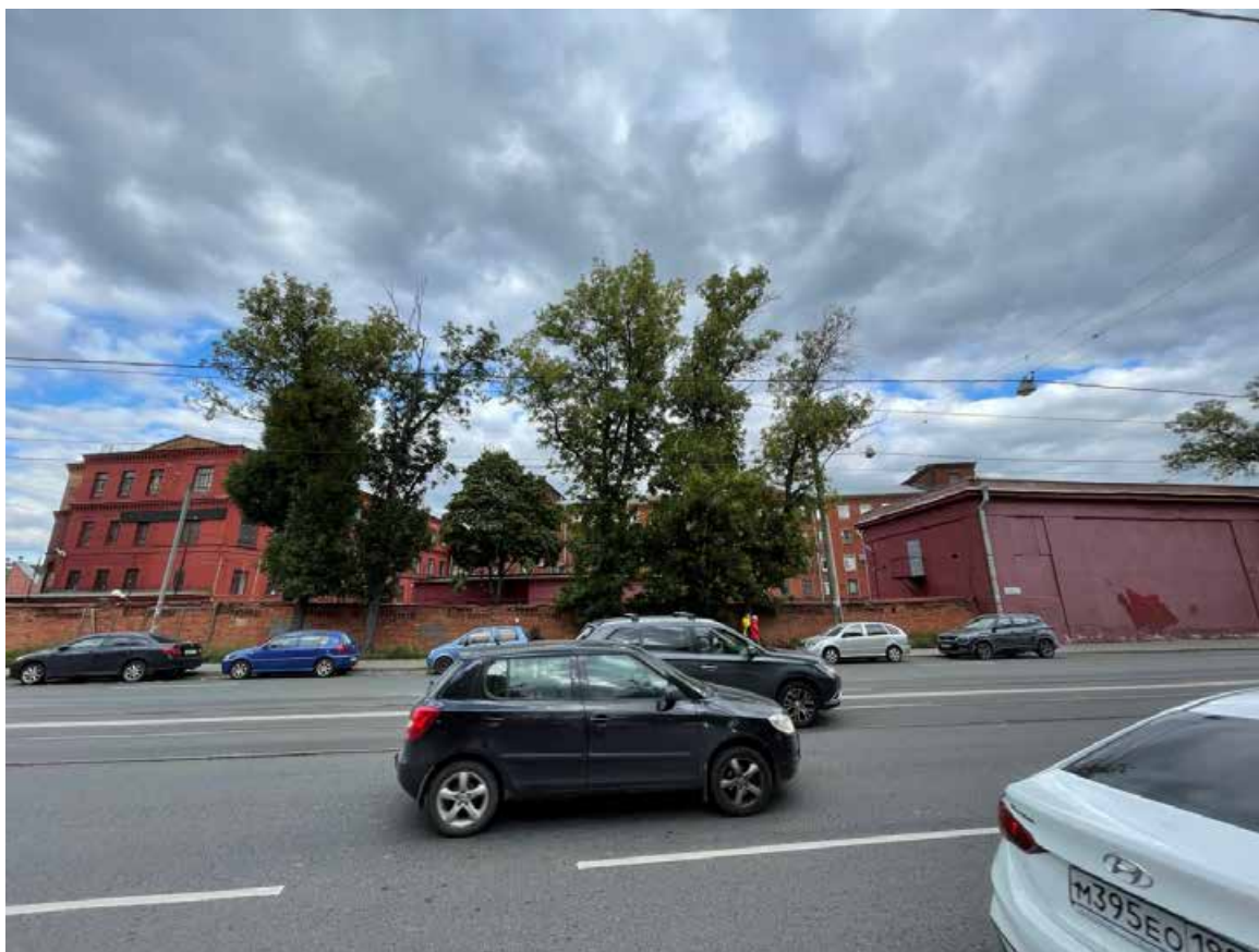
1. Общий вид с проспекта Обуховской обороны
