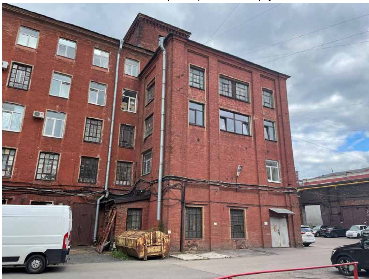
26. Фрагмент западного фасада прядильного корпуса
