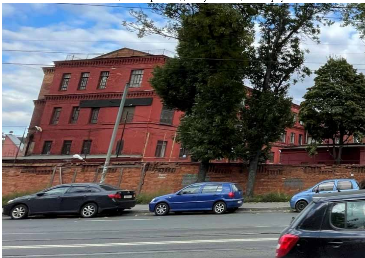
20. Вид на торцевой фасад ткацкого корпуса с проспекта Обуховской обороны
