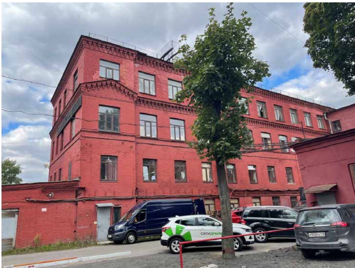
21. Фрагмент южного фасада ткацкого корпуса
