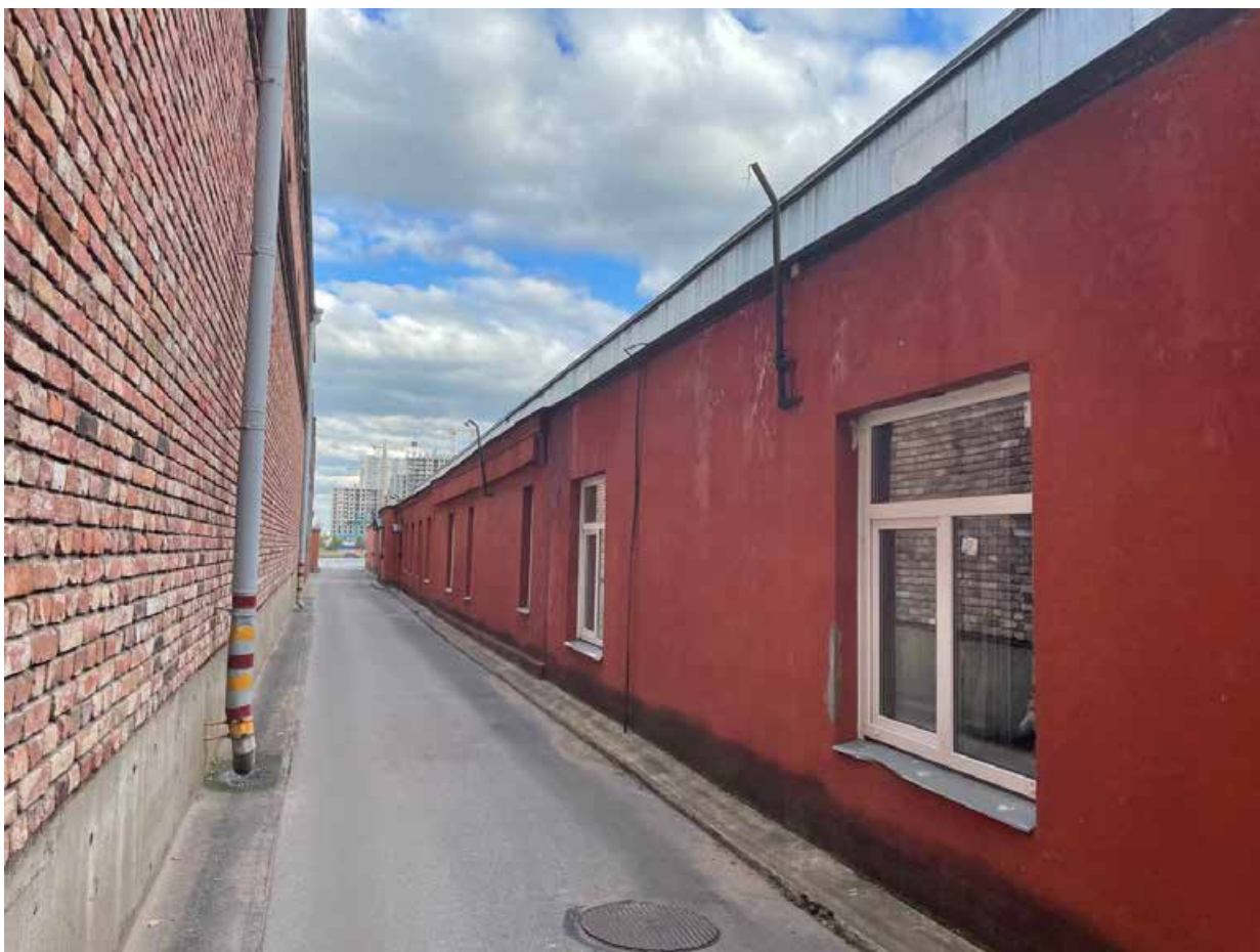
13. Фрагмент северного фасада шедового корпуса
