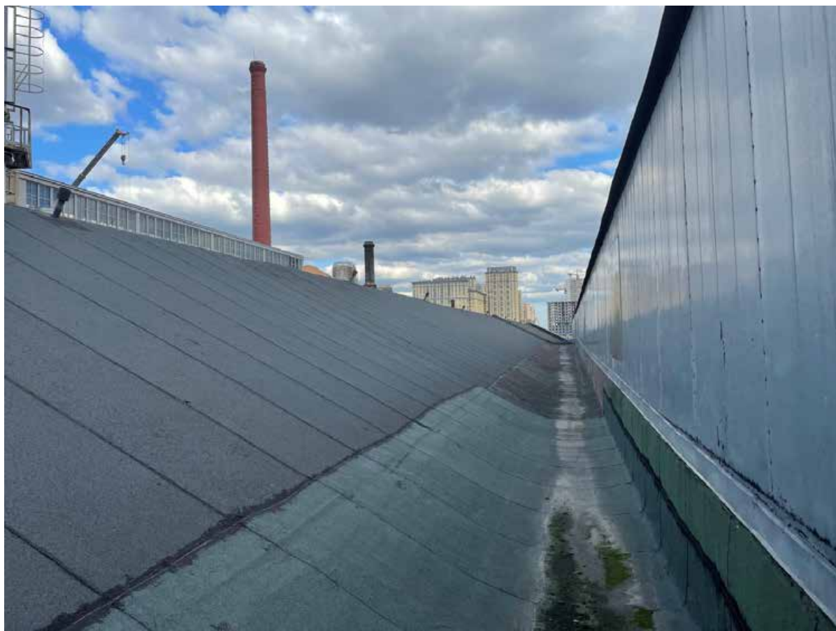
17. Фрагмент крыши шедового корпуса
