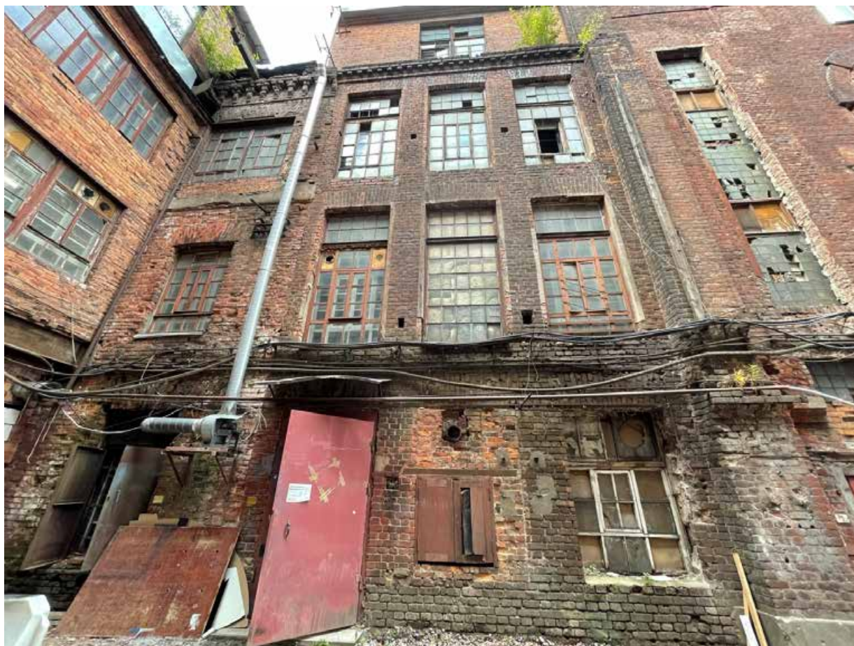
43. Фрагмент южного фасада прядильного корпуса
