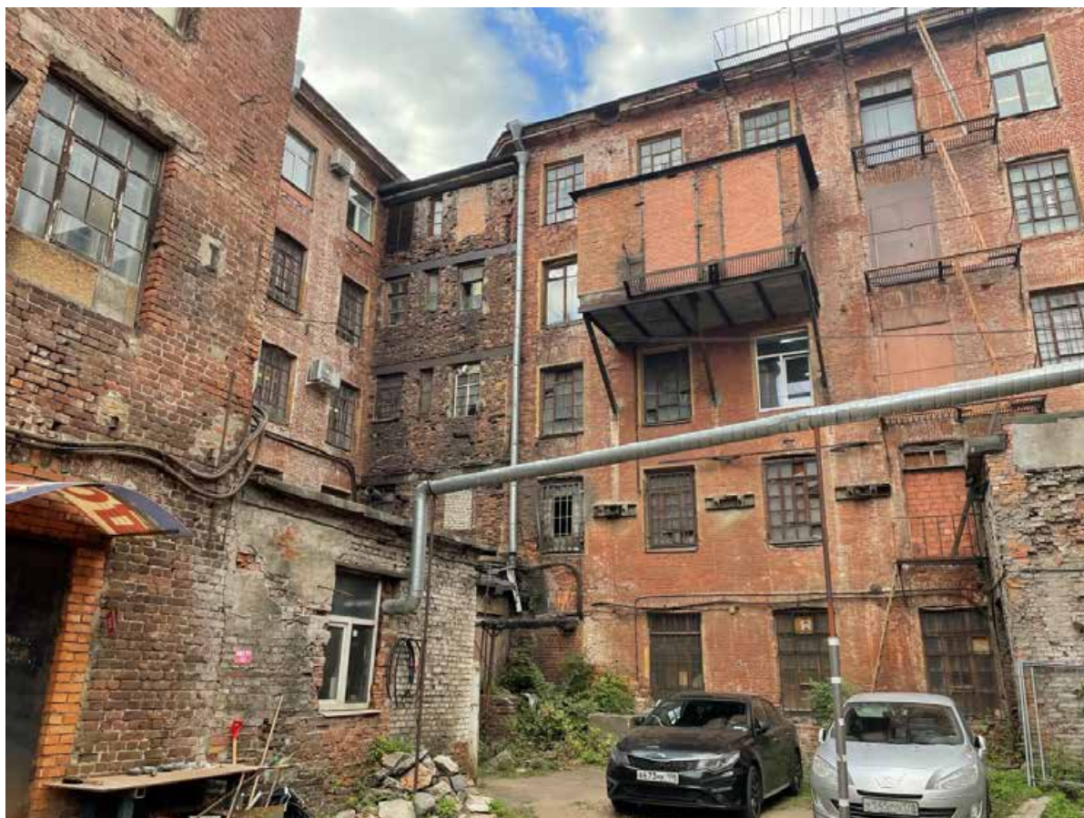
35. Фрагмент восточного фасада
