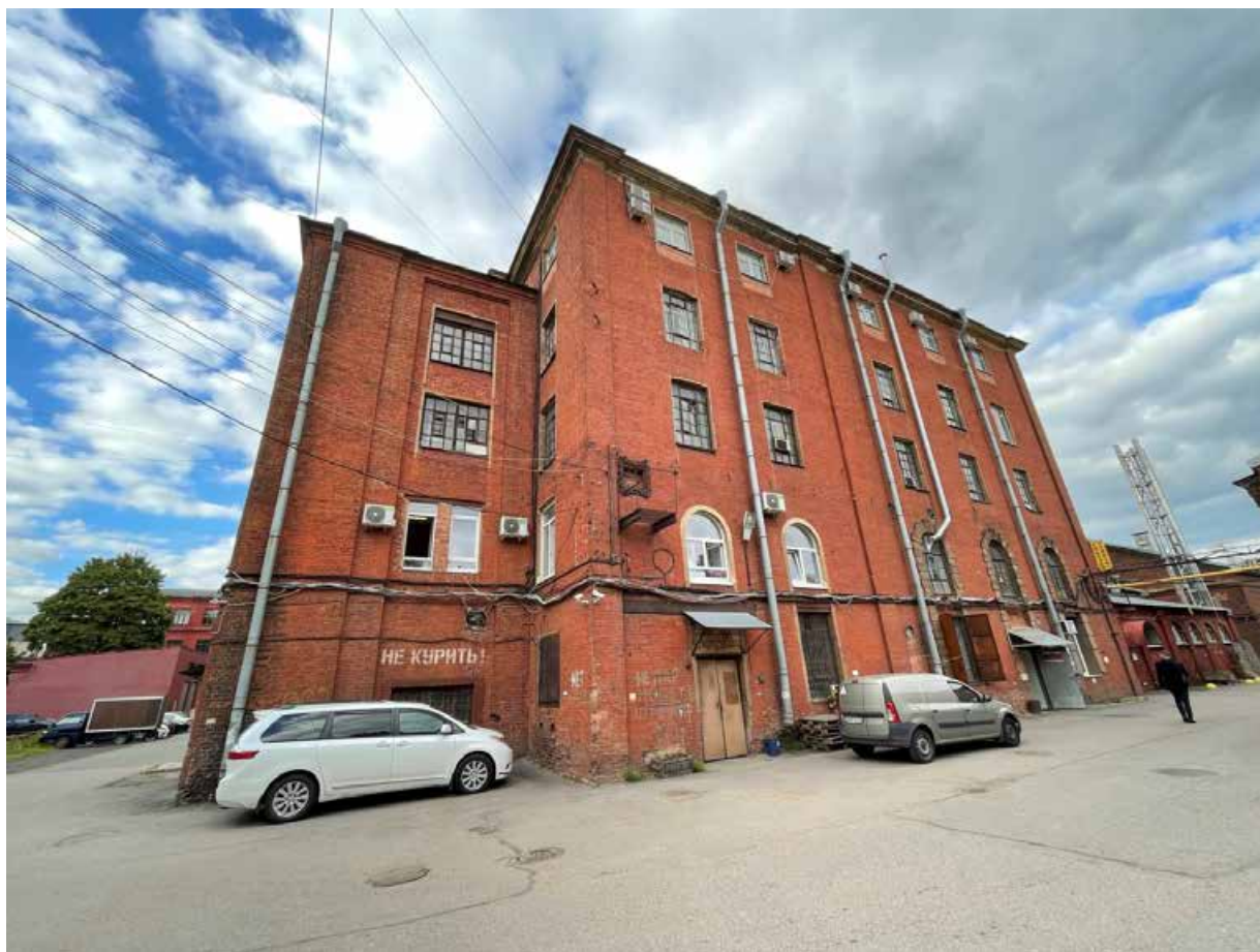
27. Фрагмент южного фасада прядильного корпуса
