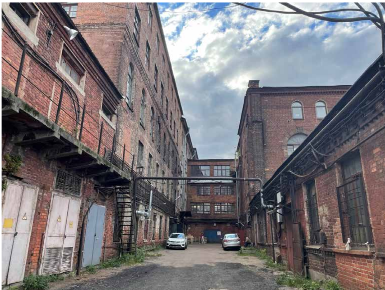
49. Вид на проход между корпусами
