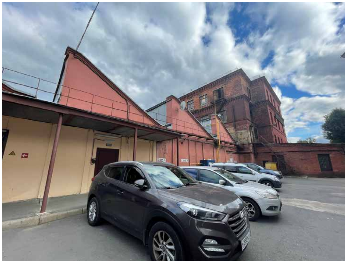
19. Вид на северо-западный угол ткацкого корпуса
