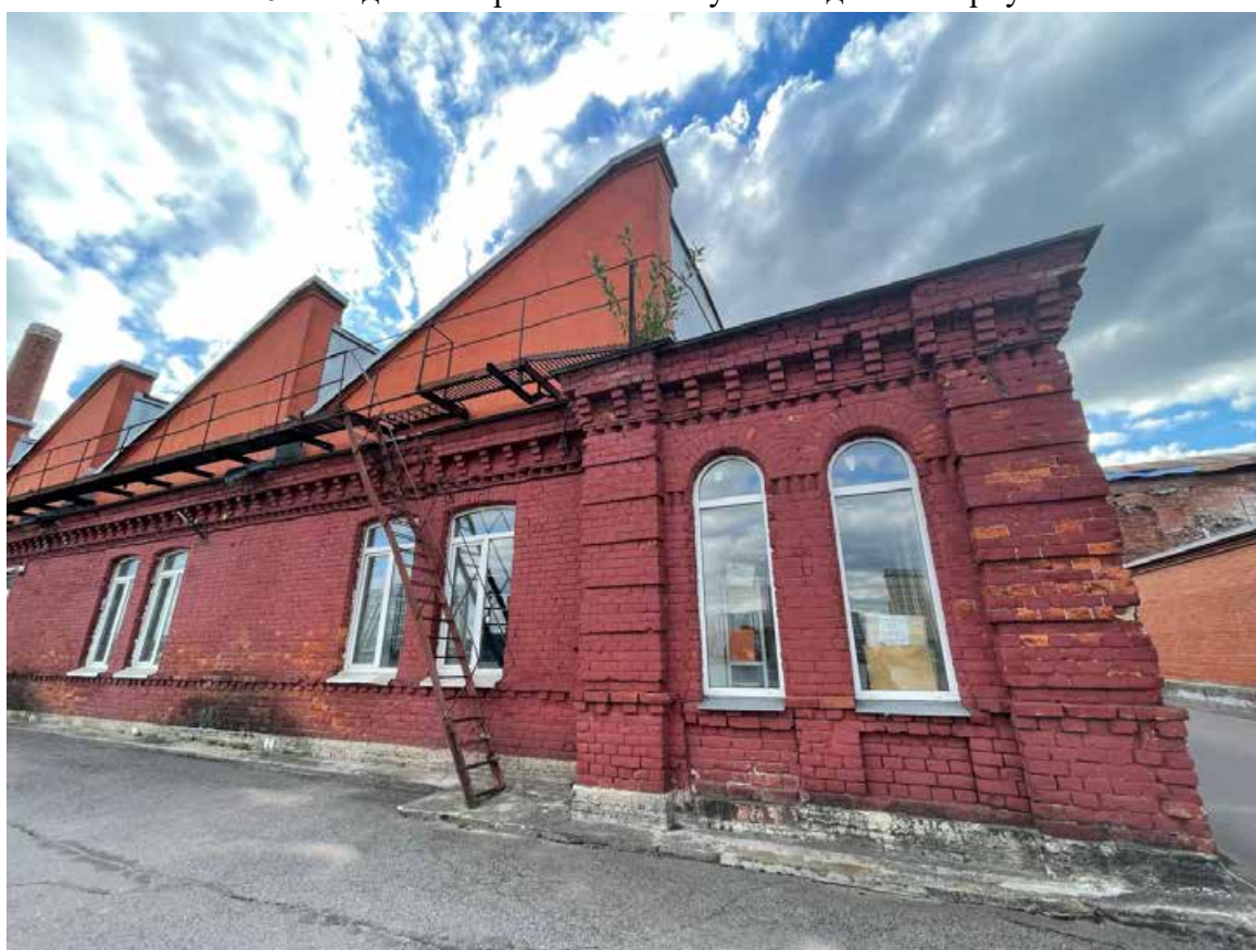
10. Вид на северо-восточный угол шедового корпуса
