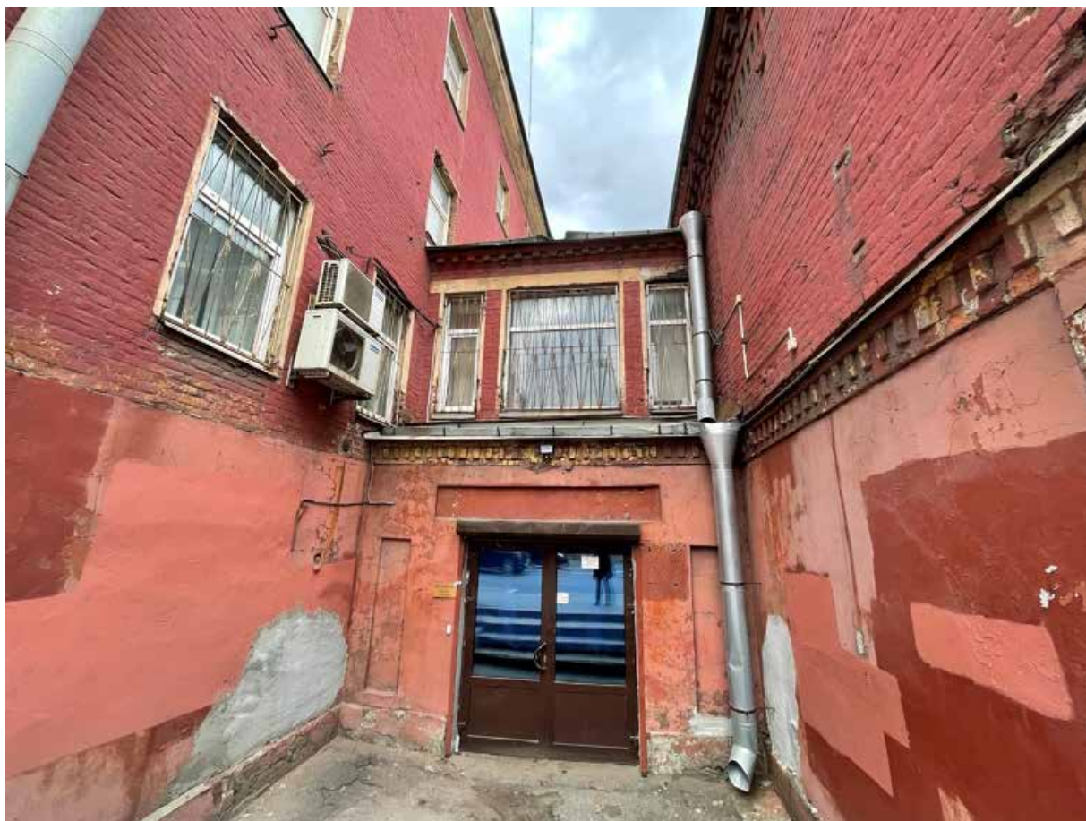
9. Вид на переход с запада
