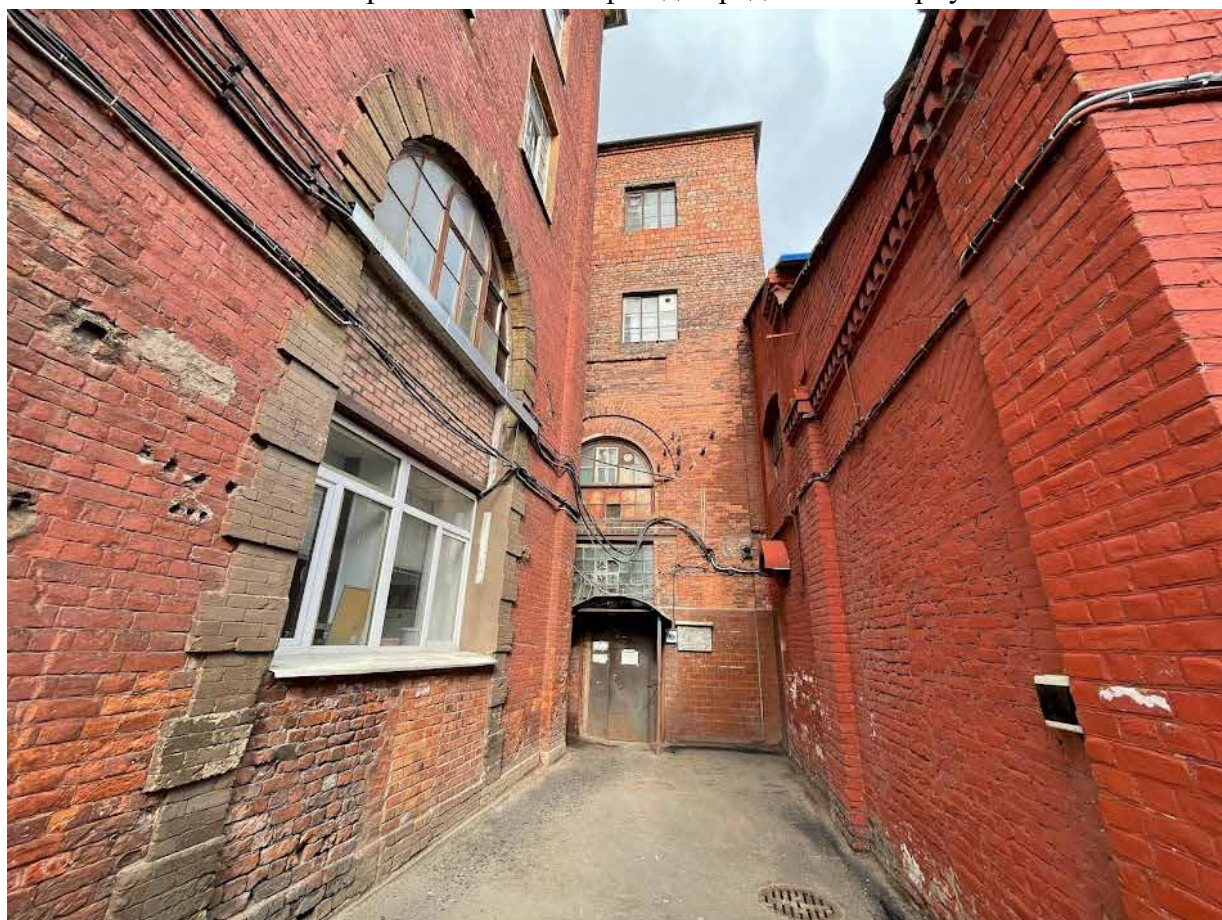
28. Фрагмент южного фасада прядильного корпуса
