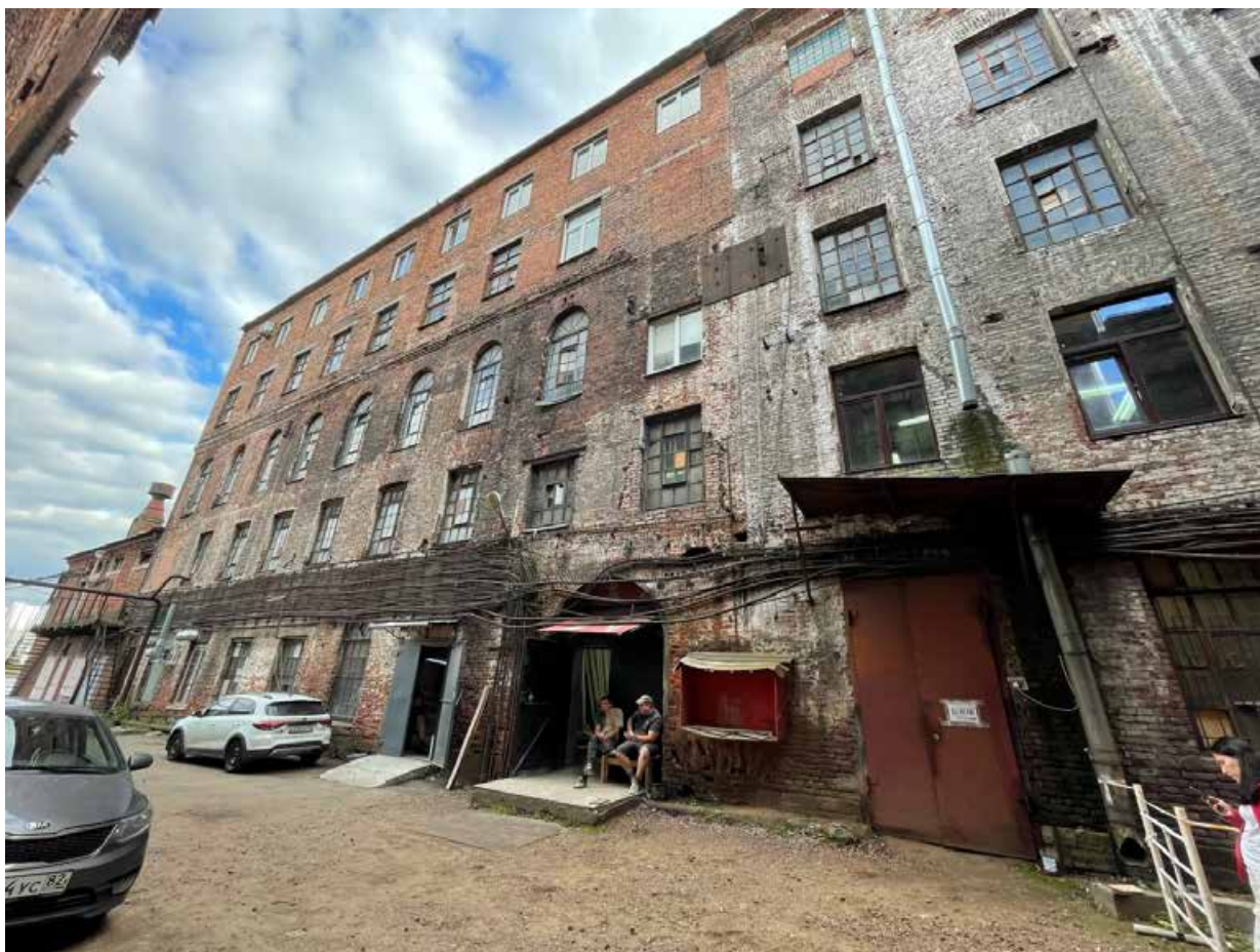
45. Фрагмент северного фасада прядильного корпуса
