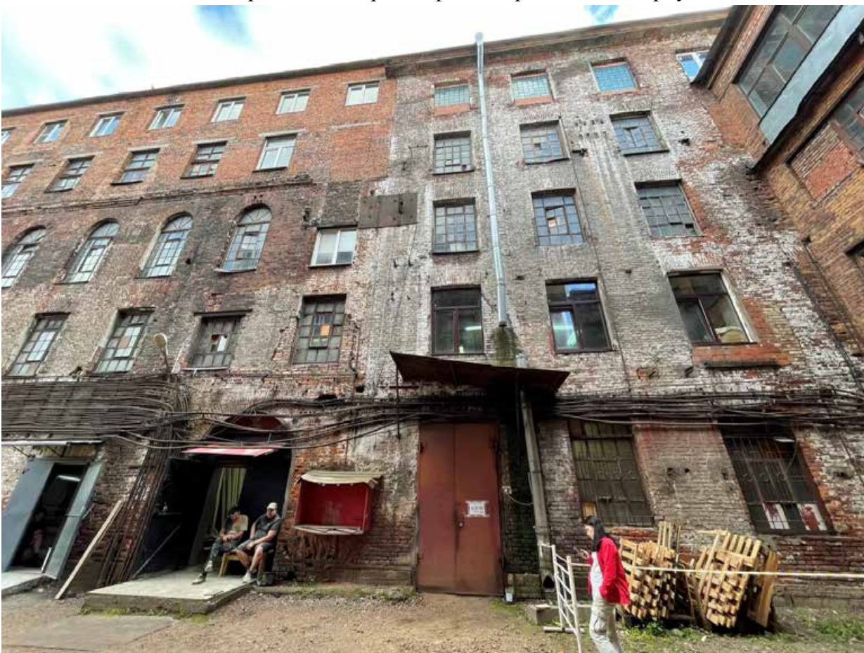
46. Фрагмент северного фасада прядильного корпуса
