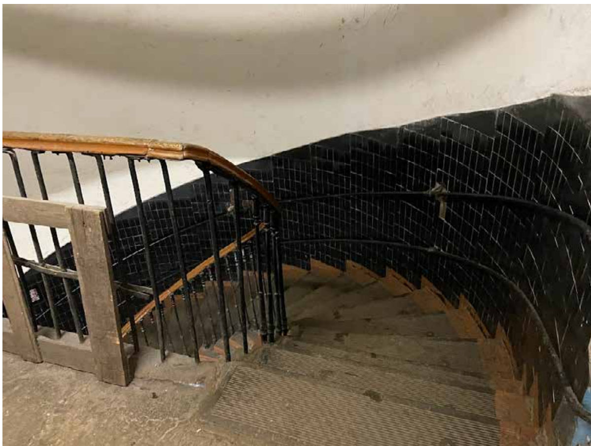
168. Фрагмент интерьера пятого этажа
