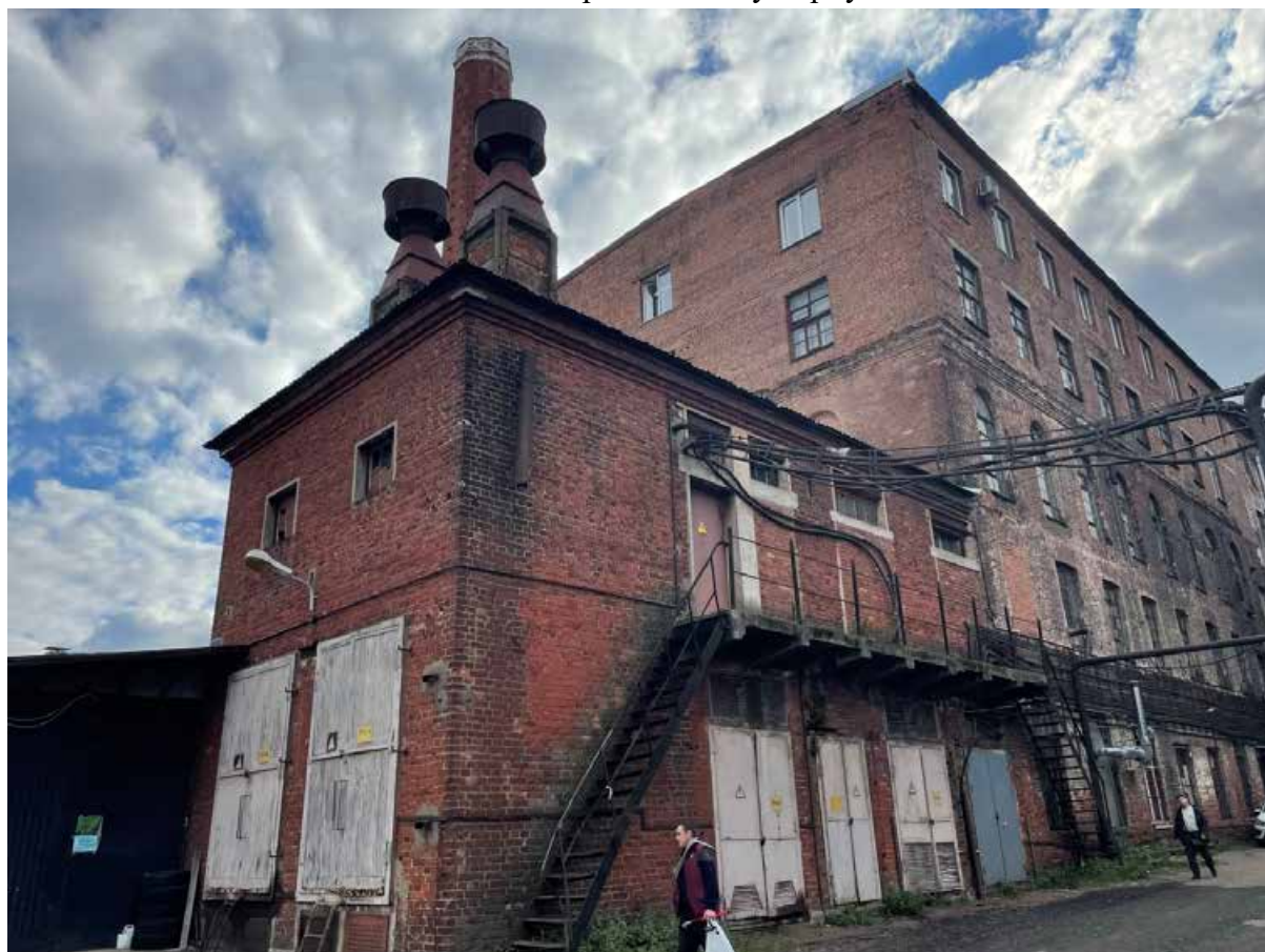
50. Вид на северо-восточный угол прядильного корпуса
