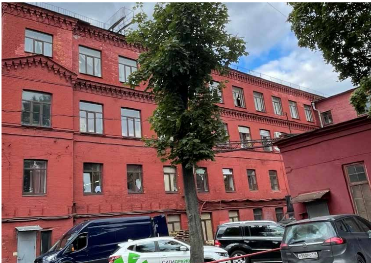
23. Фрагмент южного фасада ткацкого корпуса
