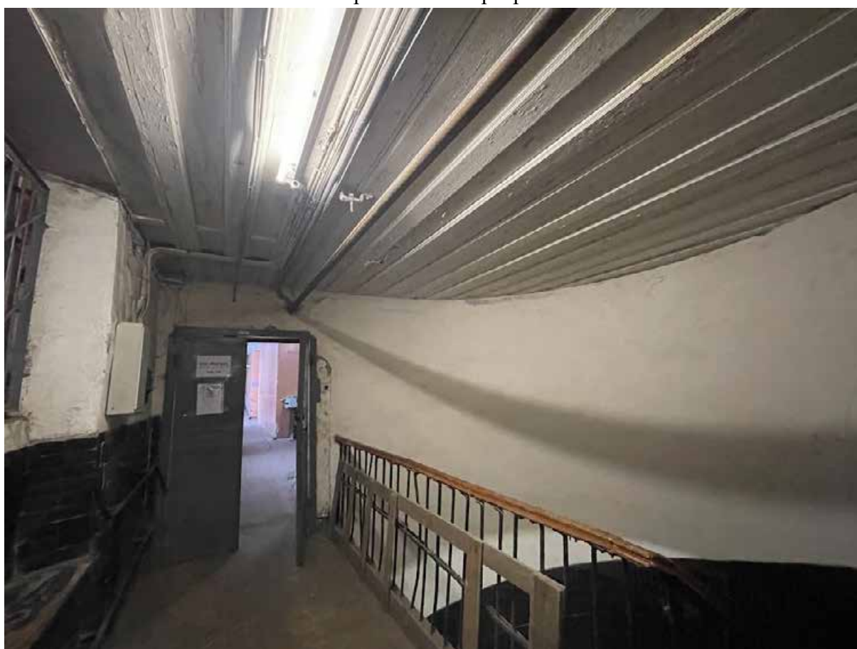
169. Фрагмент интерьера пятого этажа
