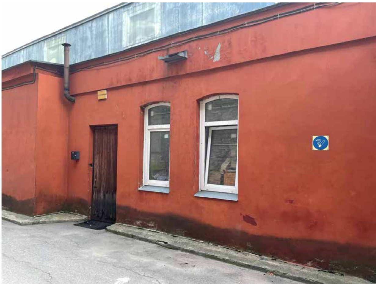
11. Фрагмент северного фасада шедового корпуса
