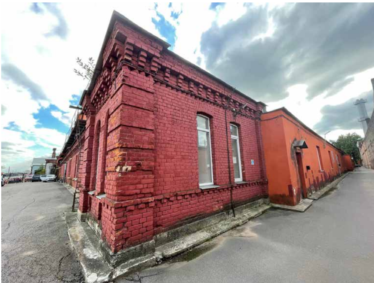
9. Вид на северо-восточный угол шедового корпуса
