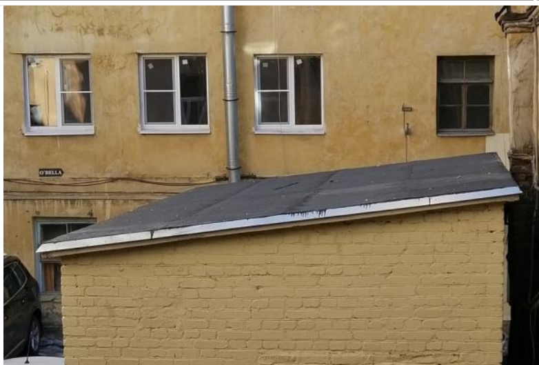
Фото 37. Общий вид кровли здания подстанции.
