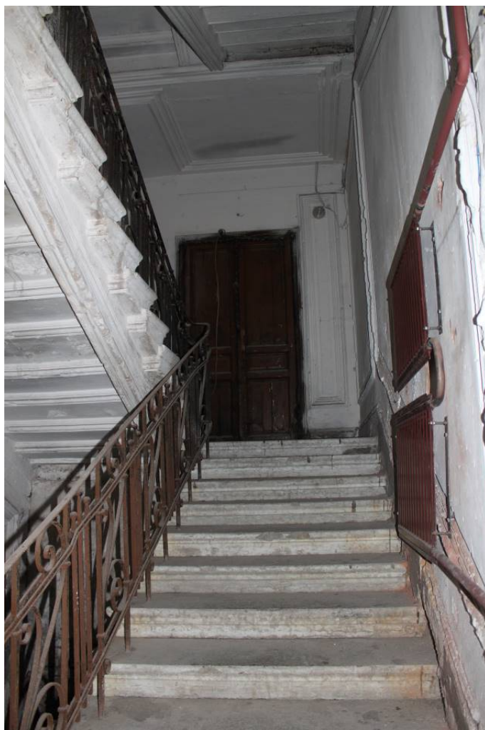
Фото 212. Лестница № 3: 2 этаж. Съемка 26.04.2021 г. Трушковский В.Э.
