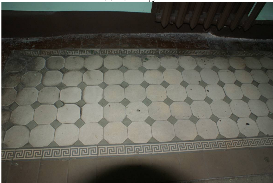
Фото 152. Лестница № 1: Площадка между 1-м и 2-м этажом. Покрытие пола. Съемка 26.04.2021 г. Трушковский В.Э.
