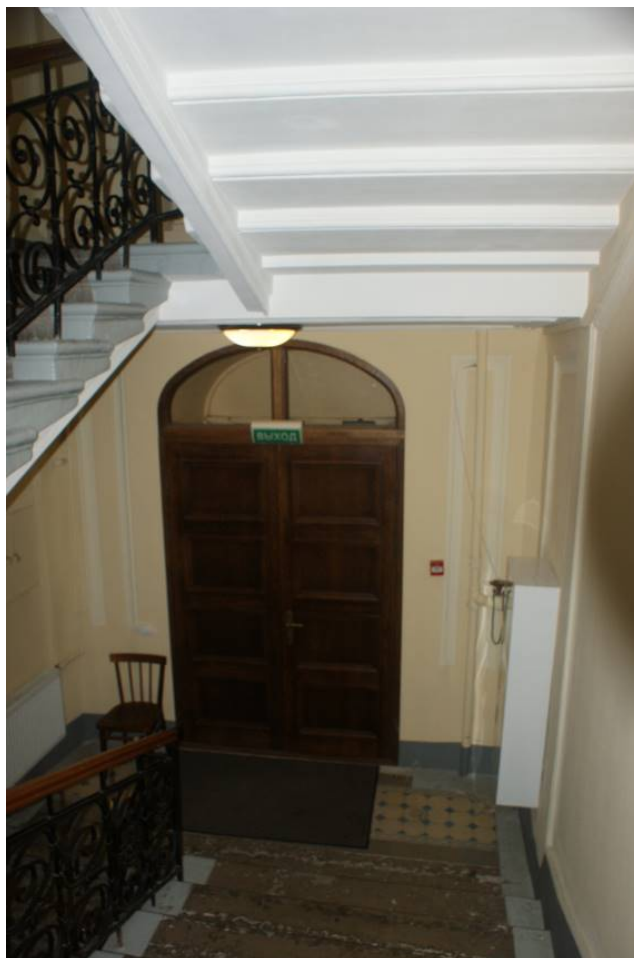
Фото 234. Лестница № 1: Площадка 1-го этажа. Входная дверь. Съемка 26.04.2021 г. Трушковский В.Э.
