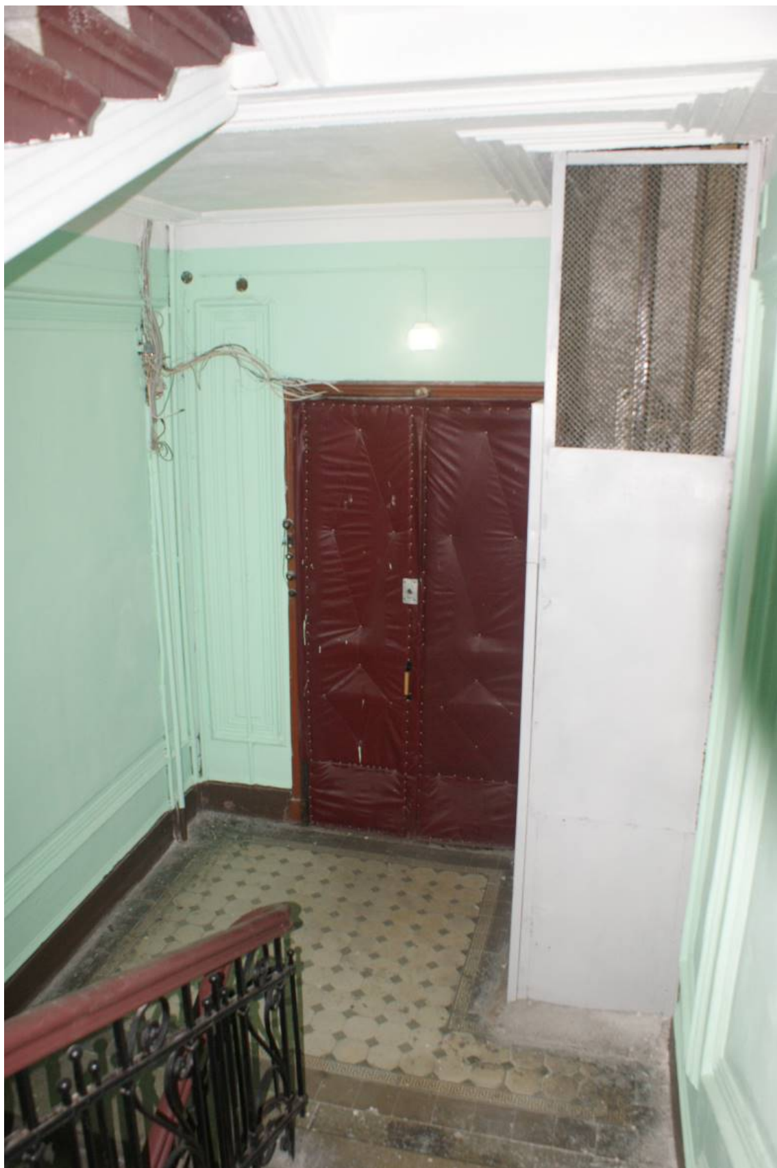
Фото 168. Лестница № 1: 4 этаж. Съемка 26.04.2021 г. Трушковский В.Э.
