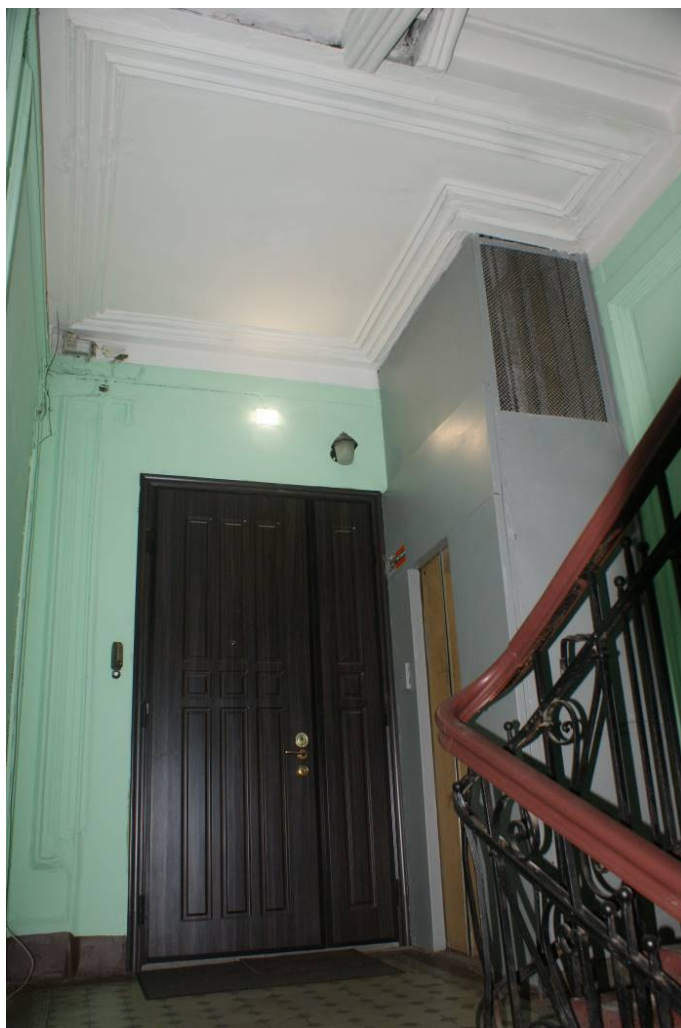
Фото 156. Лестница № 1: 2 этаж. Съемка 26.04.2021 г. Трушковский В.Э.
