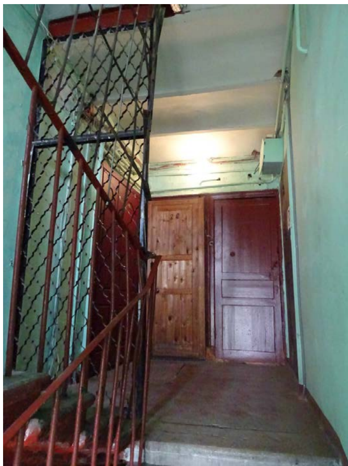
Фото 201. Лестница № 2: 5 этаж. Съемка 26.04.2021 г. Трушковский В.Э.
