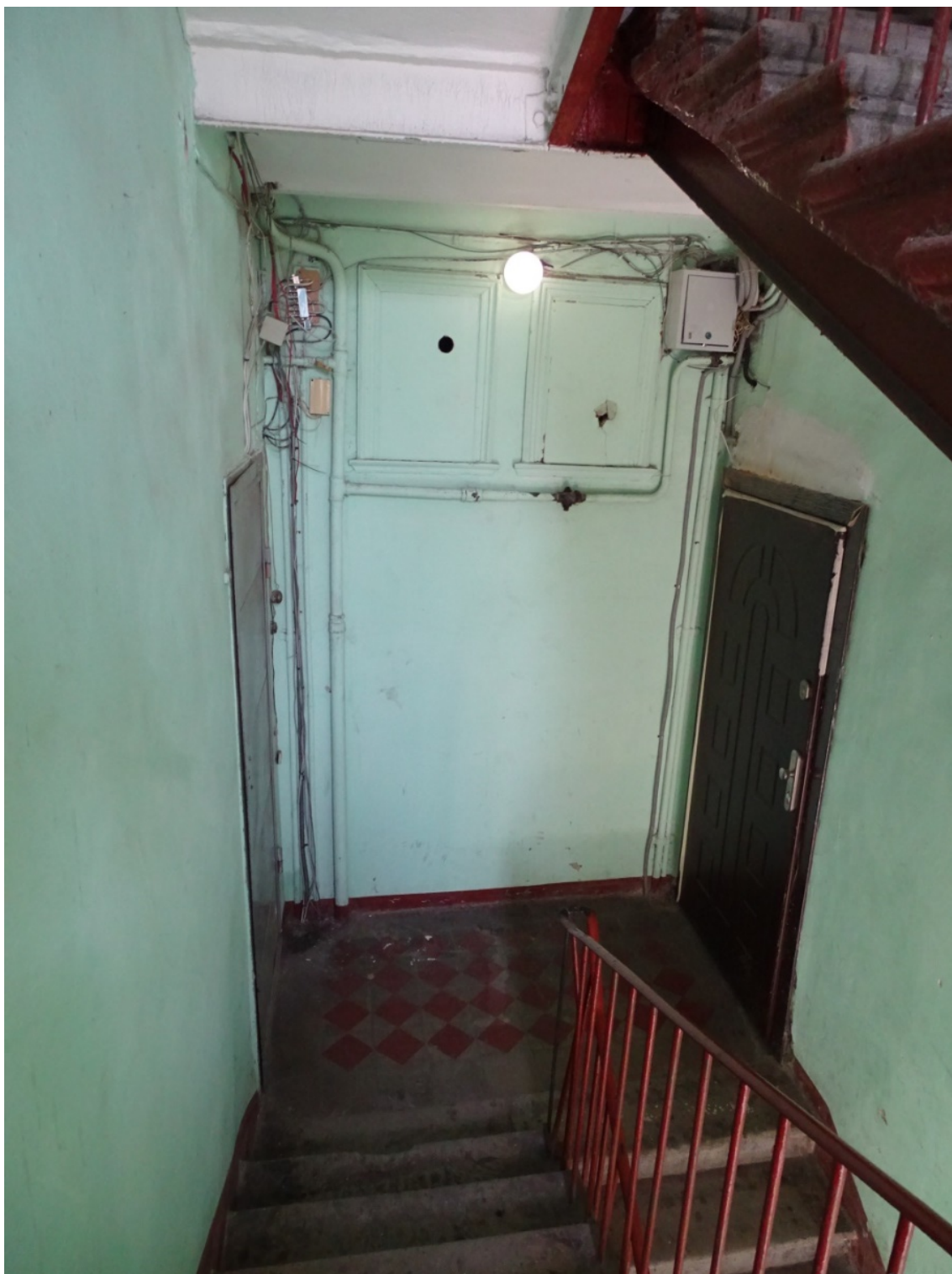
Фото 198. Лестница № 2: 4 этаж. Съемка 26.04.2021 г. Трушковский В.Э.
