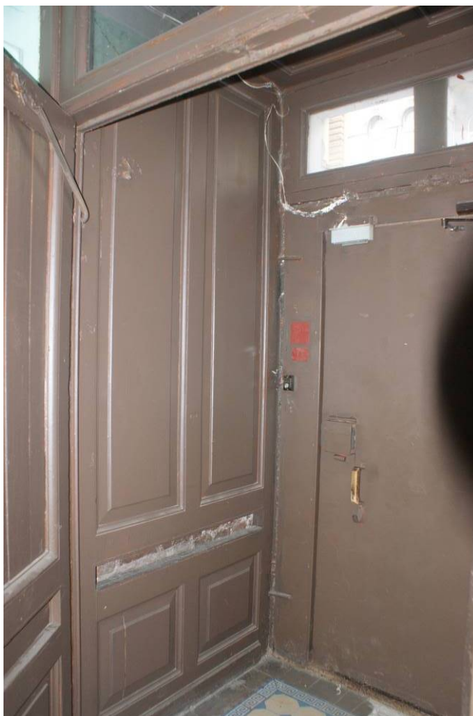
Фото 130. Лестница № 1: Тамбур. 1-й этаж. Оформление стен. Съемка 26.04.2021 г. Трушковский В.Э.
