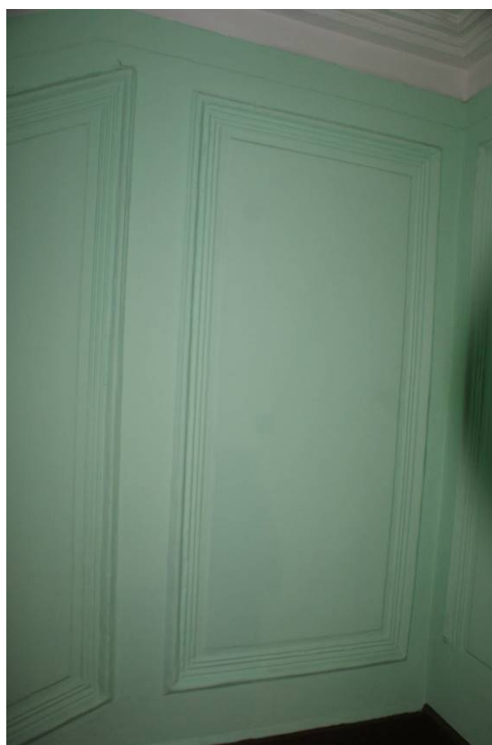
Фото 154. Лестница № 1: Площадка между 1-м и 2-м этажом. Профилированные рамы стен. Съемка 26.04.2021 г. Трушковский В.Э.
