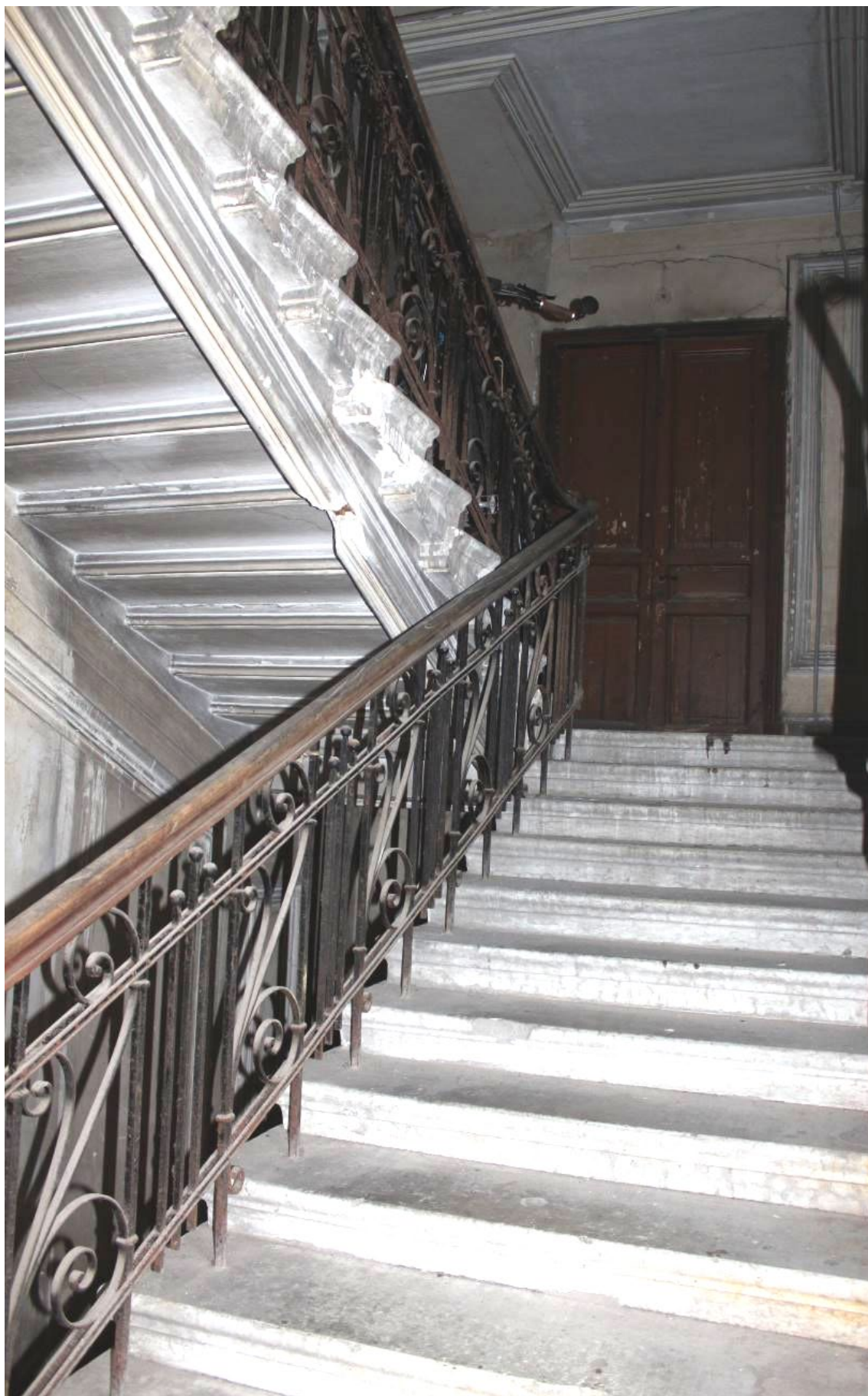
Фото 220. Лестница № 3: Лестничный марш на 4-й этаж. Съемка 26.04.2021 г. Трушковский В.Э.
