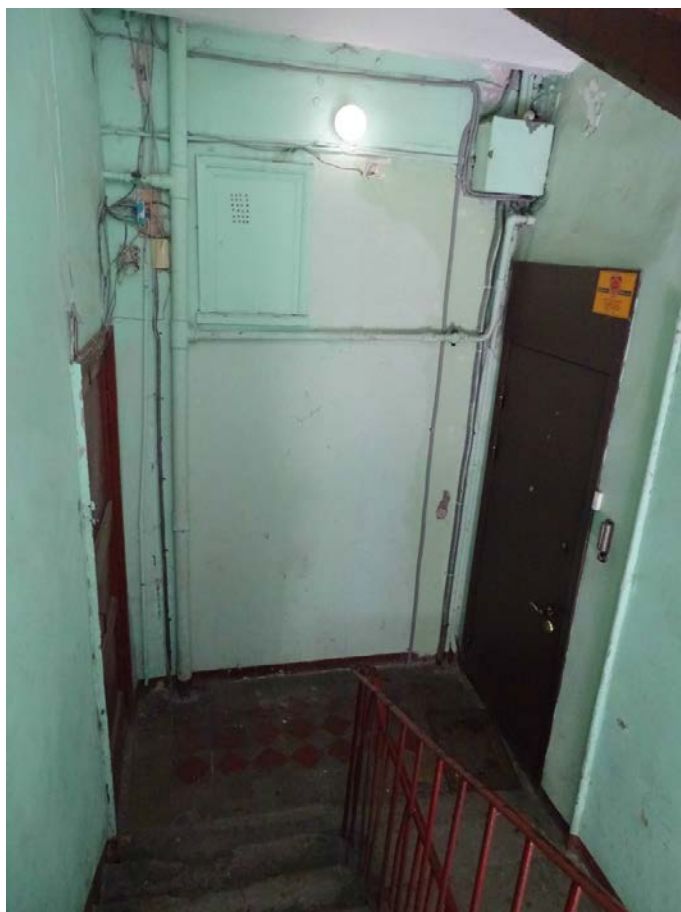
Фото 191. Лестница № 2: 2 этаж. Съемка 26.04.2021 г. Трушковский В.Э.
