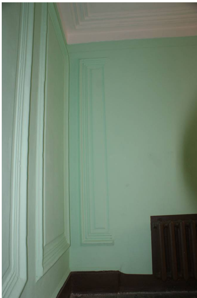
Фото 170. Лестница № 1: Площадка между 4-м и 5-м этажом. Профилированные рамы стен.
