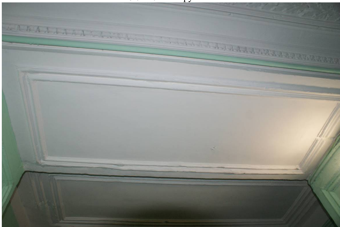
Фото 146. Лестница № 1: Вестибюль.1-й этаж. Зеркало плафона перехода к межэтажной лестнице. Съемка 26.04.2021 г. Трушковский В.Э.
