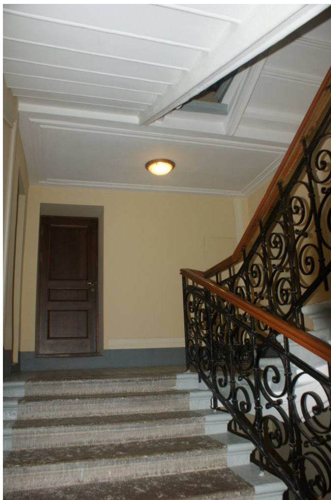
Фото 241. Лестница № 1: 2 этаж. Съемка 26.04.2021 г. Трушковский В.Э.
