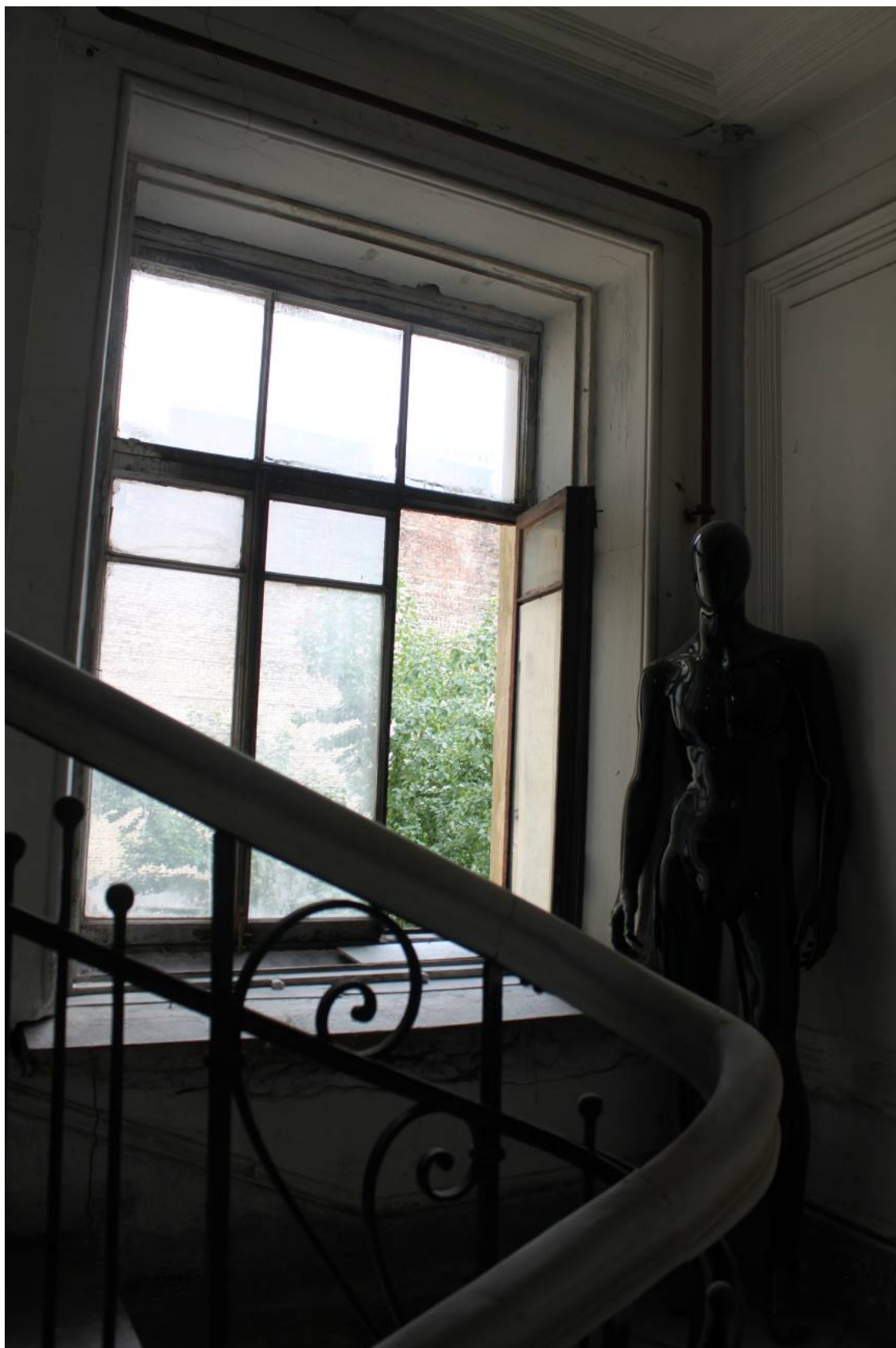
Фото 230. Лестница № 3: Площадка между 5-м и 6-м этажом. Оформление окна. Съемка 26.04.2021 г. Трушковский В.Э.
