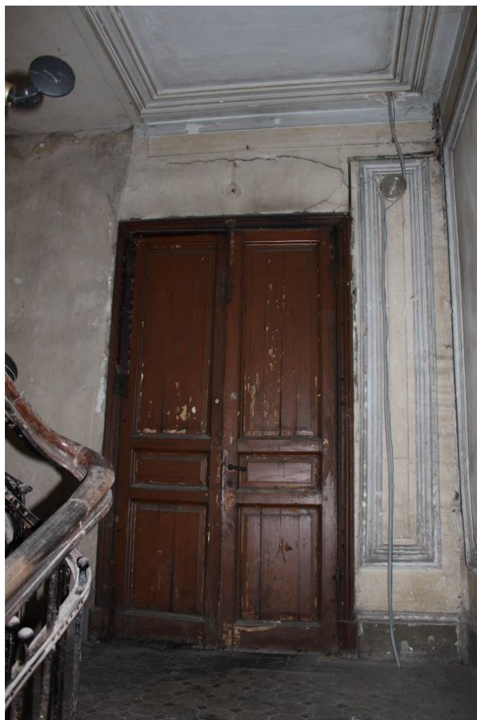
Фото 221. Лестница № 3: Площадка 4-го этажа. Оформление двери. Съемка 26.04.2021 г. Трушковский В.Э.
