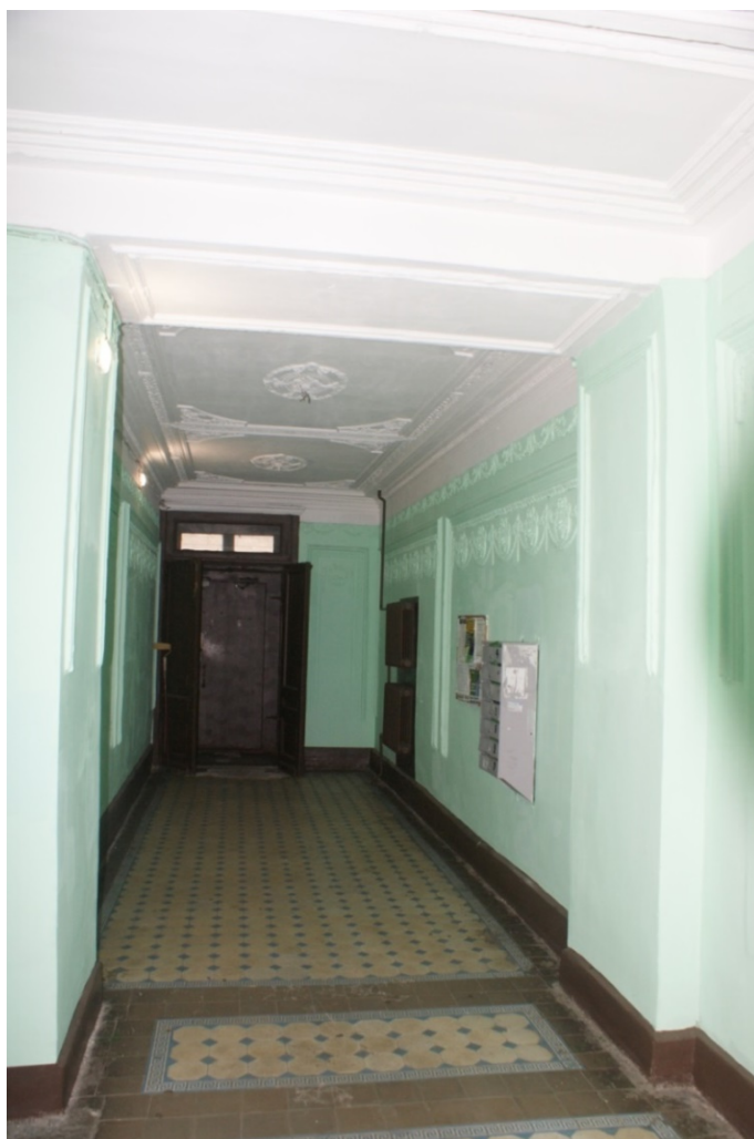
Фото 141. Лестница № 1: Вестибюль.1-й этаж. Покрытие пола. Съемка 26.04.2021 г. Трушковский В.Э.
