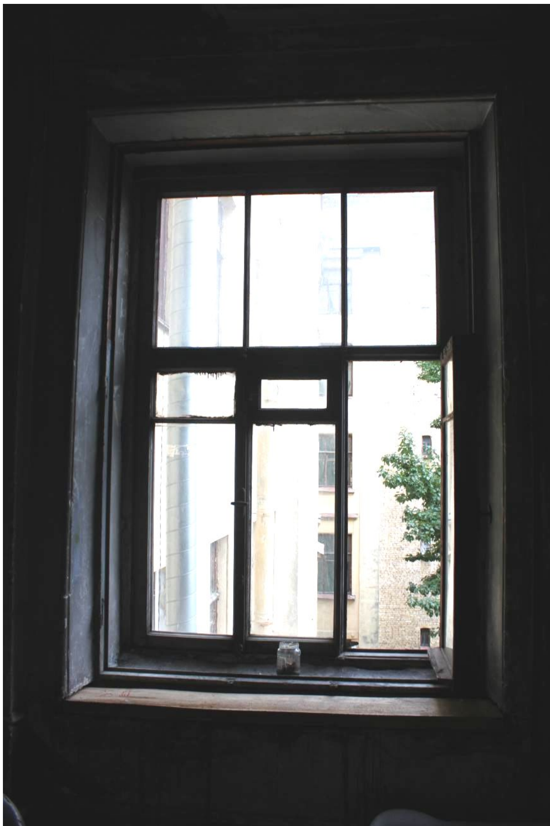
Фото 224. Лестница № 3: Площадка между 4-м и 5-м этажом. Оформление окна. Съемка 26.04.2021 г. Трушковский В.Э.
