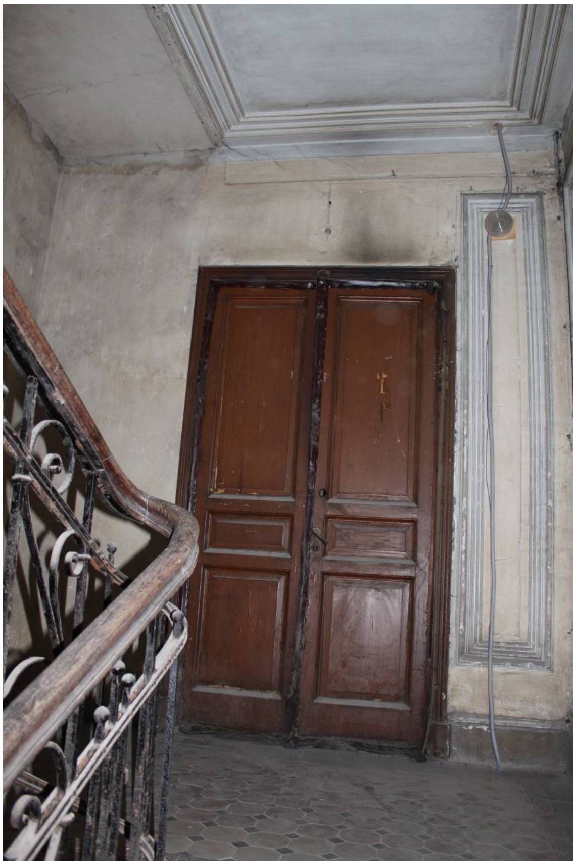
Фото 217. Лестница № 3: 3 этаж. Съемка 26.04.2021 г. Трушковский В.Э.
