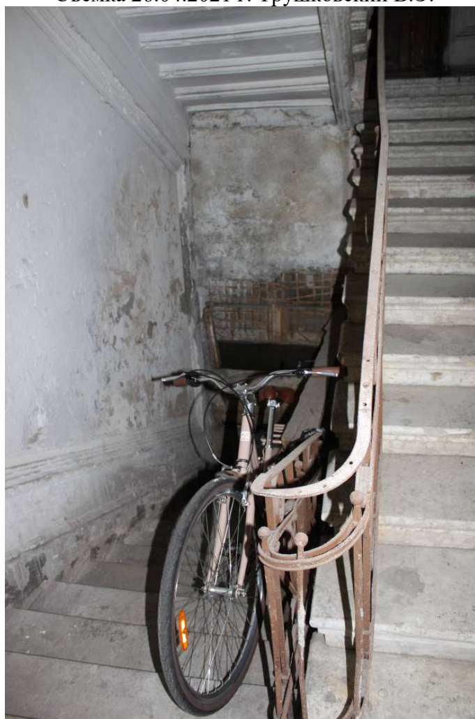
Фото 211. Лестница № 3: Лестничный марш на 1-й этаж. Съемка 26.04.2021 г. Трушковский В.Э.
