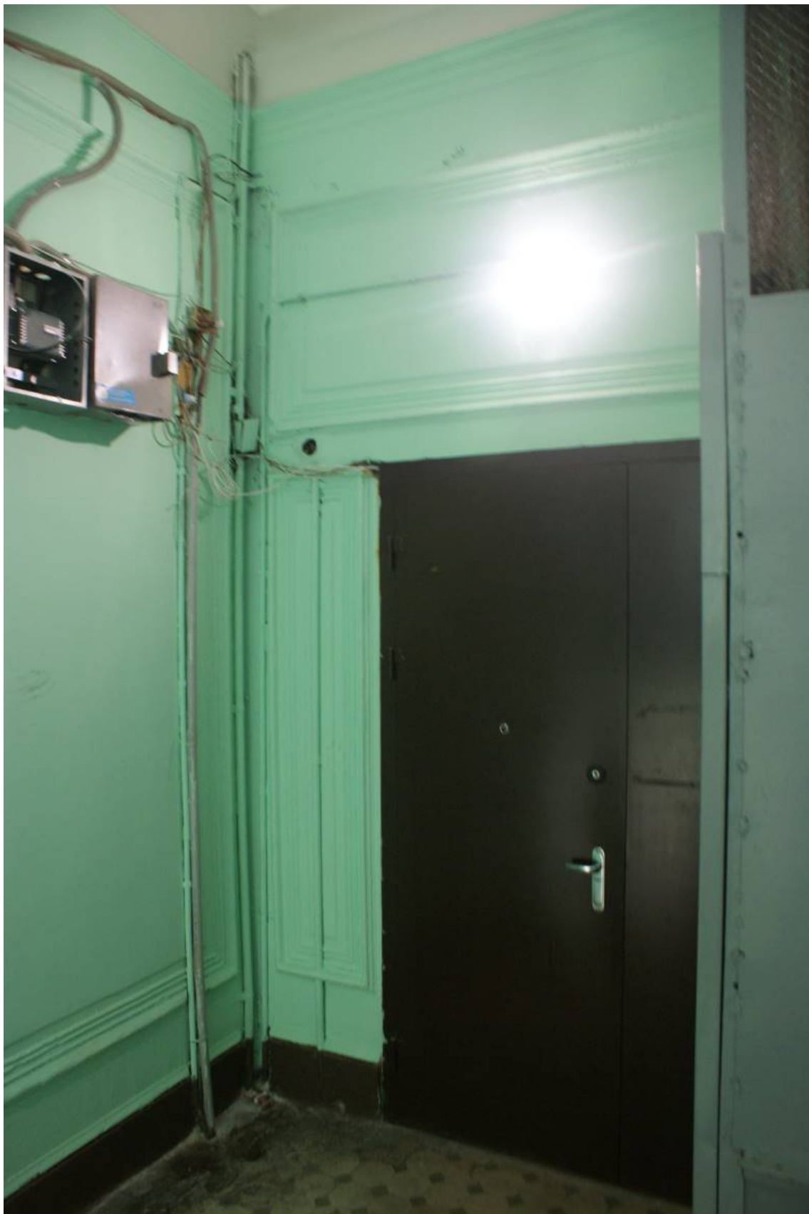
Фото 181. Лестница № 1: Площадка 6-го этажа. Профилированные рамы стен. Съемка 26.04.2021 г. Трушковский В.Э.
