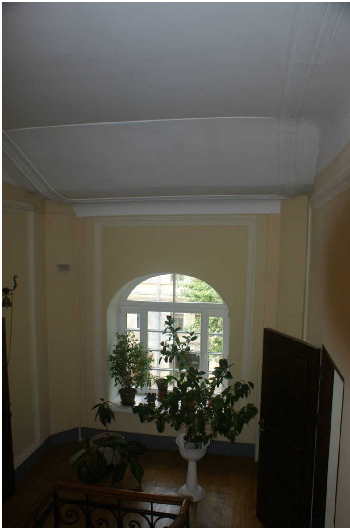
Фото 250. Лестница № 1: Площадка 3-го этажа. Съемка 26.04.2021 г. Трушковский В.Э.
