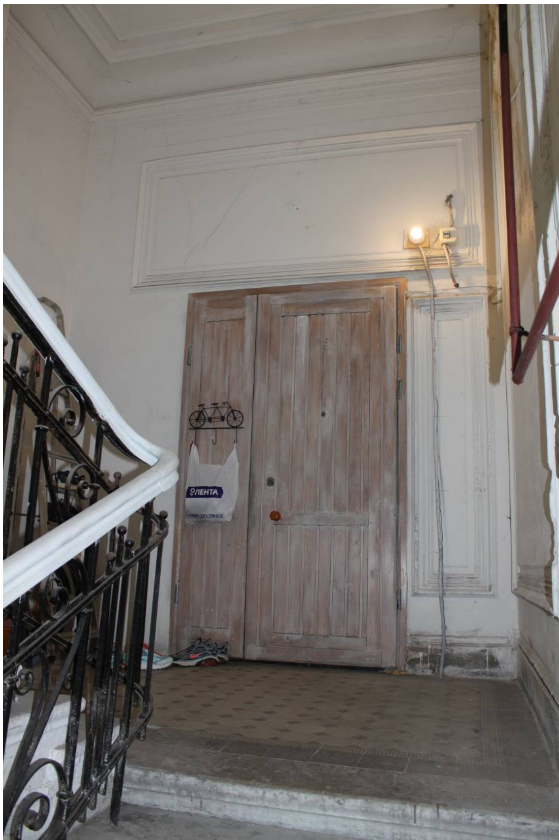
Фото 231. Лестница № 3: Площадка 6-го этажа. Съемка 26.04.2021 г. Трушковский В.Э.
