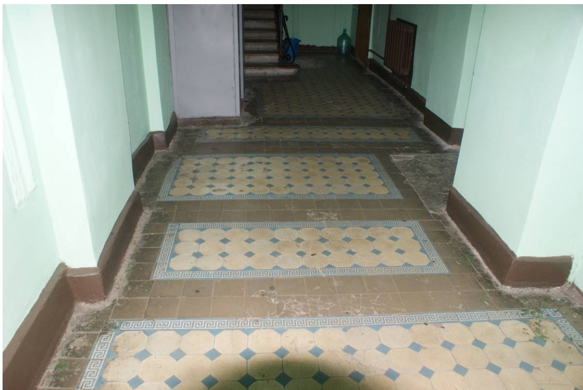
Фото 147. Лестница № 1: Вестибюль.1-й этаж. Покрытие пола. Съемка 26.04.2021 г. Трушковский В.Э.
