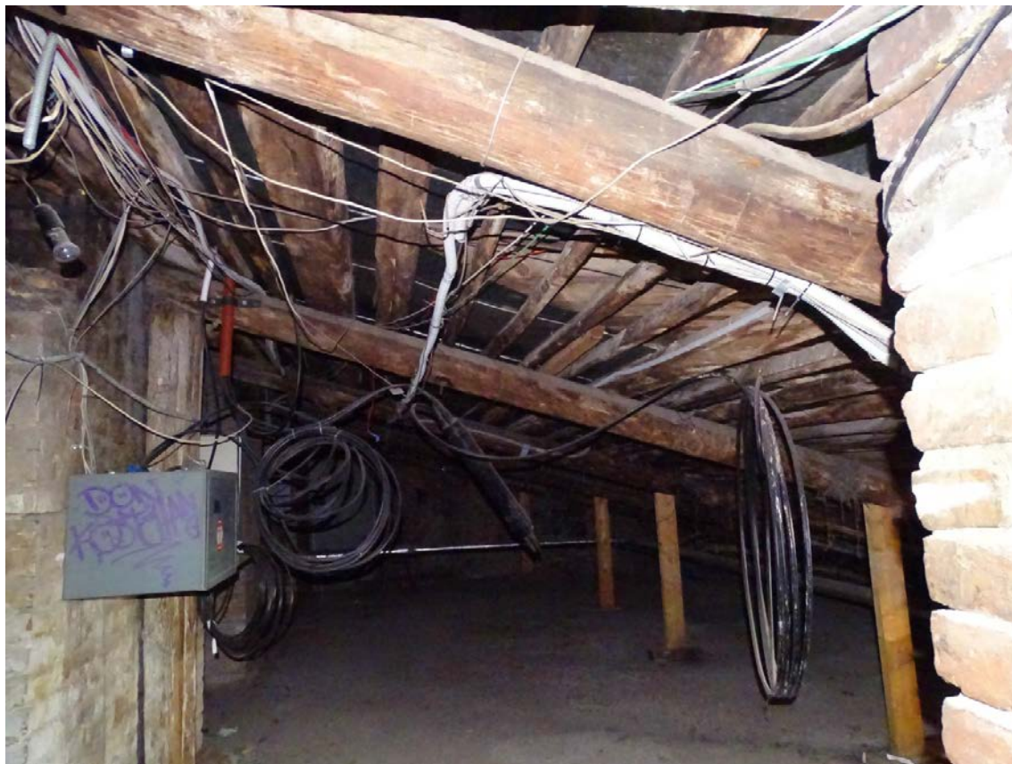
Фото 206. Лестница № 2: Чердак. Съемка 26.04.2021 г. Трушковский В.Э.
