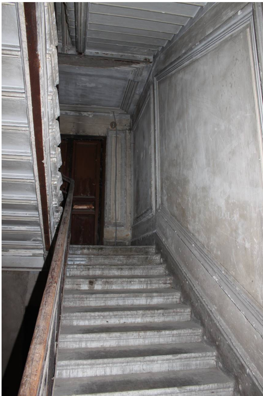
Фото 225. Лестница № 3: Лестничный марш на 5-й этаж. Съемка 26.04.2021 г. Трушковский В.Э.
