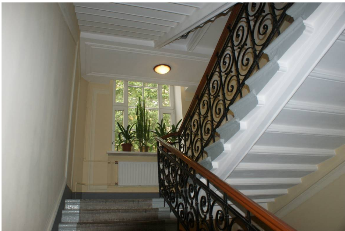
Фото 239. Лестница № 1: Вид на площадку между 1-м и 2-м этажом. Съемка 26.04.2021 г. Трушковский В.Э.
