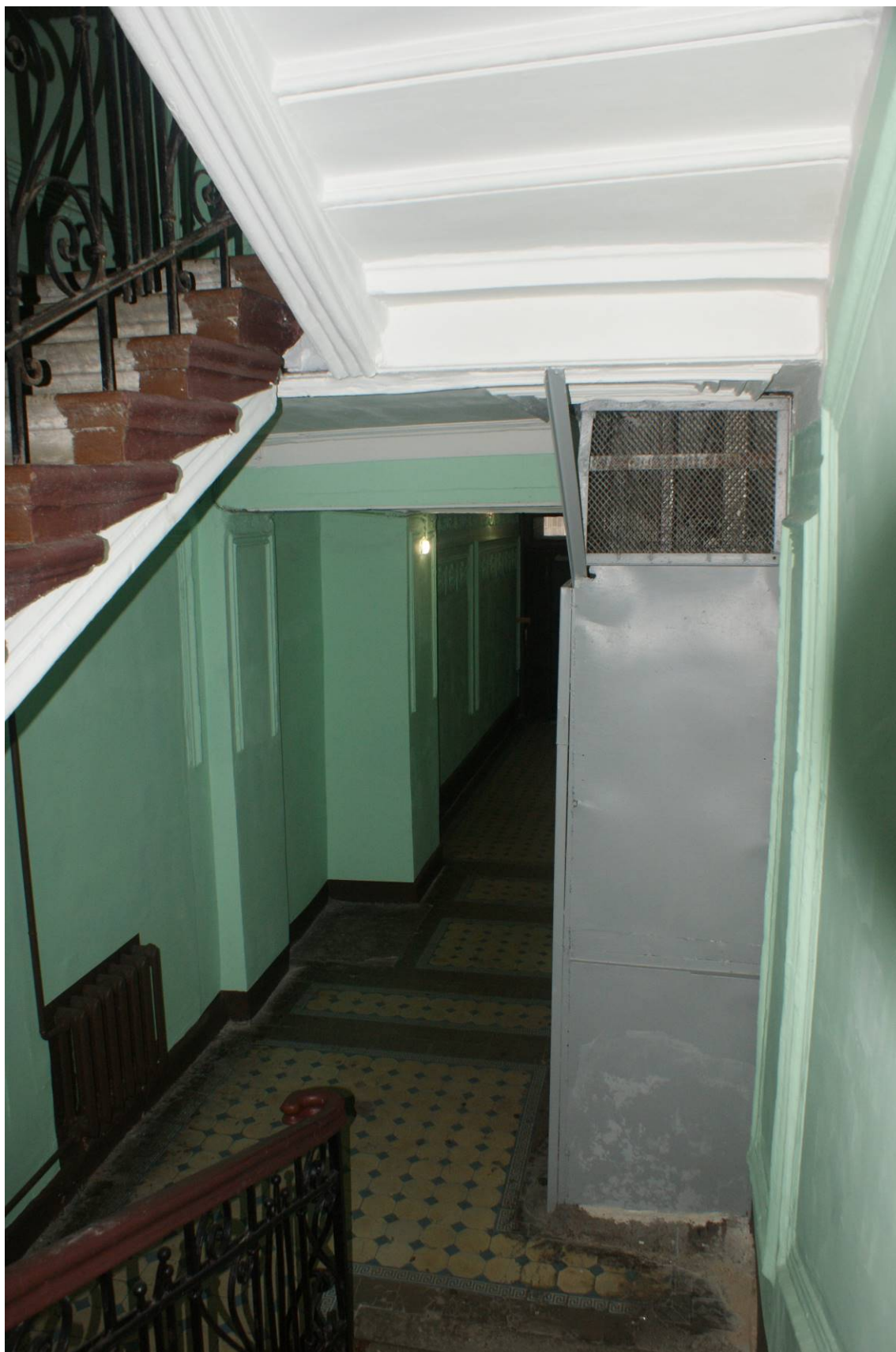
Фото 150. Лестница № 1: Площадка 1-го этажа. Съемка 26.04.2021 г. Трушковский В.Э.
