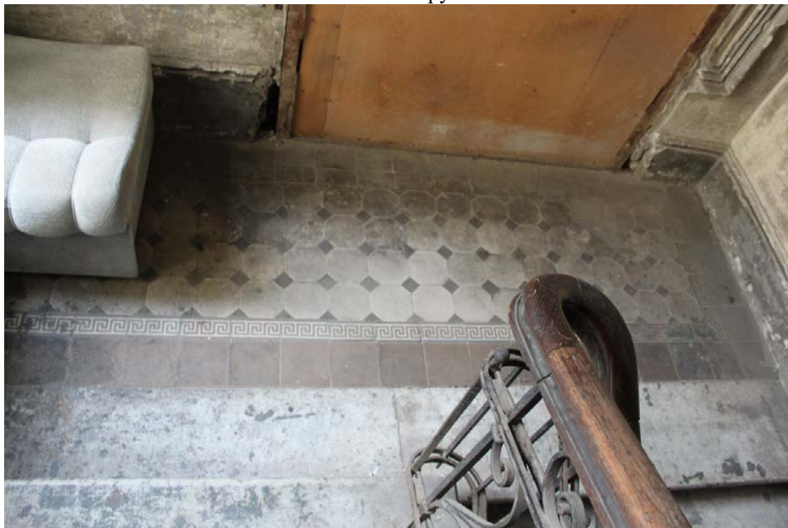
Фото 222. Лестница № 3: Площадка между 4-м и 5-м этажом. Покрытие пола. Съемка 26.04.2021 г. Трушковский В.Э.
