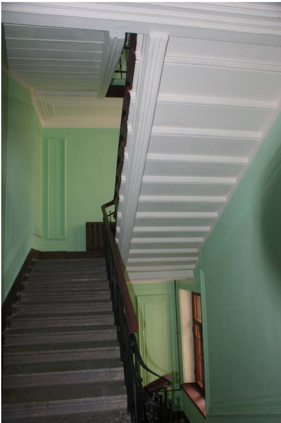
Фото 175. Лестница № 1: Лестничный марш на площадку между 5-м и 6-м этажом. Съемка 26.04.2021 г. Трушковский В.Э.
