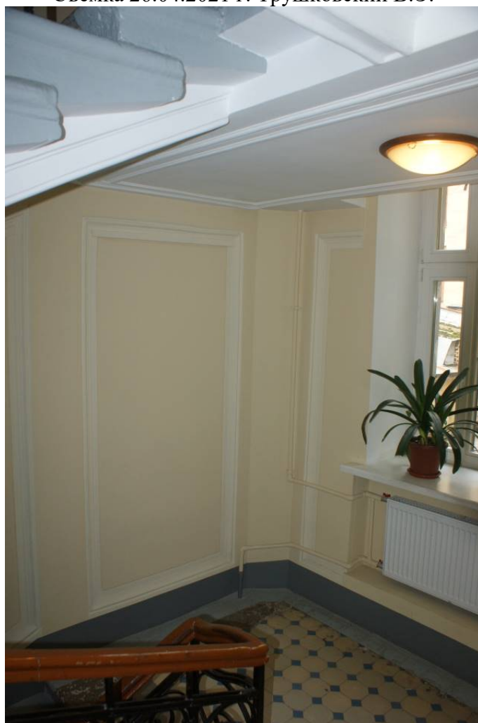
Фото 240. Лестница № 1: Площадка между 1-м и 2-м этажом. Профильное оформление стен. Съемка 26.04.2021 г. Трушковский В.Э.
