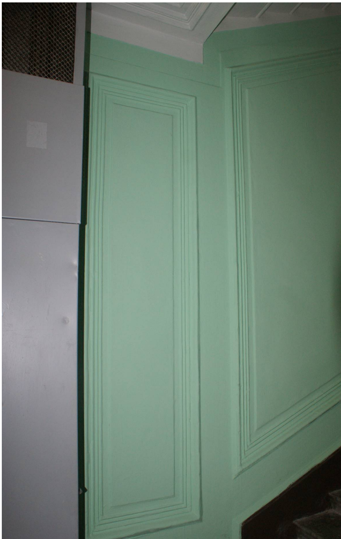
Фото 163. Лестница № 1: 3 этаж. Профилированные рамы стен. Съемка 26.04.2021 г. Трушковский В.Э.
