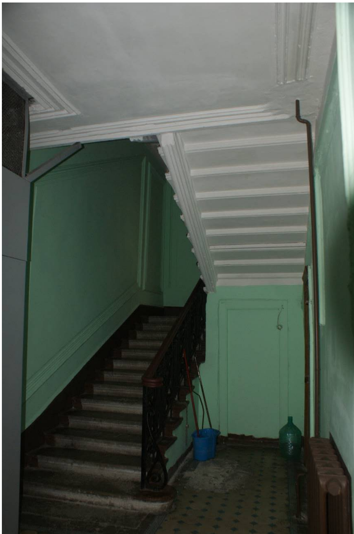
Фото 149. Лестница № 1: Площадка 1-го этажа. Съемка 26.04.2021 г. Трушковский В.Э.
