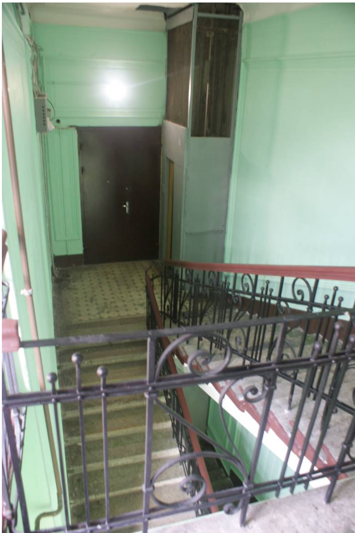
Фото 180. Лестница № 1: Вид на площадку 6-го этажа. Съемка 26.04.2021 г. Трушковский В.Э.
