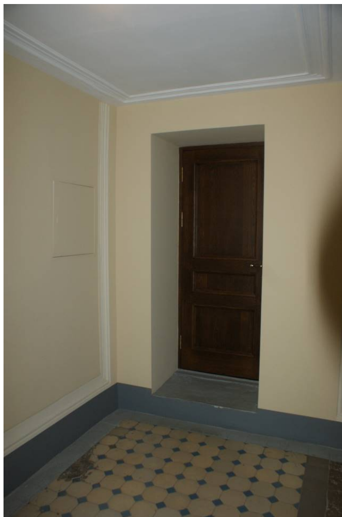
Фото 243. Лестница № 1: Площадка 2-го этажа. Съемка 26.04.2021 г. Трушковский В.Э.
