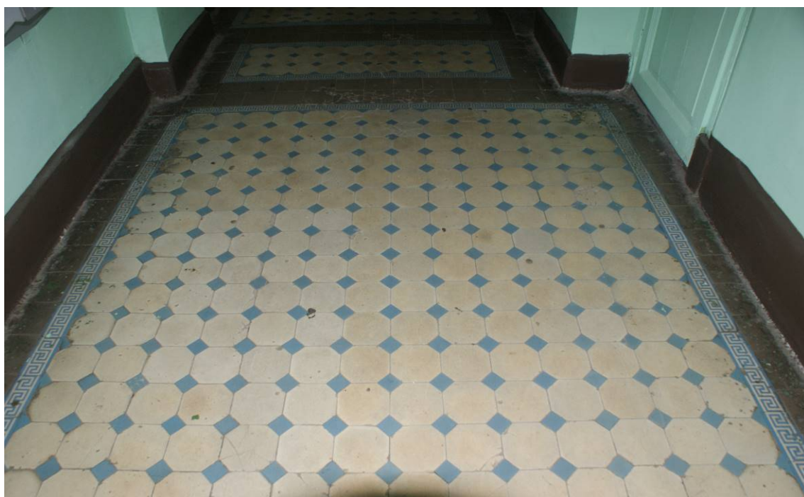
Фото 142. Лестница № 1: Вестибюль.1-й этаж. Покрытие пола. Съемка 26.04.2021 г. Трушковский В.Э.
