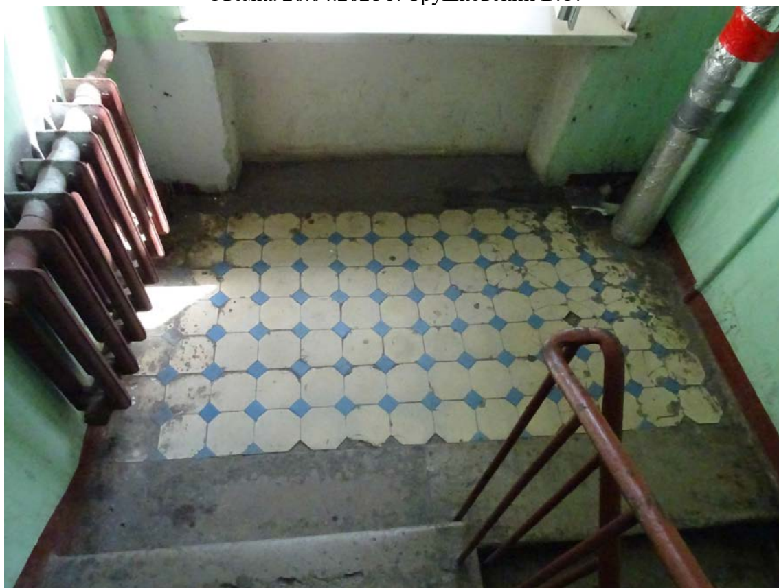
Фото 194. Лестница № 2: Площадка между 2-м и 3-м этажом. Покрытие пола. Съемка 26.04.2021 г. Трушковский В.Э.
