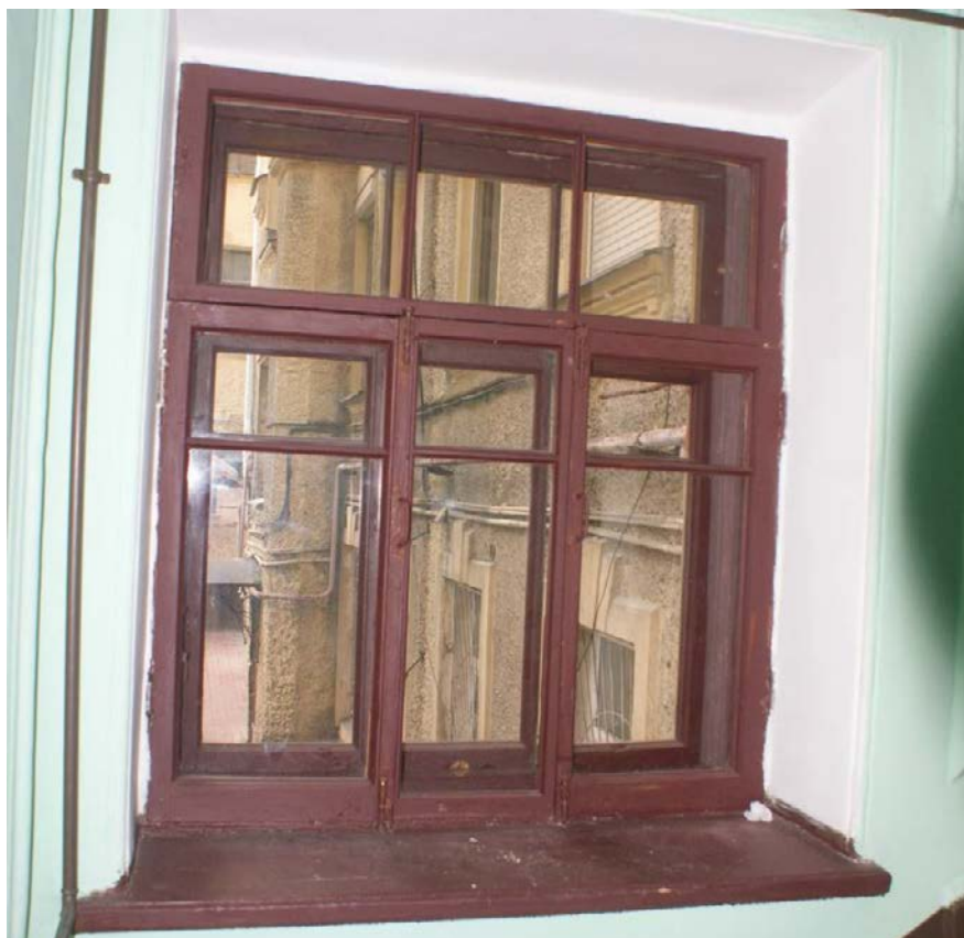
Фото 153. Лестница № 1: Площадка между 1-м и 2-м этажом. Оформление окна. Съемка 26.04.2021 г. Трушковский В.Э.
