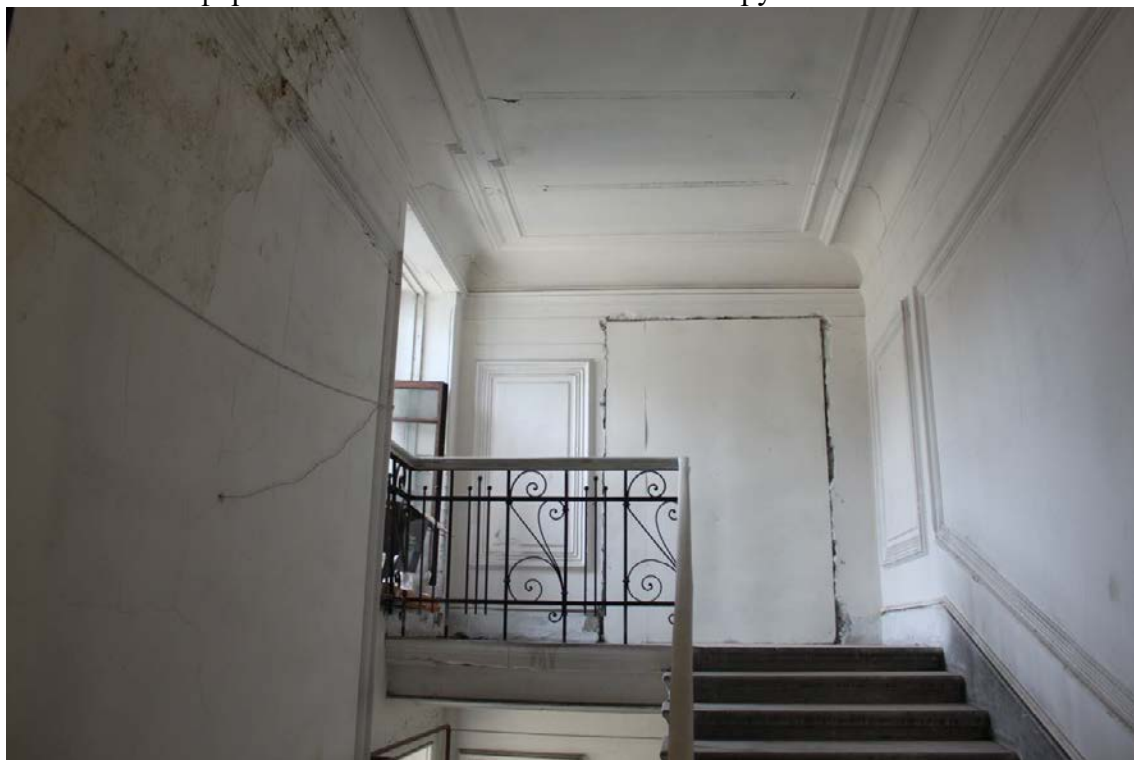
Фото 233. Лестница № 3: Площадка между 6-м и чердачным этажом. Съемка 26.04.2021 г. Трушковский В.Э.
