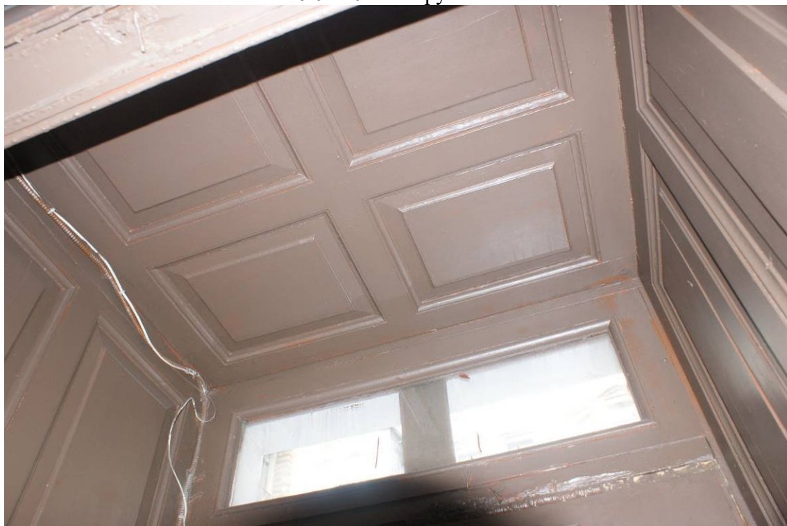
Фото 129. Лестница № 1: Тамбур. 1-й этаж. Оформление потолка. Съемка 26.04.2021 г. Трушковский В.Э.
