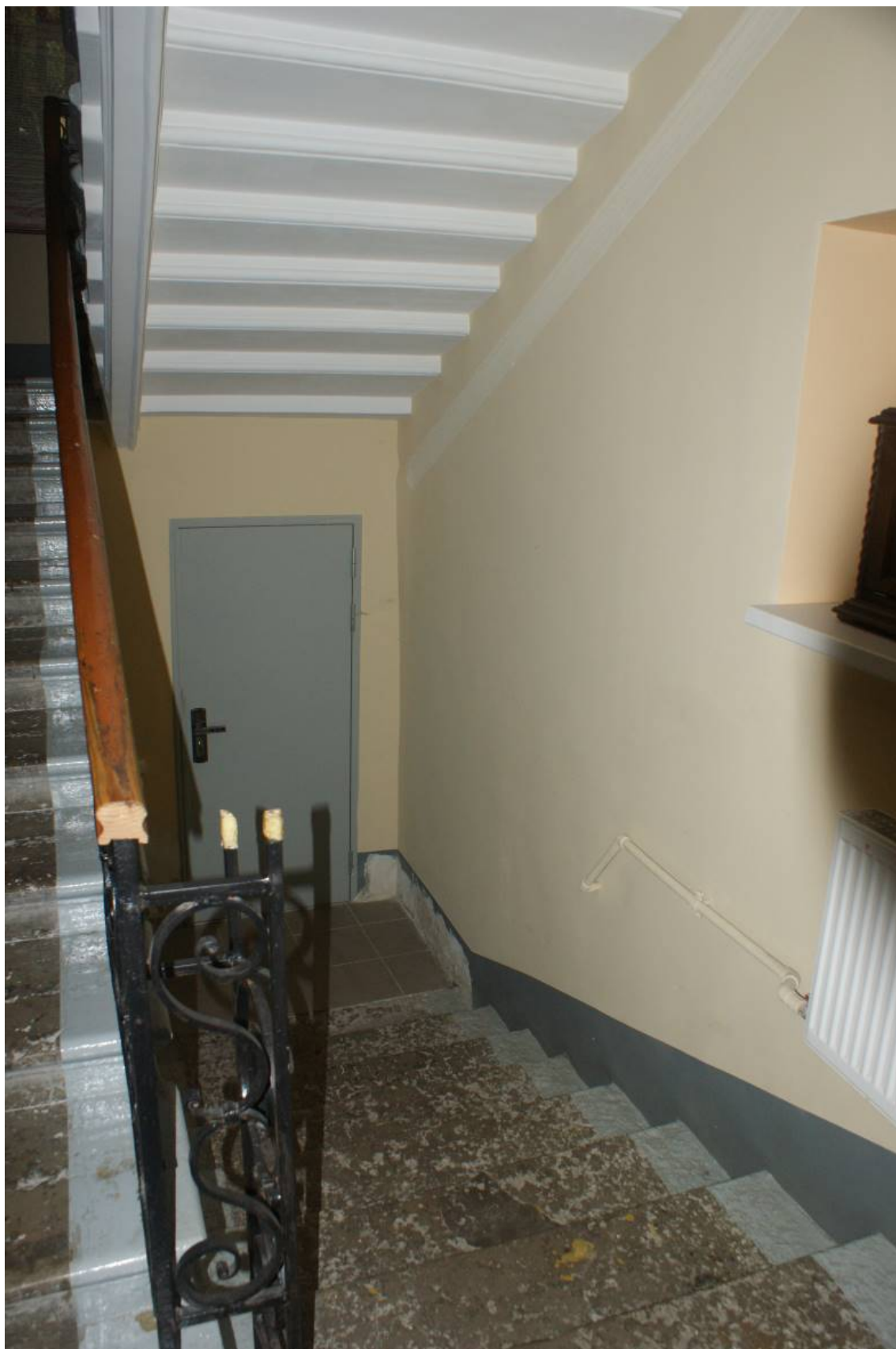
Фото 236. Лестница № 1: Лестничный марш в подвал. Съемка 26.04.2021 г. Трушковский В.Э.
