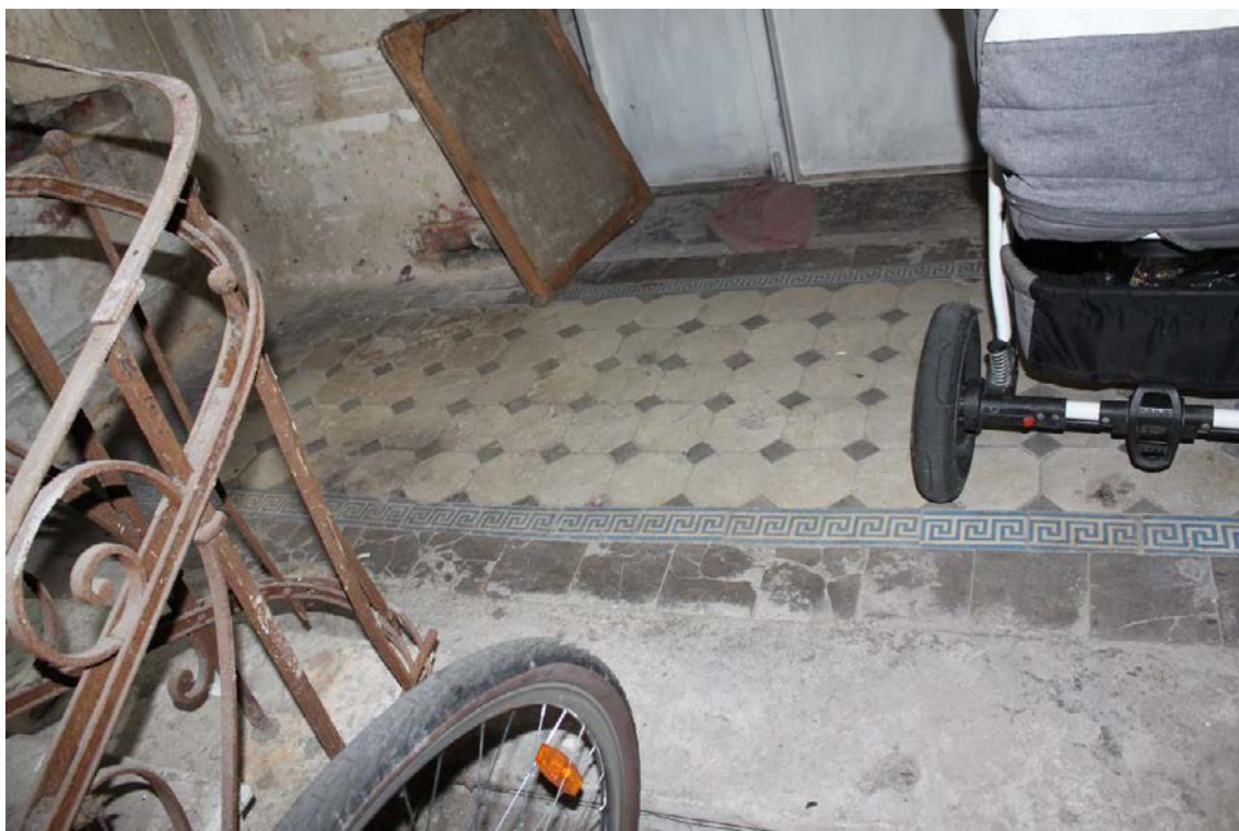
Фото 210. Лестница № 3: Площадка между 1-м и 2-м этажом. Покрытие пола. Съемка 26.04.2021 г. Трушковский В.Э.
