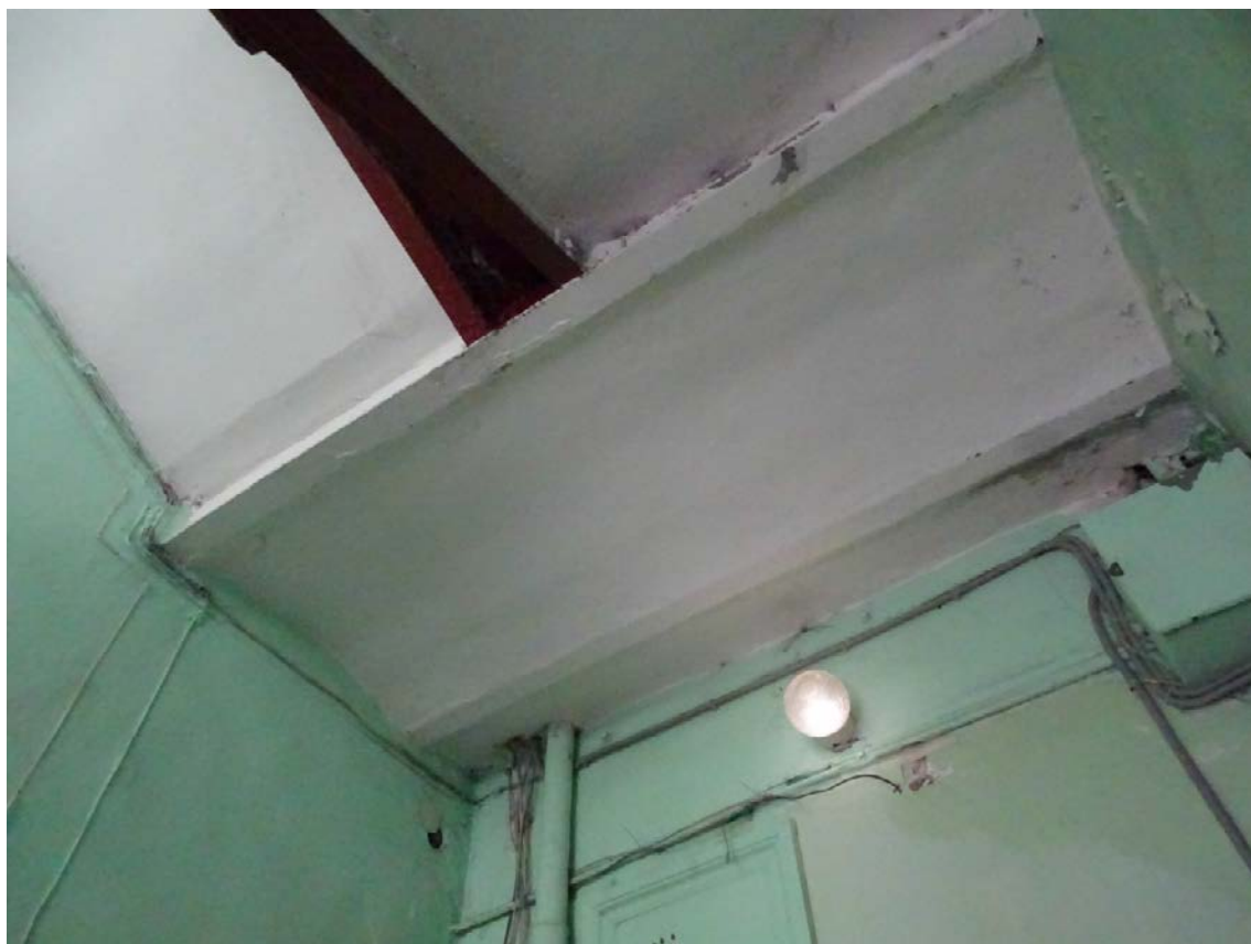
Фото 192. Лестница № 2: 2 этаж. Междуэтажное перекрытие в виде цилиндрического свода. Съемка 26.04.2021 г. Трушковский В.Э.
