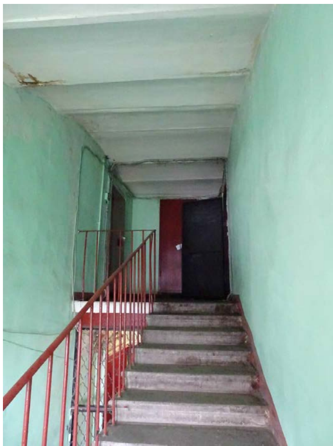
Фото 205. Лестница № 2: Чердачный этаж. Съемка 26.04.2021 г. Трушковский В.Э.
