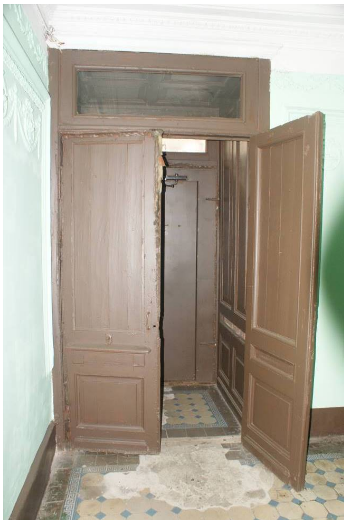
Фото 128. Лестница № 1: Вестибюль. 1-й этаж. Дверь в тамбур. Съемка 26.04.2021 г. Трушковский В.Э.
