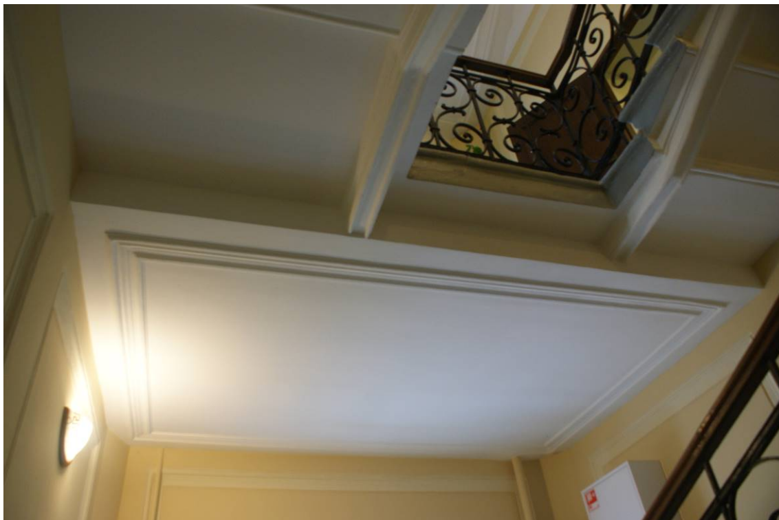
Фото 245. Лестница № 1: Смежная площадка 2-го этажа. Съемка 26.04.2021 г. Трушковский В.Э.
