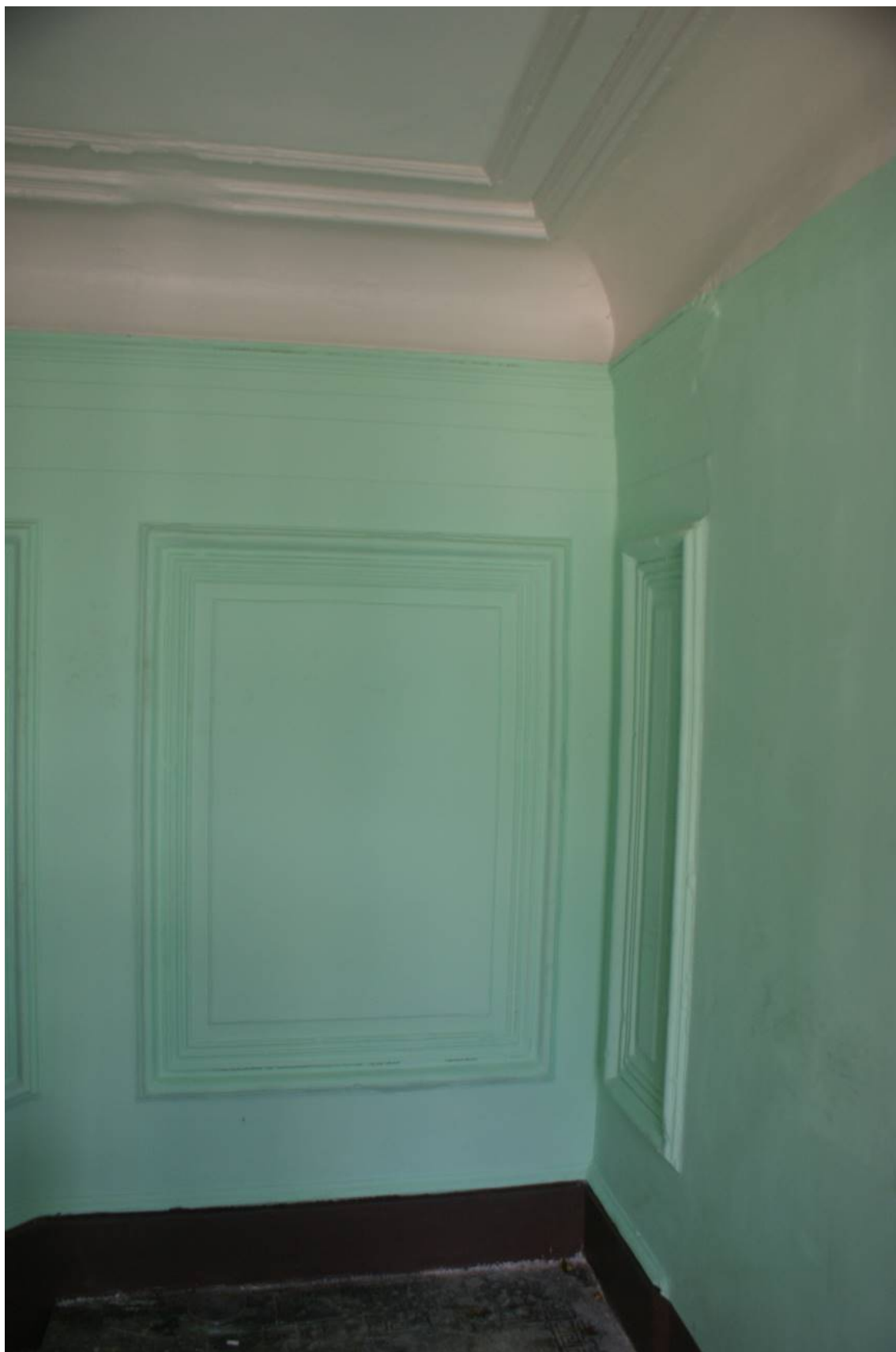
Фото 184. Лестница № 1: Площадка между 6-м и чердачным этажом. Профилированные рамы стен и потолка. Съемка 26.04.2021 г. Трушковский В.Э.
