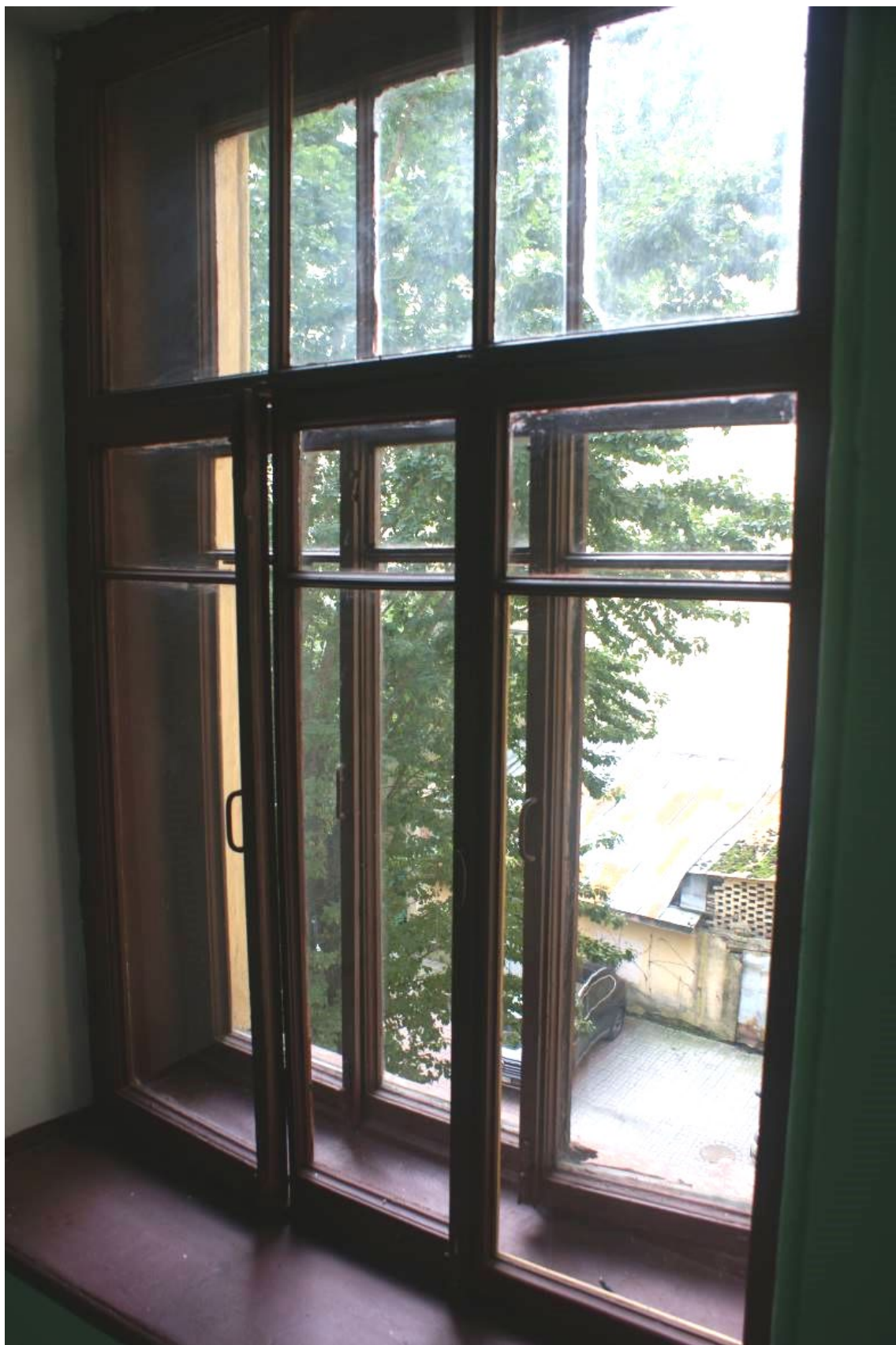
Фото 166. Лестница № 1: Площадка между 3-м и 4-м этажом. Оформление окна. Съемка 26.04.2021 г. Трушковский В.Э.
