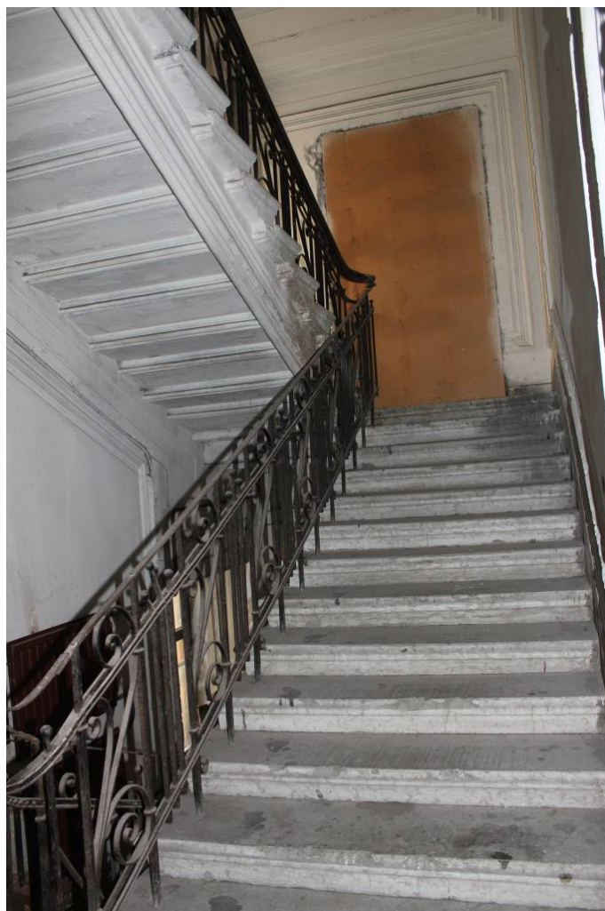
Фото 214. Лестница № 3: Лестничный марш на площадку между 2-м и 3-м этажом. Съемка 26.04.2021 г. Трушковский В.Э.
