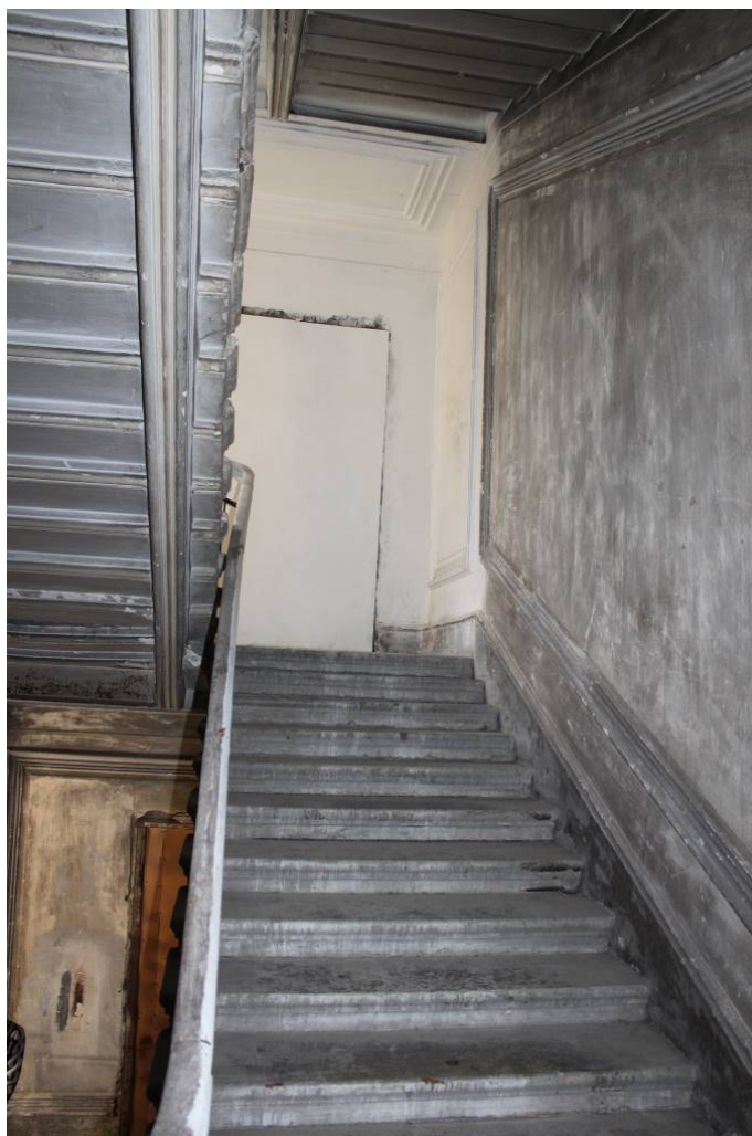
Фото 228. Лестница № 3: Лестничный марш на площадку между 5-м и 6-м этажом. Съемка 26.04.2021 г. Трушковский В.Э.
