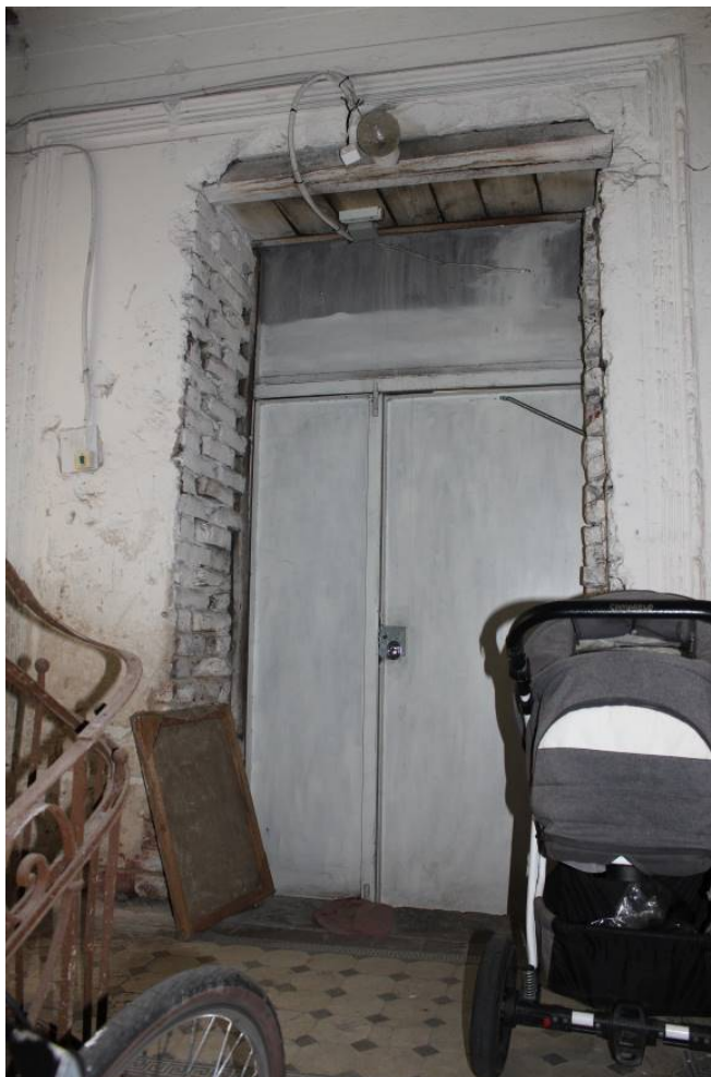
Фото 208. Лестница № 3: Площадка между 1-м и 2-м этажом. Входная дверь. Съемка 26.04.2021 г. Трушковский В.Э.
