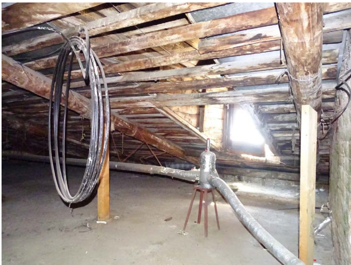
Фото 207. Лестница № 2: Чердак. Съемка 26.04.2021 г. Трушковский В.Э.
