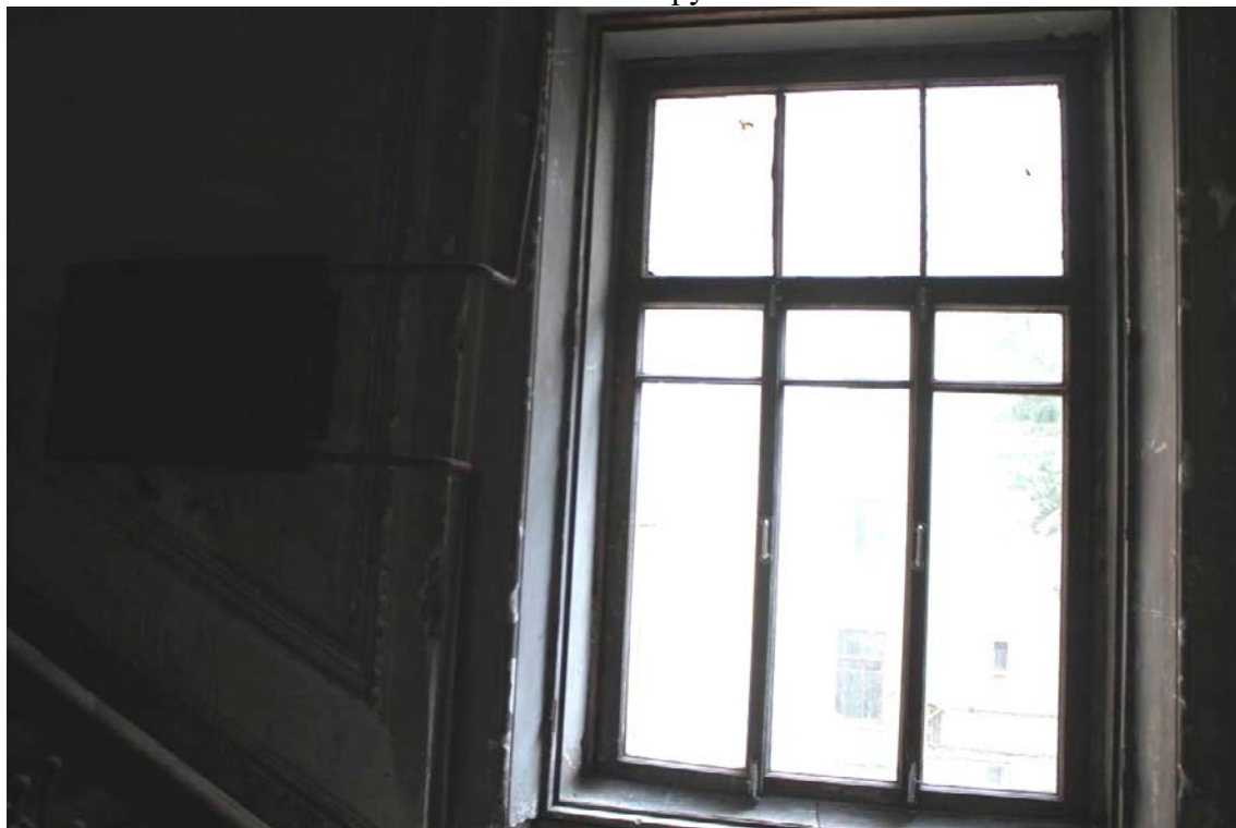
Фото 219. Лестница № 3: Площадка между 3-м и 4-м этажом. Оформление окна. Съемка 26.04.2021 г. Трушковский В.Э.
