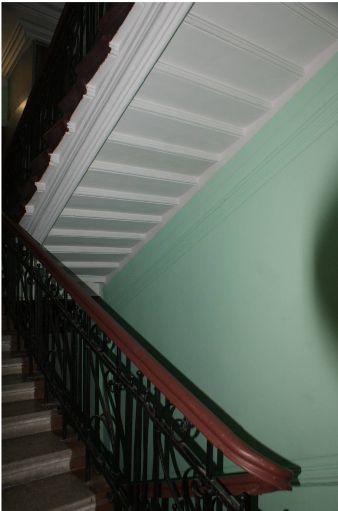
Фото 155. Лестница № 1: Площадка между 1-м и 2-м этажом. Лестничный марш. Съемка 26.04.2021 г. Трушковский В.Э.
