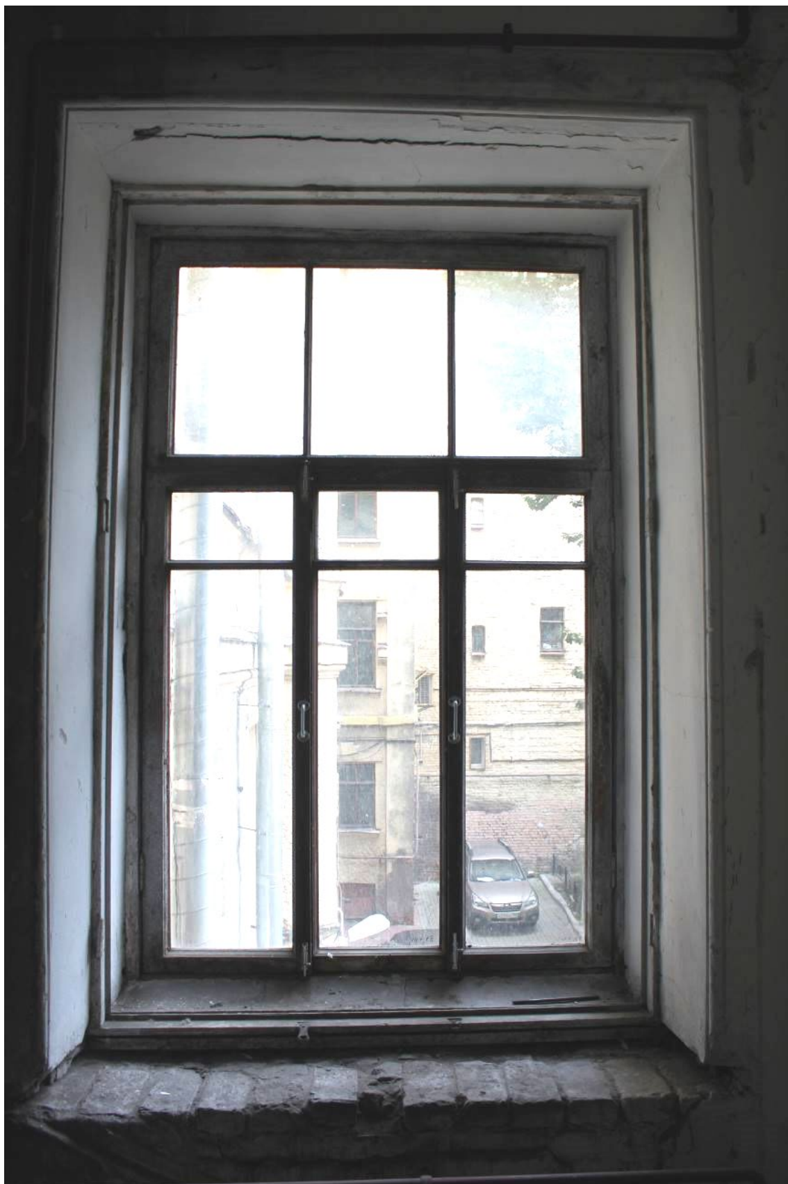
Фото 216. Лестница № 3: Площадка между 2-м и 3-м этажом. Оформление окна. Съемка 26.04.2021 г. Трушковский В.Э.
