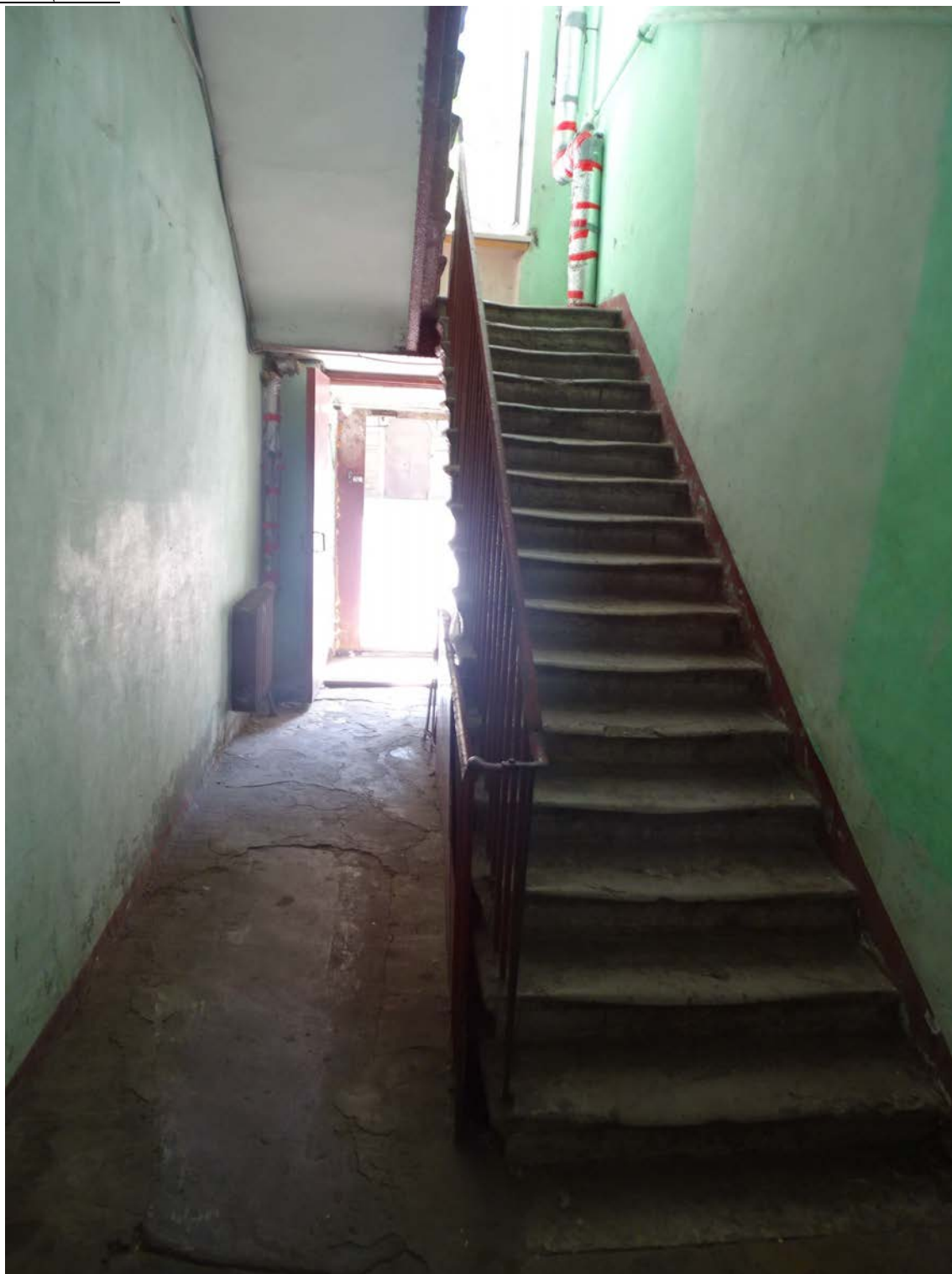
Фото 185. Лестница № 2: 1 этаж. Вход в лестничную клетку. Съемка 26.04.2021 г. Трушковский В.Э.
