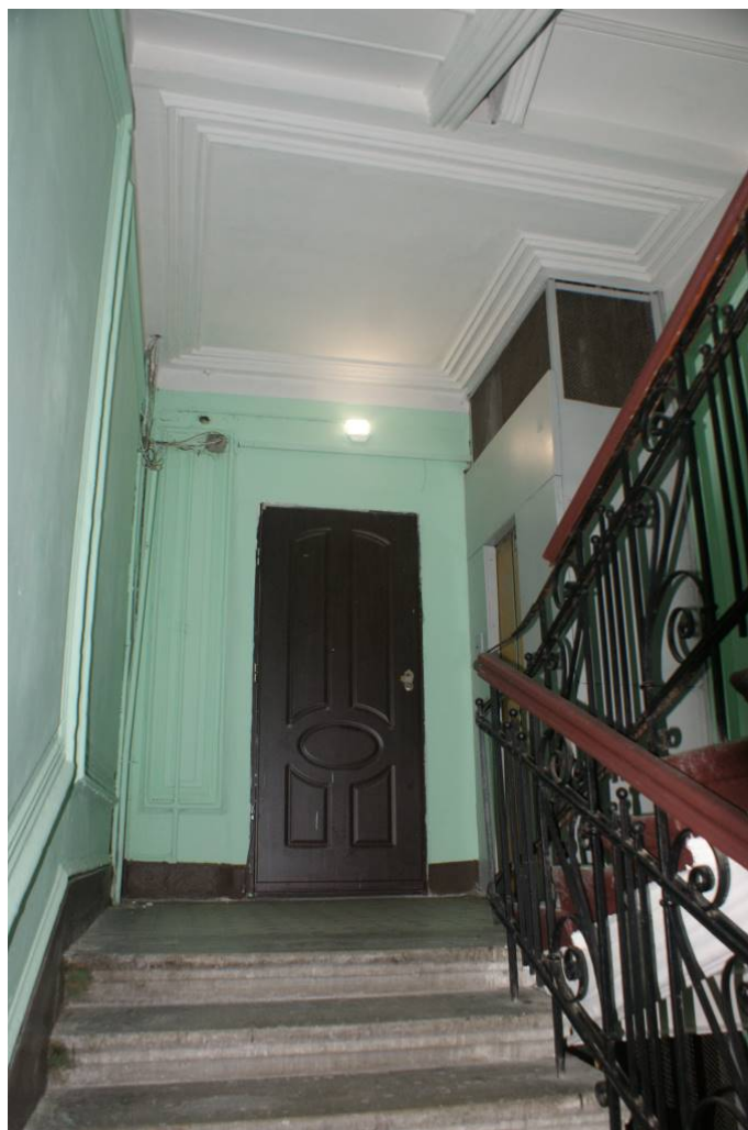
Фото 173. Лестница № 1: Площадка 5-го этажа. Съемка 26.04.2021 г. Трушковский В.Э.
