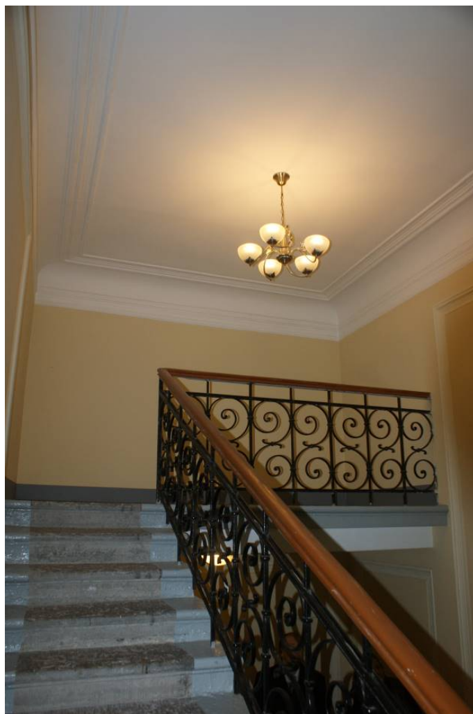
Фото 251. Лестница № 1: Площадка между 3-м и чердачным этажом. Съемка 26.04.2021 г. Трушковский В.Э.
