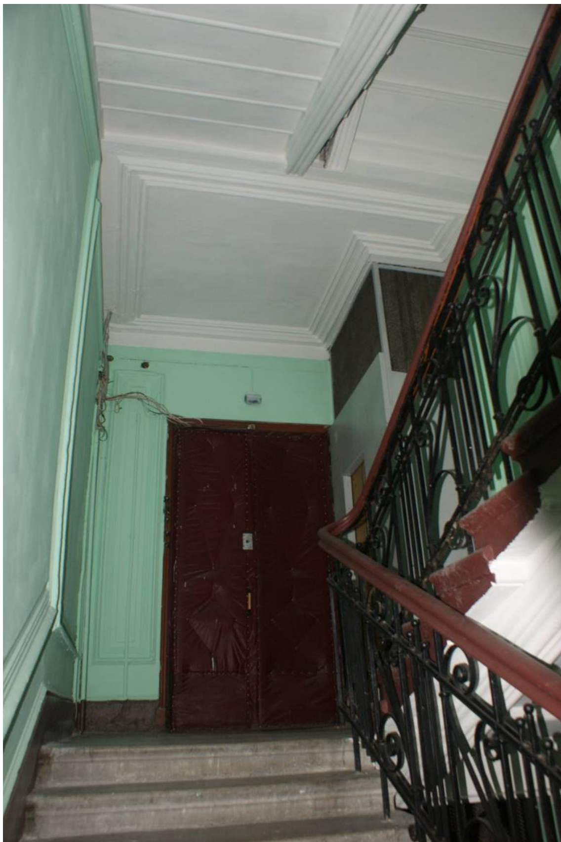
Фото 167. Лестница № 1: 4 этаж. Съемка 26.04.2021 г. Трушковский В.Э.
