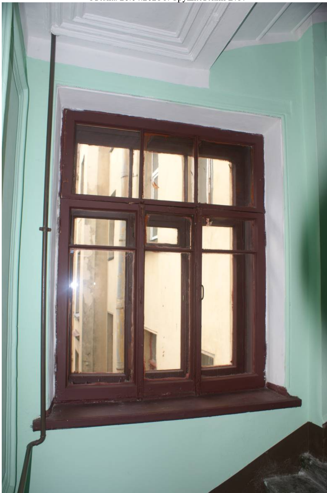
Фото 172. Лестница № 1: Площадка между 4-м и 5-м этажом. Оформление окна. Съемка 26.04.2021 г. Трушковский В.Э.
