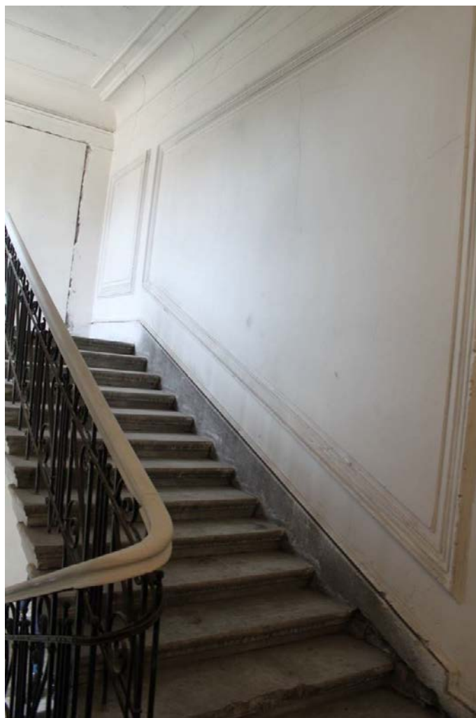
Фото 232. Лестница № 3: Лестничный марш на площадку между 6-м и чердачным этажом. Оформление стен. Съемка 26.04.2021 г. Трушковский В.Э.
