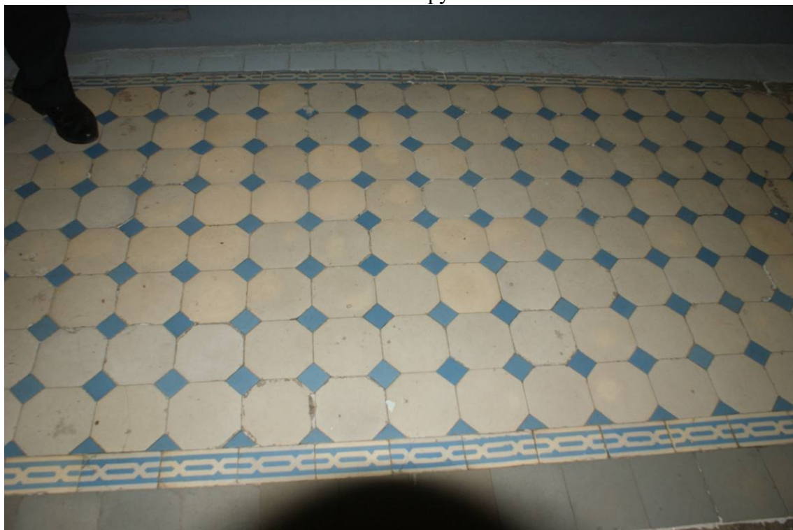
Фото 238. Лестница № 1: Площадка 1-го этажа. Покрытие пола. Съемка 26.04.2021 г. Трушковский В.Э.
