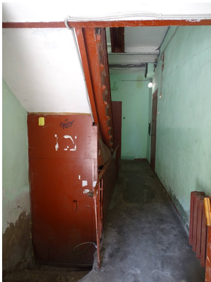
Фото 186. Лестница № 2: 1 этаж. Вход в лестничную клетку. Съемка 26.04.2021 г. Трушковский В.Э.
