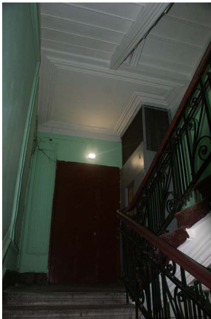
Фото 161. Лестница № 1: 3 этаж. Съемка 26.04.2021 г. Трушковский В.Э.
