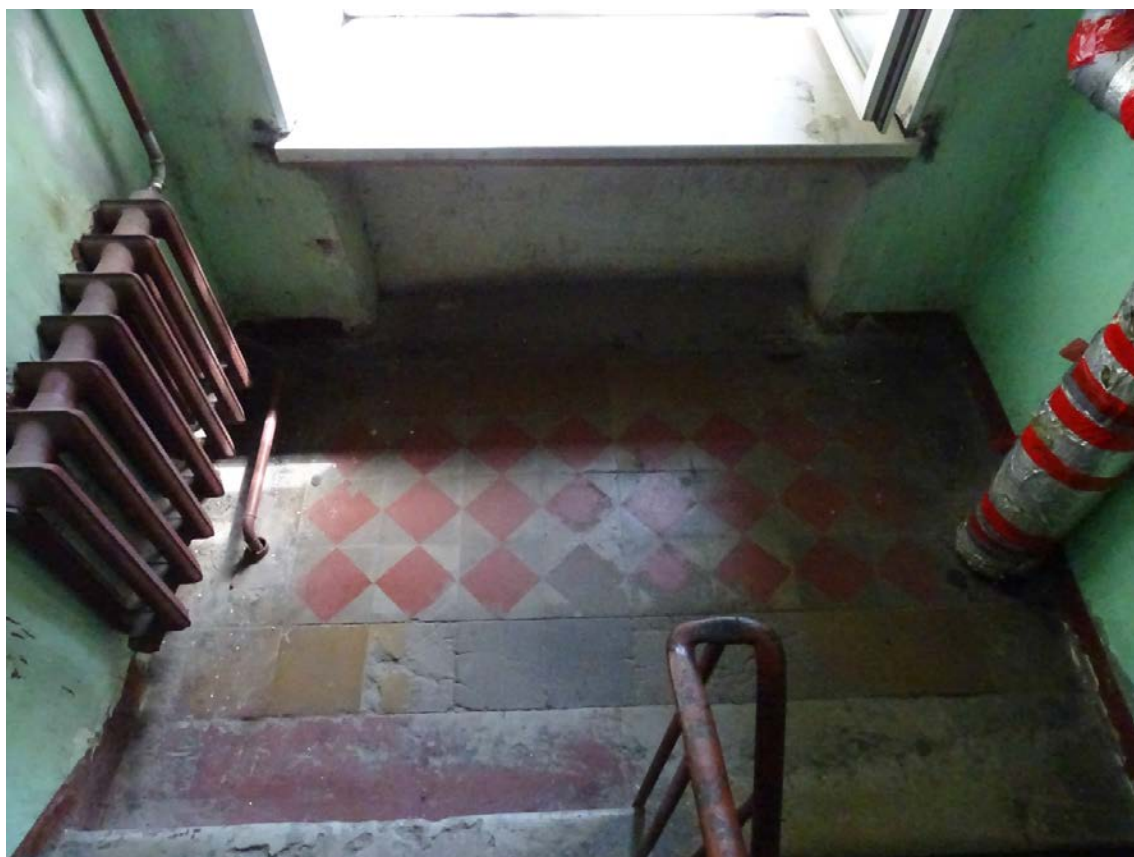
Фото 190. Лестница № 2: Площадка между 1-м и 2-м этажом. Покрытие пола. Съемка 26.04.2021 г. Трушковский В.Э.
