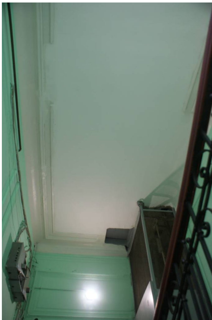
Фото 182. Лестница № 1: Площадка 6-го этажа. Оформление потолка. Съемка 26.04.2021 г. Трушковский В.Э.
