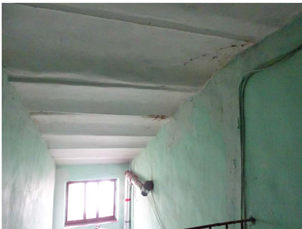
Фото 204. Лестница № 2: Площадка между 5-м и 6-м этажом. Междуетажное перекрытие в виде цилиндрического свода. Съемка 26.04.2021 г. Трушковский В.Э.
