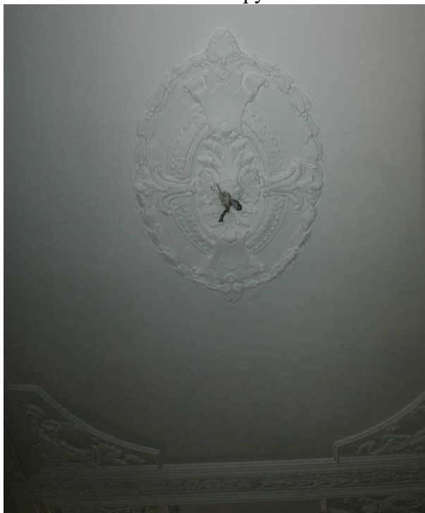
Фото 135. Лестница № 1: Вестибюль.1-й этаж. Оформление потолка. Лепная розетка. Съемка 26.04.2021 г. Трушковский В.Э.
