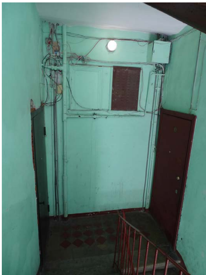
Фото 195. Лестница № 2: 3 этаж. Съемка 26.04.2021 г. Трушковский В.Э.
