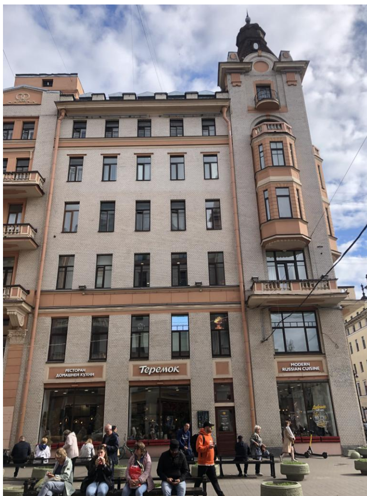
Фото 4. Вид на часть лицевого северного фасада.
