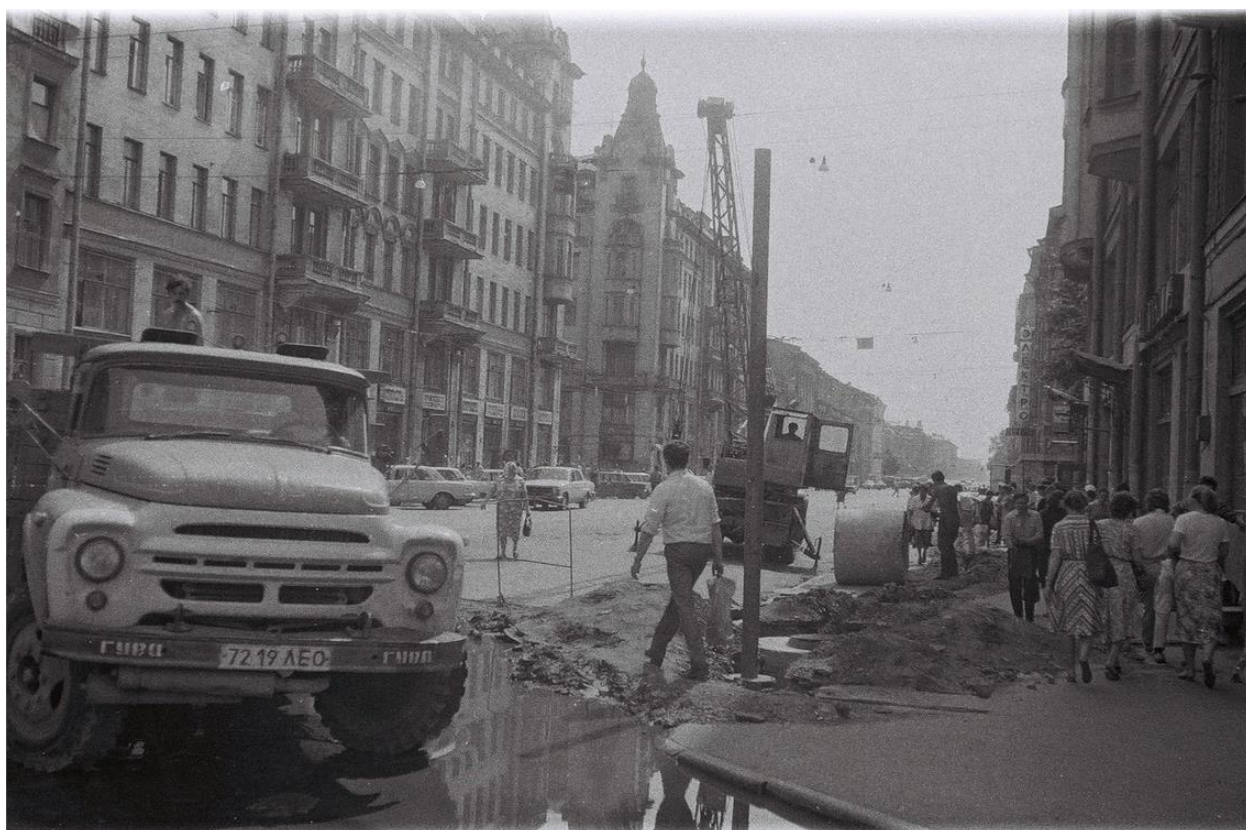
Илл. 20. Вид по направлению с севера на юг на Московский проспект, выявленный объект культурного наследия «Дома М.В. Вяземской (2 здания)». Дата: 1989 г. Источник: информационный портал pastvu.
