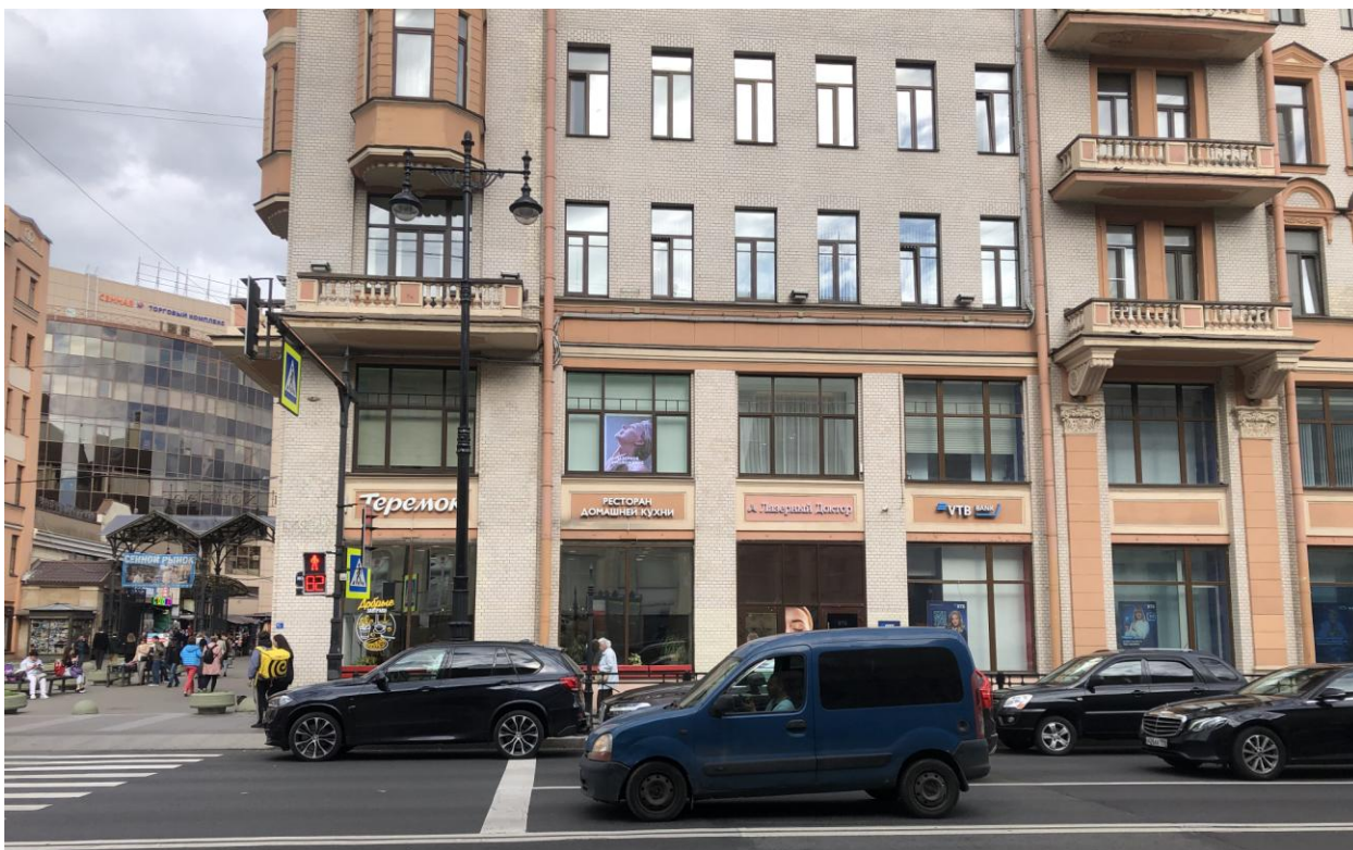
Фото 3. Вид на фрагмент лицевого западного фасада.
