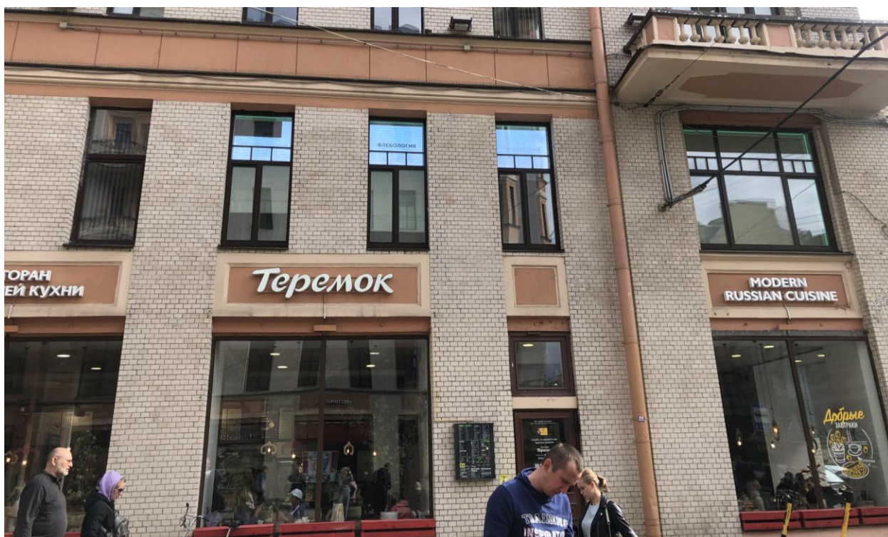
Фото 5. Вид на фрагмент лицевого северного фасада.
