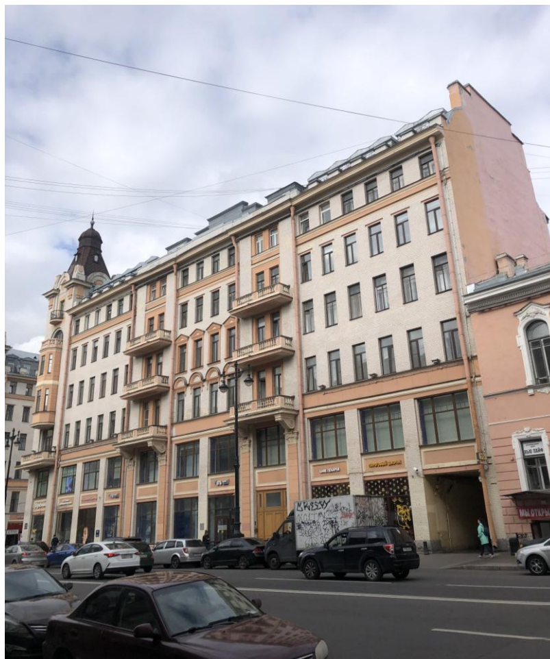
Фото 2. Вид на лицевой западный и торцевой фасады.
