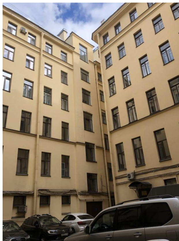
Фото 7. Вид на дворовые фасады.
