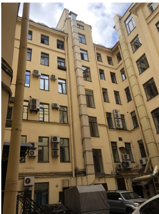
Фото 6. Вид на дворовые фасады.
