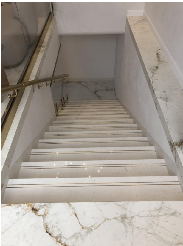
Фото 1. Лестница в пом. № 1.
