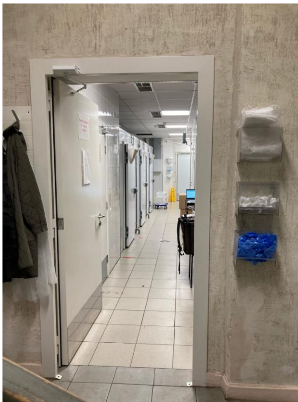
Фото 25. Интерьер первого этажа объекта культурного наследия регионального значения «Службы» (в составе «Мастерские и службы»), входящего в состав объекта культурного наследия регионального значения «Римско-католическое убежище Благотворительного общества для бедных мальчиков (т.н. «Дом Кербедзя»)»
