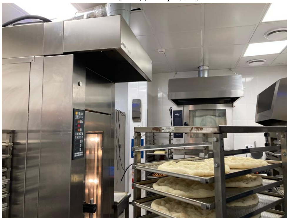
Фото 18. Интерьер первого этажа объекта культурного наследия регионального значения «Службы» (в составе «Мастерские и службы»), входящего в состав объекта культурного наследия регионального значения «Римско-католическое убежище Благотворительного общества для бедных мальчиков (т.н. «Дом Кербедзя»»
