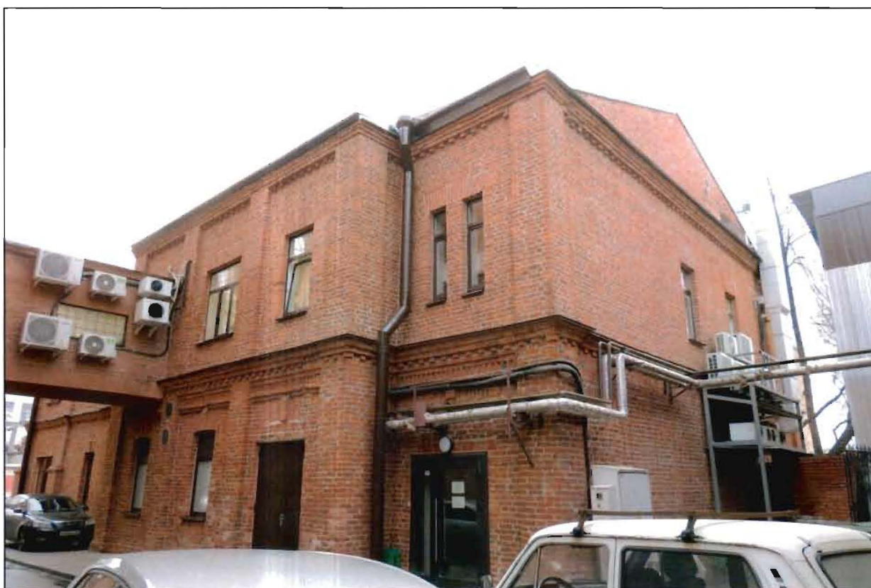
3. Общий вид части объекта культурного наследия с севера.
