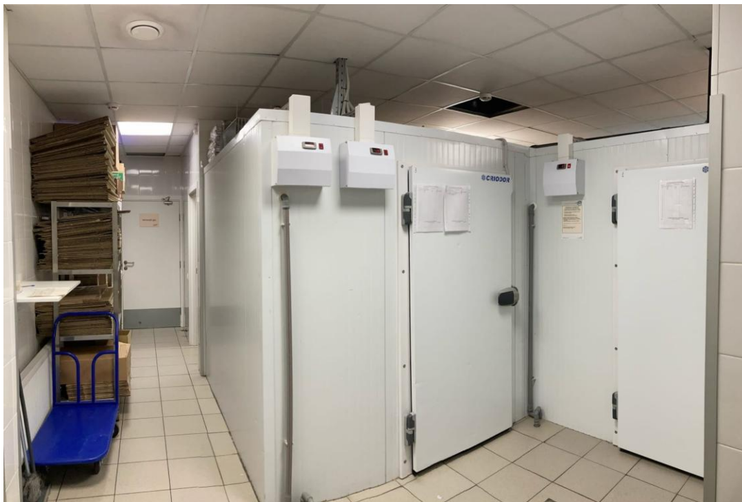
Фото 23. Интерьер первого этажа объекта культурного наследия регионального значения «Службы» (в составе «Мастерские и службы»), входящего в состав объекта культурного наследия регионального значения «Римско-католическое убежище Благотворительного общества для бедных мальчиков (т.н. «Дом Кербедзя»»
