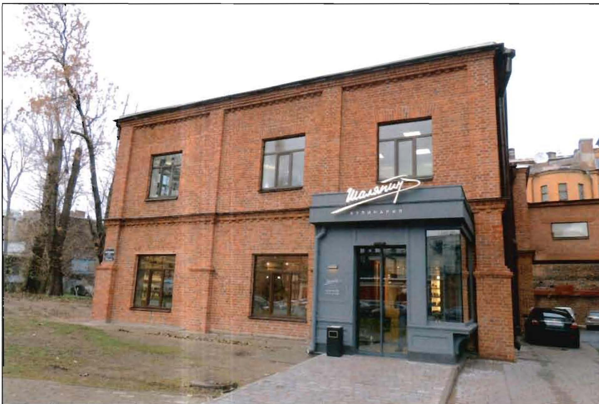
2. Юго-восточный фасад части объекта культурного наследия. Общий вид.
