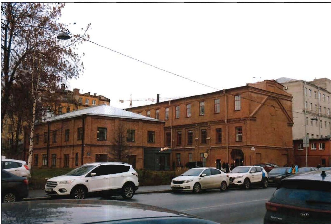
1. Общий вид объекта культурного наследия с юго-востока.
