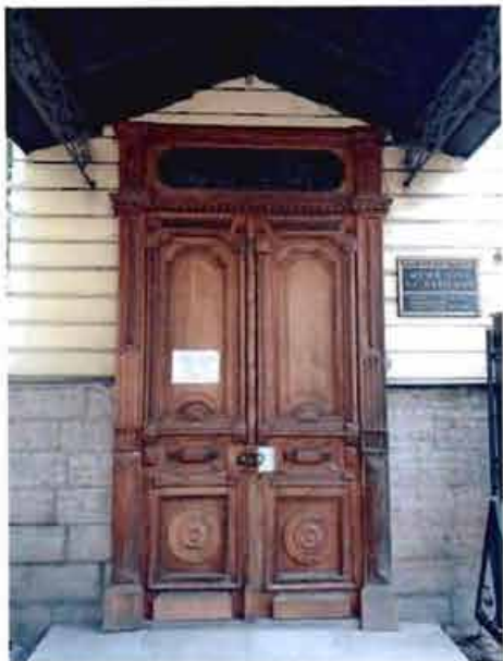
12. Крыльцо в юго-западной части здания
