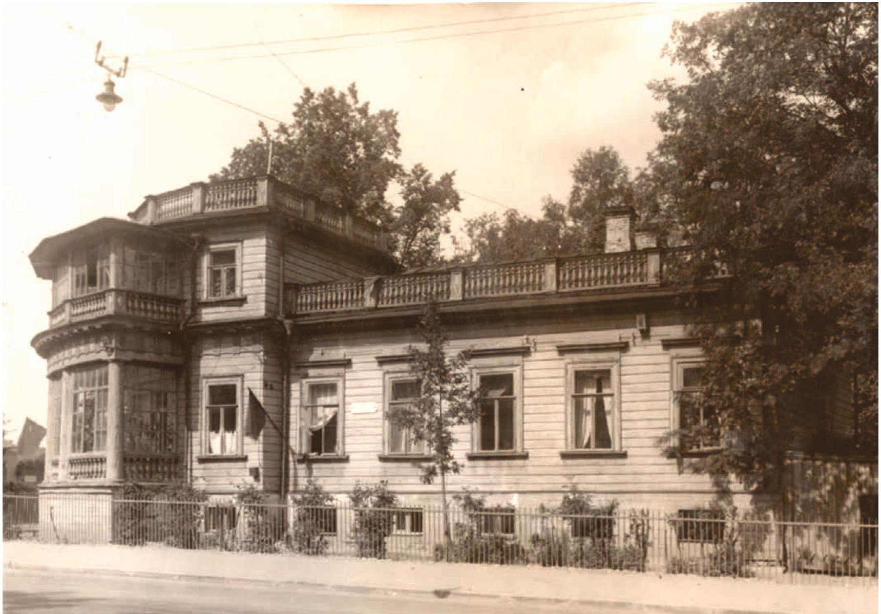
Ил. 10. Колпинская ул., д. № 2. Вид с Колпинской ул. 1939 г. Архив КГИОП, б/н. 1939 г.
