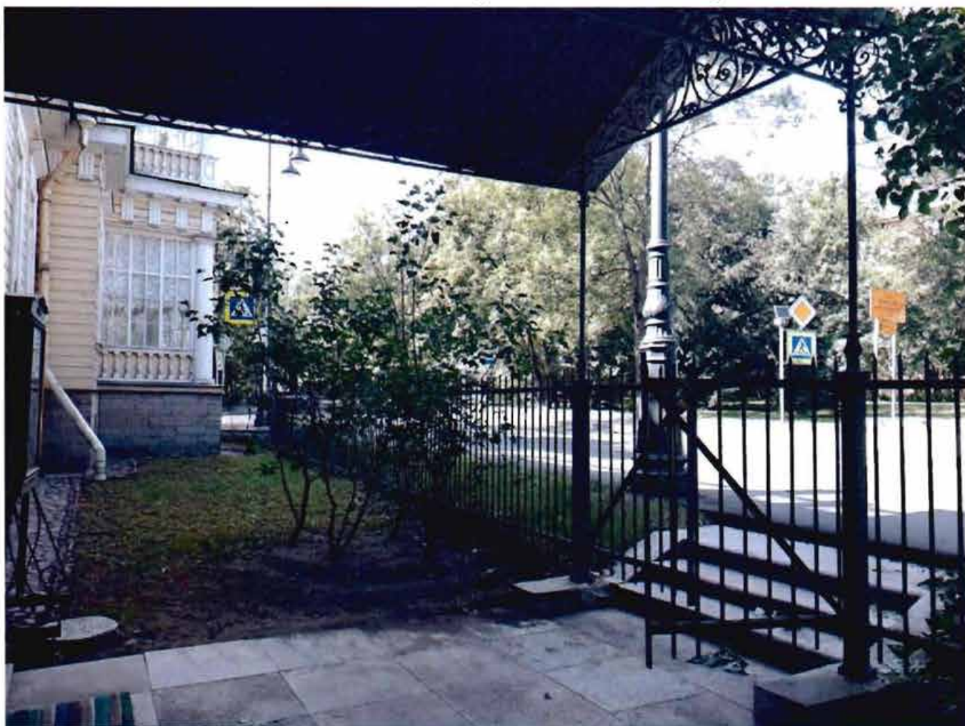
34. Металлическая ограда с юго-западной стороны
