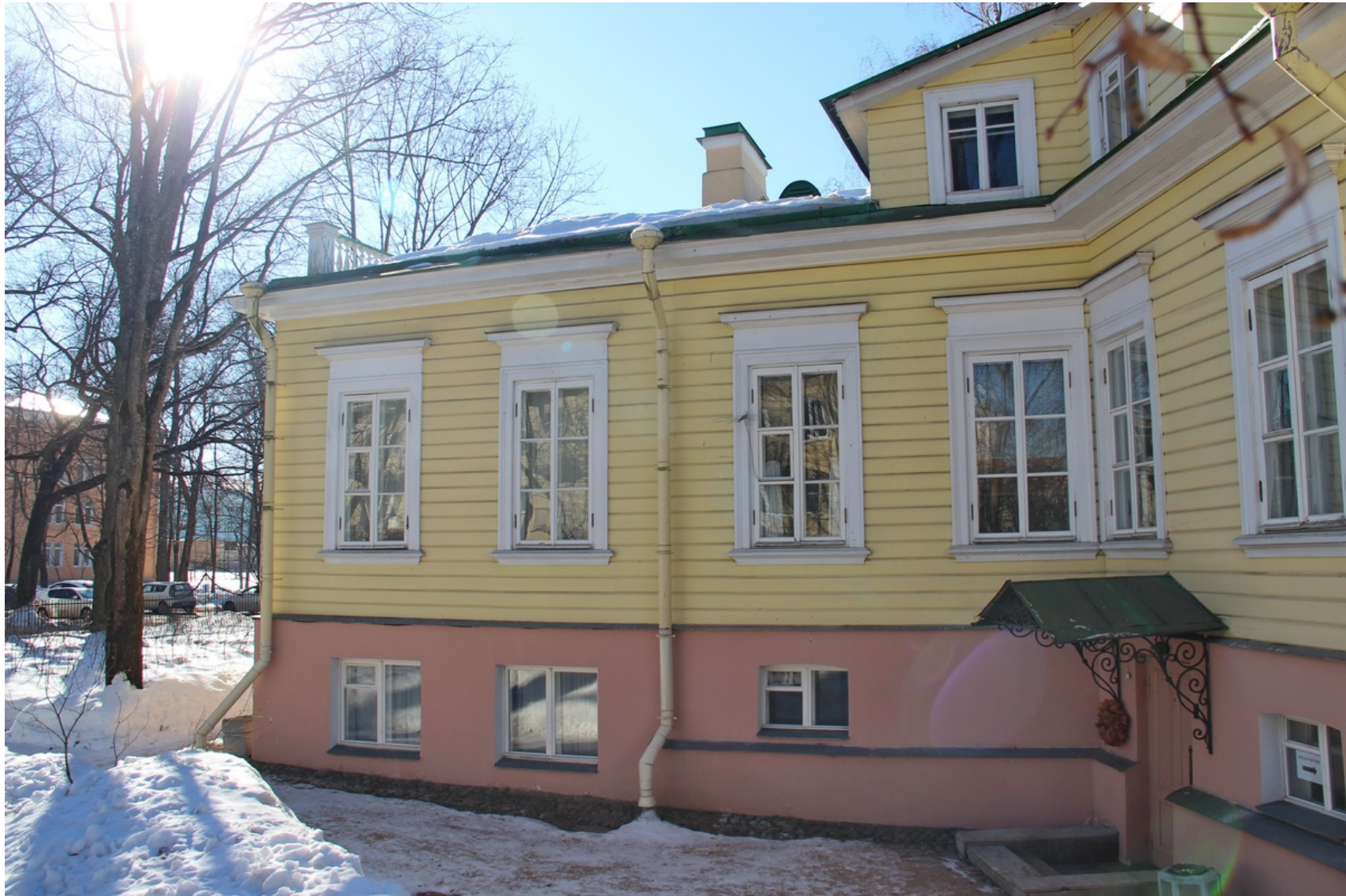
21 ОКН федерального значения "Дом Китаева Я. с оградой и садом. Здесь в 1831 г. жил поэт Пушкин А.С.» Санкт-Петербург, г. Пушкин, Пушкинская ул., д. 2/19, лит. А Северо-восточный дворовый фасад Дата съемки: 01.04.2022 Фото Д.А. Зайцевой
