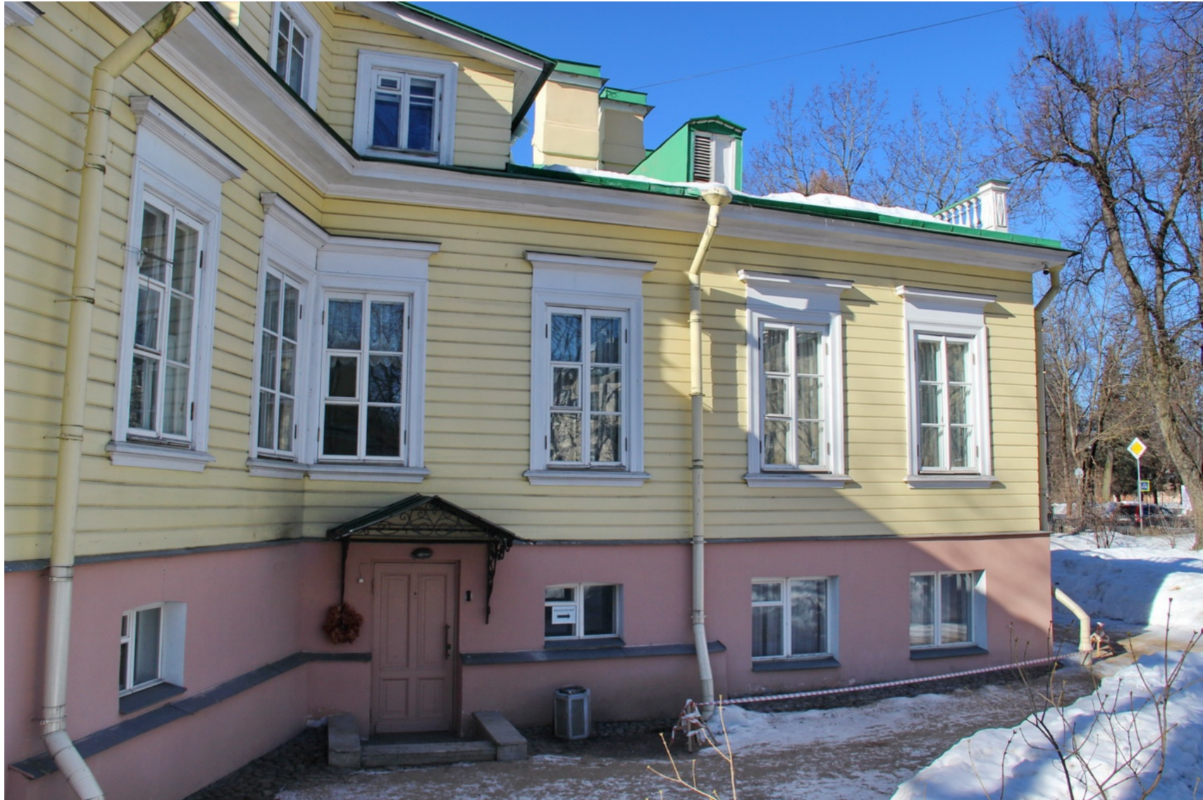
24 ОКН федерального значения "Дом Китаева Я. с оградой и садом. Здесь в 1831 г. жил поэт Пушкин А.С.» Санкт-Петербург, г. Пушкин, Пушкинская ул., д. 2/19, лит. А Восточный дворовый фасад Дата съемки: 01.04.2022 Фото Д.А. Зайцевой
