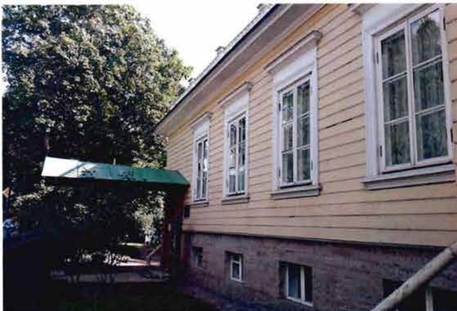
13. Вид на южный фасад здания
