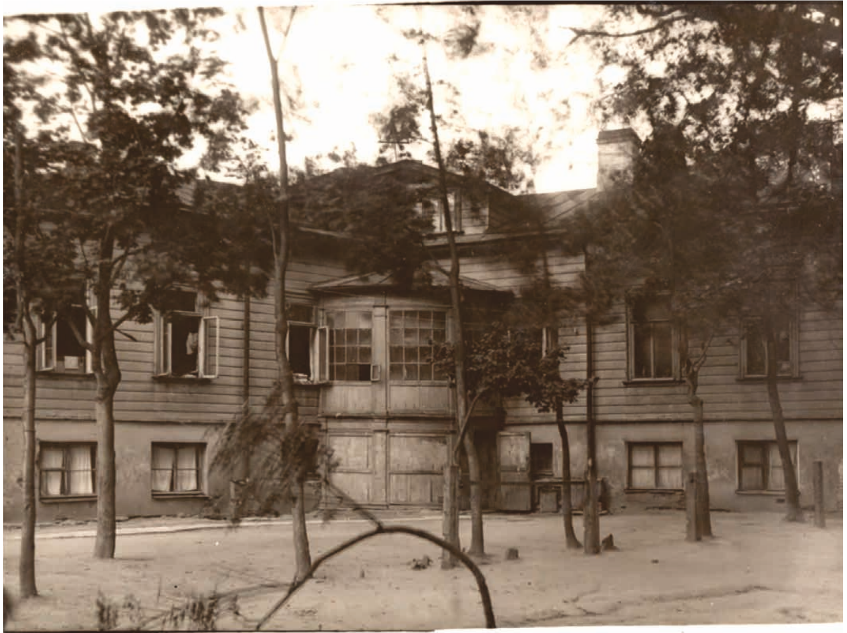
Ил. 7. Колпинская ул., д. № 2. Вид со двора. 1939 г. Архив КГИОП, б/н. 1939 г.
