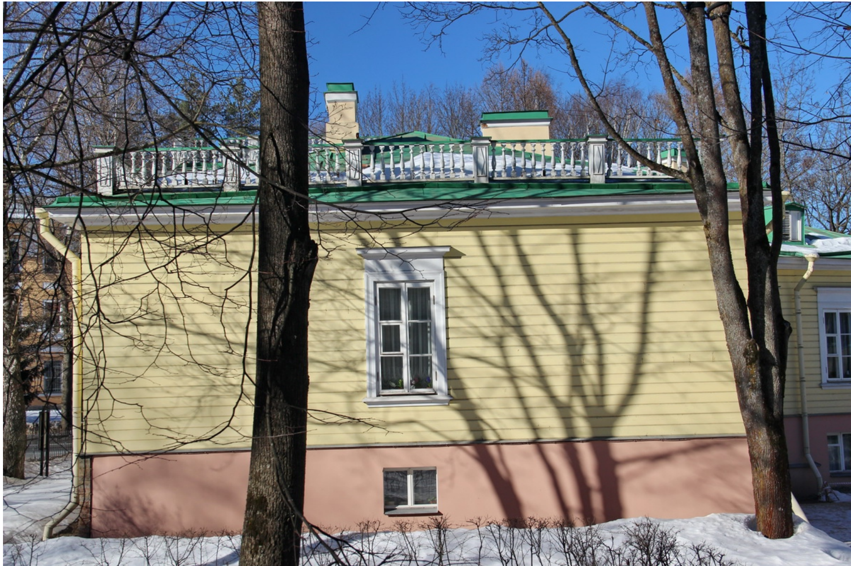
17 ОКН федерального значения "Дом Китаева Я. с оградой и садом. Здесь в 1831 г. жил поэт Пушкин А.С.» Санкт-Петербург, г. Пушкин, Пушкинская ул., д. 2/19, лит. А Восточный фасад Дата съемки: 01.04.2022 Фото Д.А. Зайцевой
