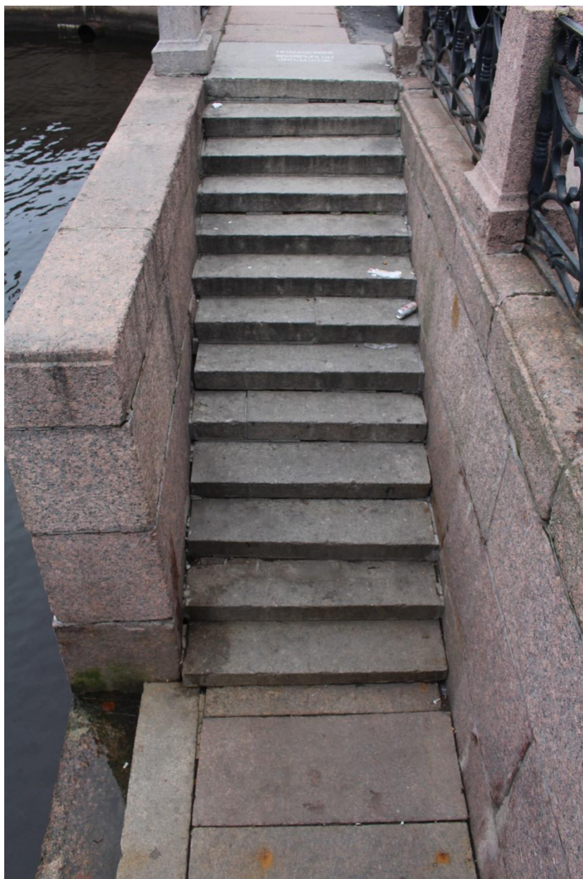
Фото 5. Вид на лестницу и нижнюю площадку спуска № 12 с запада.
