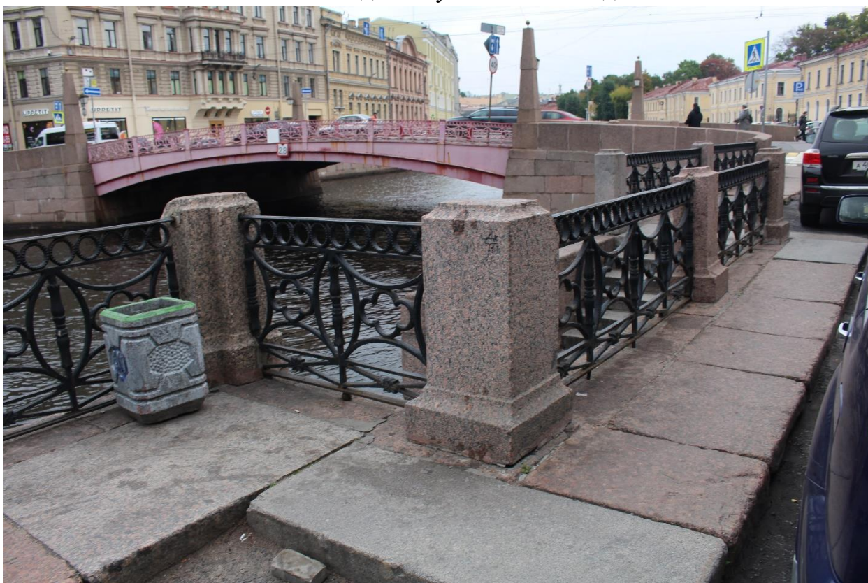
Фото 7. Вид на ограждение спуска № 12.
