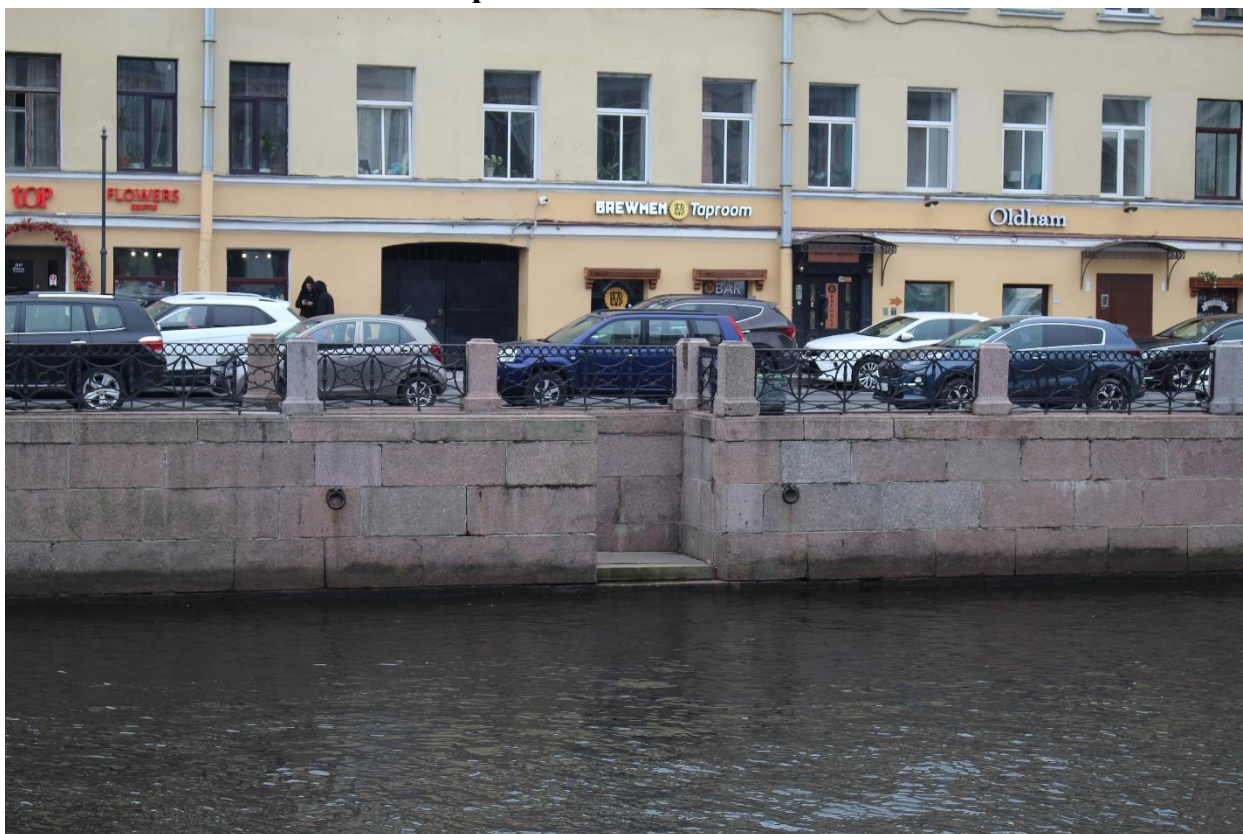
Фото 1. Общий вид на спуск № 12 объекта культурного наследия федерального значения «Набережные со спусками» с левого берега реки Мойки.
