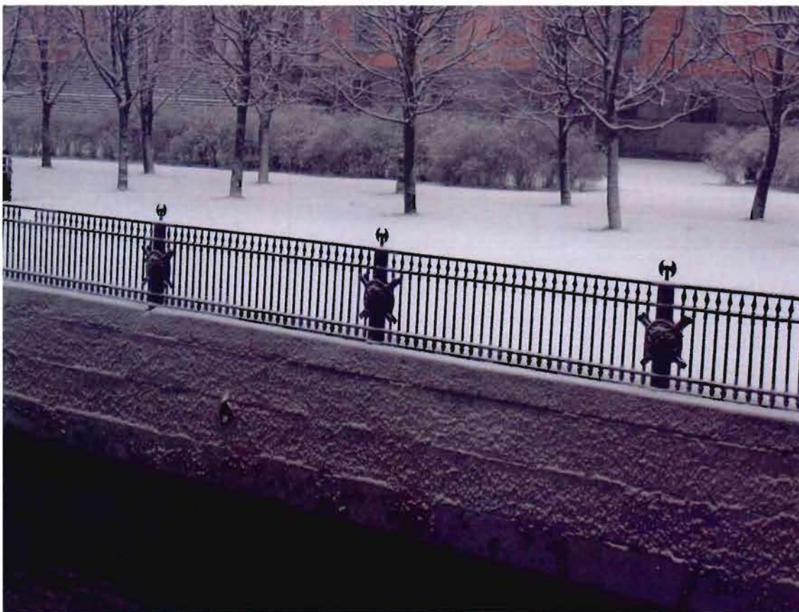
3. Ограждение набережной со стороны Михайловского (Инженерного) замка
