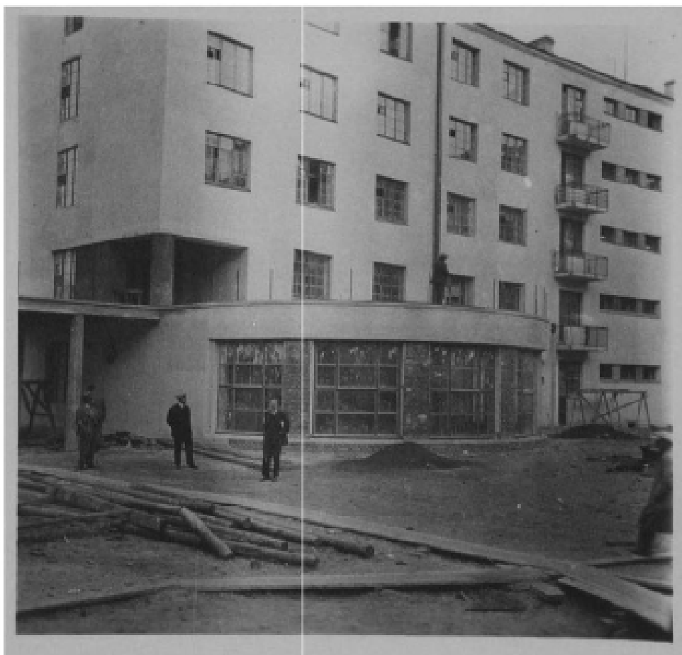
11. Вид на одноэтажную полуцилиндрическую пристройку во дворе, клуб-столовая. 1932-1933 гг. Источник: Канадский центр архитектуры;
