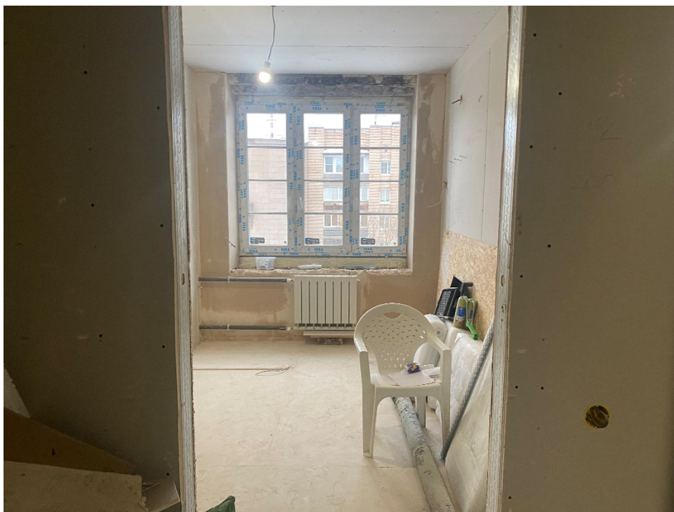
Фото № 6. Фрагмент интерьера кабинета;
