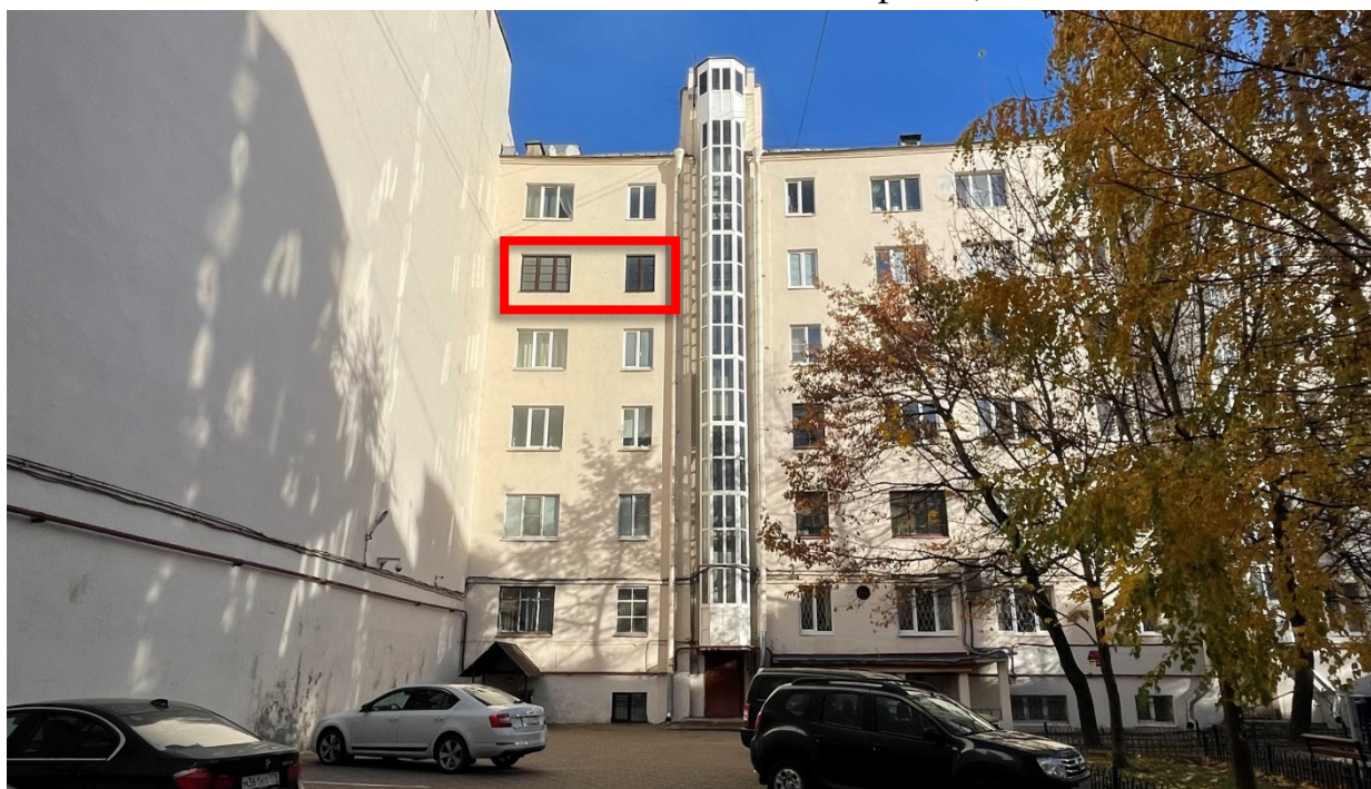
Фото №2. Вид на лицевой фасад;
