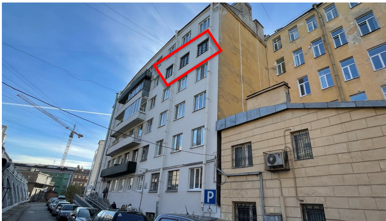
Фото № 1. Вид на лицевой фасад;
