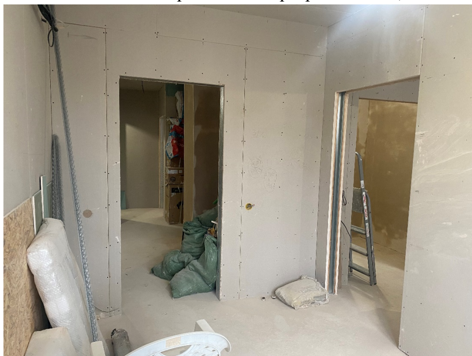
Фото № 7. Фрагмент интерьера кабинета;
