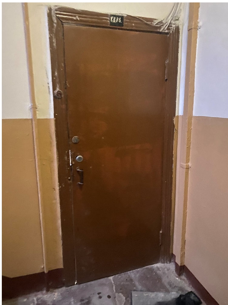
Фото № 3. Вид на входную дверь квартиры;
