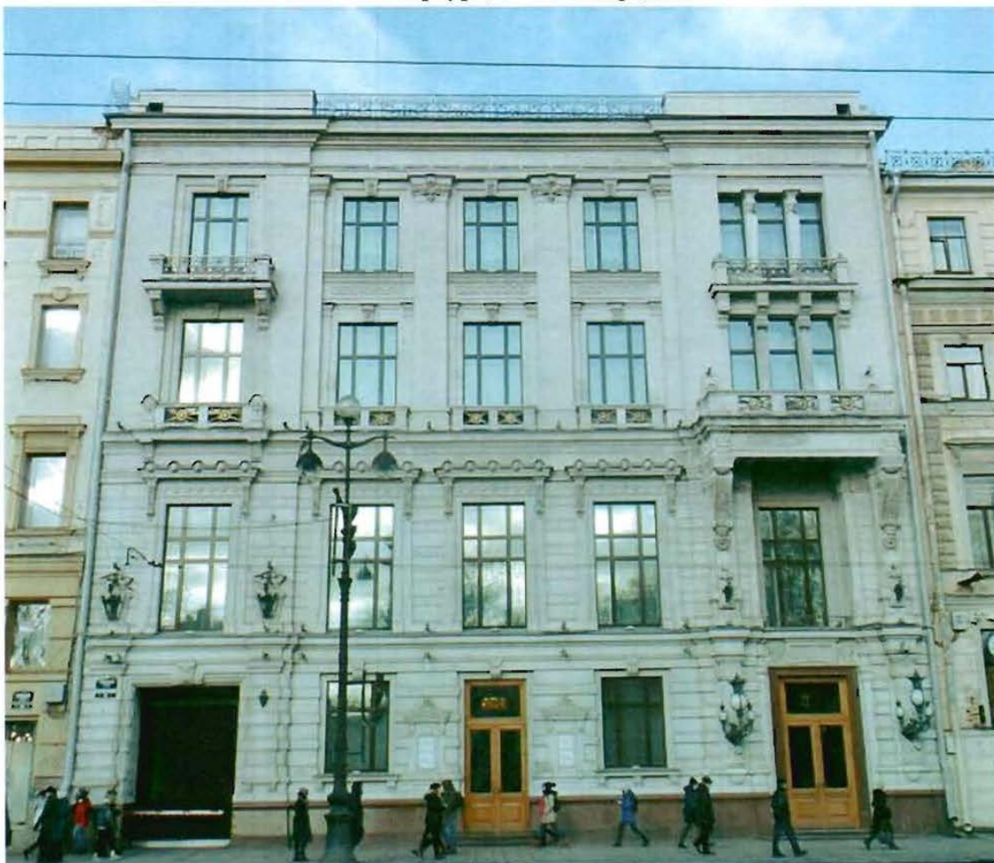
1. Фасад по Невскому проспекту.
