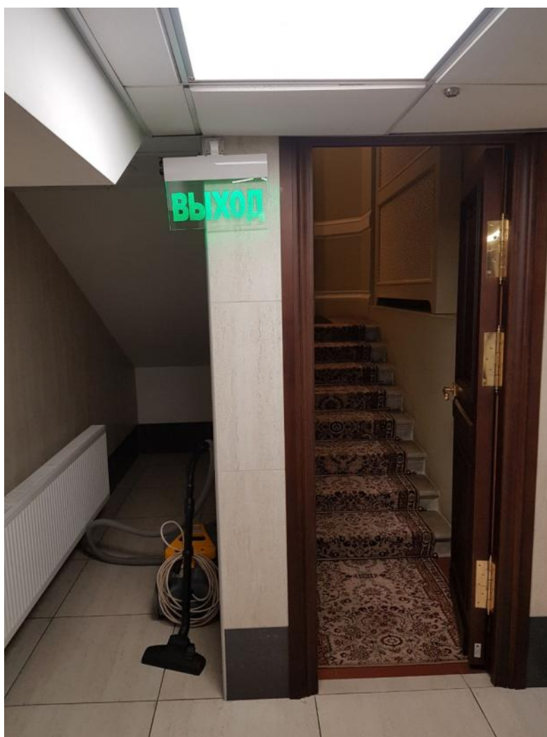
25. ОКН регионального значения «Международный коммерческий банк» по адресу г. Санкт-Петербург, Невский проспект, д.58, литера А. Помещение 1 этажа.
