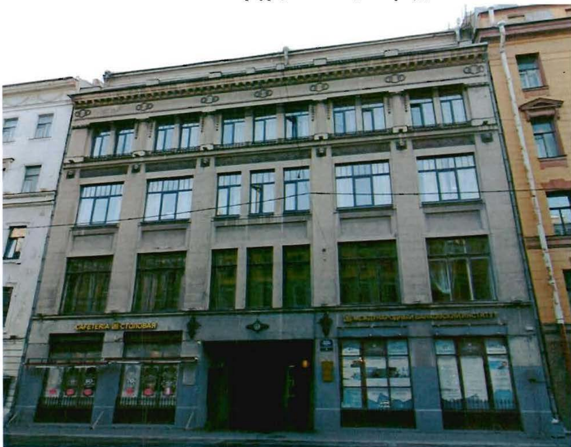
14. Фасад по Малой Садовой улице
