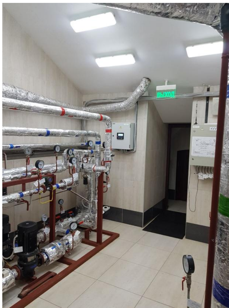
27. ОКН регионального значения «Международный коммерческий банк» по адресу г. Санкт-Петербург, Невский проспект, д.58, литера А. Подвальное помещение
