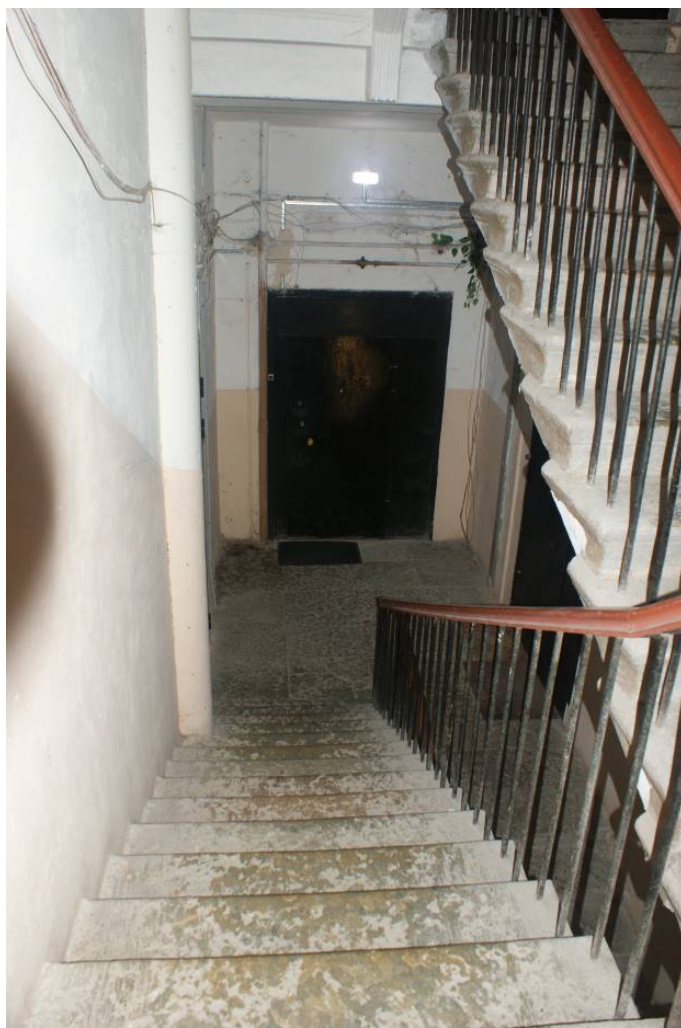
Фото 246. Лестница №3. 2 этаж. Съемка 26.04.2021 г. Трушковский В.Э.
