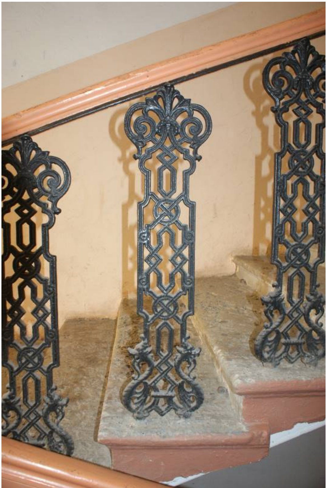
Фото 279. Лестница №4. Лестничное ограждение. Съемка 26.04.2021 г. Трушковский В.Э.
