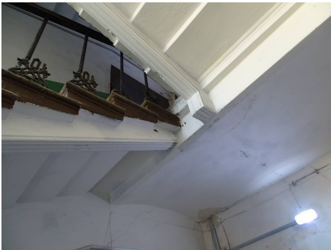
Фото 219. Лестница №2. 4 этаж. Перекрытие из цилиндрического сводика. Съемка 26.04.2021 г. Трушковский В.Э.
