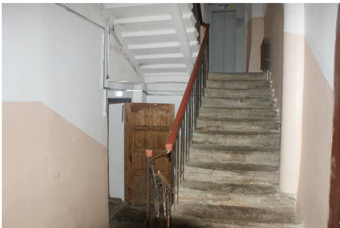
Фото 239. Лестница №3. 1 этаж. Вход в лестничную клетку. Съемка 26.04.2021 г. Трушковский В.Э.
