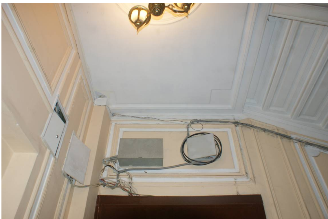
Фото 165. Лестница №1. 2 этаж. Междуэтажное перекрытие. Съемка 26.04.2021 г. Трушковский В.Э.
