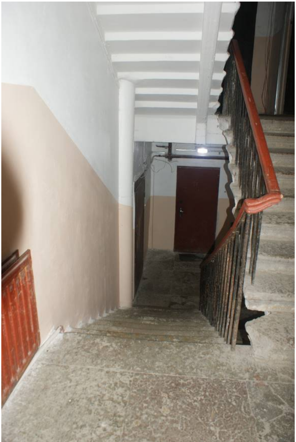
Фото 241. Лестница №3. 1 этаж. Съемка 26.04.2021 г. Трушковский В.Э.
