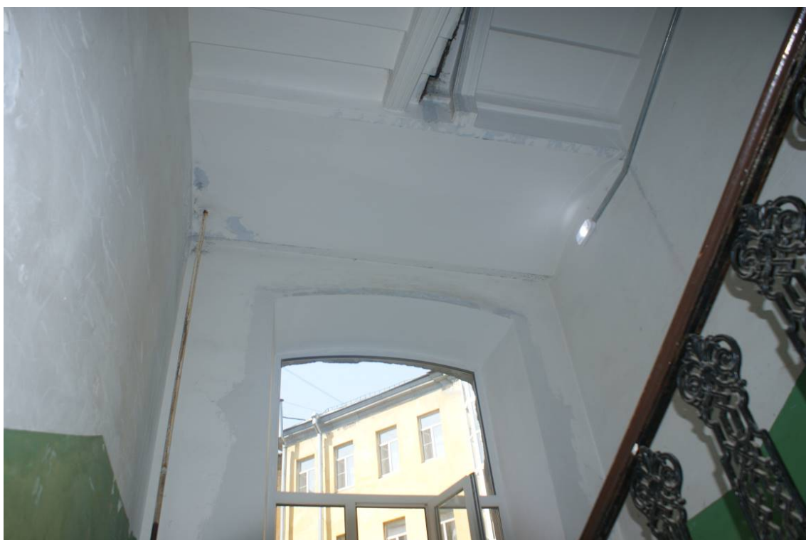
Фото 211. Лестница №2. Площадка между 2-м и 3-м этажом. Перекрытие из цилиндрического сводика. Съемка 26.04.2021 г. Трушковский В.Э.
