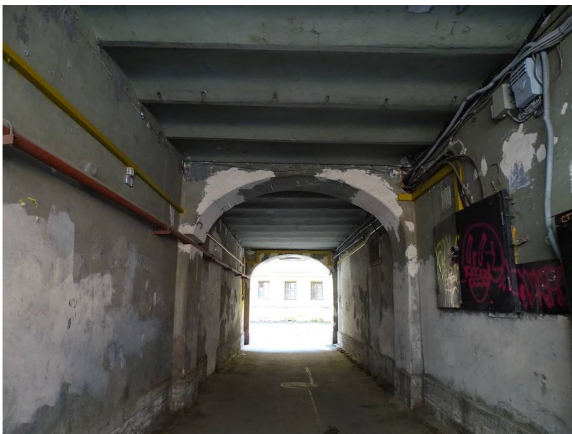
Фото 76. Здание по адресу: г. Санкт-Петербург, Коломенская ул., 14, литера Б. Западный воротный проезд. Съемка 26.04.2021 г. Трушковский В.Э.
