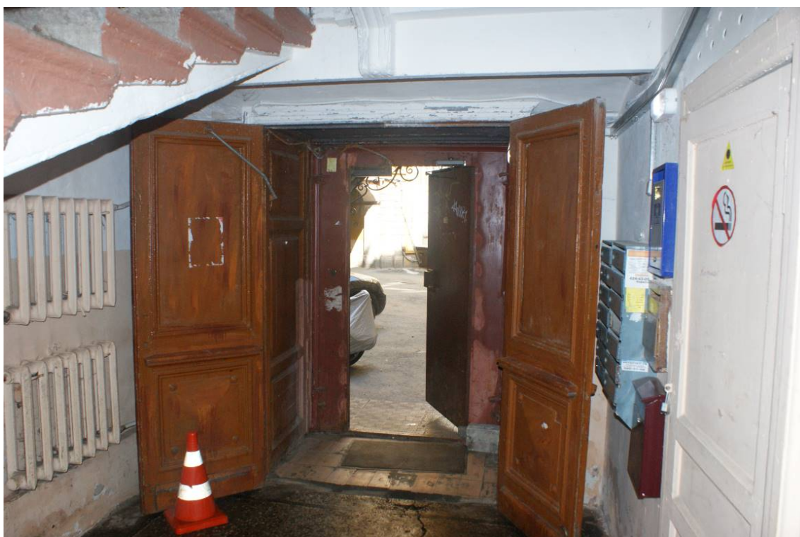
Фото 268. Лестница №4. 1 этаж. Вход на лестницу №4. Съемка 26.04.2021 г. Трушковский В.Э.
