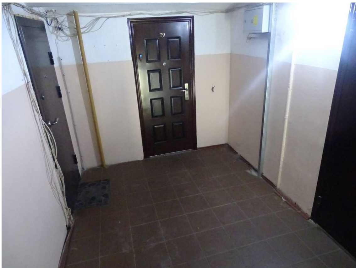
Фото 257. Лестница №3. 6 этаж. Съемка 26.04.2021 г. Трушковский В.Э.
