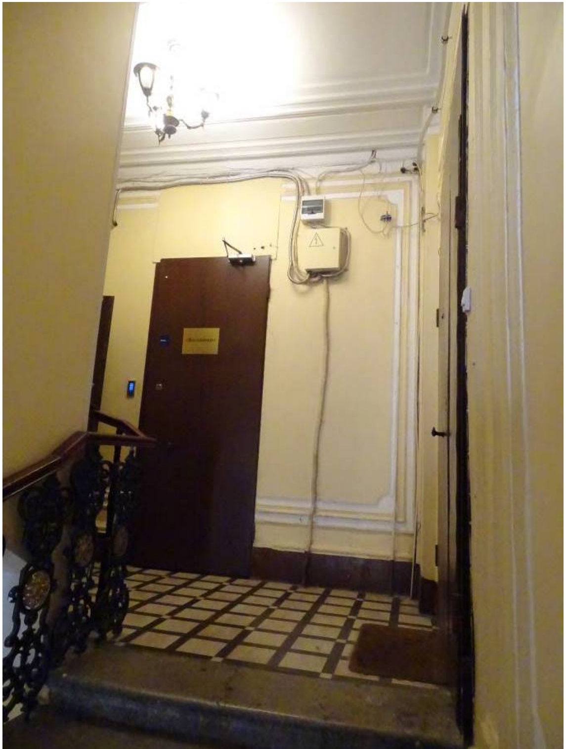
Фото 184. Лестница №1. 5 этаж. Съемка 26.04.2021 г. Трушковский В.Э.
