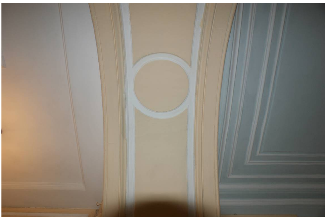
Фото 156. Лестница №1. 1 этаж. Фрагмент оформления арки. Съемка 26.04.2021 г. Трушковский В.Э.
