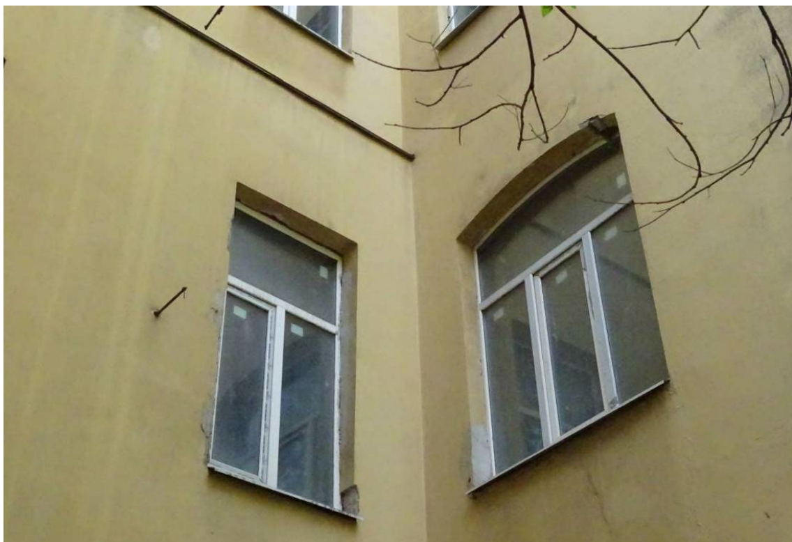
Фото 119. Здание по адресу: г. Санкт-Петербург, Коломенская ул., 14, литера Б. Фрагмент северного фасада. Окна 2-го этажа. Съемка 26.04.2021 г. Трушковский В.Э.
