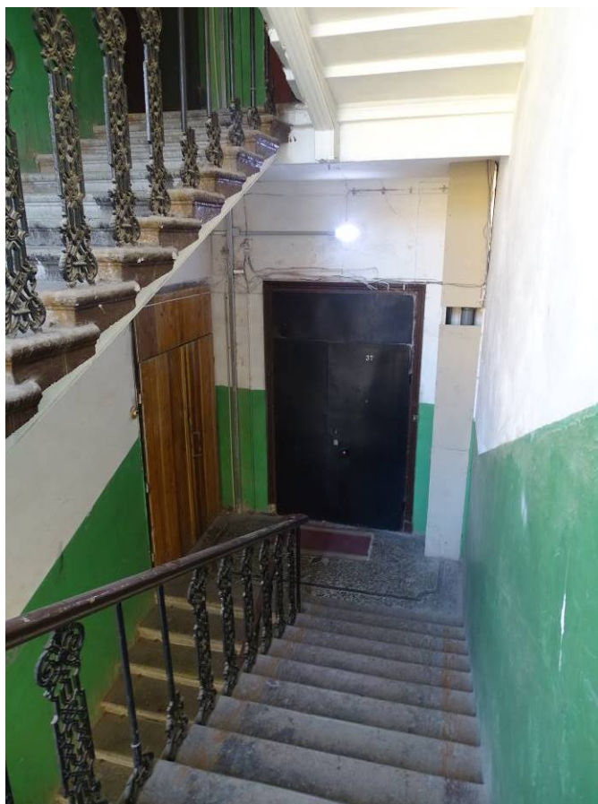
Фото 217. Лестница №2. 4 этаж. Съемка 26.04.2021 г. Трушковский В.Э.
