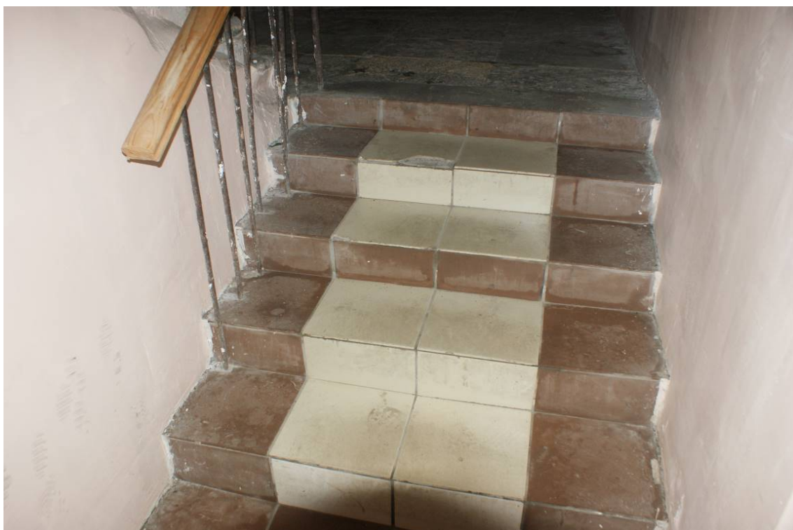
Фото 237. Лестница №3. Лестничный марш на 1-й этаж. Съемка 26.04.2021 г. Трушковский В.Э.
