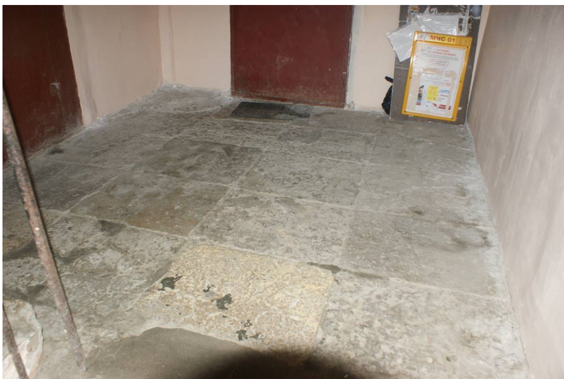
Фото 235. Лестница №3. 1 этаж. Известняковое покрытие пола. Съемка 26.04.2021 г. Трушковский В.Э.
