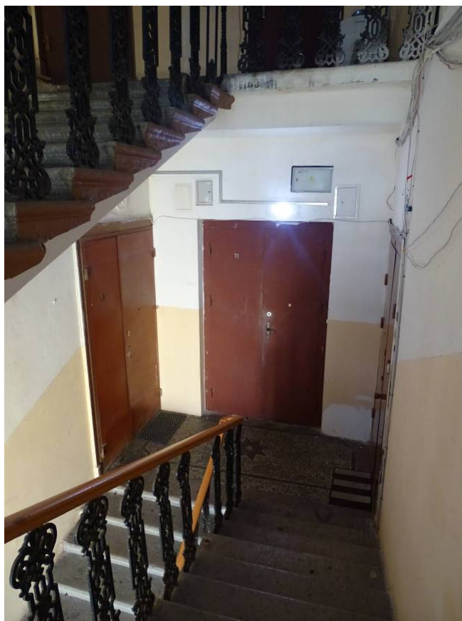
Фото 293. Лестница №4. 5 этаж. Съёмка 26.04.2021 г. Трушковский В.Э.
