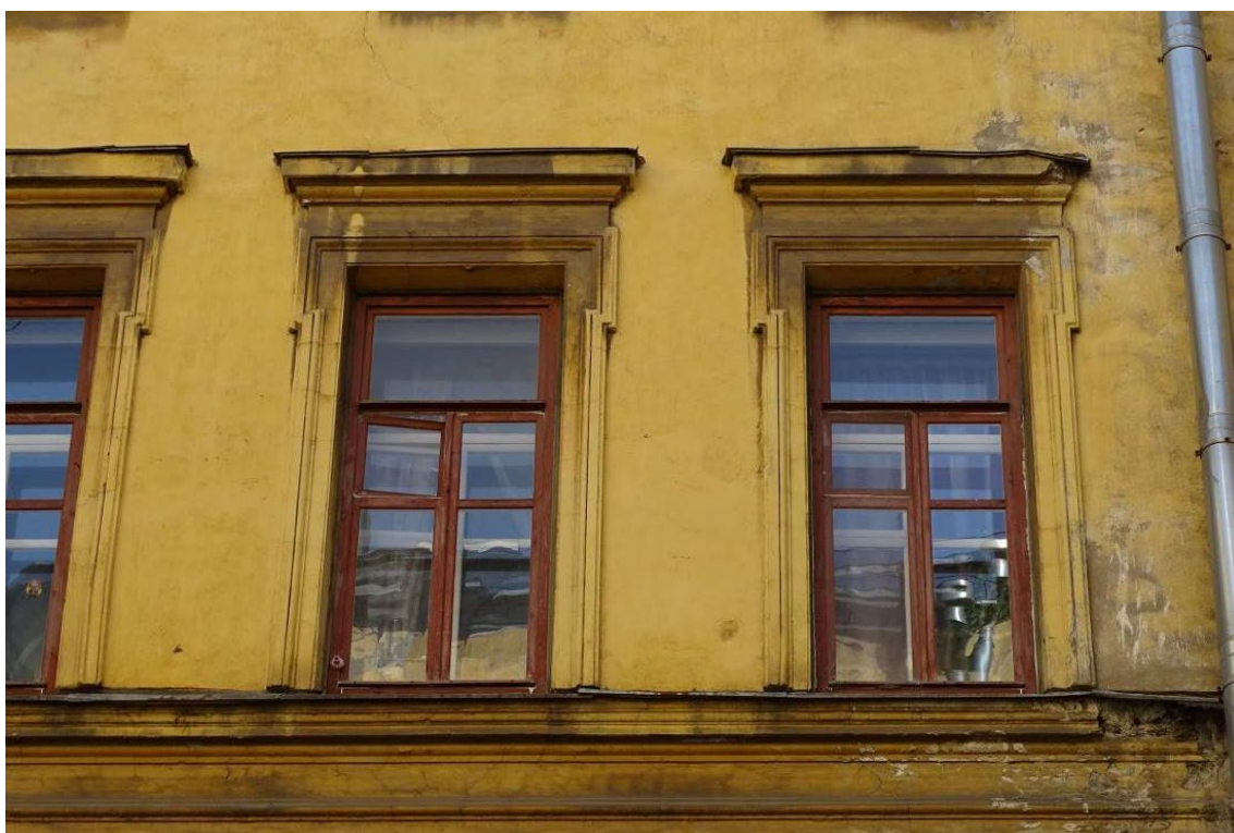
Фото 80. Здание по адресу: г. Санкт-Петербург, Коломенская ул., 14, литера Б. Фрагмент восточного фасада внутреннего двора. Окна 3-го этажа. Съемка 26.04.2021 г. Трушковский В.Э.
