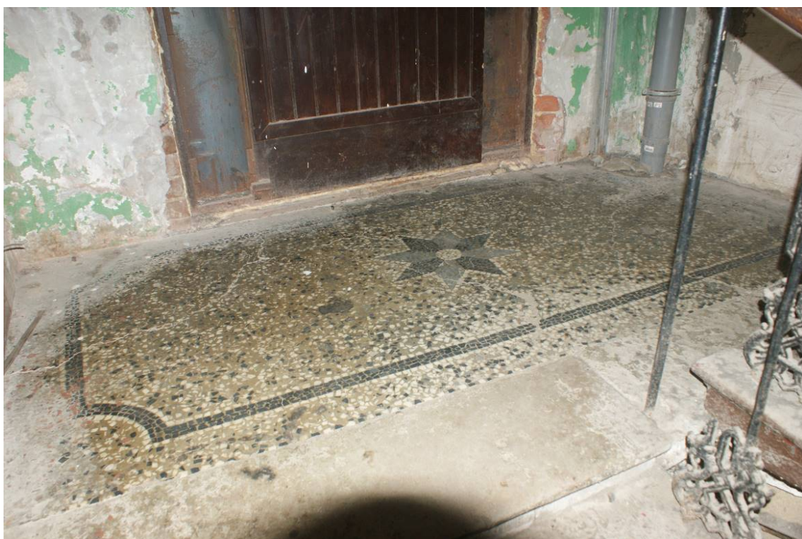
Фото 201. Лестница №2. 1 этаж. Покрытие террасо. Съемка 26.04.2021 г. Трушковский В.Э.
