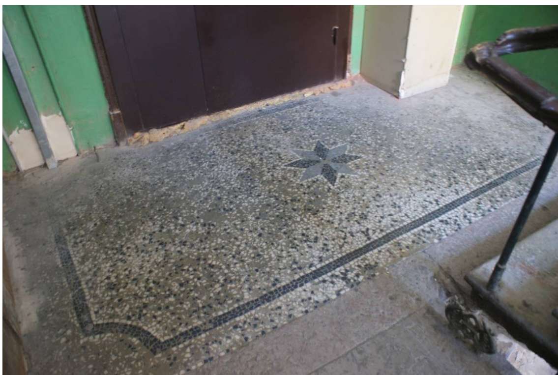
Фото 209. Лестница №2. 2 этаж. Покрытие терраццо. Съёмка 26.04.2021 г. Трушковский В.Э.
