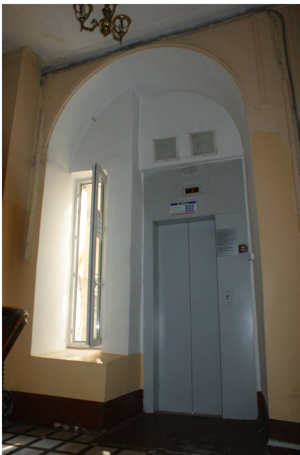
Фото 160. Лестница №1. Площадка между 1-м и 2-м этажом. Съемка 26.04.2021 г. Трушковский В.Э.
