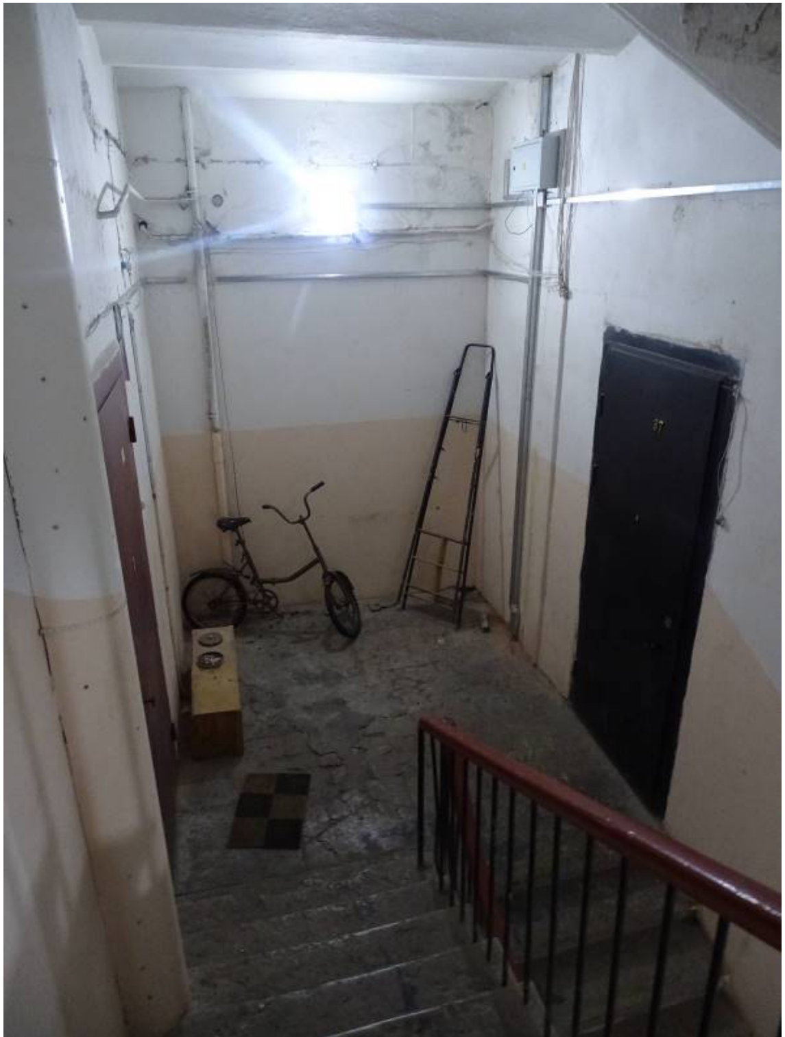
Фото 251. Лестница №3. 4 этаж. Съёмка 26.04.2021 г. Трушковский В.Э.
