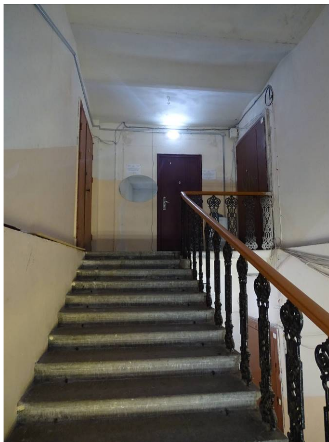
Фото 299. Лестница №4. 6 этаж. Съемка 26.04.2021 г. Трушковский В.Э.
