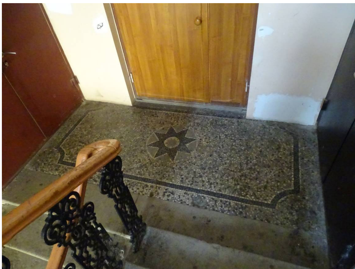
Фото №286. Лестница №4. 3 этаж. Покрытие террасо. Съемка 26.04.2021 г. Трушковский В.Э.
