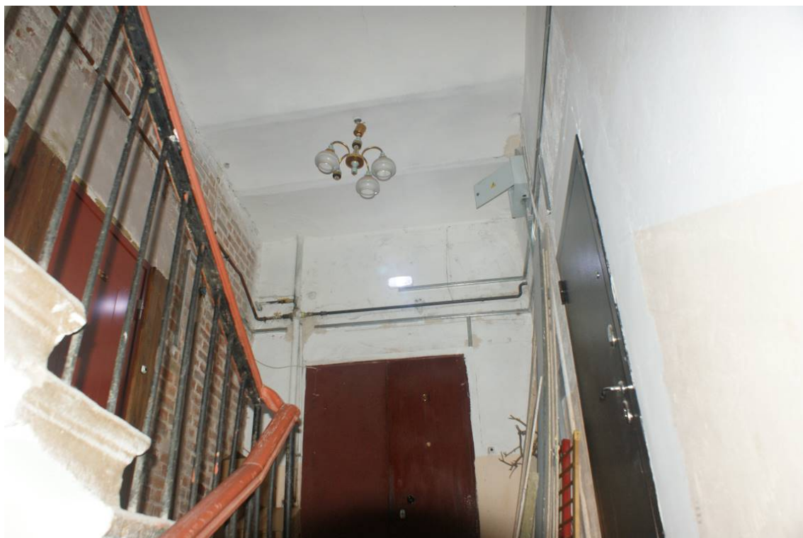
Фото 247. Лестница №3. 3 этаж. Съемка 26.04.2021 г. Трушковский В.Э.
