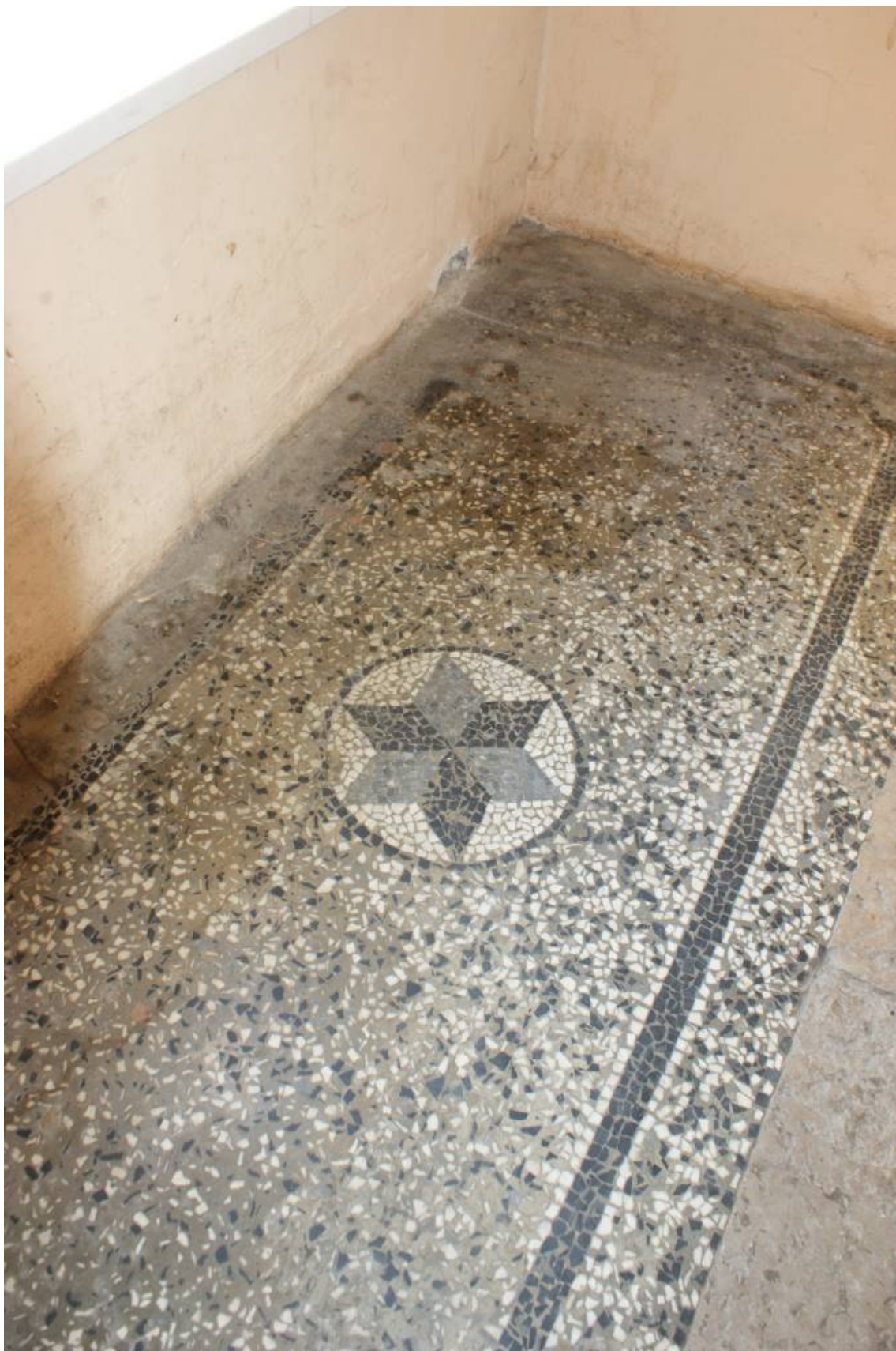
Фото 278. Лестница №4. Площадка между 1-м и 2-м этажом. Покрытие террацо. Съемка 26.04.2021 г. Трушковский В.Э.
