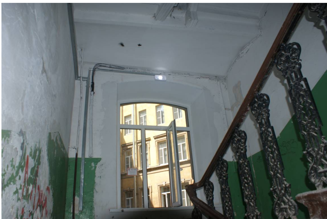
Фото 203. Лестница №2. Площадка между 1-м и 2-м этажом. Съёмка 26.04.2021 г. Трушковский В.Э.
