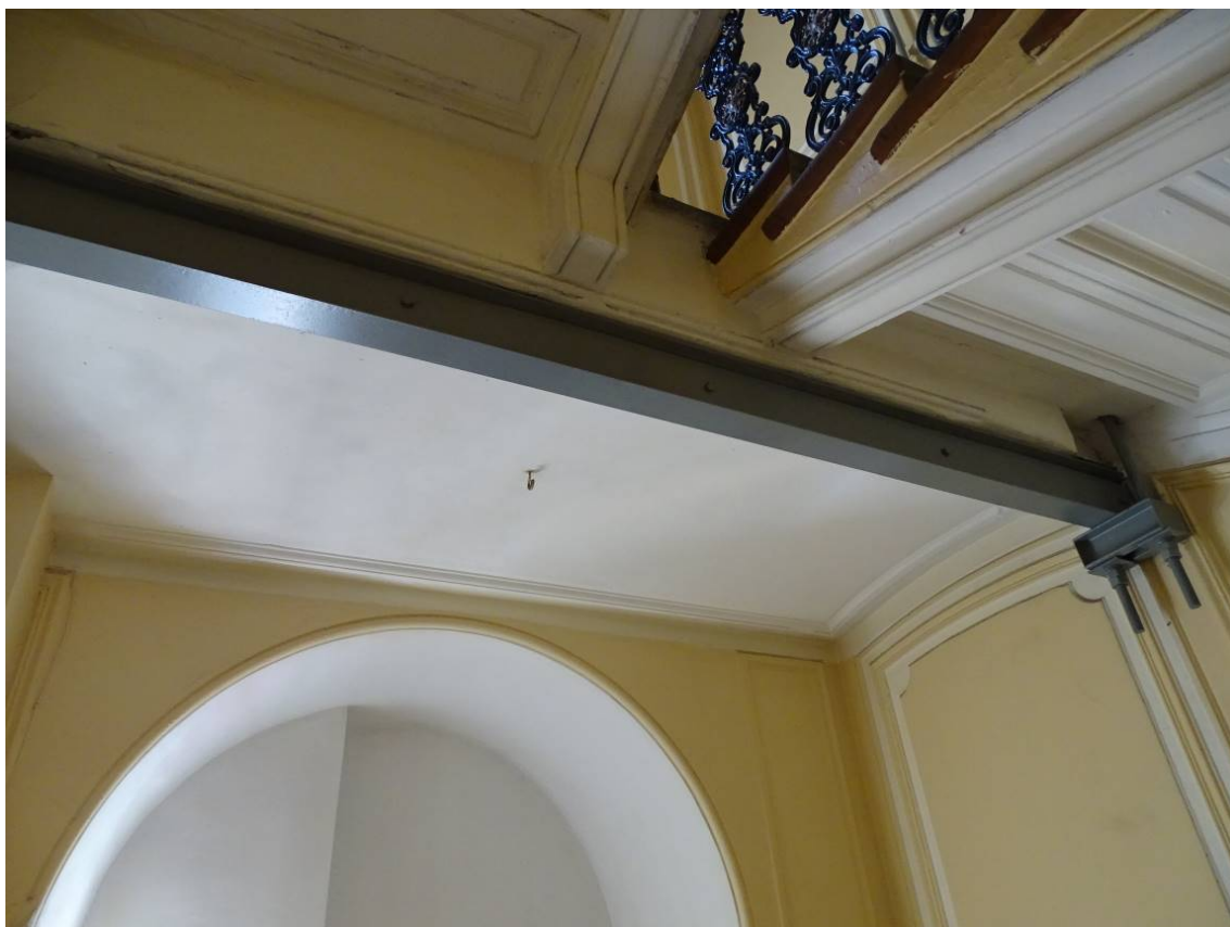
Фото 172. Лестница №1. Площадка между 3-м и 4-м этажом. Перекрытие из цилиндрического сводика. Съемка 26.04.2021 г. Трушковский В.Э.
