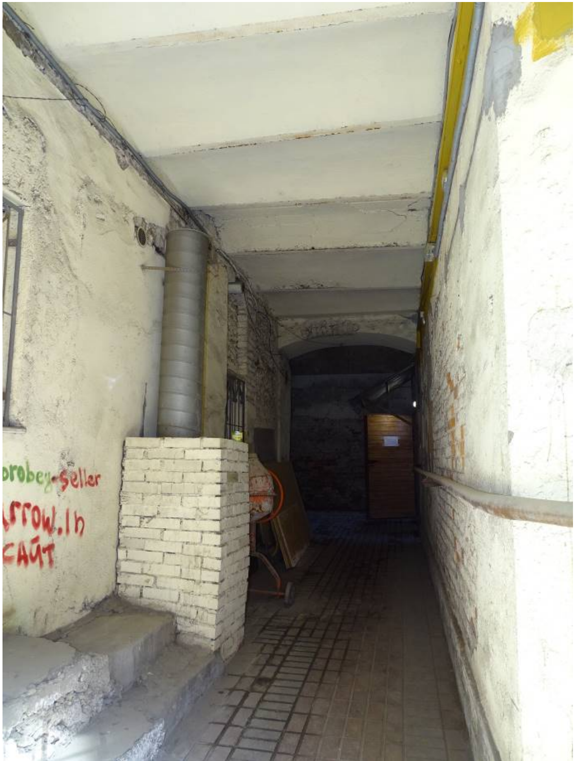
Фото 104. Здание по адресу: г. Санкт-Петербург, Коломенская ул., 14, литера Б. Сквозной проход с северной стороны. Перекрытие прохода из цилиндрических сводиков. Съемка 26.04.2021 г. Трушковский В.Э.
