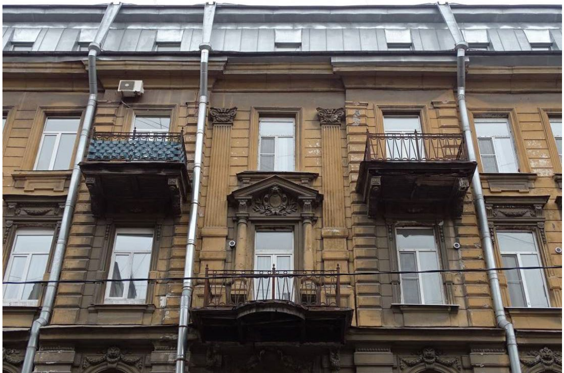
Фото 68. Здание по адресу: г. Санкт-Петербург, Коломенская ул., 14, литера Б. Фрагмент лицевого фасада. 3-й, 4-й и мансардный этажи. Съемка 26.04.2021 г. Трушковский В.Э.
