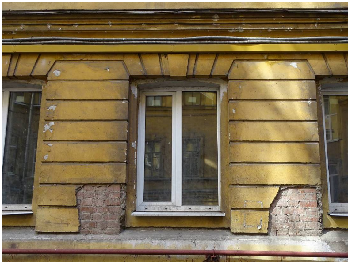
Фото 89. Здание по адресу: г. Санкт-Петербург, Коломенская ул., 14, литера Б. Фрагмент северного фасада внутреннего двора. 1-й этаж. Съемка 26.04.2021 г. Трушковский В.Э.
