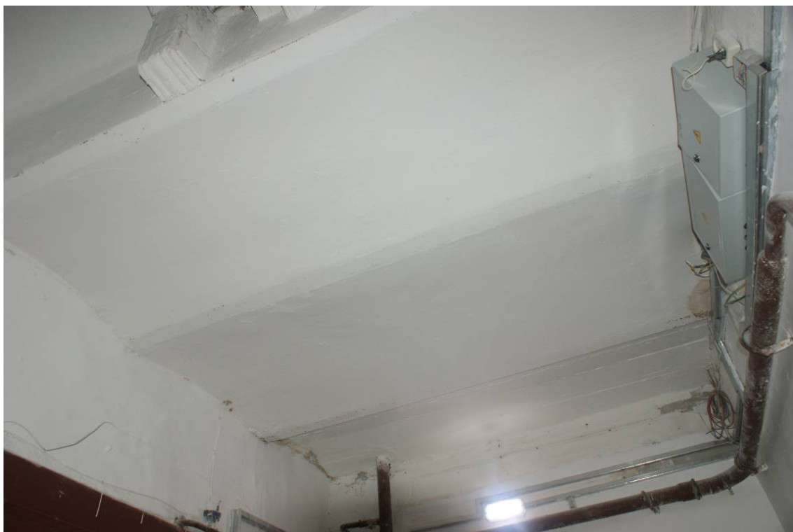
Фото 236. Лестница №3. 1 этаж. Перекрытие из цилиндрических сводиков. Съемка 26.04.2021 г. Трушковский В.Э.
