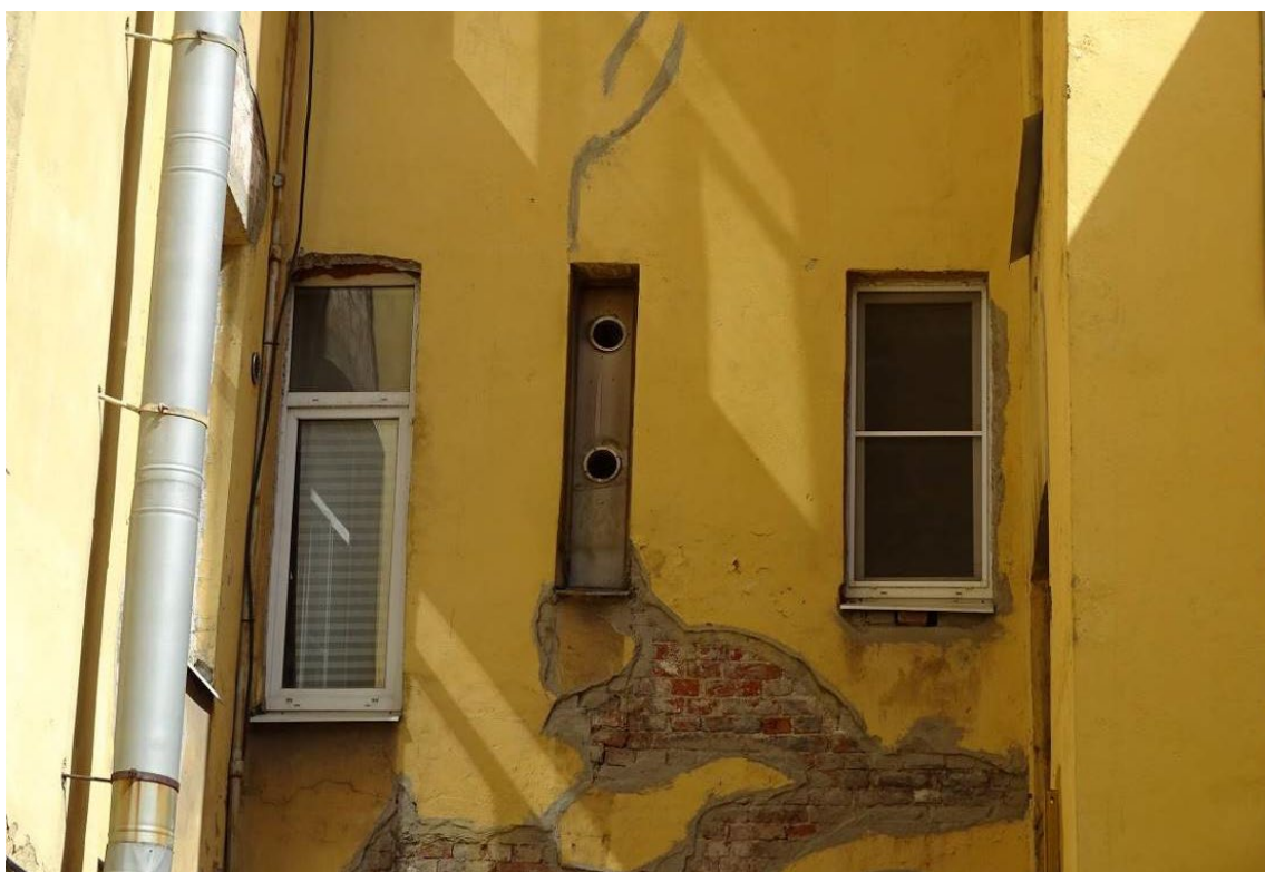
Фото 122. Здание по адресу: г. Санкт-Петербург, Коломенская ул., 14, литера Б. Фрагмент южного фасада. 4-й этаж. Съемка 26.04.2021 г. Трушковский В.Э.
