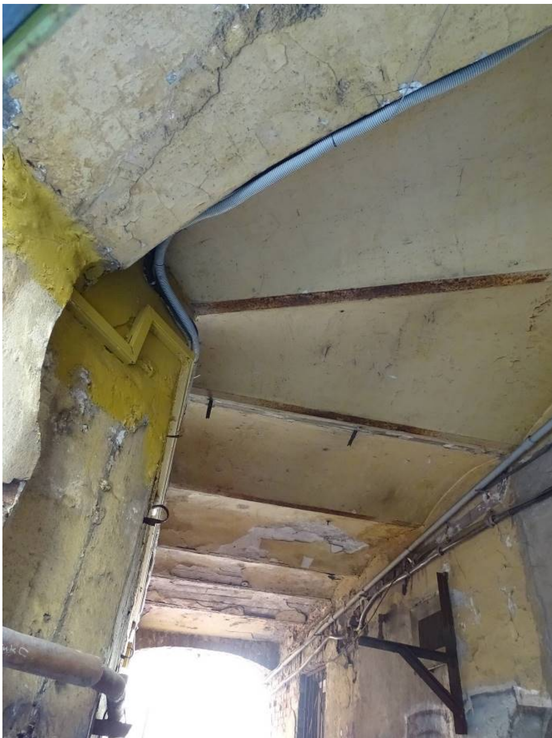
Фото 98. Здание по адресу: г. Санкт-Петербург, Коломенская ул., 14, литера Б. Перекрытие прохода из цилиндрических сводиков. Съемка 26.04.2021 г. Трушковский В.Э.
