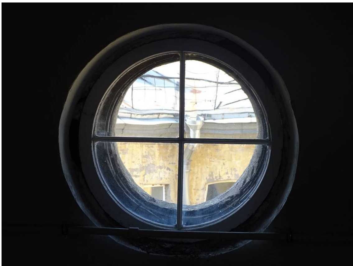
Фото 230. Лестница №2. Окно 6-го этажа лестничной клетки. Съемка 26.04.2021 г. Трушковский В.Э.
