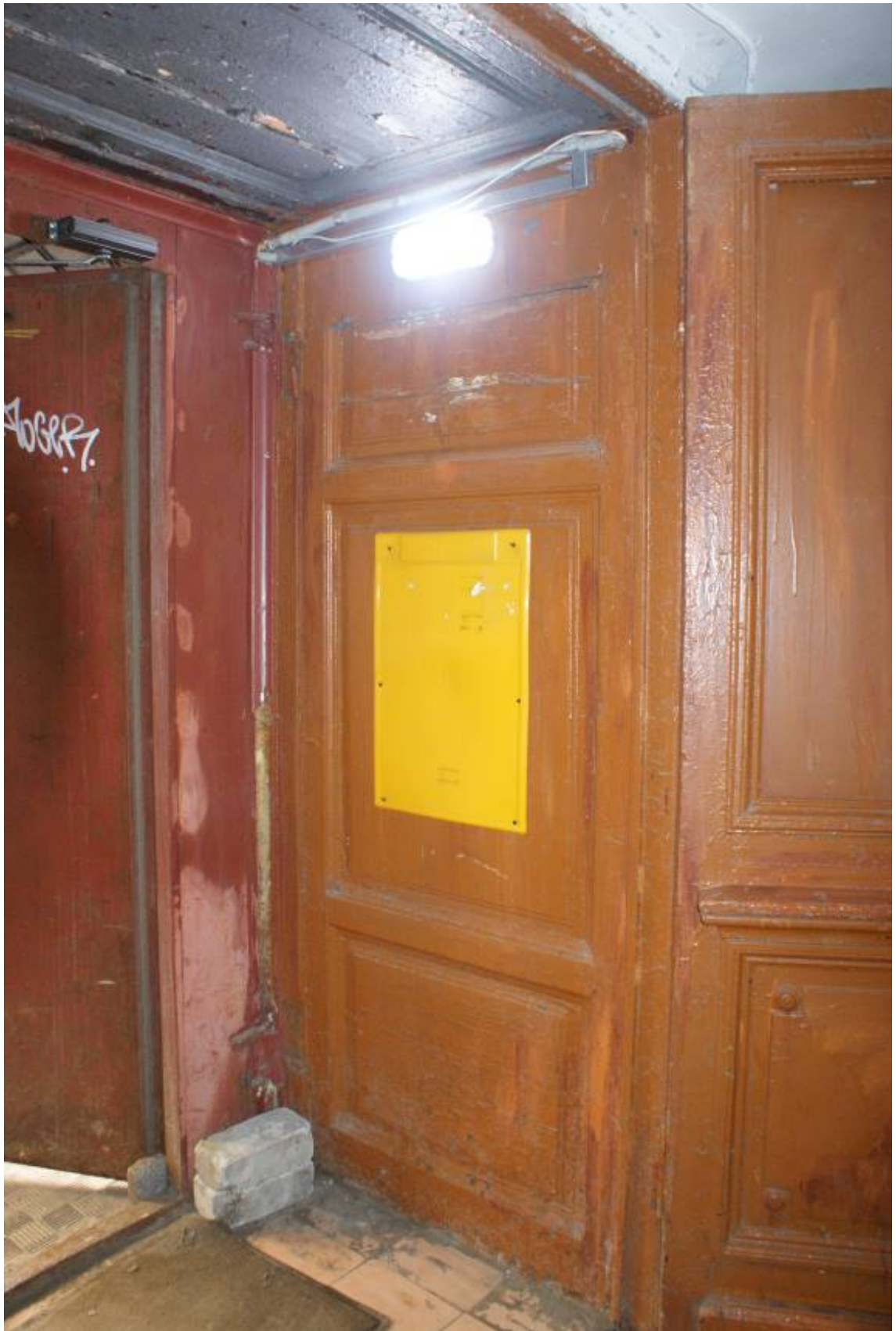
Фото 269. Лестница №4. 1 этаж. Фрагмент входа на лестницу №4. Съемка 26.04.2021 г. Трушковский В.Э.
