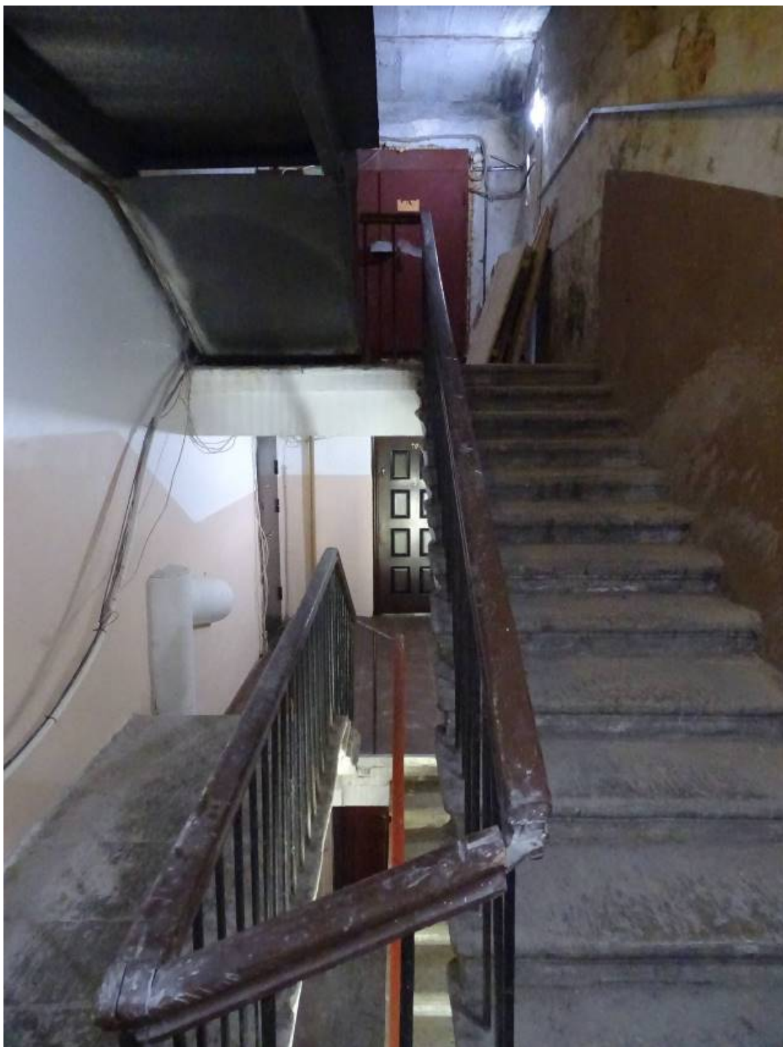
Фото 262. Лестница №3. 7 этаж. Съемка 26.04.2021 г. Трушковский В.Э.
