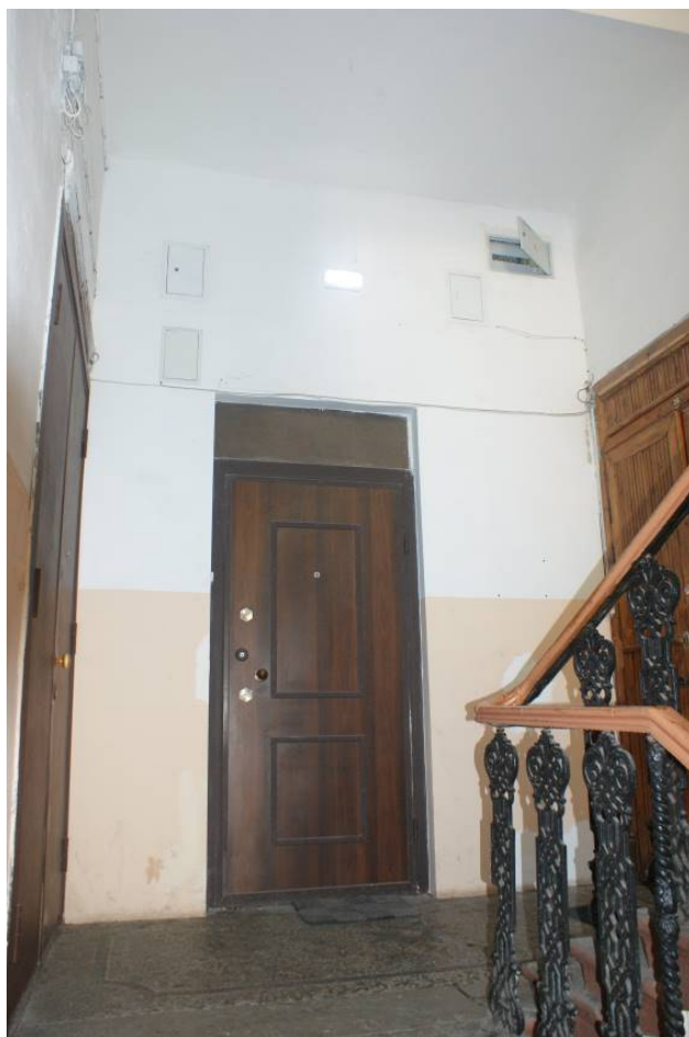
Фото 280. Лестница №4. 2 этаж. Съемка 26.04.2021 г. Трушковский В.Э.
