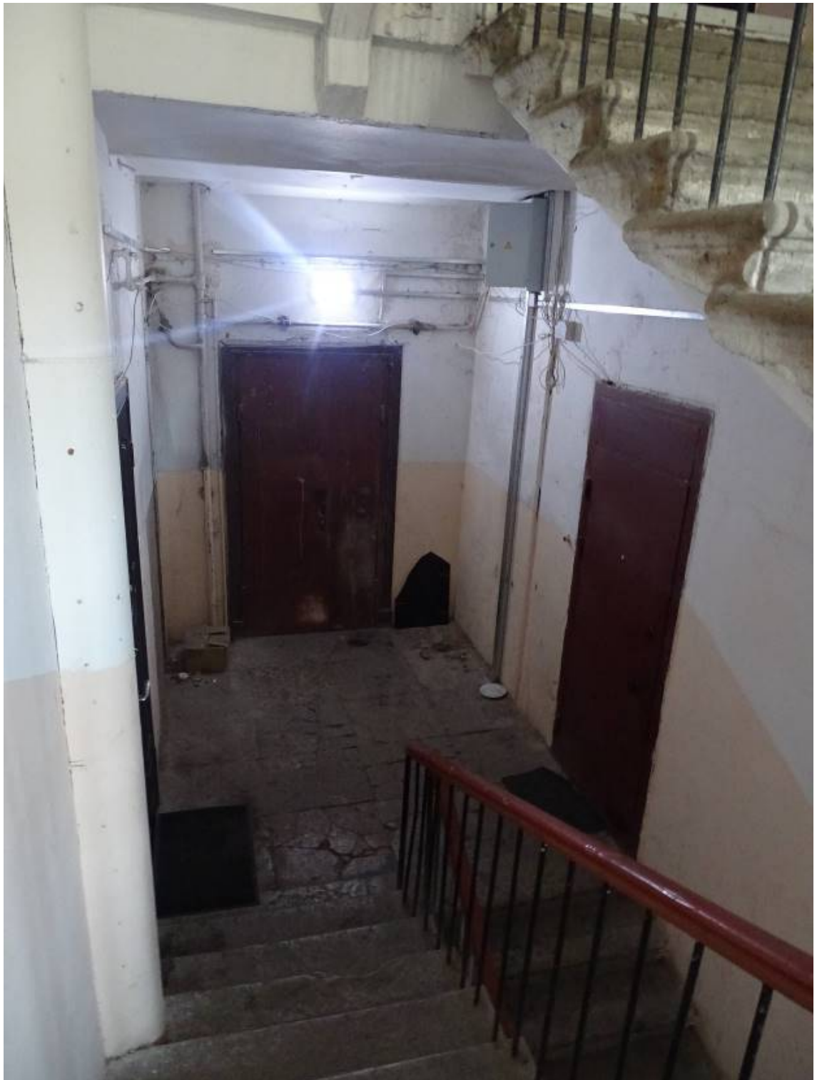
Фото 254. Лестница №3. 5 этаж. Съемка 26.04.2021 г. Трушковский В.Э.
