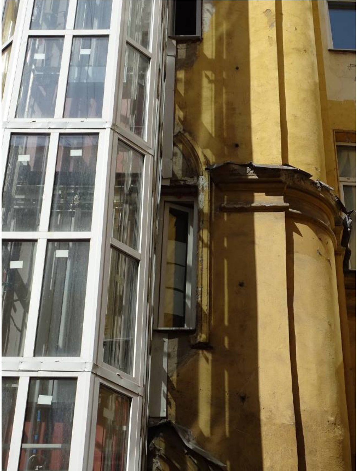
Фото 101. Здание по адресу: г. Санкт-Петербург, Коломенская ул., 14, литера Б. Фрагмент западного фасада внутреннего двора. Съемка 26.04.2021 г. Трушковский В.Э.
