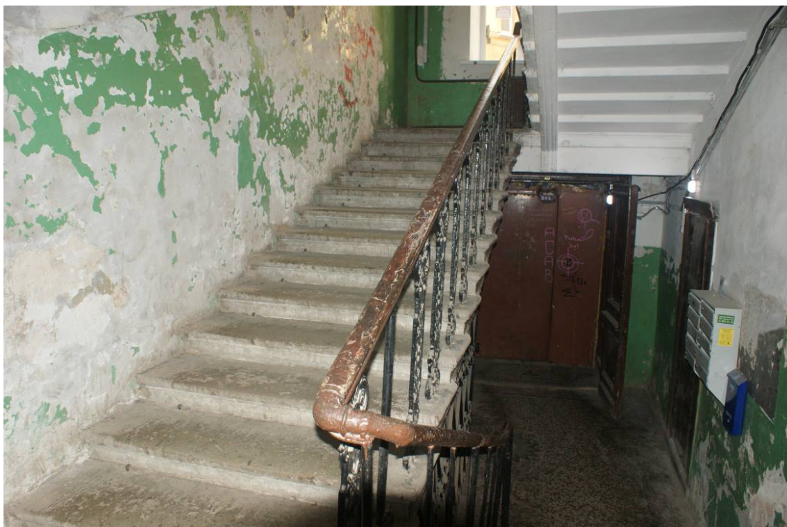
Фото 202. Лестница №2. 1 этаж. Съёмка 26.04.2021 г. Трушковский В.Э.
