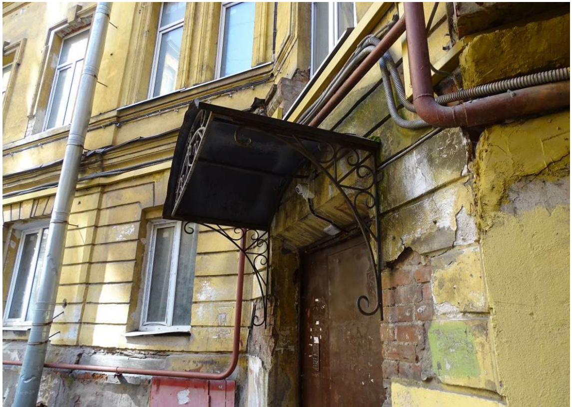
Фото 85. Здание по адресу: г. Санкт-Петербург, Коломенская ул., 14, литера Б. Фрагмент восточного фасада внутреннего двора. Козырек над дверным проемом лестничной клетки №2. Съемка 26.04.2021 г. Трушковский В.Э.
