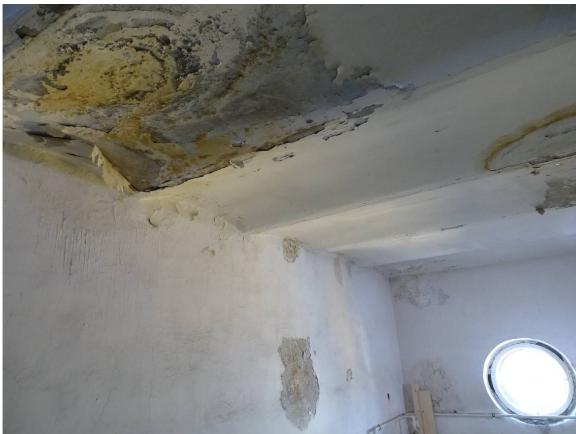
Фото 229. Лестница №2. Перекрытие из цилиндрических сводиков. Съемка 26.04.2021 г. Трушковский В.Э.
