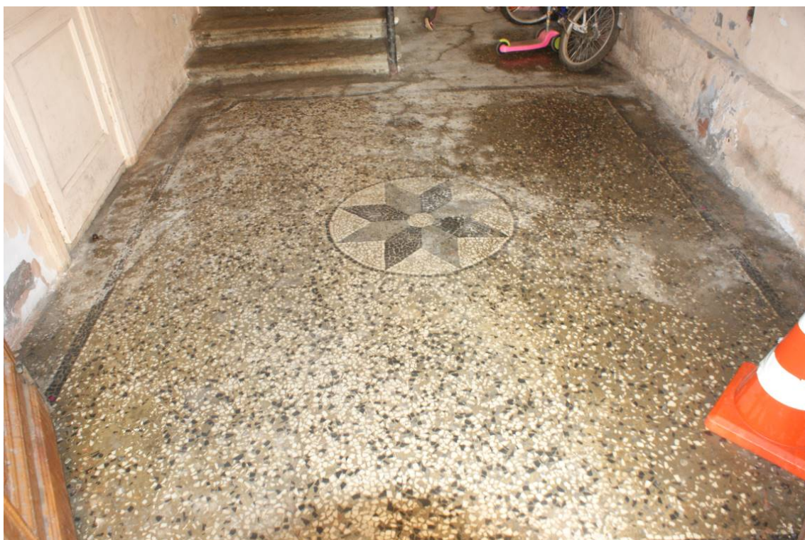
Фото 266. Лестница №4. 1 этаж. Покрытие террасо. Съемка 26.04.2021 г. Трушковский В.Э.
