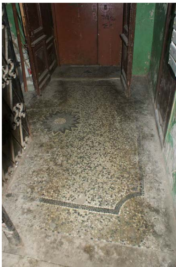
Фото 193. Лестница №2. 1 этаж. Покрытие терраццо. Съемка 26.04.2021 г. Трушковский В.Э.
