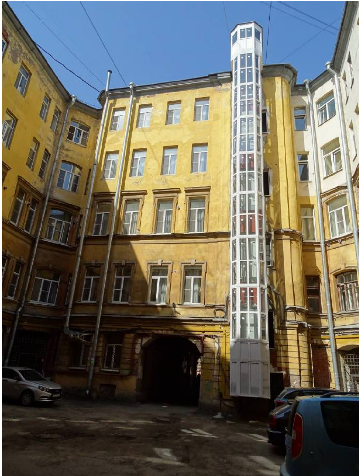
Фото 100. Здание по адресу: г. Санкт-Петербург, Коломенская ул., 14, литера Б. Западный фасад внутреннего двора. Съемка 26.04.2021 г. Трушковский В.Э.
