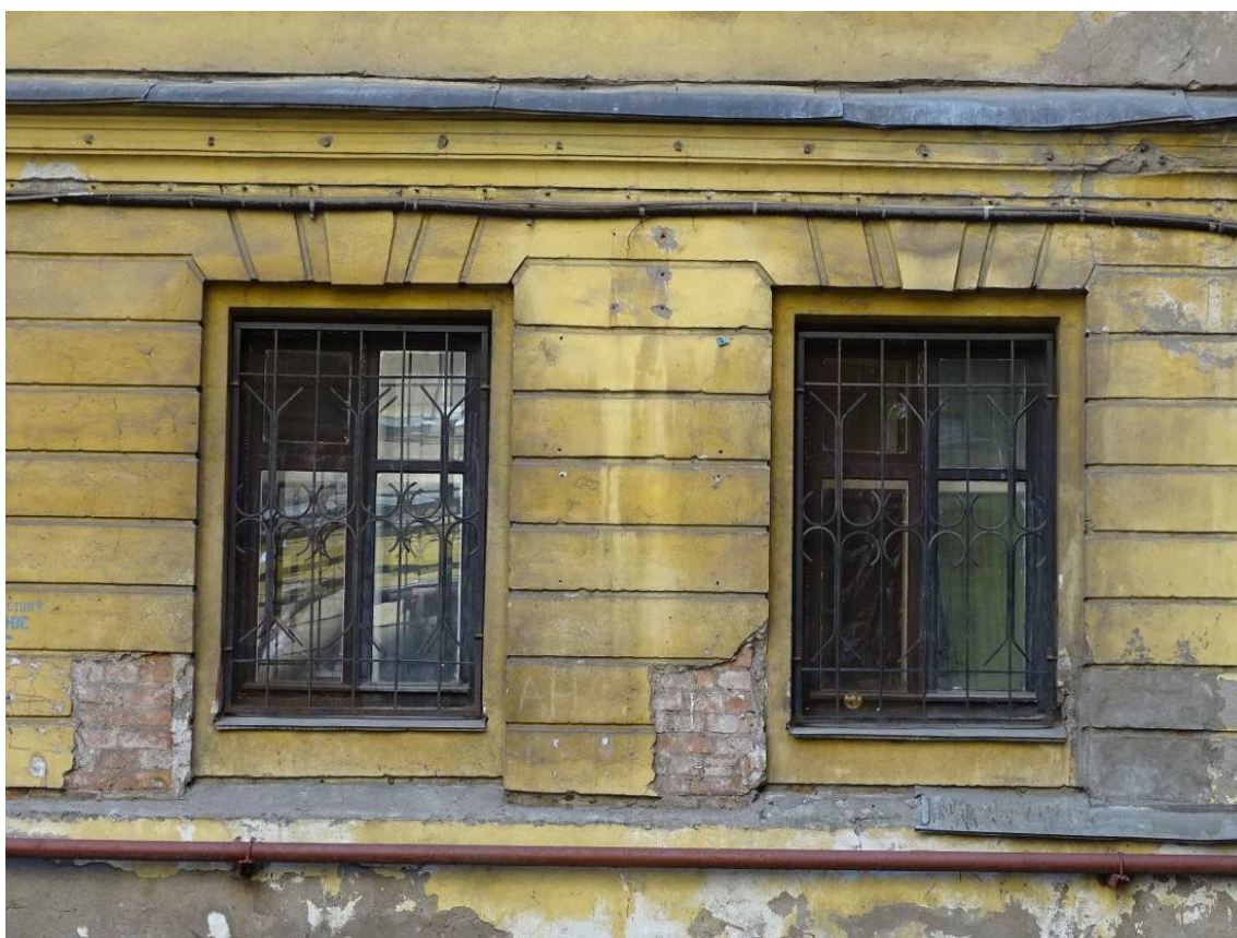
Фото 82. Здание по адресу: г. Санкт-Петербург, Коломенская ул., 14, литера Б. Фрагмент восточного фасада внутреннего двора. Окна 1-го этажа. Съемка 26.04.2021 г. Трушковский В.Э.
