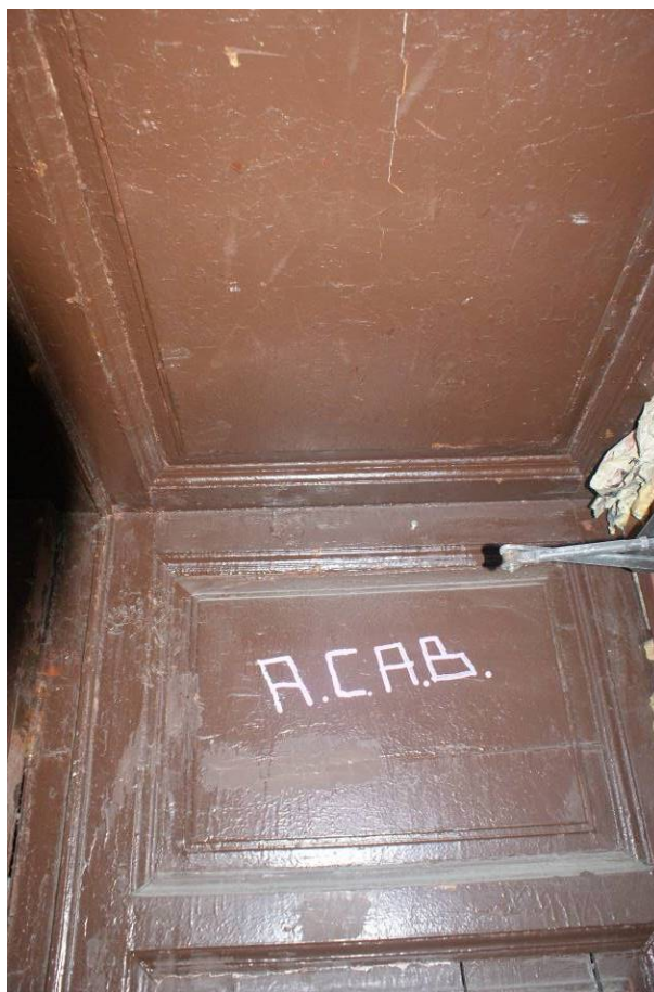
Фото 196. Лестница №2. 1 этаж. Фрагмент входа в лестничную клетку. Съемка 26.04.2021 г. Трушковский В.Э.
