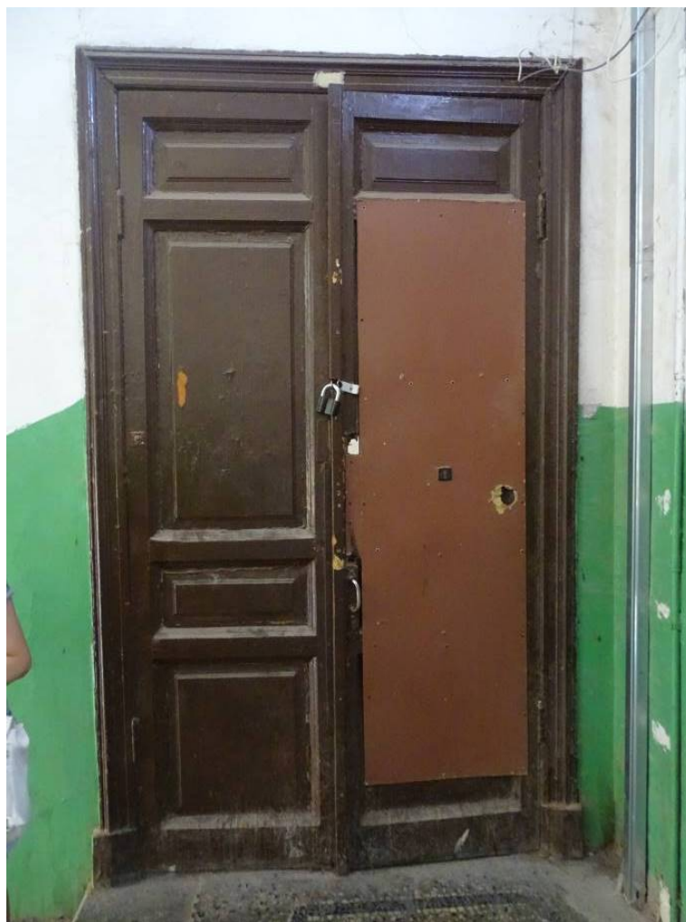
Фото 213. Лестница №2. 3 этаж. Съёмка 26.04.2021 г. Трушковский В.Э.
