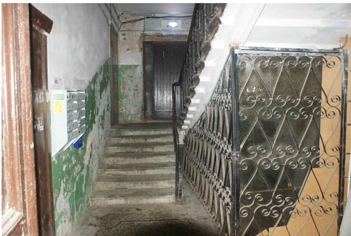
Фото 199. Лестница №2. Лестничный марш на 1-й этаж. Съемка 26.04.2021 г. Трушковский В.Э.
