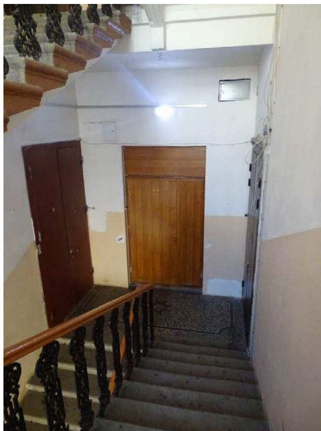
Фото 285. Лестница №4. 3 этаж. Съемка 26.04.2021 г. Трушковский В.Э.
