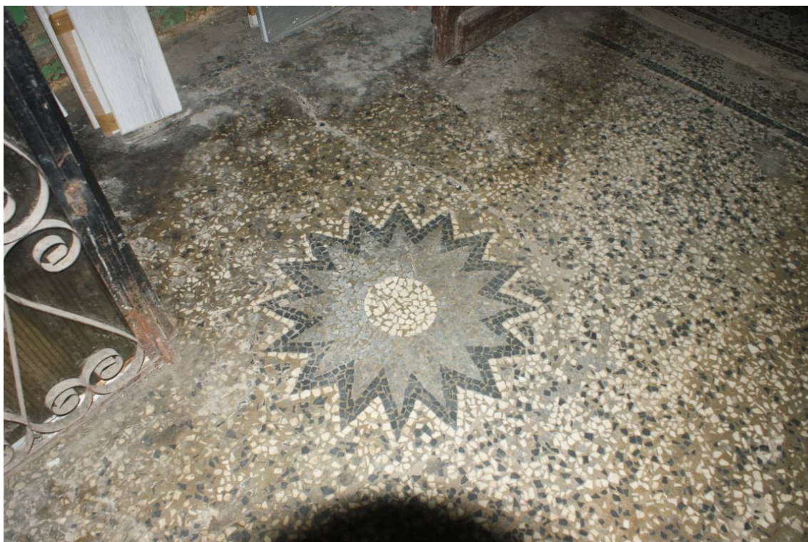
Фото 198. Лестница №2. 1 этаж. Покрытие террасо. Съемка 26.04.2021 г. Трушковский В.Э.
