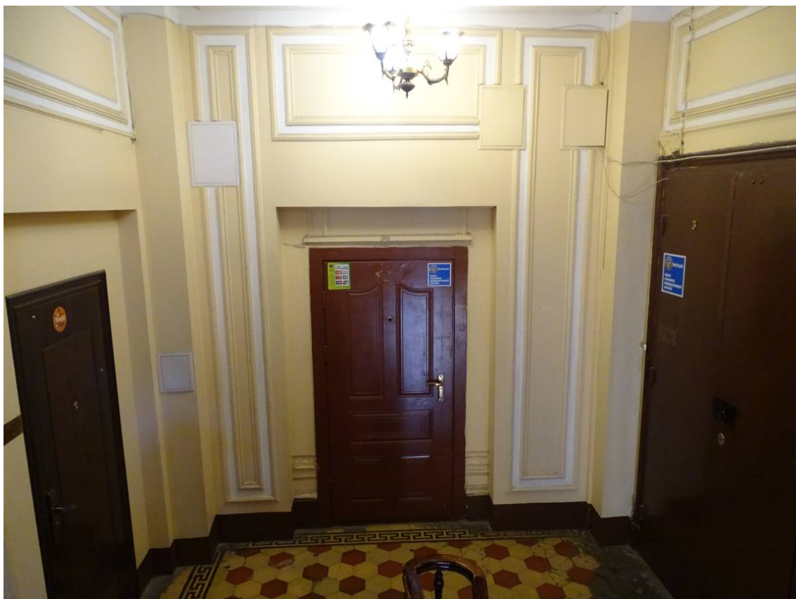
Фото 174. Лестница №1. 4 этаж. Съемка 26.04.2021 г. Трушковский В.Э.
