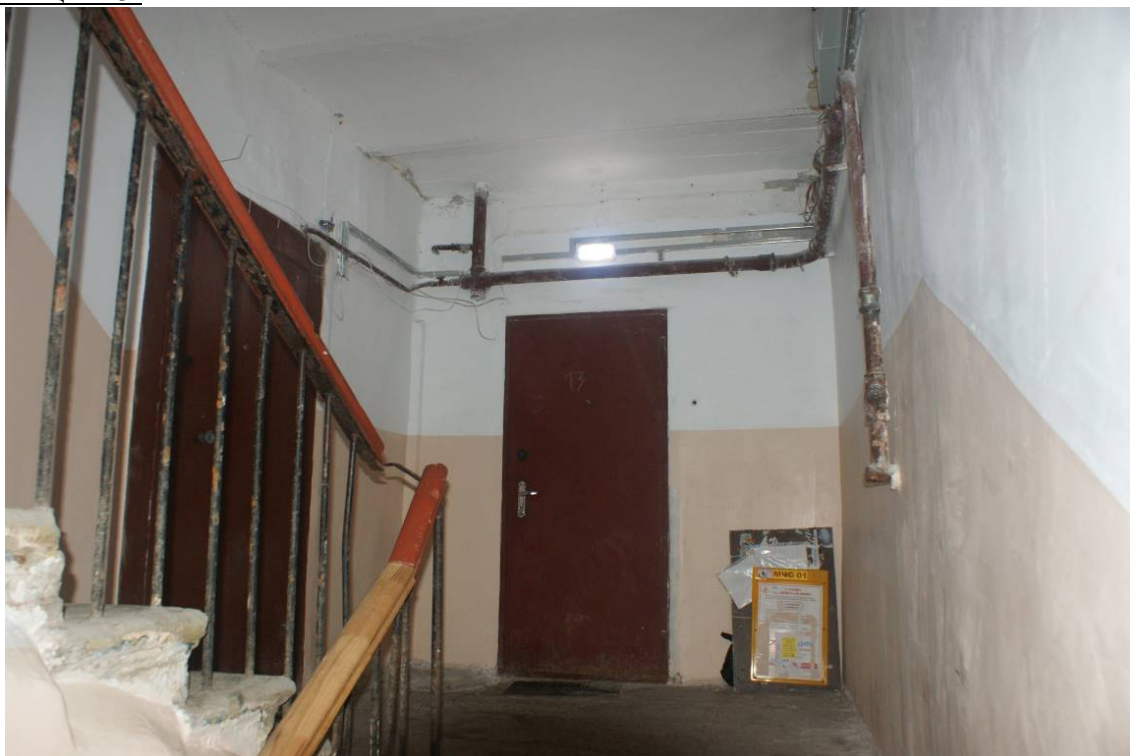
Фото 234. Лестница №3. 1 этаж. Съемка 26.04.2021 г. Трушковский В.Э.
