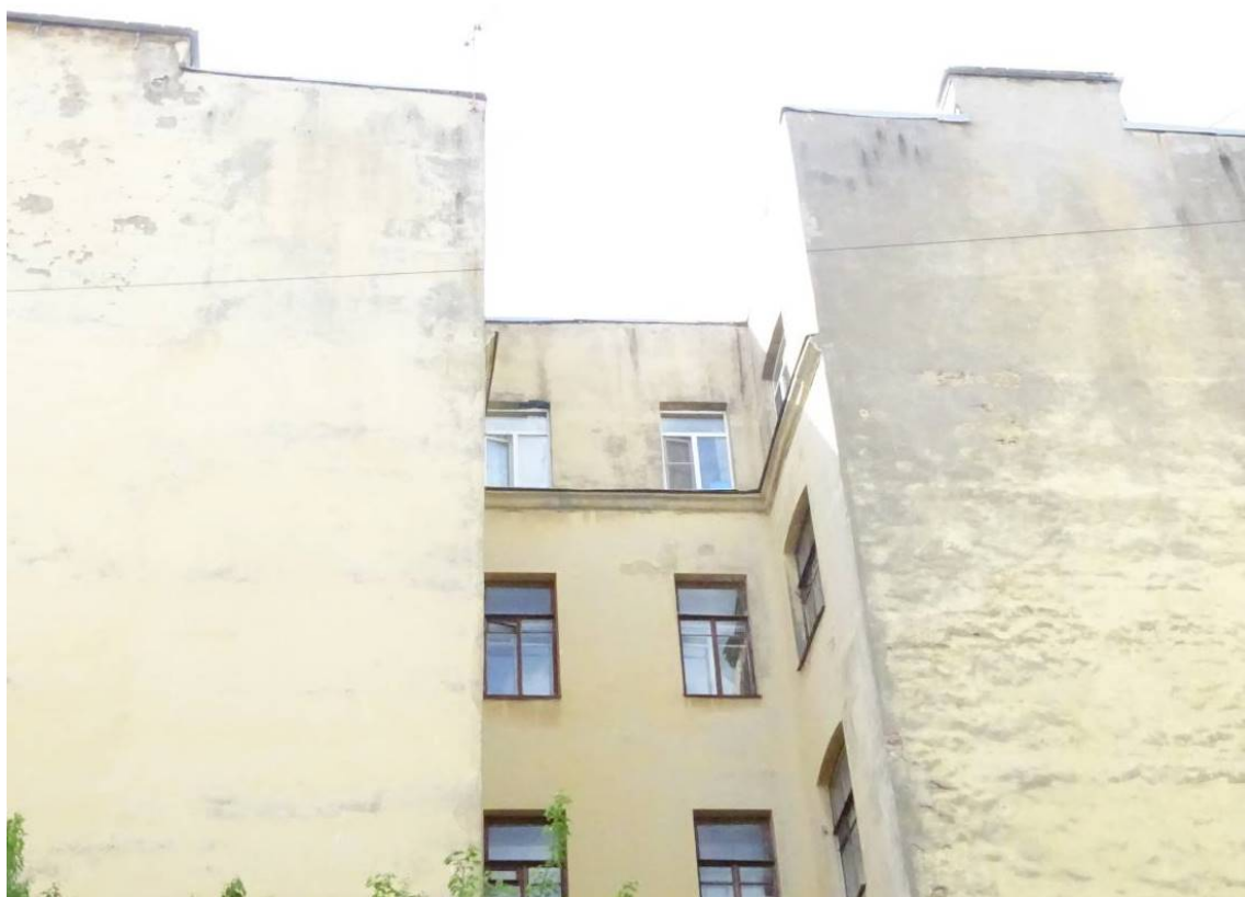
Фото 118. Здание по адресу: г. Санкт-Петербург, Коломенская ул., 14, литера Б. Фрагмент северного фасада. Съемка 26.04.2021 г. Трушковский В.Э.
