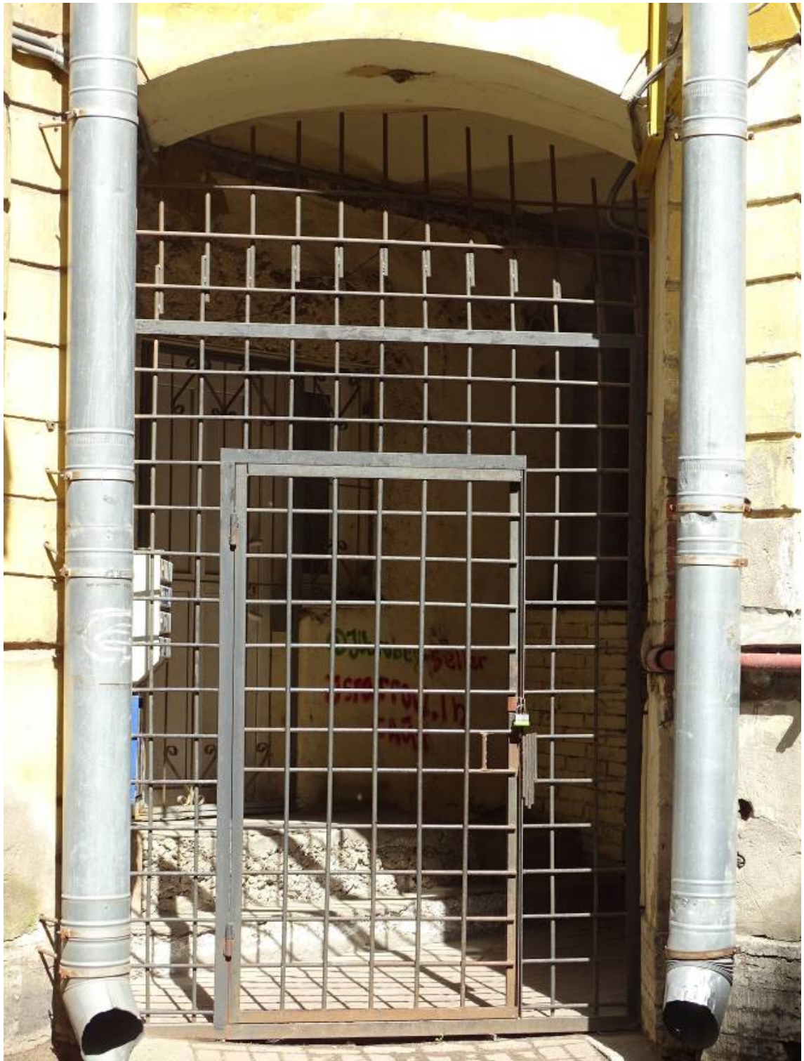
Фото 103. Здание по адресу: г. Санкт-Петербург, Коломенская ул., 14, литера Б. Фрагмент северного фасада внутреннего двора. Вид на сквозной проход с северной стороны. Съемка 26.04.2021 г. Трушковский В.Э.
