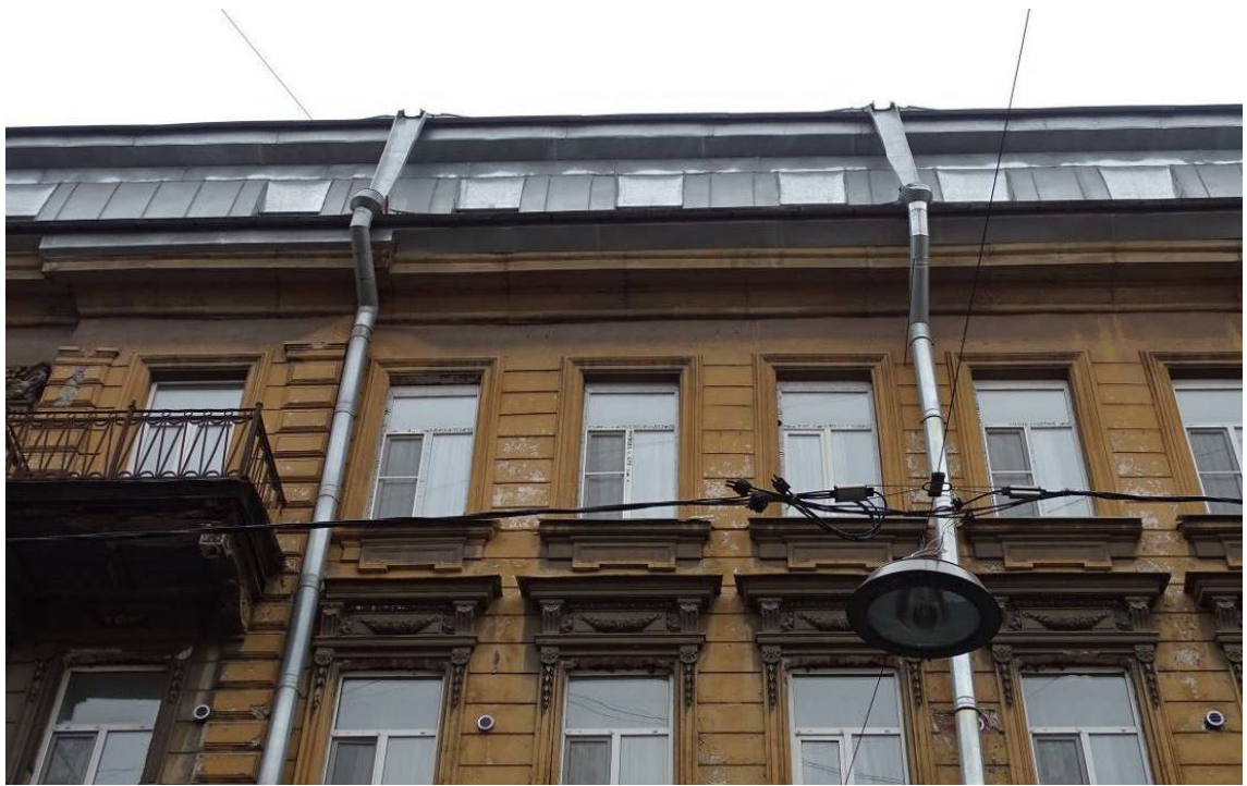
Фото 66. Здание по адресу: г. Санкт-Петербург, Коломенская ул., 14, литера Б. Фрагмент лицевого фасада. 4-й и мансардный этажи. Съемка 26.04.2021 г. Трушковский В.Э.
