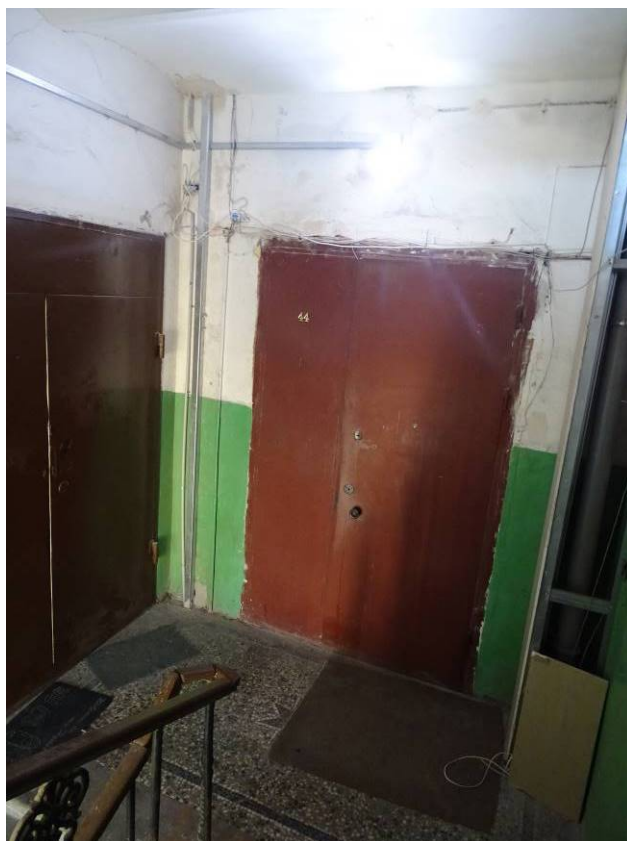
Фото 223. Лестница №2. 5 этаж. Съёмка 26.04.2021 г. Трушковский В.Э.
