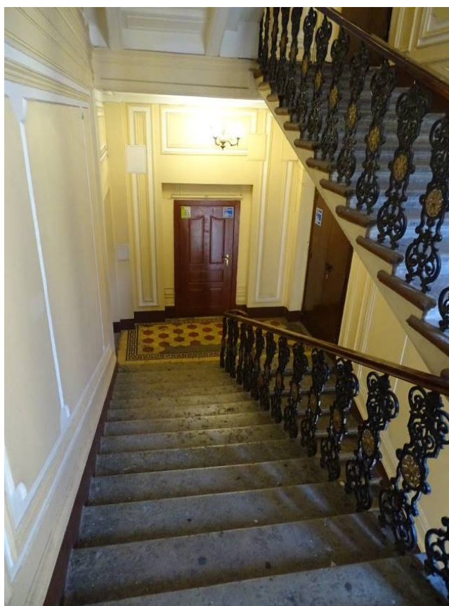
Фото 173. Лестница №1. 4 этаж. Съемка 26.04.2021 г. Трушковский В.Э.
