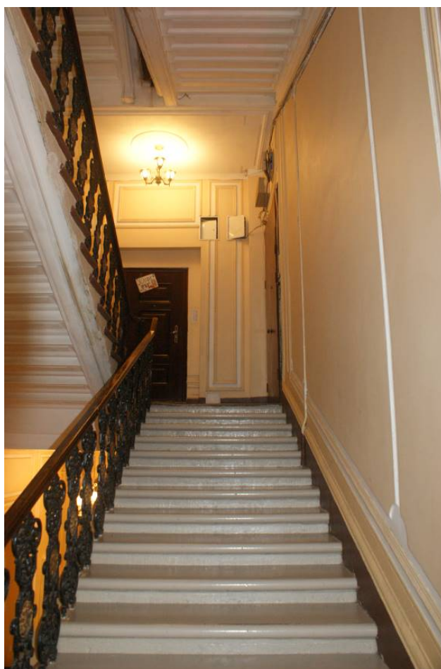
Фото 163. Лестница №1. 2 этаж. Съемка 26.04.2021 г. Трушковский В.Э.
