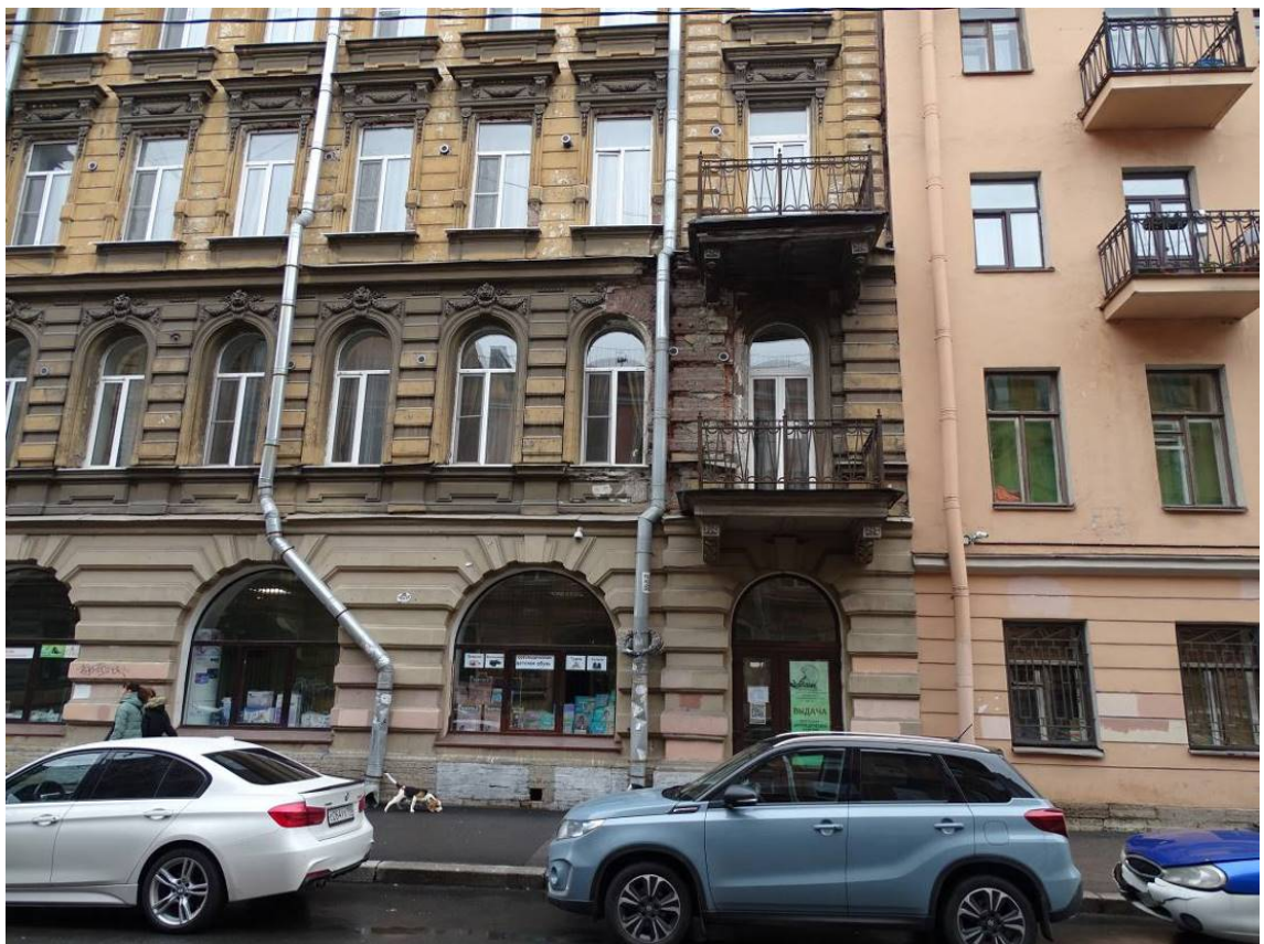
Фото 65. Здание по адресу: г. Санкт-Петербург, Коломенская ул., 14, литера Б. Фрагмент лицевого фасада. 1-й, 2-й, 3-й этажи. Съемка 26.04.2021 г. Трушковский В.Э.
