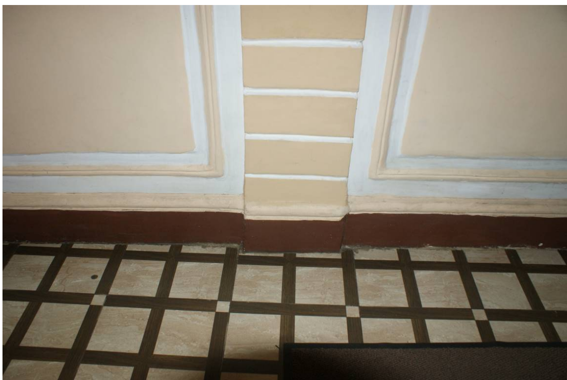
Фото 154. Лестница №1. 1 этаж. Фрагмент лепного декора стены. Съемка 26.04.2021 г. Трушковский В.Э.
