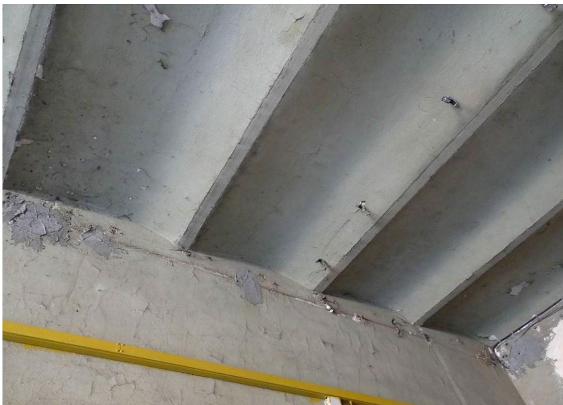
Фото 75. Здание по адресу: г. Санкт-Петербург, Коломенская ул., 14, литера Б. Перекрытие проезда из цилиндрических сводиков. Съемка 26.04.2021 г. Трушковский В.Э.
