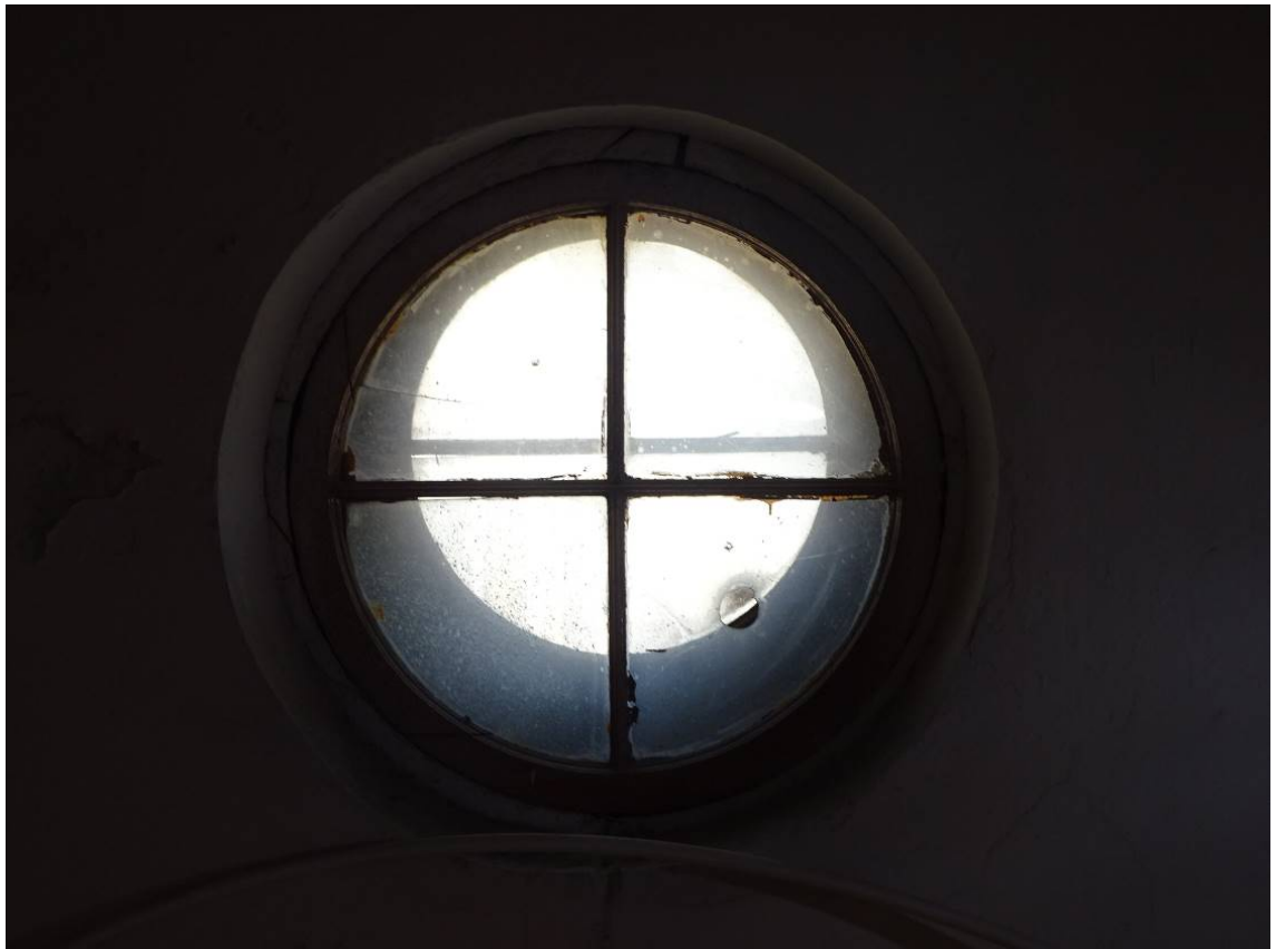
Фото 297. Лестница №4. Окно лестничной клетки между 5-м и 6-м этажом. Съемка 26.04.2021 г. Трушковский В.Э.
