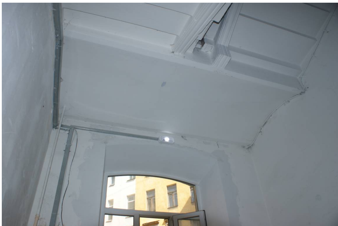
Фото 277. Лестница №4. Площадка между 1-м и 2-м этажом. Перекрытие в виде цилиндрического сводика. Съемка 26.04.2021 г. Трушковский В.Э.
