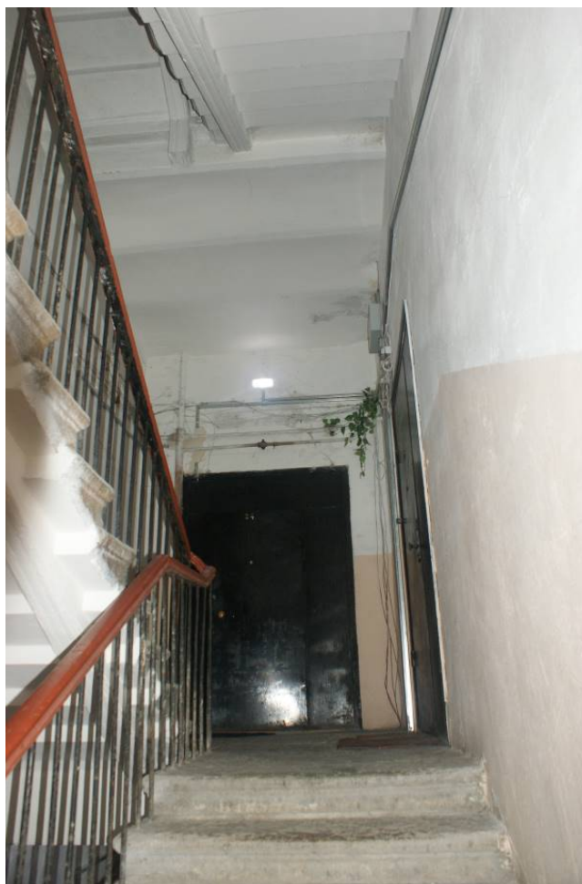
Фото 242. Лестница №3. 2 этаж. Съемка 26.04.2021 г. Трушковский В.Э.
