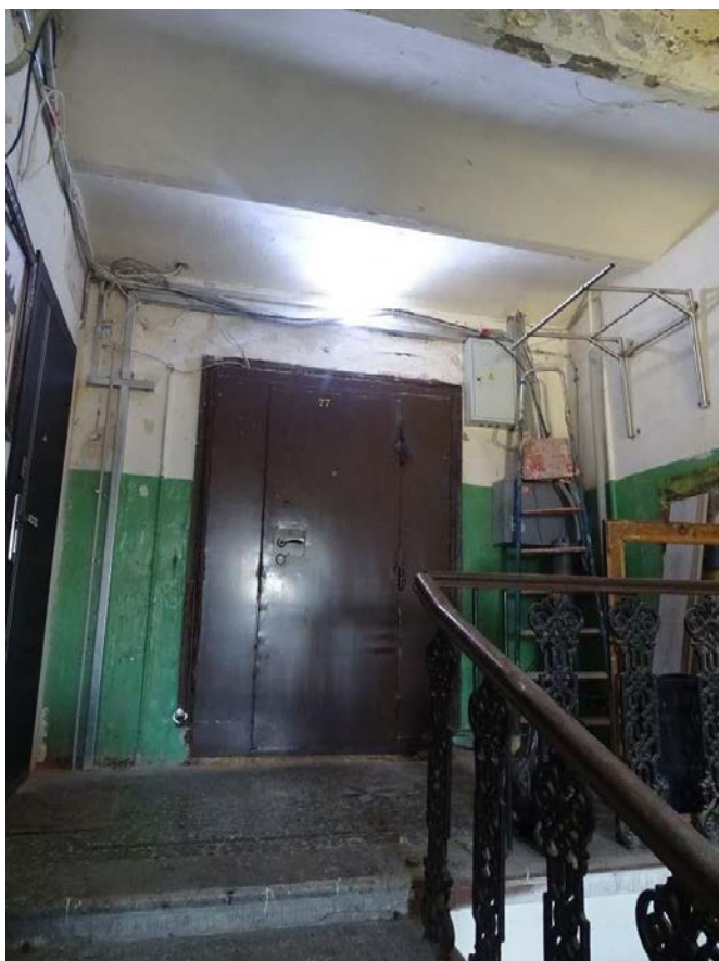
Фото 231. Лестница №2. 6 этаж. Съемка 26.04.2021 г. Трушковский В.Э.
