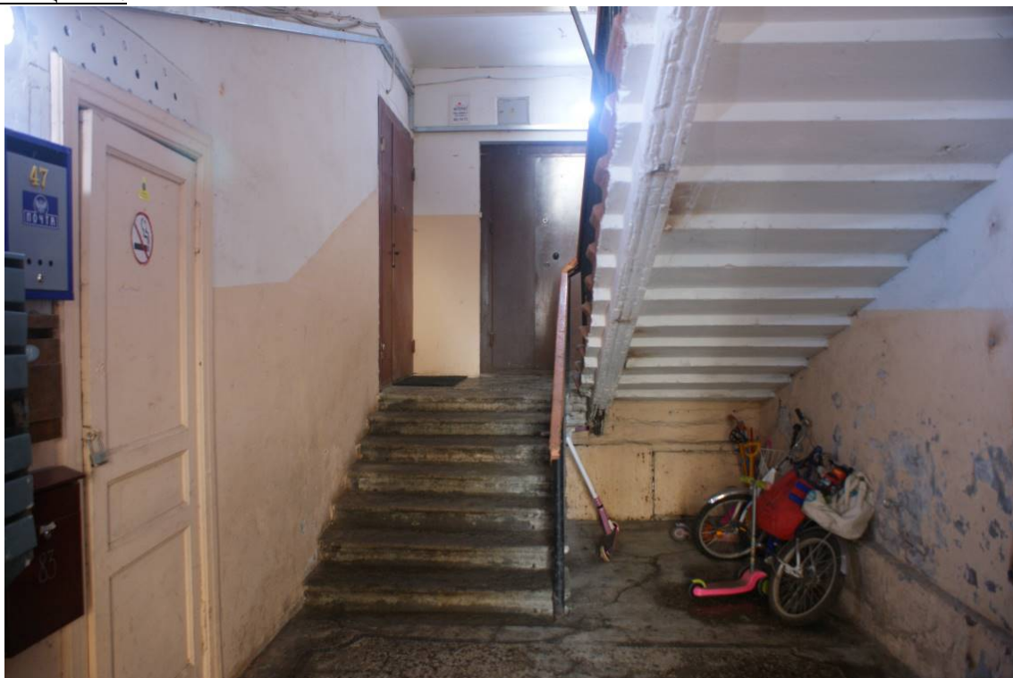
Фото 265. Лестница №4. 1 этаж. Лестничный марш на 1-й этаж. Съемка 26.04.2021 г. Трушковский В.Э.
