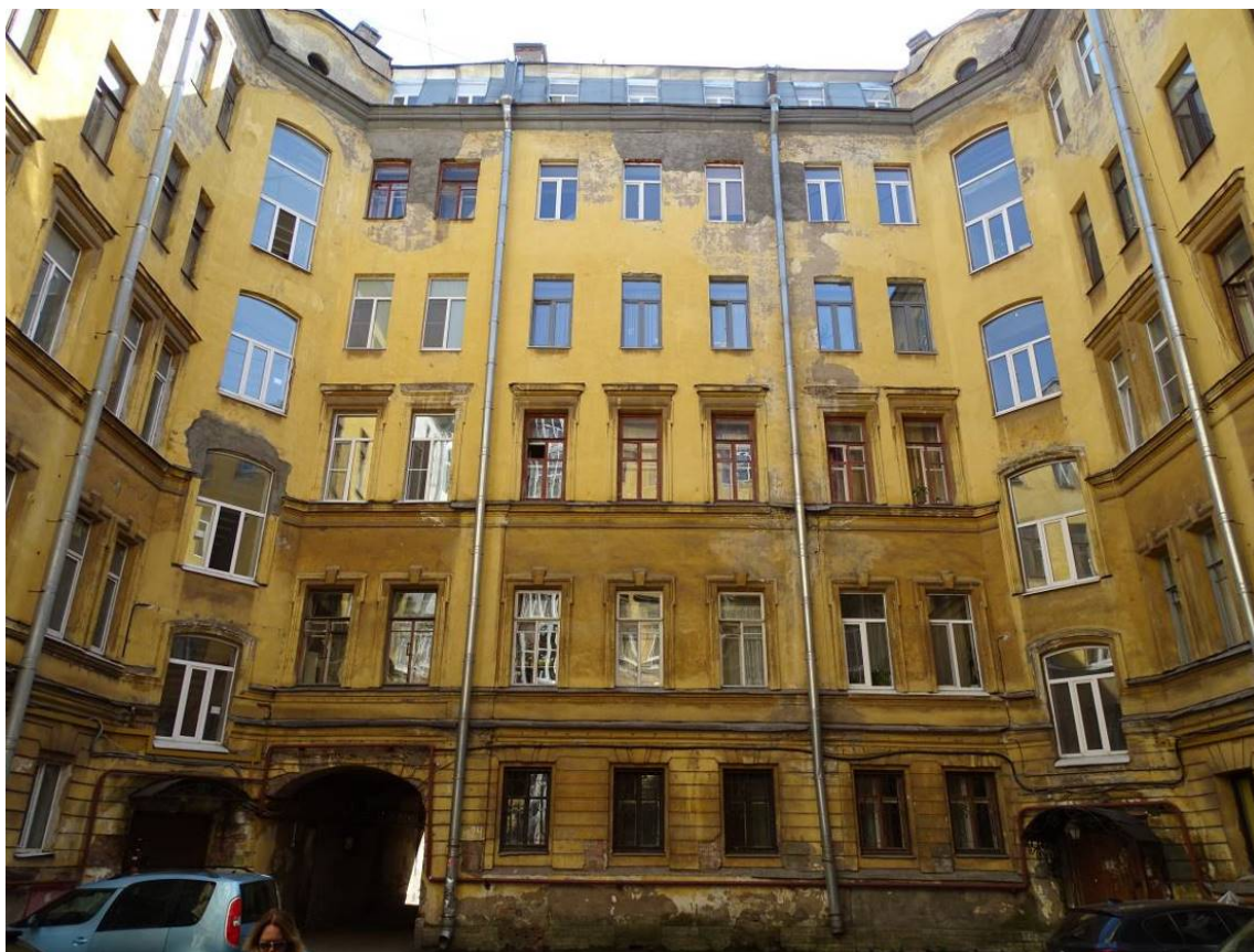
Фото 78. Здание по адресу: г. Санкт-Петербург, Коломенская ул., 14, литера Б. Восточный фасад внутреннего двора. Съемка 26.04.2021 г. Трушковский В.Э.
