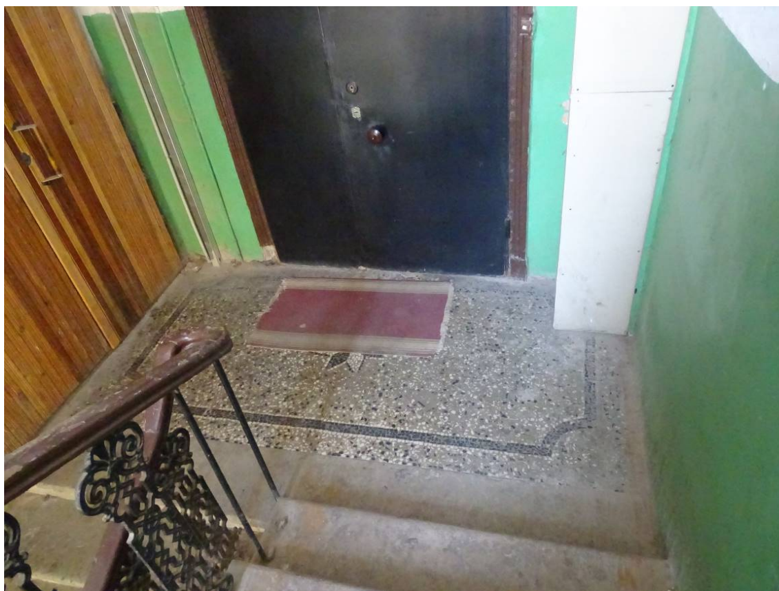
Фото 218. Лестница №2. 4 этаж. Покрытие террасо. Съемка 26.04.2021 г. Трушковский В.Э.
