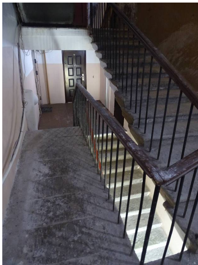
Фото 258. Лестница №3. 6 этаж. Съемка 26.04.2021 г. Трушковский В.Э.
