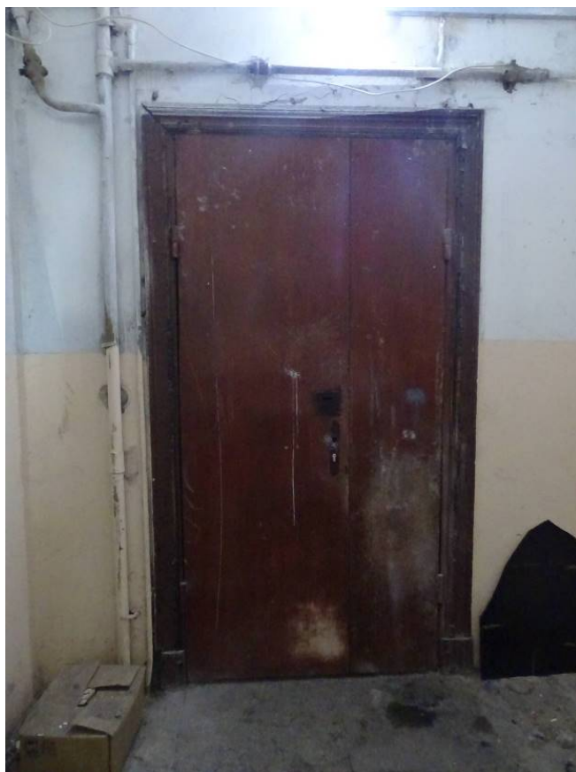
Фото 255. Лестница №3. 5 этаж. Съемка 26.04.2021 г. Трушковский В.Э.
