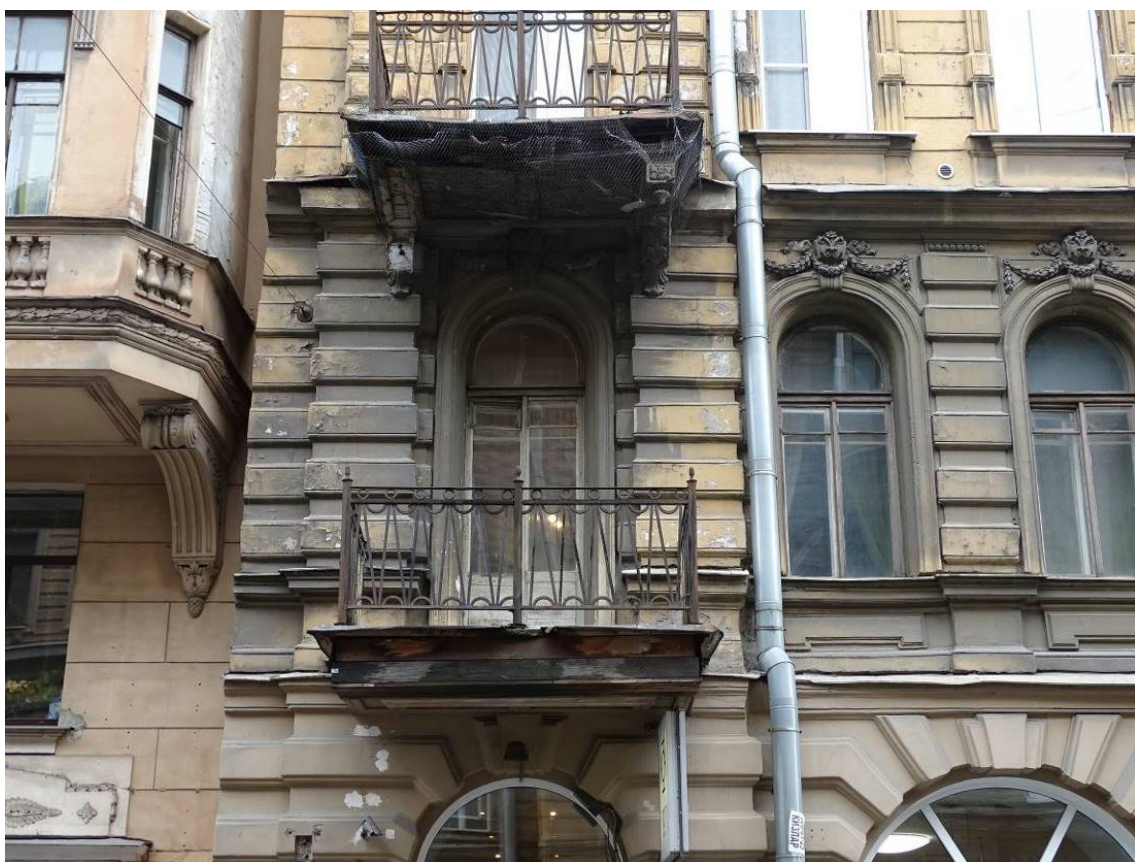
Фото 71. Здание по адресу: г. Санкт-Петербург, Коломенская ул., 14, литера Б. Фрагмент лицевого фасада. Балкон 2-го этажа. Съемка 26.04.2021 г. Трушковский В.Э.
