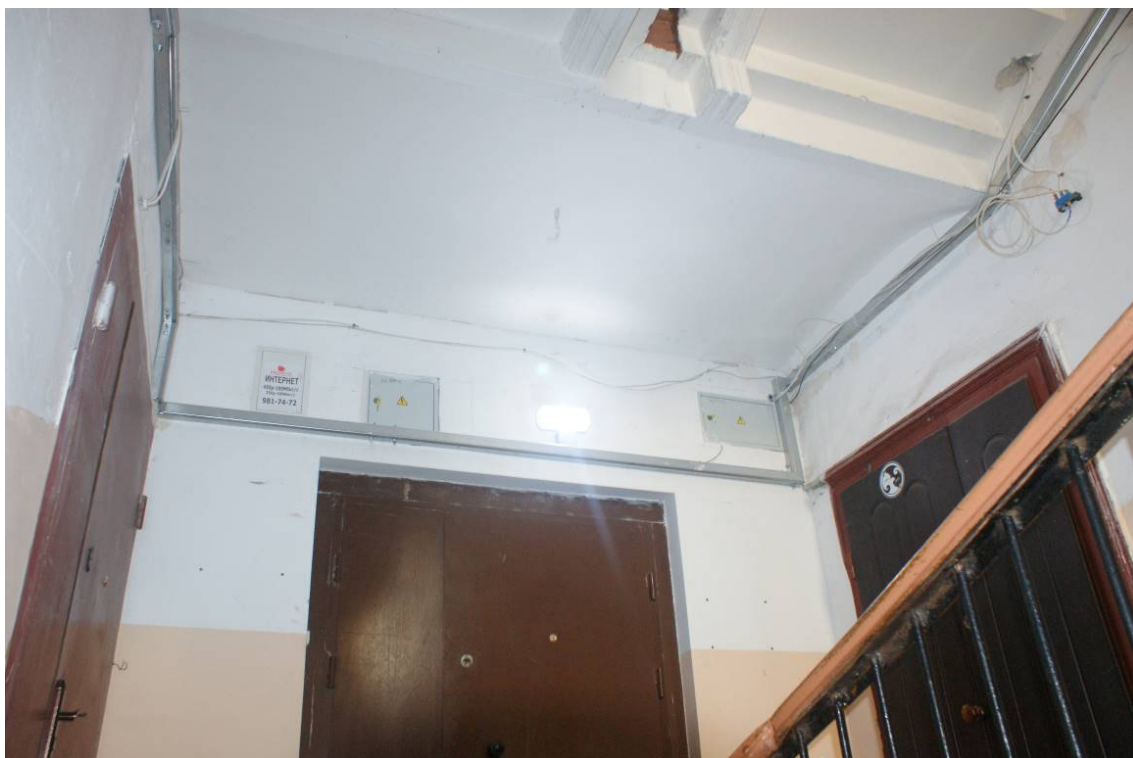
Фото 274. Лестница №4. 1 этаж. Межэтажное перекрытие в виде цилиндрического сводика. Съемка 26.04.2021 г. Трушковский В.Э.
