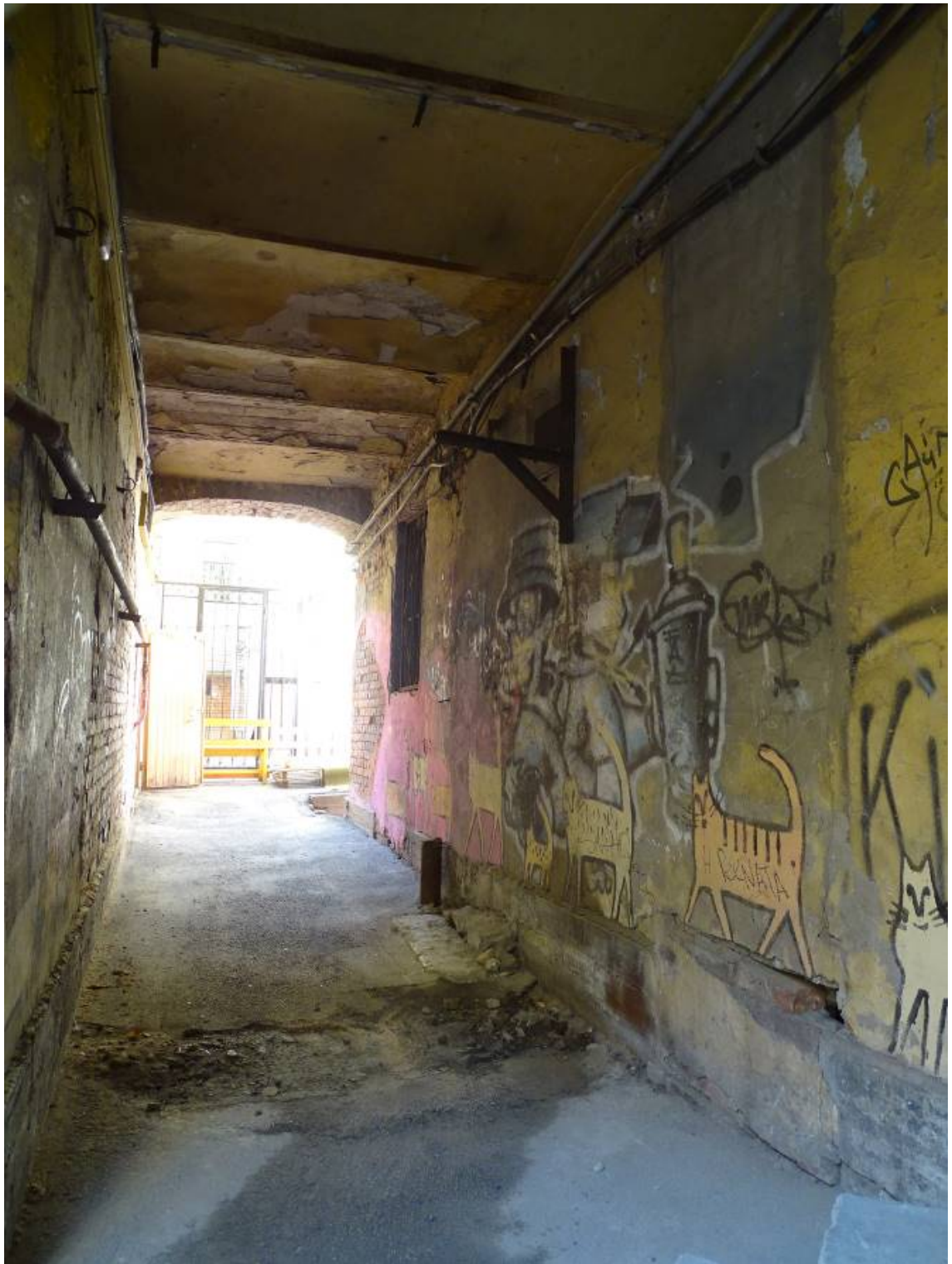
Фото 97. Здание по адресу: г. Санкт-Петербург, Коломенская ул., 14, литера Б. Перекрытие прохода из цилиндрических сводиков. Съемка 26.04.2021 г. Трушковский В.Э.
