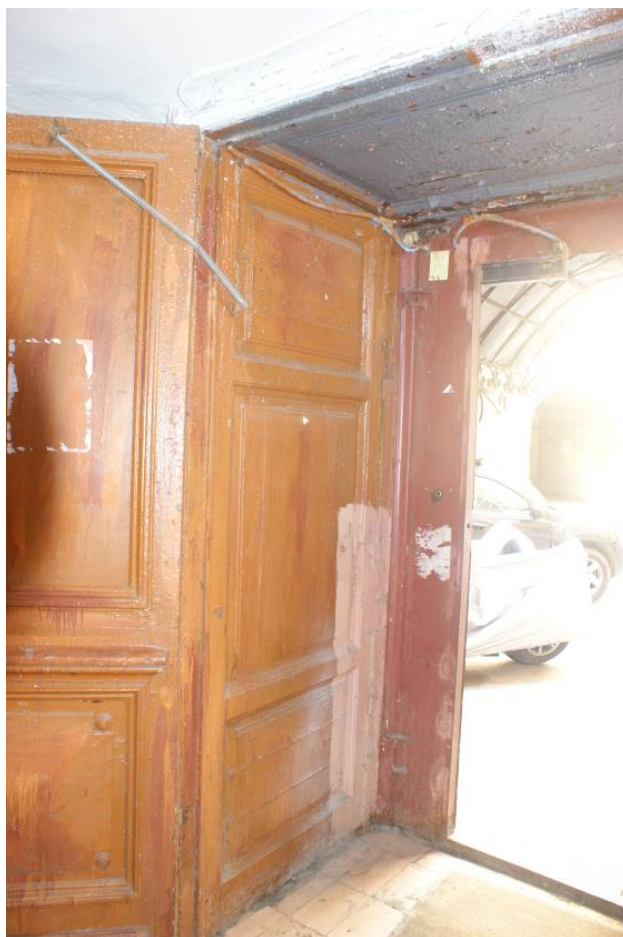
Фото 270. Лестница №4. 1 этаж. Фрагмент входа на лестницу №4. Съемка 26.04.2021 г. Трушковский В.Э.
