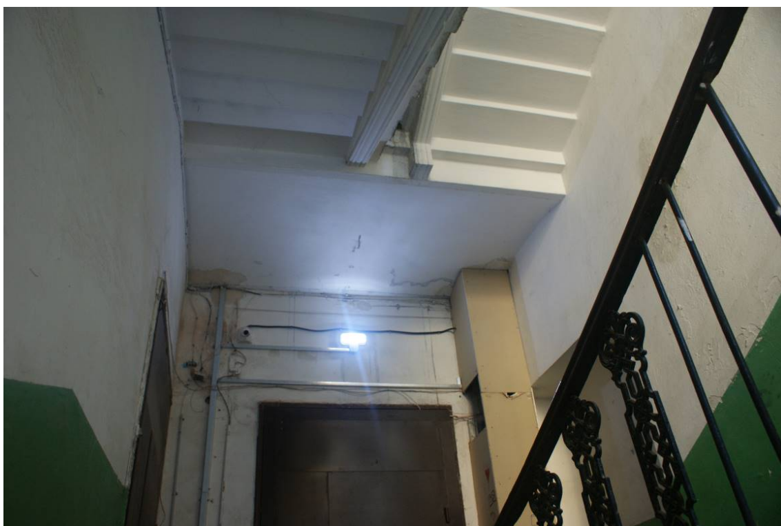
Фото 207. Лестница №2. 2 этаж. Перекрытие из цилиндрического сводика. Съемка 26.04.2021 г. Трушковский В.Э.
