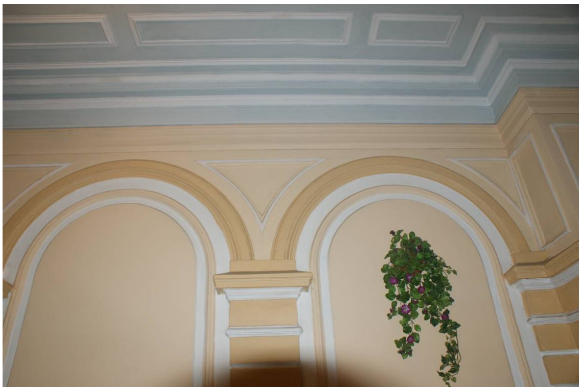
Фото 153. Лестница №1. 1 этаж. Фрагмент лепного декора стены. Съемка 26.04.2021 г. Трушковский В.Э.
