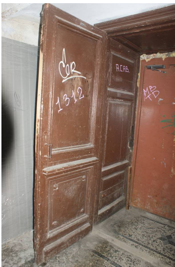
Фото 195. Лестница №2. 1 этаж. Фрагмент входа в лестничную клетку. Съемка 26.04.2021 г. Трушковский В.Э.
