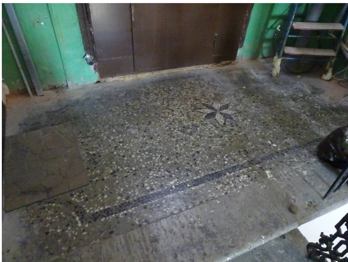
Фото 232. Лестница №2. 6 этаж. Покрытие террасцо. Съемка 26.04.2021 г. Трушковский В.Э.
