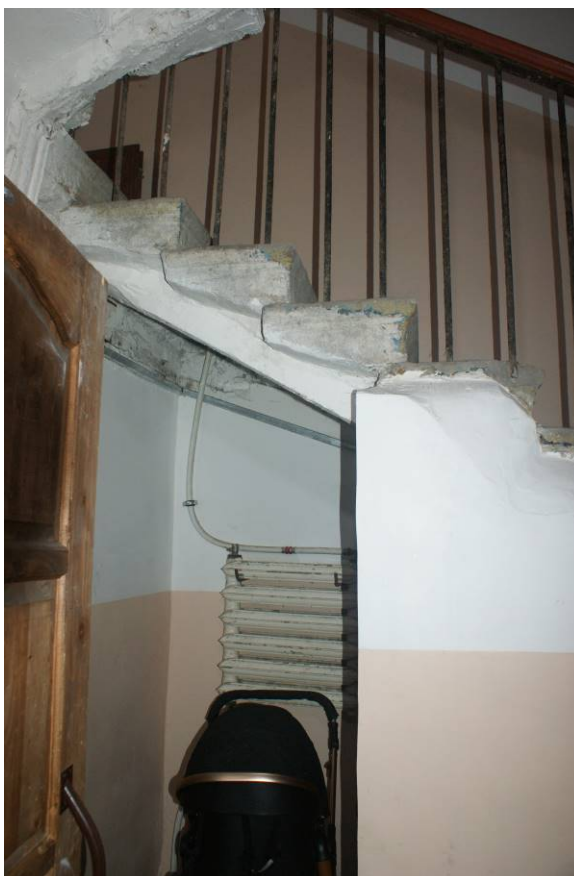
Фото 238. Лестница №3. 1 этаж. Пространство под лестничным маршем. Съемка 26.04.2021 г. Трушковский В.Э.
