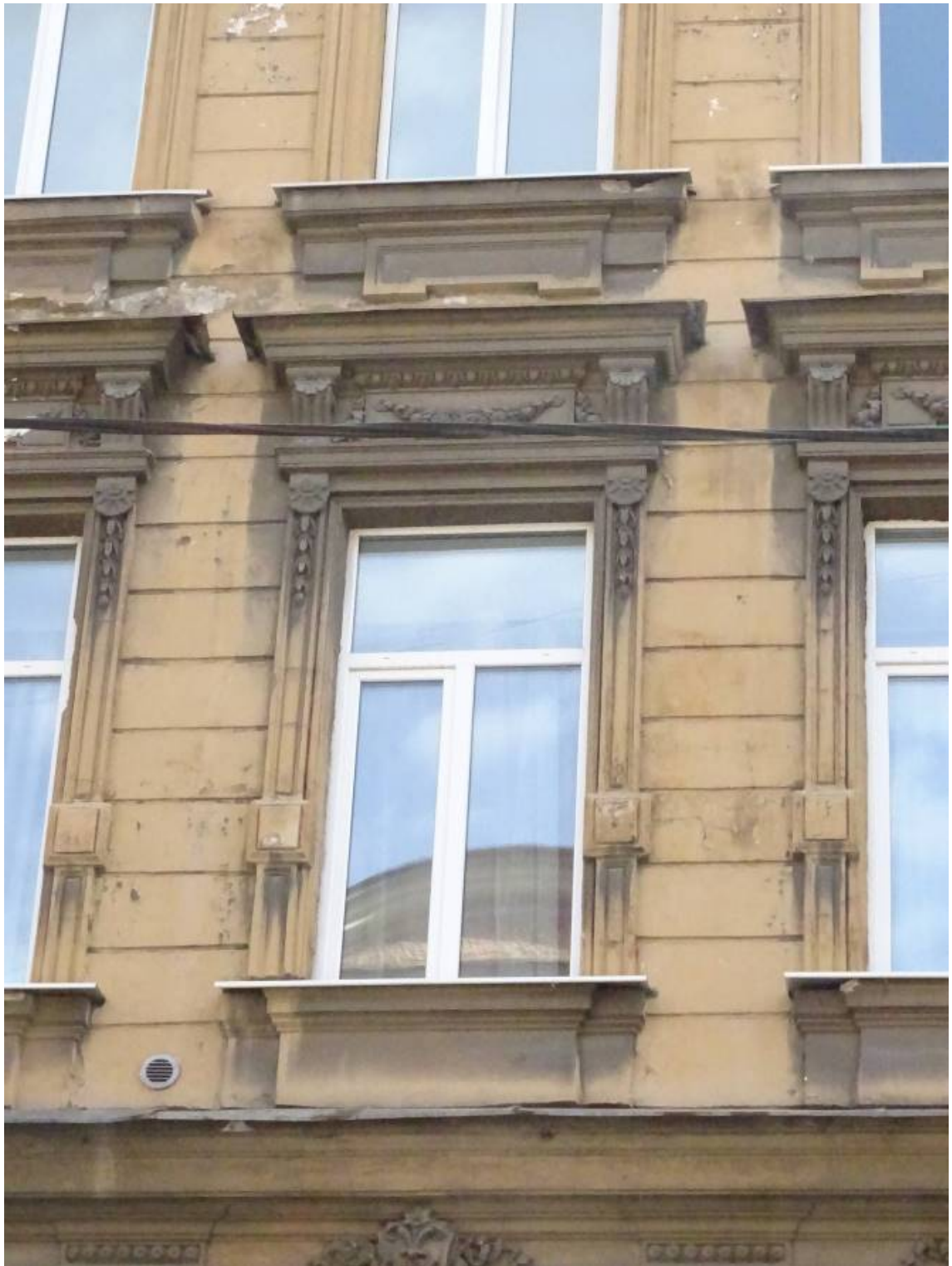
Фото 72. Здание по адресу: г. Санкт-Петербург, Коломенская ул., 14, литера Б. Фрагмент лицевого фасада. Оформление окна 3-го этажа. Съемка 26.04.2021 г. Трушковский В.Э.
