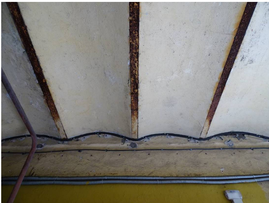
Фото 107. Здание по адресу: г. Санкт-Петербург, Коломенская ул., 14, литера Б. Перекрытие проезда из цилиндрических сводков. Съемка 26.04.2021 г. Трушковский В.Э.
