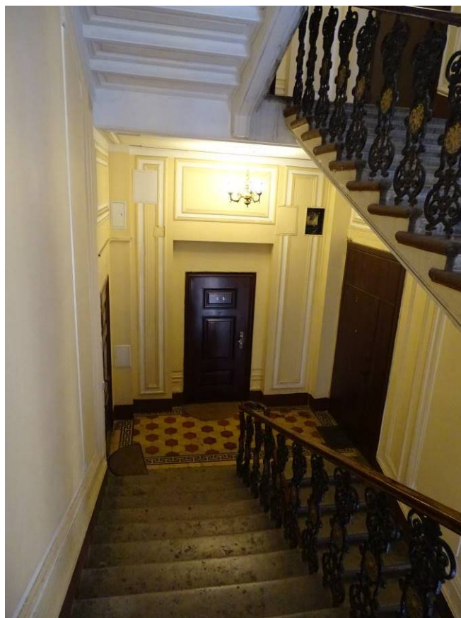
Фото 168. Лестница №1. 3 этаж. Съемка 26.04.2021 г. Трушковский В.Э.
