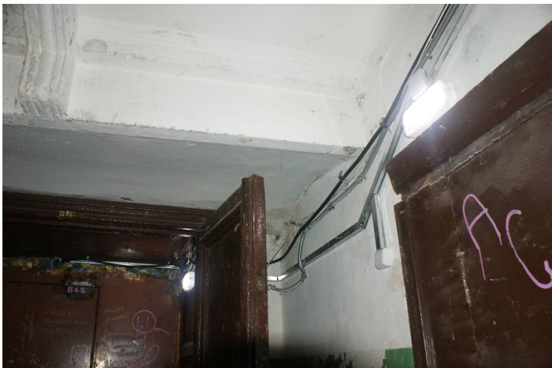
Фото 194. Лестница №2. 1 этаж. Фрагмент междуэтажного перекрытия. Съемка 26.04.2021 г. Трушковский В.Э.
