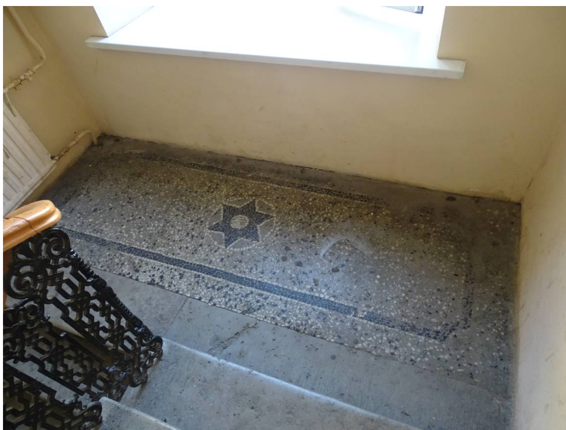
Фото 288. Лестница №4. Площадка между 3-м и 4-м этажом. Покрытие террасцо. Съемка 26.04.2021 г. Трушковский В.Э.
