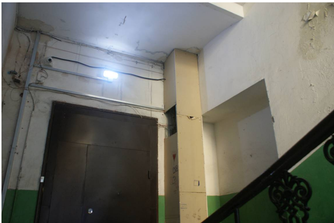
Фото 208. Лестница №2. 2 этаж. Ниша в стене. Съёмка 26.04.2021 г. Трушковский В.Э.
