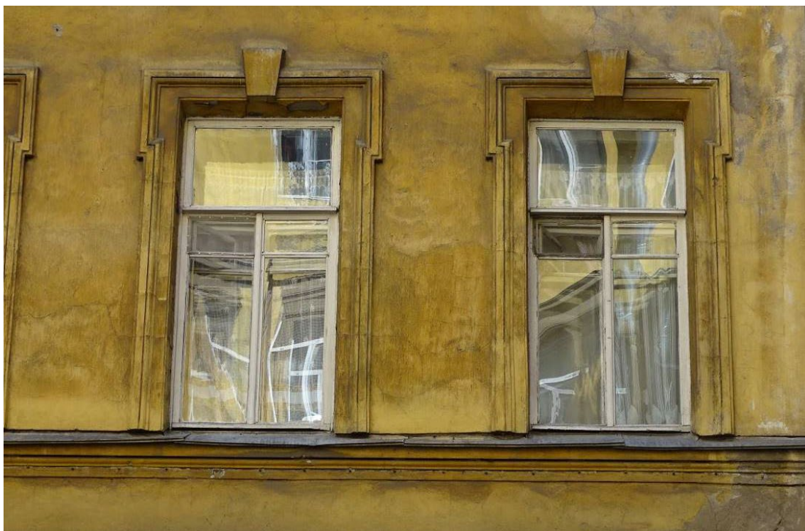
Фото 81. Здание по адресу: г. Санкт-Петербург, Коломенская ул., 14, литера Б. Фрагмент восточного фасада внутреннего двора. Окна 2-го этажа. Съемка 26.04.2021 г. Трушковский В.Э.
