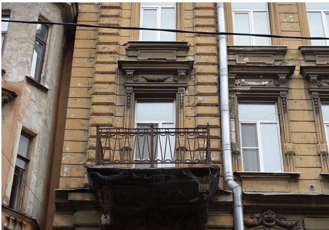
Фото 70. Здание по адресу: г. Санкт-Петербург, Коломенская ул., 14, литера Б. Фрагмент лицевого фасада. Балкон 3-го этажа. Съемка 26.04.2021 г. Трушковский В.Э.
