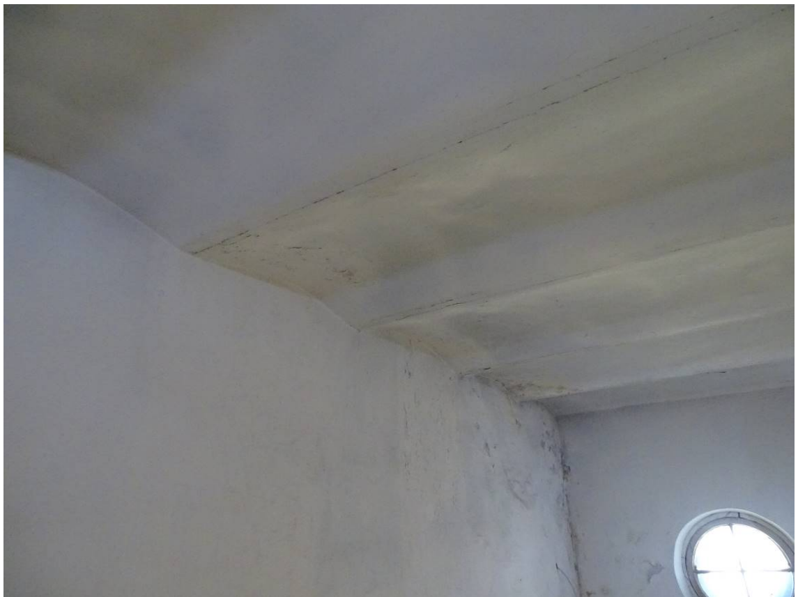
Фото 298. Лестница №4. Перекрытие из цилиндрических сводиков. Съемка 26.04.2021 г. Трушковский В.Э.
