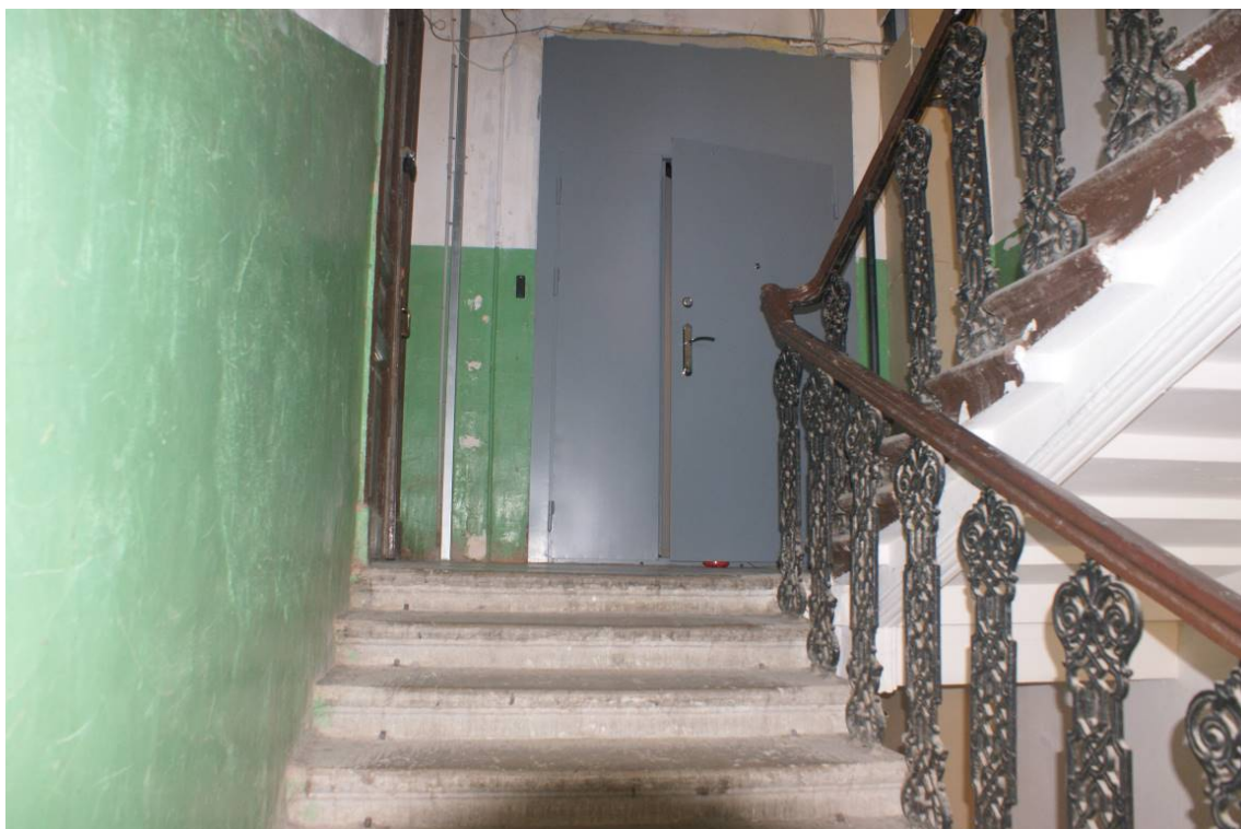
Фото 212. Лестница №2. 3 этаж. Съёмка 26.04.2021 г. Трушковский В.Э.
