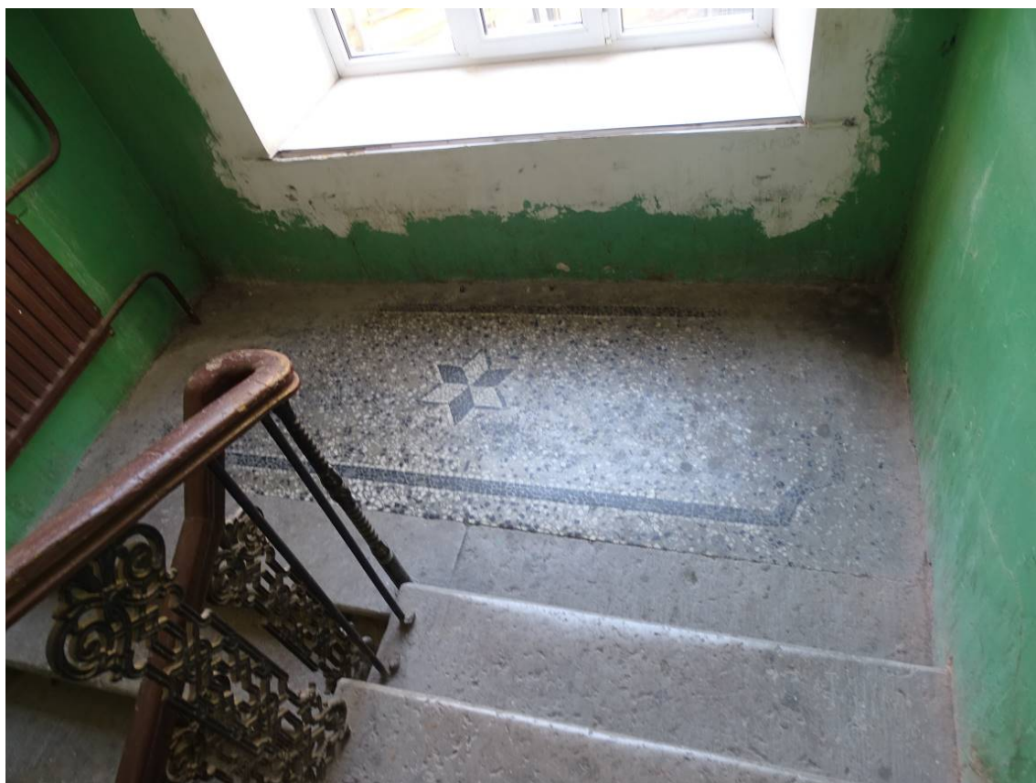
Фото 215. Лестница №2. Площадка между 3-м и 4-м этажом. Покрытие террасо. Съемка 26.04.2021 г. Трушковский В.Э.
