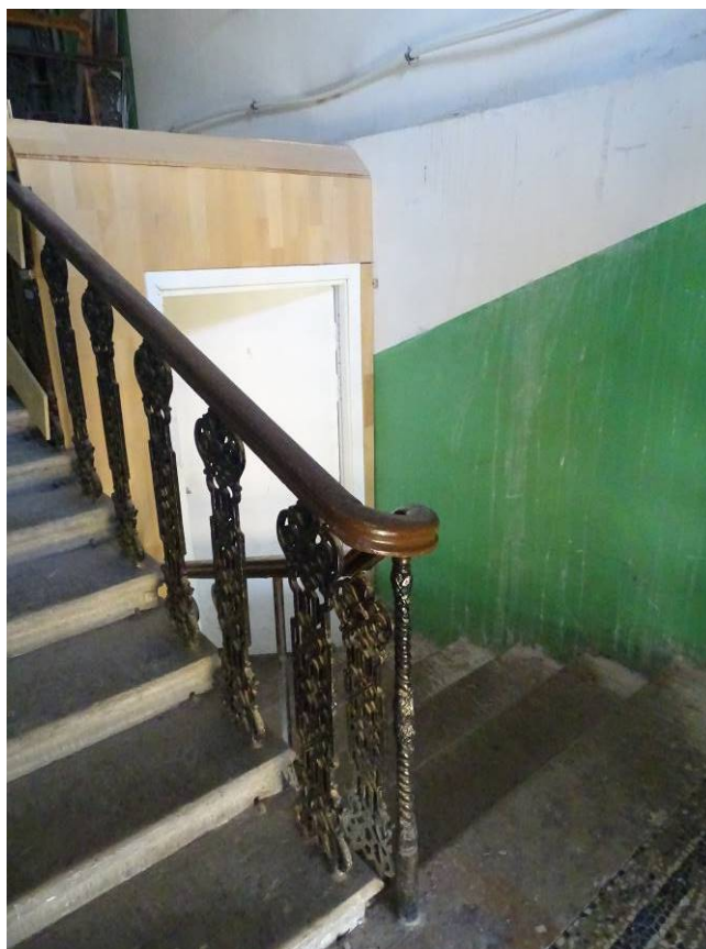
Фото 227. Лестница №2. Площадка между 5-м и 6-м этажом. Вход на площадку. Съемка 26.04.2021 г. Трушковский В.Э.
