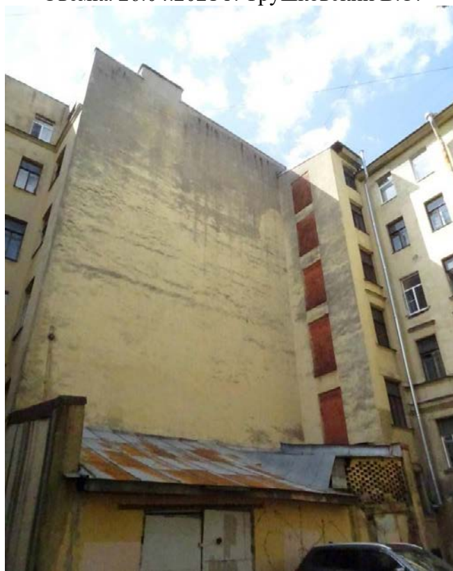
Фото 116. Здание по адресу: г. Санкт-Петербург, Коломенская ул., 14, литера Б. Фрагмент северного фасада. Съемка 26.04.2021 г. Трушковский В.Э.
