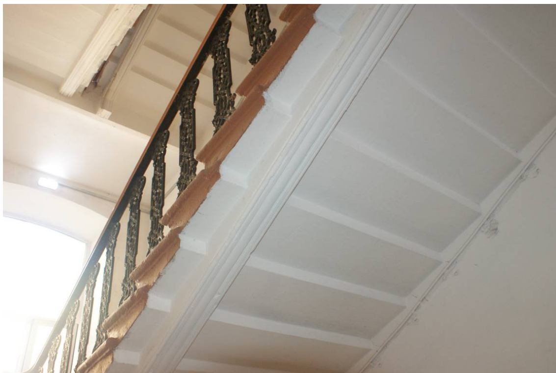
Фото 284. Лестница №4. Лестничный марш со 2-го на 3-й этаж. Съемка 26.04.2021 г. Трушковский В.Э.
