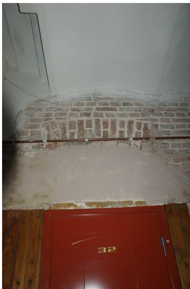
Фото 249. Лестница №3. 3 этаж. Съемка 26.04.2021 г. Трушковский В.Э.
