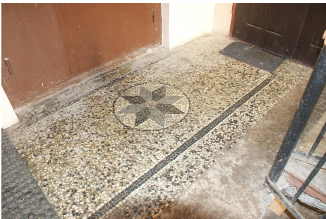
Фото 275. Лестница №4. 1 этаж. Покрытие террасо. Съемка 26.04.2021 г. Трушковский В.Э.
