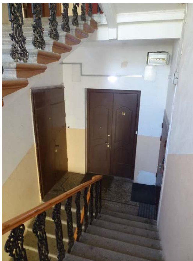
Фото 290. Лестница №4. 4 этаж. Съемка 26.04.2021 г. Трушковский В.Э.
