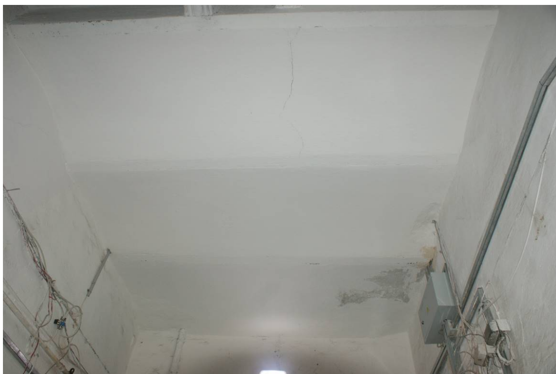
Фото 243. Лестница №3. 2 этаж. Перекрытие из цилиндрических сводиков. Съемка 26.04.2021 г. Трушковский В.Э.
