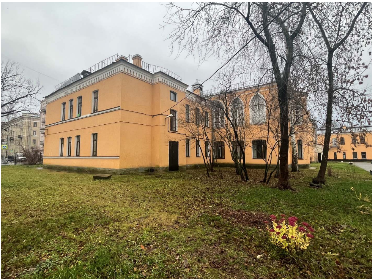
Фото №7. Восточный фасад, общий вид.
