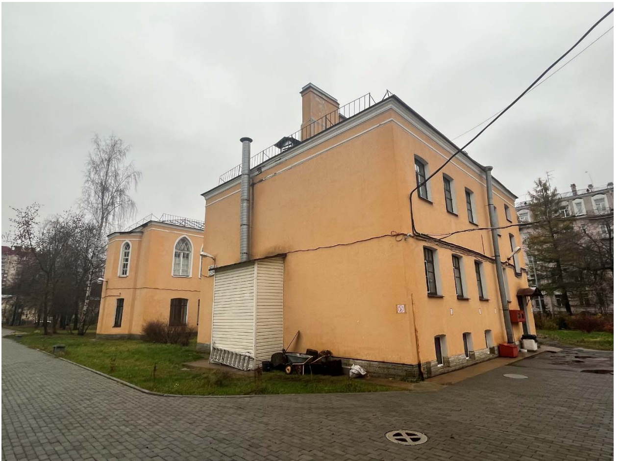
Фото №12. Северный и западный фасады.
