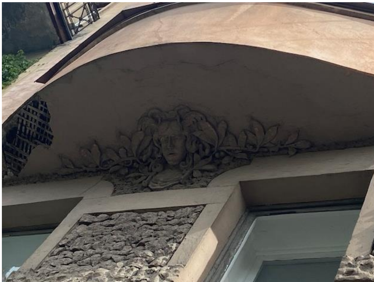
Фото 25 Выявленный объект культурного наследия «Дом К.И. Фасси и Л.А. Богусского» Вид на оформление нижней плоскости левого эркера северной части лицевого фасада. Сохранился лепной декор (женский маскарон в обрамлении лавровых ветвей)
