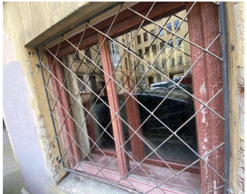
Фото 24. Выявленный объект культурного наследия «Дом К.И. Фасси и Л.А. Богусского» Вид на заполнения оконных и дверных проемов (МОП) лестничной клетки 7 Сохранились исторические оконные заполнения. Дверные – утрачены.
