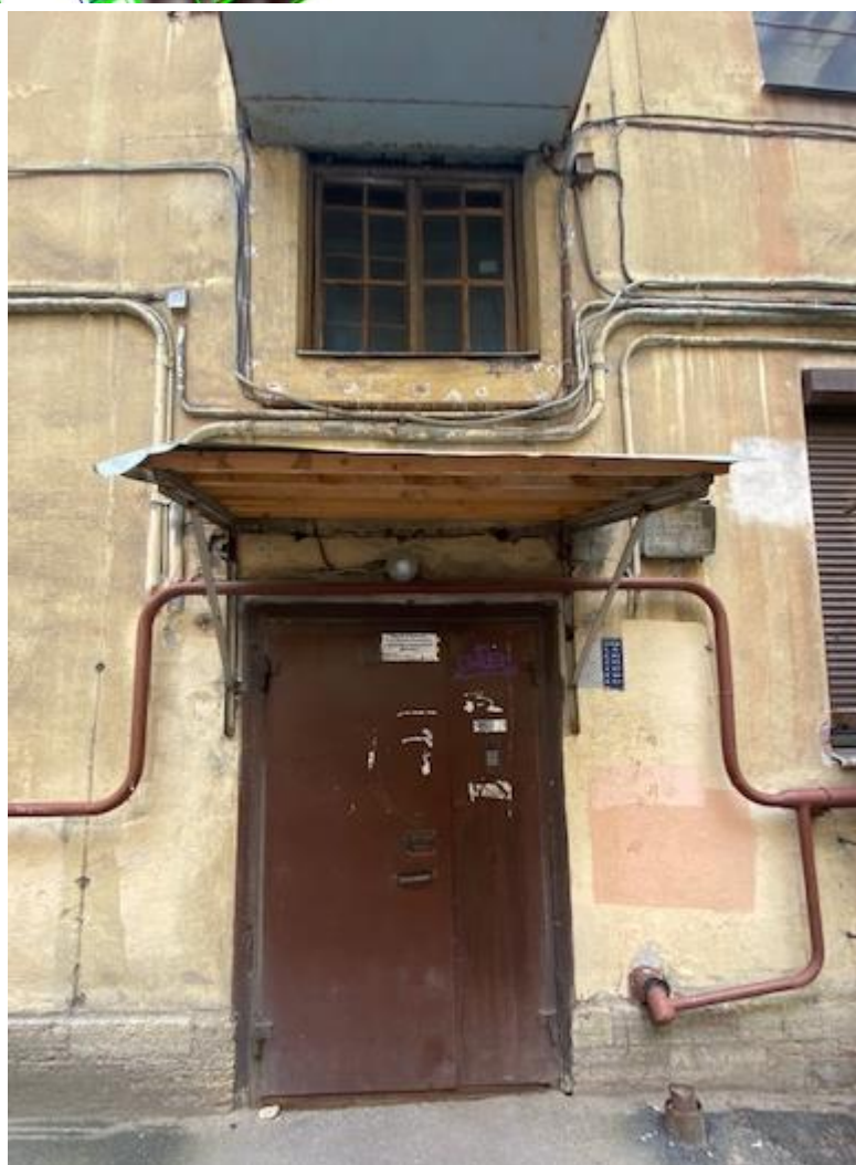
Фото 38. Выявленный объект культурного наследия «Дом К.И. Фасси и Л.А. Богусского» Вид на заполнения оконных и дверных проемов (МОП), козырек лестничной клетки б. Сохранились исторические оконные заполнения. Дверные – утрачены. Козырек поздний. Не исторический.
