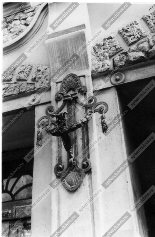
27 Флагодержатель на фасаде дома № 37 на 6-й линии Васильевского острова (бывший дом С.Х.Мельцер, военный инженер Э.Ф.Мельцер, 1909-1911 гг.). ЦГАКФФД СПб. Фотодокумент Ар 225790 Дата съемки 09.05.1991
