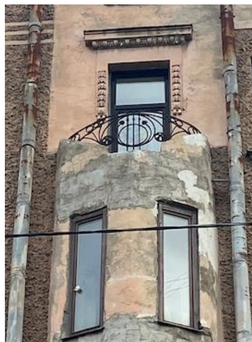
Фото 9,10 Выявленный объект культурного наследия «Дом К.И. Фасси и Л.А. Богусского» Вид на ограждения балконов и сандрики дверных (балконных) проемов 5-гоэтажа южной части лицевой фасада Сохранился исторический штукатурных и металлический архитектурный декор.
