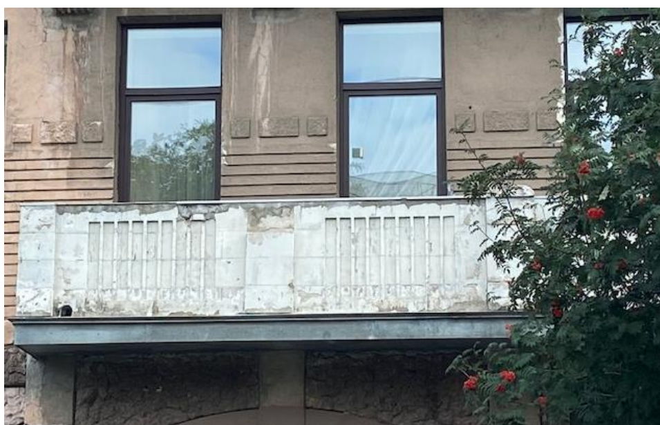
Фото13 Выявленный объект культурного наследия «Дом К.И. Фасси и Л.А. Богусского» Вид на ограждения балконов 2-го и 3-его этажа южной части лицевой фасада. Сохранилось металлическое ограждение балкона 3-его этажа. Сохранилось горизонтальное членения фасада тягами, в уровне 2-го этажа – врезанными бороздками;
