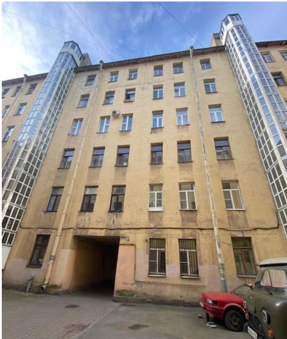
Фото 41. Выявленный объект культурного наследия «Дом К.И. Фасси и Л.А. Богусского» Общий вид внутреннего двора 2 .Фасады гладко оштукатурены, без лепного и штукатурного декора. Устроены лифтовые шахты. Общая авторская композиция сохранилась, частично утрачены оконные заполнения, свесы крыши на деревянных «кобылках». Устроены лифтовые шахты.
