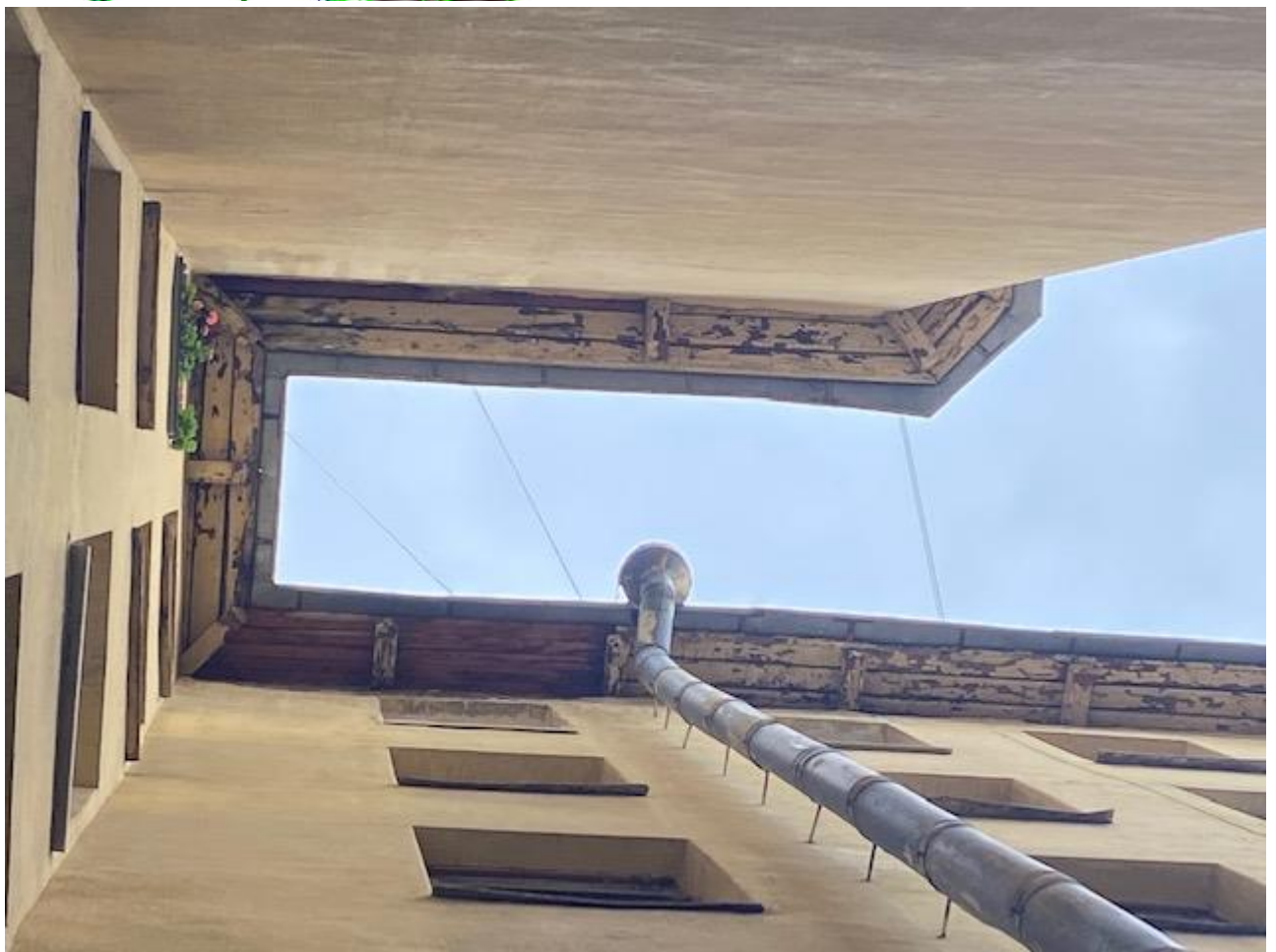
Фото36. Выявленный объект культурного наследия «Дом К.И. Фасси и Л.А. Богусского» Вид на свесы крыши на деревянных «кобылках».
