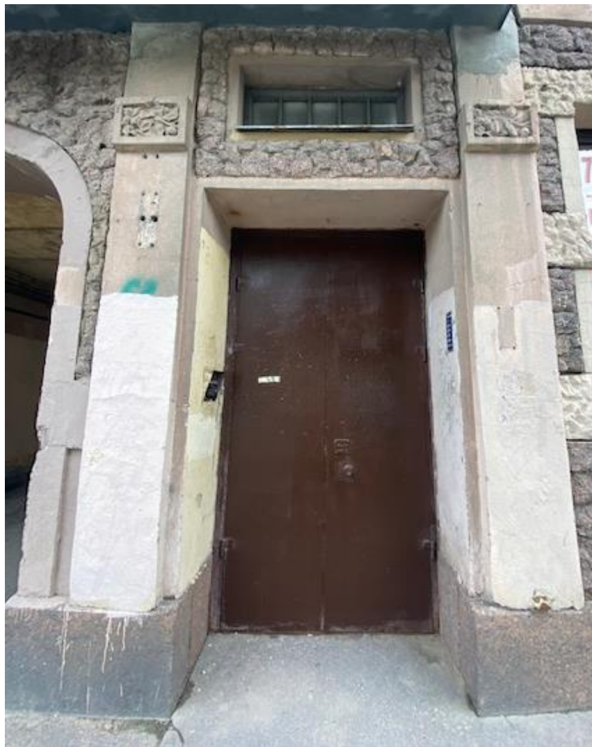
Фото 5. Выявленный объект культурного наследия «Дом К.И. Фасси и Л.А. Богусского» Вид на входную группу лестничной клетки 1 южной части лицевого фасада со стороны 6-ой линии В.О. Дверное заполнение позднее, металлическое. Фрамуга деревянная историческая. Дверное заполнение – утрачено.
