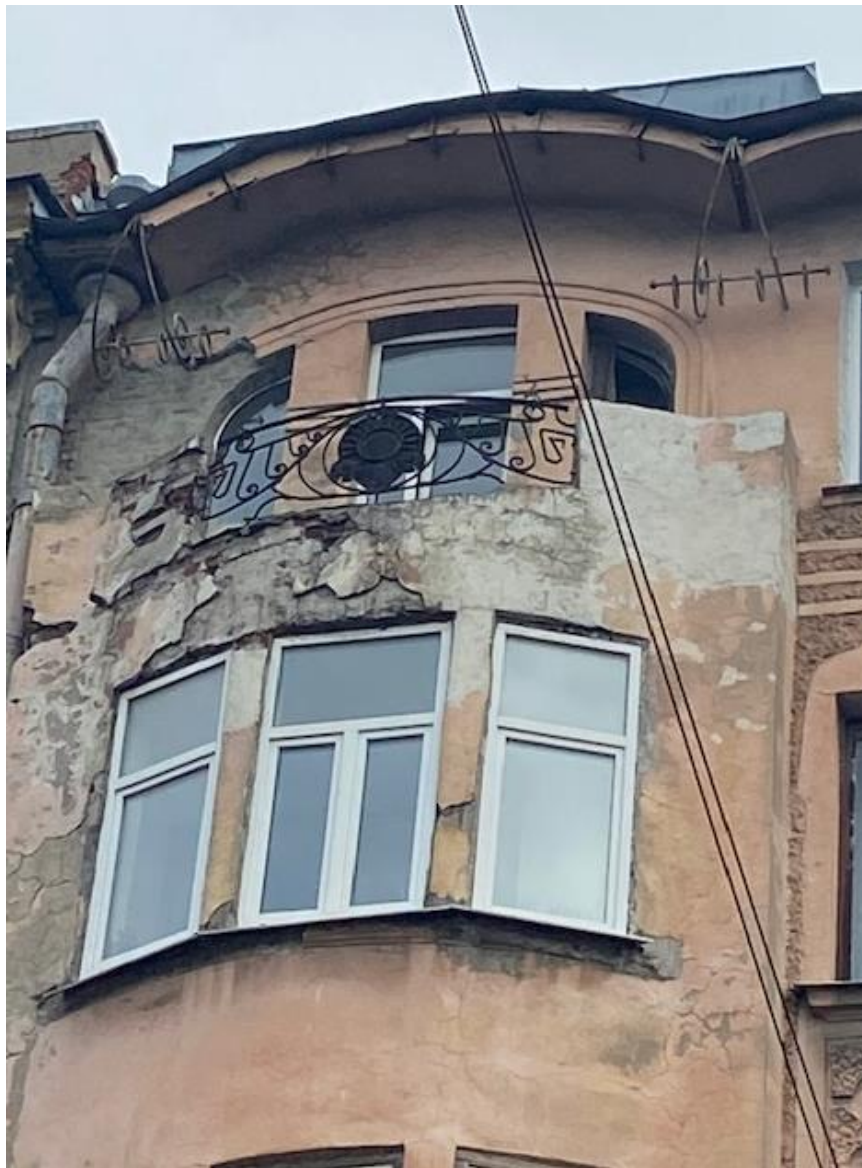
Фото 23 Выявленный объект культурного наследия «Дом К.И. Фасси и Л.А. Богусского» Вид на правый эркер северной части лицевого фасада, завершенный в уровне 6-го этажа балконами с ограждениями кованого железа, венчающий карниз Сохранилась историческая штукатурная отделка и историческое ограждение балкона. Сохранился
