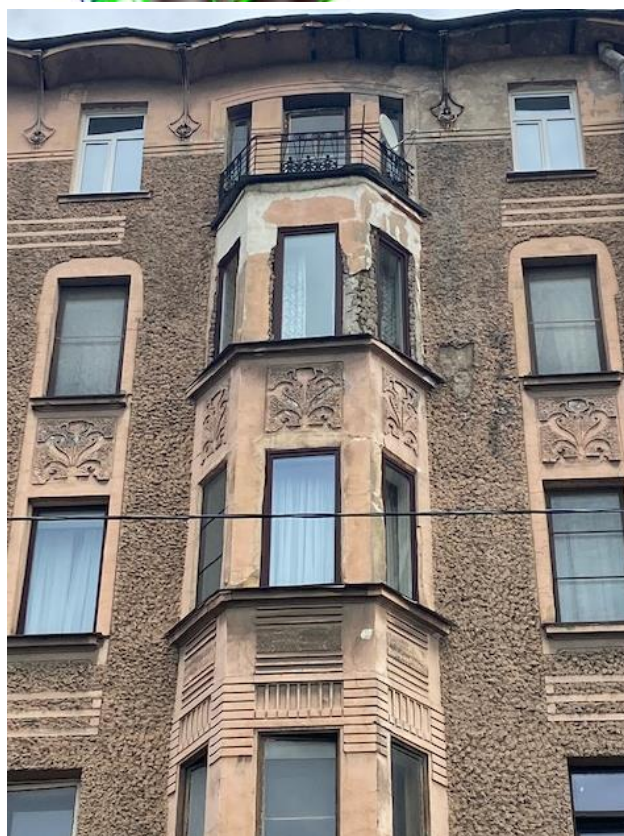
Фото 22 Выявленный объект культурного наследия «Дом К.И. Фасси и Л.А. Богусского» Вид на левый эркер северной части лицевого фасада, завершенный в уровне 6-го этажа балконами с ограждениями кованого железа, венчающий карниз. Сохранилась историческая штукатурная отделка и историческое ограждение балкона. Сохранился криволинейный (волнообразный) свес крыши на металлических кронштейнах .
