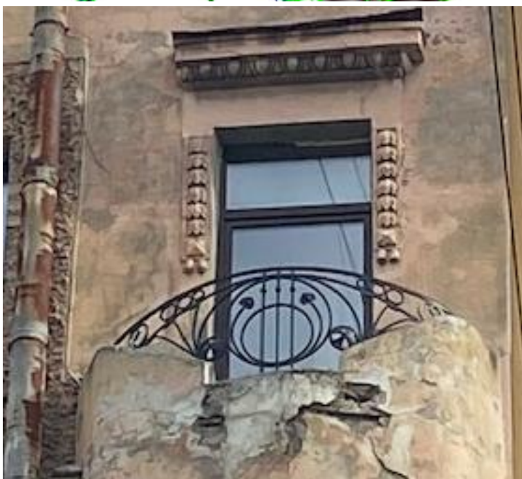
Фото 9,10 Выявленный объект культурного наследия «Дом К.И. Фасси и Л.А. Богусского» Вид на ограждения балконов и сандрики дверных (балконных) проемов 5-гоэтажа южной части лицевой фасада Сохранился исторический штукатурных и металлический архитектурный декор.
