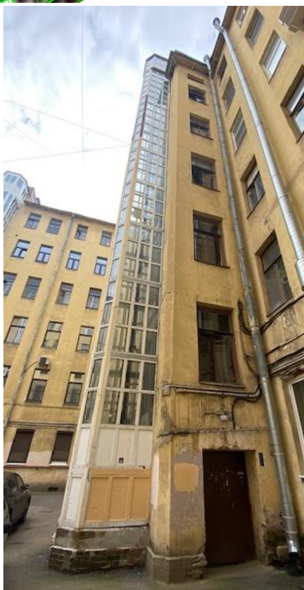
Фото 25. Выявленный объект культурного наследия «Дом К.И. Фасси и Л.А. Богусского» Вид на заполнения оконных и дверных проемов (МОП) лестничной клетки 8. Сохранились исторические оконные заполнения. Дверные – утрачены.
