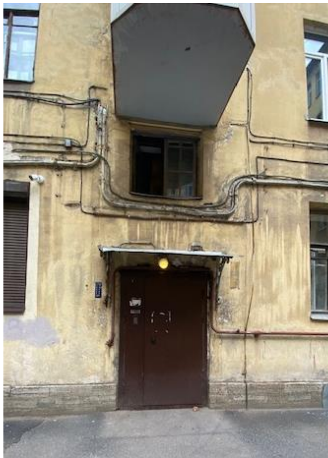
Фото 32. Выявленный объект культурного наследия «Дом К.И. Фасси и Л.А. Богусского» Вид на заполнения оконных и дверных проемов (МОП), козырек лестничной клетки 3. Сохранились исторические оконные заполнения. Дверные – утрачены. Козырек поздний. Не исторический.
