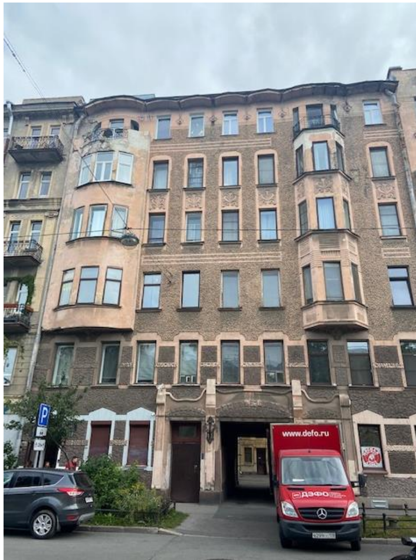
Фото 19 Выявленный объект культурного наследия «Дом К.И. Фасси и Л.А. Богусского» Общий вид на северную часть лицевой фасад со стороны 6-ой линии В.О. Два эркера в уровне 3-5-го этажей – граненый и полукруглый в плане, завершенные в уровне 6-го этажа балконами с ограждениями из металла, проем воротного проезда, слева от воротного проезда устроен вход на лестничную клетку 2 Общая авторская композиция сохранилась, утрачены оконные и дверные заполнения, Утрачены створы воротного проезда.
