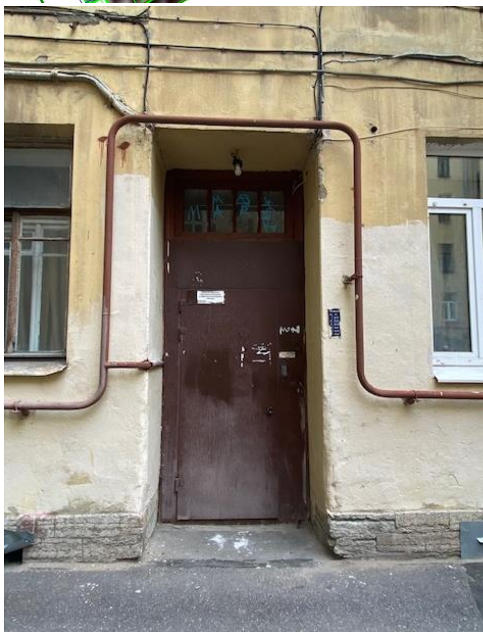
Фото 34. Выявленный объект культурного наследия «Дом К.И. Фасси и Л.А. Богусского» Вид на заполнения дверного проема (МОП) лестничной клетки 4. Сохранилась историческая фрамуга из дерева. Дверное полотно позднее металлическое.
