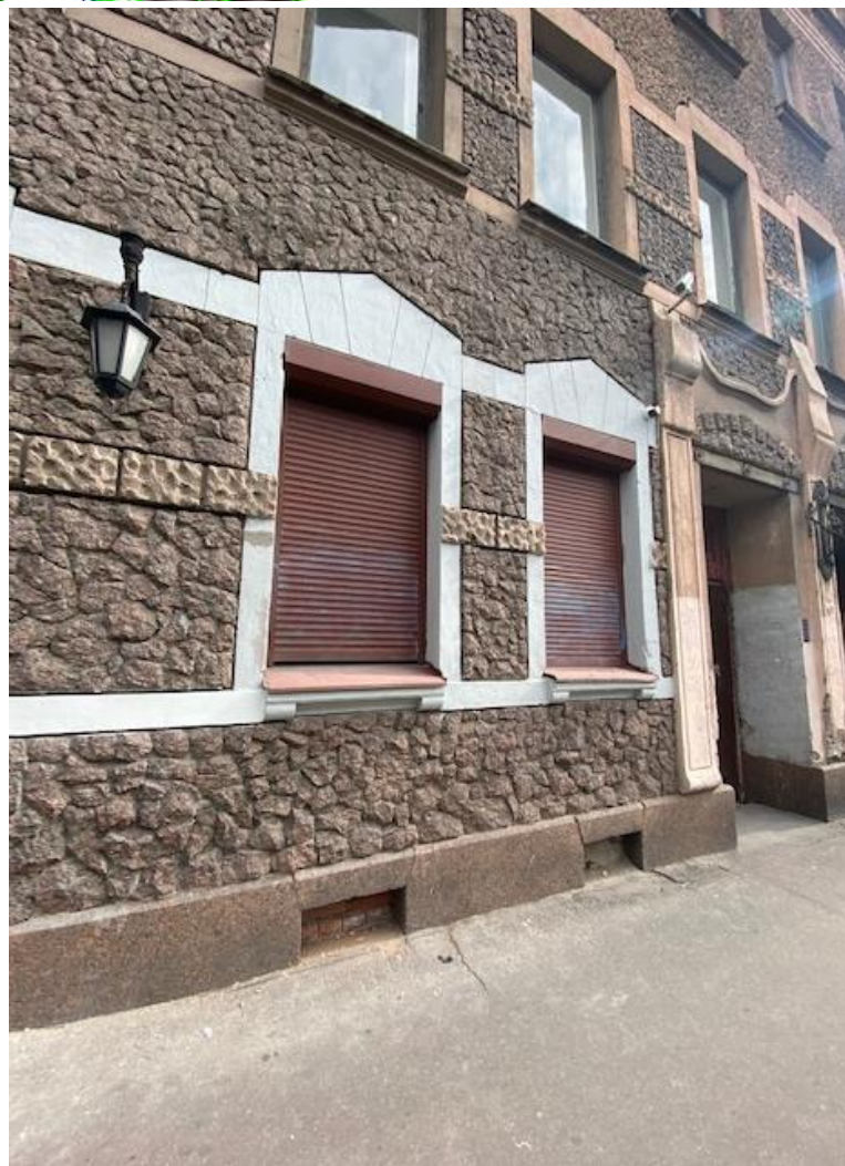
Фото 20 . Выявленный объект культурного наследия «Дом К.И. Фасси и Л.А. Богусского» Вид на цоколь из тесаного красного гранита северной части лицевого фасада. Оконные проемы цокольного этажа заложены Облицовка 1-ого этажа выполнена колотым красным гранитом (щепой) – историческая. Заполнения оконных проемов утрачены (Материал, цвет и рисунок не соответствует предметам охраны).
