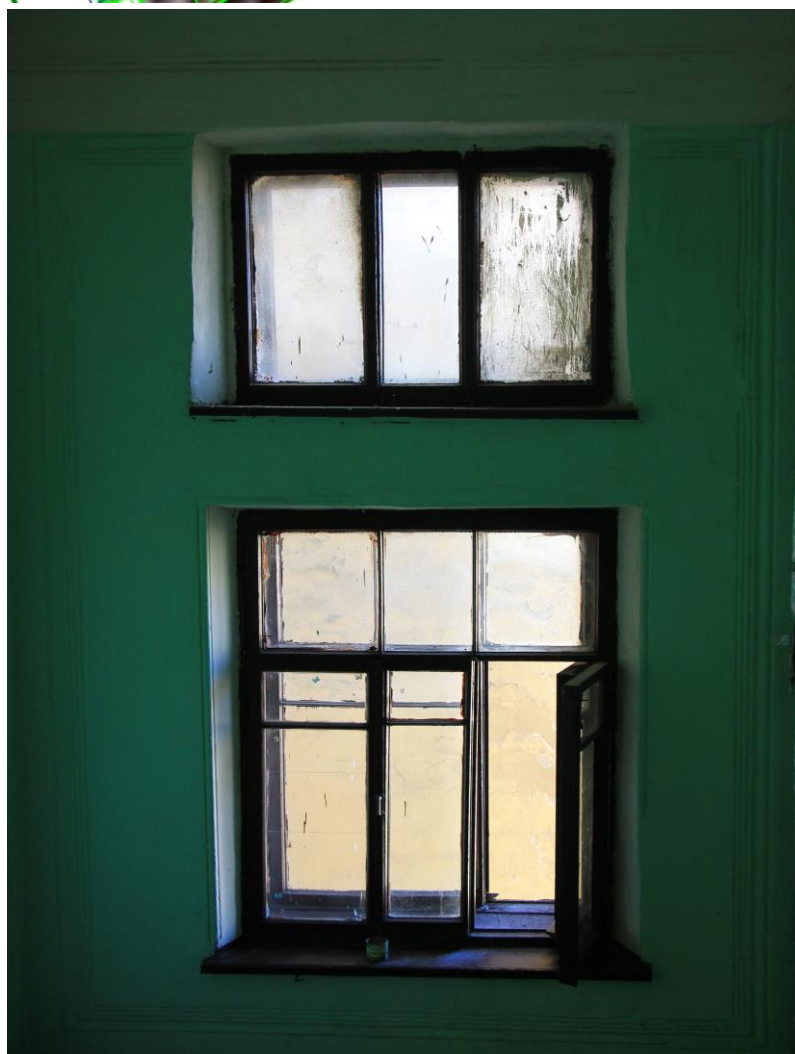
Фото 28,29 Выявленный объект культурного наследия «Дом К.И. Фасси и Л.А. Богусского» Вид на заполнения оконных проемов лестничной клетки №1 со стороны лестницы (МОП). Деревянные.
