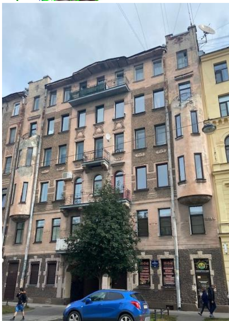
Фото 3. Выявленный объект культурного наследия «Дом К.И. Фасси и Л.А. Богусского» Общий вид на южную часть лицевой фасад со стороны 6-ой линии В.О. Эркеры в уровне 3-4-го этажей - полукруглые в плане, завершенные в уровне 5-го этажа балконами, балконы в уровне 2-4-го (на кронштейнах) и 6-го этажей центральной части, проем воротного проезда. Справа от арочного проезда устроен вход на лестничную клетку 1. Общая авторская композиция сохранилась, утрачены оконные и дверные заполнения, Сохранился створ воротного заполнения. Второй – утрачен.
