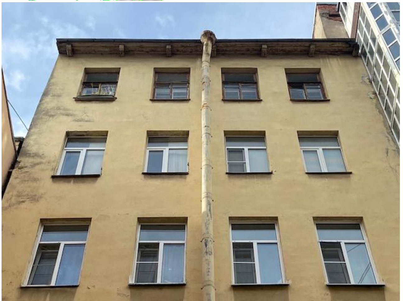
Фото 42 Выявленный объект культурного наследия «Дом К.И. Фасси и Л.А. Богусского» Вид на оконные заполнения 4,5,6 этажа , деревянные кобылки венчающего карниза внутреннего двора 2
