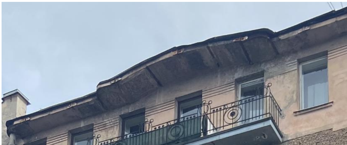
Фото 16 Выявленный объект культурного наследия «Дом К.И. Фасси и Л.А. Богусского» Вид на свес крыши, с криволинейным повышением по центру (над балконом), с кессонированной подшивкой
