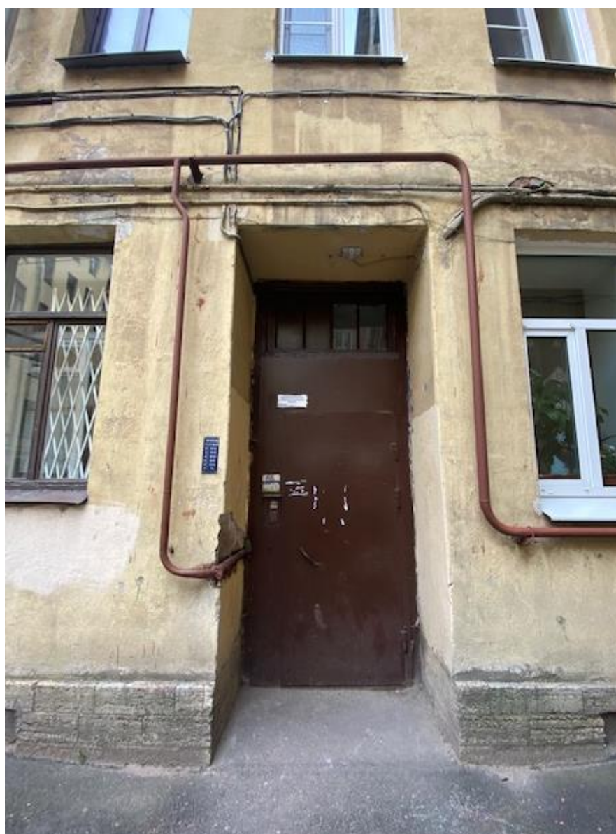
Фото 35. Выявленный объект культурного наследия «Дом К.И. Фасси и Л.А. Богусского» Вид на заполнения дверного проема (МОП) лестничной клетки 5. Сохранилась историческая фрамуга из дерева. Дверное полотно позднее металлическое.
