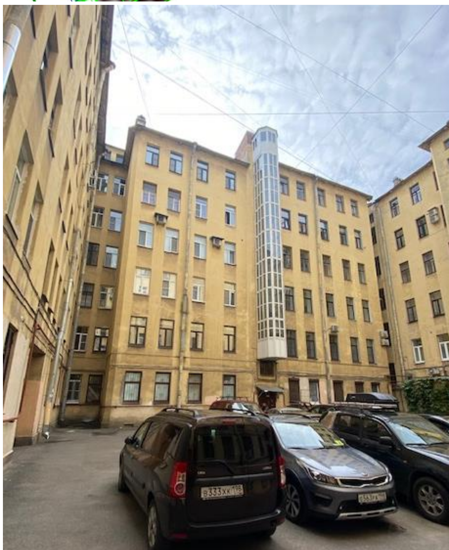
Фото 37. Выявленный объект культурного наследия «Дом К.И. Фасси и Л.А. Богусского» Общий вид внутреннего двора 1, со стороны воротного со стороны лестничной клетки 4. Фасады гладко оштукатурены, без лепного и штукатурного декора. Устроены лифтовые шахты. Общая авторская композиция сохранилась, частично утрачены оконные заполнения, свесы крыши на деревянных «кобылках».
