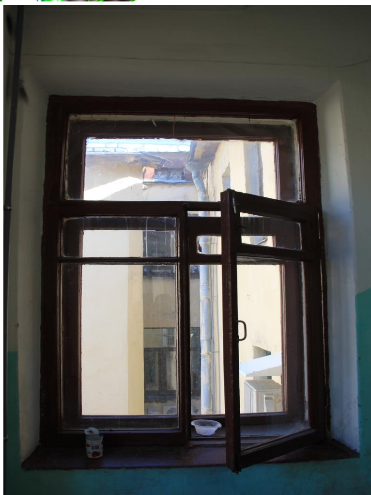
Фото 30. Выявленный объект культурного наследия «Дом К.И. Фасси и Л.А. Богусского» Вид на заполнения оконных проемов лестничной клетки №7 со стороны лестницы (МОП). Деревянные.
