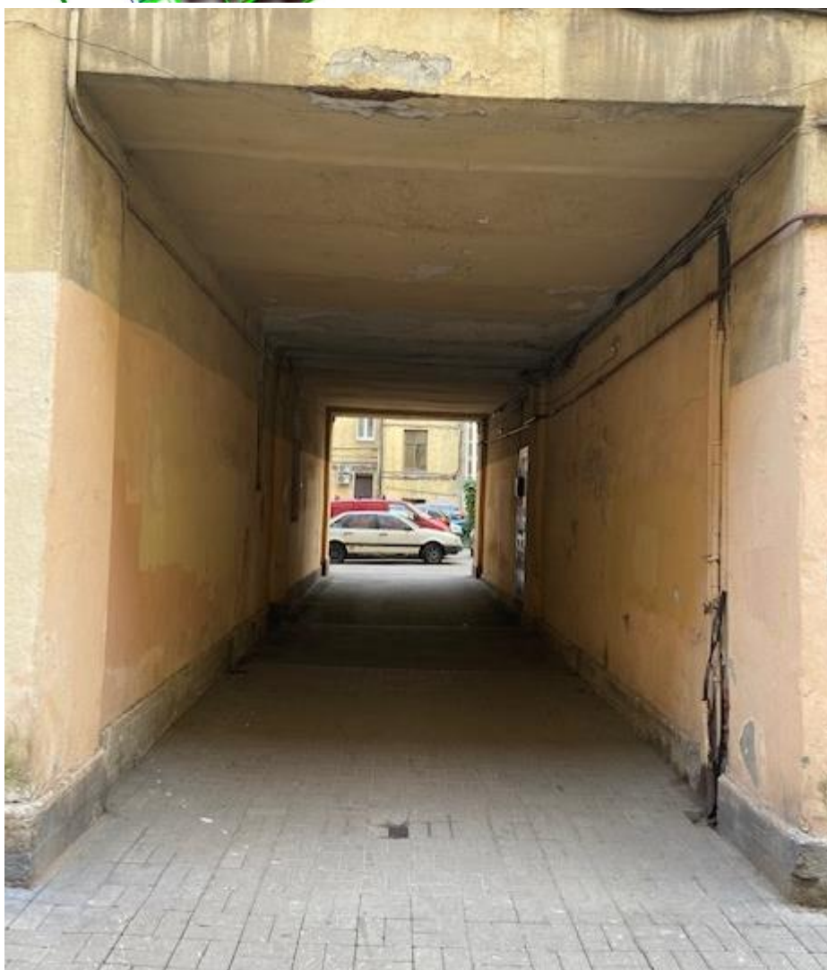
Фото 43 Выявленный объект культурного наследия «Дом К.И. Фасси и Л.А. Богусского» Общий вид воротный проезд со стороны внутреннего двора. Стены гладко оштукатурены, Отделка цоколя цоколя – известняковая плита
