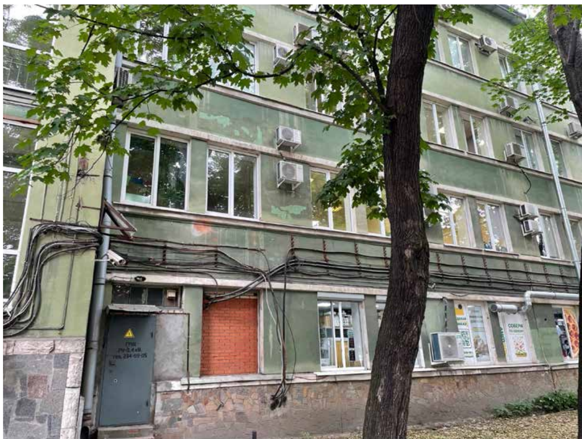
9. Фрагмент дворового фасада
