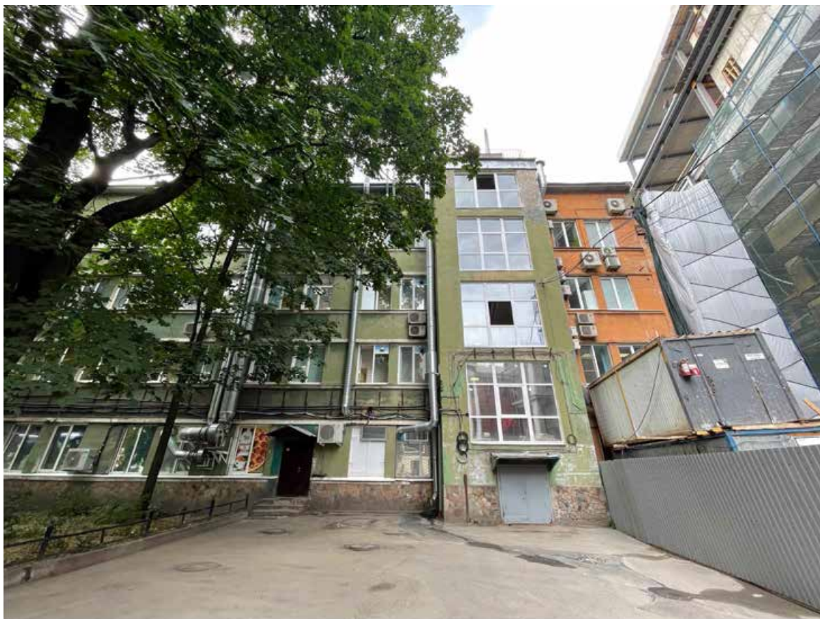
11. Фрагмент дворового фасада
