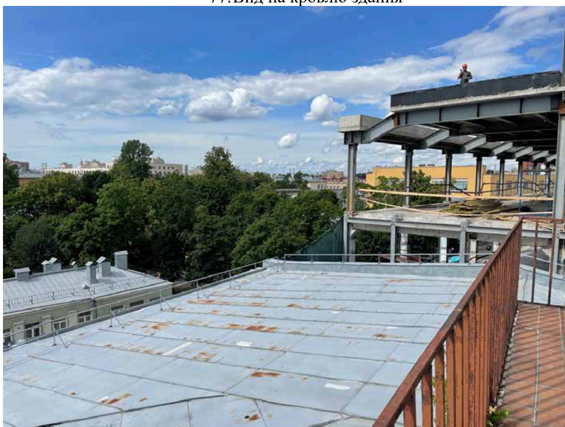
78. Вид на кровлю здания
