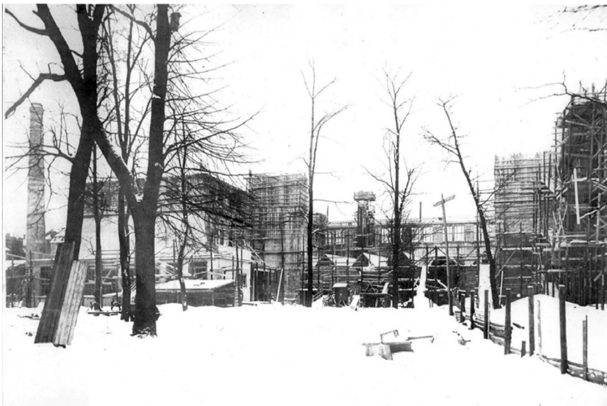
89. "Ленполиграфмаш". Возведение производственного корпуса №6, 1931-1932 гг. [Электронный ресурс]. URL: https://pastvu.com/p/1083623
