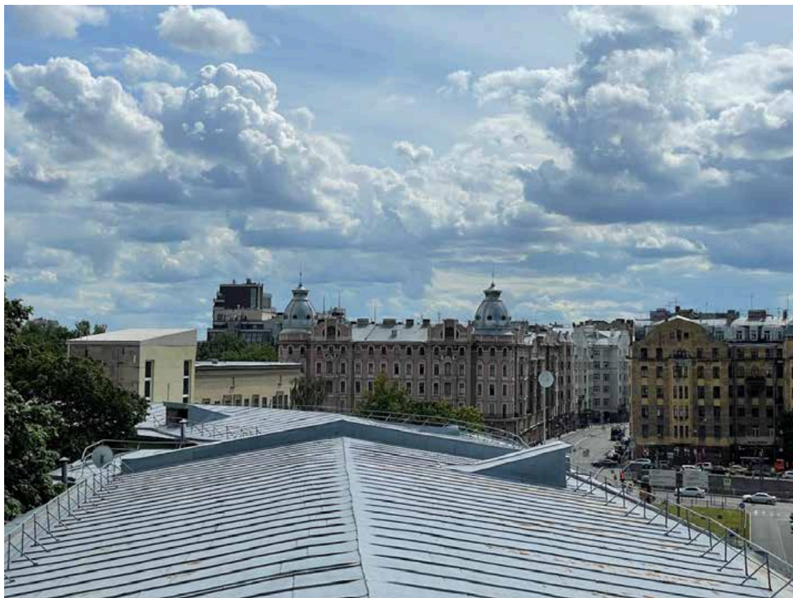
77. Вид на кровлю здания
