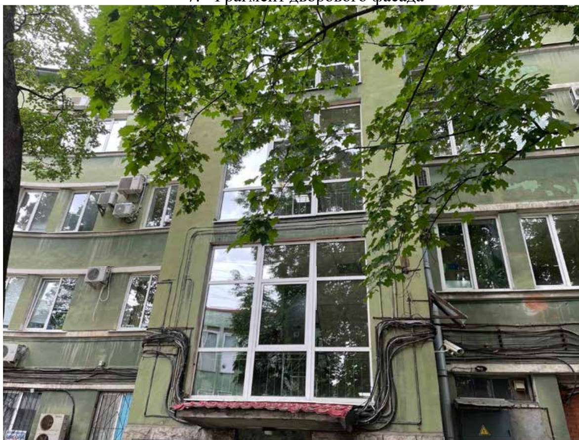
8. Фрагмент дворового фасада
