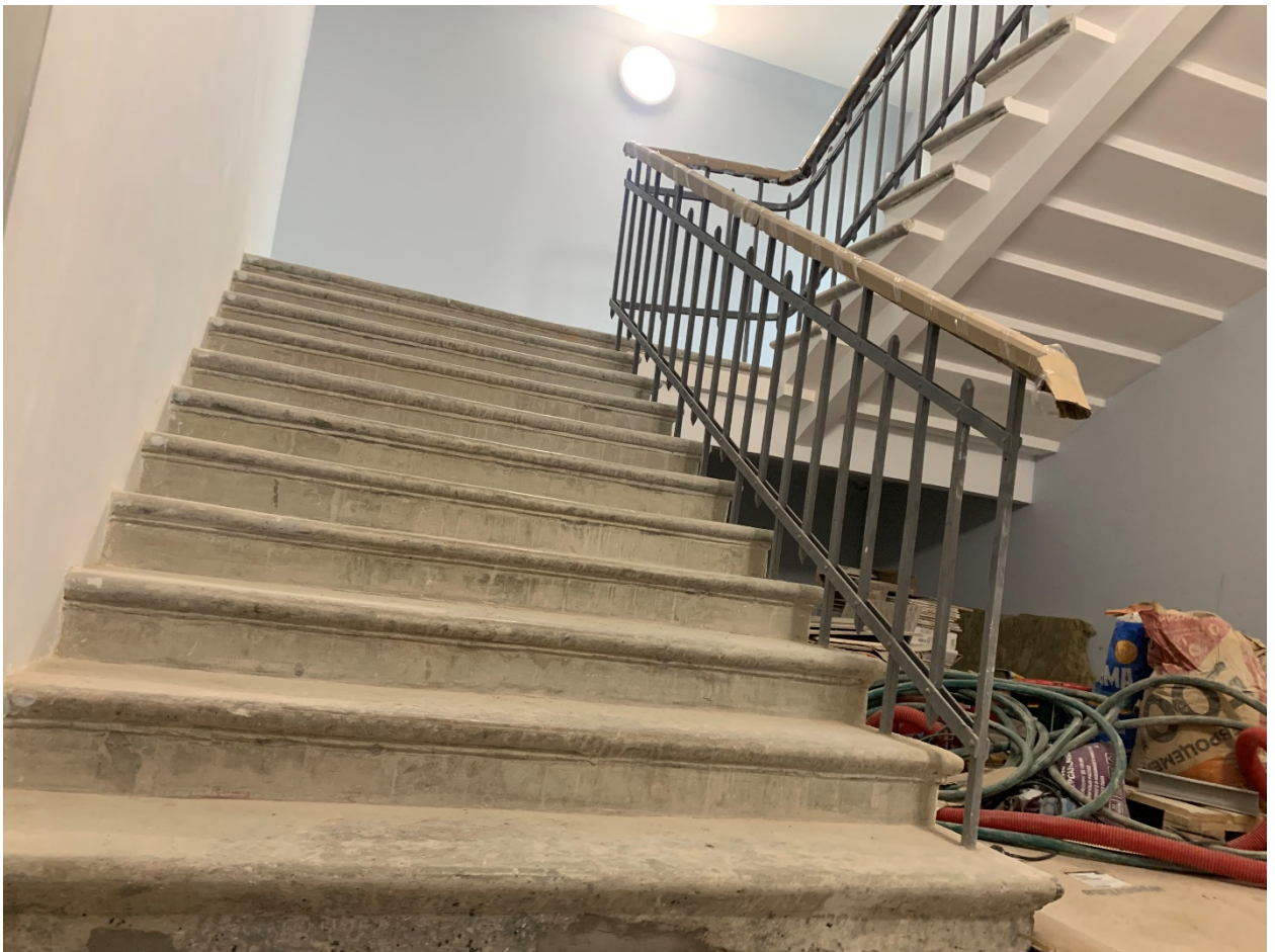
12. Лестничная клетка (пом. №37) в уровне 1-го этажа объекта культурного наследия регионального значения «Дом, где в 1917 г. начал работу VI съезд РСДРП(б)», расположенного по адресу: г. Санкт-Петербург, Большой Сампсониевский пр., д. 37, литера А. 12.04.2022
