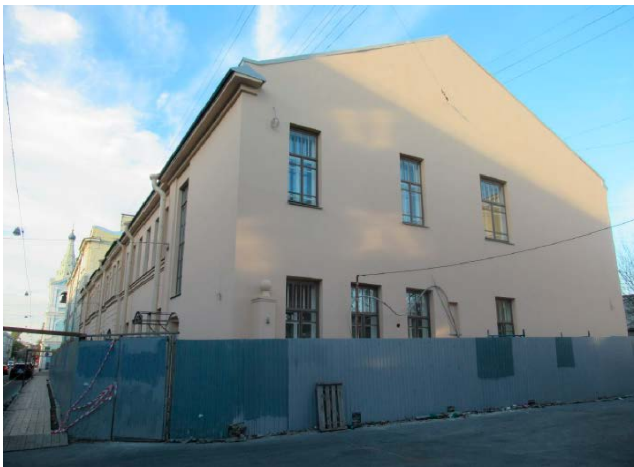
3. Юго-восточный лицевой фасад объекта культурного наследия регионального значения «Дом, где в 1917 г. начал работу VI съезд РСДРП(б)», расположенного по адресу: г. Санкт-Петербург, Большой Сампсониевский пр., д. 37, литера А. 12.04.2022
