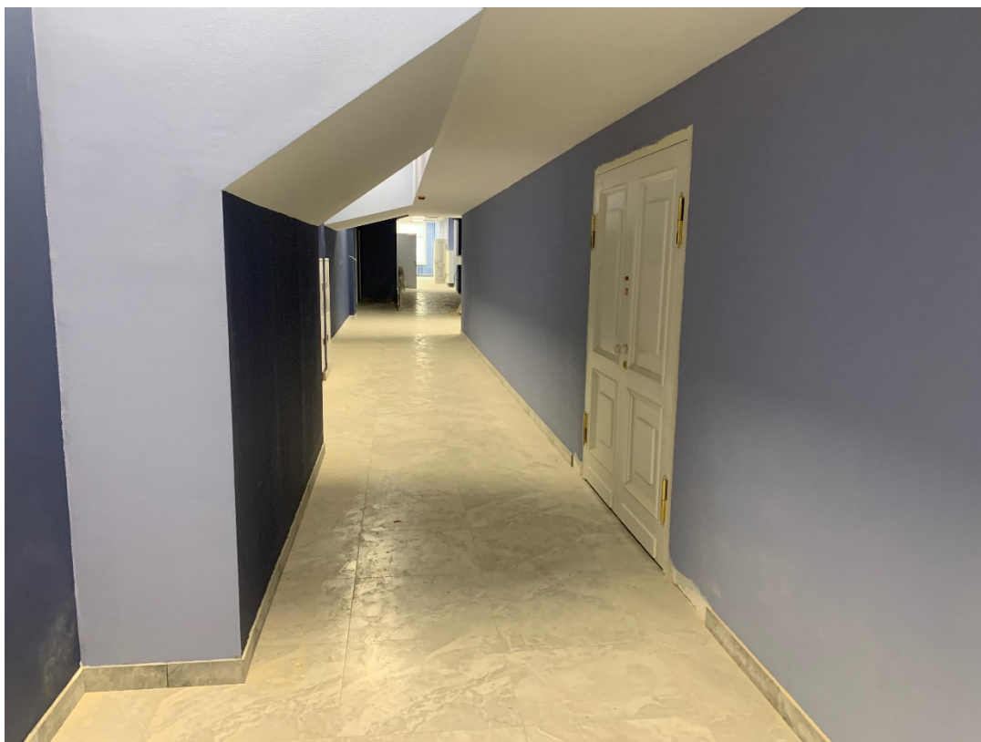
20. Коридор в уровне мансардного этажа объекта культурного наследия регионального значения «Дом, где в 1917 г. начал работу VI съезд РСДРП(б)», расположенного по адресу: г. Санкт-Петербург, Большой Сампсониевский пр., д. 37, литера А. 12.04.2022
