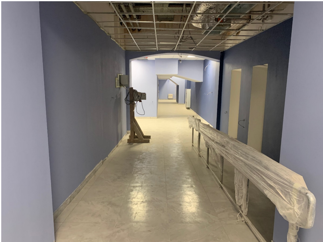
18. Коридор в уровне мансардного этажа объекта культурного наследия регионального значения «Дом, где в 1917 г. начал работу VI съезд РСДРП(б)», расположенного по адресу: г. Санкт-Петербург, Большой Сампсониевский пр., д. 37, литера А. 12.04.2022
