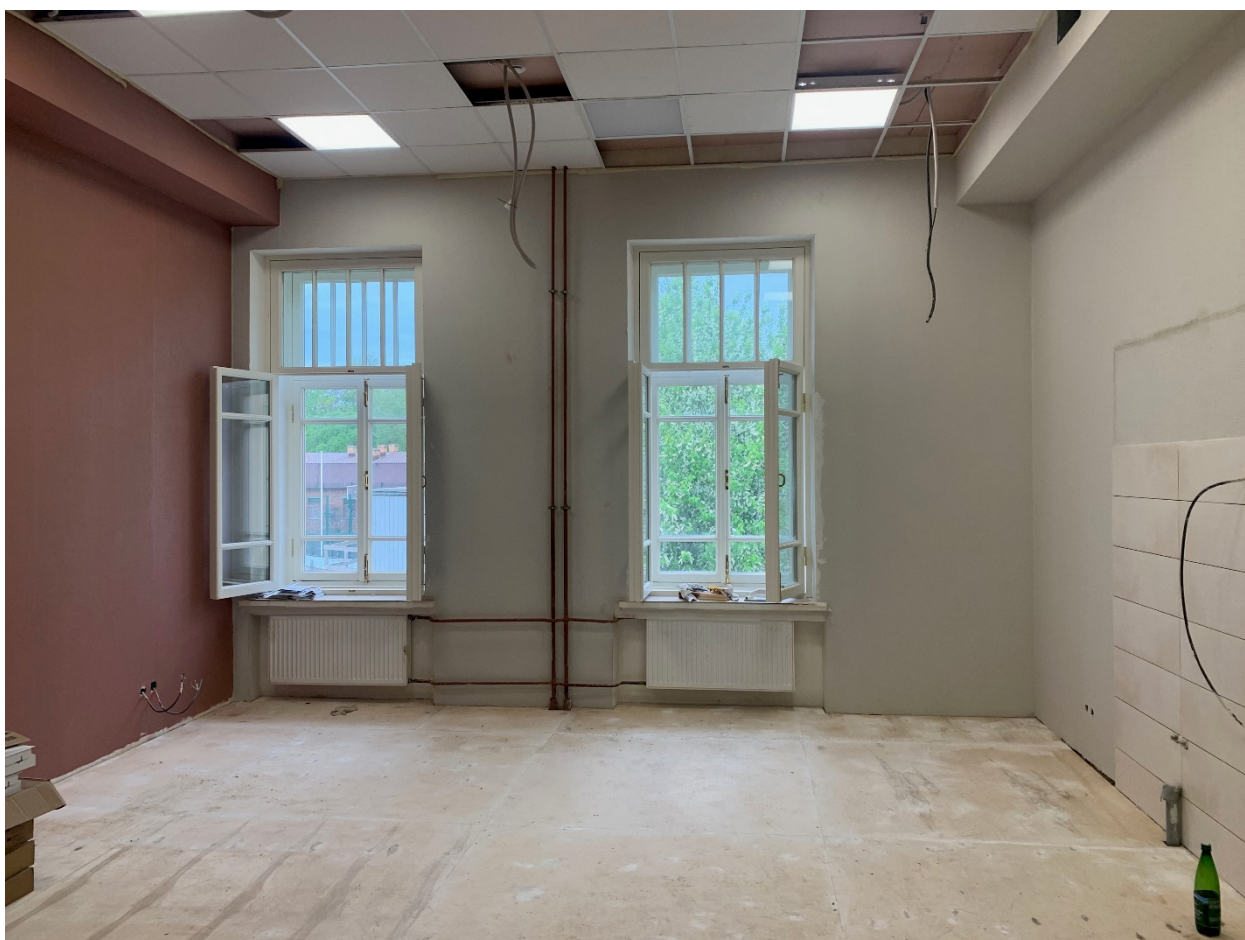
14. Помещения №№53-54 в уровне 2-го этажа объекта культурного наследия регионального значения «Дом, где в 1917 г. начал работу VI съезд РСДРП(б)», расположенного по адресу: г. Санкт-Петербург, Большой Сампсониевский пр., д. 37, литера А. 12.04.2022
