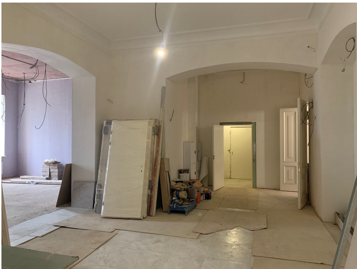
8. Помещения №9 и №12 в уровне 1-го этажа объекта культурного наследия регионального значения «Дом, где в 1917 г. начал работу VI съезд РСДРП(б)», расположенного по адресу: г. Санкт-Петербург, Большой Сампсониевский пр., д. 37, литера А. 12.04.2022
