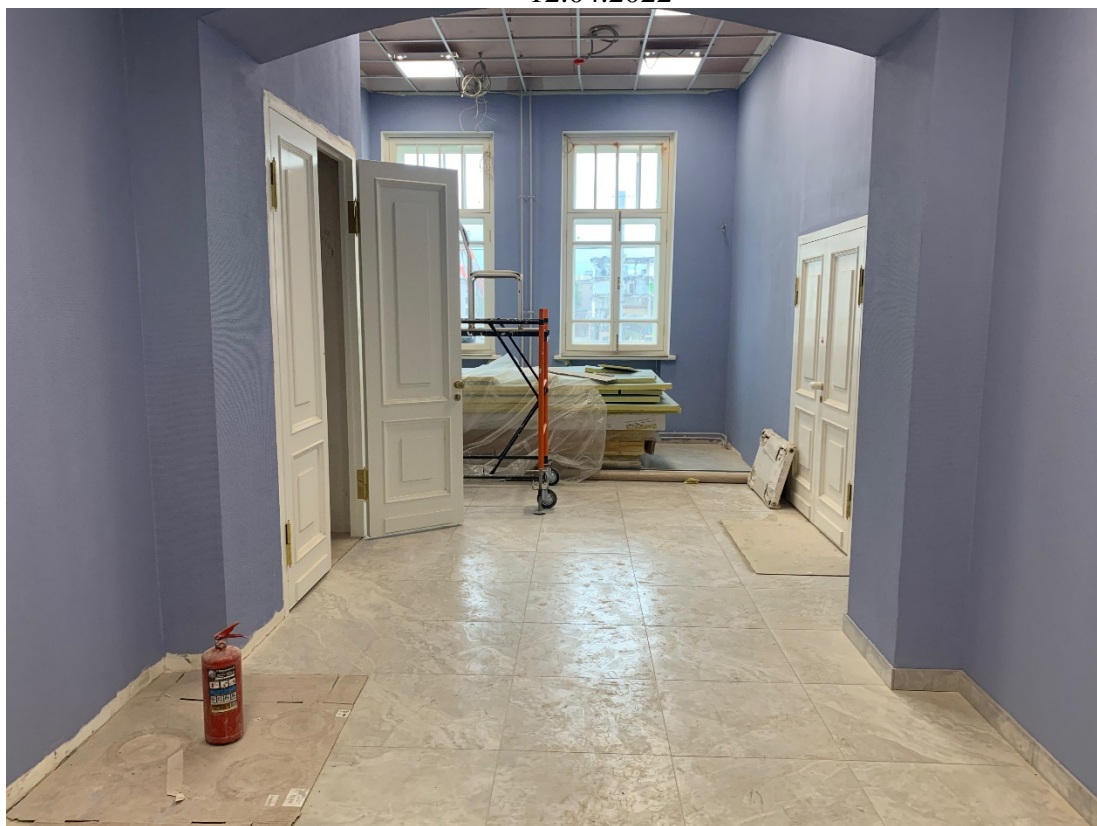
19. Коридор в уровне мансардного этажа объекта культурного наследия регионального значения «Дом, где в 1917 г. начал работу VI съезд РСДРП(б)», расположенного по адресу: г. Санкт-Петербург, Большой Сампсониевский пр., д. 37, литера А. 12.04.2022
