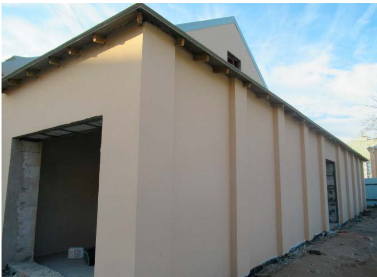
б. Северо-восточный торцевой дворовый фасад объекта культурного наследия регионального значения «Дом, где в 1917 г. начал работу VI съезд РСДРП(б)», расположенного по адресу: г. Санкт-Петербург, Большой Сампсониевский пр., д. 37, литера А. 12.04.2022
