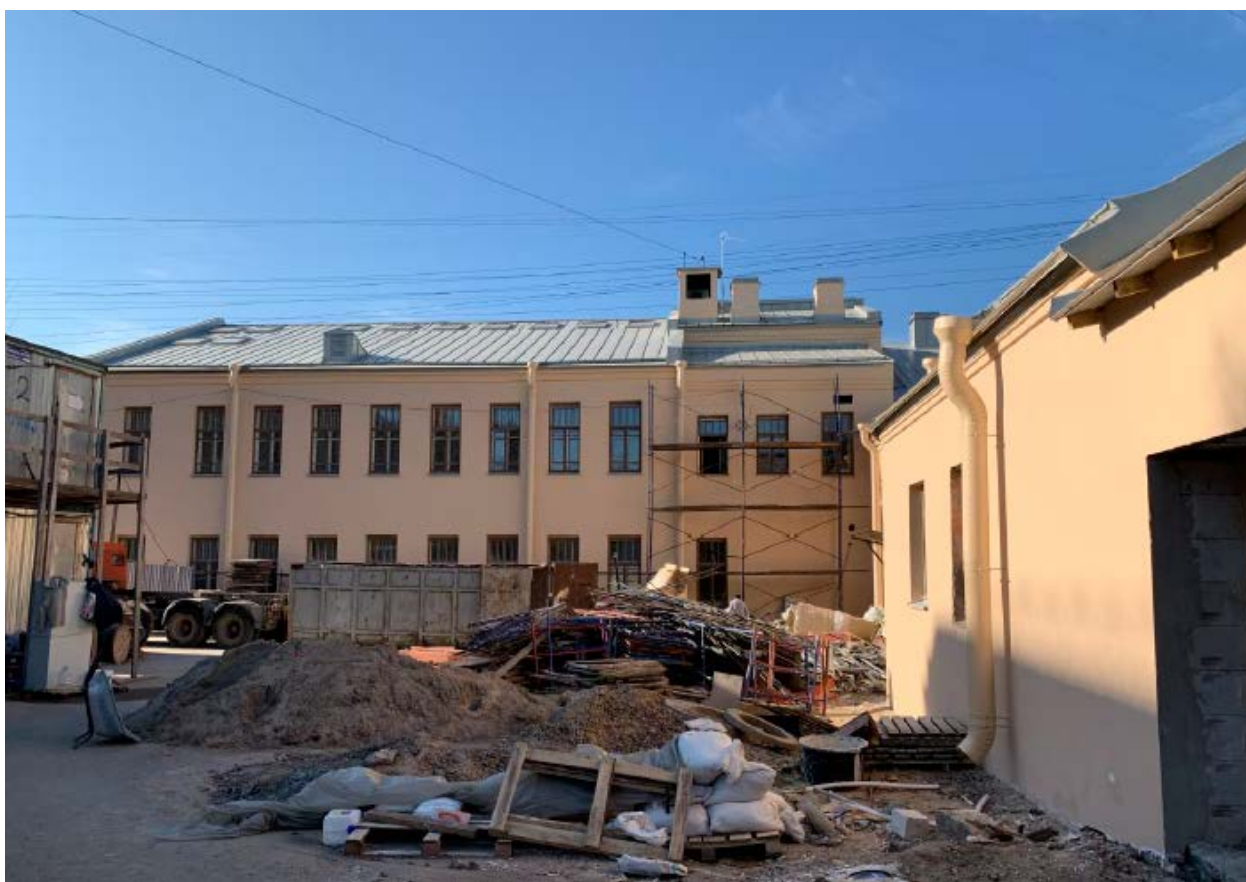
5. Северо-восточный дворовый фасад объекта культурного наследия регионального значения «Дом, где в 1917 г. начал работу VI съезд РСДРП(б)», расположенного по адресу: г. Санкт-Петербург, Большой Сампсониевский пр., д. 37, литера А. 12.04.2022
