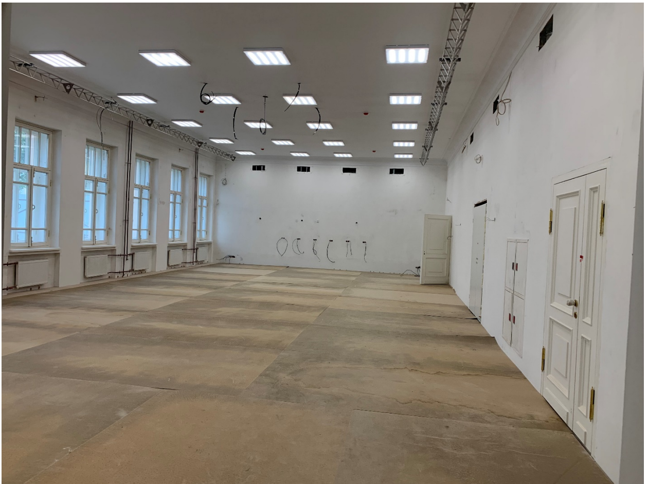
10. Помещение №3 в уровне 1-го этажа объекта культурного наследия регионального значения «Дом, где в 1917 г. начал работу VI съезд РСДРП(б)», расположенного по адресу: г. Санкт-Петербург, Большой Сампсониевский пр., д. 37, литера А. 12.04.2022
