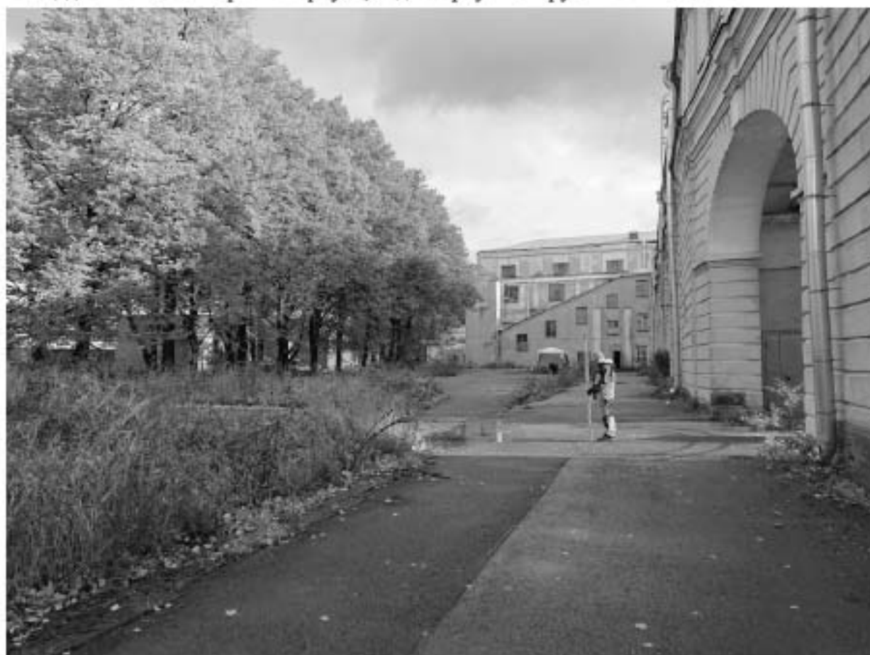
Ил. 42. г. Санкт-Петербург, Большой пр. П.С., д. 1а. Точка фотофиксации 5. Внутридворовый проезд. Восточная половина. Вид с 3.
