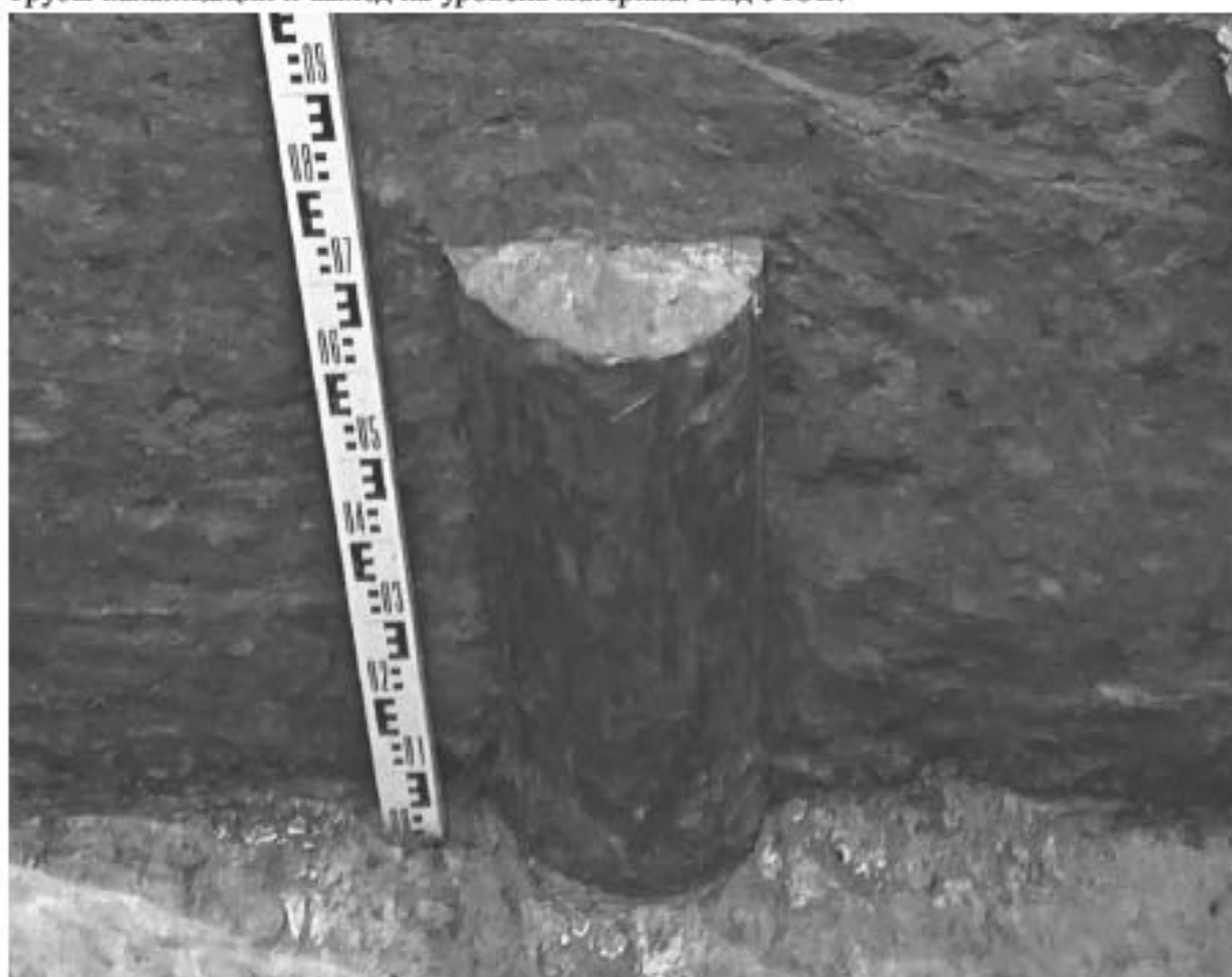
Ил. 68. г. Санкт-Петербург, Большой пр. П.С., д. 1а. Археологическая разведка. Шурф 2. Свая, заглубленная в материк. Вид с СЗ.
