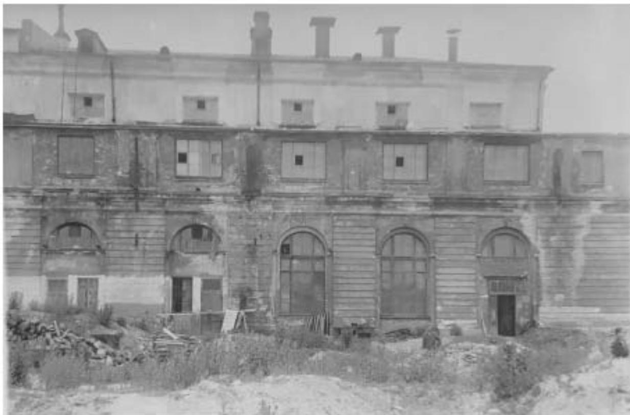
Ил. 21. Фрагмент галереи левого (восточного) корпуса со стороны двора. На переднем плане - разборка после взрыва шофного корпуса. Фото в ходе ремонта нач. 1930-х гг. Архив КГИОП.
