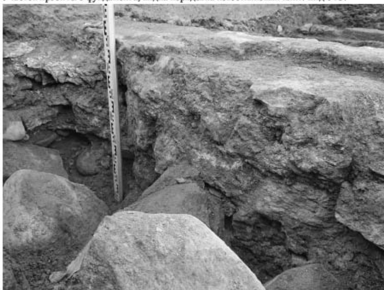
Ил. 161. г. Санкт-Петербург, Большой пр. П.С., д. 1а. Археологическая разведка. Шурф 7. Участок пробитого фундамента, видна порядовка известняковых плит. Крупный план. Вид с Ю.
