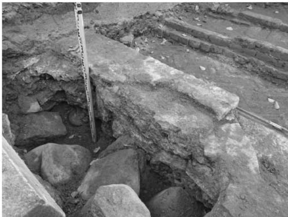
Ил. 160. г. Санкт-Петербург, Большой пр. П.С., д. 1а. Археологическая разведка. Шурф 7. Участок пробитого фундамента, видна порядовка известняковых плит. Вид с Ю.
