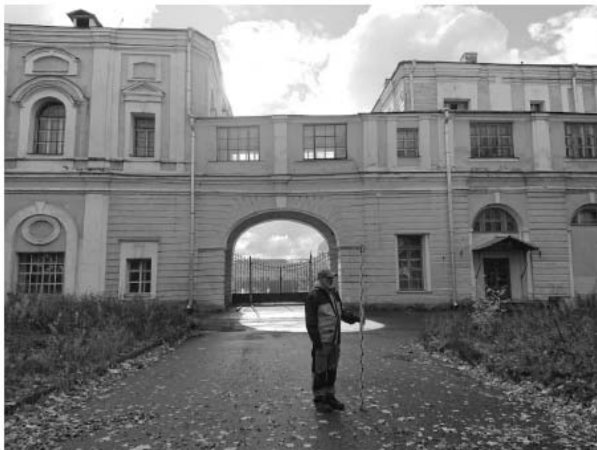
Ил. 41. г. Санкт-Петербург, Большой пр. П.С., д. 1а. Точка фотофиксации 4. Открытая площадка на месте шофного корпуса, вид на арку к северу от важни с ССВ.
