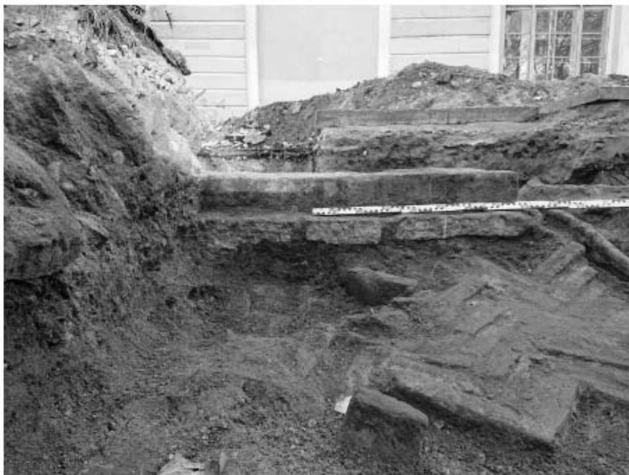
Ил. 166. г. Санкт-Петербург, Большой пр. П.С., д. 1а. Археологическая разведка. Шурф 7. СВ фасад фундамента и примыкание кирпичного пола, ЮВ часть. Вид с СВ.
