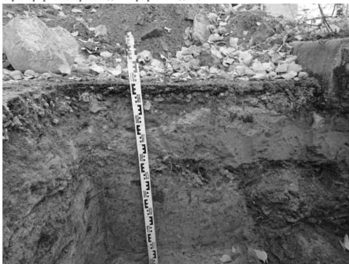
Ил. 147. г. Санкт-Петербург, Большой пр. П.С., д. 1а. Археологическая разведка. Шурф 6. Стратиграфия. Фрагмент СЗ профиля, юго-западная часть, граница фундаментного рва. Вид с ЮВ.
