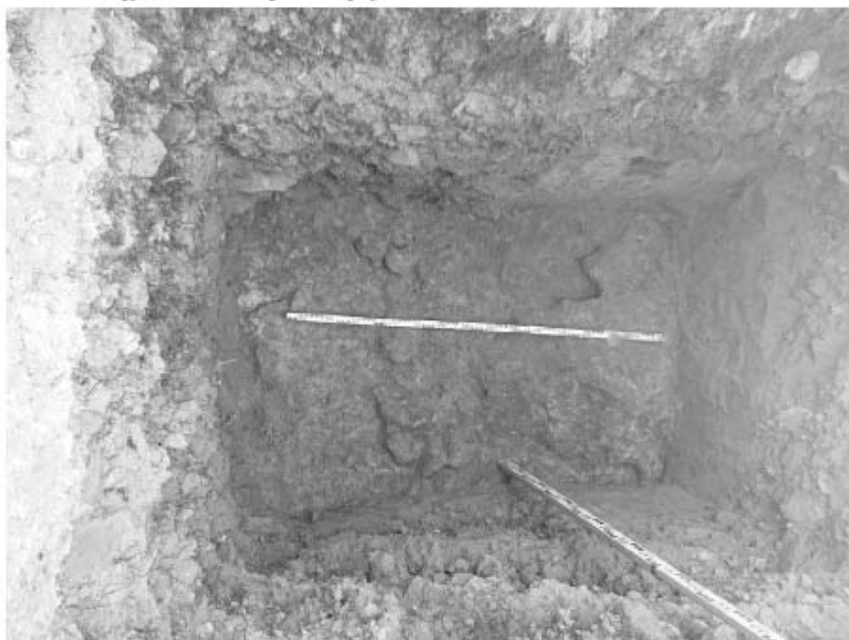
Ил. 103. г. Санкт-Петербург, Большой пр. П.С., д. 1а. Археологическая разведка. Шурф 4. СВ часть шурфа. Фундамент шофного корпуса: пролитый известково-песчаный раствор и известняковые плиты. Вид с СВ, сверху.
