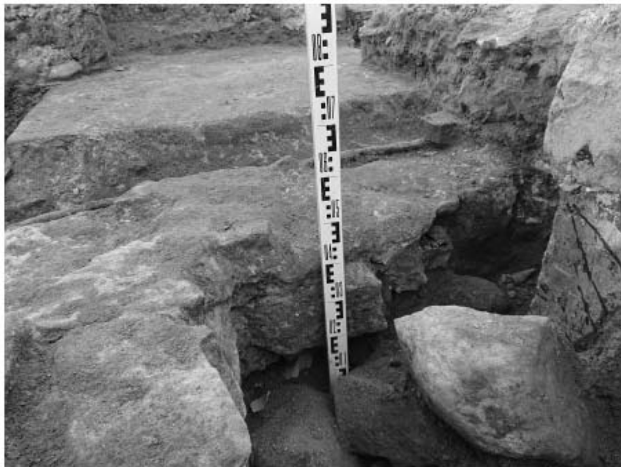
Ил. 162. г. Санкт-Петербург, Большой пр. П.С., д. 1а. Археологическая разведка. Шурф 7. Участок пробитого фундамента, видна порядовка известняковых плит. Вид с СЗ.
