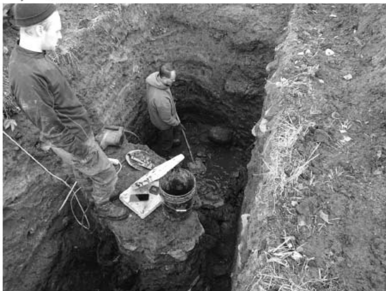
Ил. 86. г. Санкт-Петербург, Большой пр. П.С., д. 1а. Археологическая разведка. Шурф 3. Выборка слоя на этапе выхода грунтовых вод. Рабочий момент. Вид с ССЗ.
