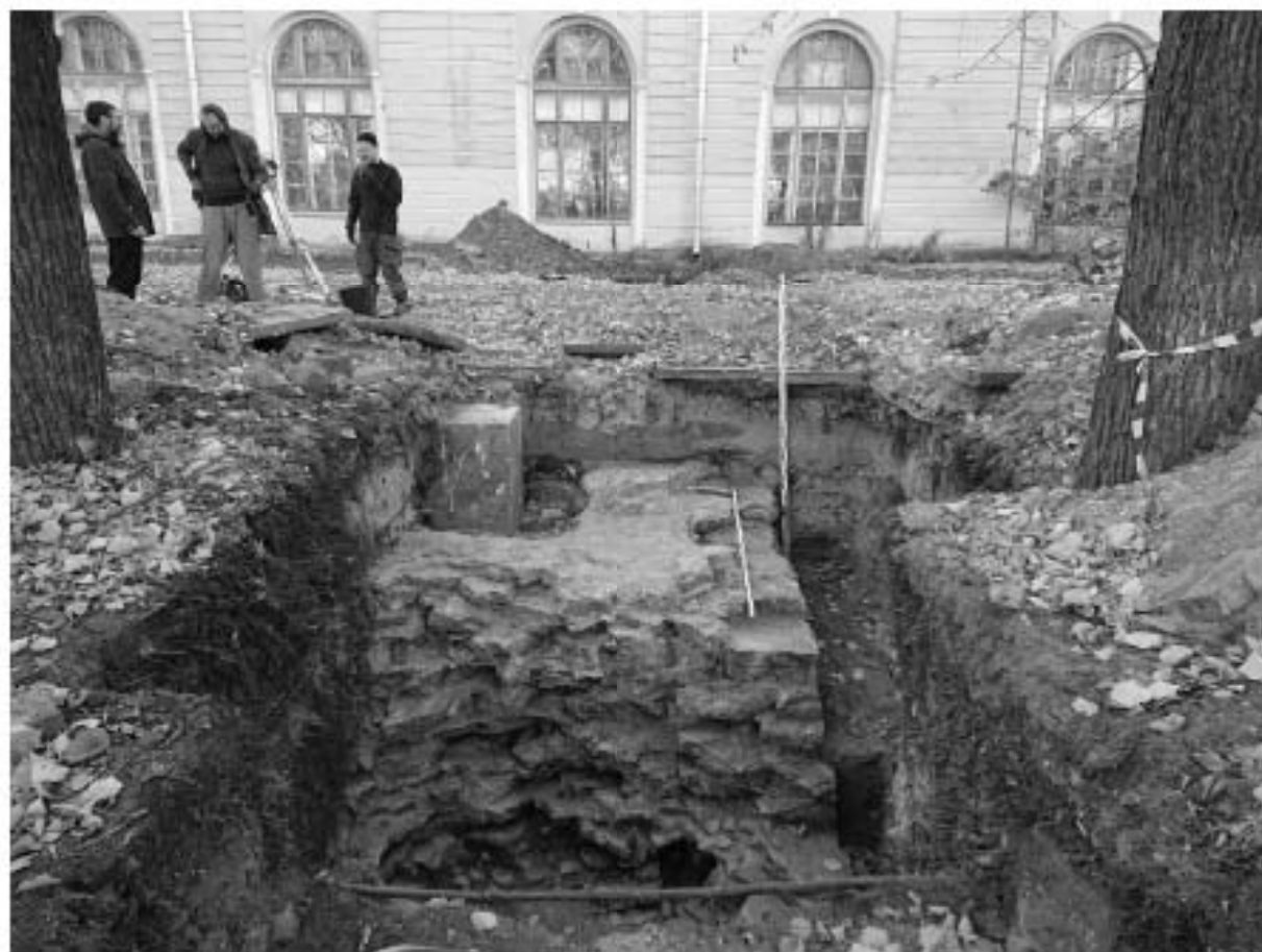
Ил. 101. г. Санкт-Петербург, Большой пр. П.С., д. 1а. Археологическая разведка. Шурф 4. Общий вид фундамента шифрного корпуса с СВ.
