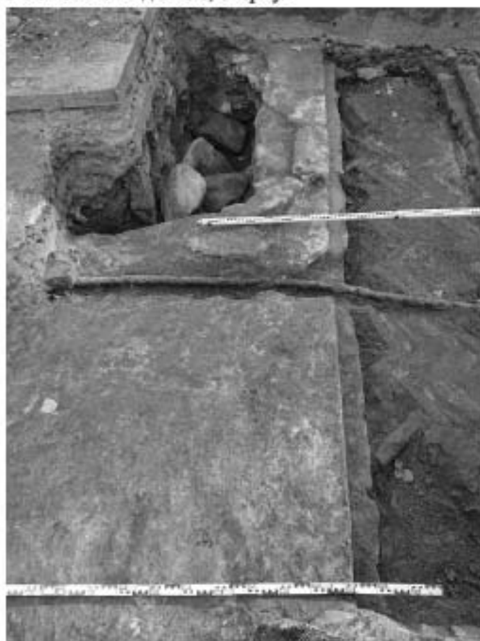
Ил. 164. г. Санкт-Петербург, Большой пр. П.С., д. 1а. Археологическая разведка. Шурф 7. Уширение фундамента с внешней стороны, граница фундаментной траншеи и магериковые отложения. Вид с ЮЗ, сверху.
