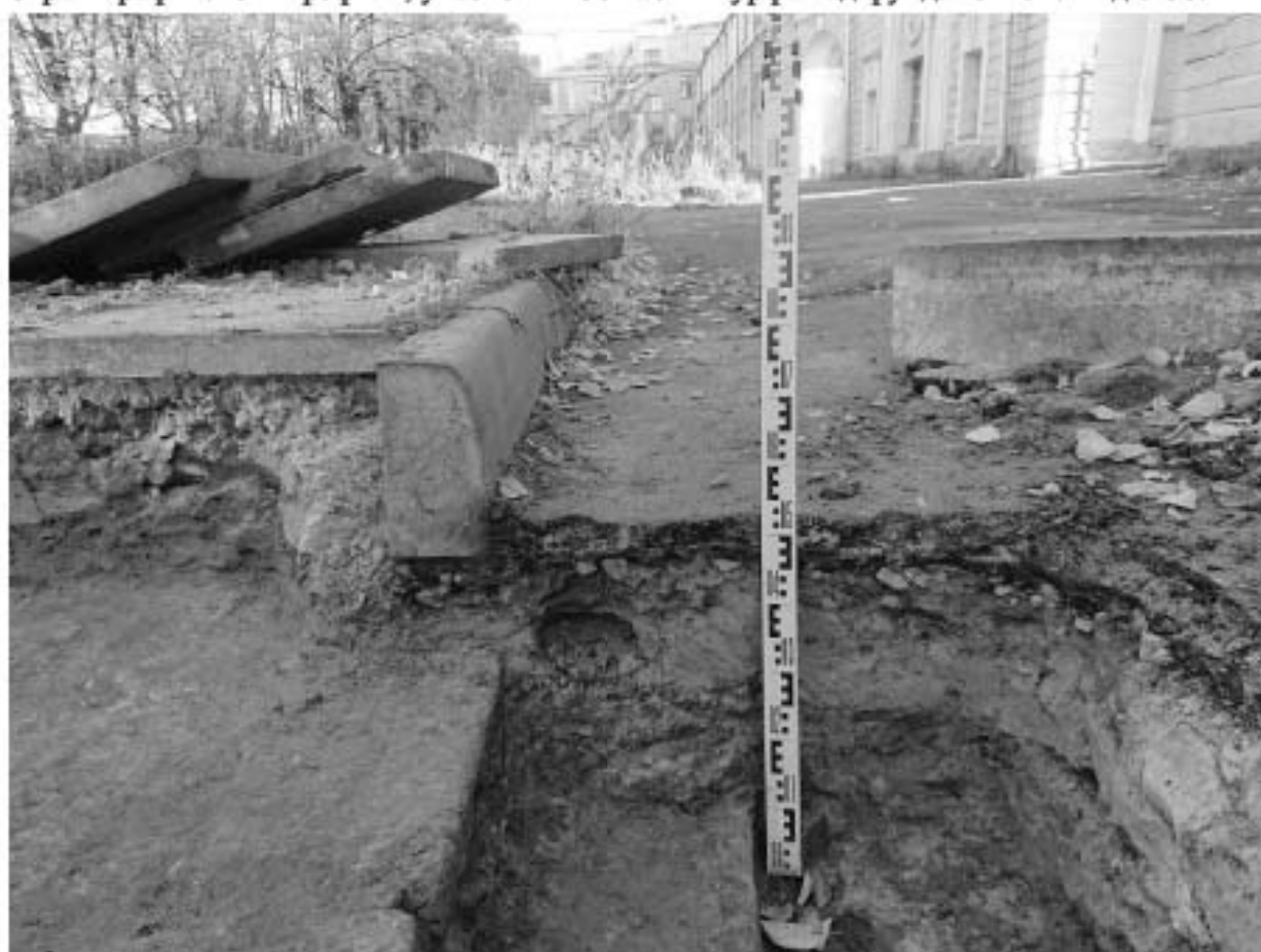
Ил. 179. г. Санкт-Петербург, Большой пр. П.С., д. 1а. Археологическая разведка. Шурф 7. Стратиграфия. ЮВ профиль, участок в ЮЗ части шурфа: разрез кладки фундамента и материковые отложения. Вид с СЗ.
