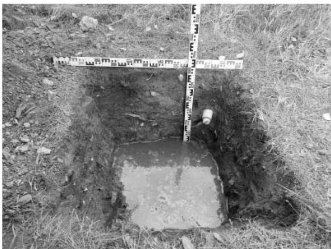
Рис. 20. Земельный участок с кадастровым номером 78:12:0712602:5, расположенный по адресу: г. Санкт-Петербург, Железнодорожный проспект, участок 1. Шурф № 1. Направление съемки север.
