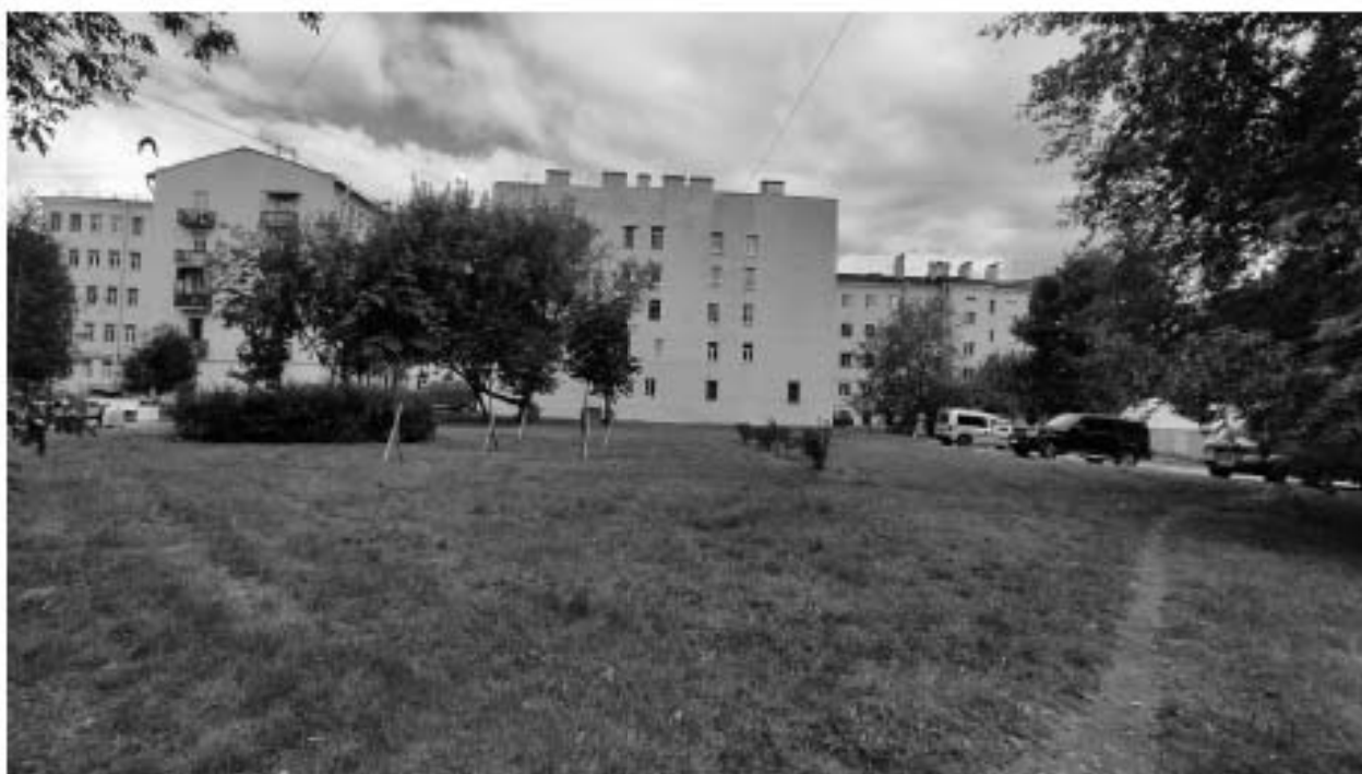
Илл. 6. Санкт-Петербург, Воронежская ул., уч. 45. Общий вид на западную часть участка с юго-запада.
