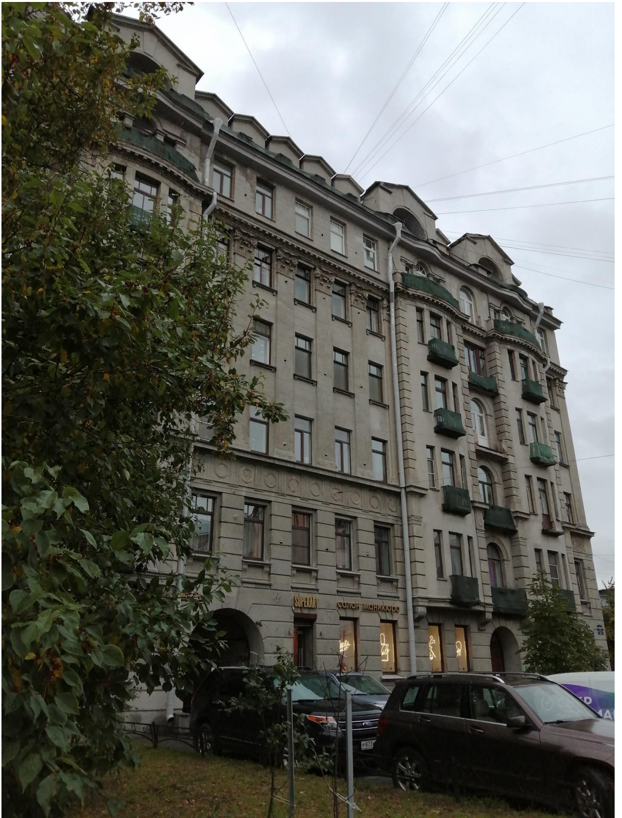
Фото 2 (экстерьер). Выявленный объект культурного наследия «Дом Ф.П. Петрова (Д.Г. Лурье)», расположенный по адресу: Санкт-Петербург, ул.Пионерская, дом 22, литера А. Северо-восточный лицевой фасад: архитектурно-художественное решение в стилистике неоклассицизма.
