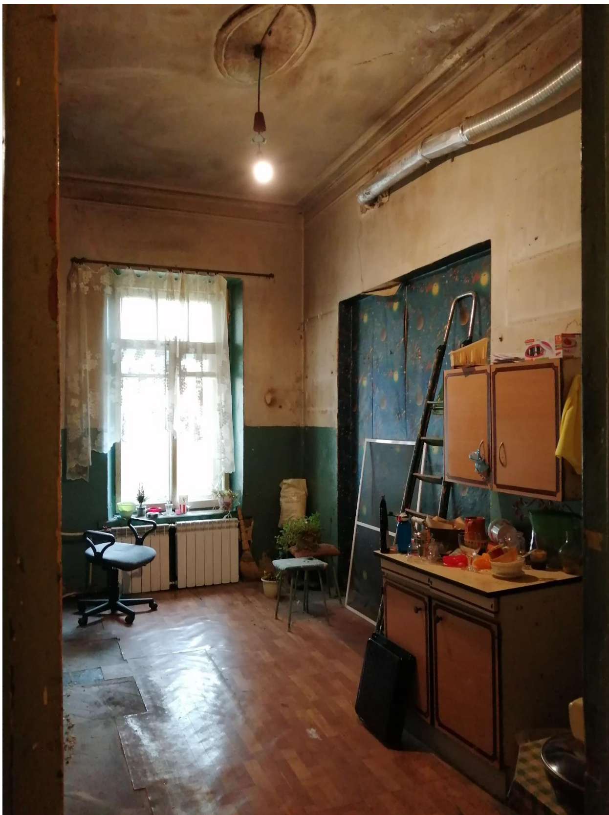
Фото 20. Выявленный объект культурного наследия «Дом Ф.П. Петрова (Д.Г. Лурье), расположенный по адресу: Санкт-Петербург, ул.Пионерская, дом 22, литера А. Квартира 4, помещение 1.
