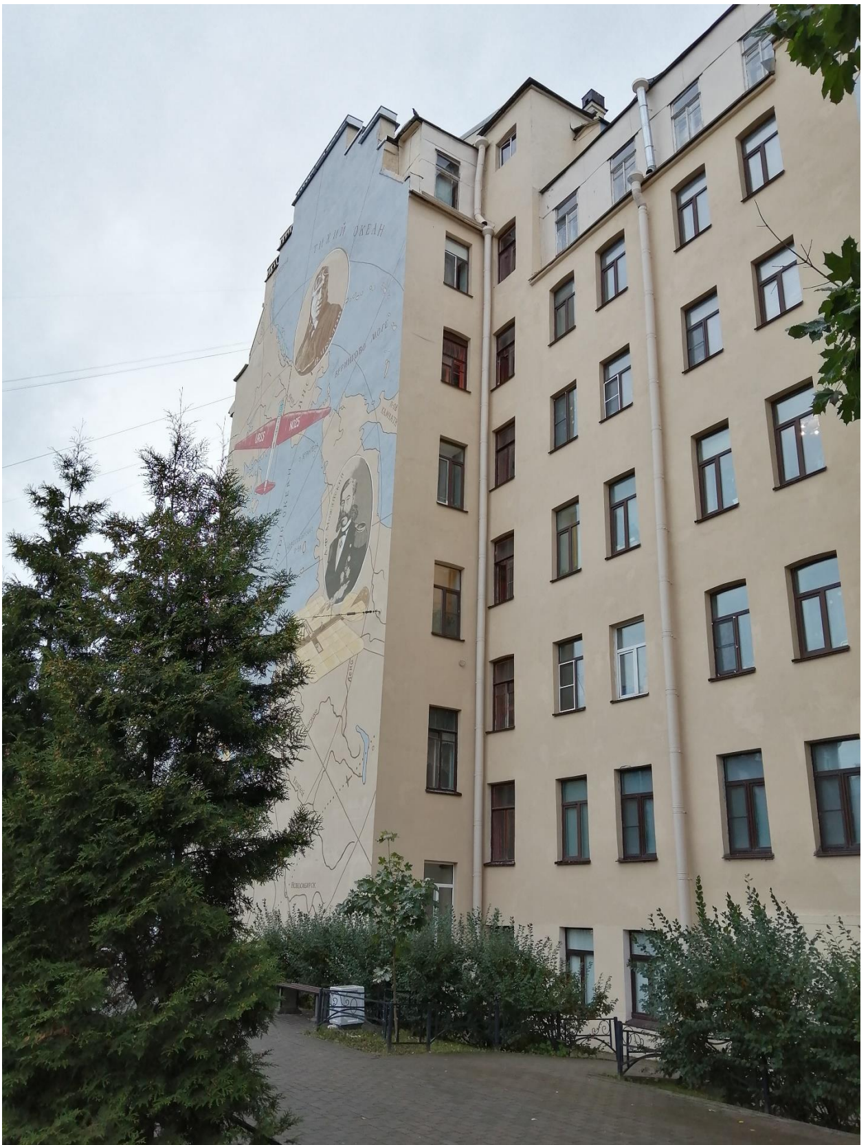
Фото 4 (экстерьер). Выявленный объект культурного наследия «Дом Ф.П. Петрова (Д.Г. Лурье)», расположенный по адресу: Санкт-Петербург, ул.Пионерская, дом 22, литера А. Брандмаурные глухие оштукатуренные стены северо-западного фасада, боковой северо-западный фасад.
