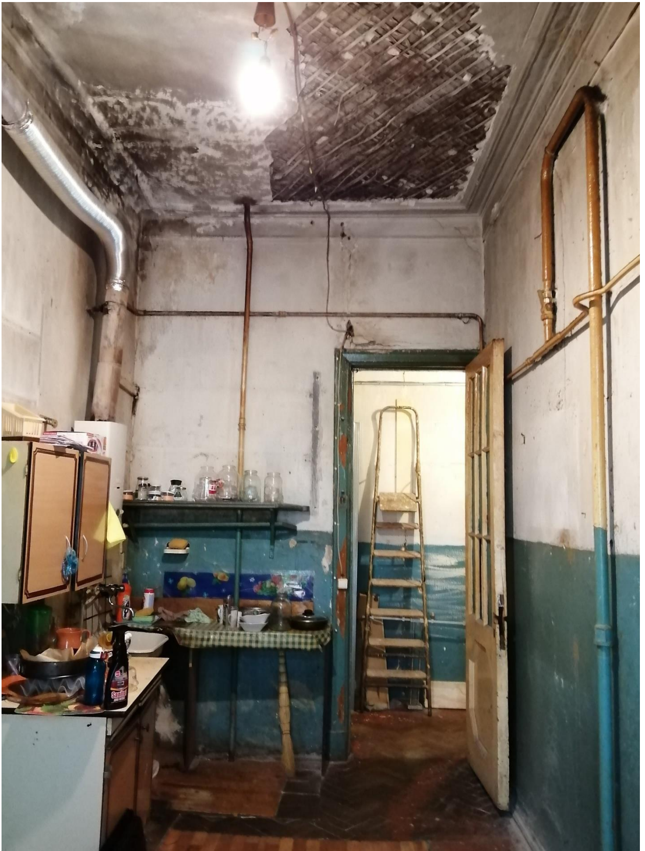
Фото 21. Выявленный объект культурного наследия «Дом Ф.П. Петрова (Д.Г. Лурье), расположенный по адресу: Санкт-Петербург, ул.Пионерская, дом 22, литера А. Квартира 4, помещение 1. Обрушение штукатурной отделки потолка.
