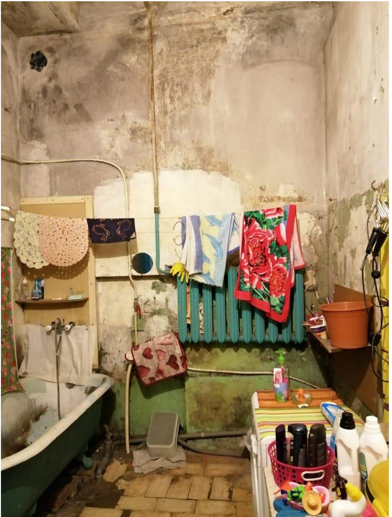
Фото 18. Выявленный объект культурного наследия «Дом Ф.П. Петрова (Д.Г. Лурье), расположенный по адресу: Санкт-Петербург, ул.Пионерская, дом 22, литера А. Квартира 4, помещение 6.
