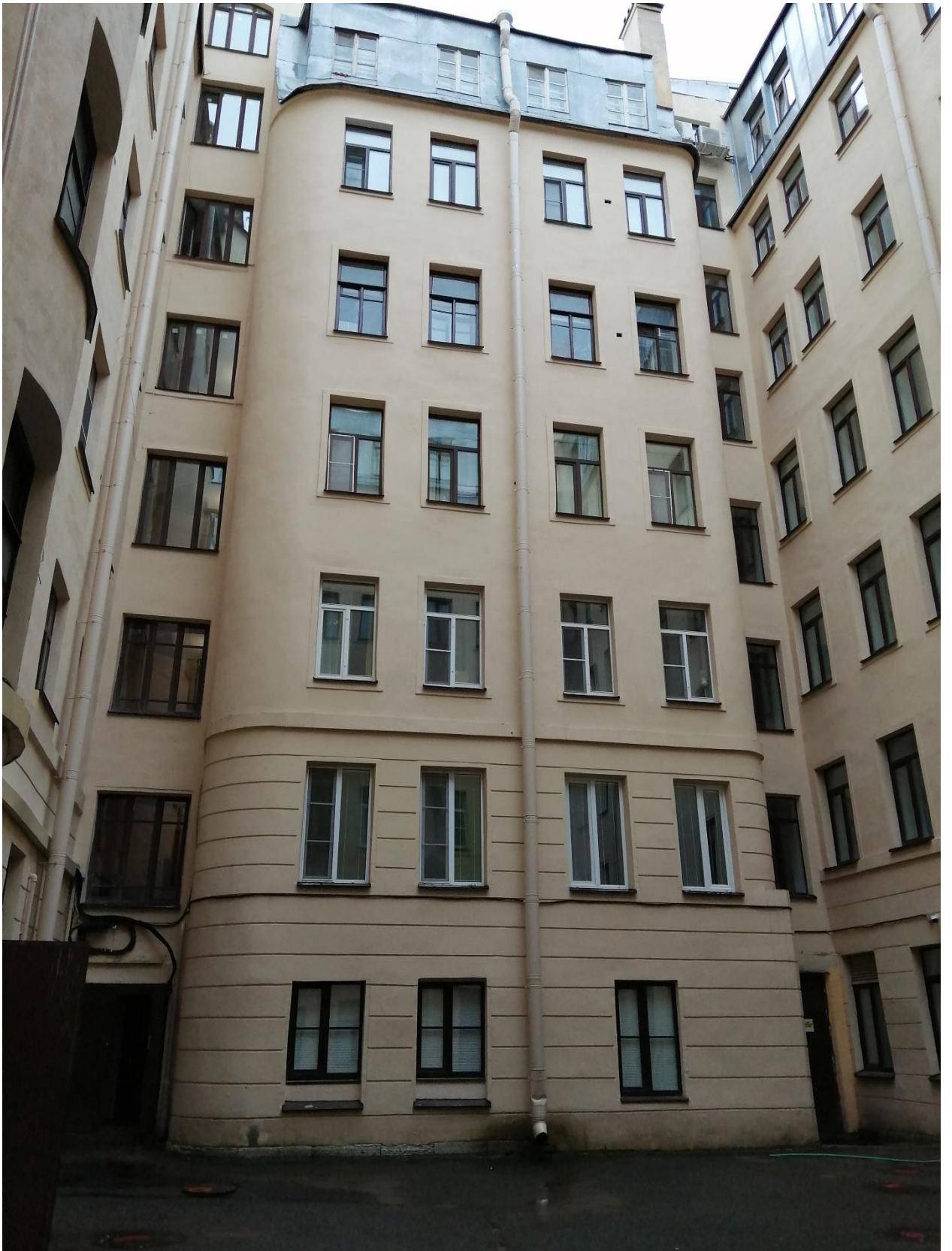
Фото 11. (экстерьер). Выявленный объект культурного наследия «Дом Ф.П. Петрова (Д.Г. Лурье)», расположенный по адресу: Санкт-Петербург, ул.Пионерская, дом 22, литера А. Внутренний замкнутый двор «колодец»: северо-западный дворовый фасад.
