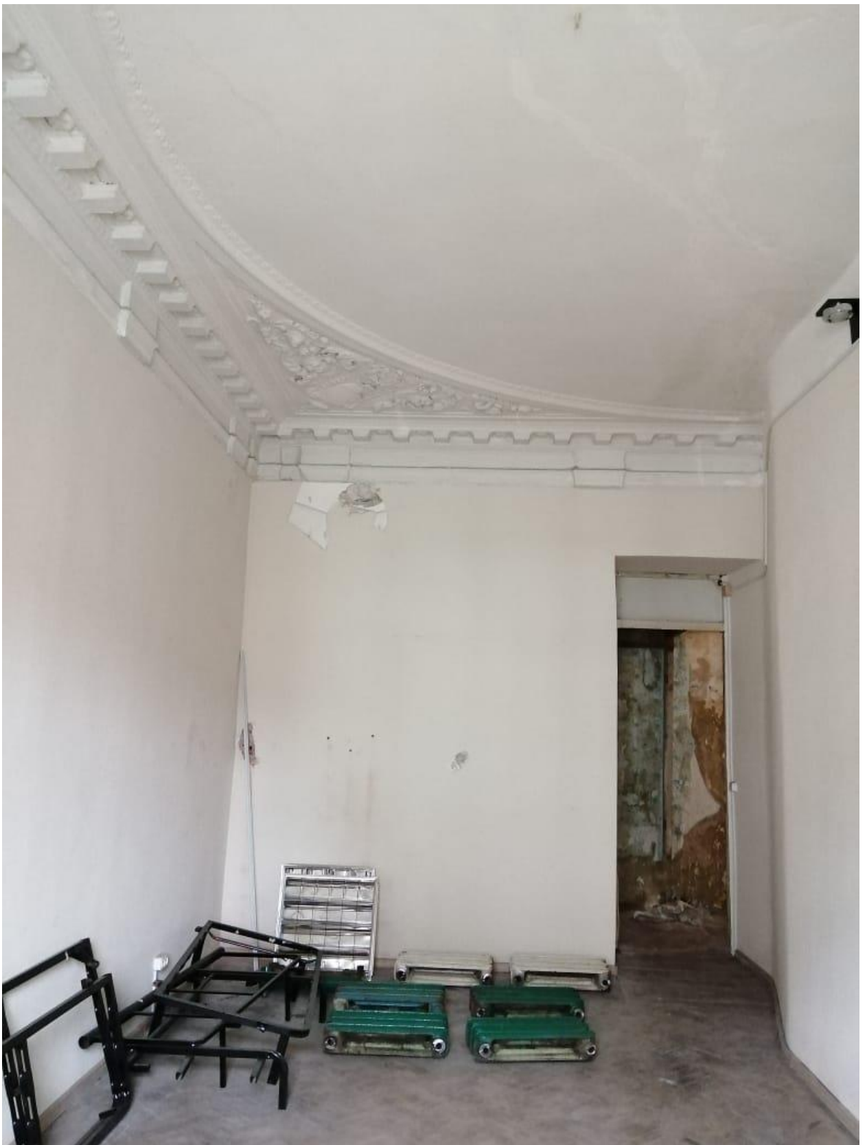
Фото 13. Выявленный объект культурного наследия «Дом Ф.П. Петрова (Д.Г. Лурье), расположенный по адресу: Санкт-Петербург, ул.Пионерская, дом 22, литера А. Квартира 4, помещение 9. Гладкий фриз с профилированной тягой в завершении стен, массивный профилированный карниз на модульонах между которыми расположены лепные цветковые розетки. Фрагмент.
