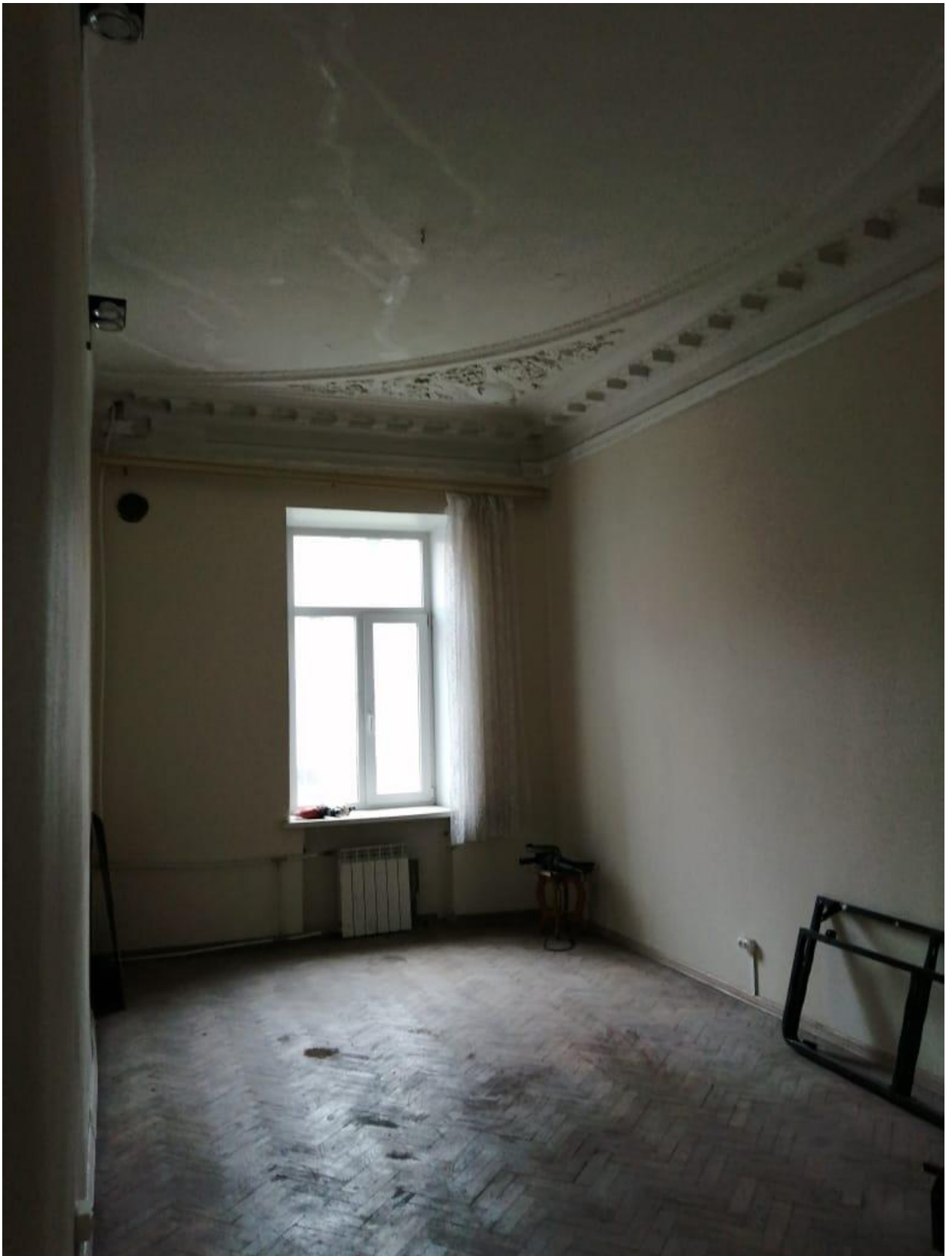
Фото12. Выявленный объект культурного наследия «Дом Ф.П. Петрова (Д.Г. Лурье), расположенный по адресу: Санкт-Петербург, ул.Пионерская, дом 22, литера А. Квартира 4, помещение 9. Гладкий фриз с профилированной тягой в завершении стен, массивный профилированный карниз на модульонах между которыми расположены лепные цветковые розетки.
