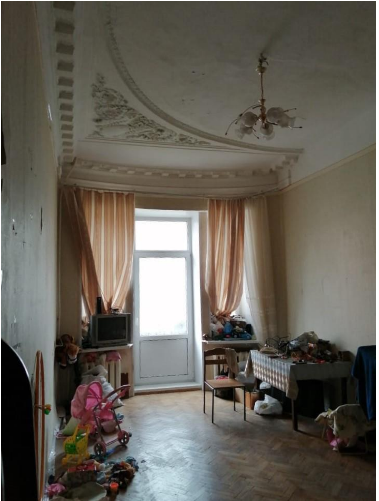
Фото10. Выявленный объект культурного наследия «Дом Ф.П. Петрова (Д.Г. Лурье), расположенный по адресу: Санкт-Петербург, ул.Пионерская, дом 22, литера А. Квартира 4, помещение 9. Гладкий фриз с профилированной тягой в завершении стен, массивный профилированный карниз на модульонах между которыми расположены лепные цветковые розетки.
