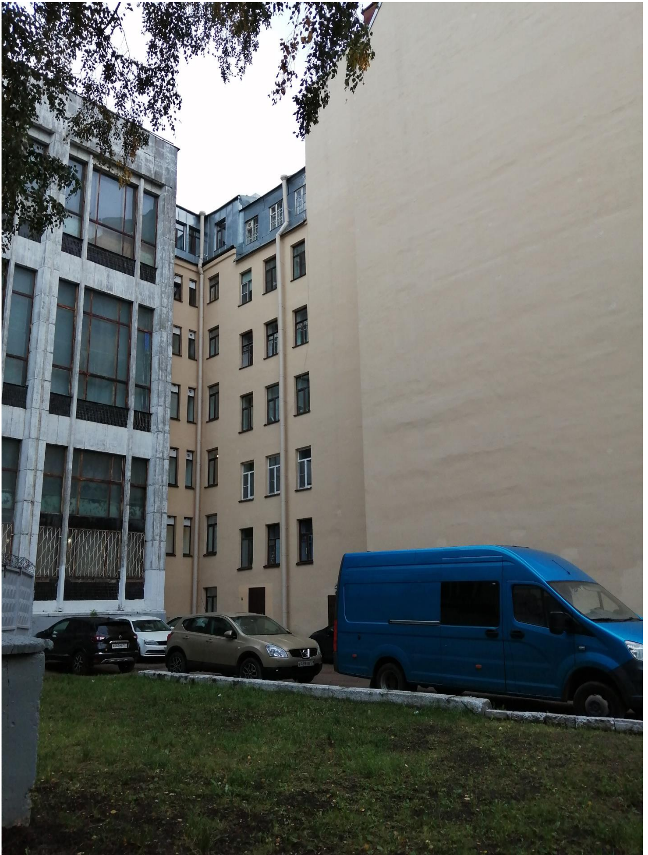
Фото 6 (экстерьер). Выявленный объект культурного наследия «Дом Ф.П. Петрова (Д.Г. Лурье)», расположенный по адресу: Санкт-Петербург, ул.Пионерская, дом 22, литера А. Брандмаурная глухая оштукатуренная стена юго-восточного фасада, боковой юго-восточный фасад. Материал и характер отделки фасадной поверхности - гладкая штукатурка.
