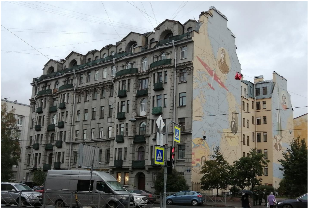
Фото 1 (экстерьер). Выявленный объект культурного наследия «Дом Ф.П. Петрова (Д.Г. Лурье), расположенный по адресу: Санкт-Петербург, ул.Пионерская, дом 22, литера А. Общий вид.
