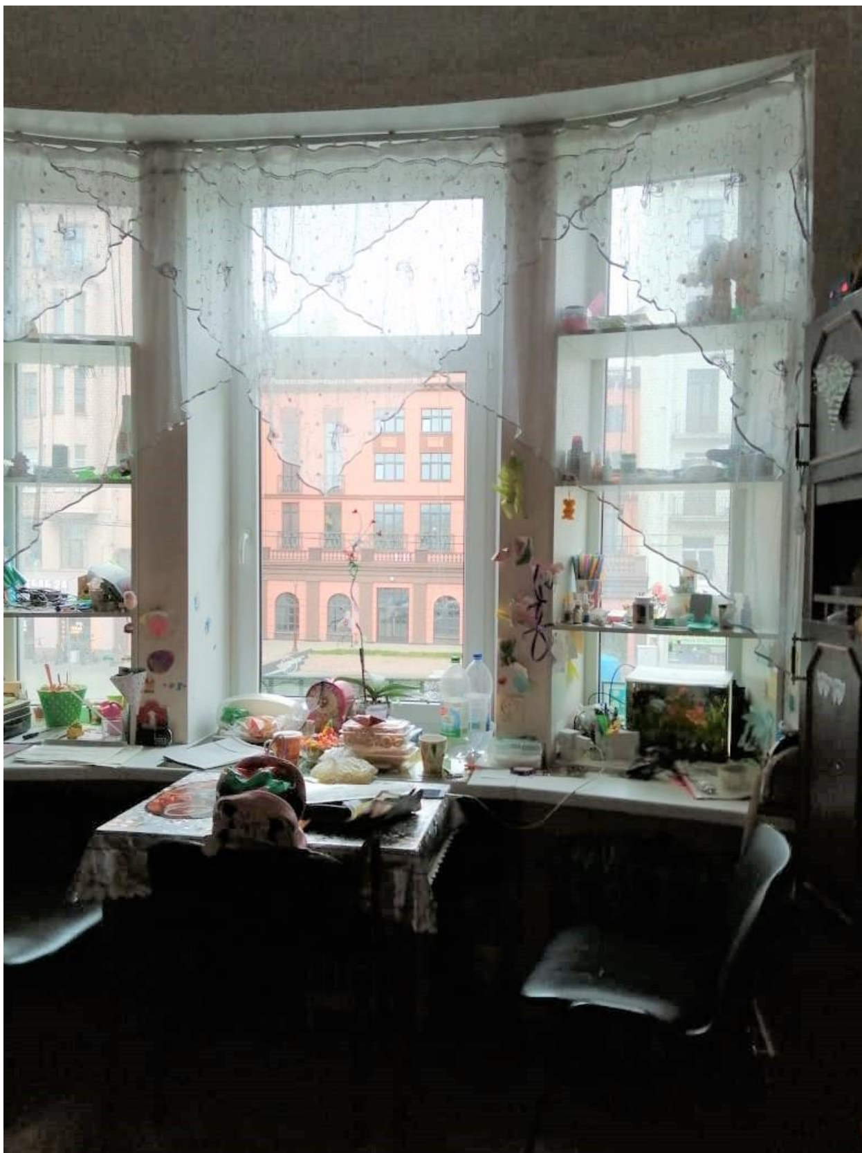
Фото 3. Выявленный объект культурного наследия «Дом Ф.П. Петрова (Д.Г. Лурье), расположенный по адресу: Санкт-Петербург, ул.Пионерская, дом 22, литера А. Квартира 4, помещение 7. Фрагмент 1.
