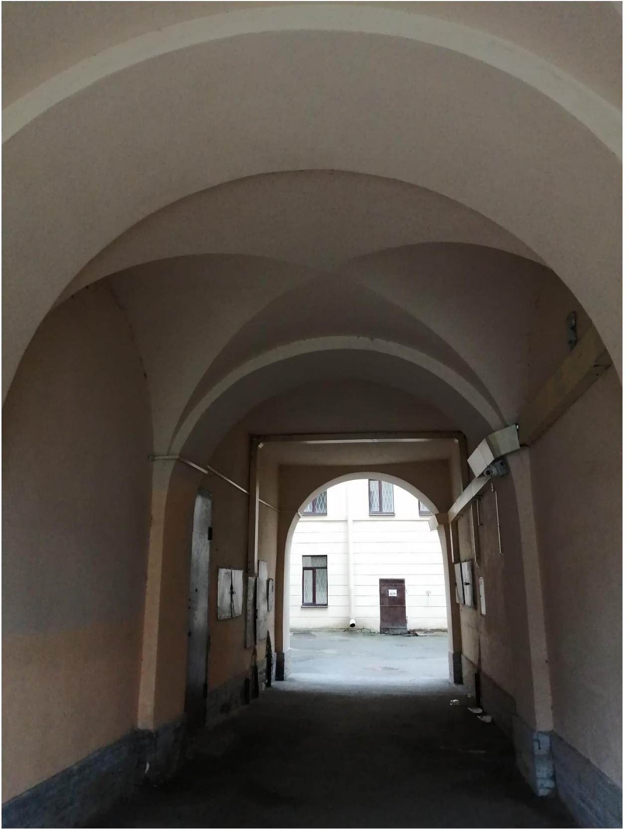
Фото 7 (экстерьер). Выявленный объект культурного наследия «Дом Ф.П. Петрова (Д.Г. Лурье)», расположенный по адресу: Санкт-Петербург, ул.Пионерская, дом 22, литера А. Система крестовых сводов на подпружных арках воротного проезда.
