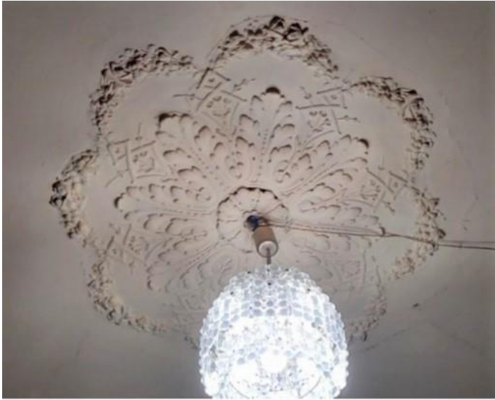
Фото 8. Выявленный объект культурного наследия «Дом Ф.П. Петрова (Д.Г. Лурье), расположенный по адресу: Санкт-Петербург, ул.Пионерская, дом 22, литера А. Квартира 4, помещение 8. Лепная «цветковая» розетка: в центре из листьев аканта, в обрамлении цветочных гирлянд.
