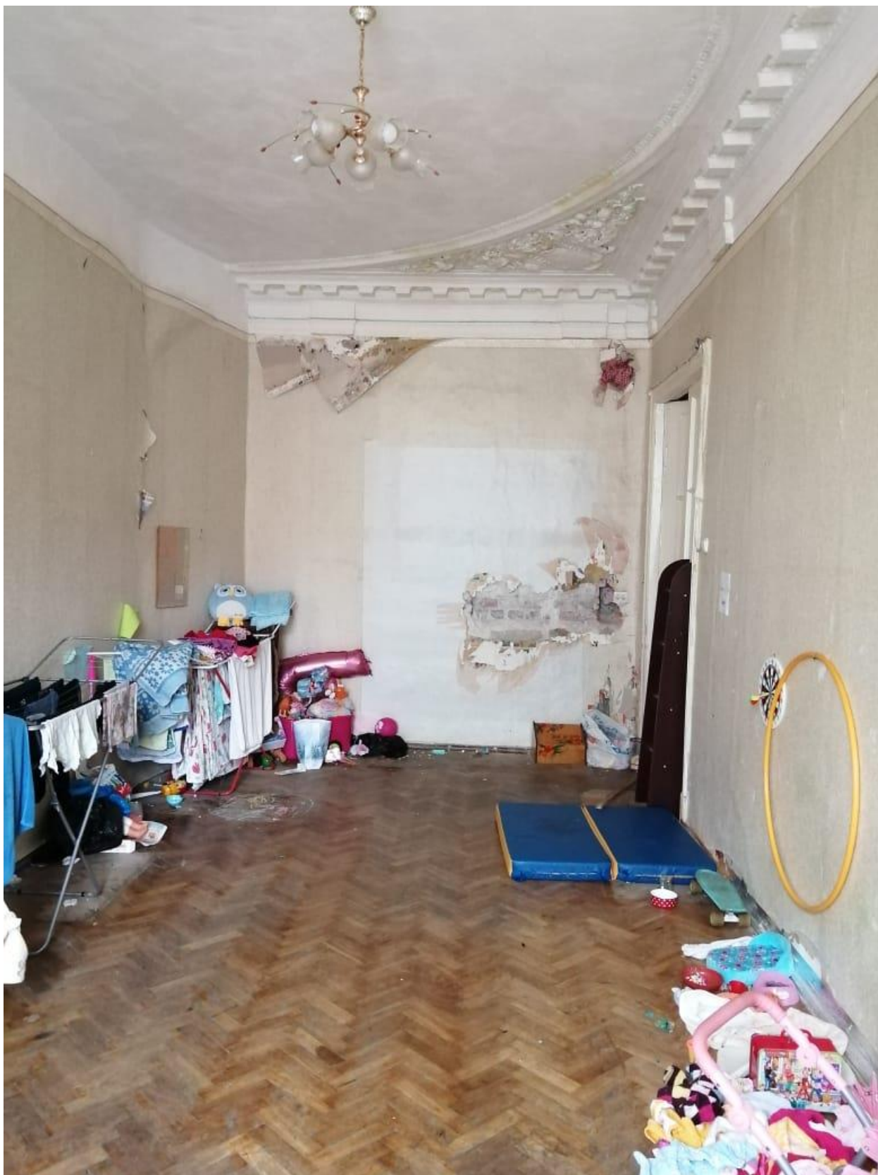
Фото11. Выявленный объект культурного наследия «Дом Ф.П. Петрова (Д.Г. Лурье), расположенный по адресу: Санкт-Петербург, ул.Пионерская, дом 22, литера А. Квартира 4, помещение 9. Гладкий фриз с профилированной тягой в завершении стен, массивный профилированный карниз на модульонах между которыми расположены лепные цветковые розетки. Фрагмент.
