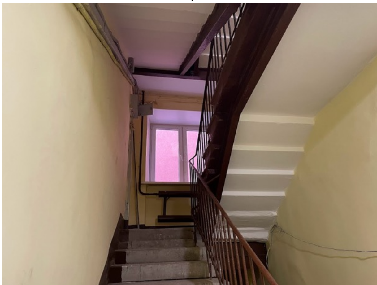
67. Черная лестница 1ЛК в уровне первого этажа
