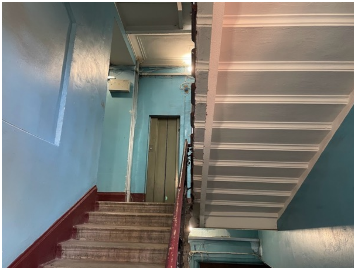
29. Лестничная клетка ЗЛК в уровне четвертого этажа
