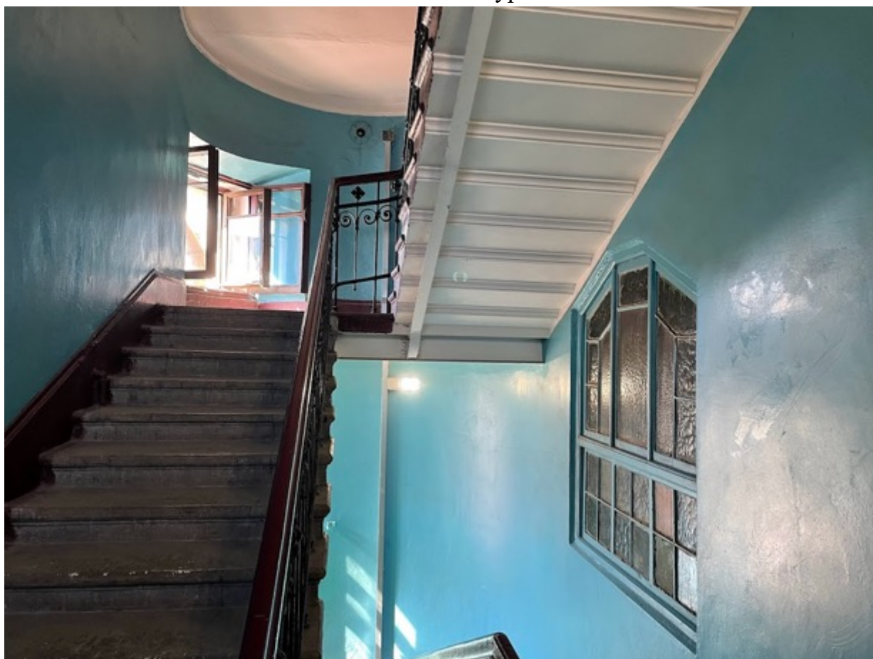
38. Лестничная клетка ЗЛК в уровне шестого этажа
