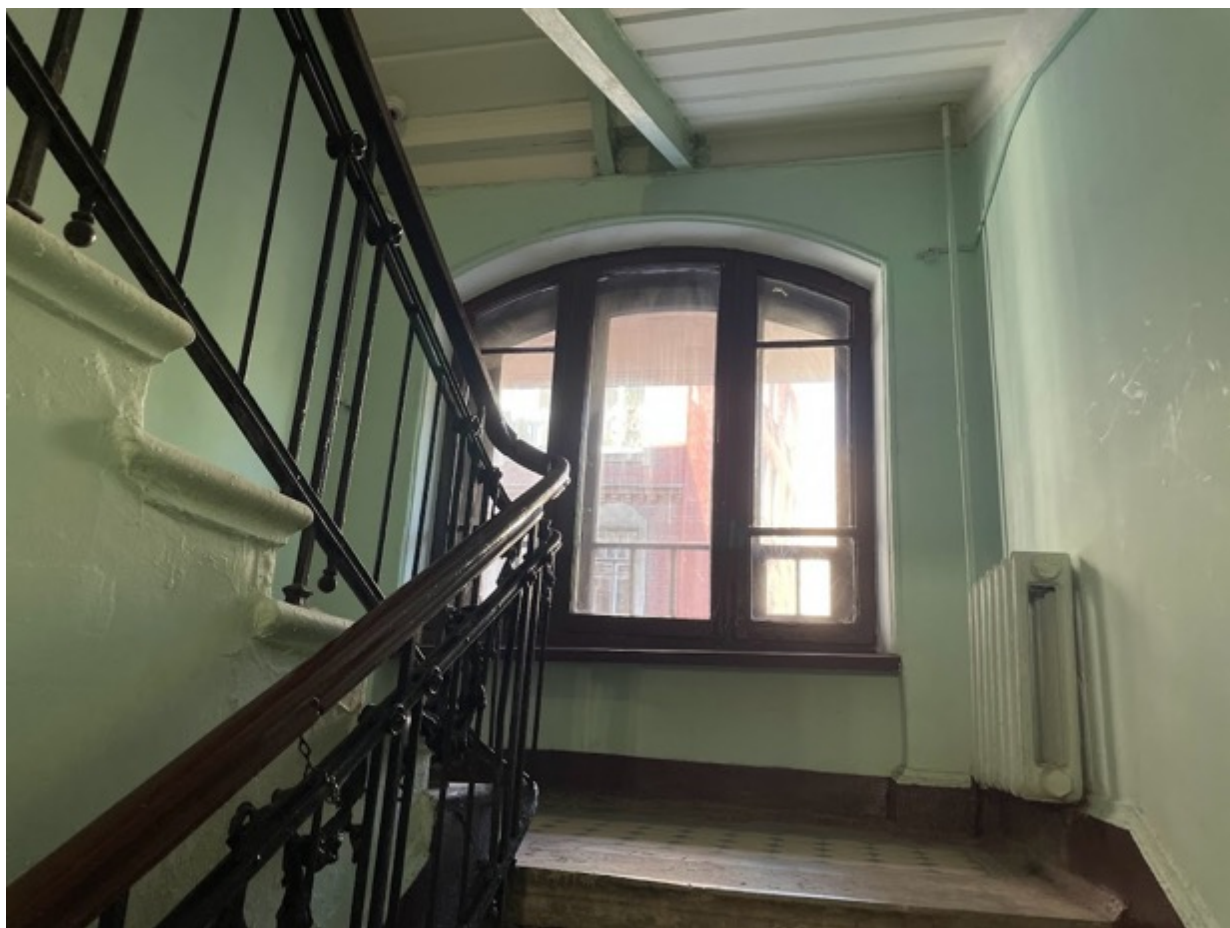
82. Лестница 1ЛК в уровне второго этажа
