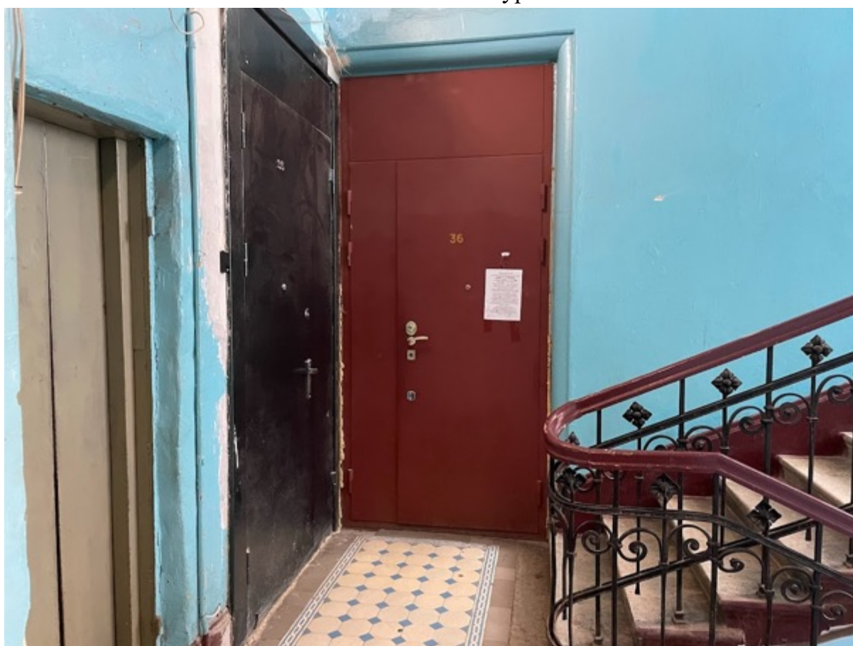
34. Лестничная клетка ЗЛК в уровне пятого этажа
