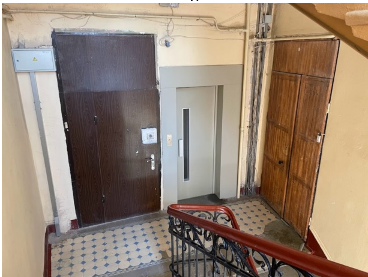
60. Лестница 2ЛК в уровне пятого этажа
