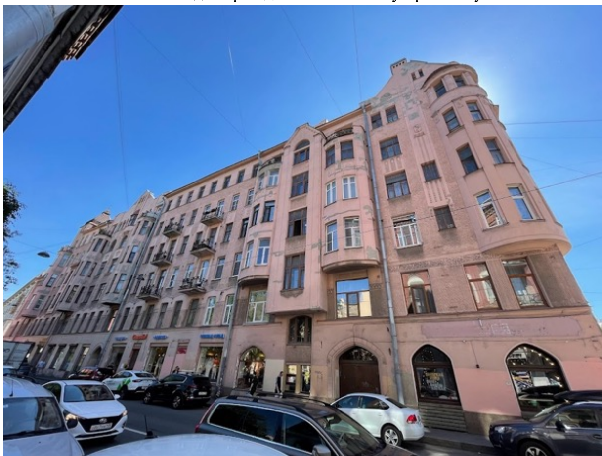
4. Вид на фасад по Чкаловскому проспекту
