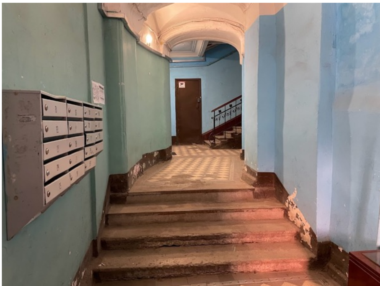
14. Вестибюль лестничной клетки 3Л
