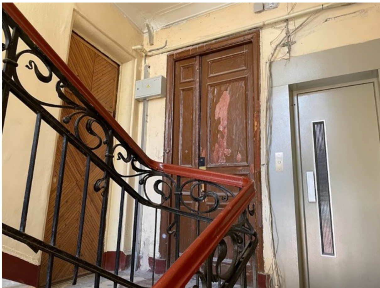
57. Лестница 2ЛК в уровне четвертого этажа
