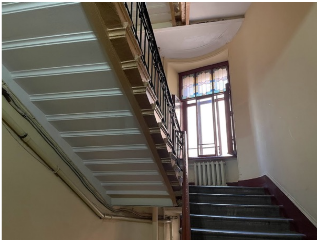
51. Лестница 2ЛК в уровне второго этажа
