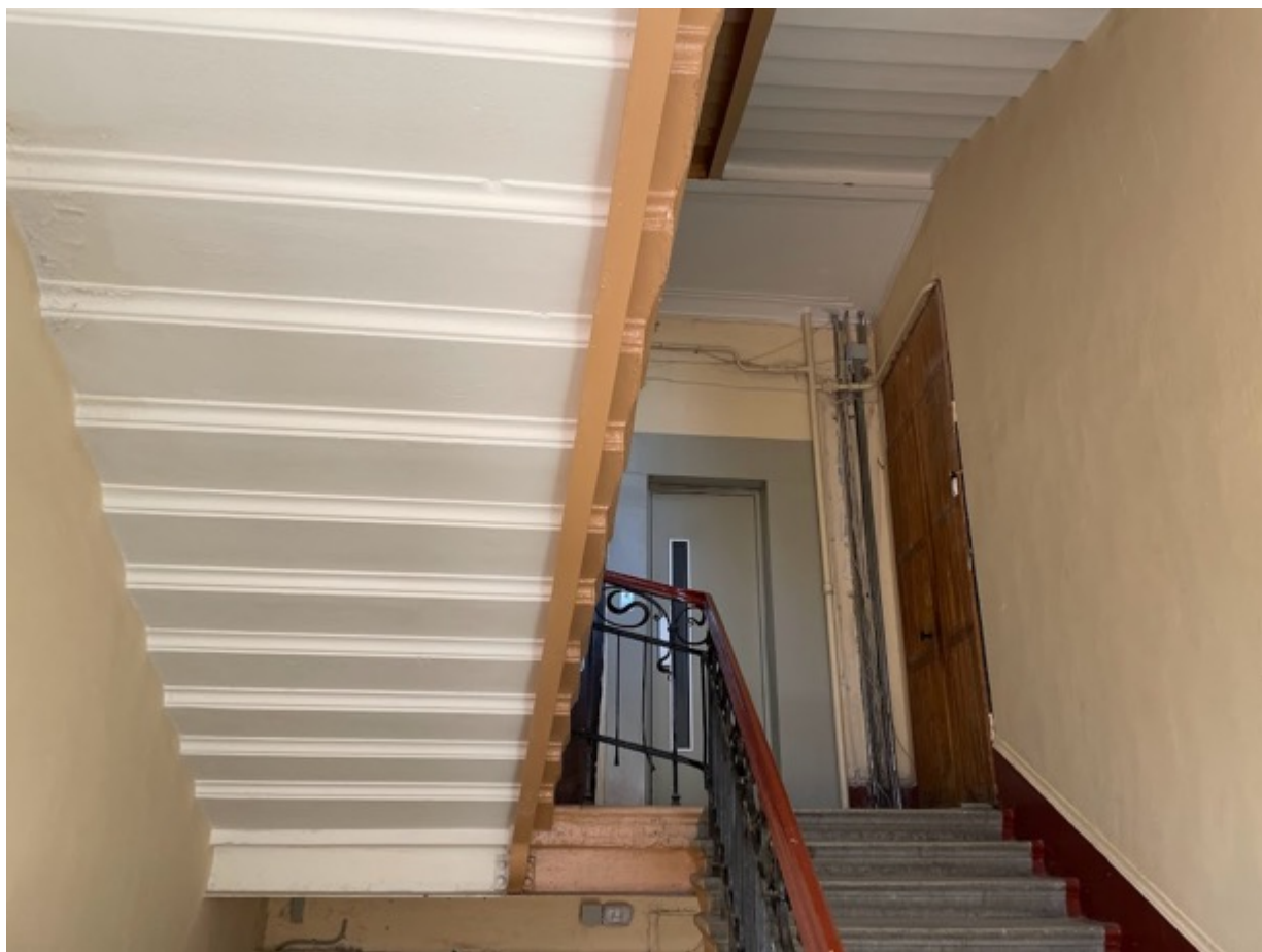
59. Лестница 2ЛК в уровне пятого этажа
