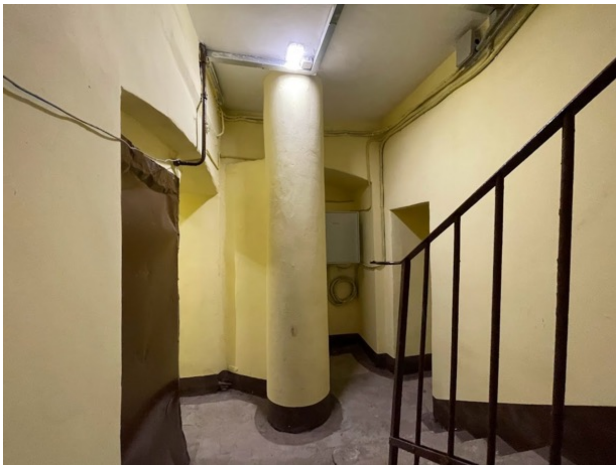
66. Вестибюль черной лестницы 1ЛК
