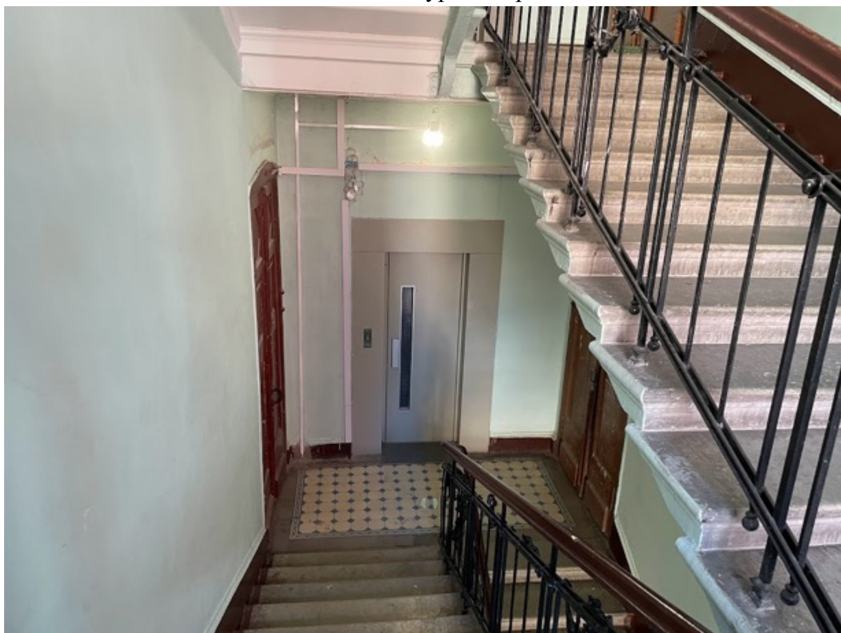
85. Лестница 1ЛК в уровне третьего этажа
