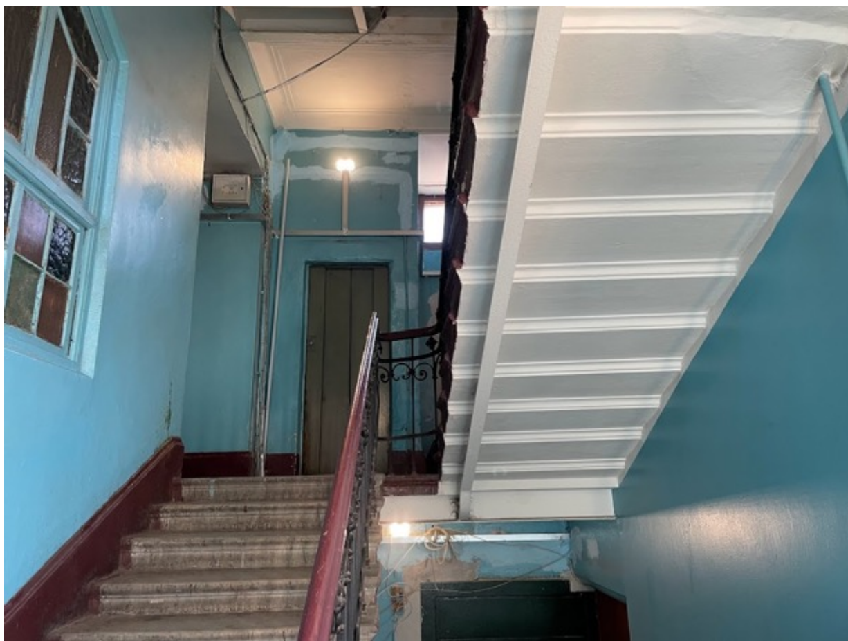
37. Лестничная клетка ЗЛК в уровне шестого этажа
