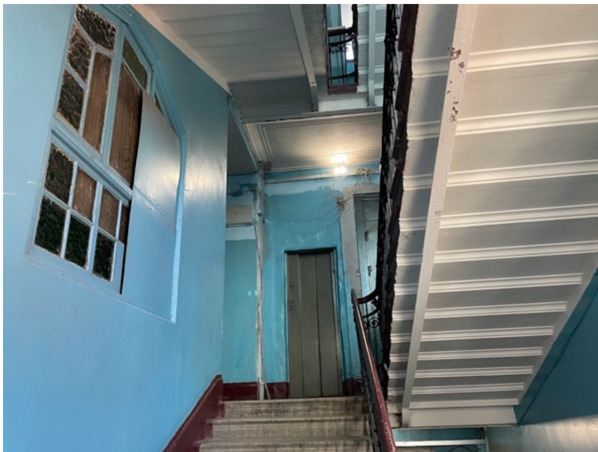
33. Лестничная клетка ЗЛК в уровне пятого этажа
