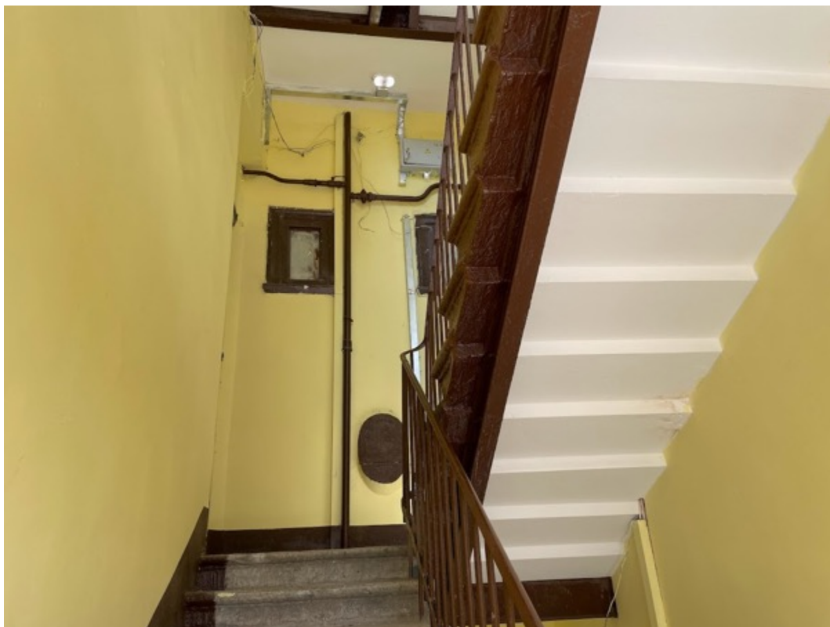
74. Черная лестница 1ЛК в уровне пятого этажа
