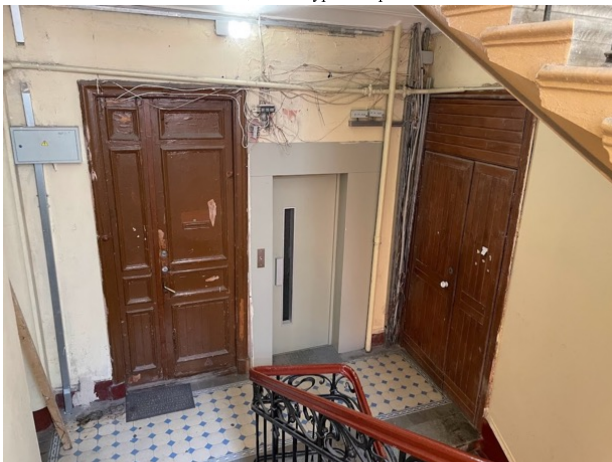
54. Лестница 2ЛК в уровне третьего этажа
