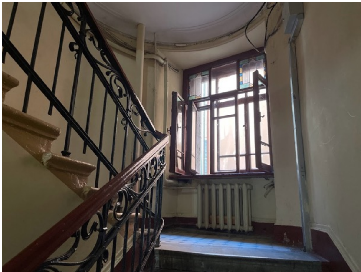
47. Лестница 2ЛК в уровне первого этажа
