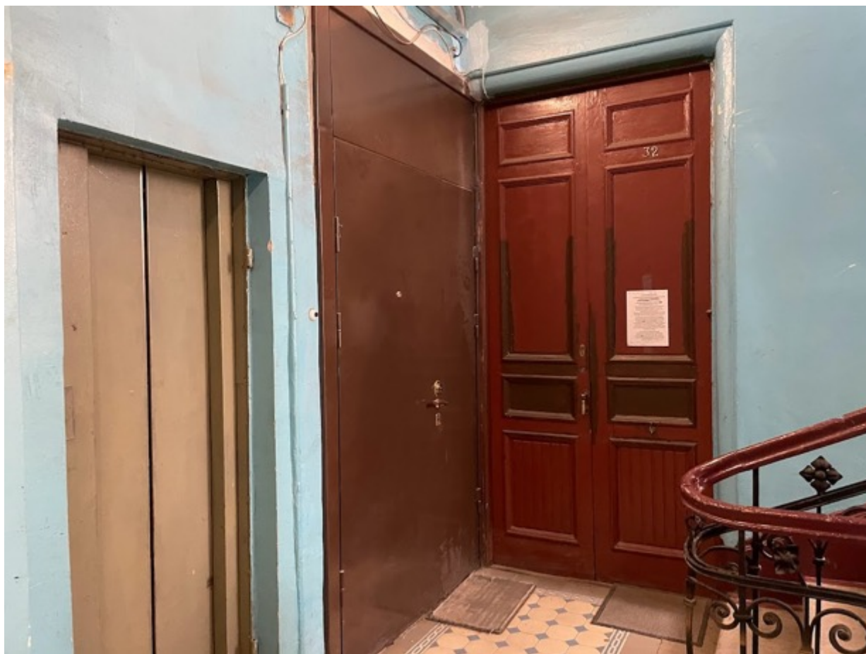
31. Лестничная клетка ЗЛК в уровне четвертого этажа
