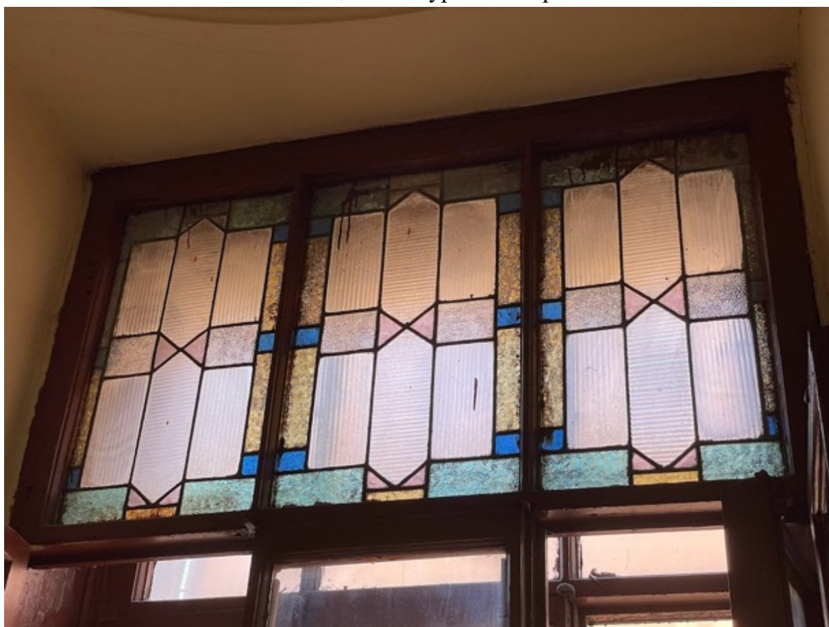
52. Оконное заполнение лестницы 2ЛК между вторым и третьим этажами
