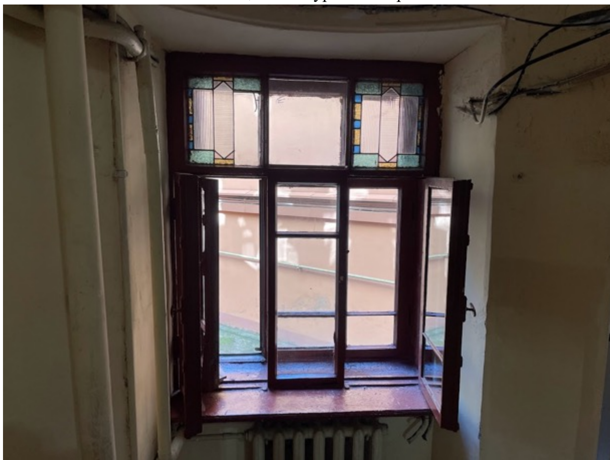
50. Оконное заполнение лестницы 2ЛК между первым и вторым этажами
