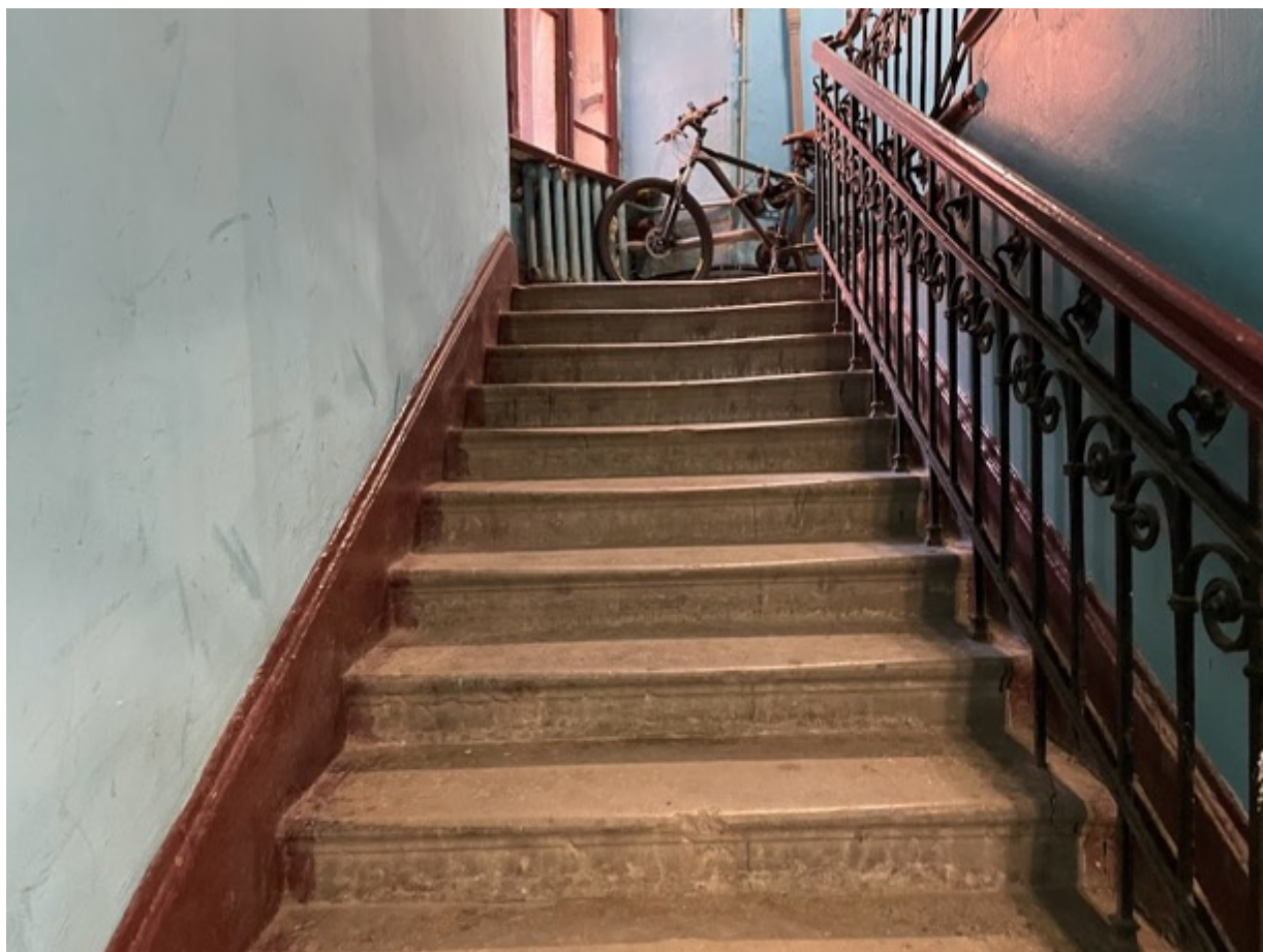
15. Лестничная клетка ЗЛК в уровне первого этажа
