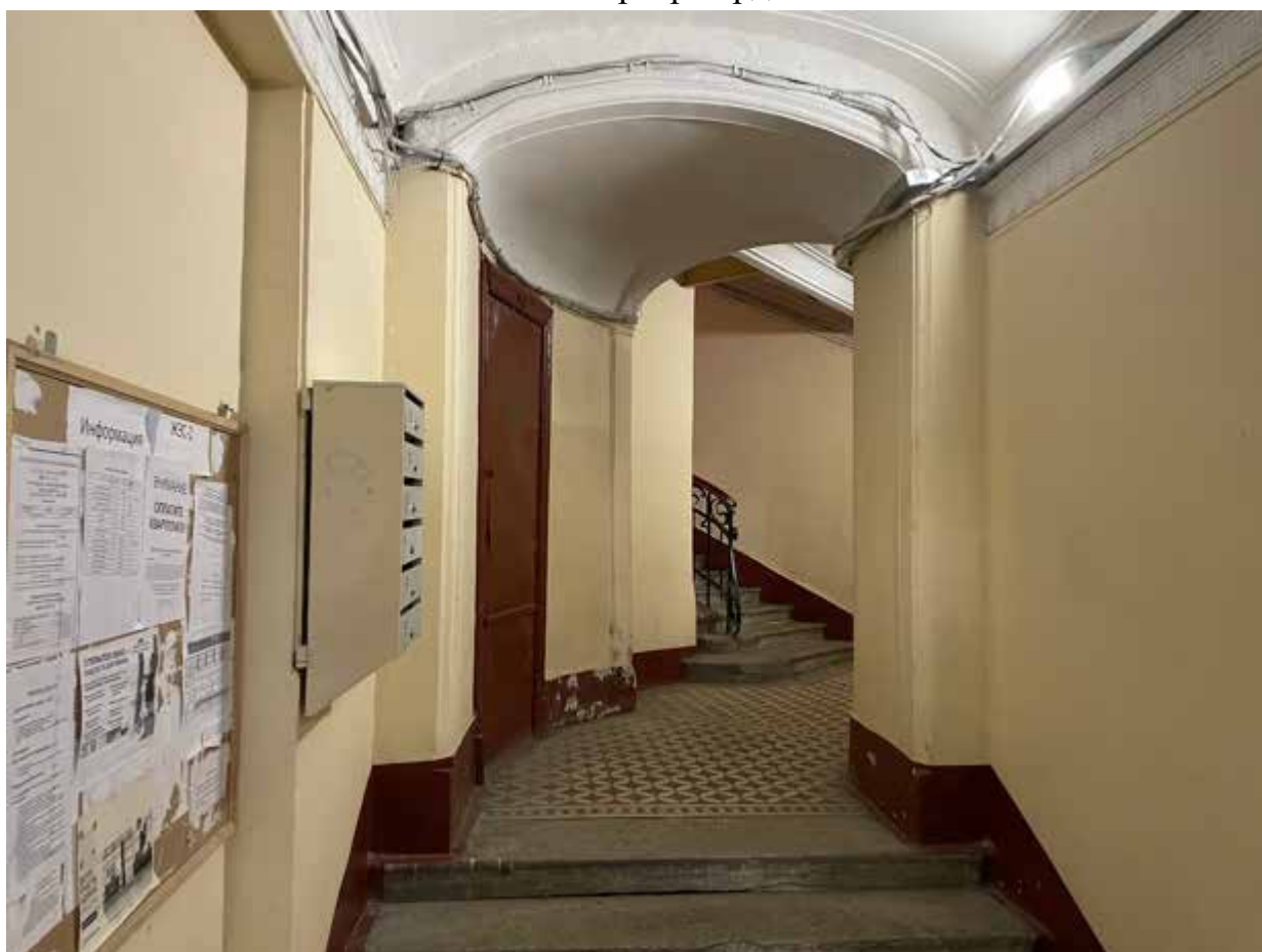
44.Вестибюль лестницы 2JK
