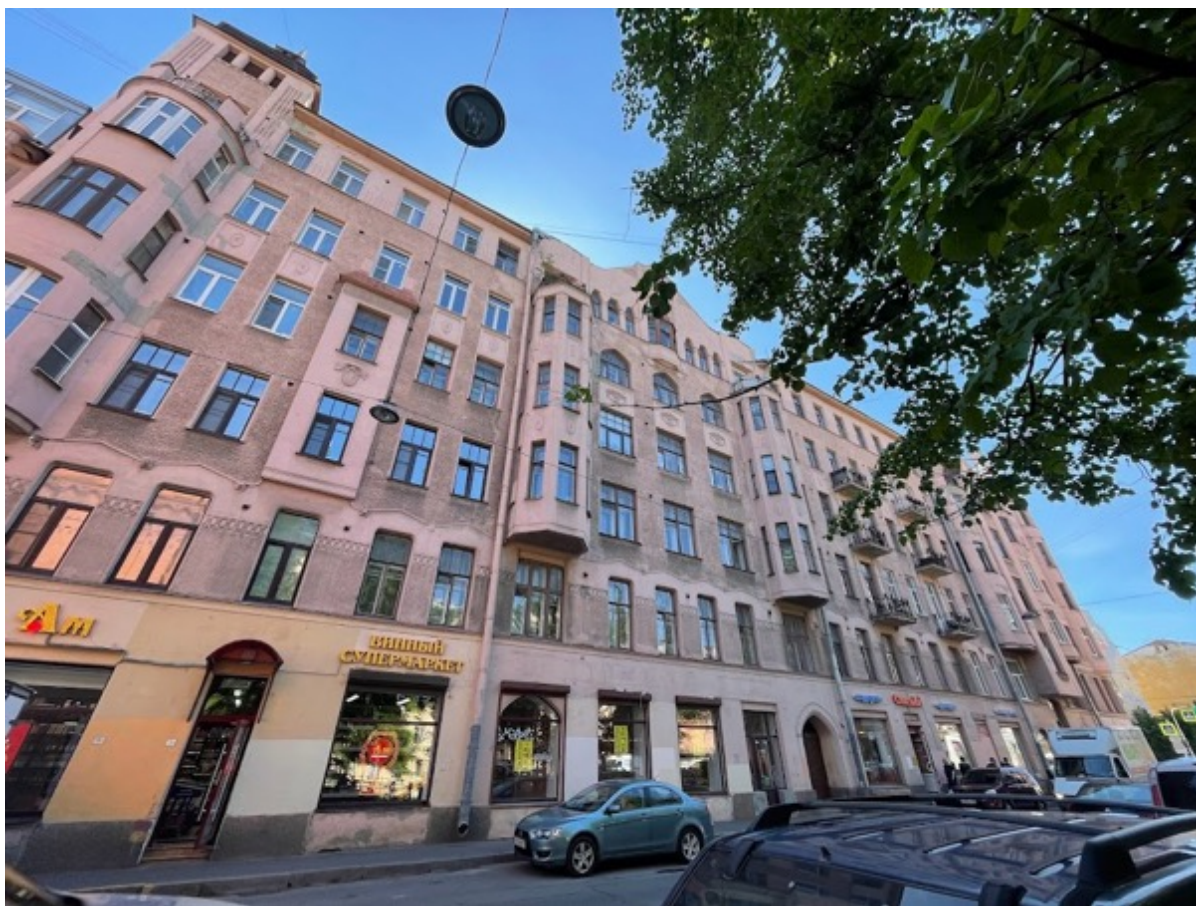
3. Вид на фасад по Чкаловскому проспекту
