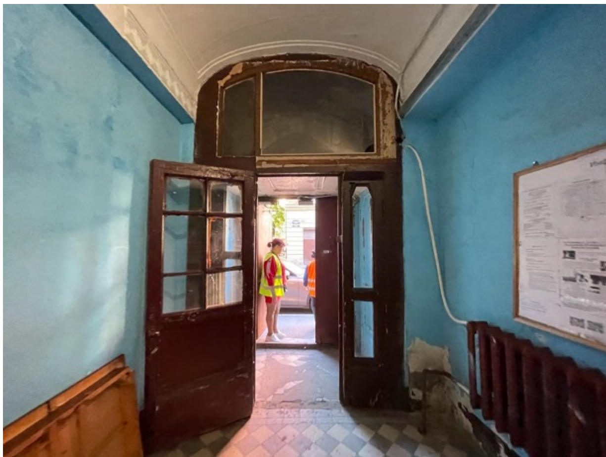
13. Вестибюль лестничной клетки 3Л
