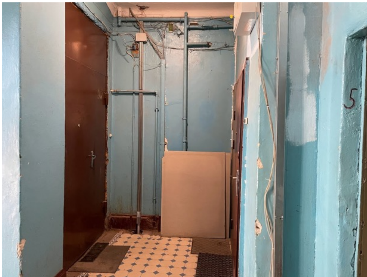
35. Лестничная клетка ЗЛК в уровне пятого этажа
