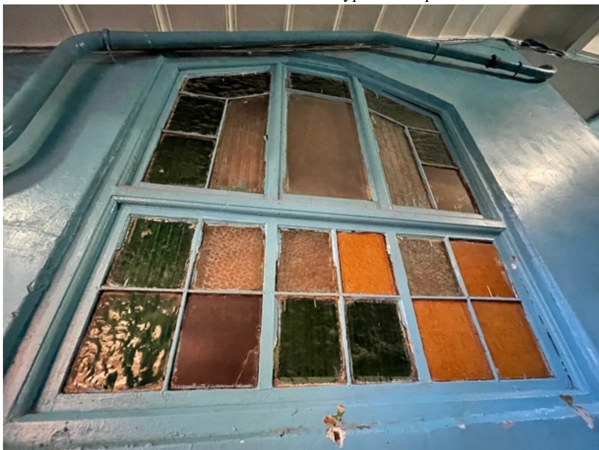
18. Окно на лестничной клетке ЗЛК в уровне второго этажа
