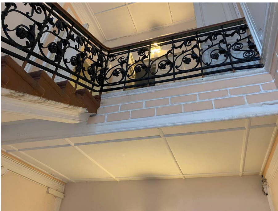
Фото №31. Лестничная площадка третьего этажа.
