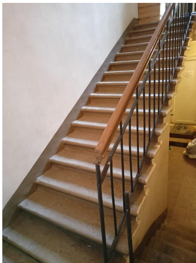
Фото №36. Запасная лестница двухмаршевая с металлическими ограждениями, вид с первого этажа.
