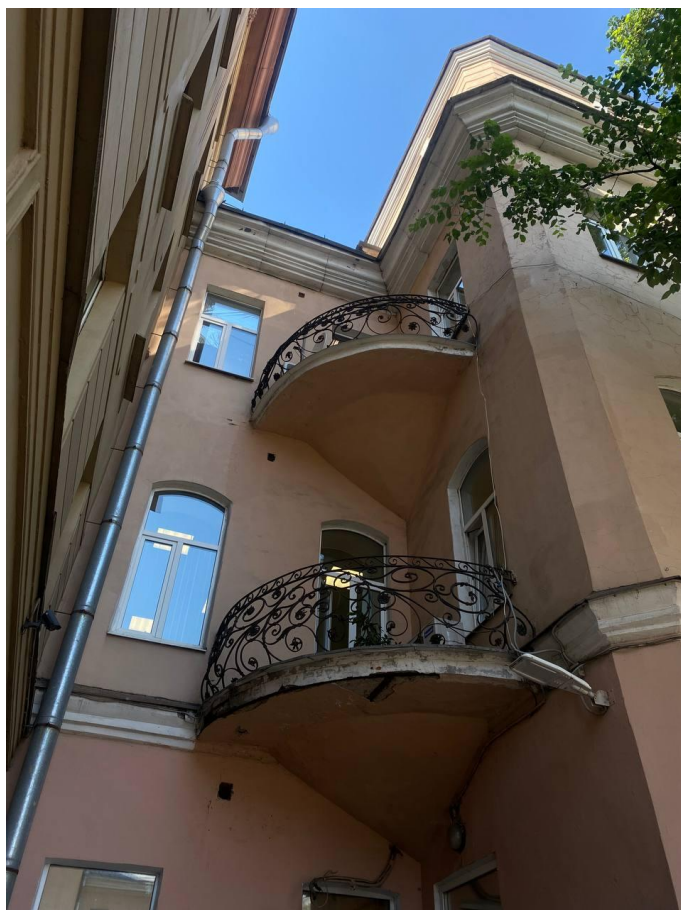
Фото №2. Балконы северного фасада с коваными ажурными ограждениями.
