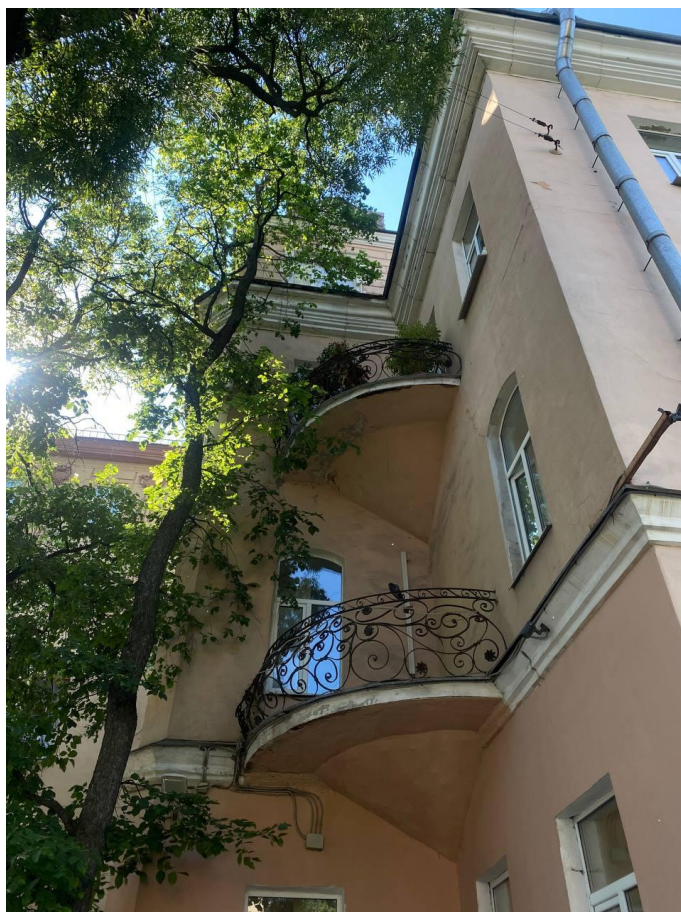
Фото №3. Балконы северного фасада с коваными ажурными ограждениями.
