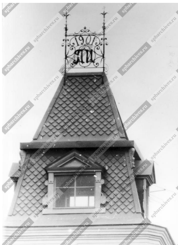
Илл.7. Шатровое завершение крыши дома №18 на Большой Пороховской улице с датой постройки «1901» и инициалами владельца «П.И.»
