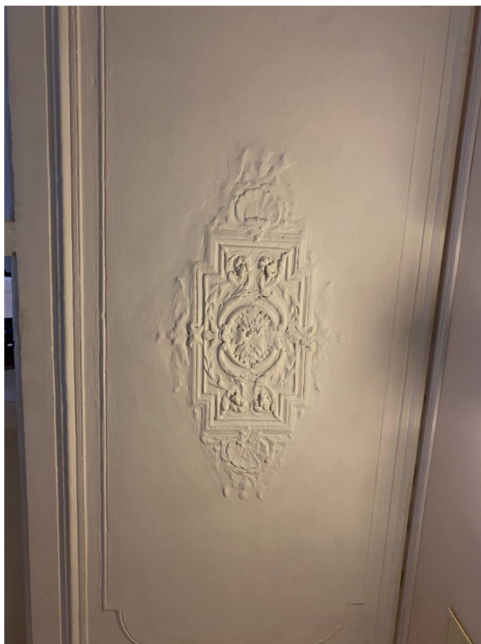
Фото №12. Оформление потолка междуэтажной площадки на первом этаже.
