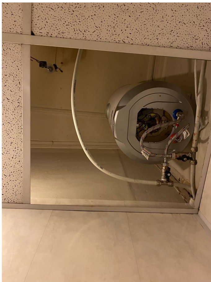
Фото №15. Оформление потолка в санузле третьего этажа.
