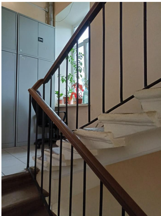
Фото №37. Запасная лестница, лестничная площадка второго этажа.
