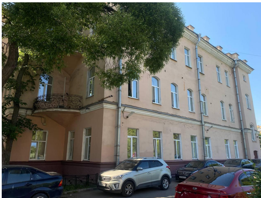
Фото №4. Северный и восточный фасады здания.
