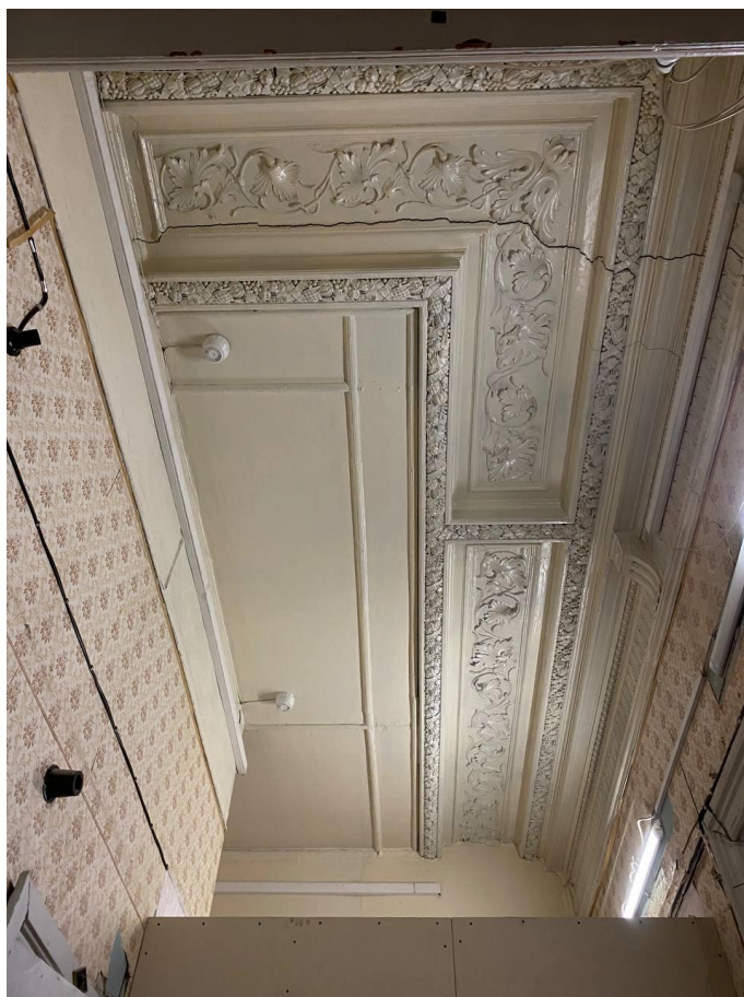
Фото №19. Оформление потолка административного помещения на втором этаже.
