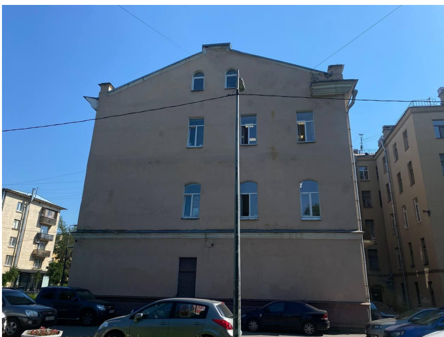
Фото №6. Южный фасад здания.
