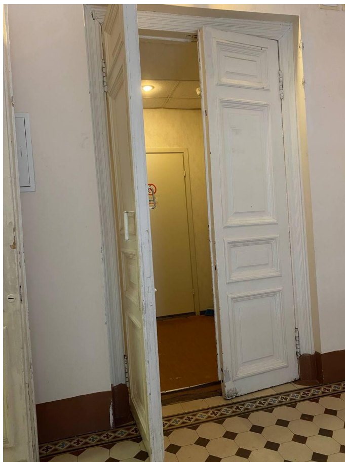
Фото №33. Оформление дверных проемов на третьем этаже.
