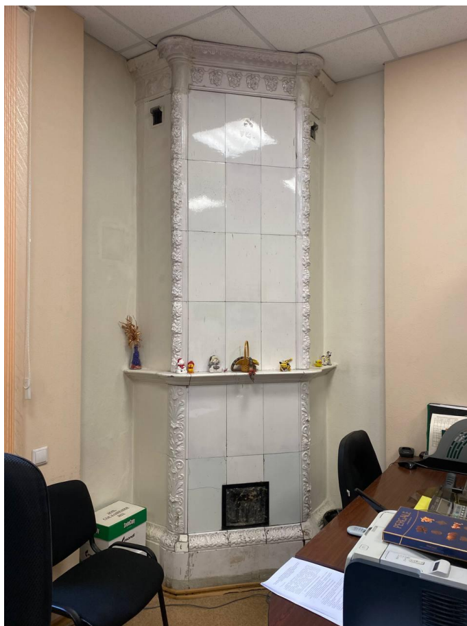
Фото №29. Угловая двухъярусная печь-камин на третьем этаже.
