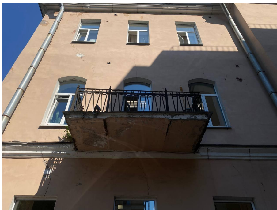
Фото №8. Балкон на западном фасаде здания.
