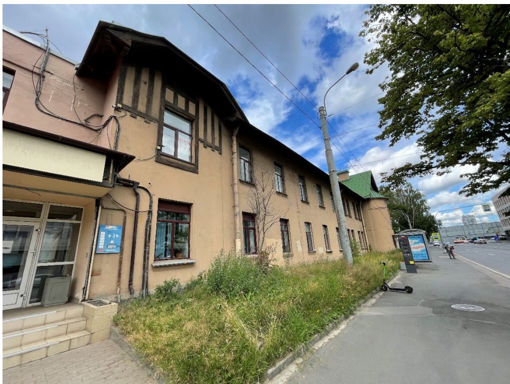
Фото №3. Северо-восточный лицевой фасад, вид от пристройки.
