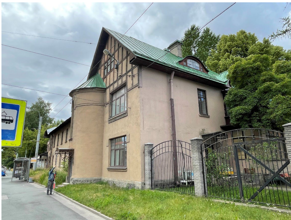
Фото №9. Северо-восточный лицевой и северный фасады.
