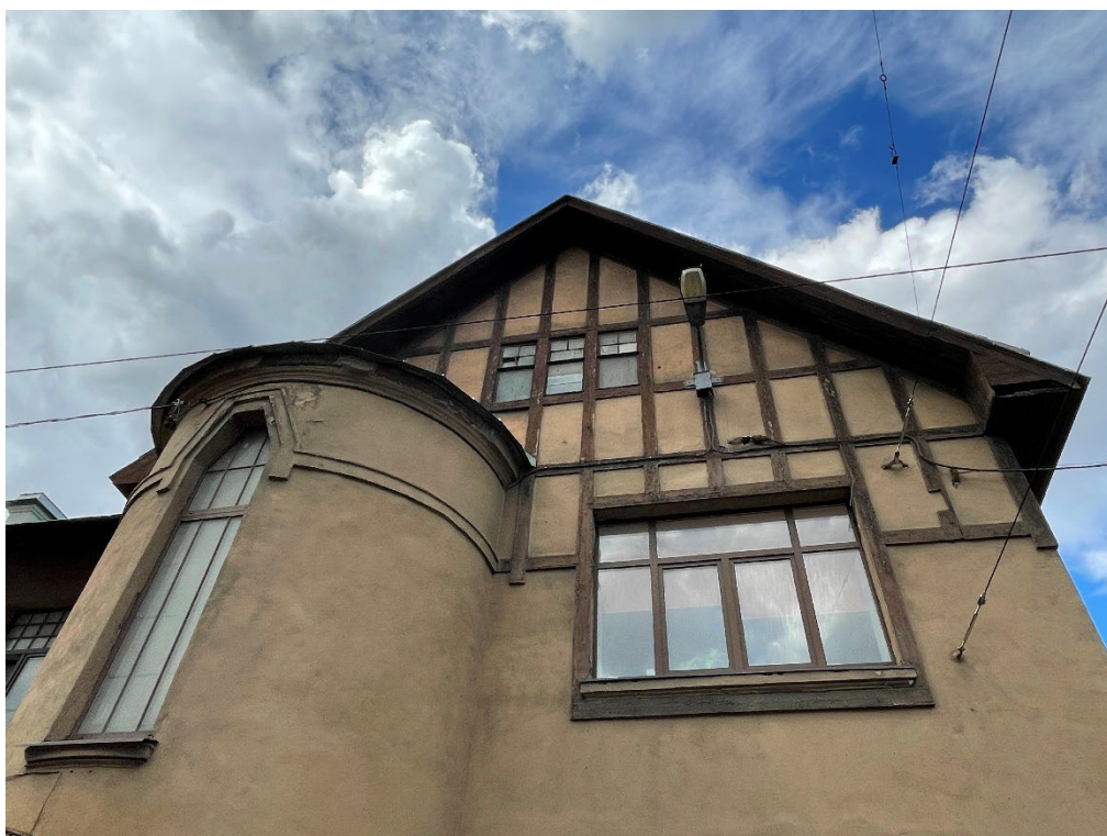
Фото №8. Фронтон лицевого фасада с фахверковой отделкой, свес крыши.
