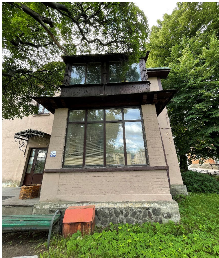
Фото №12. Северный фасад здания, остекленная веранда.
