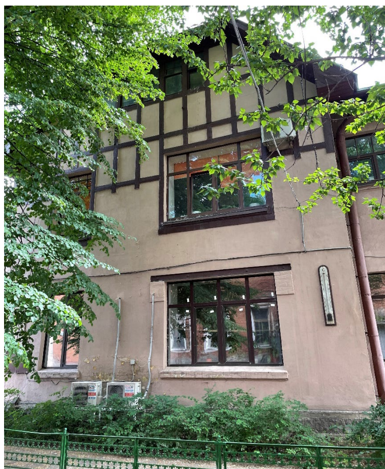
Фото №18. Дворовый фасад здания, фронтон с отделкой фахверком, оформление перемычки над окном 1-го этажа.
