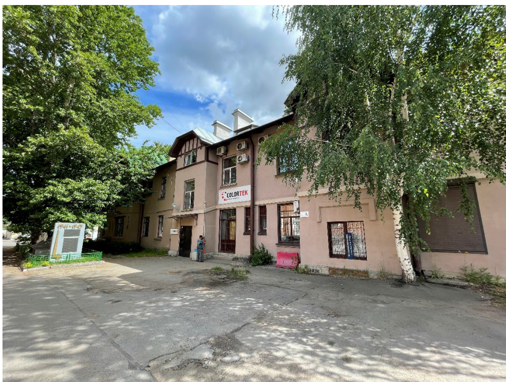
Фото №16. Северо-западный фасад здания, вид с дворовой территории.
