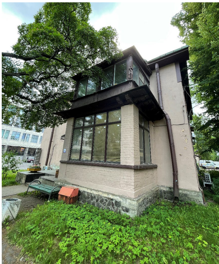
Фото №13. Северный фасад, остекленная веранда. Вид с дворовой территории.
