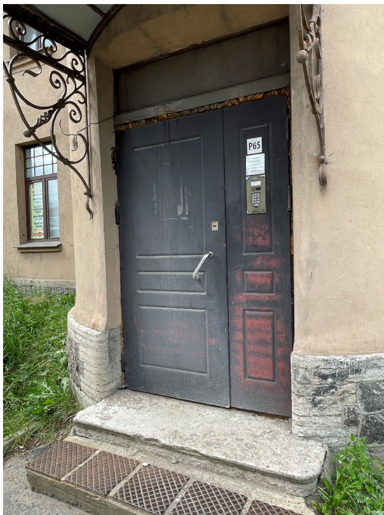
Фото №7. Входная группа башнеобразного выступа, металлический козырек на ажурных кронштейнах (поздний).
