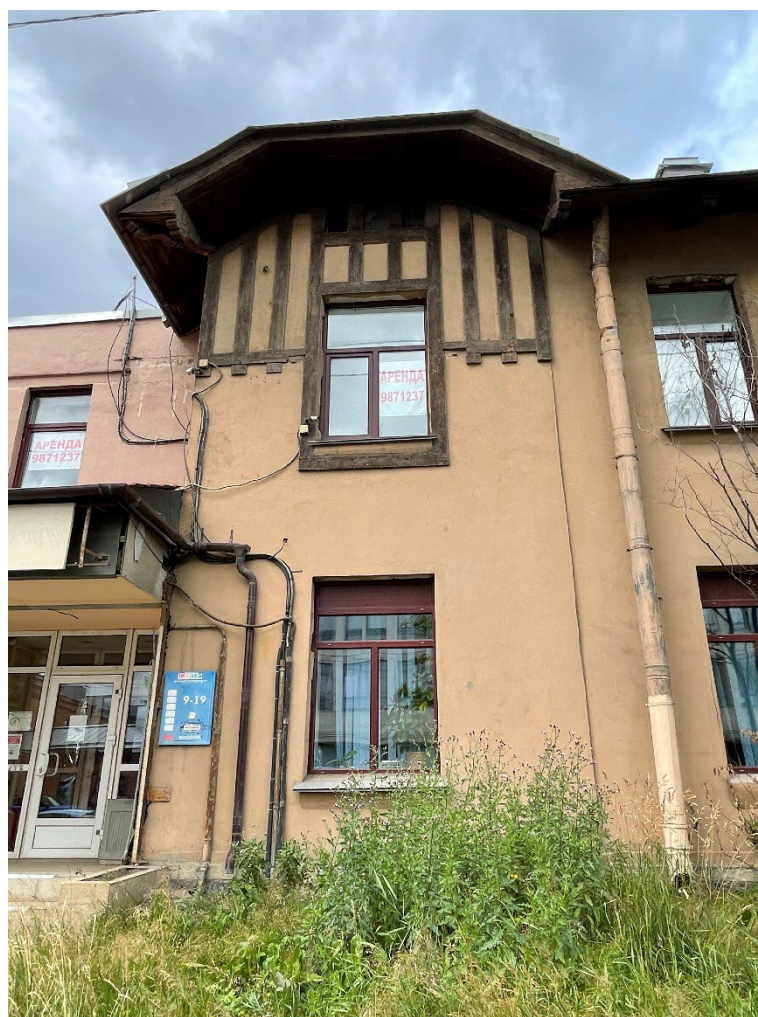
Фото №4. Фрагмент северо-восточного лицевого фасада.
