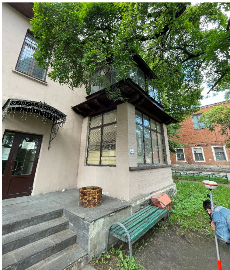
Фото №11. Северный фасад здания, остекленная веранда. Вид со стороны Новочеркасского проспекта.
