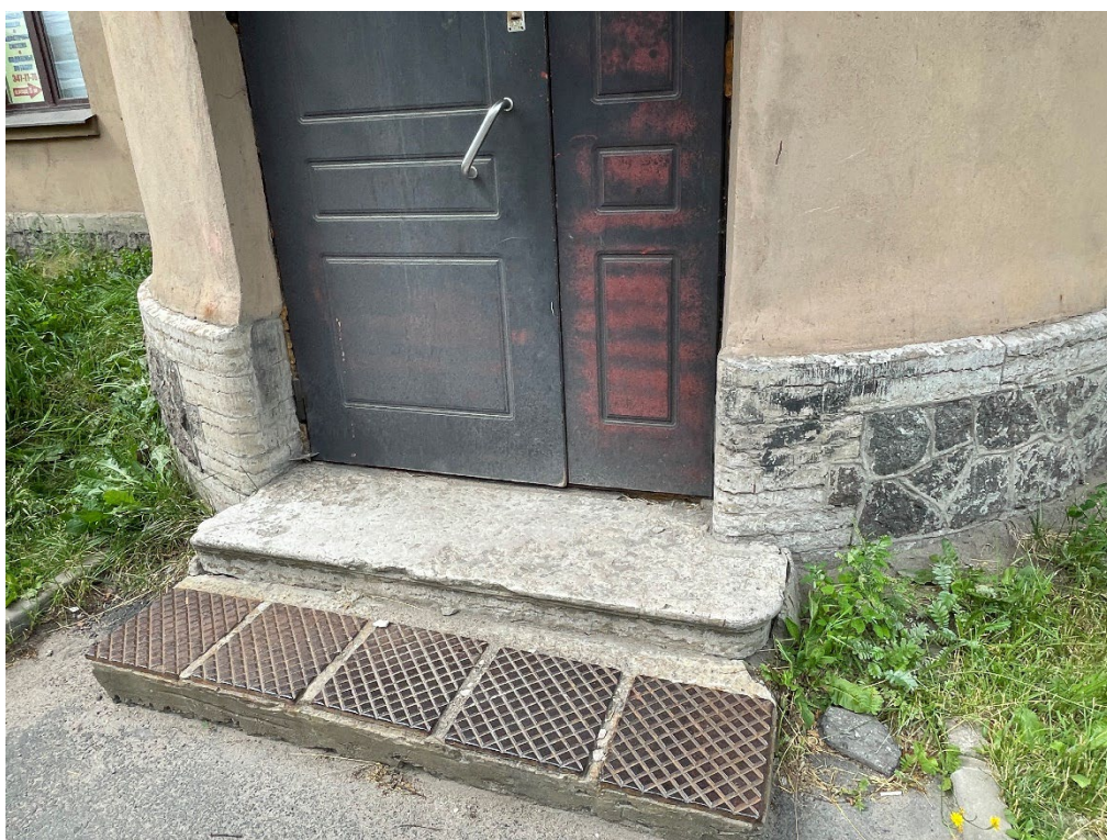
Фото №6. Цоколь, крыльцо входа в башнеобразном выступе.
