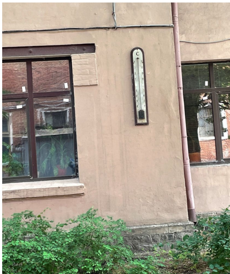
Фото №17. Металлическая перемычка из проката над окном дворового фасада.
