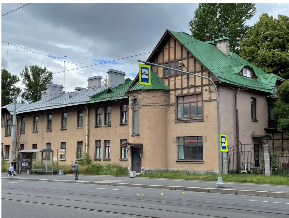
Фото №2. Общий вид здания с Новочеркасского проспекта. Северо-восточный и северный фасады.
