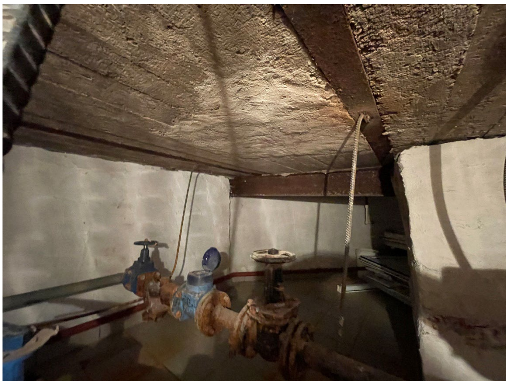
Фото №33. Подвал, лестничная площадка ж/б по металлическим балкам.
