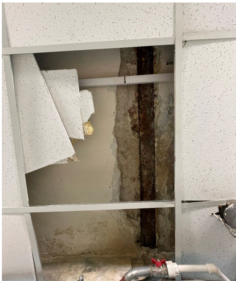
Фото №35. Плоское ж/б междуэтажное перекрытие по металлическим балкам.
