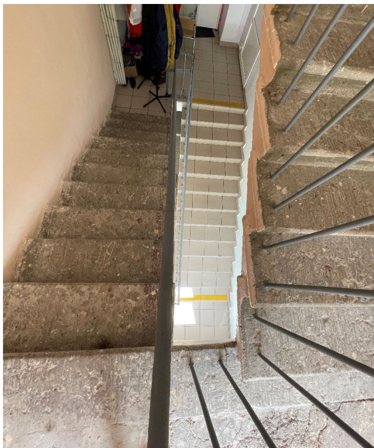
Фото №27. Службная известняковая лестница, вид с междуэтажной площадки 2 и 3 этажа на нижние марши.
