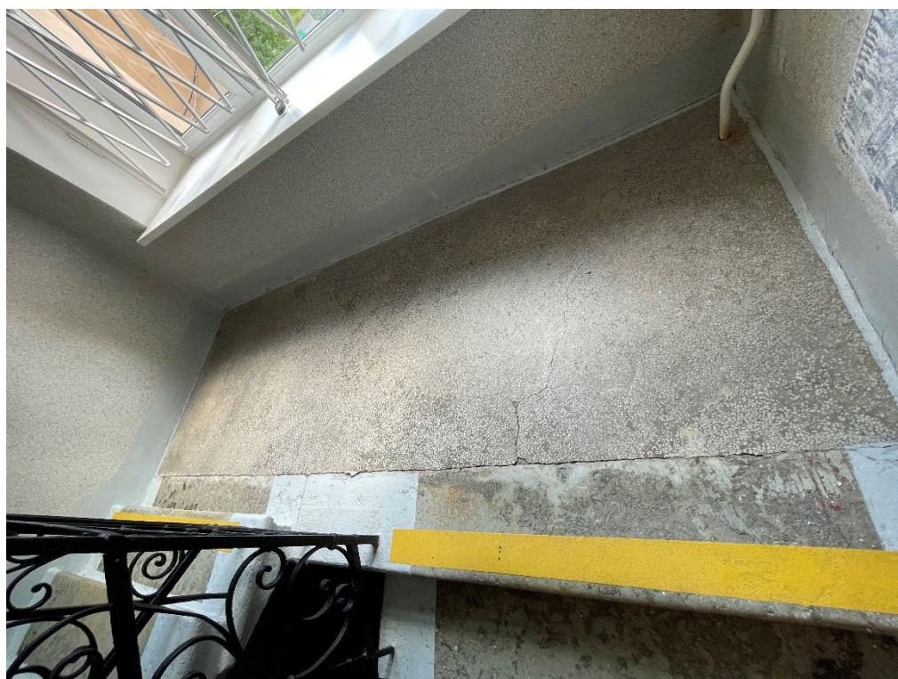
Фото №16. Междуетажная площадка парадной лестницы.
