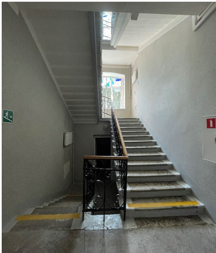
Фото №14. Парадная лестница, вид с 1 этажа.
