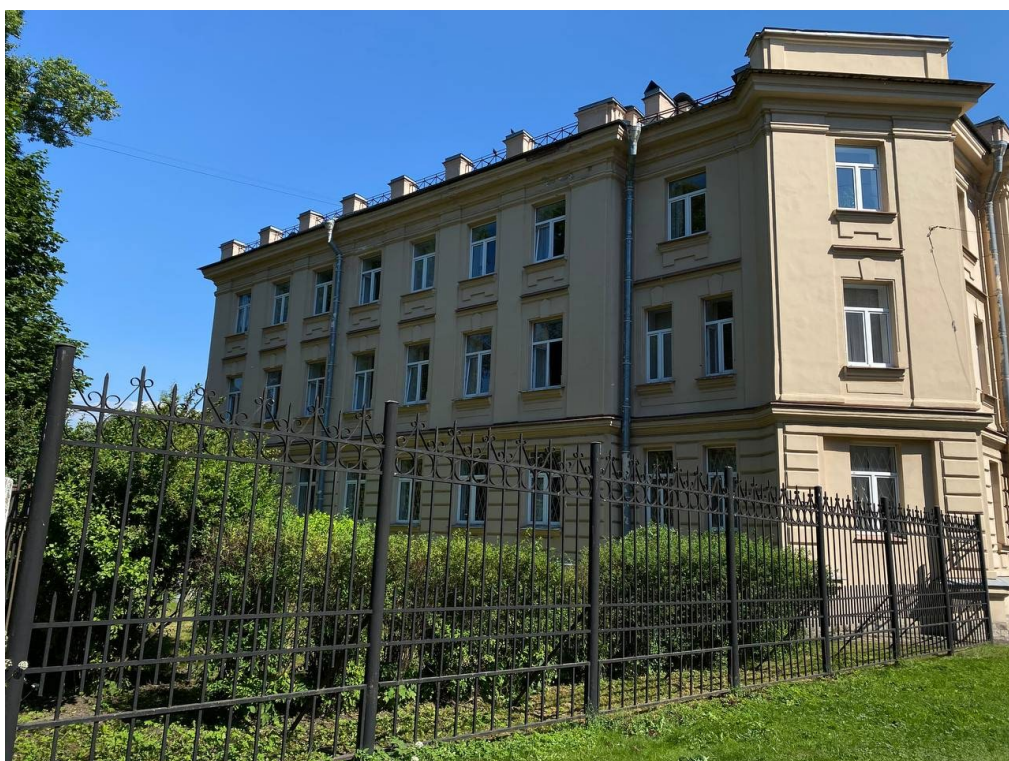
Фото №2. Северо-западный фасад здания.
