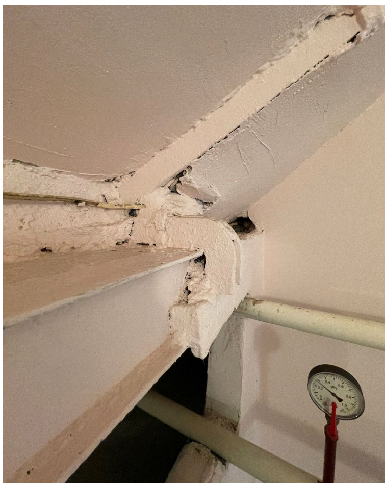
Фото №34. Подвал, лестничная площадка ж/б по металлическим балкам.
