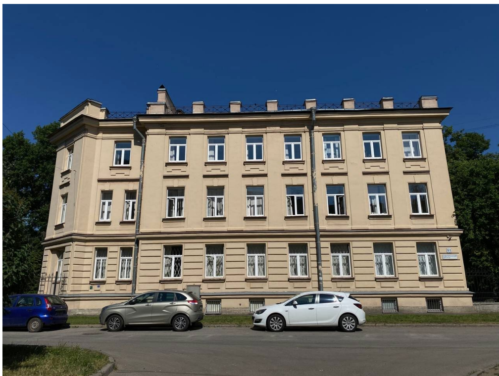
Фото №3. Западный фасад здания.
