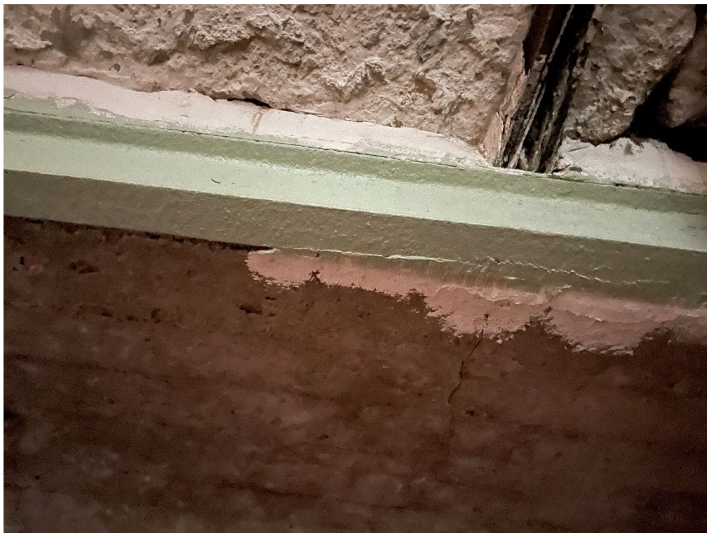
Фото №41. Сводчатое перекрытие лестничной площадки служебной лестницы.
