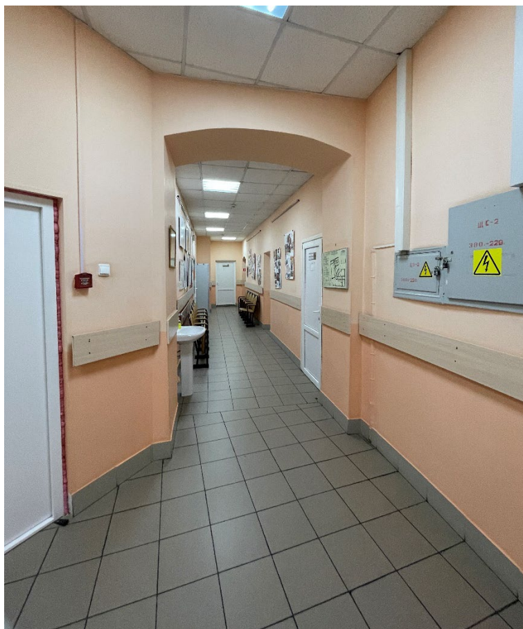
Фото №13. Отделка коридоров первого этажа, арочные проемы.
