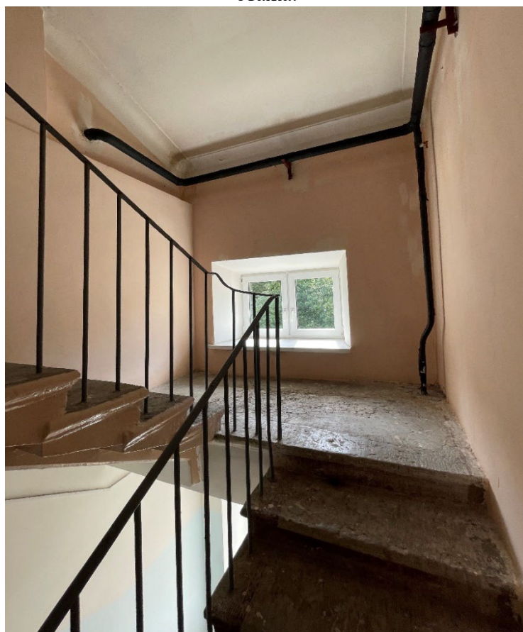
Фото №26. Службная известняковая лестница, междуэтажная площадка 2 и 3 этажа, оконный проем.
