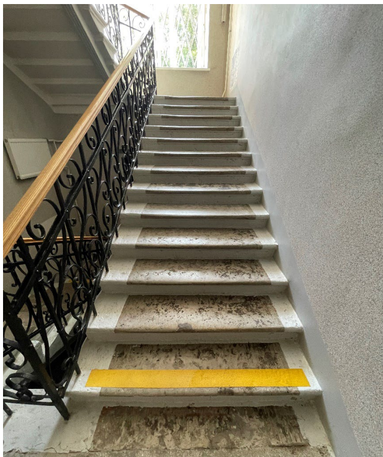
Фото №15. Лестничный марш парадной лестницы, вид с 1 этажа.
