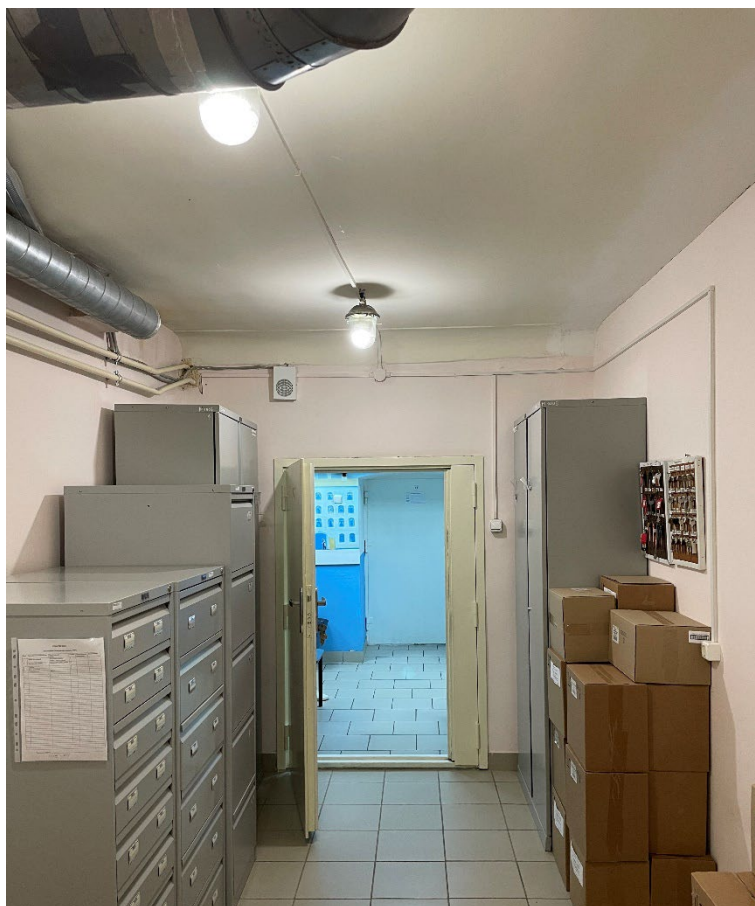
Фото №37. Помещение венткамеры в подвале.
