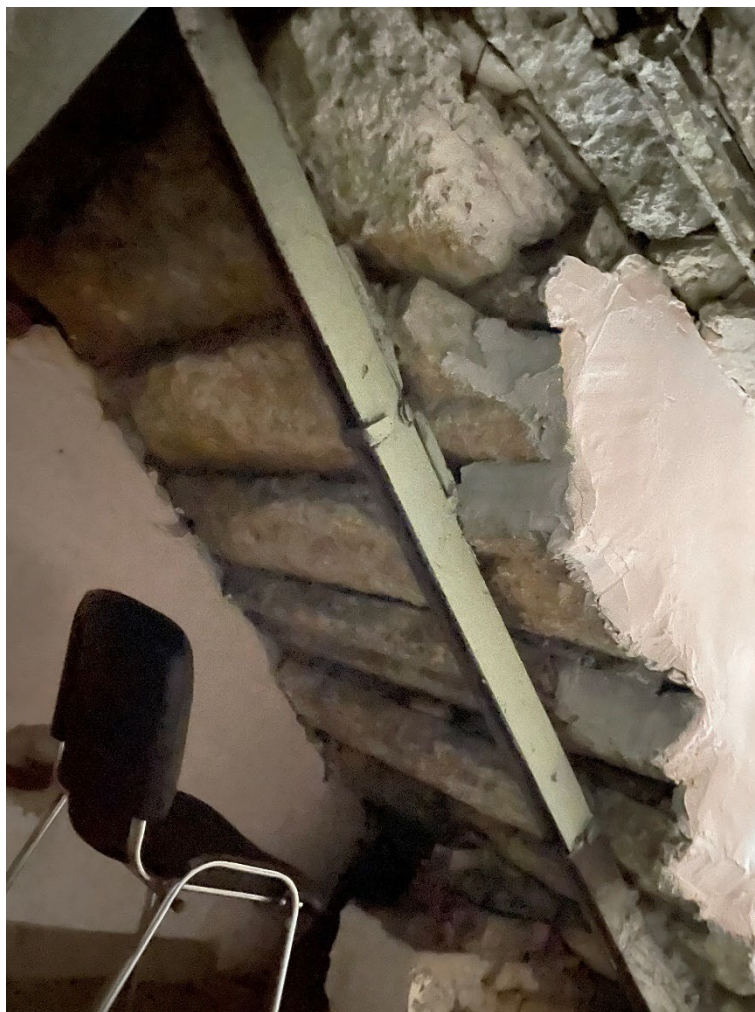
Фото №40. Служебная лестница известняковые ступени по металлическим косоурам.
