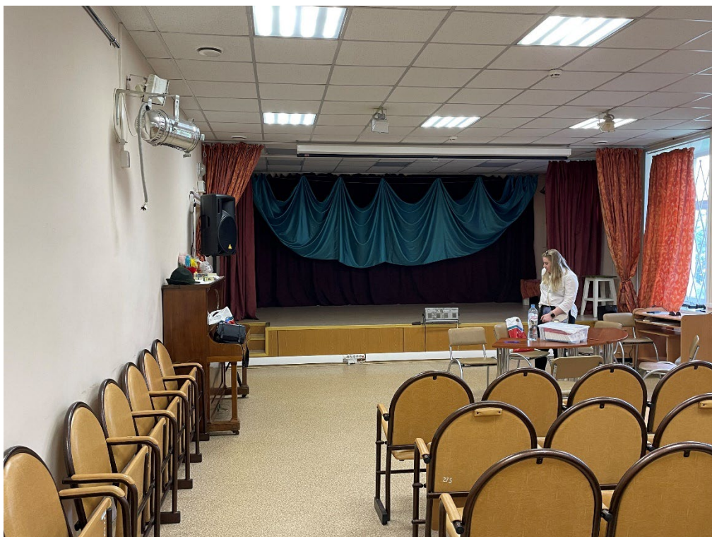
Фото №11. Отделка внутренних помещений.
