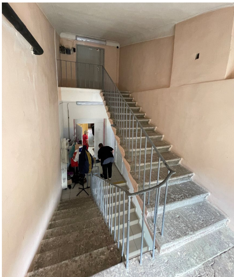
Фото №25. Службная известняковая лестница, вид с междуэтажной площадки 2 и 3 этажа.
