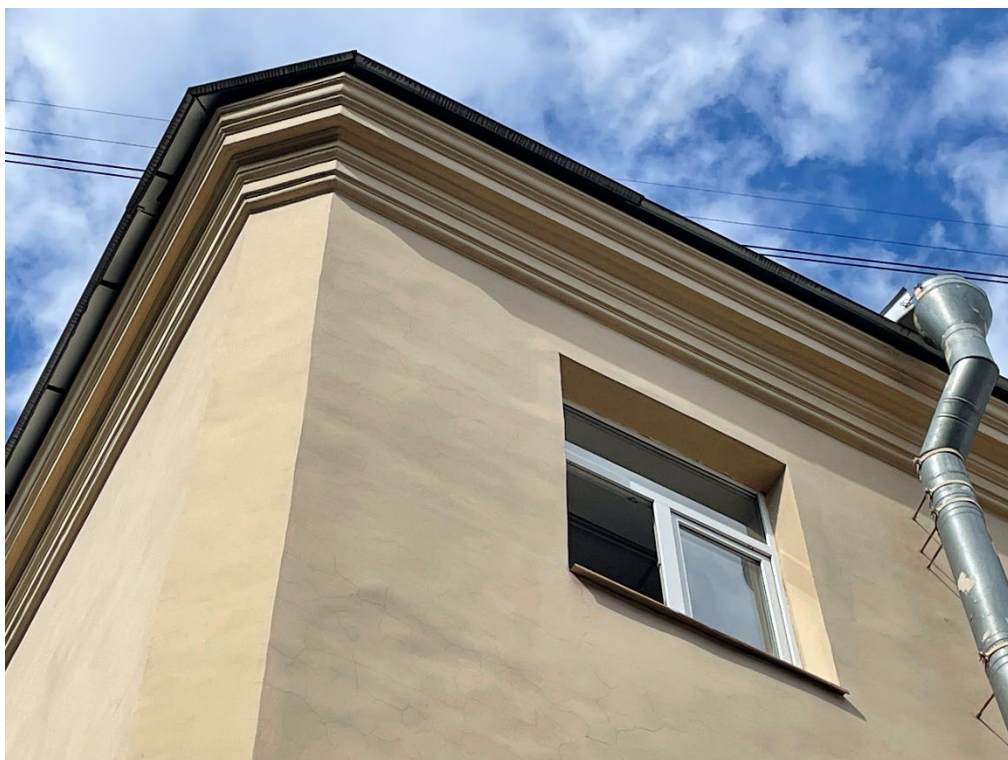
Фото №7. Венчающий профилированный карниз.
