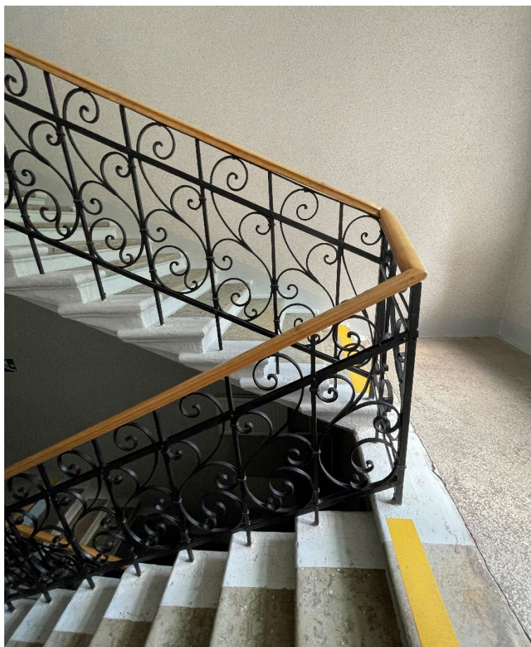
Фото №17. Металлическое ограждение парадной лестницы.
