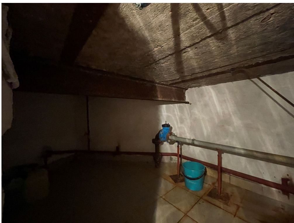
Фото №32. Подвал, помещение ИТП с надподвальным перекрытием ж/б по металлическим балкам.
