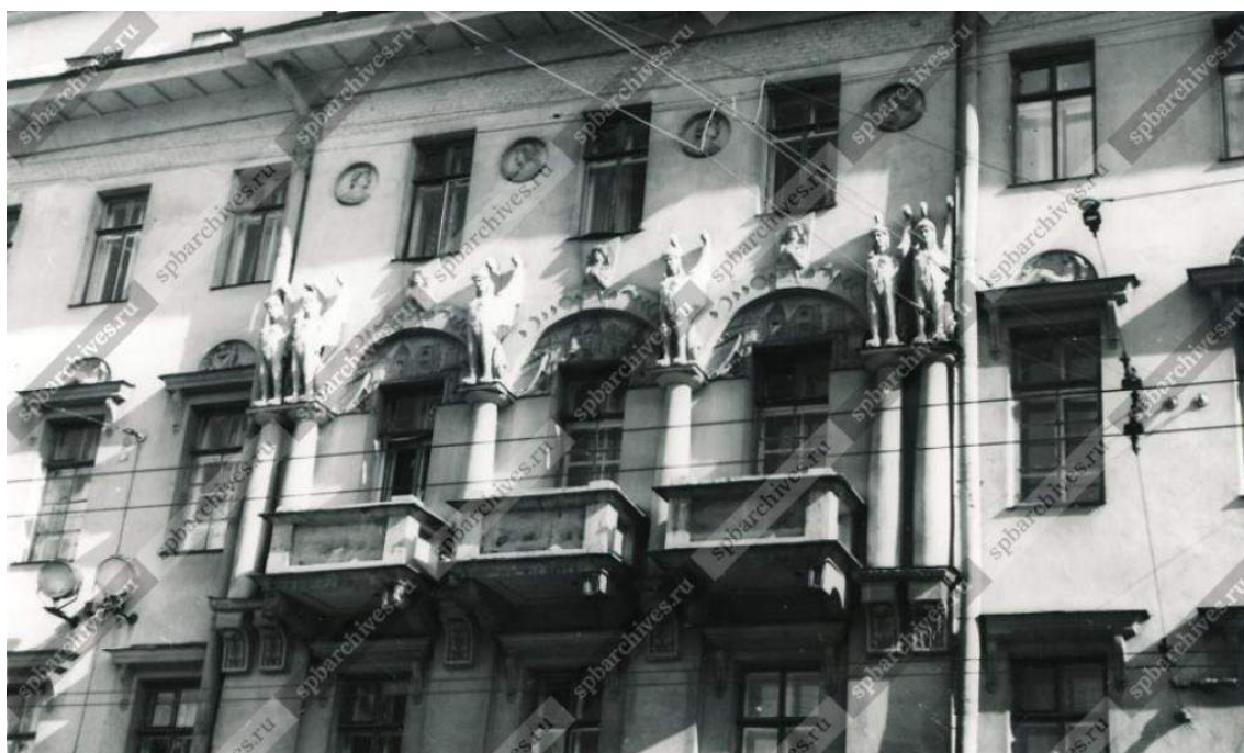
Илл.17. Вид части центрального фасада жилого дома №3 по Большой Пушкарской улице. 23 августа 1977г. (ЦГАКФФД СПб Фотодокумент Ар 242057)
