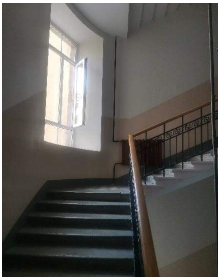
Фото №42. Парадная лестница №1. Лестничный марш, вид в сторону третьего этажа.
