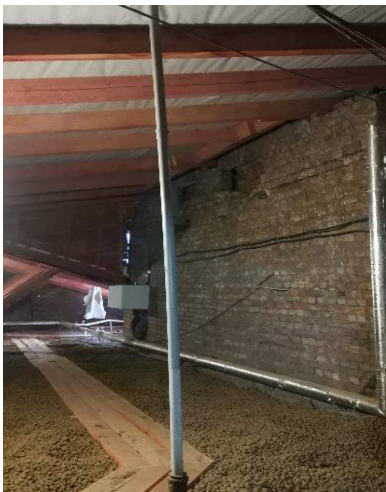
Фото №82. Парадная лестница №8. Чердак.
