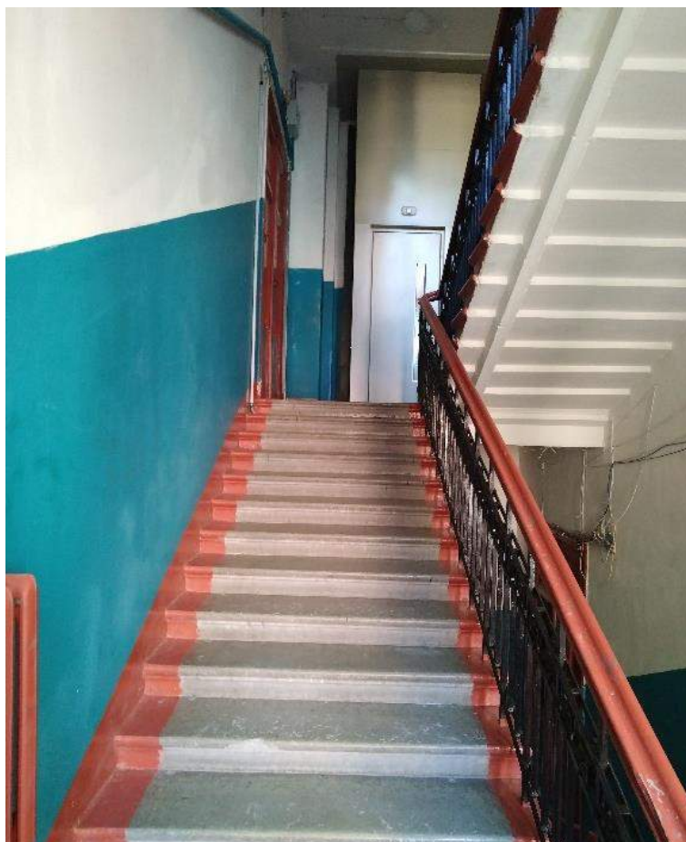
Фото №26. Парадная лестница №2. Лестничный марш, вид с междуэтажной площадки на четвертый этаж.
