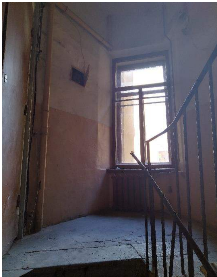
Фото №72. Парадная лестница №8. Площадка третьего этажа.
