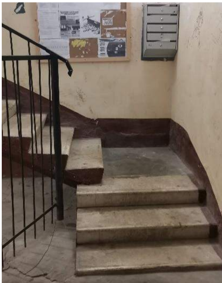
Фото №84. Парадная лестница №9. Лестница на первом этаже.
