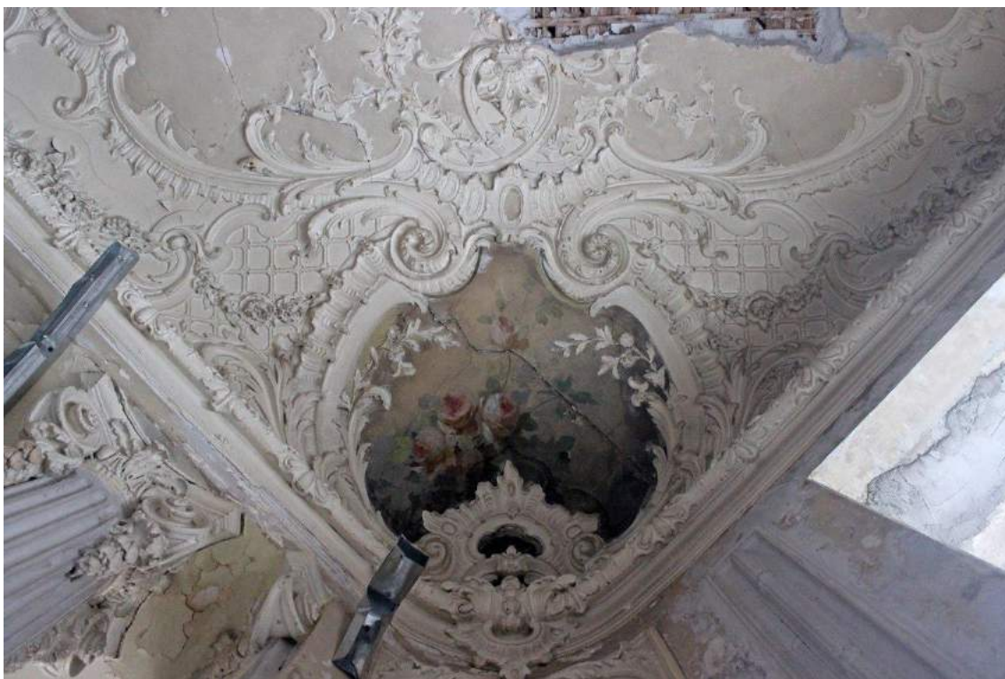
Илл.41. Левая парадная. Квартиры. На 3 этаже. Фото Олега Еверзова, 04.2017. (Источник: https://p1.citywalls.ru/photo_381-391165.jpg?mt=1555106102 )
