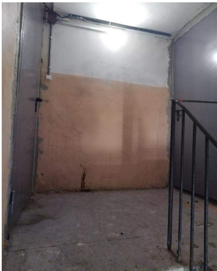
Фото №80. Парадная лестница №8. Выход на чердак.
