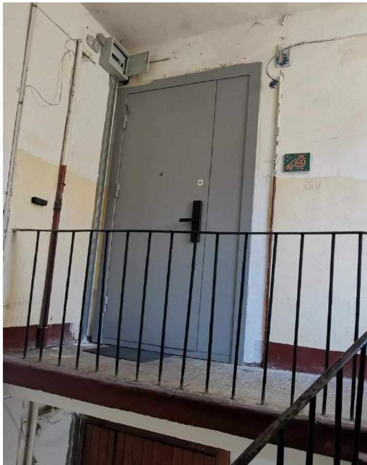
Фото №101. Парадная лестница №9. Площадка 6 этажа.
