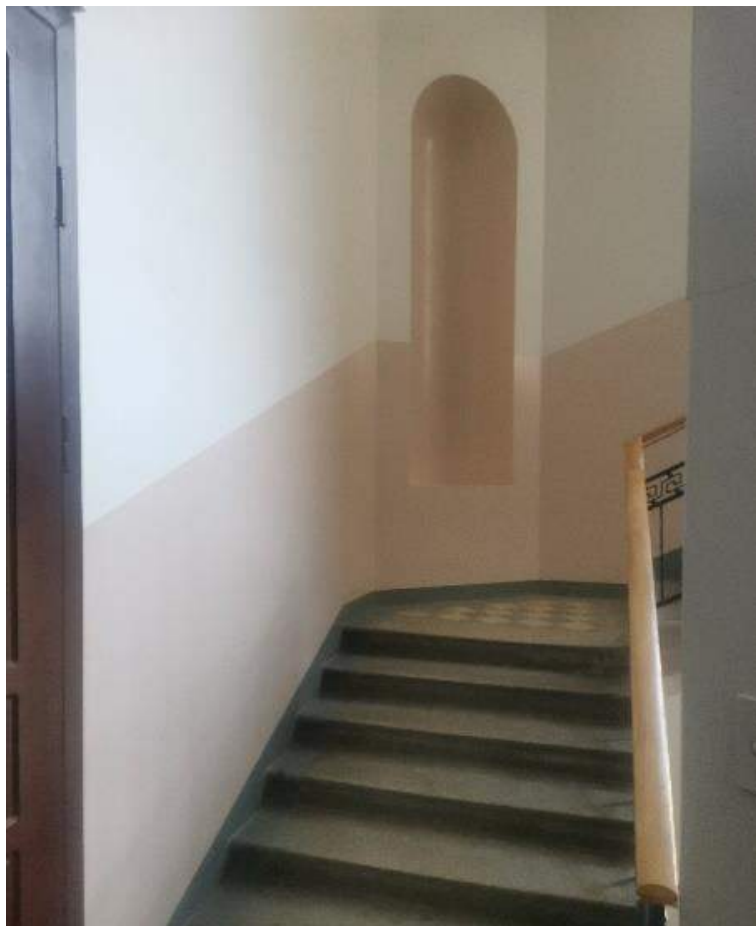
Фото №54. Парадная лестница №1. Лестничный марш, вид с третьего этажа.
