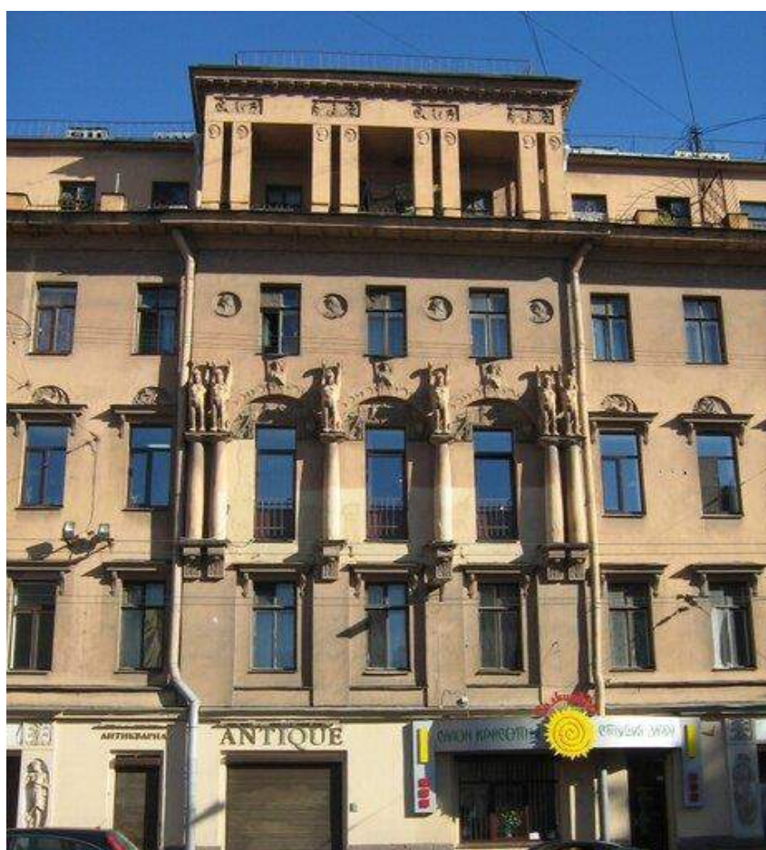
Илл.7. Фрагмент фасада дома № 3 по Большой Пушкарской улице без балконов. Фото до 2015г.
