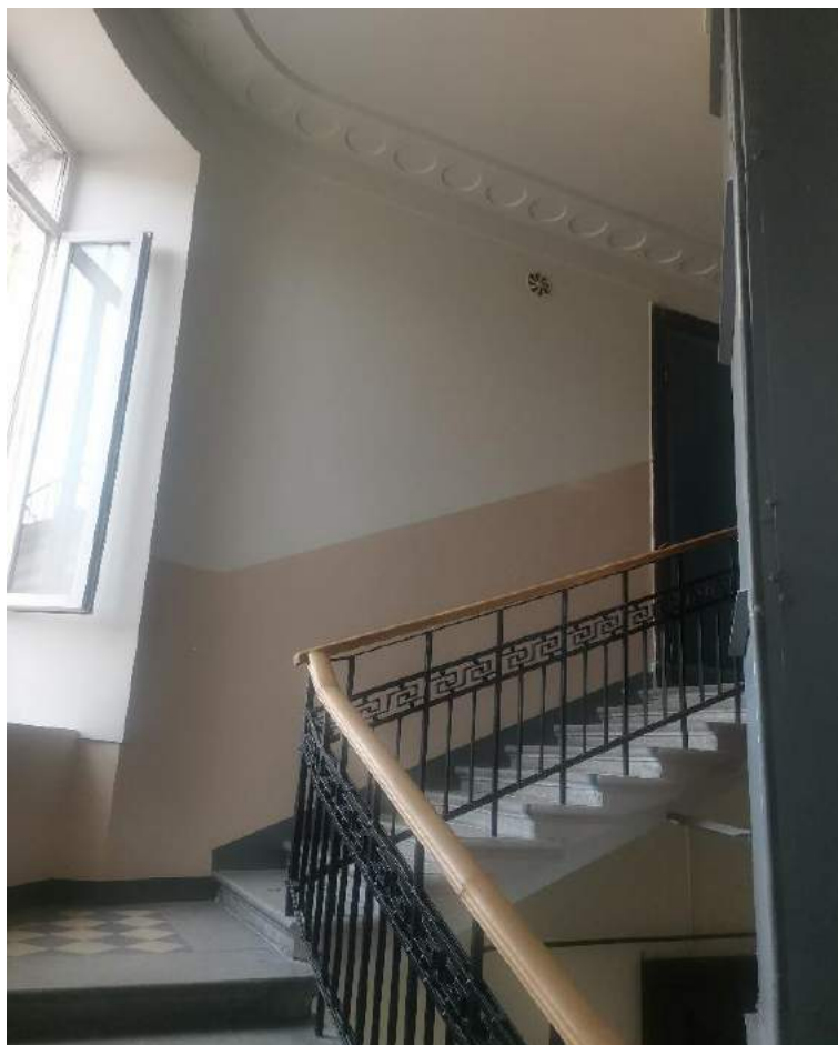
Фото №59. Парадная лестница №1. Лестничный марш, вид в сторону пятого этажа.
