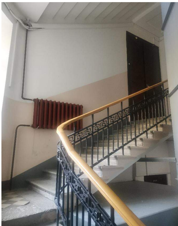
Фото №38. Парадная лестница №1. Лестничный марш, вид с первого этажа
