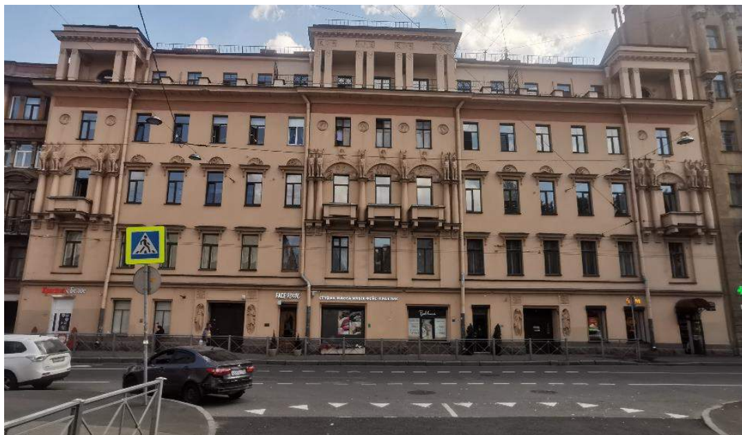
Фото №1. Лицевой фасад, вид с Большой Пушкарской ул.
