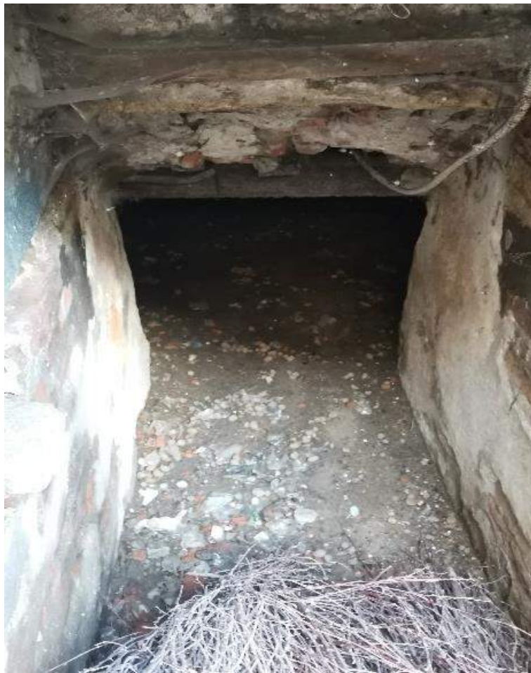
Фото №103. Вход в подвал со двора.
