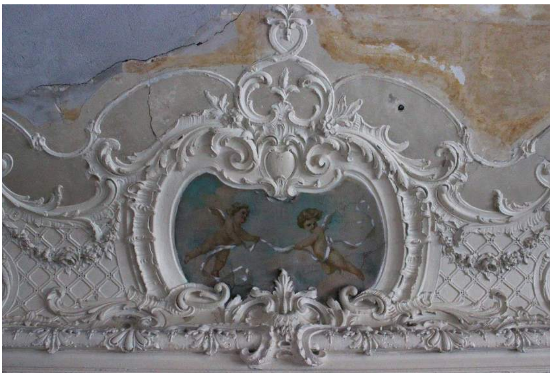
Илл.44. Левая парадная. Квартиры. На 3 этаже. Фото Олега Еверзова, 04.2017. (Источник: https://p0.citywalls.ru/photo_382-391168.jpg?mt=1555106146 )
