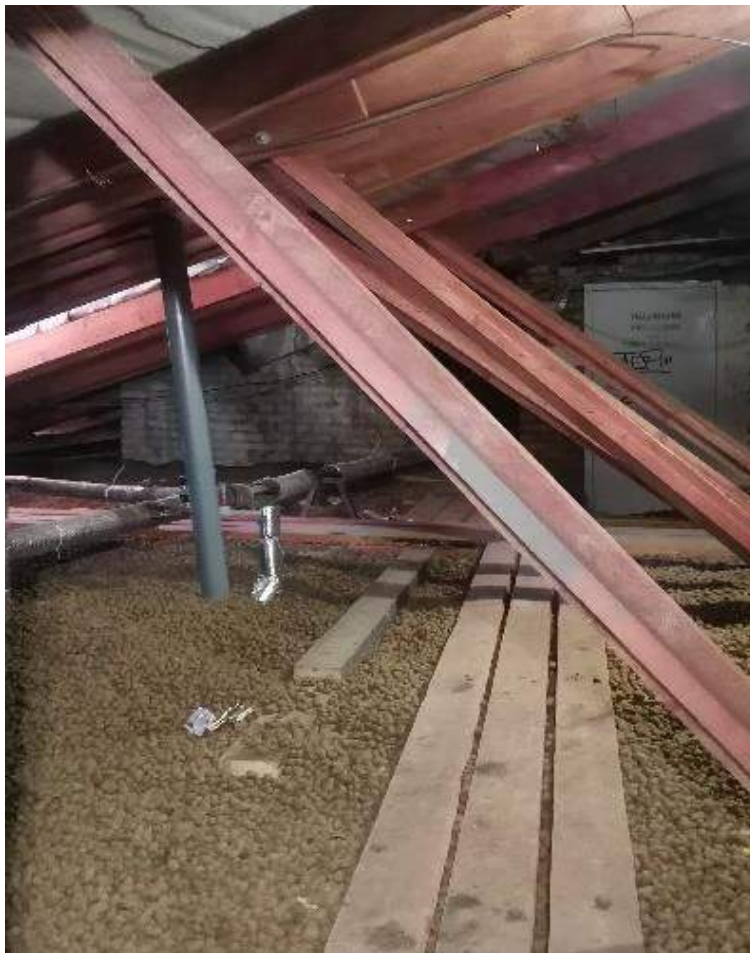
Фото №81. Парадная лестница №8. Чердак.
