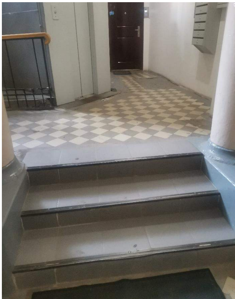
Фото №35. Парадная лестница №1. Лестница на первом этаже.
