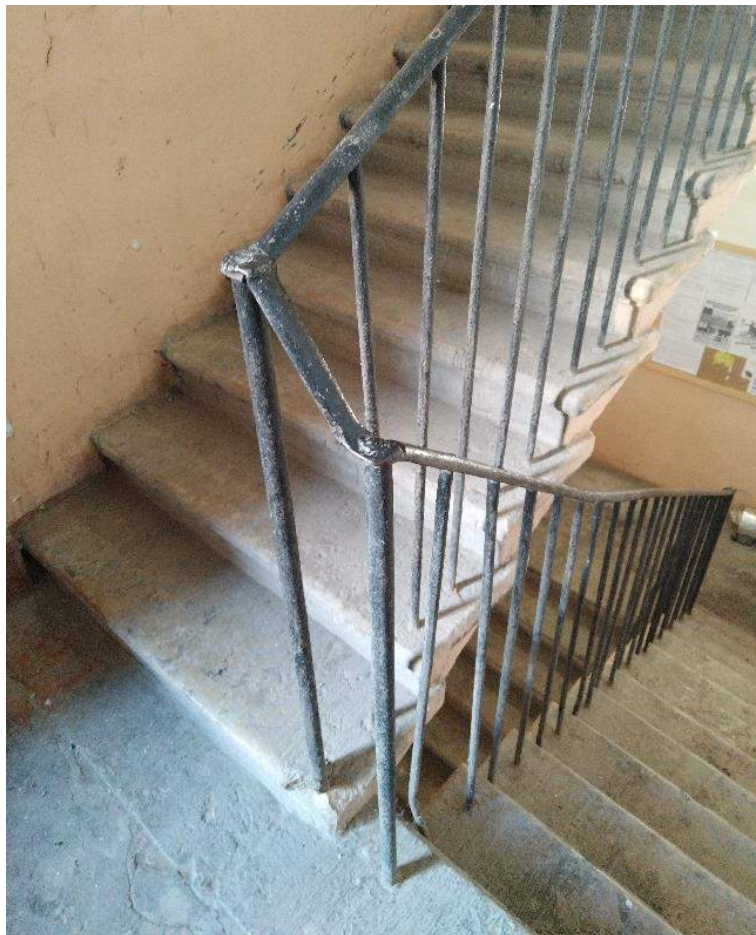
Фото №67. Парадная лестница №8. Лестничные марши, вид со второго этажа.
