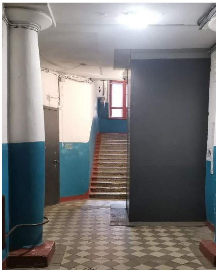
Фото №14. Парадная лестница №2. Вестибюль.
