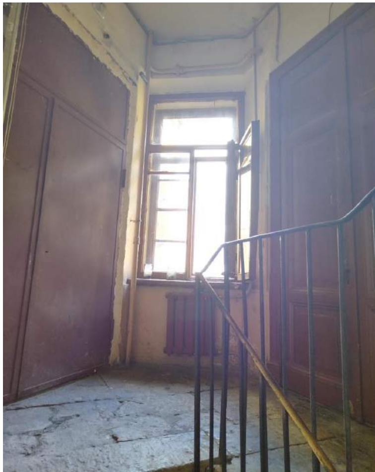
Фото №75. Парадная лестница №8. Площадка четвертого этажа.
