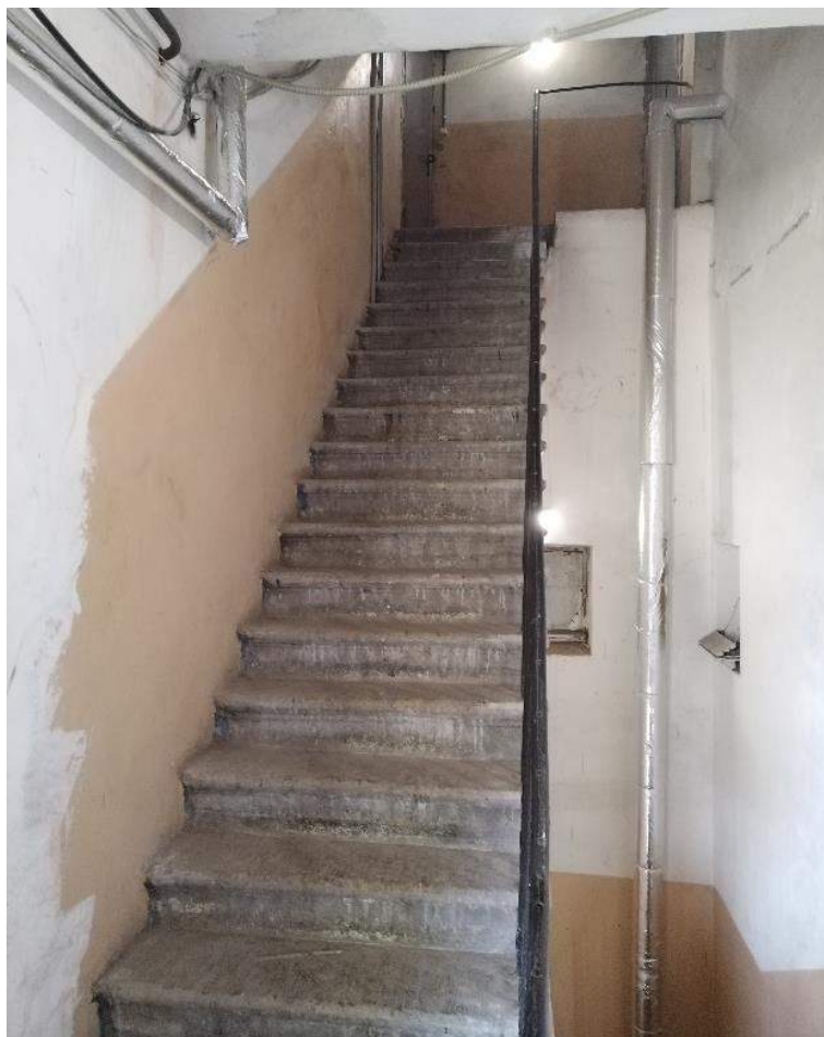
Фото №79. Парадная лестница №8. Лестничный марш, вид с пятого этажа.
