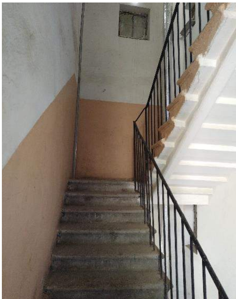
Фото №76. Парадная лестница №8. Лестничный марш, вид с четвертого этажа.
