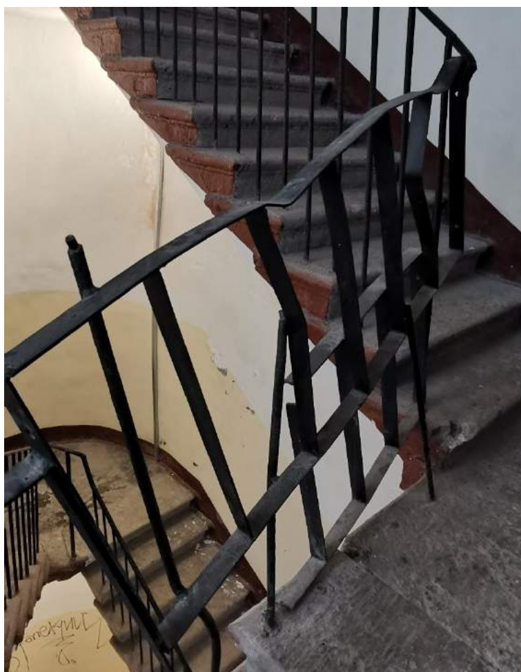
Фото №92. Парадная лестница №9. Лестничный марш, вид с третьего этажа.
