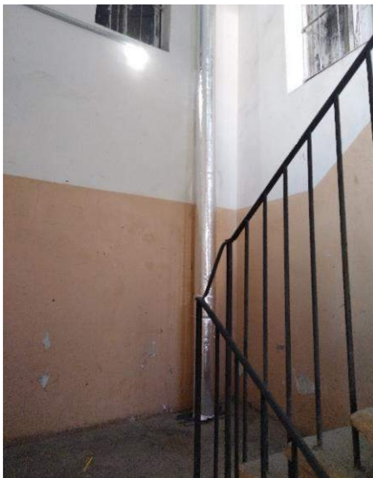
Фото №70. Парадная лестница №8. Междуэтажная площадка между 2 и 3 этажами.
