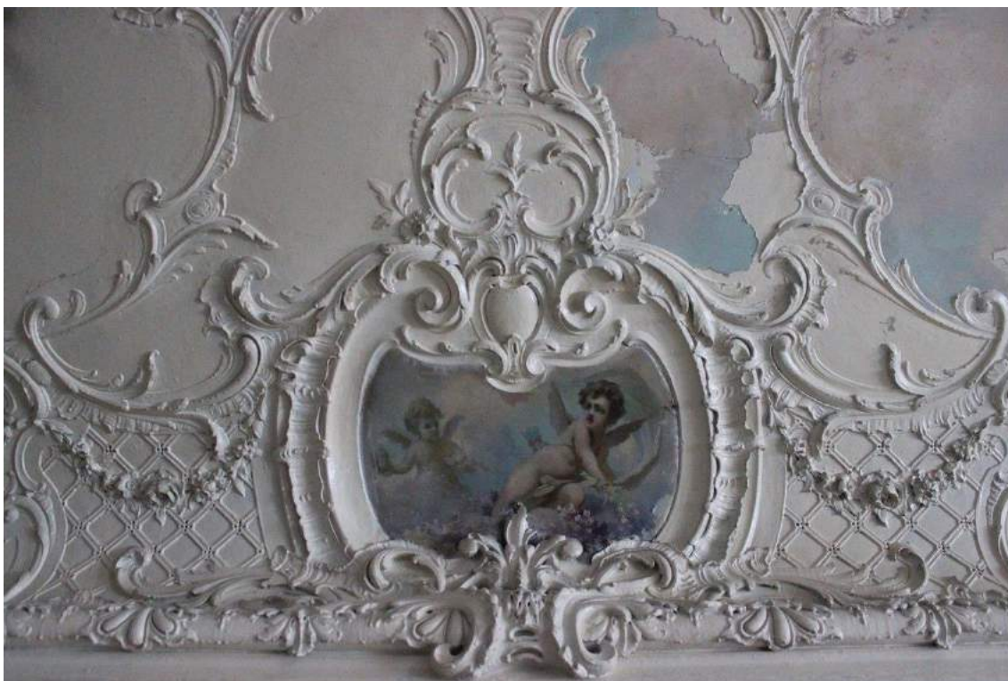
Илл.43. Левая парадная. Квартиры. На 3 этаже. Фото Олега Еверзова, 04.2017. (Источник: https://p2.citywalls.ru/photo_381-391166.jpg?mt=1555106129 )
