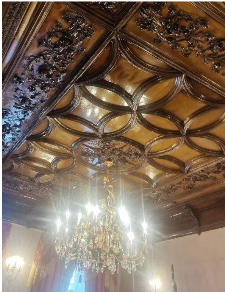
Фото №53. Помещение 1-Н. Комната 37.8 кв.м. Оформление потолка
