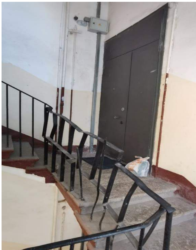
Фото №91. Парадная лестница №9. Площадка третьего этажа.
