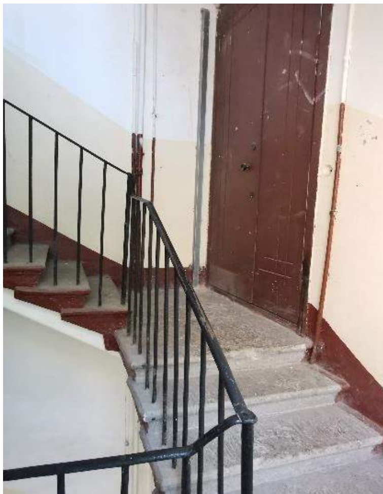
Фото №95. Парадная лестница №9. Площадка четвертого этажа.
