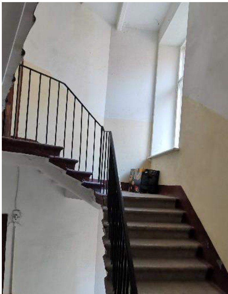
Фото №97. Парадная лестница №9. Лестничный марш, междуэтажная площадка на уровне 5 этажа.
