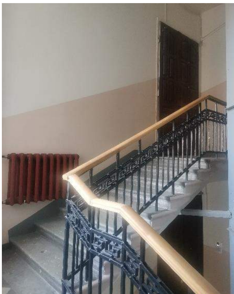
Фото №56. Парадная лестница №1. Лестничный марш, вид в сторону четвертого этажа.
