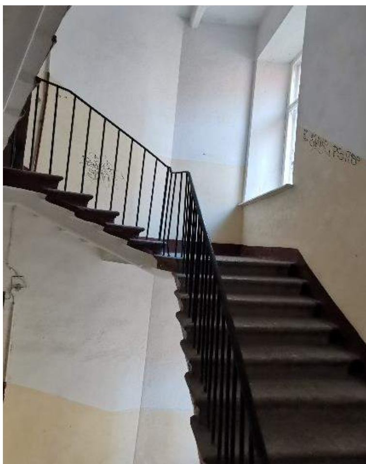
Фото №94. Парадная лестница №9. Лестничный марш, междуэтажная площадка на уровне 4 этажа.
