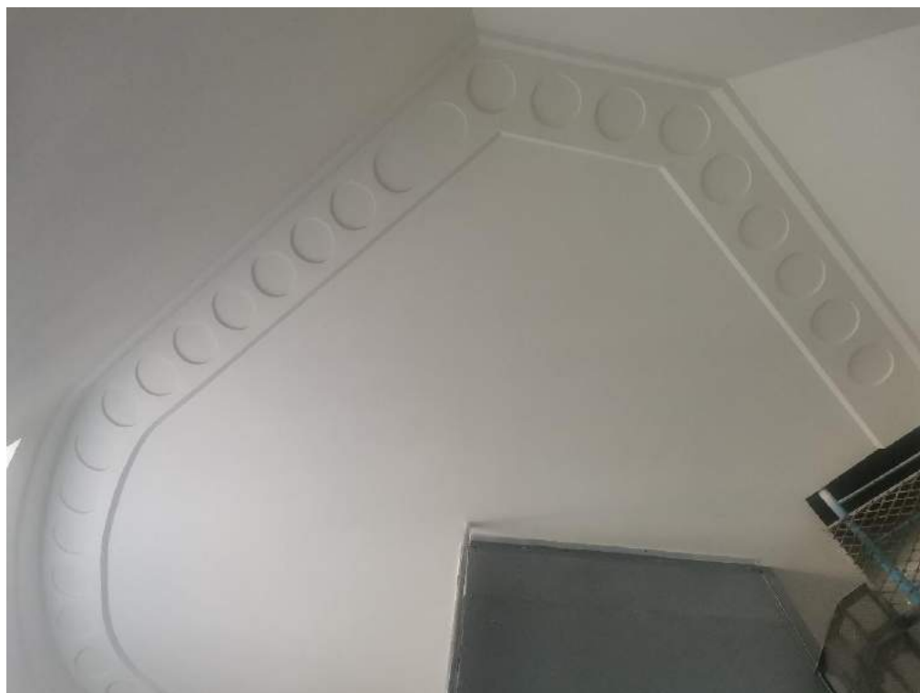
Фото №62. Парадная лестница №1. Оформление потолка на шестом этаже.
