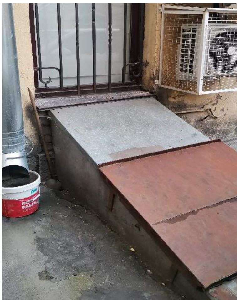
Фото №102. Вход в подвал со двора.
