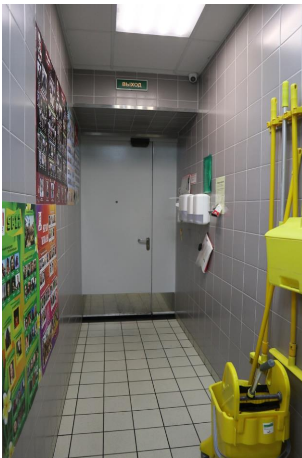
Фото 1.2. 1 этаж, коридор, помещение 1-Н (10).
