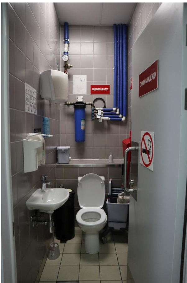
Фото 1.4. 1 этаж, санузел, помещение 1-Н (10).
