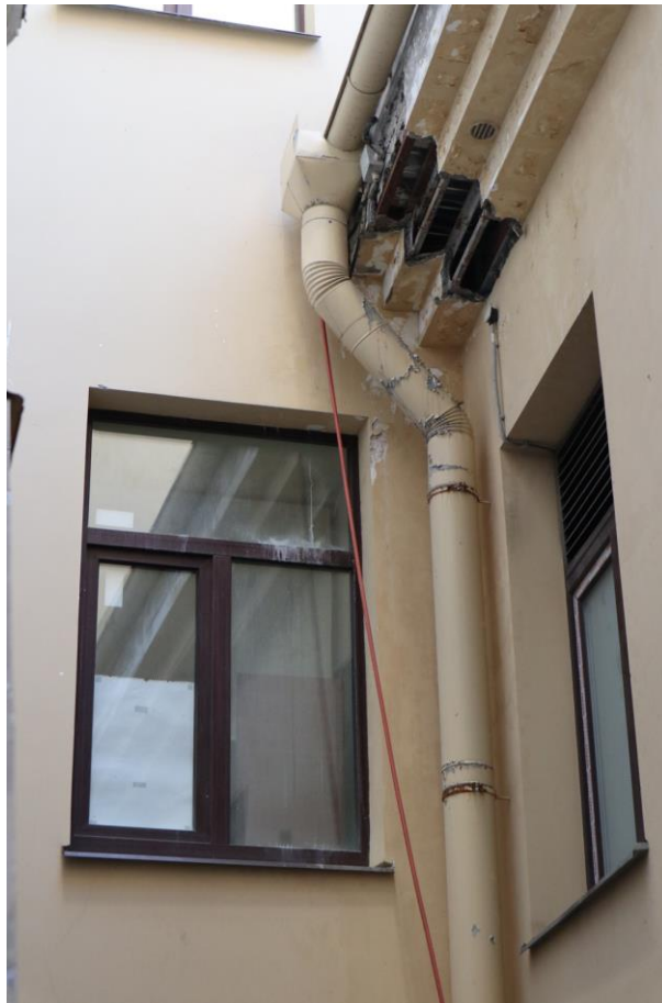
Фото 12. Фрагмент дворового фасада северной части здания, оконные проемы первого этажа.
