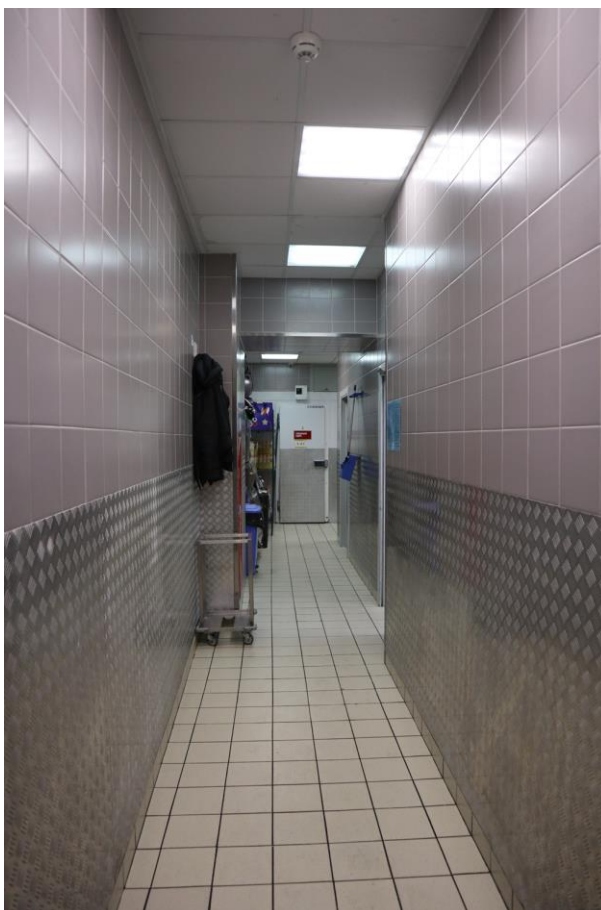
Фото 1.16. 1 этаж, коридор, помещение 1-Н (8).
