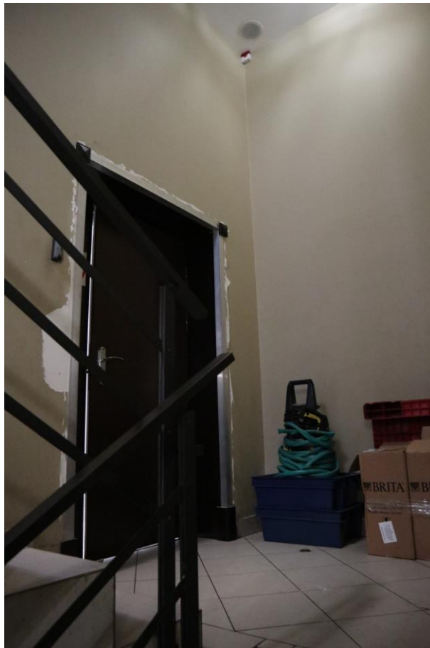
Фото 1.41. 1 этаж, лестница, помещение 1-Н (9).
