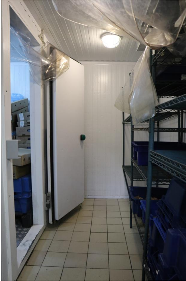
Фото 1.9. 1 этаж, служебное помещение 1-Н (10).
