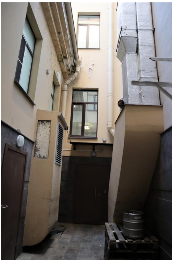
Фото 9. Фрагмент дворового фасада северной части здания.
