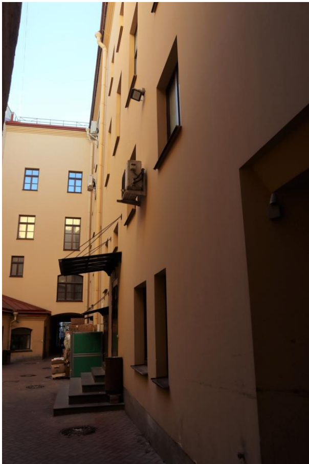
Фото 7. Фрагмент дворового фасада восточной части здания.
