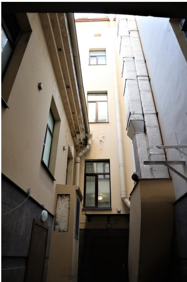
Фото 8. Фрагмент дворового фасада северной части здания.
