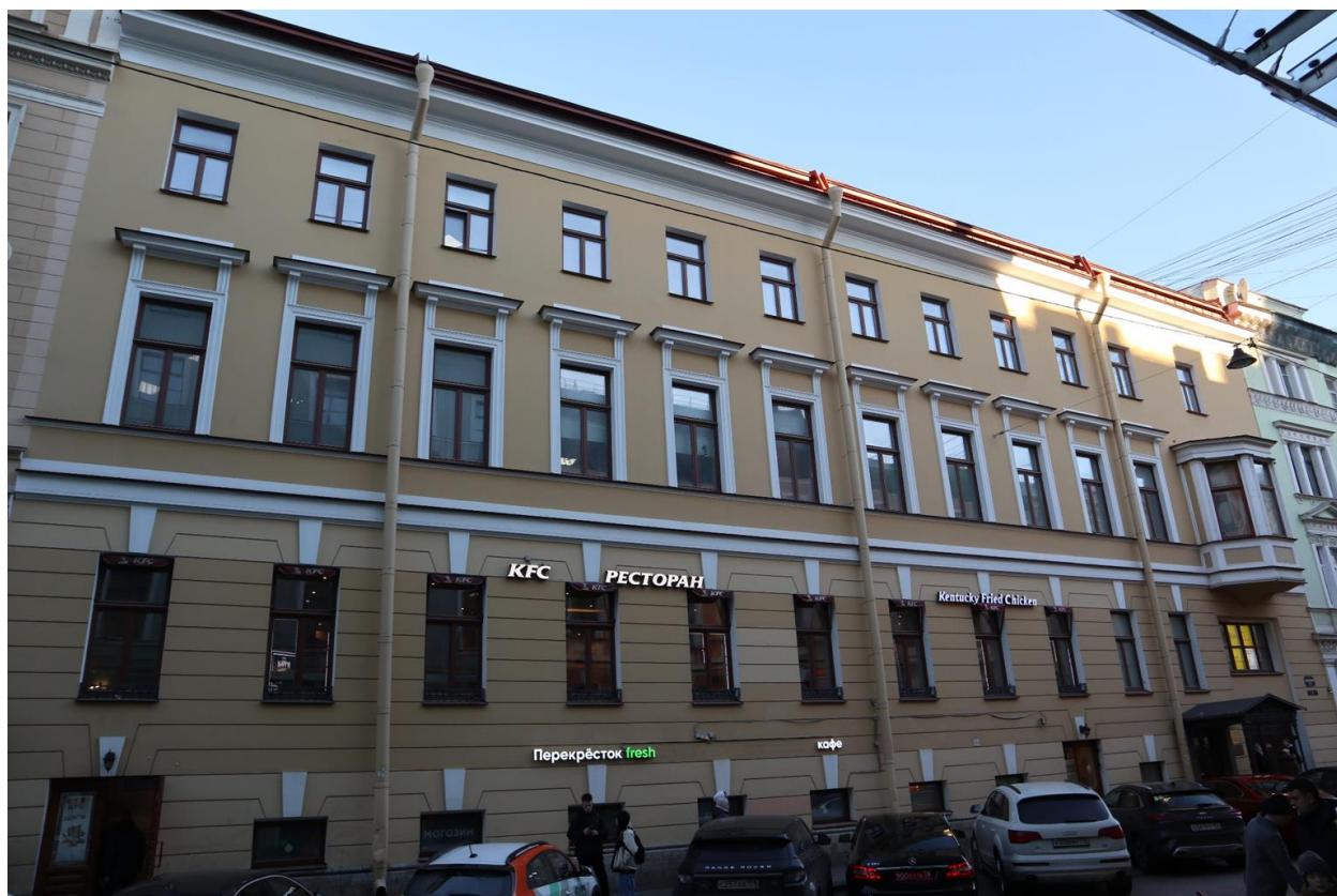
Фото 3. Лицевой фасад, Кирпичный переулок.
