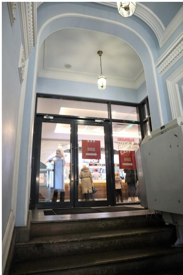
Фото 1.36. 1 этаж, парадная лестница, помещение 1-Н (7).
