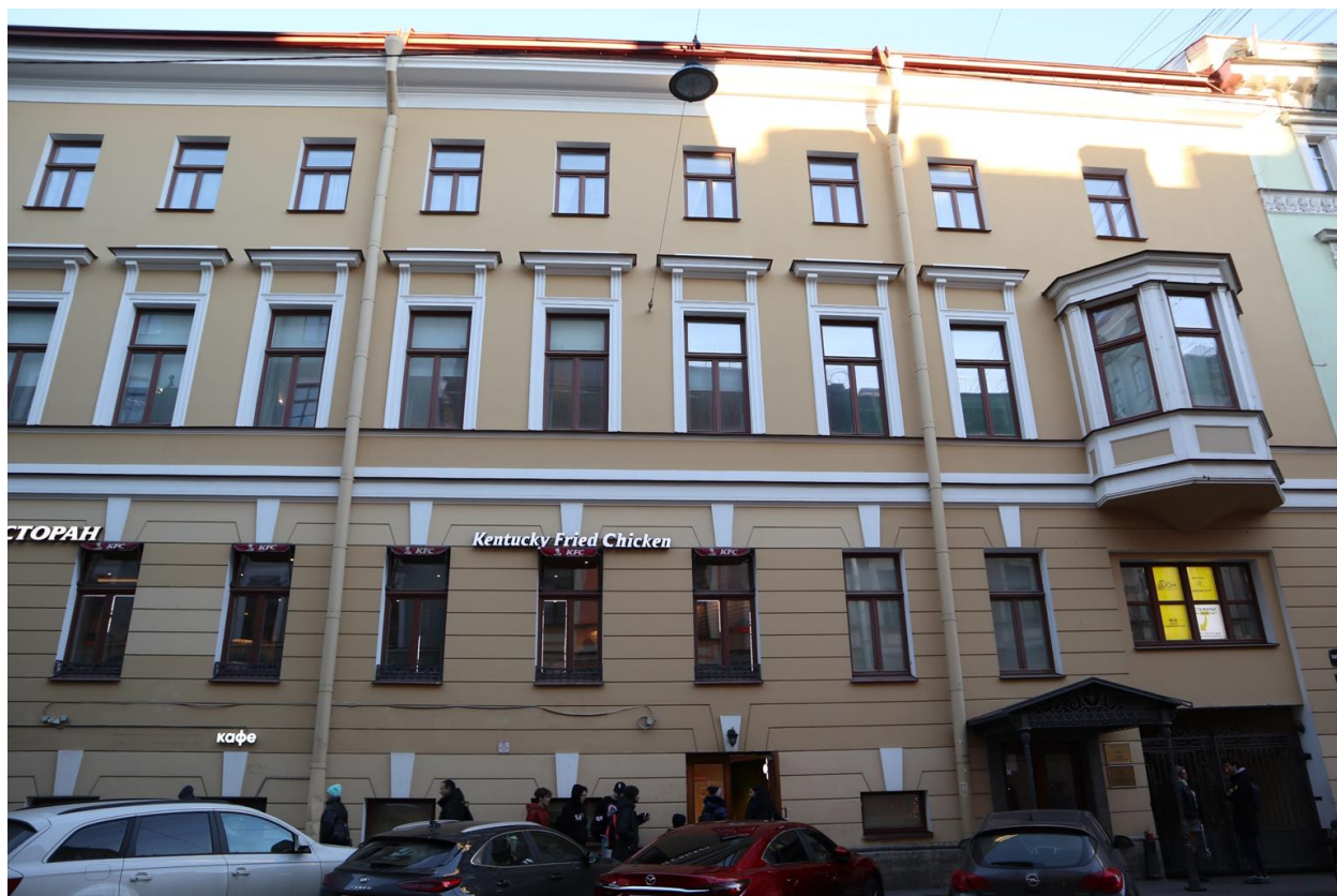
Фото 2. Лицевой фасад, Кирпичный переулок.
