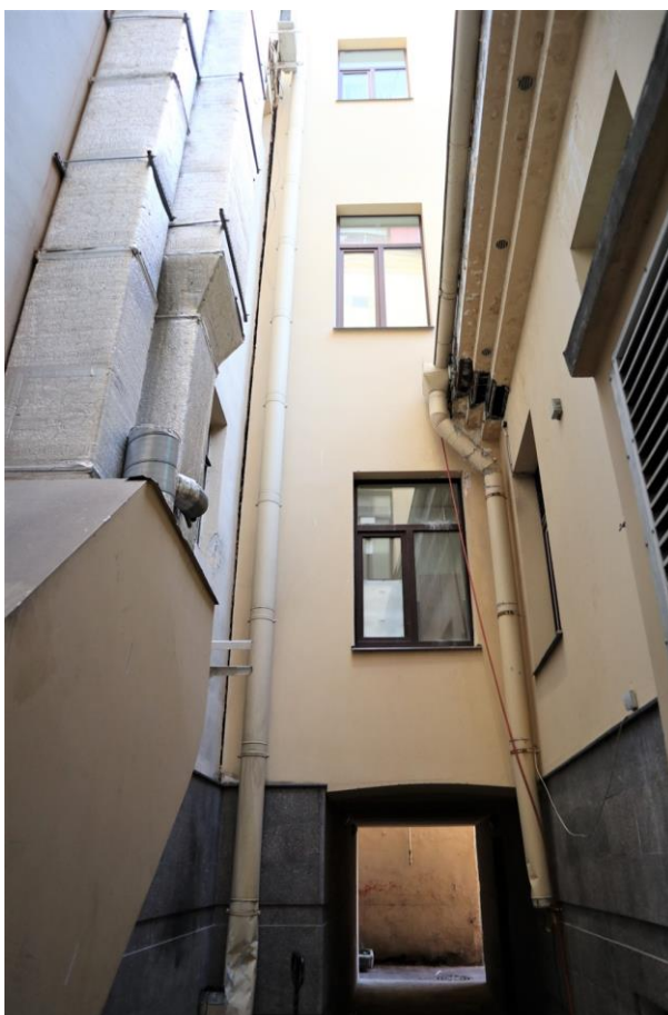
Фото 11. Фрагмент дворового фасада северной части здания.
