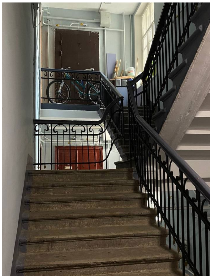
Фото №17. Вид со второго этажа на 3 этаж.
