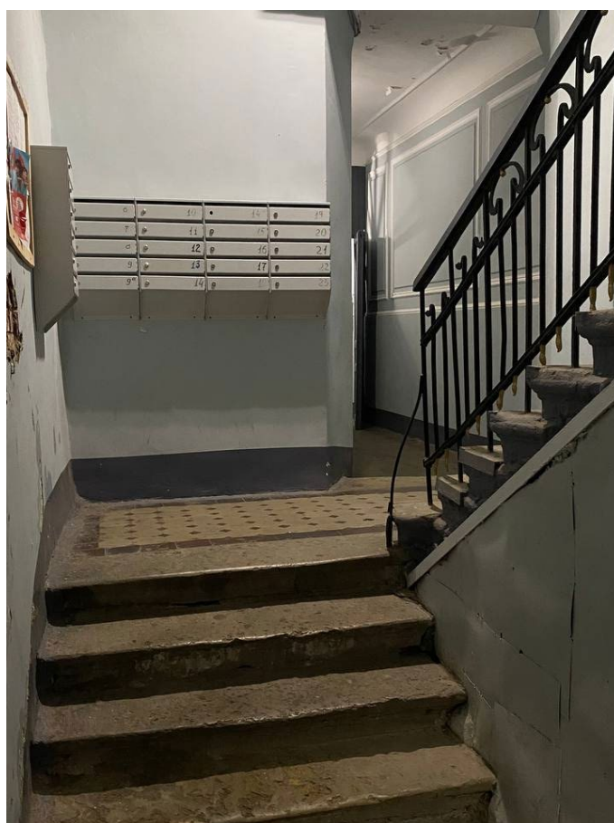
Фото №14. Вид от квартир 1 этажа в сторону тамбура.
