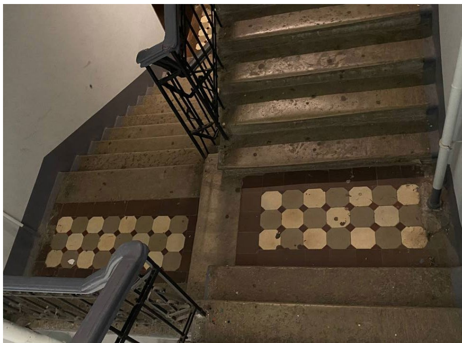
Фото №36. Метлахская плитка междуэтажной площадки 2 и 3 этажа (типовая на всех этажах).
