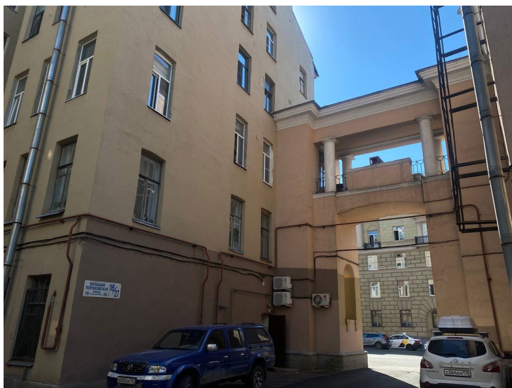
Фото №8. Арка во двор, вид со двора на Среднеохтинский проспект.
