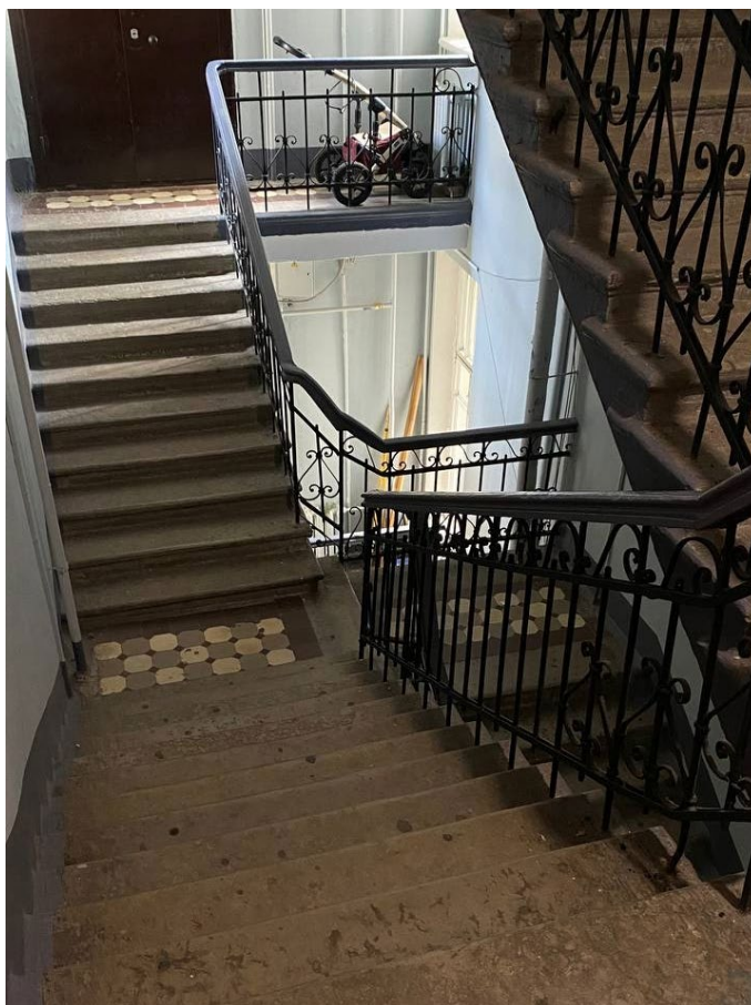
Фото №39. Вид с площадки 4 этажа на междуэтажную площадку 3 и 4 этажа.
