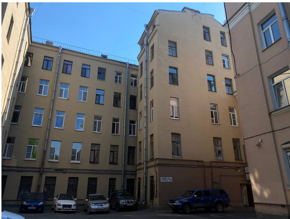
Фото №7. Дворовой фасад, флигель, расположенный вдоль Среднеохтинского проспекта.
