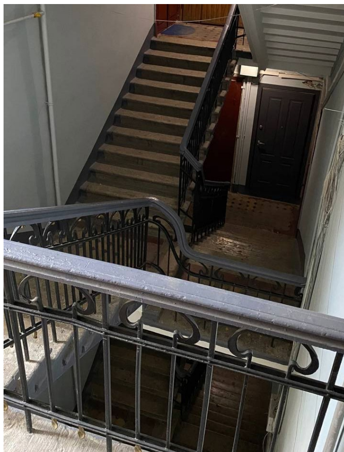
Фото №25. Вид с площадки 5 этажа на 4 этаж.
