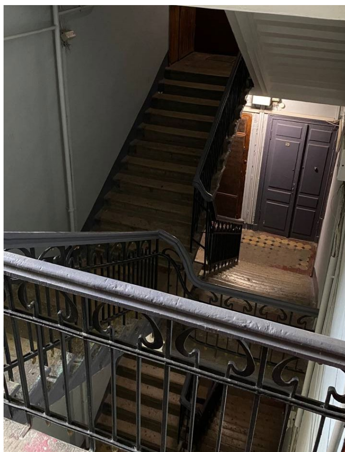
Фото №22. Вид с площадки 4 этажа на 3 этаж.
