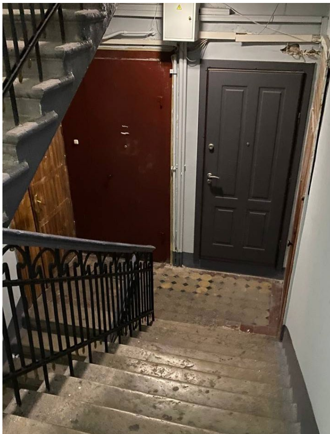
Фото №24. Квартиры 4 этажа, площадка 4 этажа.
