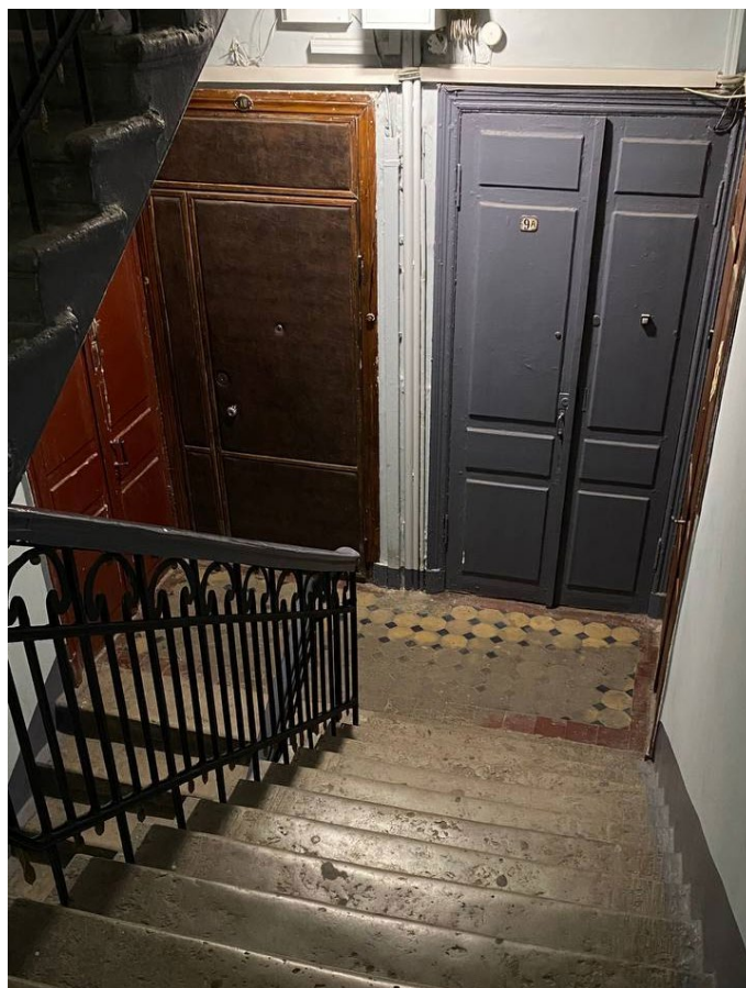
Фото №21. Квартиры 3 этажа, площадка 3 этажа.
