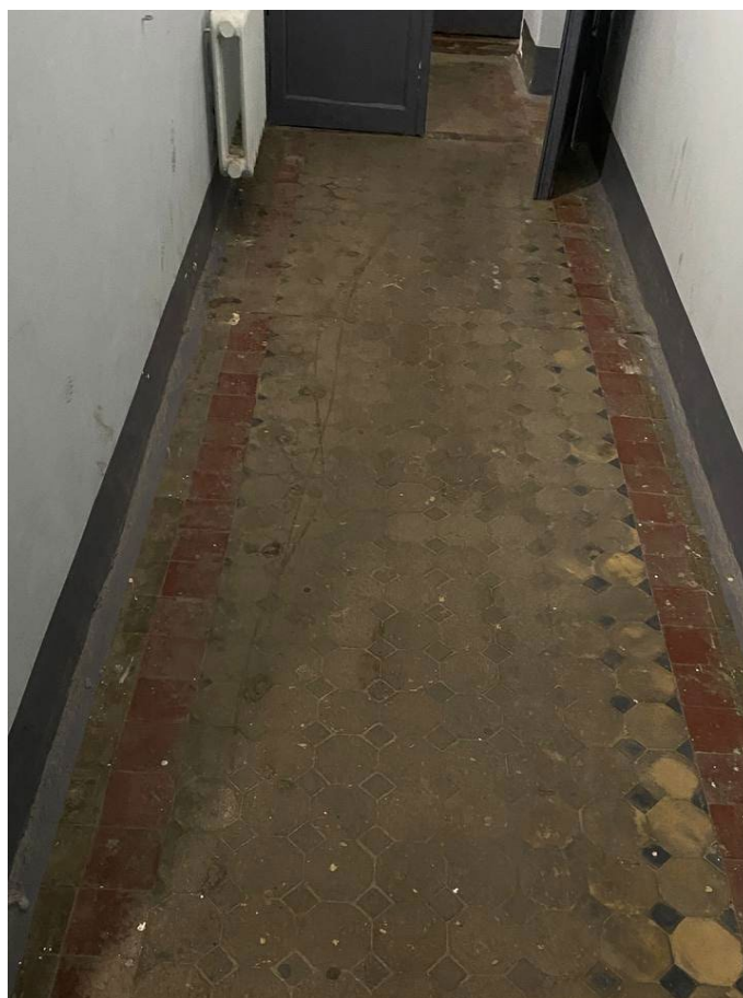
Фото №12. Метлахская плитка в тамбуре, вид от лестницы.
