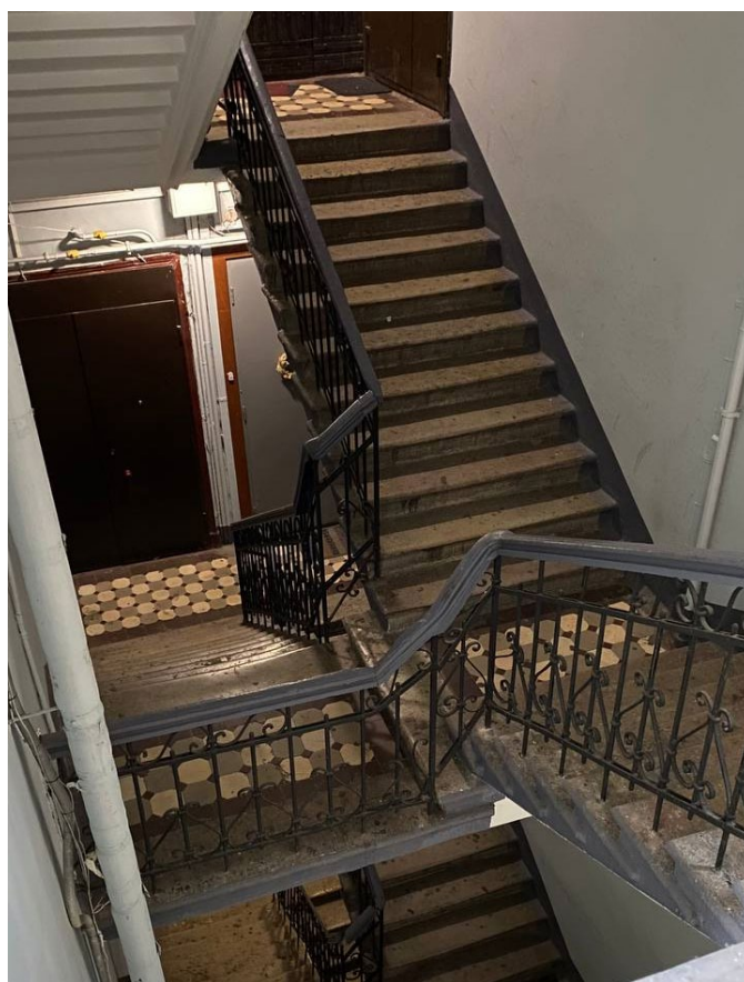
Фото №34. Вид с площадки 3 этажа на 2 этаж. Метлахская плитка междуэтажной площадок
