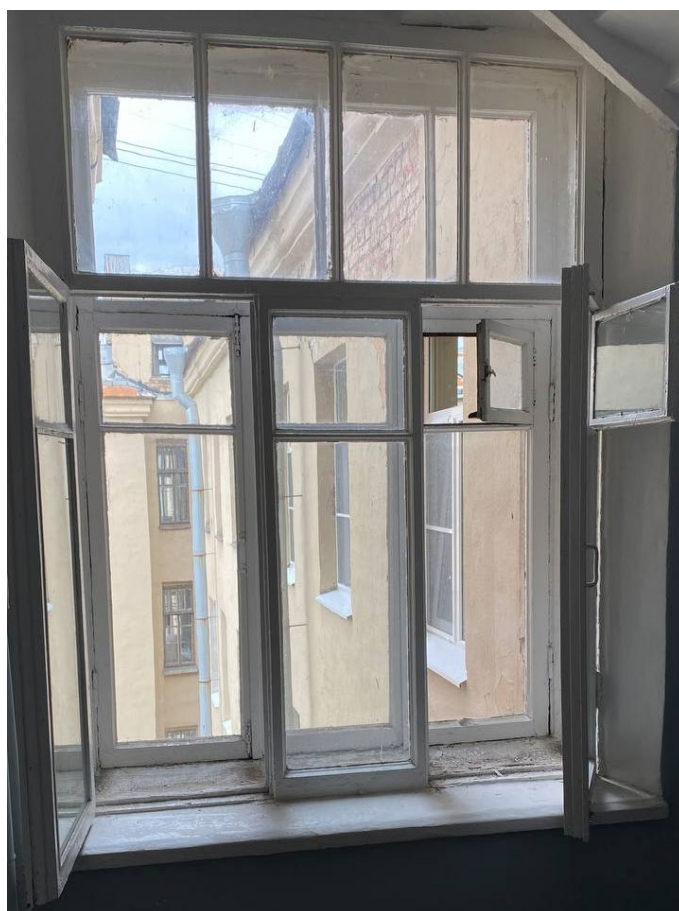
Фото №26. Оконный проем на площадке 5 этажа (типовой для всех этажей).
