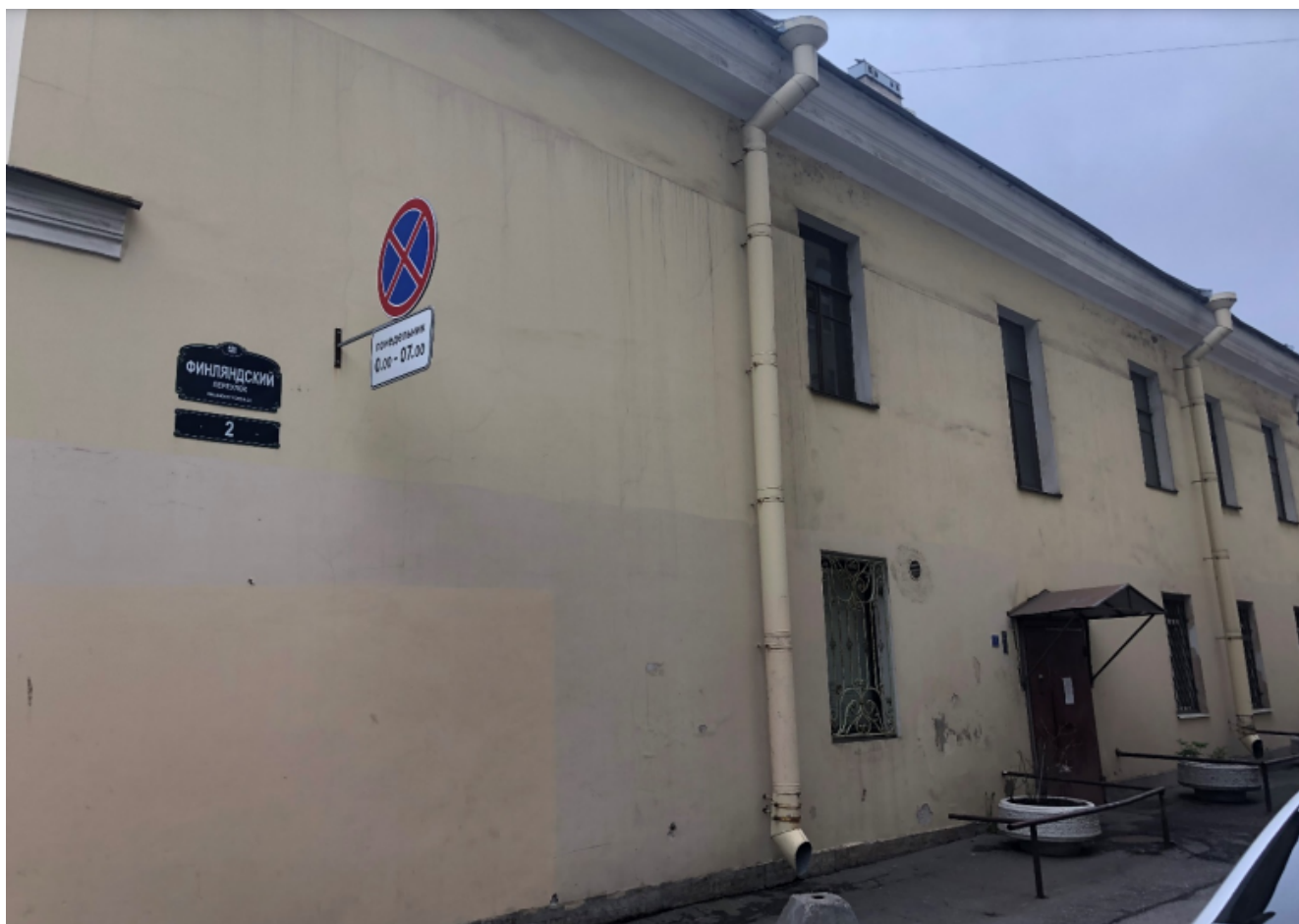
3. Вид на фасад здания с Финляндского переулка;
