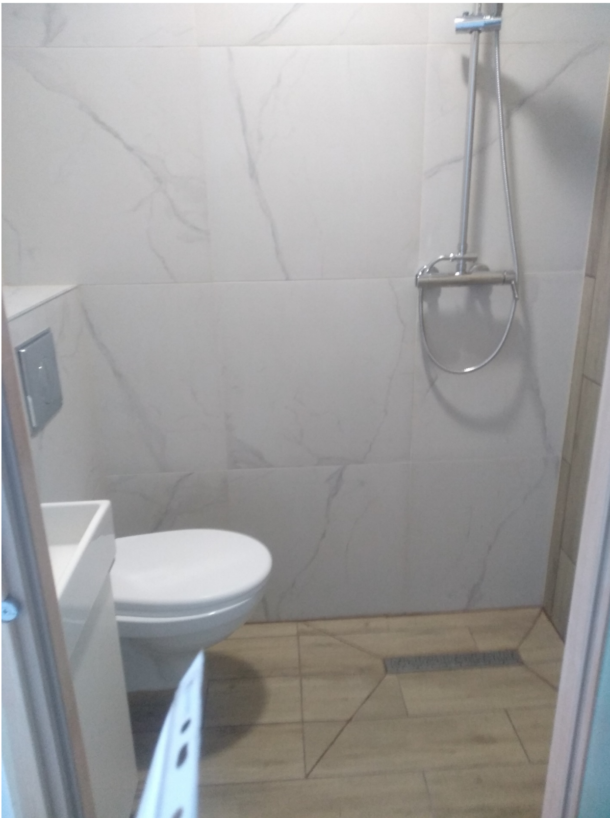
16. Фрагмент интерьера совмещенного санузла помещение (№11)
