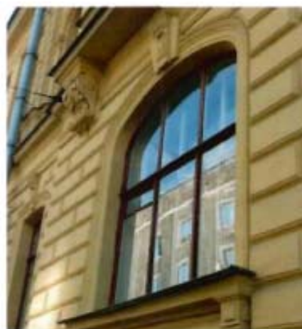
3. Историческая оконная рама на фасаде здания
