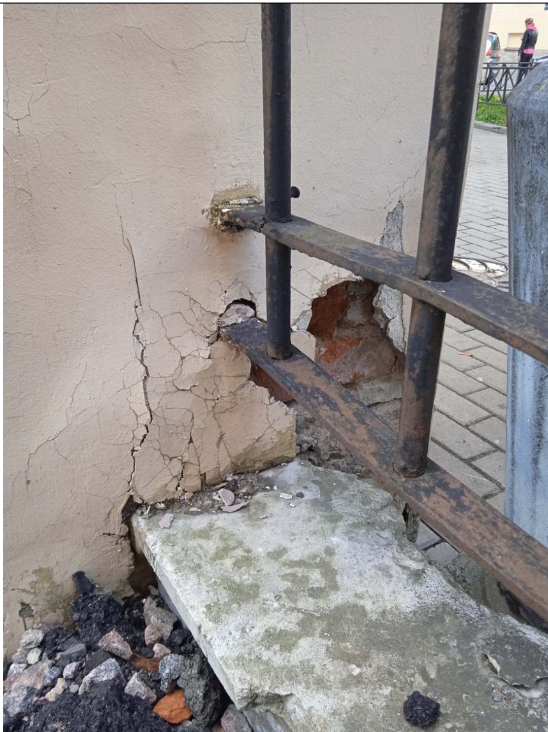
9. Особняк Горчакова К.А. Ограда по линии улицы. Участок примыкания ограды к стене здания.
