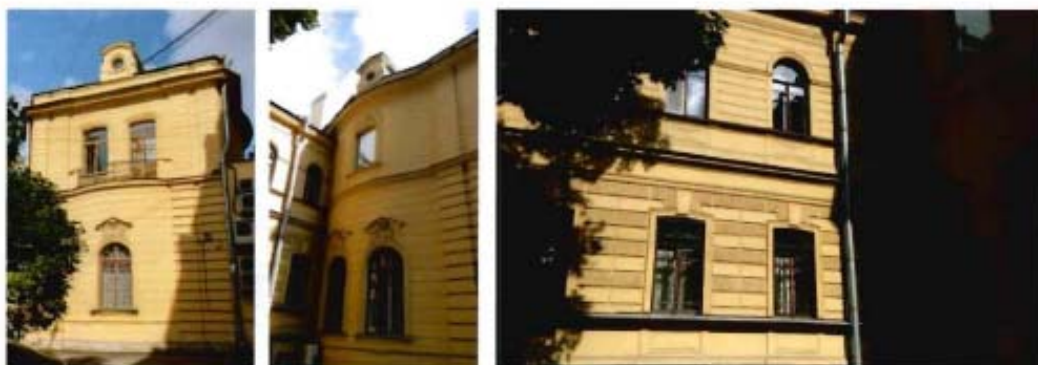
6,7,8. Дворовой фасад здания с южной стороны
