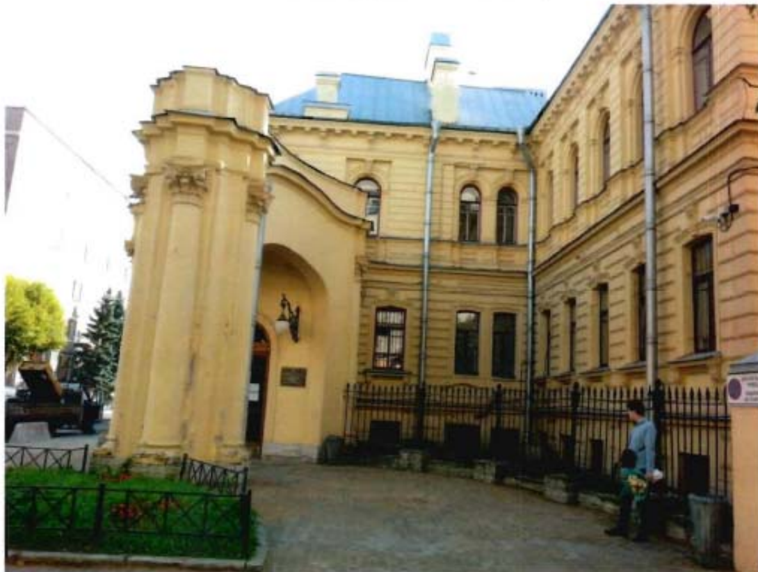
9. Фасад здания с восточной стороны
