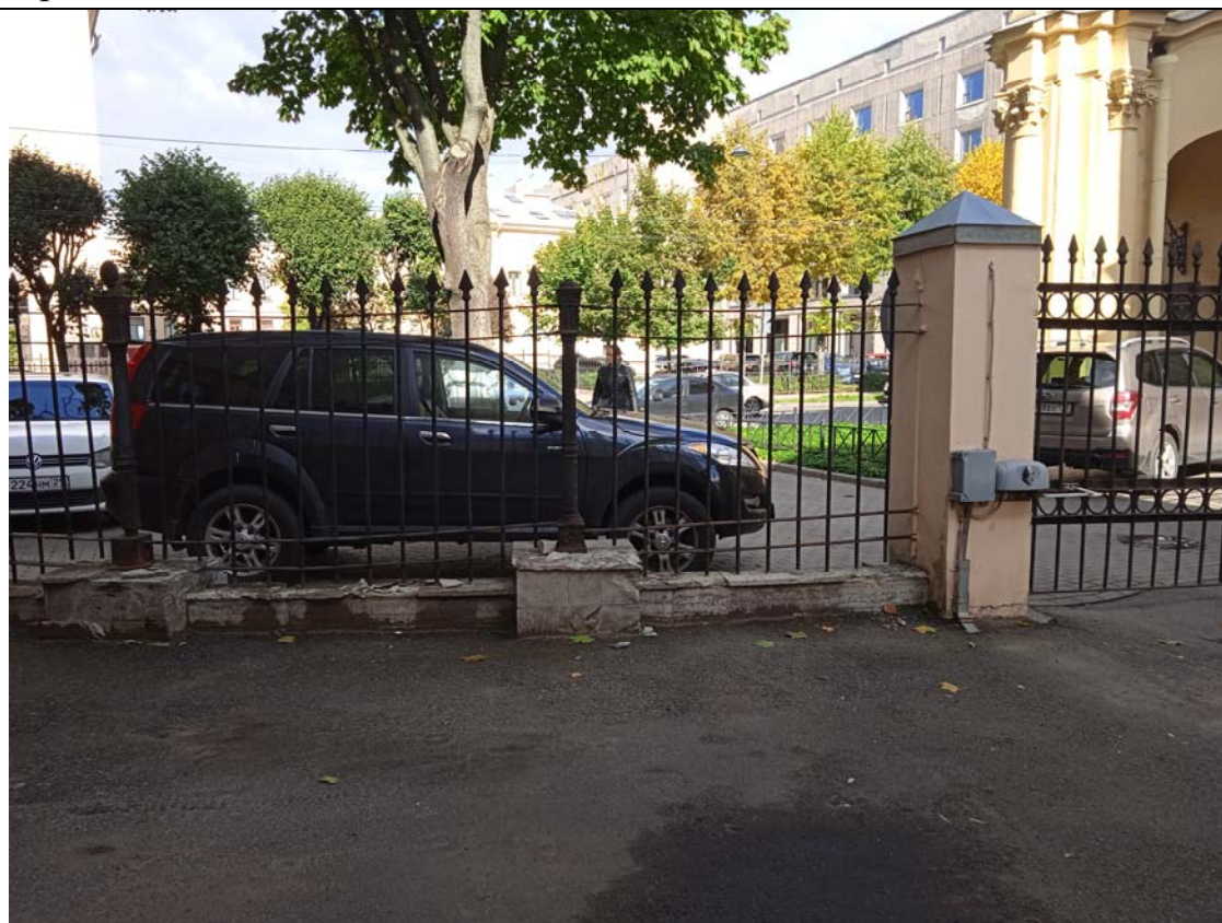
4. Особняк Горчакова К.А. Ограда по линии улицы. Фрагмент.
