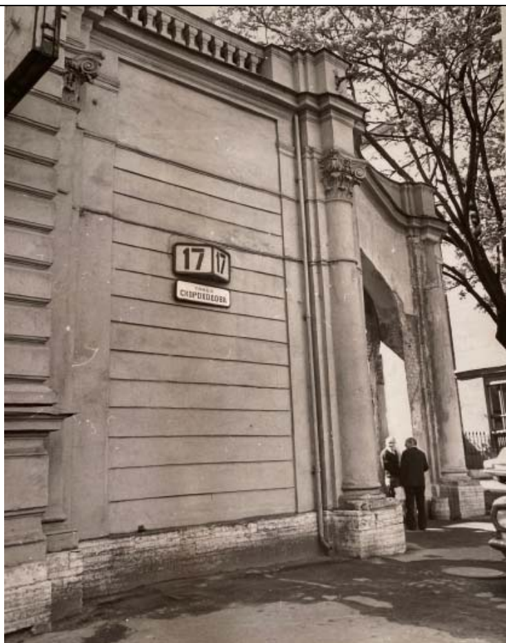
11. Фрагмент северного фасада. Фото 1991 г.
