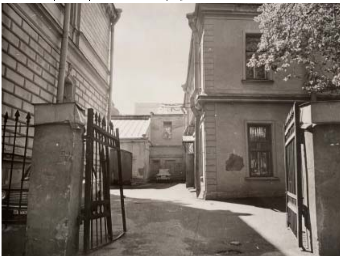
13. Северный фасад. Общий вид. Входная группа. Фото 1991 г.
