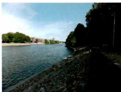
50. Береговой откос р. Большой Невки, облицованный булыжником.
