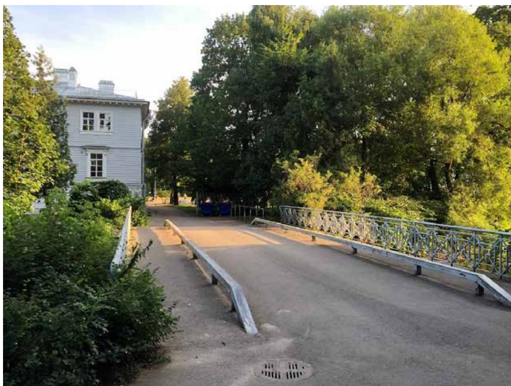
Фото 49. Вид на мост в северо-восточной части.
