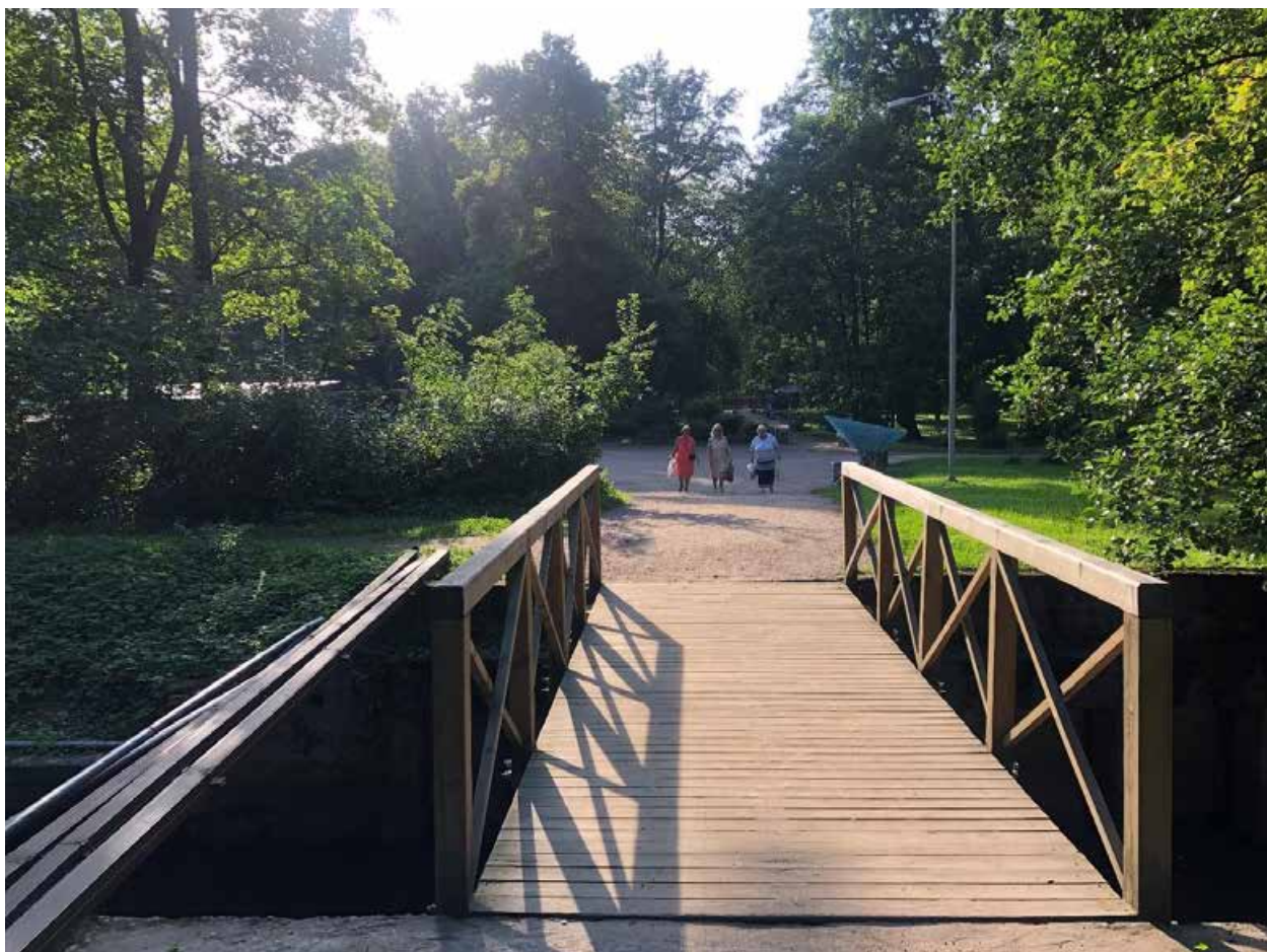
Фото 25. Мост в северо-западной части.
