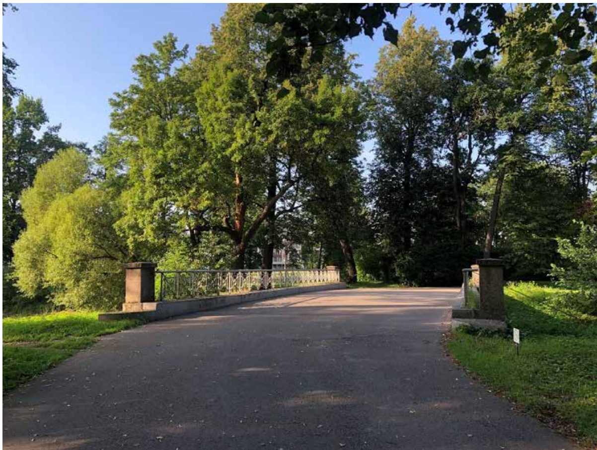
Фото 29. Мост на северо-западе.
