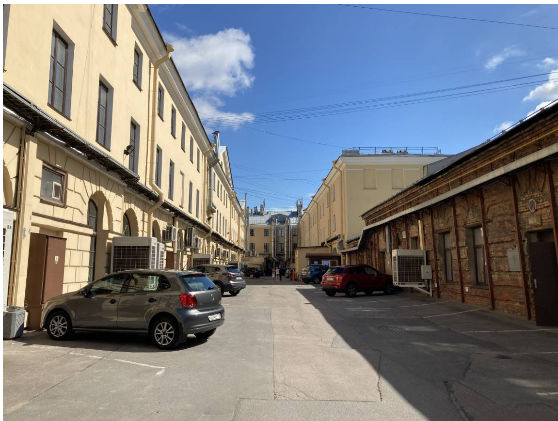
Фото 22. Фрагмент дворового фасада объекта культурного наследия федерального значения «Казармы(Трехэскадронный корпус)»
