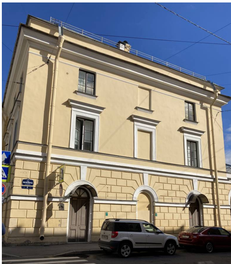
Фото 3. Лицевой фасад объекта культурного наследия федерального значения «Казармы(Трехэскадронный корпус)».
