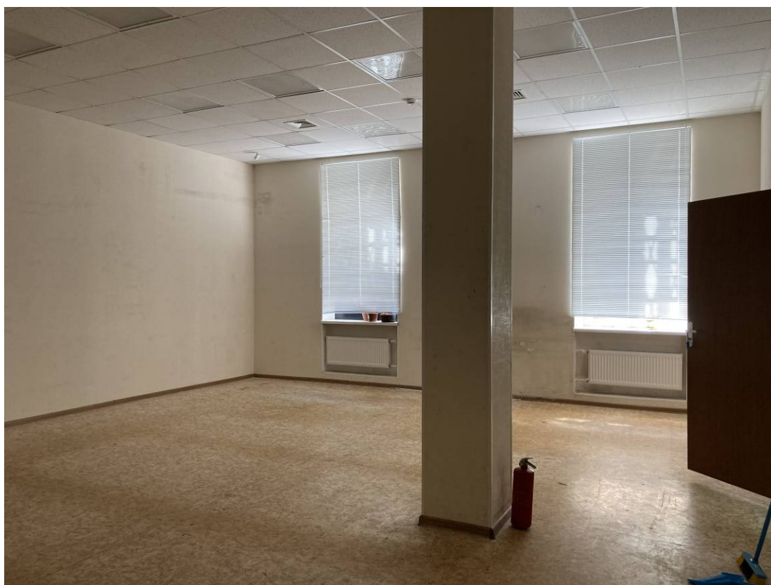
Фото 26. Интерьер объекта культурного наследия федерального значения «Казармы(Трехэскадронный корпус)», пом. 90-Н
