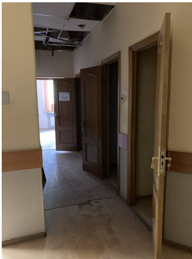
Фото 49. Интерьер объекта культурного наследия федерального значения «Казармы(Трехэскадронный корпус)», пом. 129-Н
