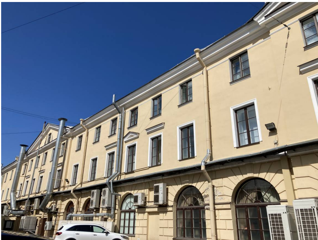
Фото 21. Фрагмент дворового фасада объекта культурного наследия федерального значения «Казармы(Трехэскадронный корпус)»
