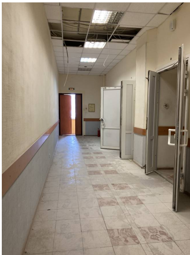
Фото 43. Интерьер объекта культурного наследия федерального значения «Казармы(Трехэскадронный корпус)», пом. 129-Н
