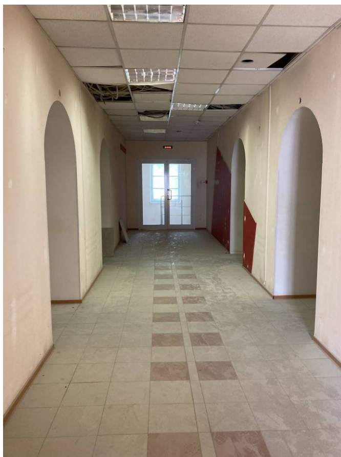
Фото 66. Интерьер объекта культурного наследия федерального значения «Казармы(Трехэскадронный корпус)», пом. 130-Н
