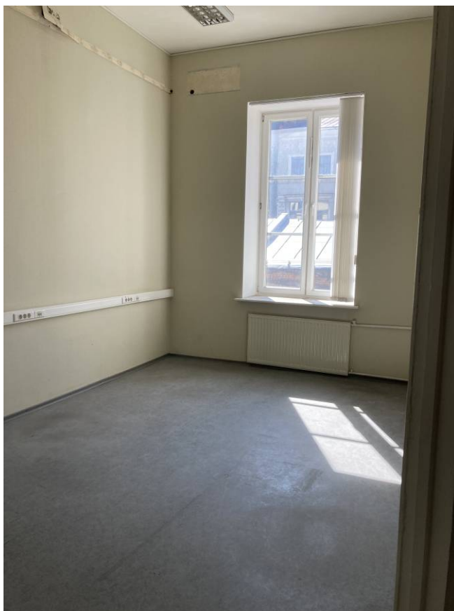
Фото 39. Интерьер объекта культурного наследия федерального значения «Казармы(Трехэскадронный корпус)», пом. 53-Н
