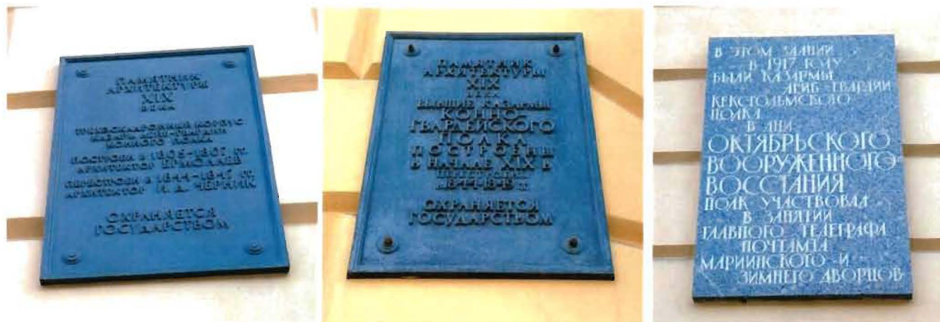
6. Юго-восточный фасад трехэтажного корпуса.
