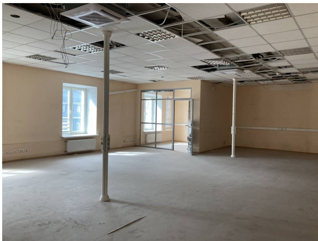
Фото 72. Интерьер объекта культурного наследия федерального значения «Казармы(Трехэскадронный корпус)», пом. 130-Н
