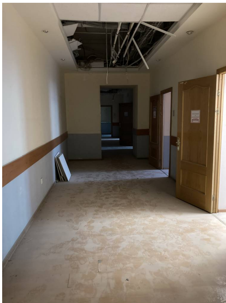
Фото 48. Интерьер объекта культурного наследия федерального значения «Казармы(Трехэскадронный корпус)», пом. 129-Н
