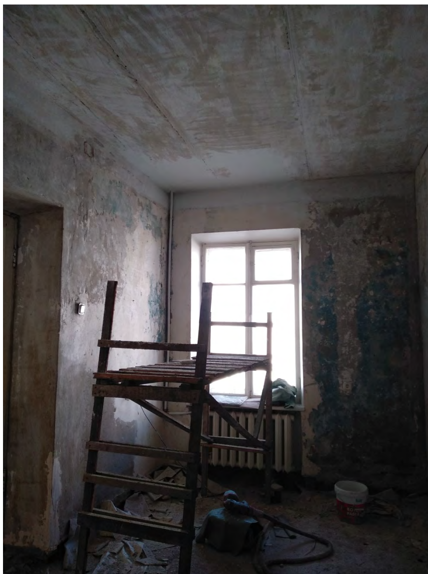
Фото 13. Комната (пом. №6 по проектной экспликации).
