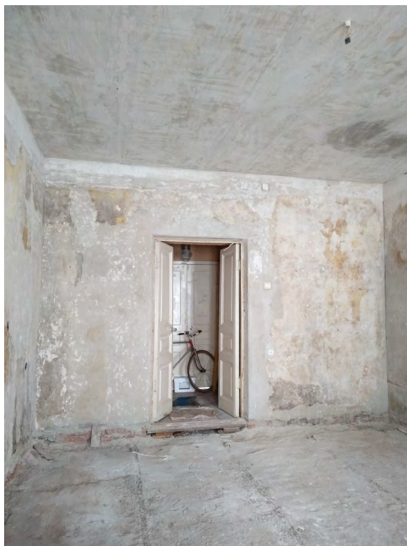
Фото 12. Комната (пом. №5 по проектной экспликации).
