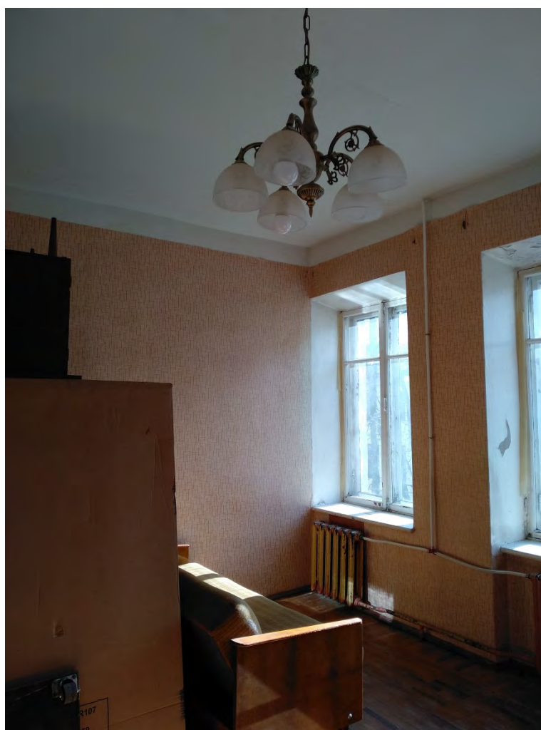
Фото 18. Комната (пом. №2 по проектной экспликации).
