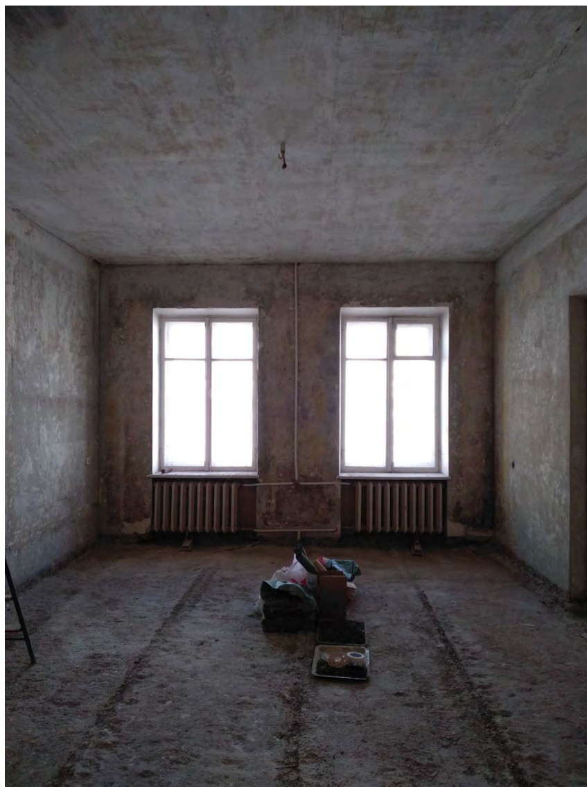
Фото 11. Комната (пом. №5 по проектной экспликации).
